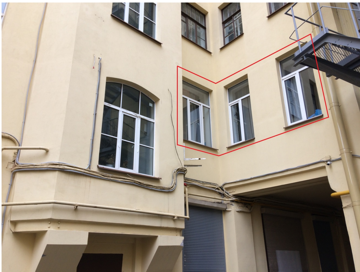
Фото 5. Дворовой фасад. Оконные проемы квартиры 29.
