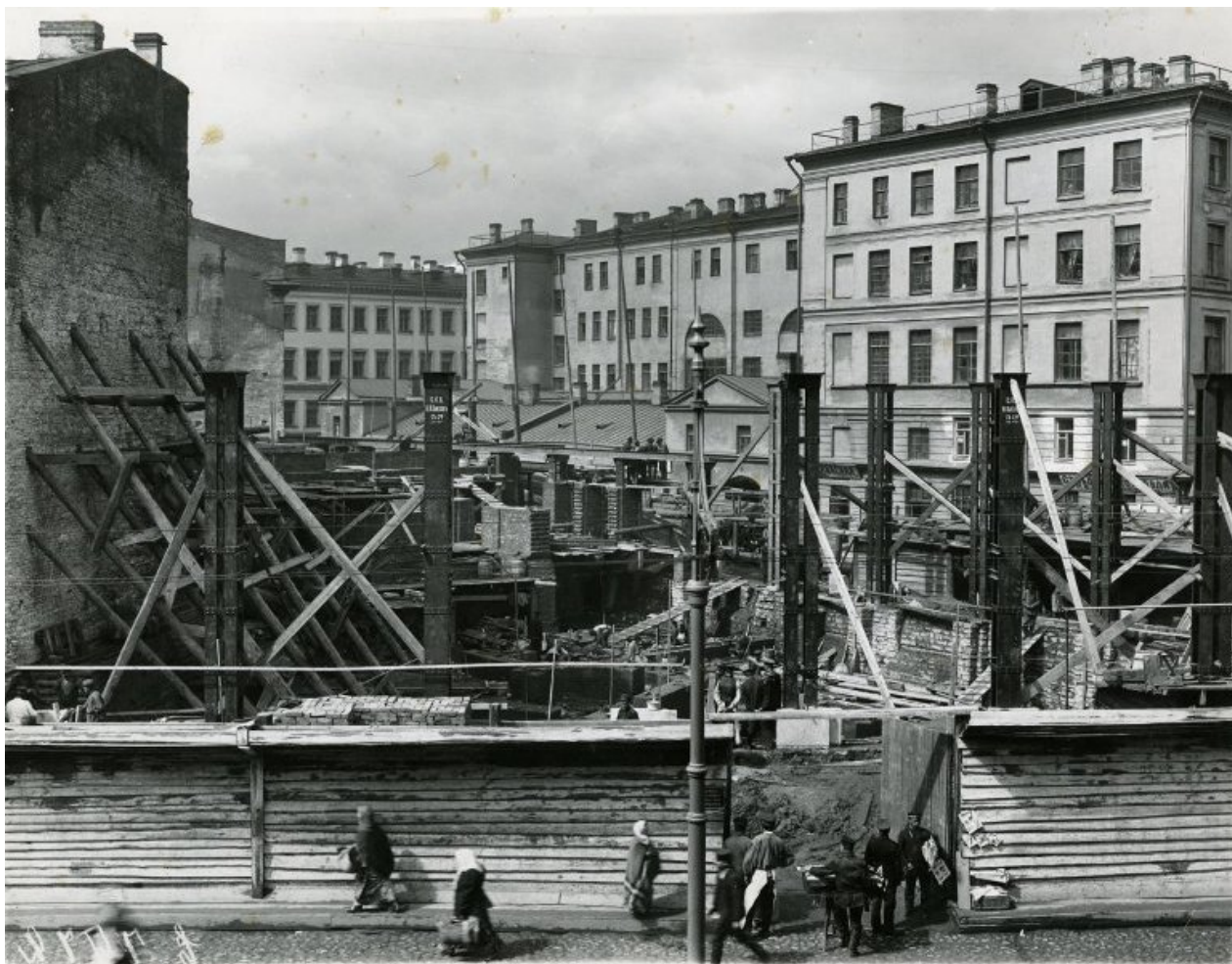
Илл. 32. Строительство на Забалканском проспекте. 1908г.— «PastVu» – ретро-фотографии стран и городов [Электронный ресурс]. URL: https://pastvu.com./p/782731
