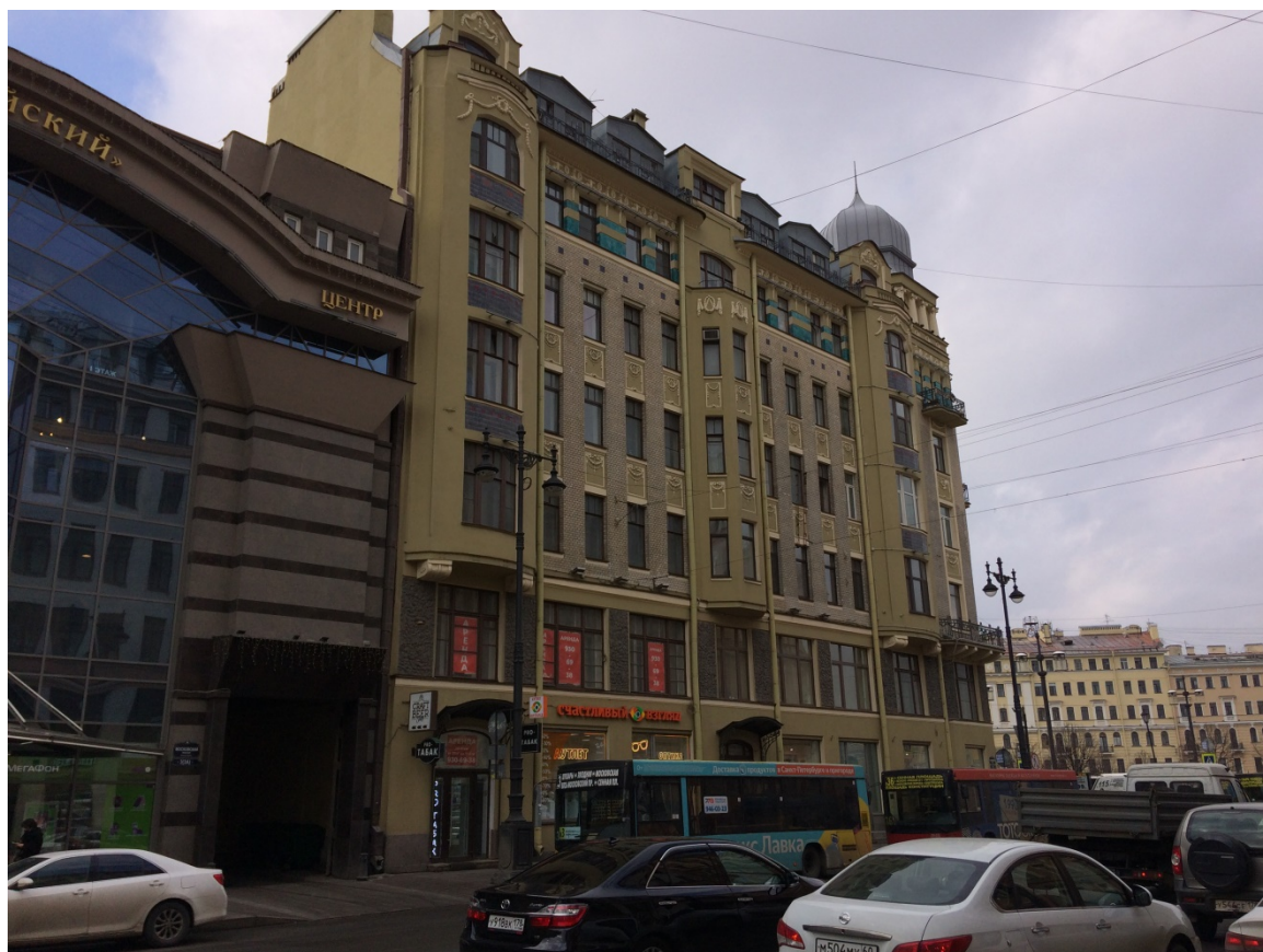
Фото 10. Фасад по Московскому проспекту.
