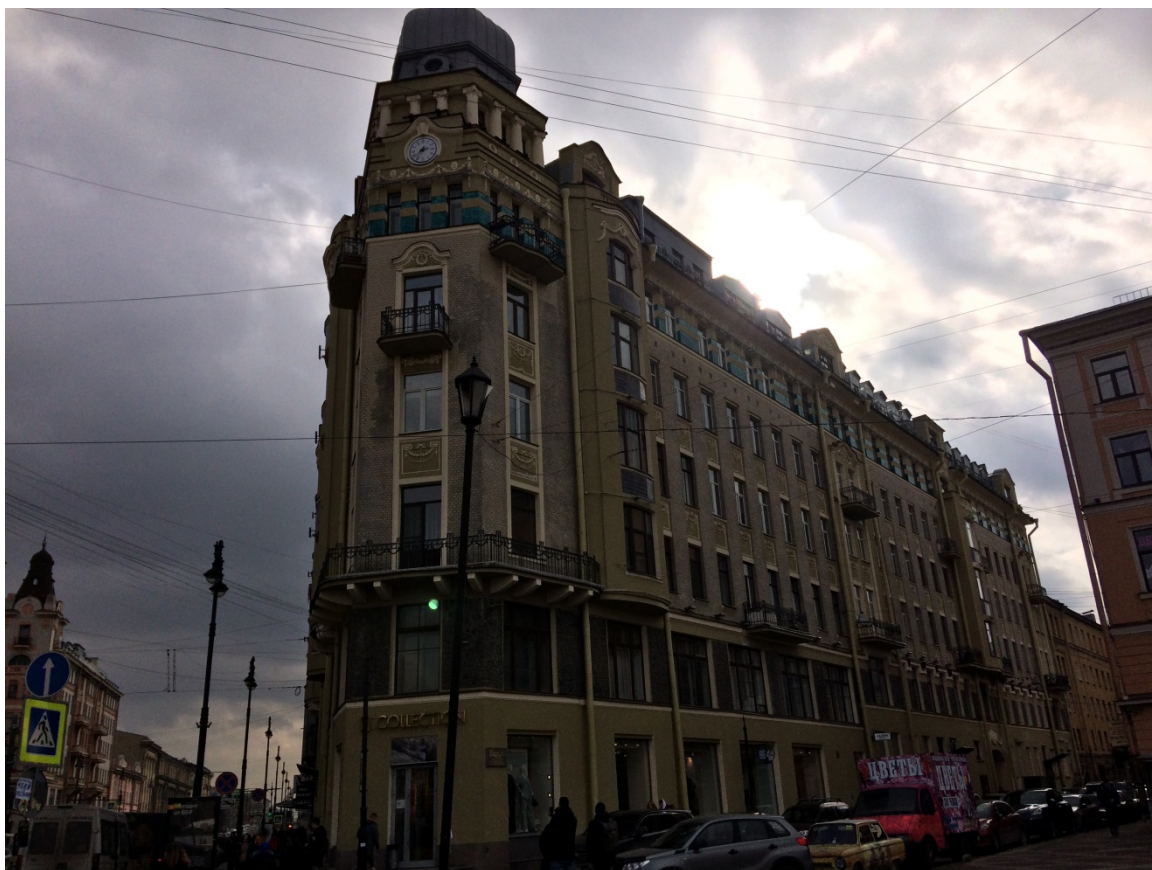
Фото 8. Угловой фасад и фасад по переулку Бринько.
