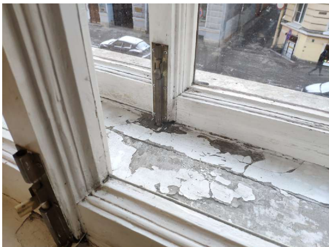
6, 7 “Дом Мельникова (Н.А. Тирана)(с оградой)». Санкт-Петербург, Саперный пер., 10, лит.А; 10, лит.В (Саперный пер.,10; Гродненский пер.,1). Фрагменты столярного заполнения оконного проема в пом. 1. Фото: 25.04.21.
