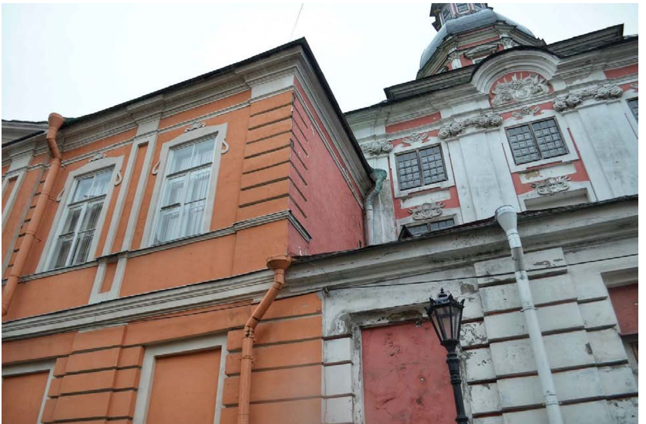
Фото 60. ОКН федерального значения «Корпус Духовской» (наб. реки Монастырки, дом 1, литера Д). Восточный фасад. Фрагмент. Съёмка 23.10.2020 г.
