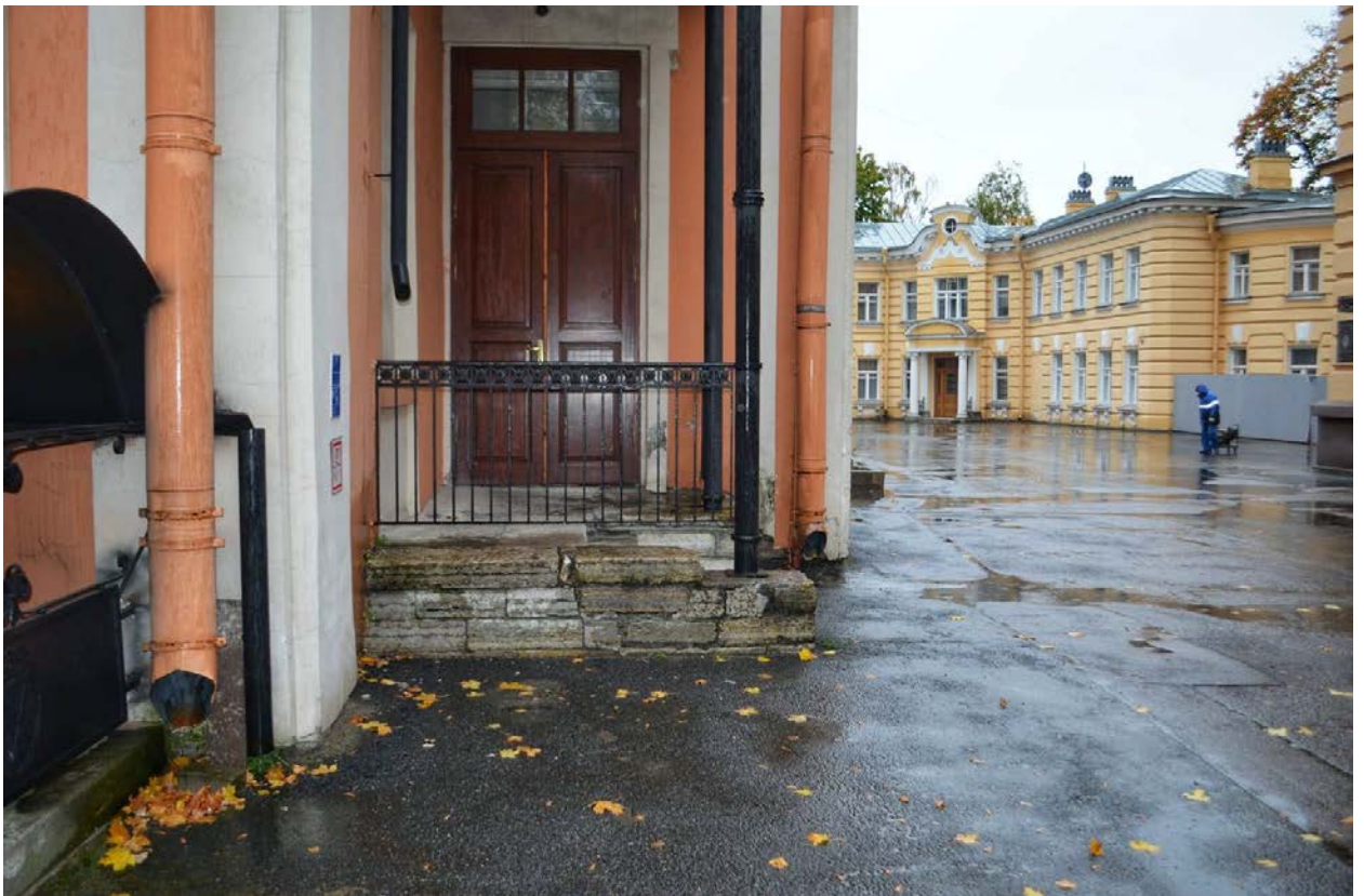
Фото 55. ОКН федерального значения «Корпус Духовской» (наб. реки Монастырки, дом 1, литера Д). Восточный фасад. Крыльцо. Фрагмент. Съёмка 23.10.2020 г.
