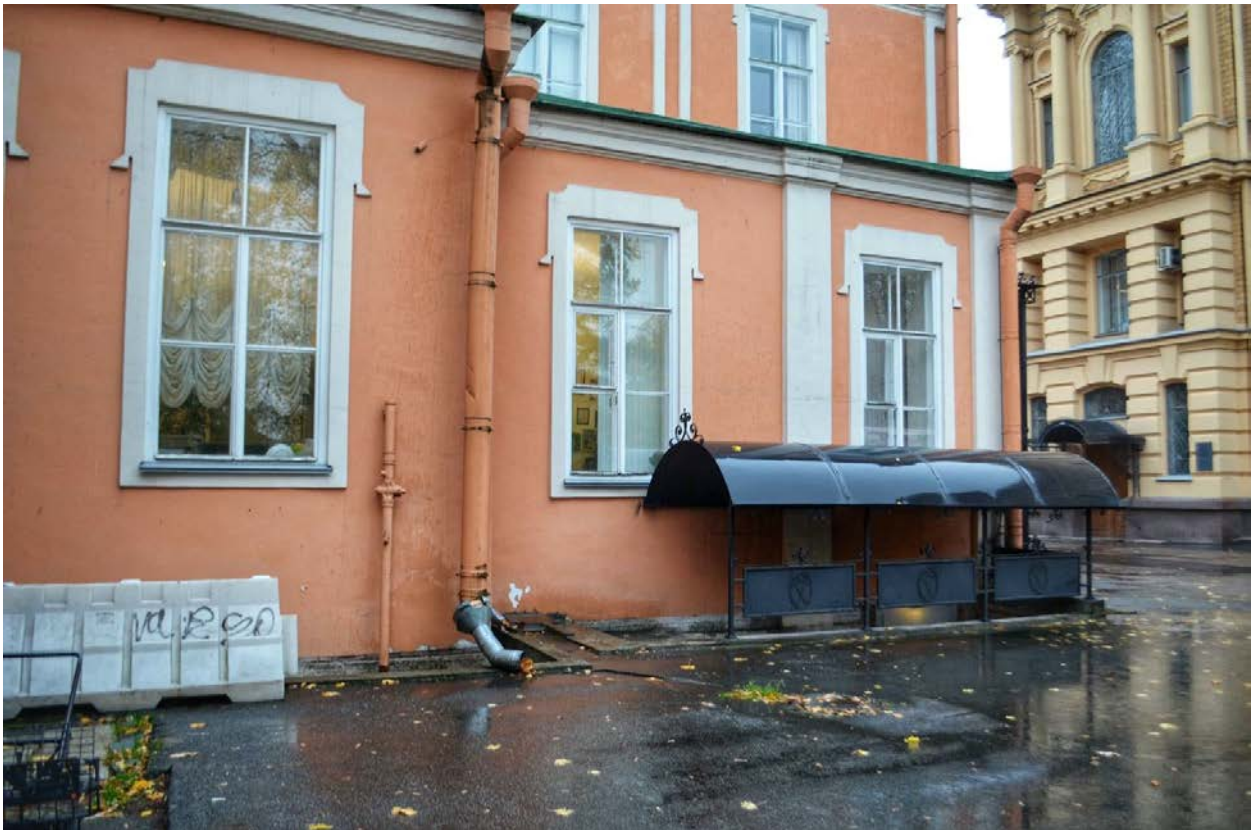
Фото 51. ОКН федерального значения «Корпус Духовской» (наб. реки Монастырки, дом 1, литера Д). Восточный фасад. Фрагмент. Съёмка 23.10.2020 г.
