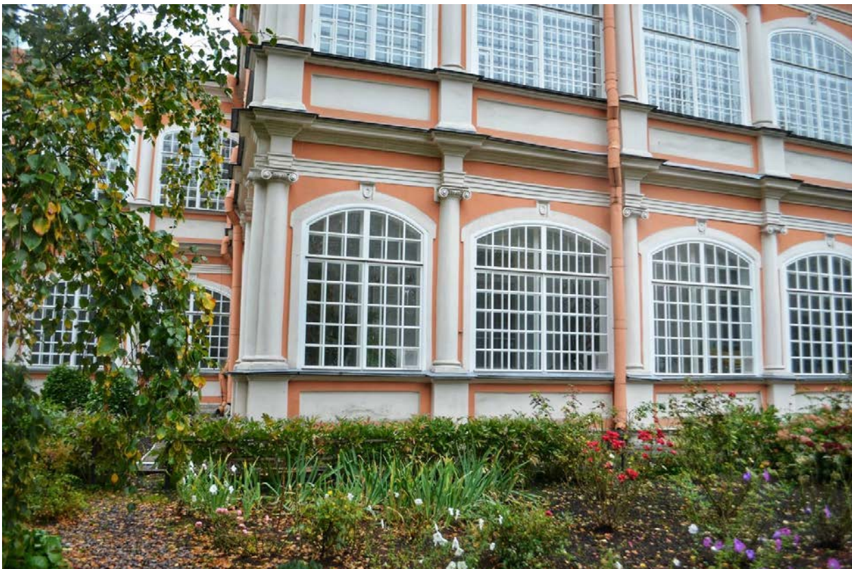
Фото 17. ОКН федерального значения «Корпус Духовской» (наб. реки Монастырки, дом 1, литера Д). Западный фасад. Фрагмент. Съёмка 23.10.2020 г.
