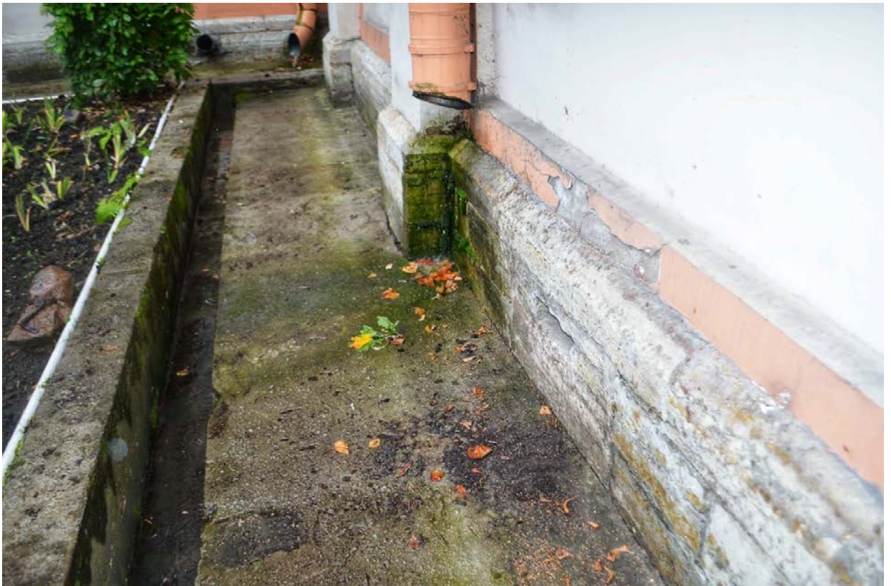
Фото 15. ОКН федерального значения «Корпус Духовской» (наб. реки Монастырки, дом 1, литера Д). Западный фасад. Фрагмент. Съёмка 23.10.2020 г.
