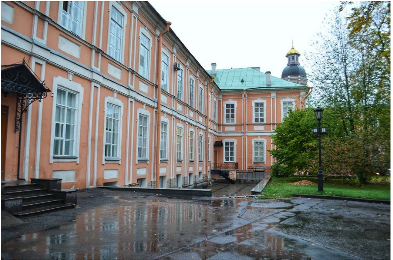
Фото 41. ОКН федерального значения «Корпус Духовской» (наб. реки Монастырки, дом 1, литера Д). Восточный фасад. Фрагмент. Съёмка 23.10.2020 г.
