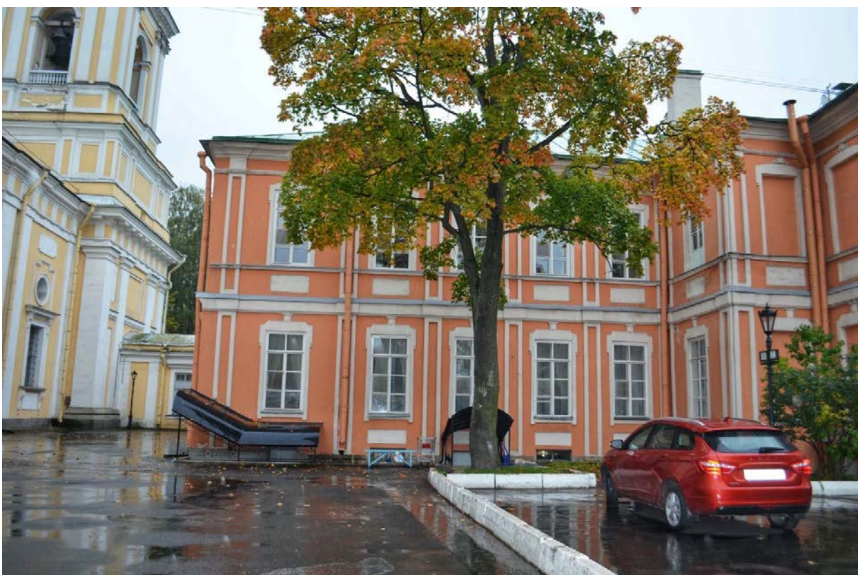
Фото 30. ОКН федерального значения «Корпус Духовской» (наб. реки Монастырки, дом 1, литера Д). Восточный фасад. Фрагмент. Съёмка 23.10.2020 г.
