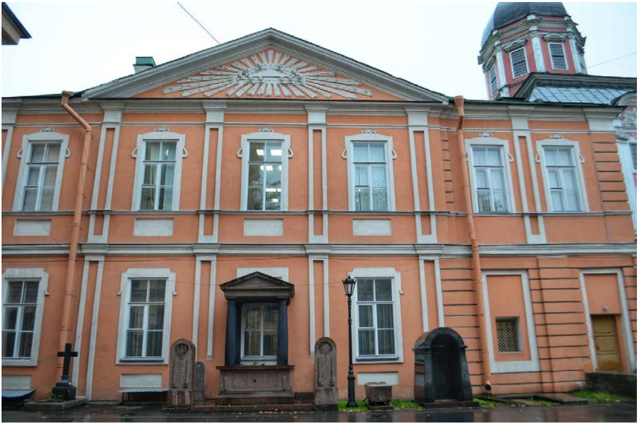
Фото 57. ОКН федерального значения «Корпус Духовской» (наб. реки Монастырки, дом 1, литера Д). Восточный фасад. Фрагмент. Съёмка 23.10.2020 г.
