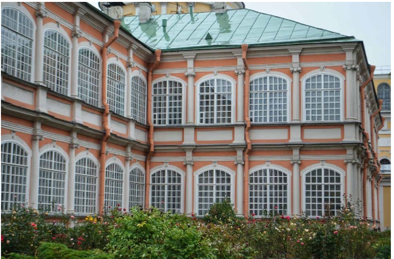
Фото 14. ОКН федерального значения «Корпус Духовской» (наб. реки Монастырки, дом 1, литера Д). Западный фасад. Фрагмент. Съёмка 23.10.2020 г.
