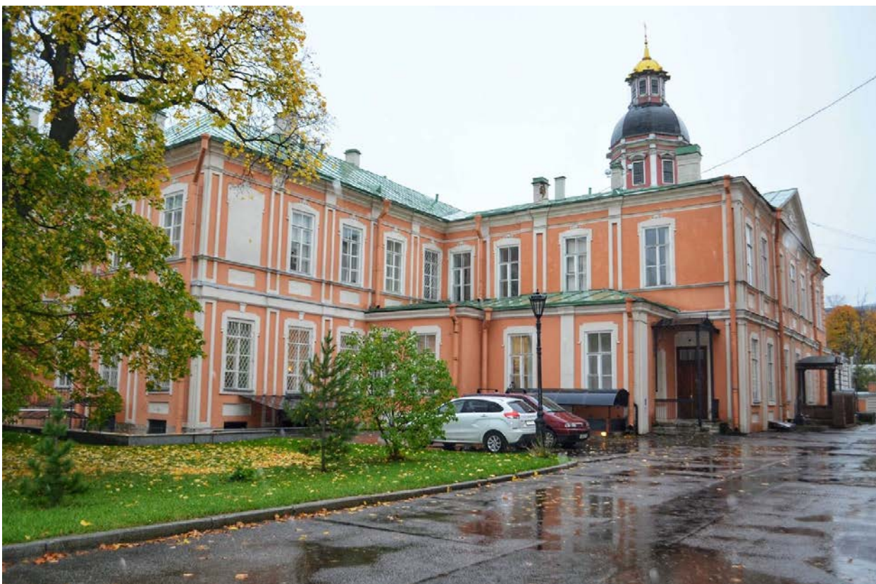
Фото 43. ОКН федерального значения «Корпус Духовской» (наб. реки Монастырки, дом 1, литера Д). Восточный фасад. Фрагмент. Съёмка 23.10.2020 г.
