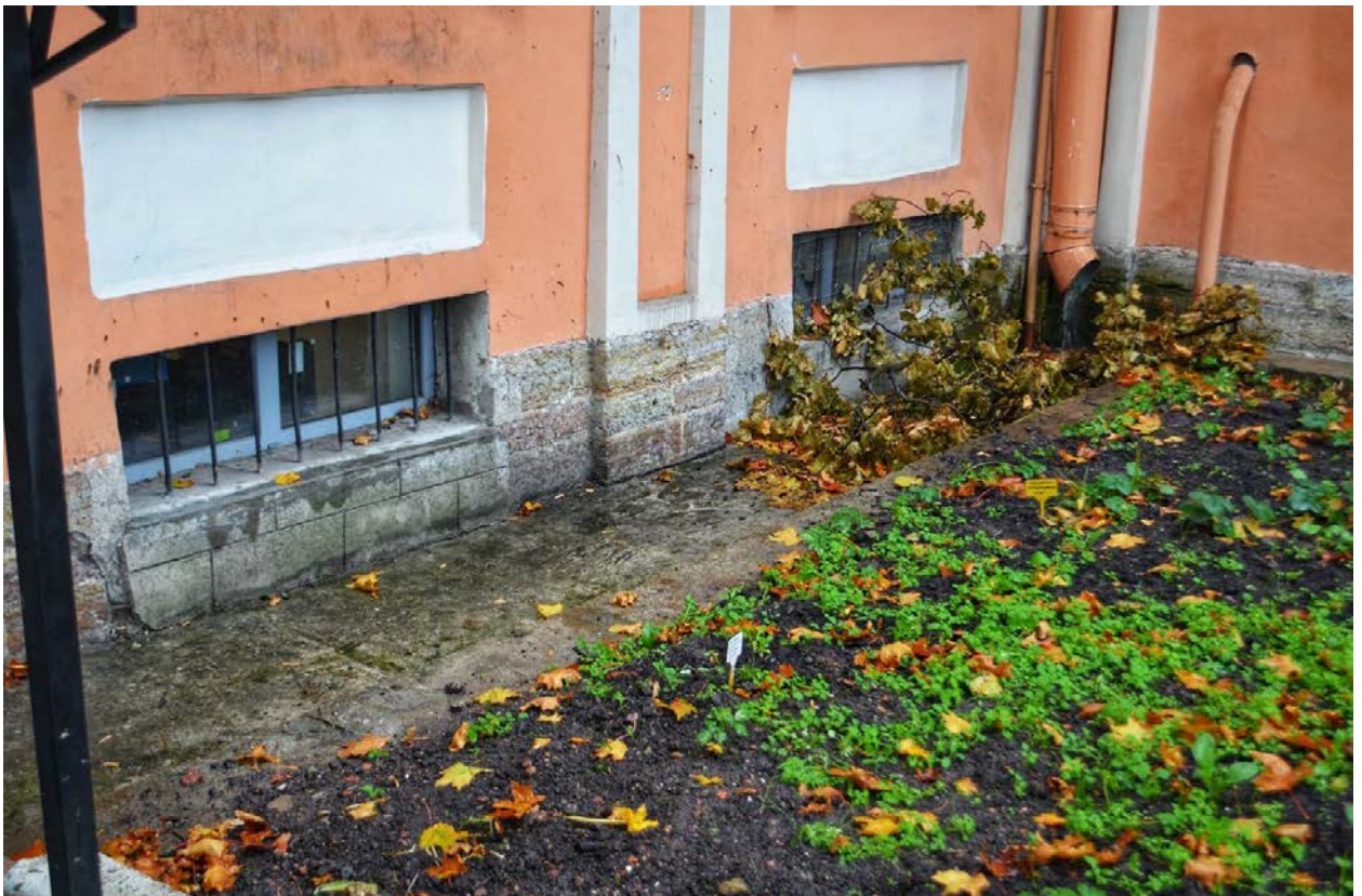
Фото 34. ОКН федерального значения «Корпус Духовской» (наб. реки Монастырки, дом 1, литера Д). Восточный фасад. Цоколь. Фрагмент. Съёмка 23.10.2020 г.
