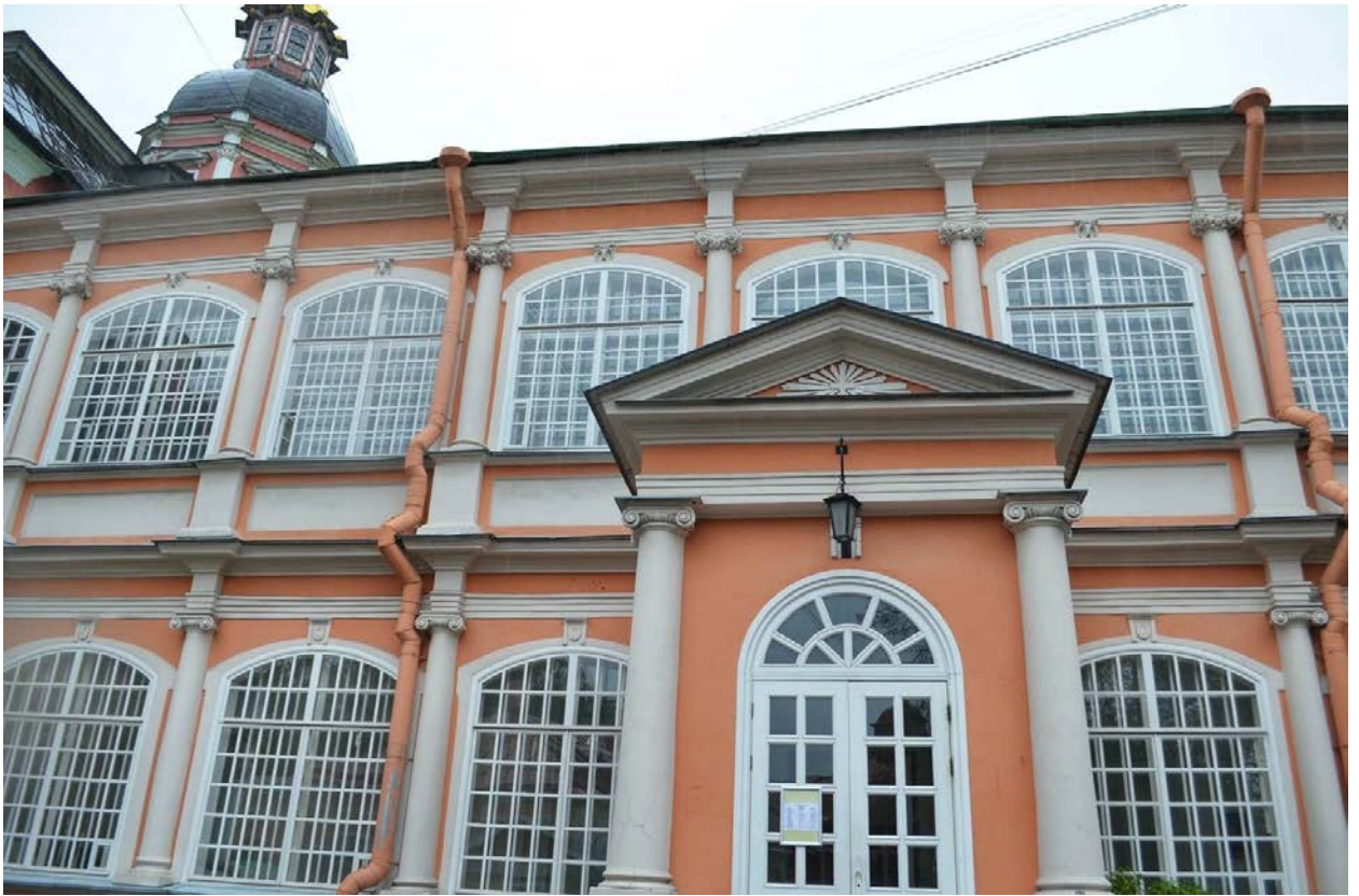
Фото 03. ОКН федерального значения «Корпус Духовской» (наб. реки Монастырки, дом 1, литера Д). Западный фасад. Фрагмент. Съёмка 23.10.2020 г.
