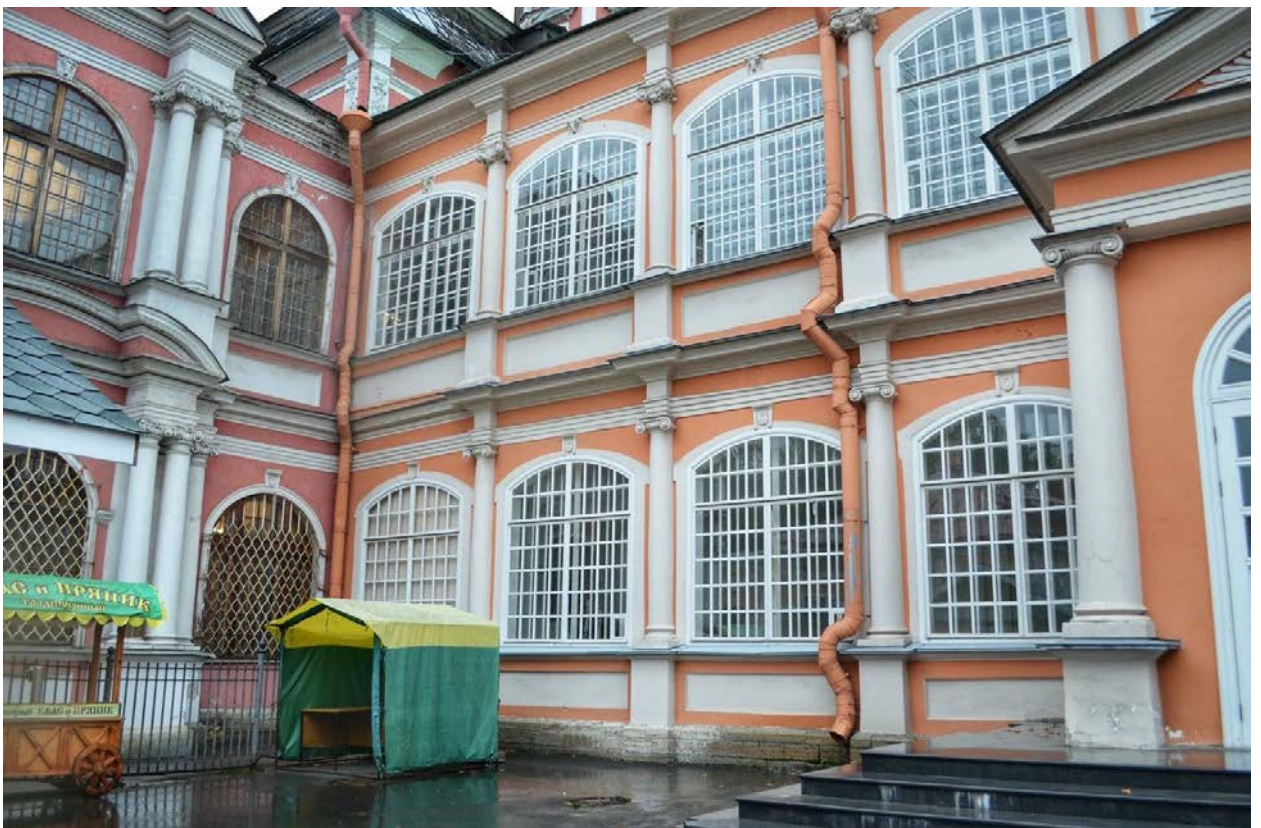
Фото 02. ОКН федерального значения «Корпус Духовской» (наб. реки Монастырки, дом 1, литера Д). Западный фасад. Фрагмент. Съёмка 23.10.2020 г.
