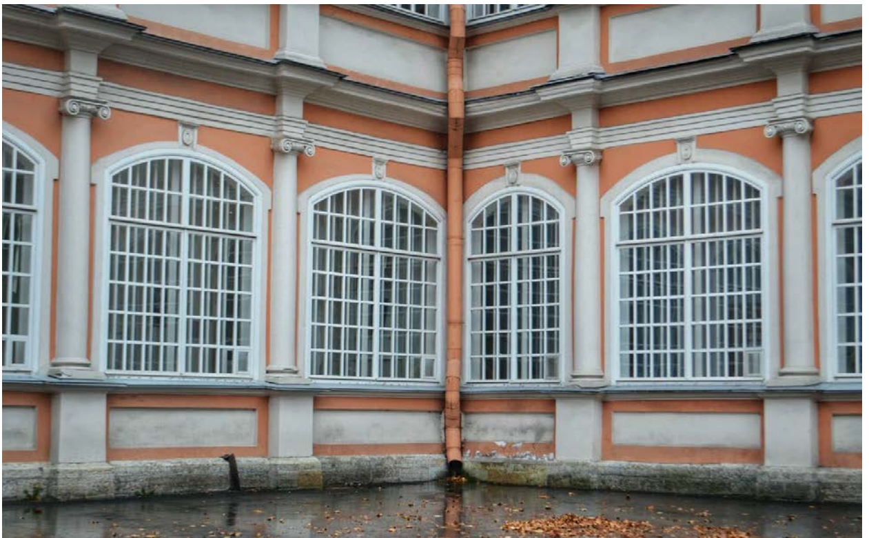
Фото 08. ОКН федерального значения «Корпус Духовской» (наб. реки Монастырки, дом 1, литера Д). Западный фасад. Фрагмент. Съёмка 23.10.2020 г.
