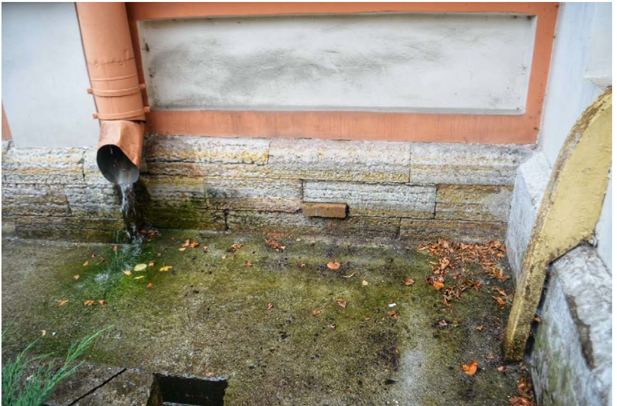
Фото 21. ОКН федерального значения «Корпус Духовской» (наб. реки Монастырки, дом 1, литера Д). Западный фасад. Фрагмент. Съёмка 23.10.2020 г.
