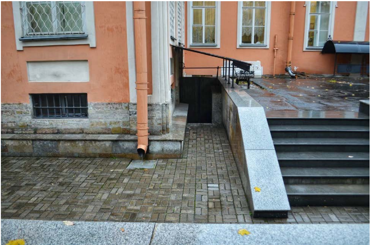
Фото 47. ОКН федерального значения «Корпус Духовской» (наб. реки Монастырки, дом 1, литера Д). Восточный фасад. Фрагмент. Съёмка 23.10.2020 г.
