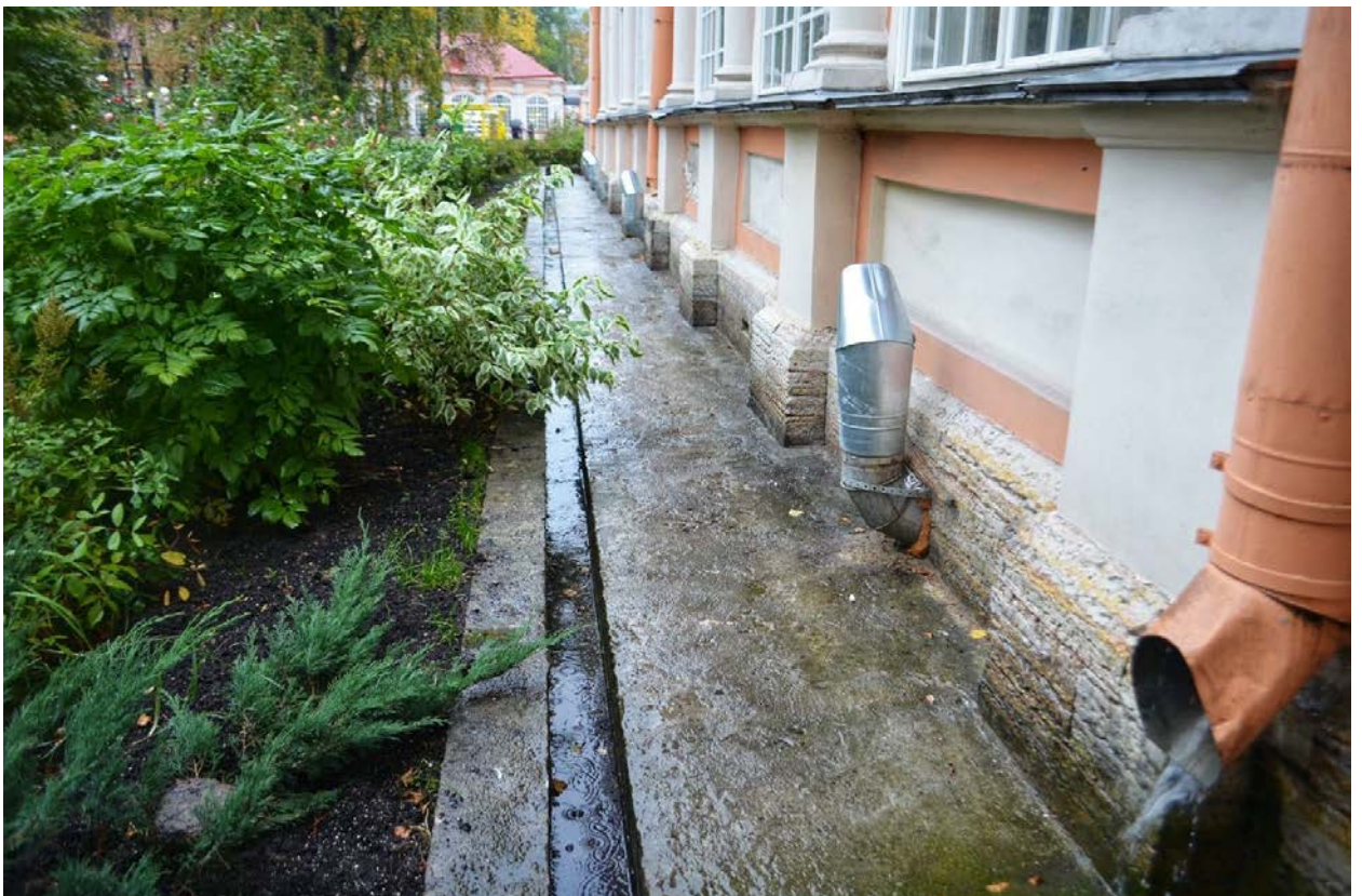
Фото 22. ОКН федерального значения «Корпус Духовской» (наб. реки Монастырки, дом 1, литера Д). Западный фасад. Фрагмент. Съёмка 23.10.2020 г.
