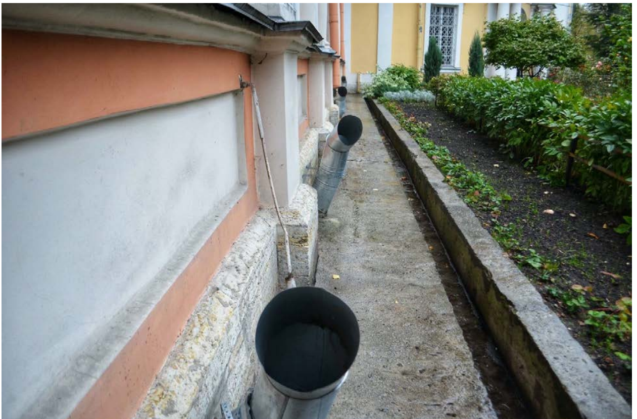
Фото 24. ОКН федерального значения «Корпус Духовской» (наб. реки Монастырки, дом 1, литера Д). Западный фасад. Фрагмент. Съёмка 23.10.2020 г.
