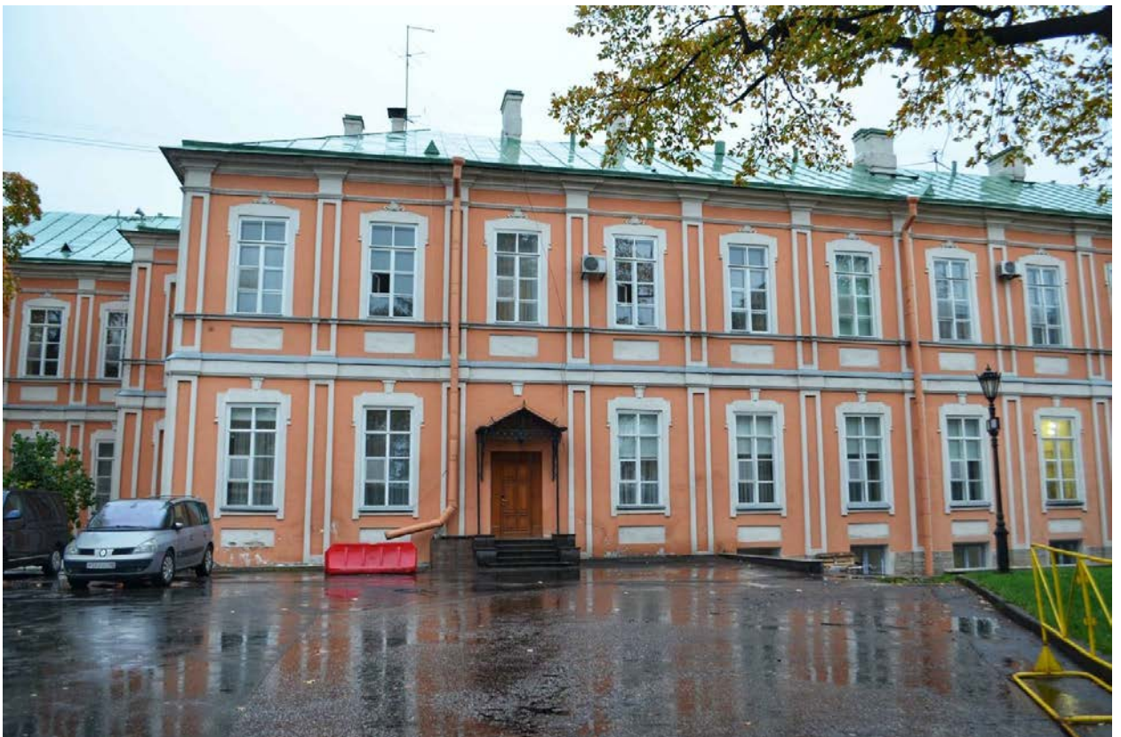
Фото 38. ОКН федерального значения «Корпус Духовской» (наб. реки Монастырки, дом 1, литера Д). Восточный фасад. Фрагмент. Съёмка 23.10.2020 г.
