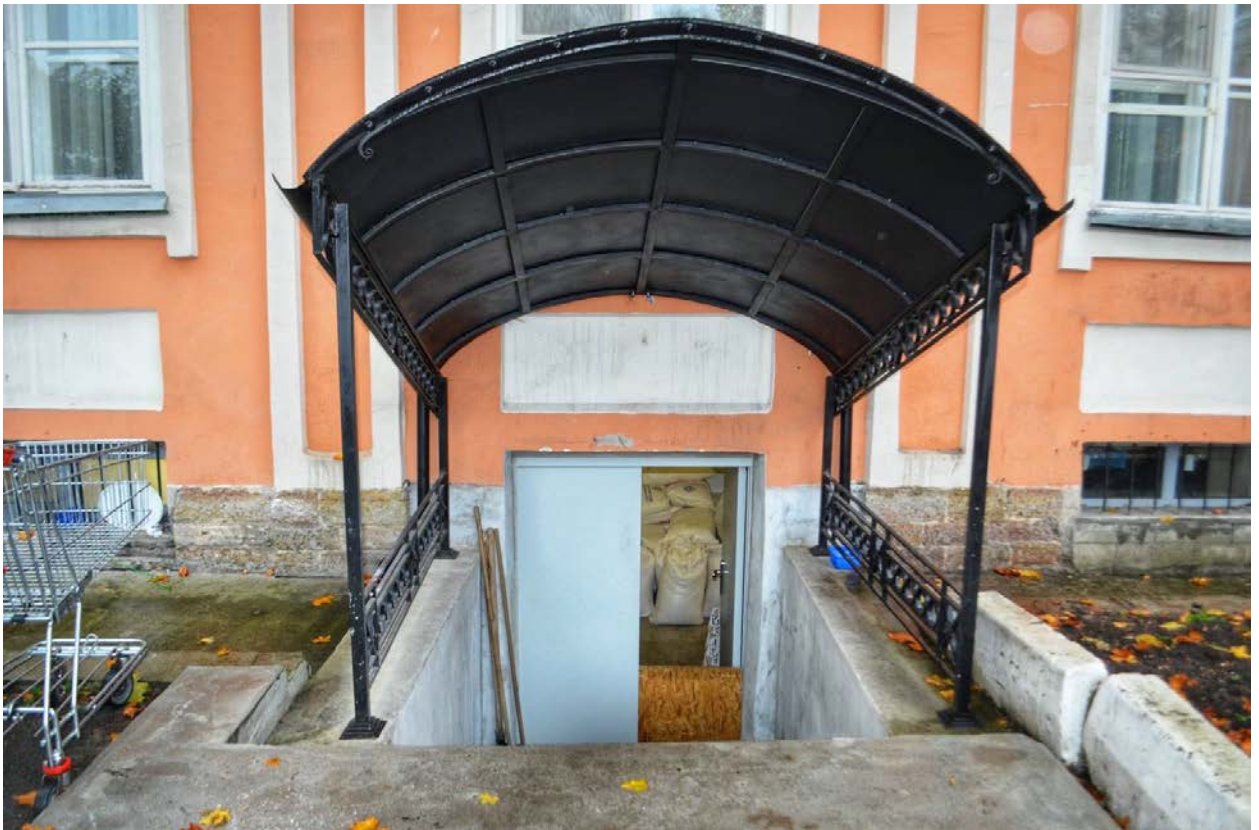
Фото 33. ОКН федерального значения «Корпус Духовской» (наб. реки Монастырки, дом 1, литера Д). Восточный фасад. Вход в подвальное помещение. Фрагмент. Съёмка 23.10.2020 г.
