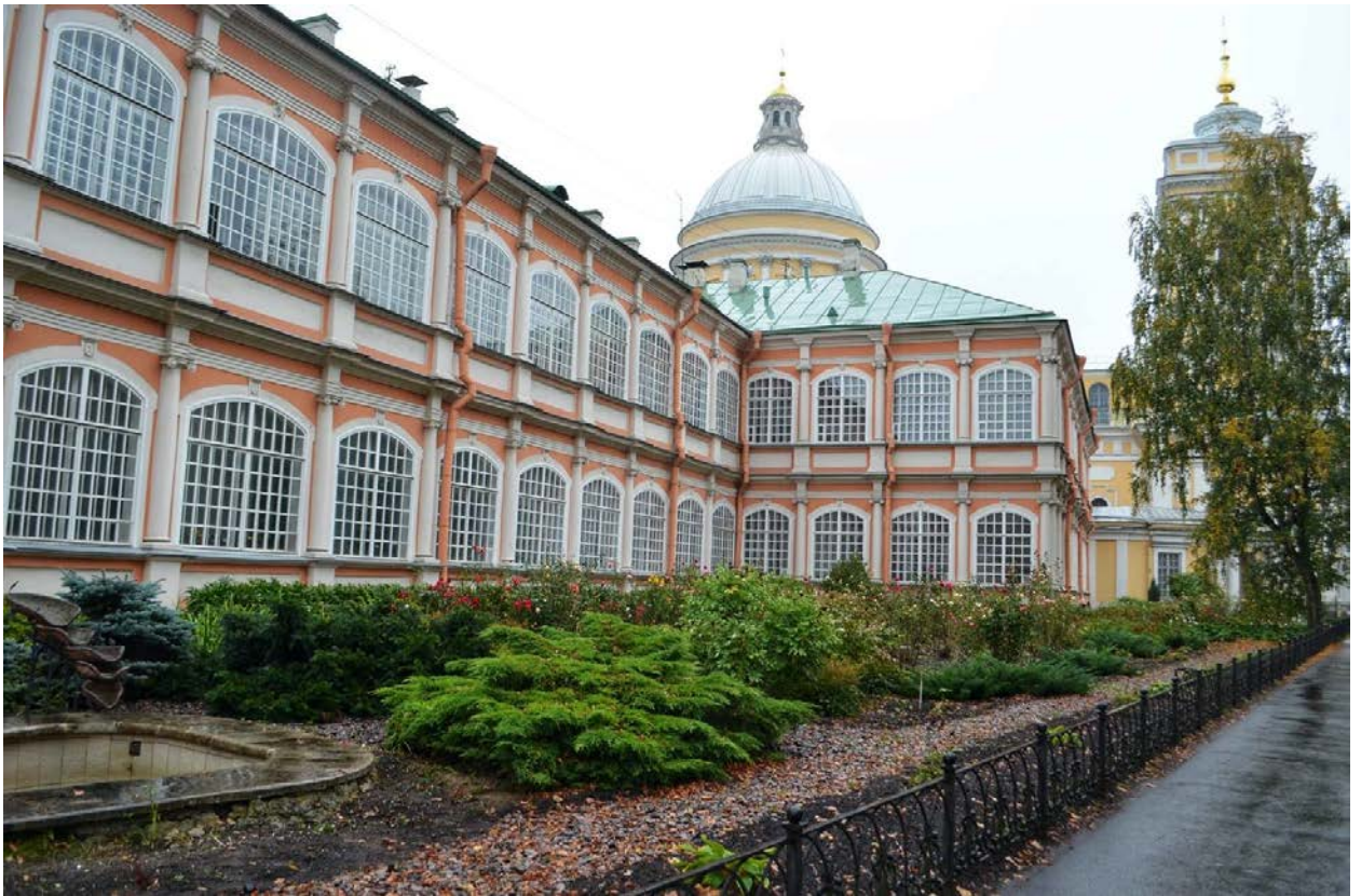
Фото 13. ОКН федерального значения «Корпус Духовской» (наб. реки Монастырки, дом 1, литера Д). Западный фасад. Фрагмент. Съёмка 23.10.2020 г.
