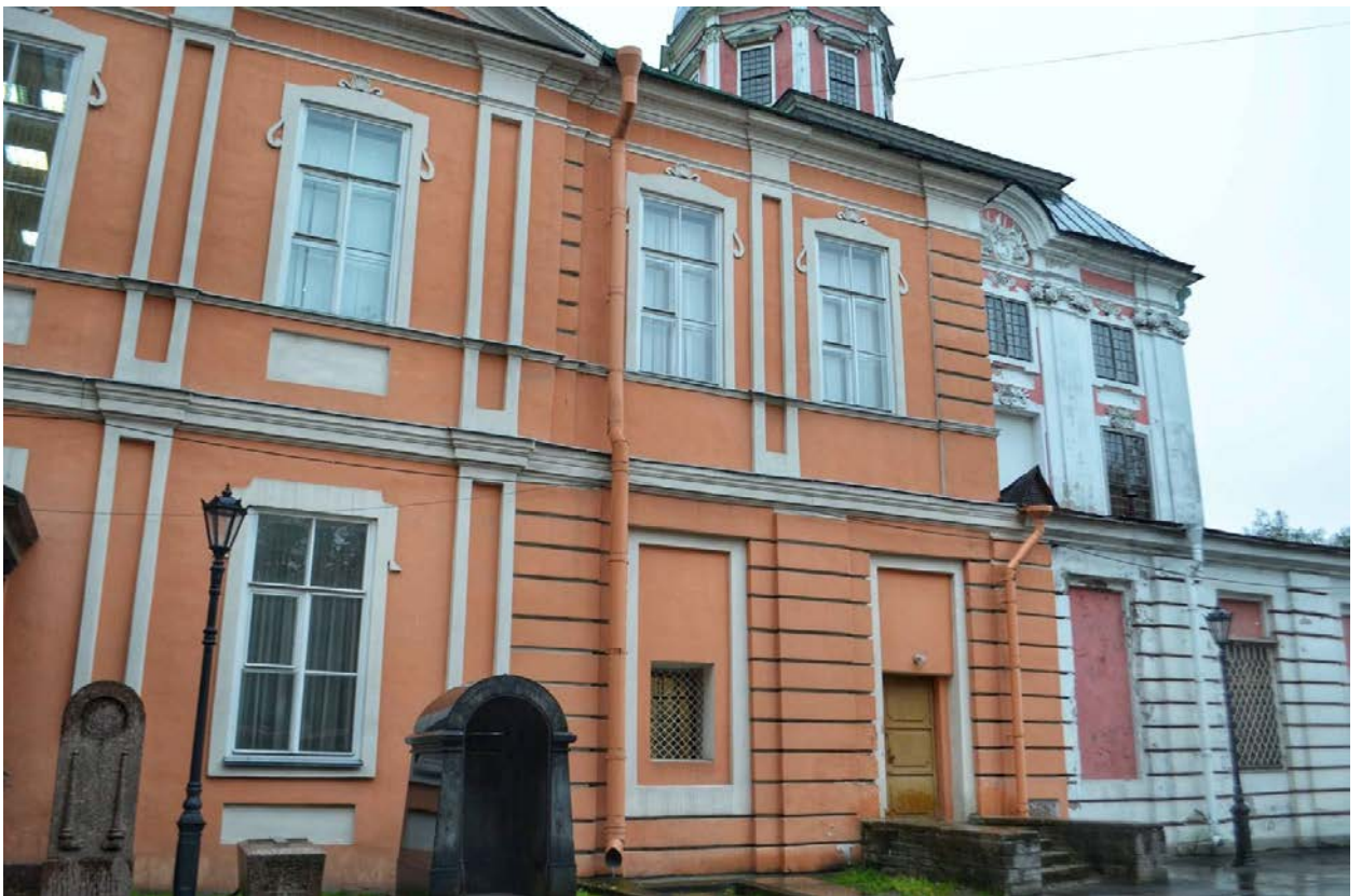
Фото 58. ОКН федерального значения «Корпус Духовской» (наб. реки Монастырки, дом 1, литера Д). Восточный фасад. Фрагмент. Съёмка 23.10.2020 г.
