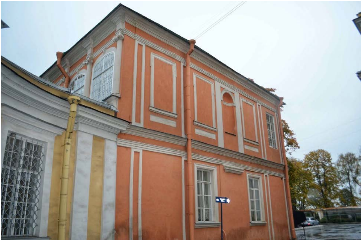
Фото 25. ОКН федерального значения «Корпус Духовской» (наб. реки Монастырки, дом 1, литера Д). Южный фасад. Общий вид. Съёмка 23.10.2020 г.
