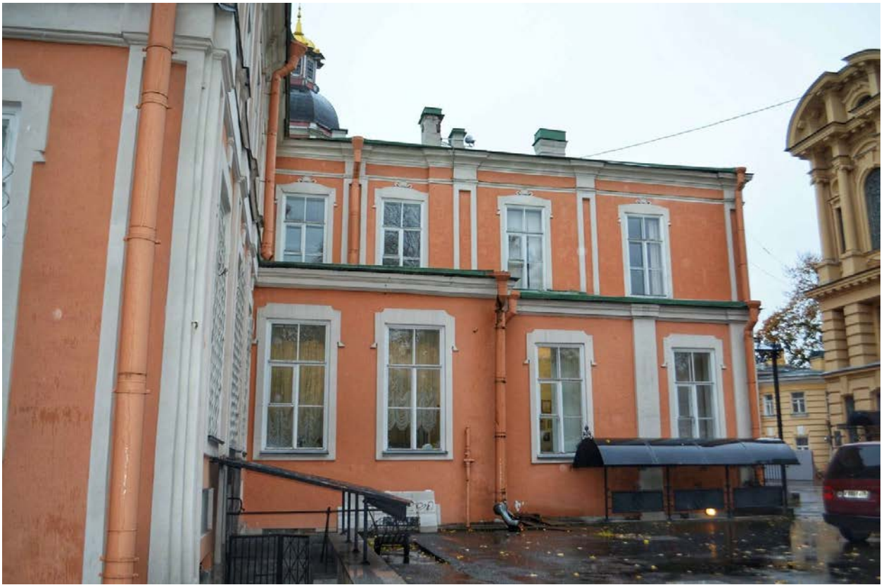
Фото 49. ОКН федерального значения «Корпус Духовской» (наб. реки Монастырки, дом 1, литера Д). Восточный фасад. Фрагмент. Съёмка 23.10.2020 г.
