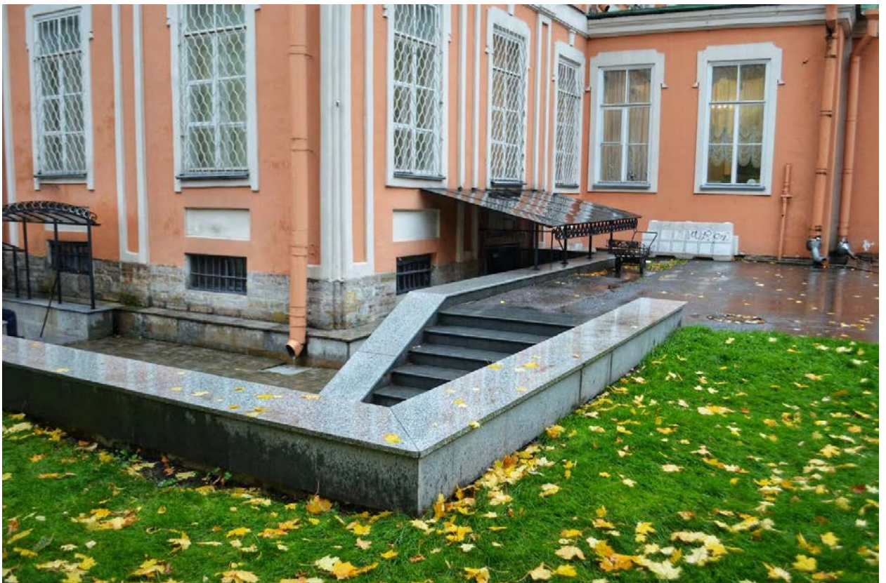
Фото 46. ОКН федерального значения «Корпус Духовской» (наб. реки Монастырки, дом 1, литера Д). Восточный фасад. Фрагмент. Съёмка 23.10.2020 г.
