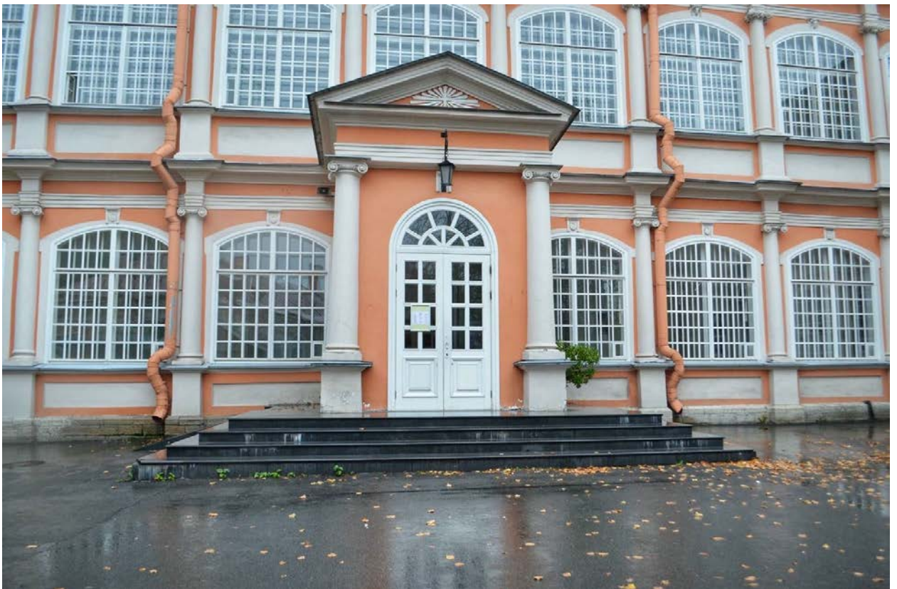
Фото 04. ОКН федерального значения «Корпус Духовской» (наб. реки Монастырки, дом 1, литера Д). Западный фасад. Тамбур. Съёмка 23.10.2020 г.
