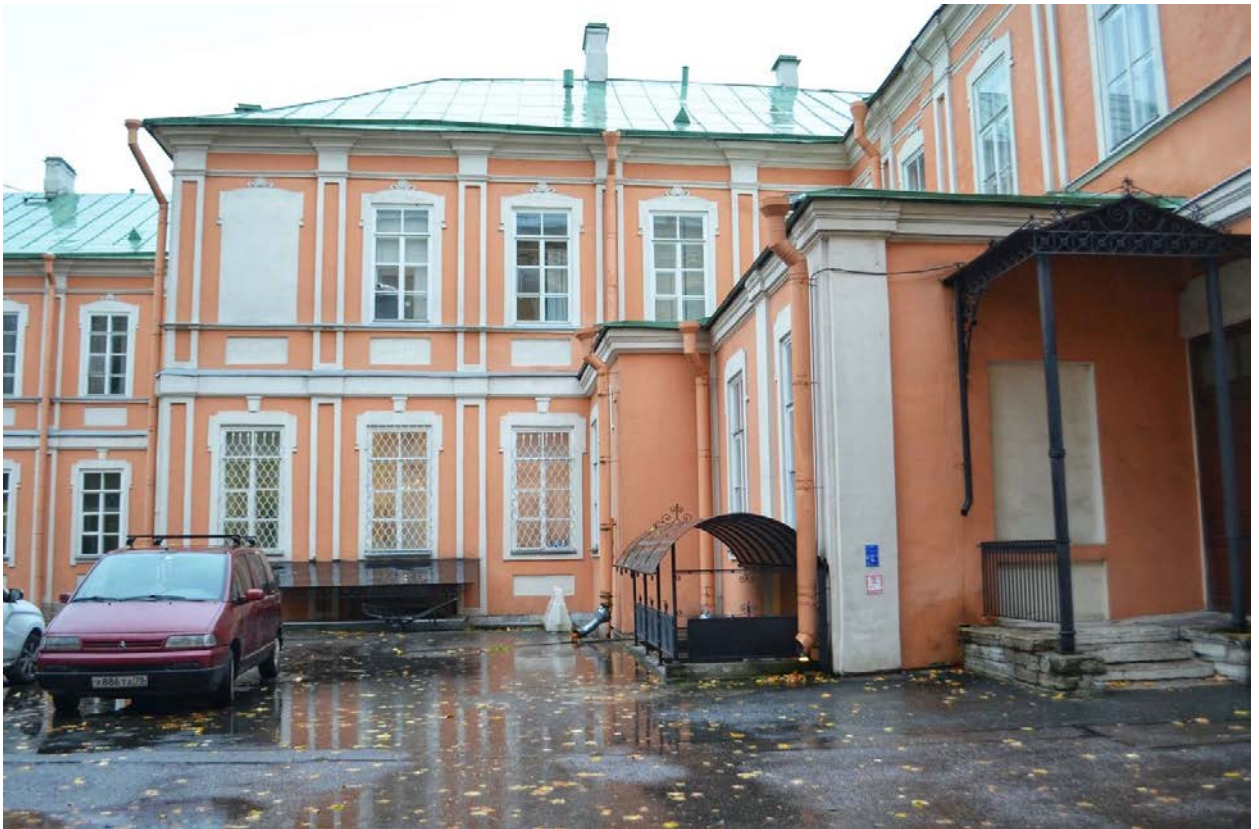
Фото 48. ОКН федерального значения «Корпус Духовской» (наб. реки Монастырки, дом 1, литера Д). Восточный фасад. Фрагмент. Съёмка 23.10.2020 г.
