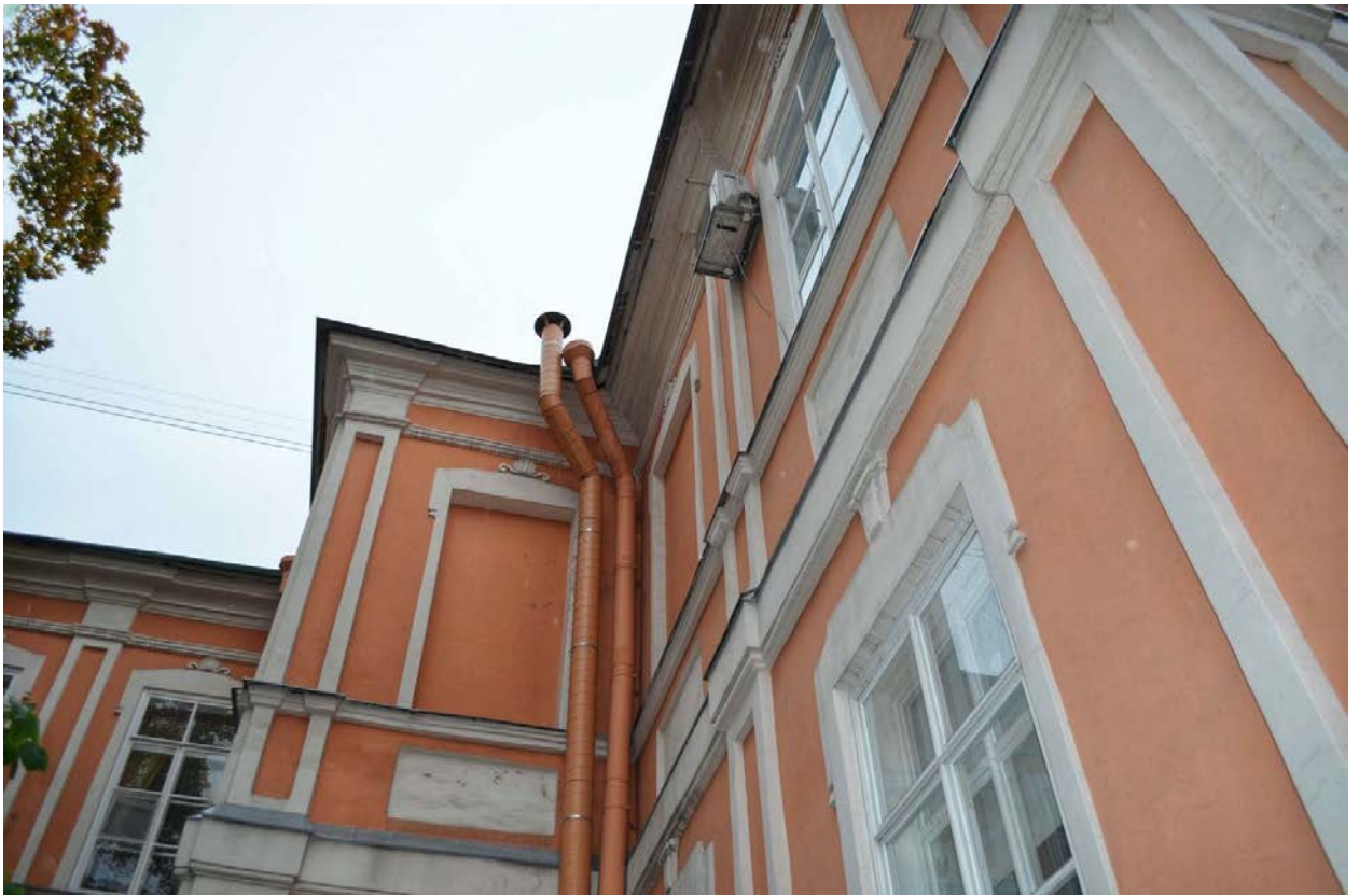
Фото 37. ОКН федерального значения «Корпус Духовской» (наб. реки Монастырки, дом 1, литера Д). Восточный фасад. Фрагмент. Съёмка 23.10.2020 г.
