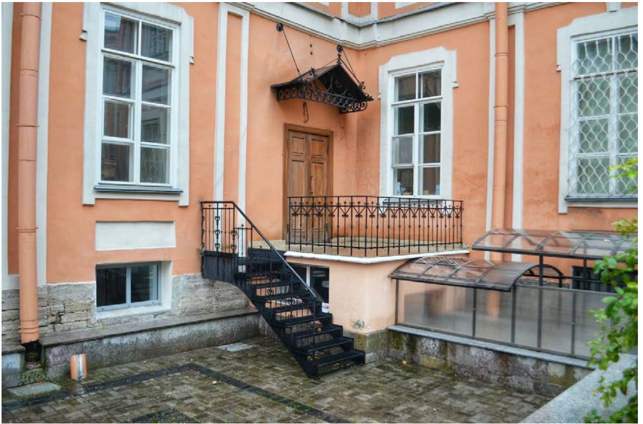
Фото 45. ОКН федерального значения «Корпус Духовской» (наб. реки Монастырки, дом 1, литера Д). Восточный фасад. Крыльцо. Фрагмент. Съёмка 23.10.2020 г.
