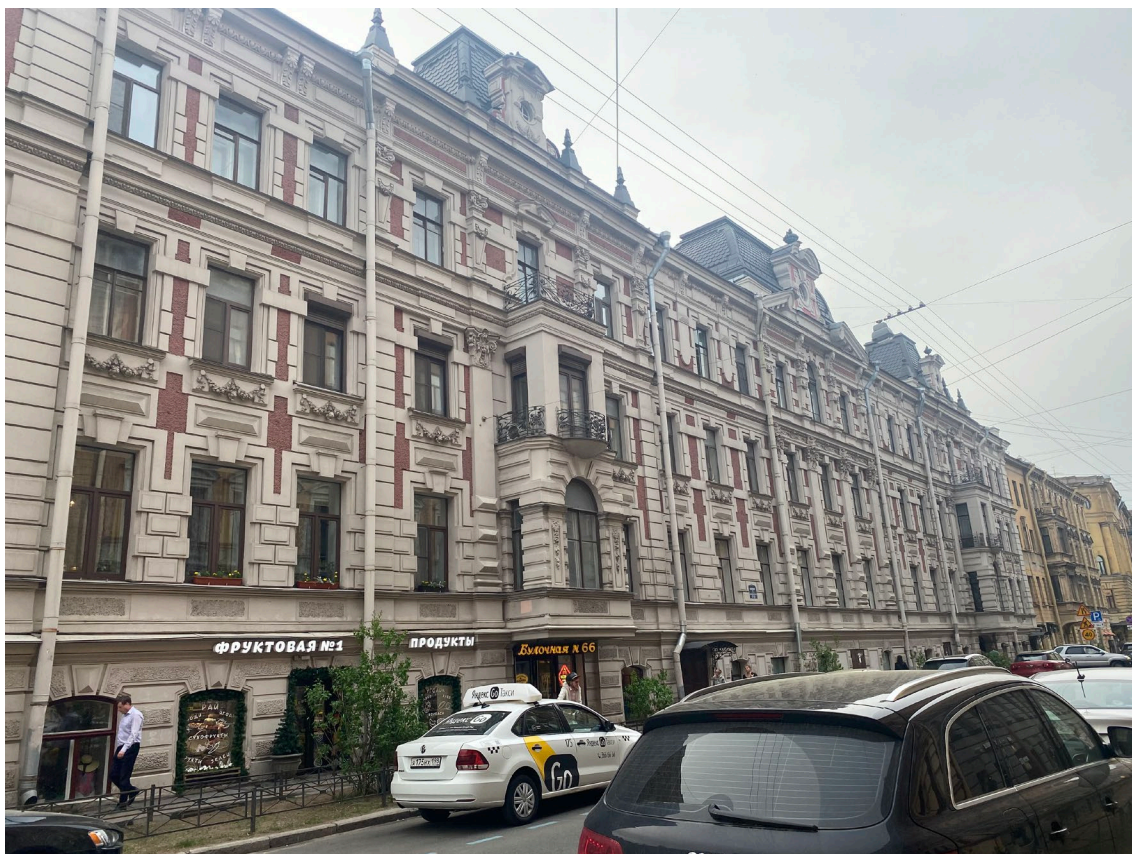
1. Лицевой фасад на Моховой ул.
