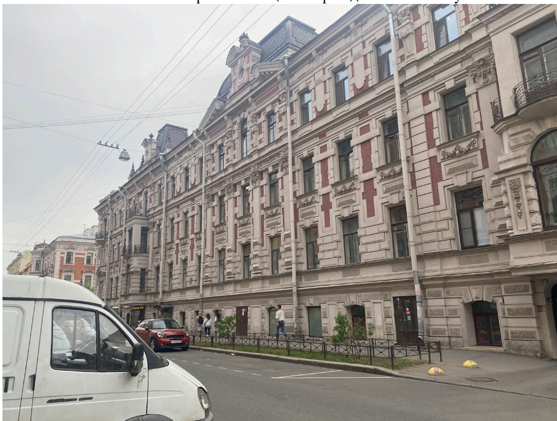
5. Лицевой фасад на Моховой ул
