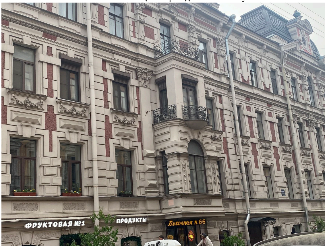
2. Фрагмент лицевого фасада на Моховой ул.
