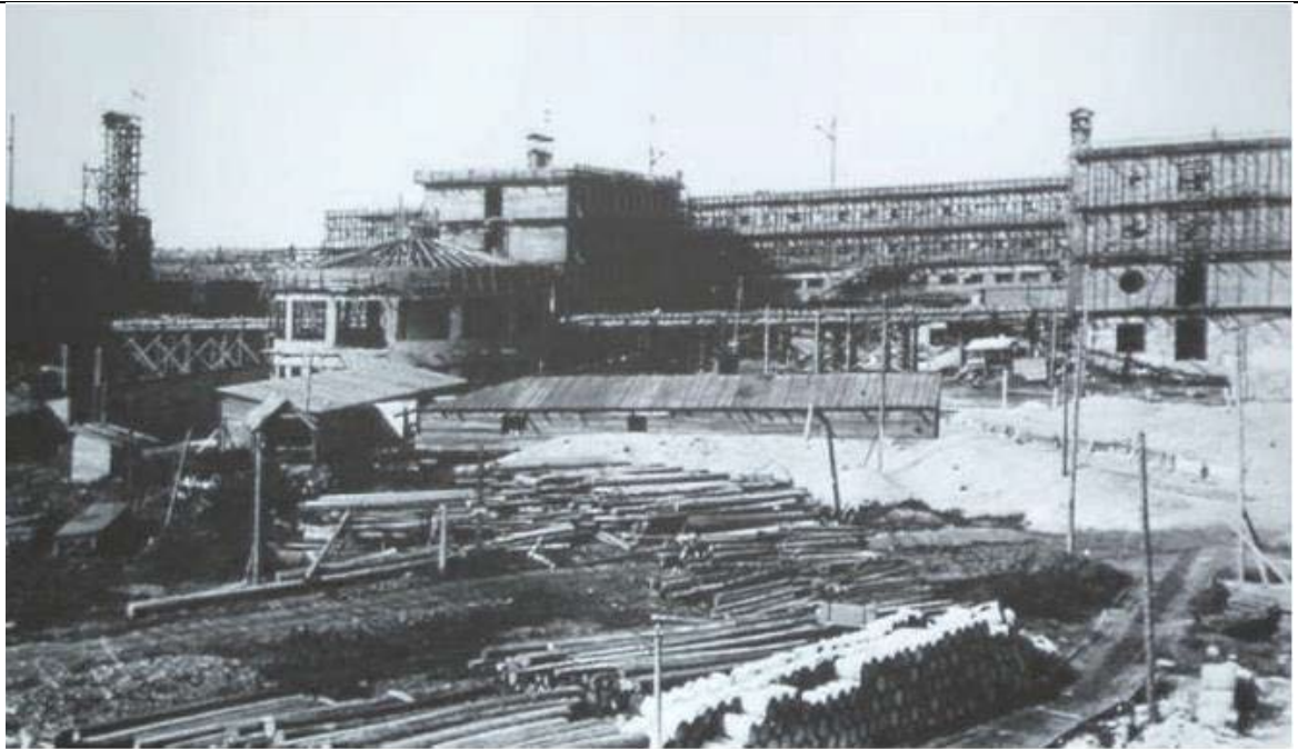
3. Строительство Кировского райсовета. Фото из фондов библиотеки им. Шолохова. 1930-е гг.
