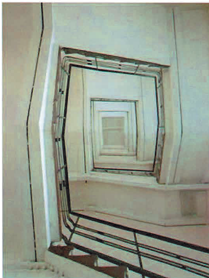
14. Угловая башня. Лестница
