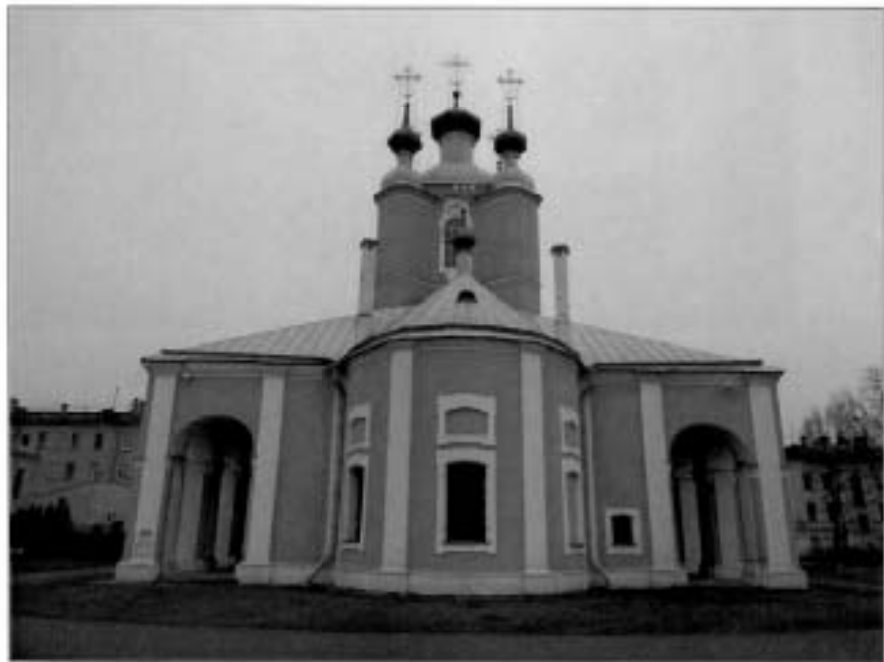
23. «Собор». Восточный фасад.
