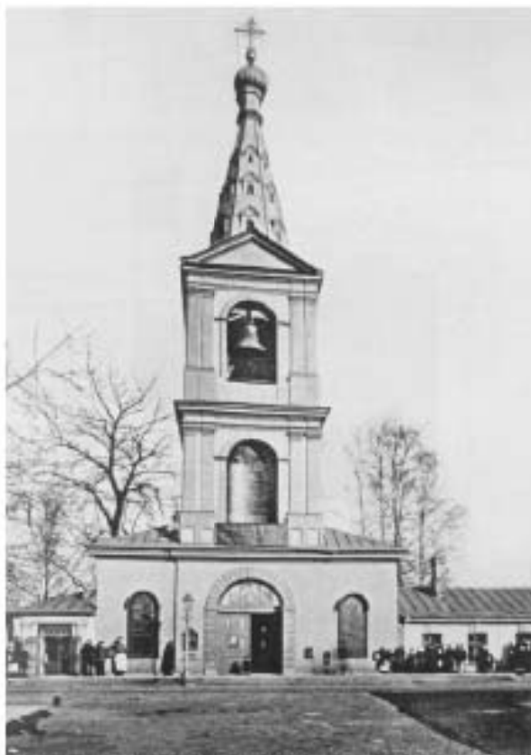
23. Колокольня Сампсониевского собора до реставрации 1908-1909 годов. Фото К. К. Буллы.
