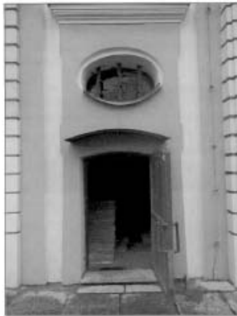
2. «Колокольня». Восточный фасад. Фрагмент.
