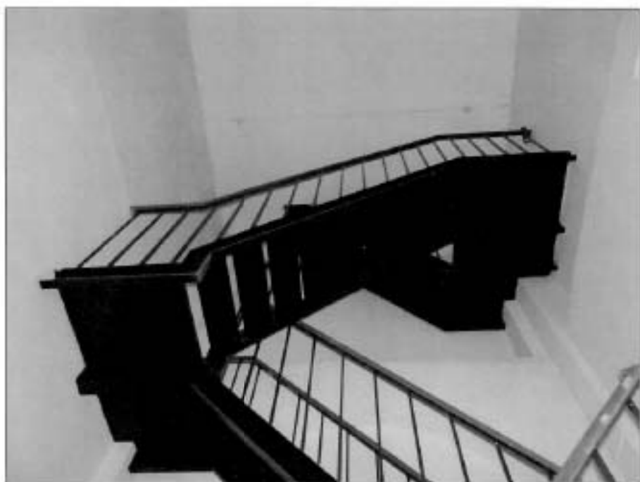
4. «Колокольня». Лестница в уровне второго яруса.
