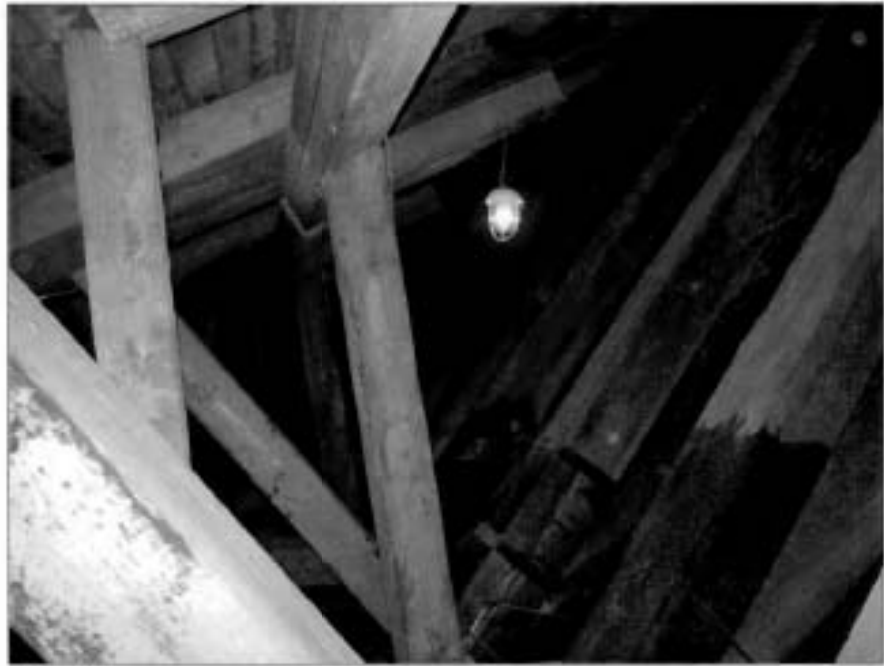
30. «Собор». Стропильная система. Фрагмент.
