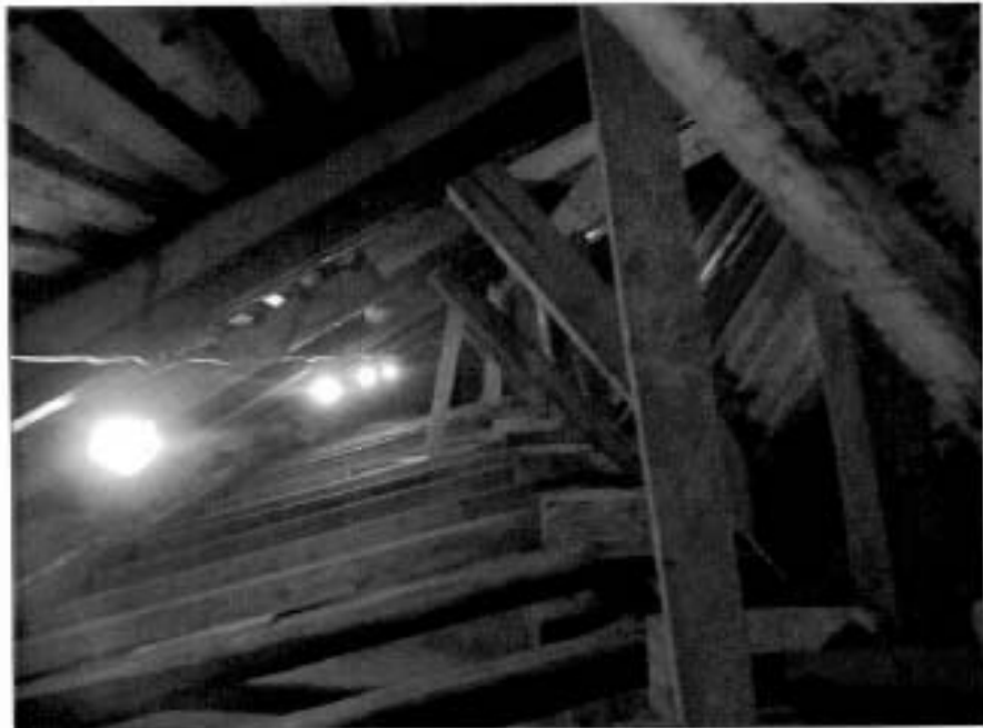
29. «Собор». Стропильная система. Фрагмент.
