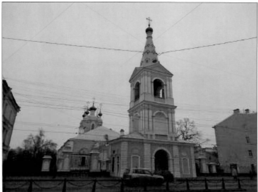
1. «Колокольня». Вид с северо-западной стороны.
