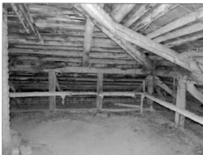
49. «Юбилейный домик», Стропильная система.
