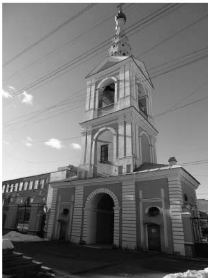
Илл. 14. Восточный фасад Колокольни. Съемка 05.02.21 г. Трушковский В.Э.
