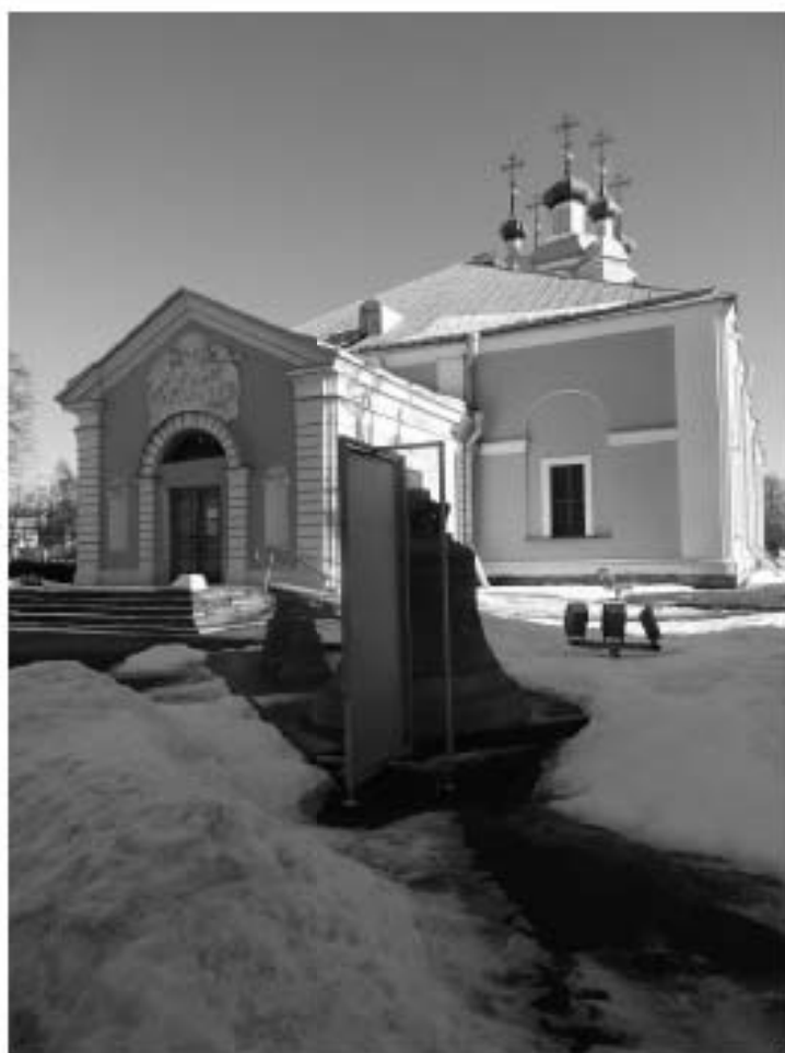
Илл. 10. Вид на западный фасад Собора. Съемка 05.02.21 г. Трушковский В.Э.
