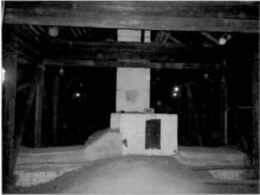
32. «Собор». Стропильная система. Фрагмент.
