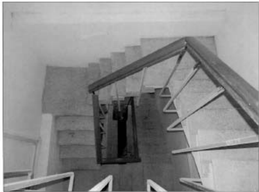
3. «Колокольня». Лестница в уровне первого яруса.
