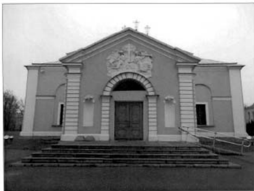
25. «Собор», Западный фасад. Притвор.
