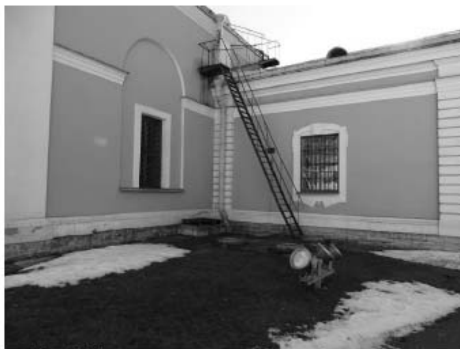
Илл. 24. Фрагмент западного и северного фасадов Собора. Съемка 05.02.21 г. Трушковский В.Э.
