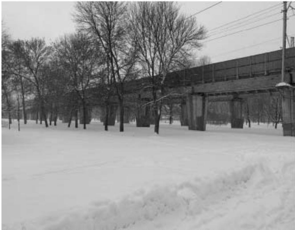
Рис. 62. Санкт-Петербург, Невский район. Территория ОКН «Участок сохранившегося культурного слоя, вмещающего остатки фундаментов зданий постройки середины XIX - начала XX вв., относящихся к историческому району Санкт-Петербурга Стекланный городок, в границах сада 30-летия Октября». Вид с восточной части ОКН на ЗСЗ.
