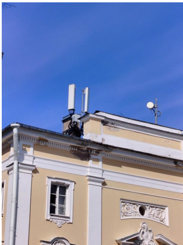
Фото 7. Фрагмент лицевого фасада объекта культурного наследия федерального значения «Дом Министерский Первый»
