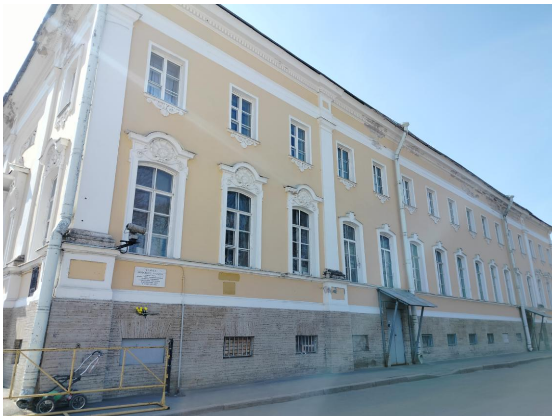
Фото 5. Фрагмент лицевого фасада объекта культурного наследия федерального значения «Дом Министерский Первый»
