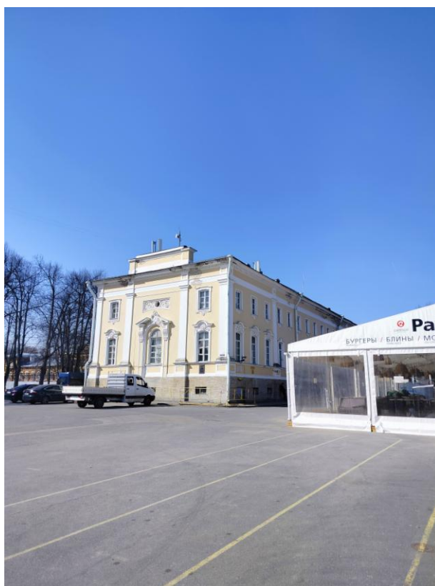
Фото 6. Лицевой фасад объекта культурного наследия федерального значения «Дом Министерский Первый»
