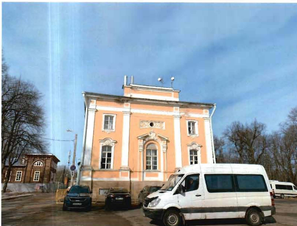
2. Вид на объект культурного наследия с восточной стороны.
