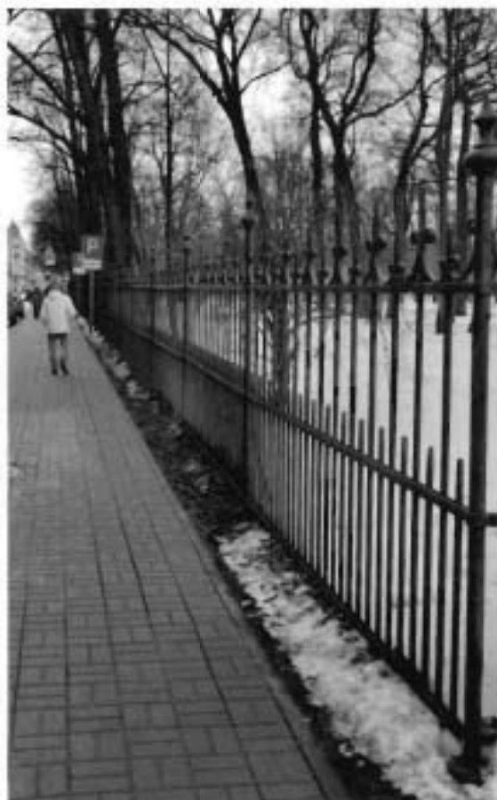
Фото 2: фрагмент объекта культурного наследия. Вид с севера (Таврическая ул.).
