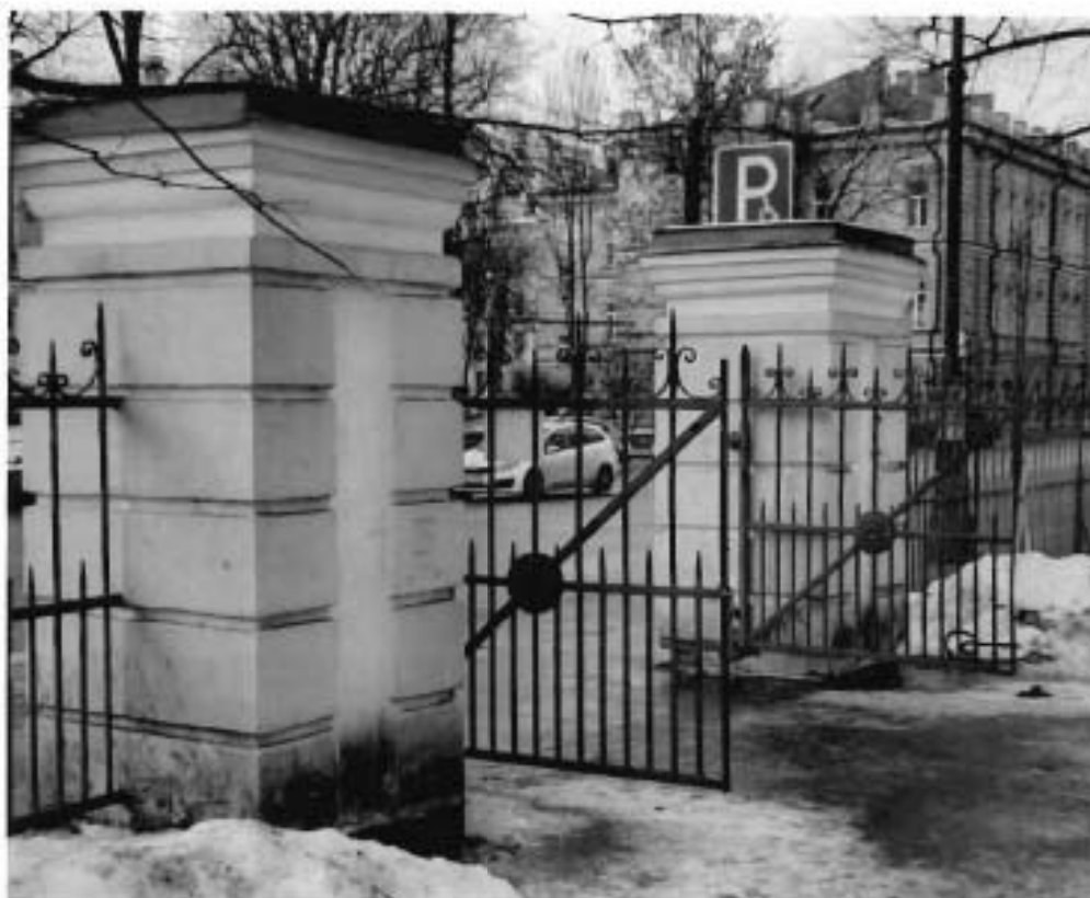
Фото 11: фрагмент объекта культурного наследия. Ворота по Кирочной ул. (Вид со стороны объекта культурного наследия федерального значения «Сад Таврический с прудом»).
