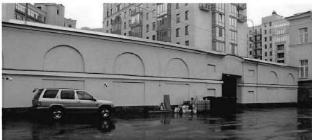
Фото №3. Восточный фрагмент. Вид со стороны сада.
