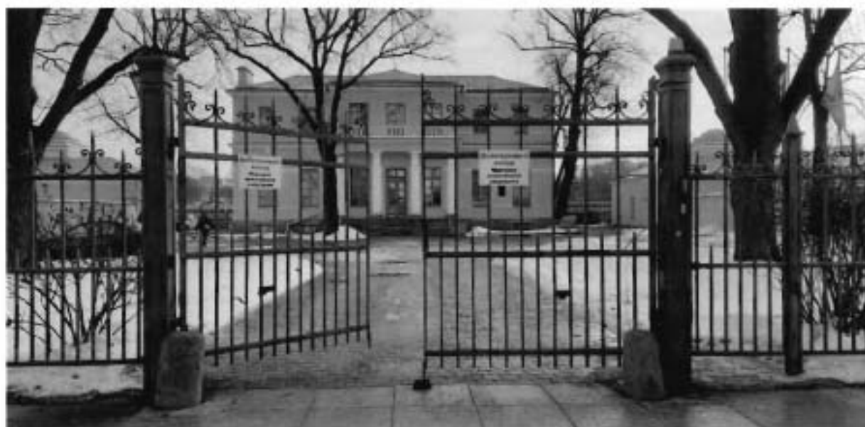
Фото 23: фрагмент объекта культурного наследия. Ворота и калитка по Потемкинской ул. (напротив объекта культурного наследия федерального значения «Дом садовника с двумя флигелями»). Гранитные колесоотбойные тумбы.
