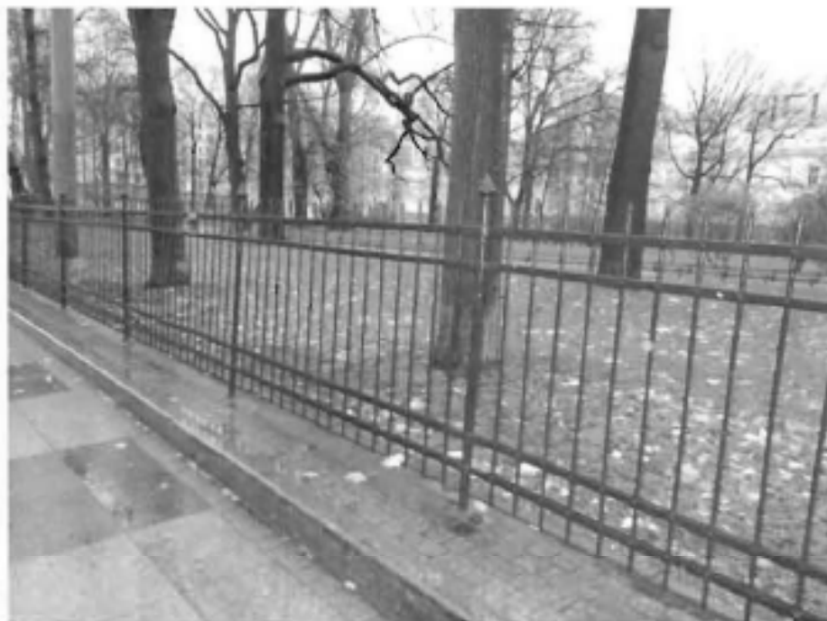
1. Вид со стороны ул. Кировская.
