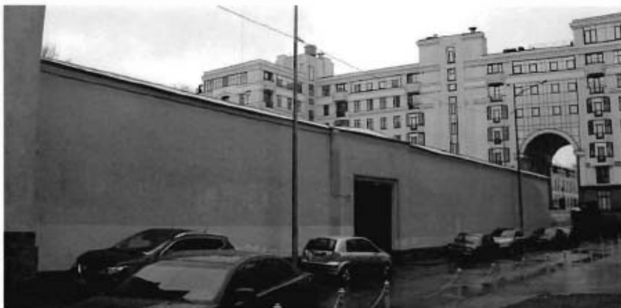
Фото №5. Восточный фрагмент. Вид со стороны внутриворотового проезда.
