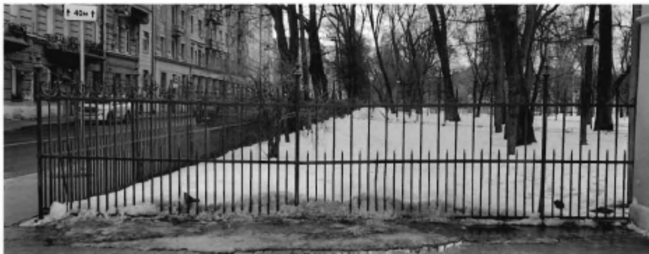
Фото 1: фрагмент объекта культурного наследия. Вид с севера (Таврическая ул.).
