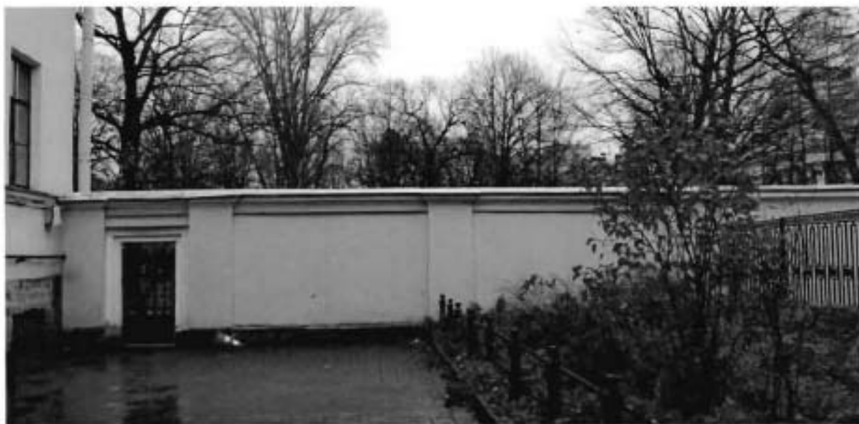
Фото №8. Фрагмент ограды с калиткой. Вид со стороны внутреннего двора.
