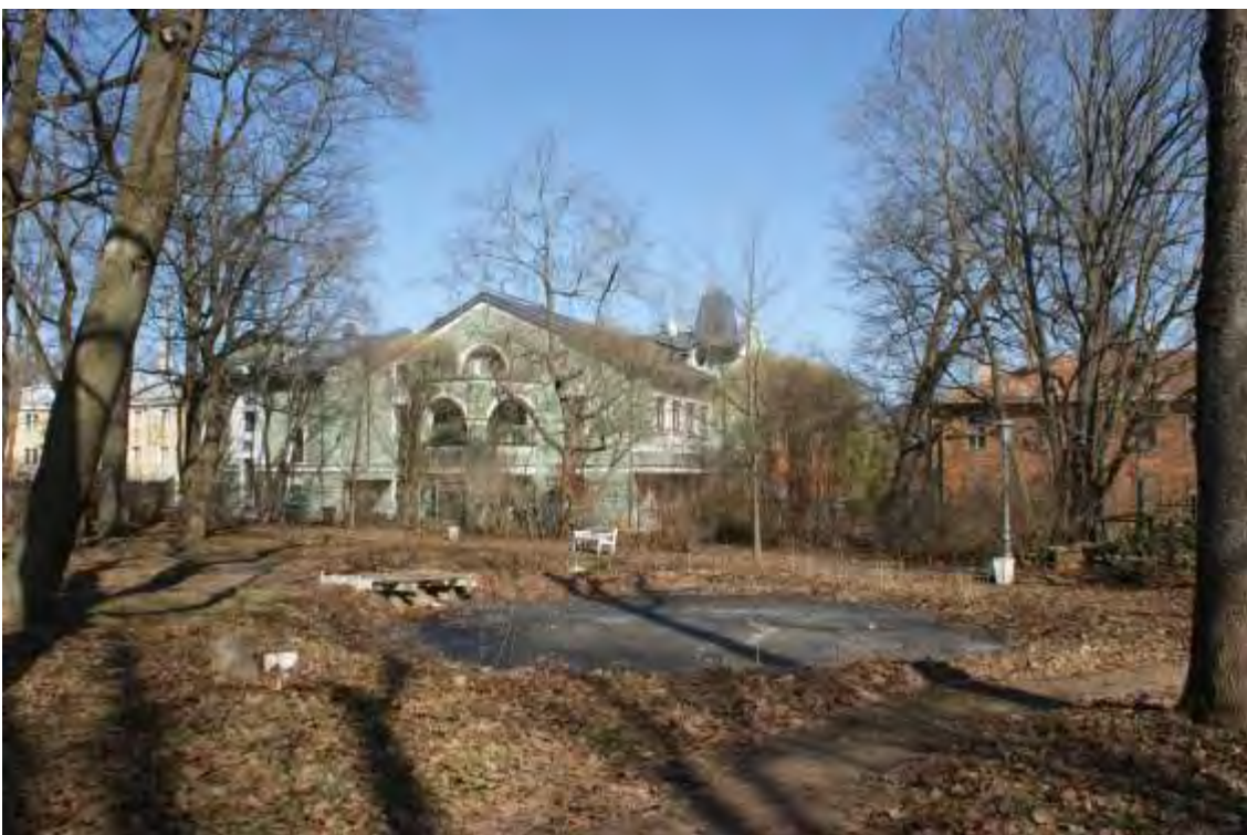
Фото 10. Выявленный объект культурного наследия «Усадьба Д. Кваренги (фундаменты построек, сад)». Вид на северо-восточную часть сада. Съемка 17.04.2023 г. Трушковский В.Э.
