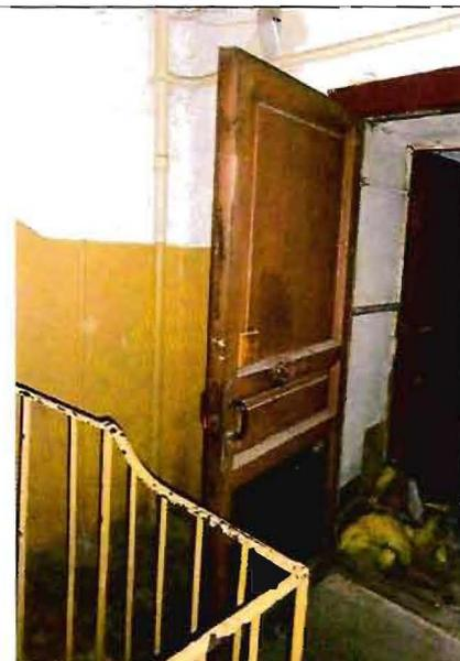
«чёрная» лестница - двухмаршевая, ступени из известняковой плиты, марши на металлических косоурах, площадки на сводах, ограждение из вертикальных металлических прутьев с деревянным поручнем; стены оштукатурены и окрашены
