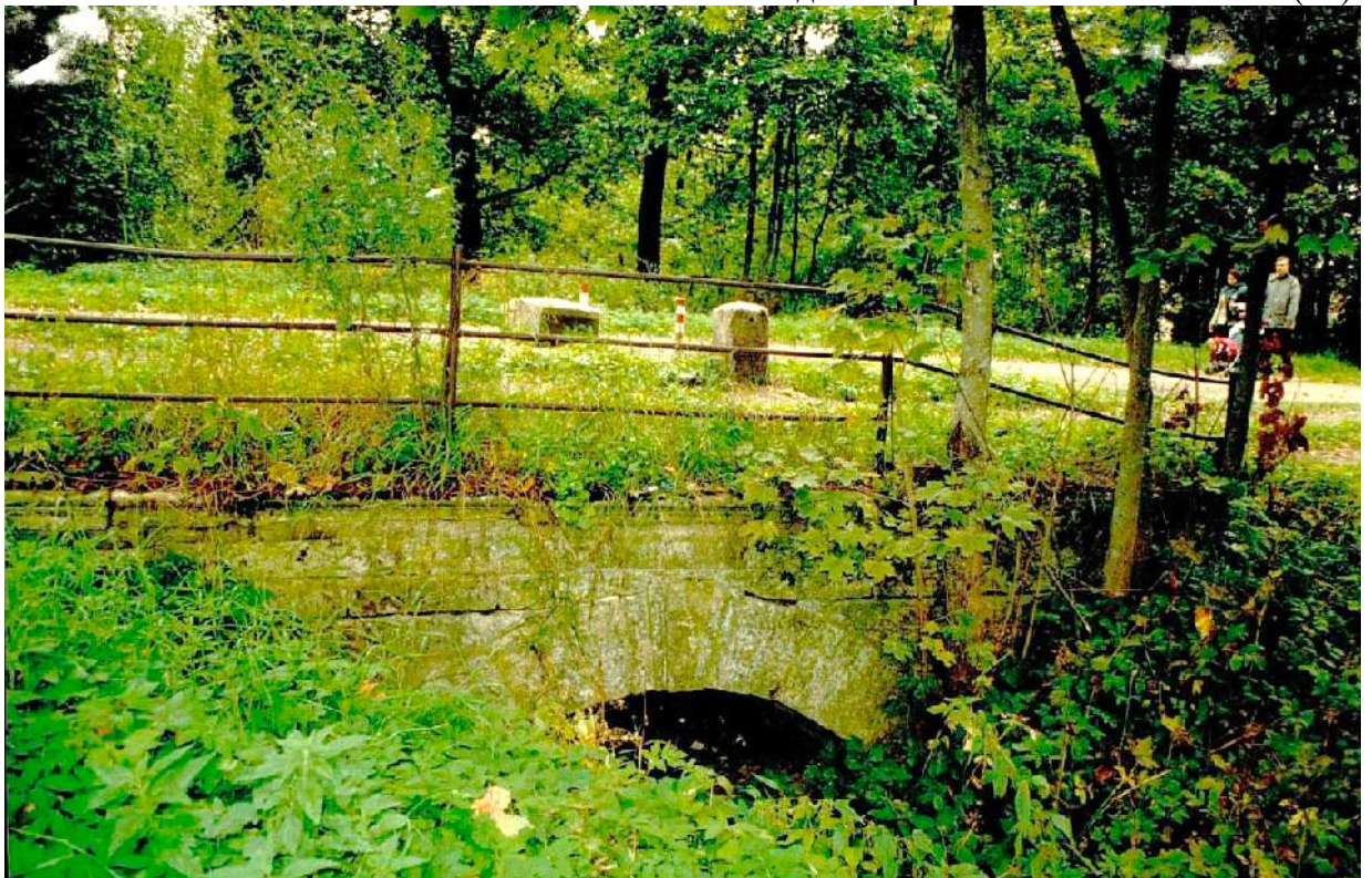
Илл. 24. Центральная часть парка. Каменный мост через ручей на Старопавловской дороге у Парковой ул. Вид с запада. Фото 2004 г. (38).
