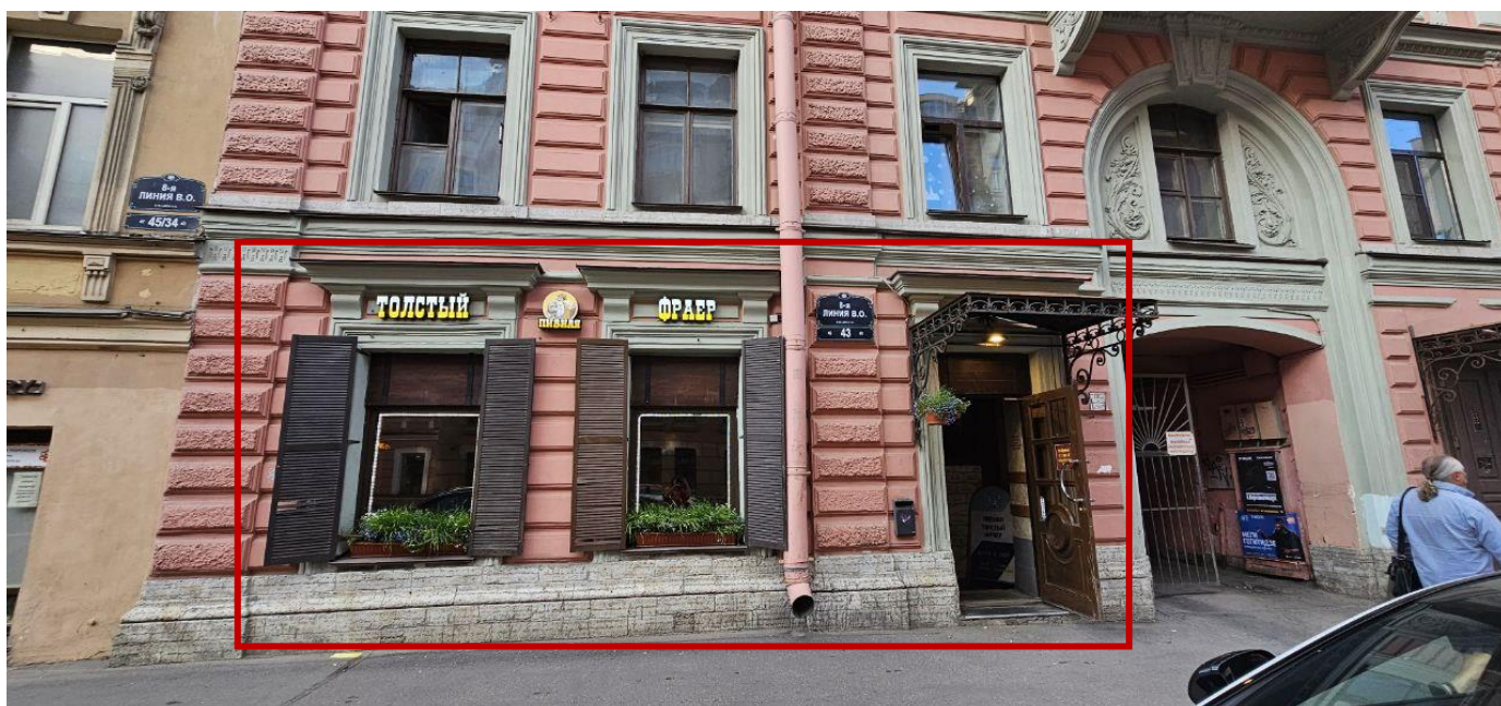
Фото 2. Общий вид на помещение 5-Н в границах лицевого фасада объекта культурного наследия регионального значения «Дом А.И. Кракау»
