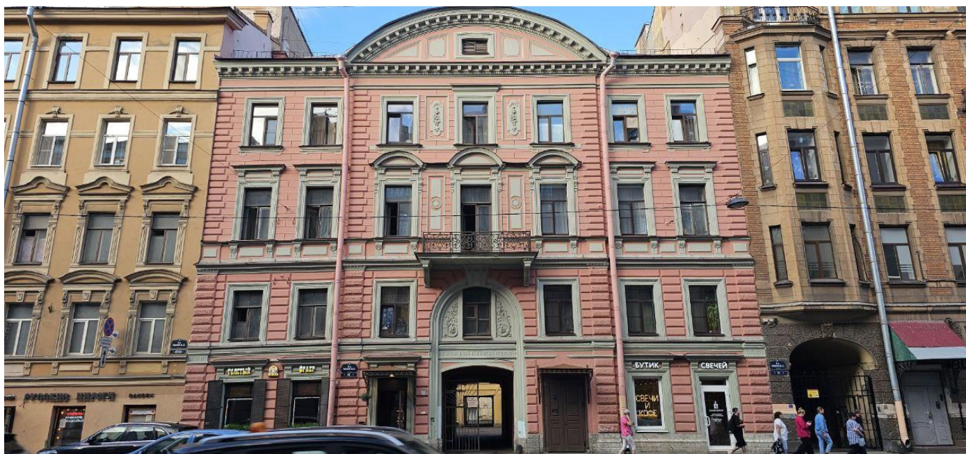
Фото 1. Лицевой фасад объекта культурного наследия регионального значения «Дом А.И. Кракау»
