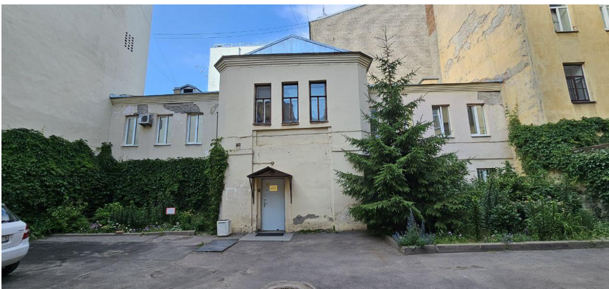
Фото 6. Общий вид дворового фасада (второй двор) объекта культурного наследия регионального значения «Дом А.И. Кракау».
