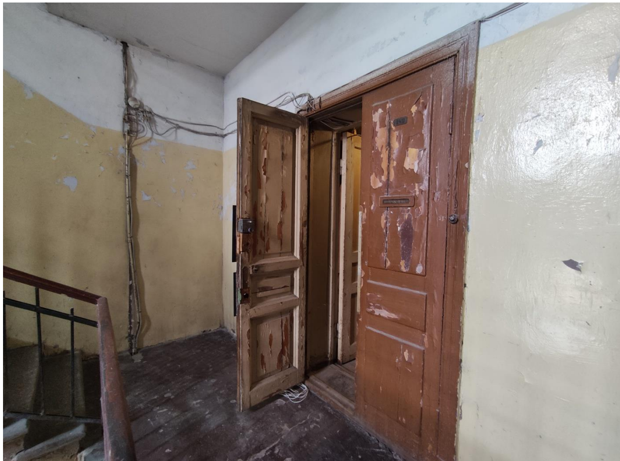
Фото 3. Вид на вход в квартиру №142 с лестничной клетки
