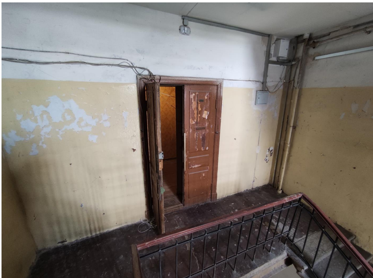
Фото 4. Вид на вход в квартиру №142 с лестничной клетки
