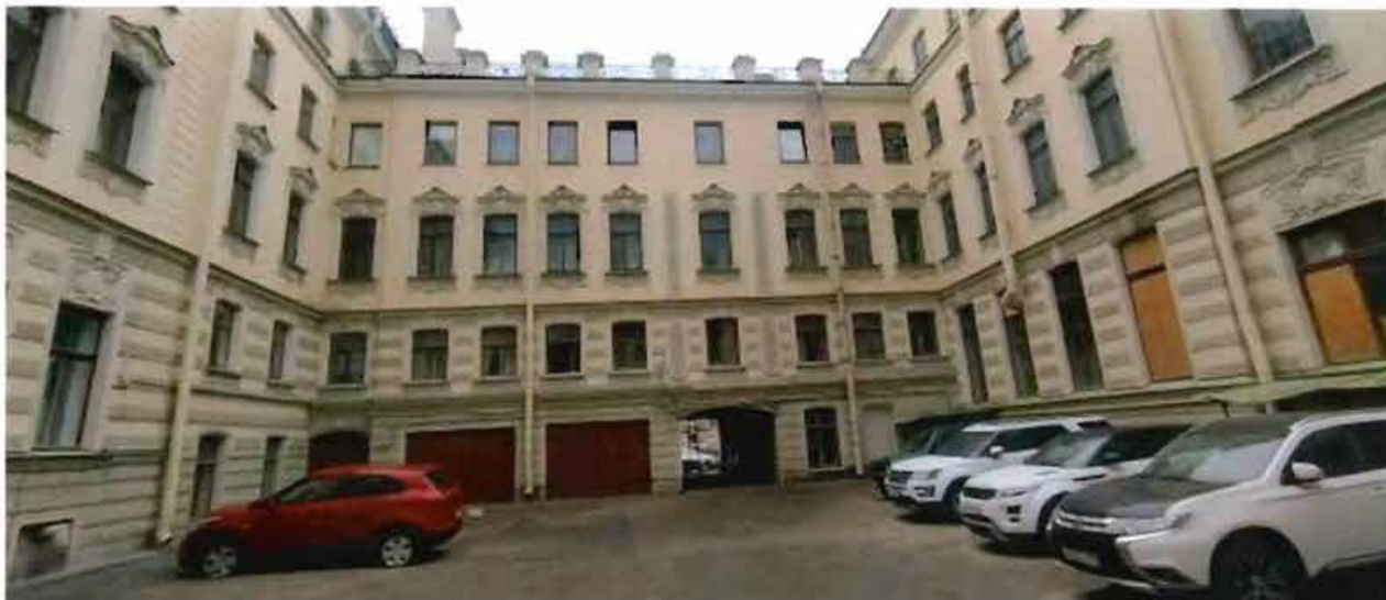
6. Общий вид на западный (дворовый) фасад объекта культурного наследия (16.04.2021 г.)
