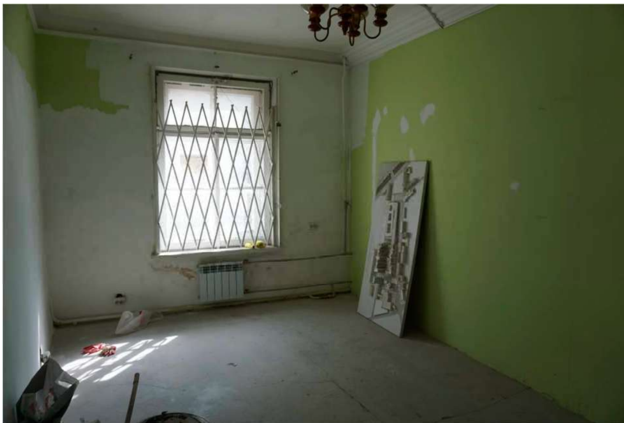
36. «Дом Половцова А.А. с дворовыми флигелями» - объект культурного наследия федерального значения по адресу: Санкт-Петербург, Большая Морская ул., 52, р.Мойки наб., 97
