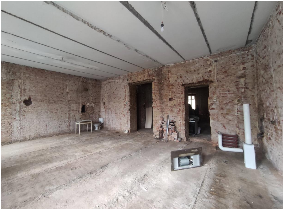
Фото 14. Объект культурного наследия регионального значения «Жилой дом», расположенный по адресу: Санкт-Петербург, улица Ефимова, дом 6, литера А. Общий вид пом. № 40(6,7).
