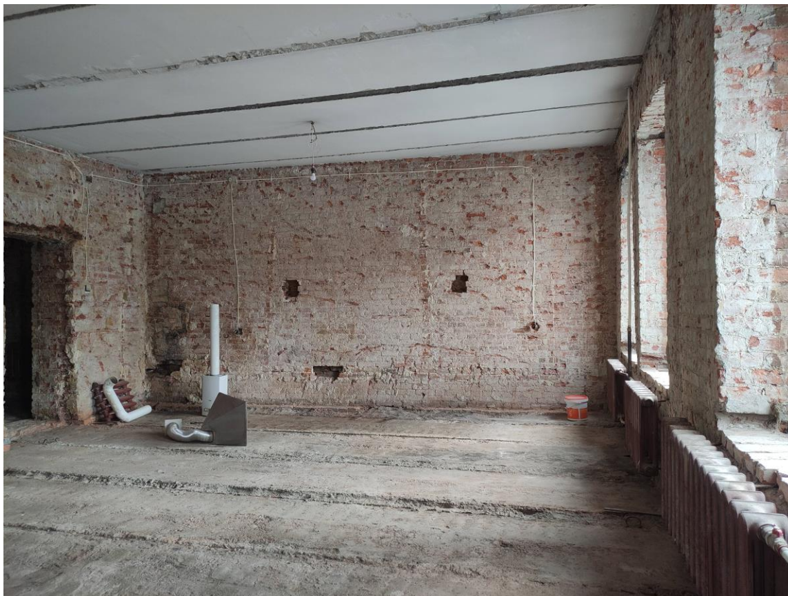
Фото 18. Объект культурного наследия регионального значения «Жилой дом», расположенный по адресу: Санкт-Петербург, улица Ефимова, дом 6, литера А. Общий вид пом. № 40(6,7).
