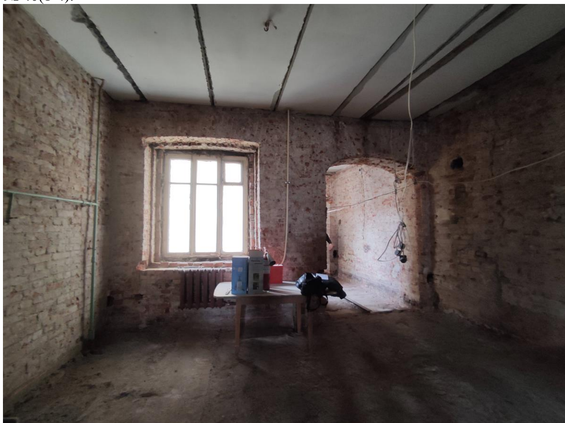
Фото 21. Объект культурного наследия регионального значения «Жилой дом», расположенный по адресу: Санкт-Петербург, улица Ефимова, дом 6, литера А. Общий вид пом. № 40(1-4).
