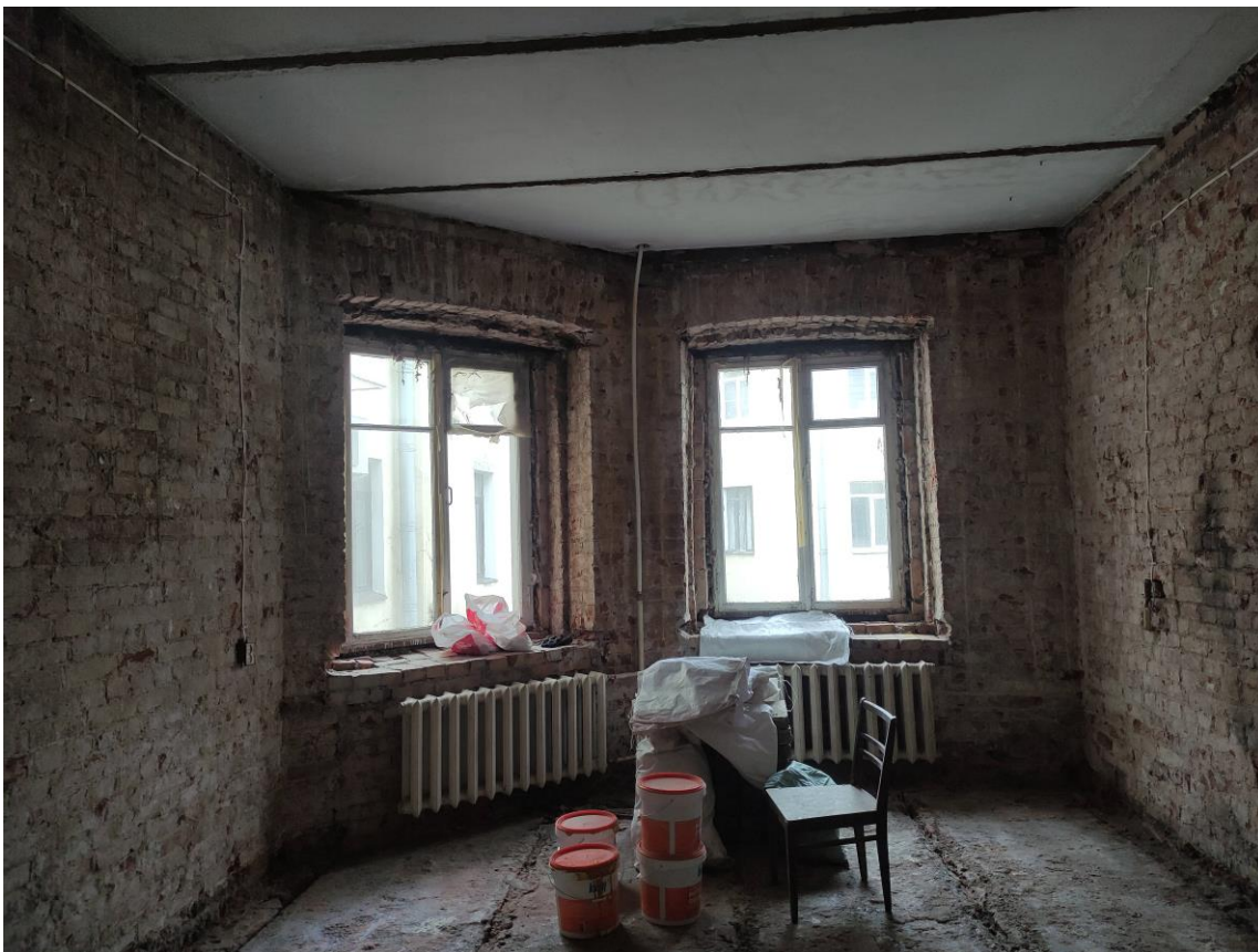
Фото 34. Объект культурного наследия регионального значения «Жилой дом», расположенный по адресу: Санкт-Петербург, улица Ефимова, дом 6, литера А. Общий вид пом. № 40(5).
