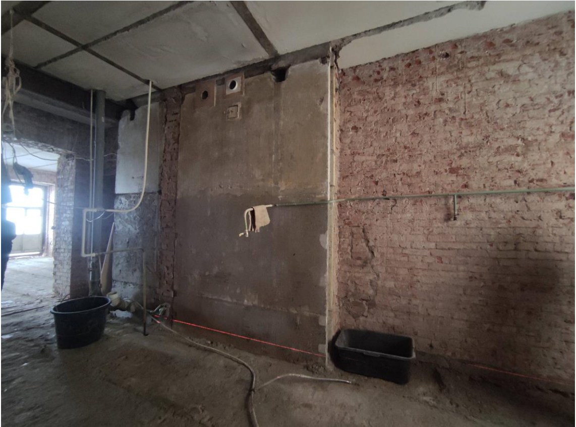
Фото 22. Объект культурного наследия регионального значения «Жилой дом», расположенный по адресу: Санкт-Петербург, улица Ефимова, дом 6, литера А. Общий вид пом. № 40(1-4).
