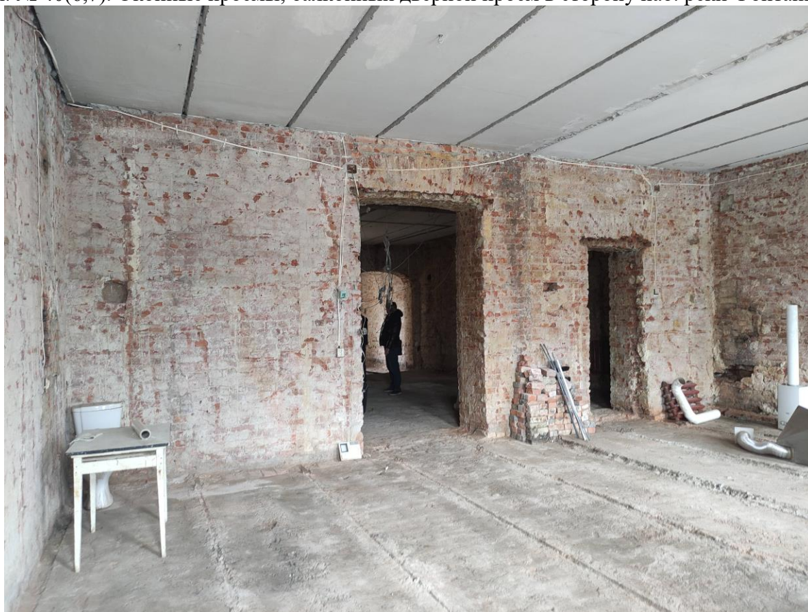
Фото 13. Объект культурного наследия регионального значения «Жилой дом», расположенный по адресу: Санкт-Петербург, улица Ефимова, дом 6, литера А. Общий вид пом. № 40(6,7).
