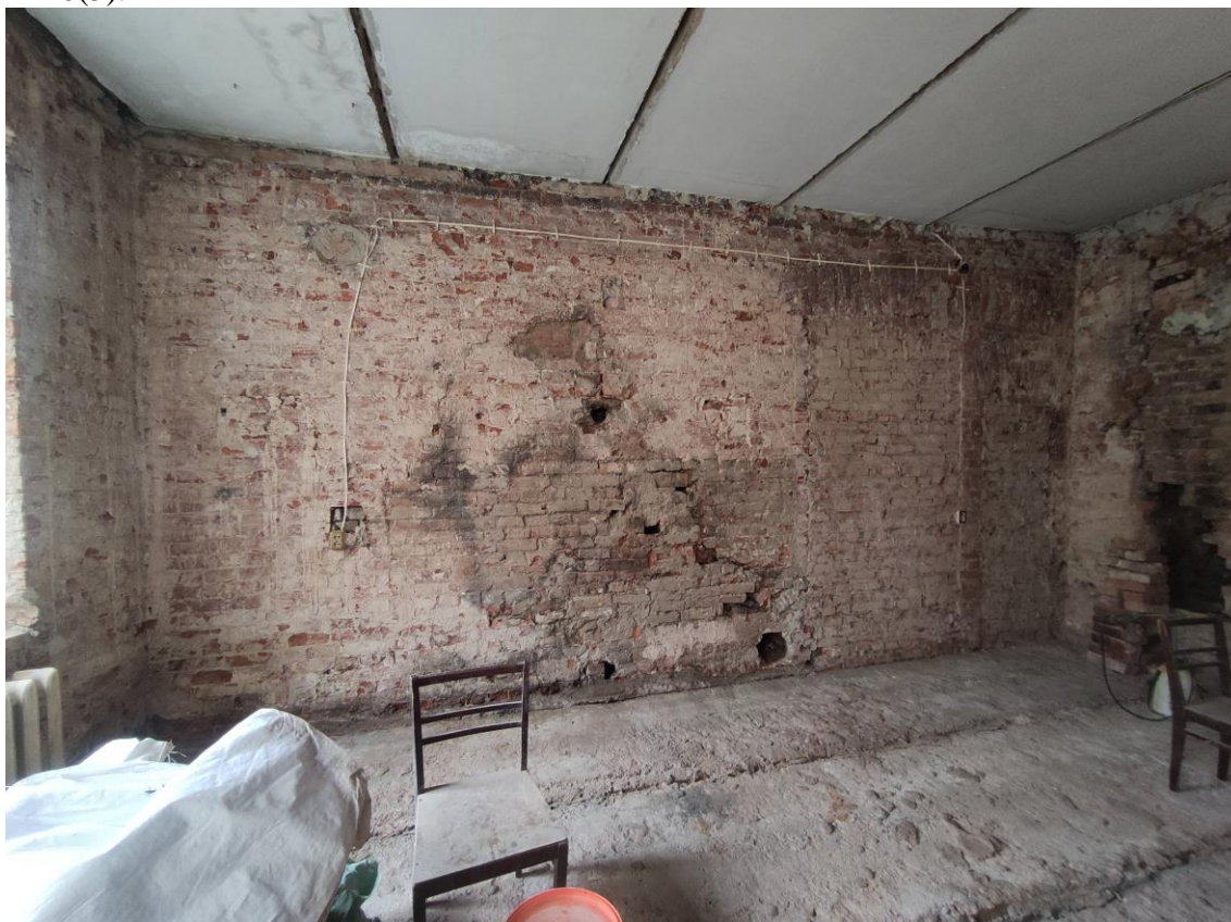
Фото 41. Объект культурного наследия регионального значения «Жилой дом», расположенный по адресу: Санкт-Петербург, улица Ефимова, дом 6, литера А. Общий вид пом. № 40(5).
