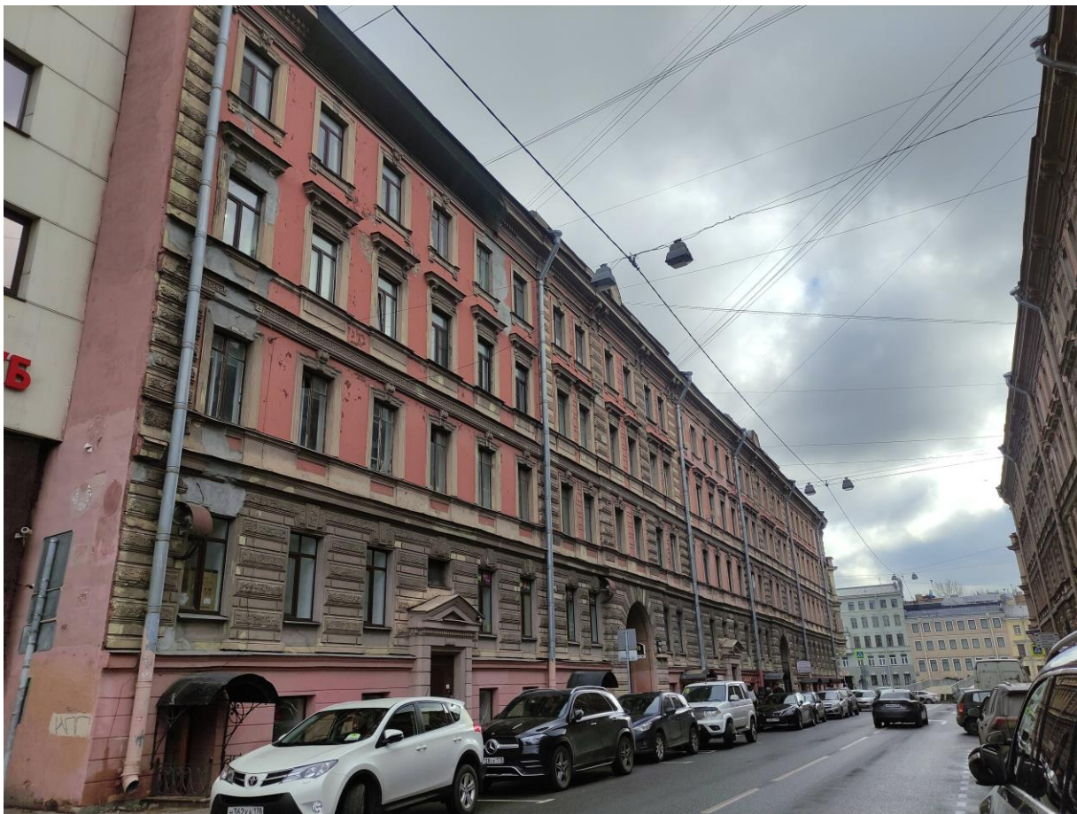
Фото 5. Объект культурного наследия регионального значения «Жилой дом», расположенный по адресу: Санкт-Петербург, улица Ефимова, дом 6, литера А. Общий вид лицевого фасада по ул. Ефимова.
