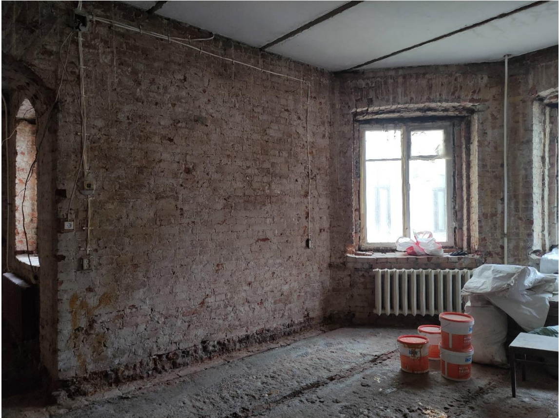
Фото 36. Объект культурного наследия регионального значения «Жилой дом», расположенный по адресу: Санкт-Петербург, улица Ефимова, дом 6, литера А. Общий вид пом. № 40(5).
