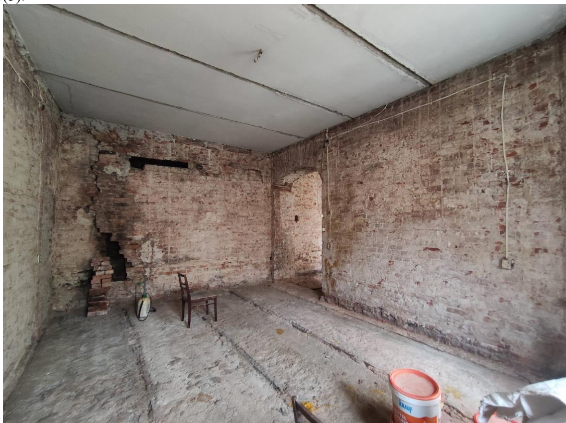
Фото 39. Объект культурного наследия регионального значения «Жилой дом», расположенный по адресу: Санкт-Петербург, улица Ефимова, дом 6, литера А. Общий вид пом. № 40(5).
