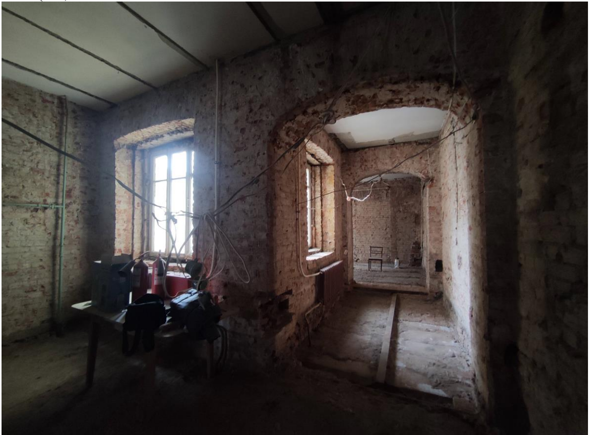
Фото 23. Объект культурного наследия регионального значения «Жилой дом», расположенный по адресу: Санкт-Петербург, улица Ефимова, дом 6, литера А. Общий вид пом. № 40(1-4).
