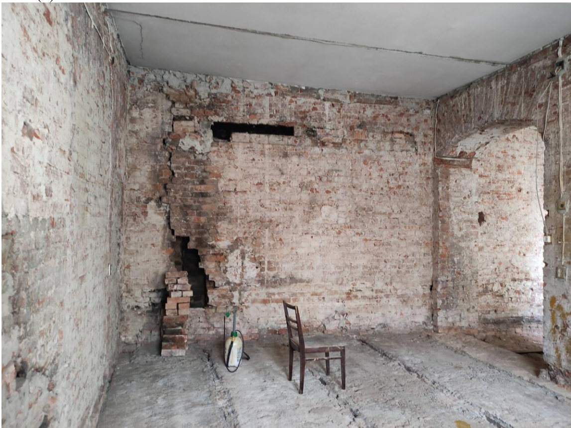
Фото 37. Объект культурного наследия регионального значения «Жилой дом», расположенный по адресу: Санкт-Петербург, улица Ефимова, дом 6, литера А. Общий вид пом. № 40(5).
