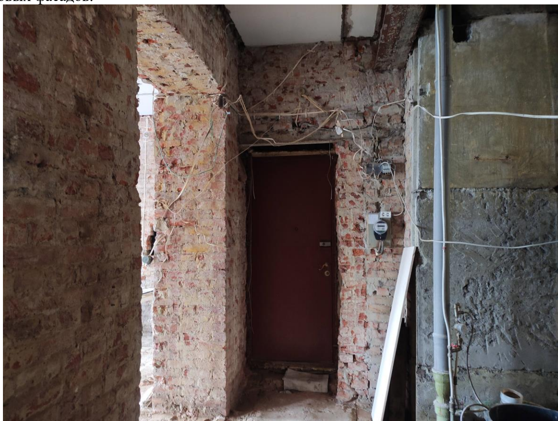
Фото 11. Объект культурного наследия регионального значения «Жилой дом», расположенный по адресу: Санкт-Петербург, улица Ефимова, дом 6, литера А. Фрагмент пом. № 40(1-4). Входной дверной проем с лестницы.
