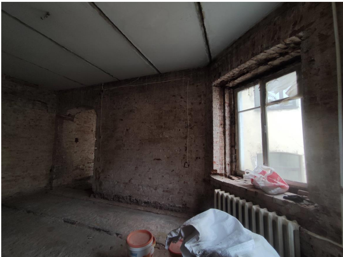
Фото 40. Объект культурного наследия регионального значения «Жилой дом», расположенный по адресу: Санкт-Петербург, улица Ефимова, дом 6, литера А. Общий вид пом. № 40(5).
