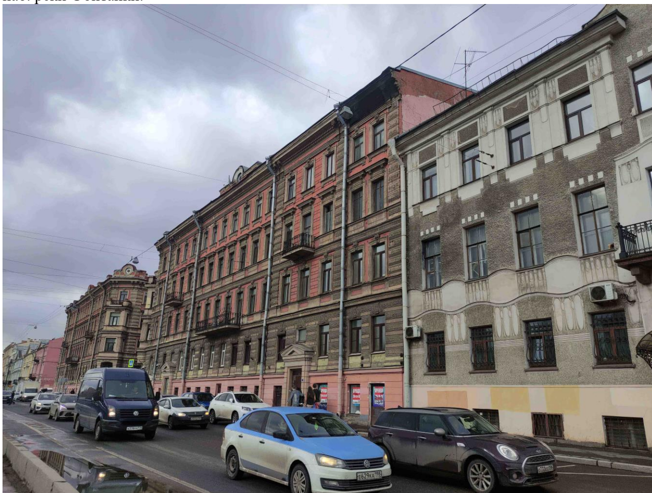
Фото 4. Объект культурного наследия регионального значения «Жилой дом», расположенный по адресу: Санкт-Петербург, улица Ефимова, дом 6, литера А. Общий вид лицевого фасада по наб. реки Фонтанки.
