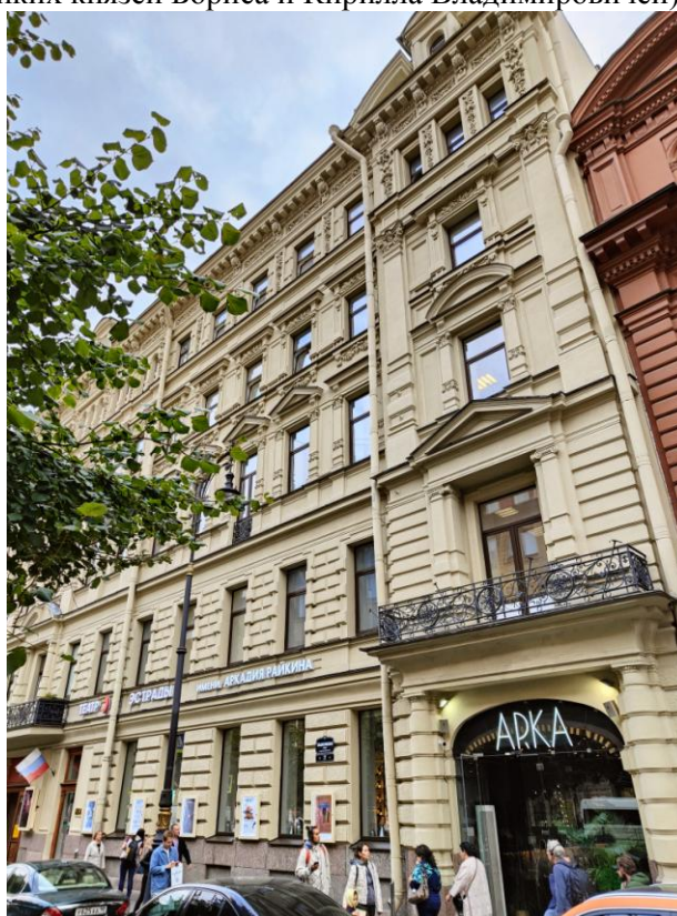
Фото 2. Фрагмент лицевого фасада объекта культурного наследия регионального значения «Дом по Большой Конюшенной ул. с флигелями», входящего в состав ансамбля «Доходные дома фон Дервиза П.П. (великих князей Бориса и Кирилла Владимировичей)» (с Большой Конюшенной ул.)
