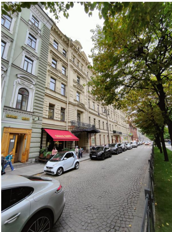
Фото 3. Фрагмент лицевого фасада объекта культурного наследия регионального значения «Дом по Большой Конюшенной ул. с флигелями», входящего в состав ансамбля «Доходные дома фон Дервиза П.П. (великих князей Бориса и Кирилла Владимировичей)» (с Большой Конюшенной ул.)
