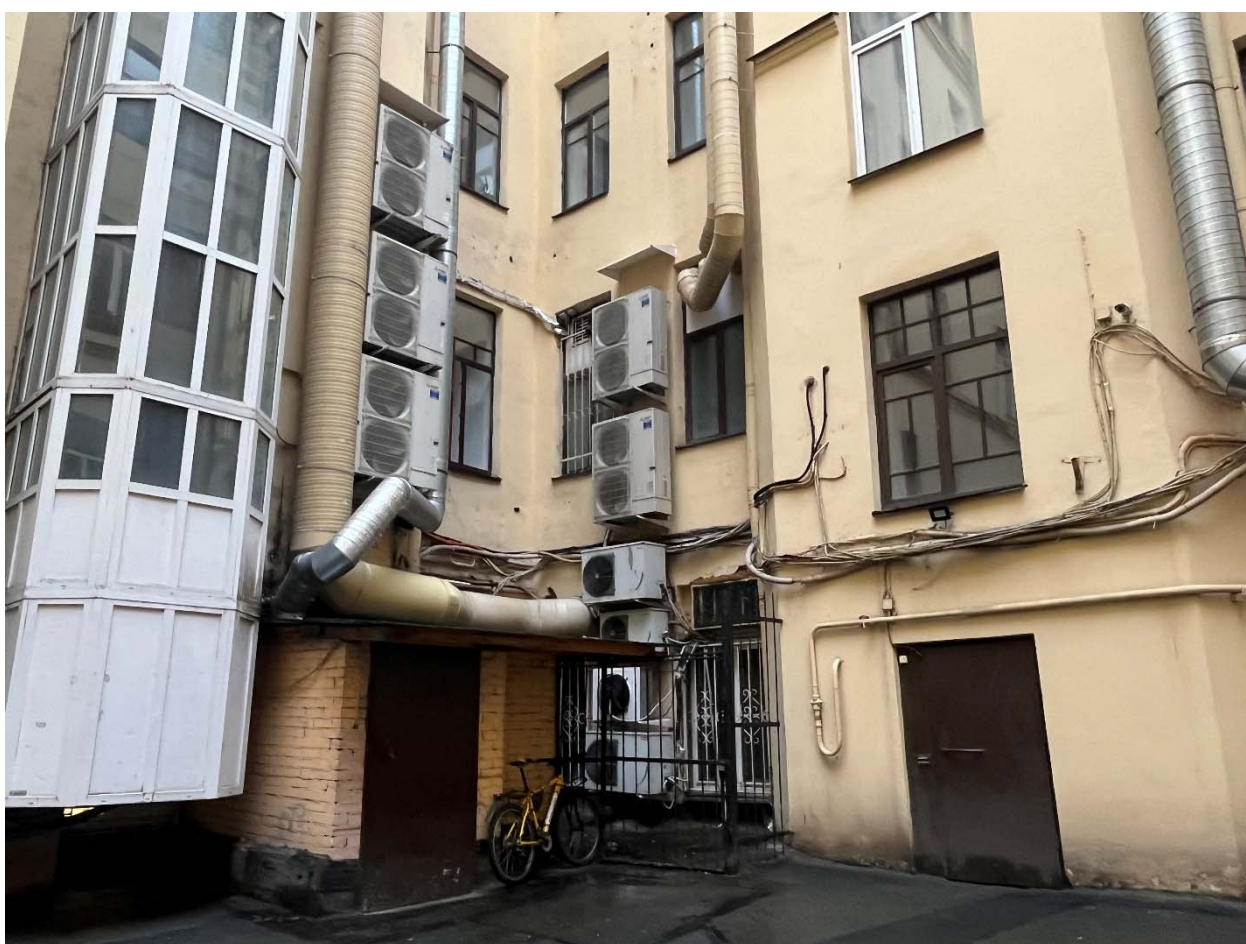
Фото №7. Южный и восточный дворовые фасады, оборудование.
