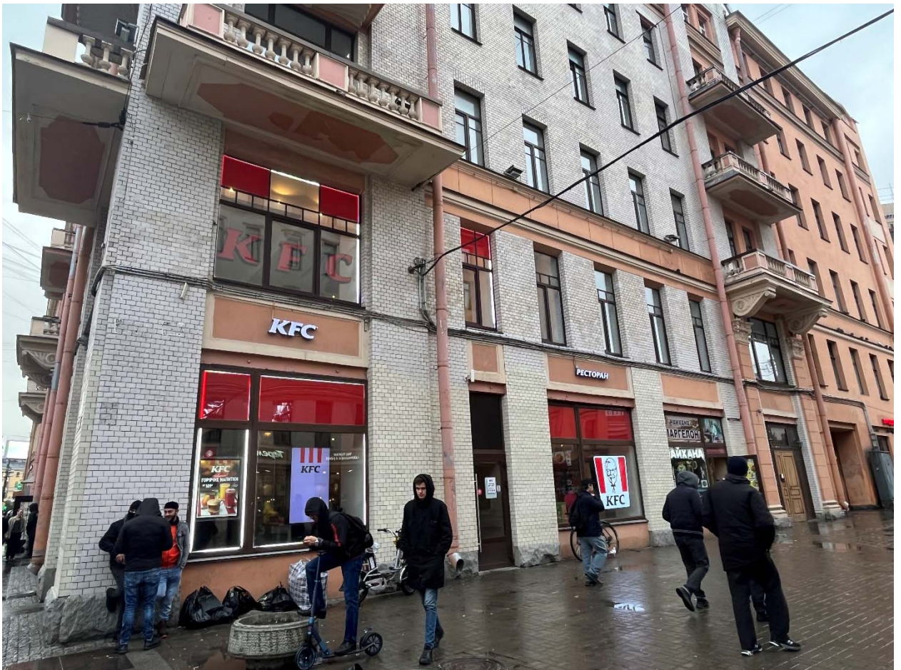
Фото №4. Северный лицевые фасады.
