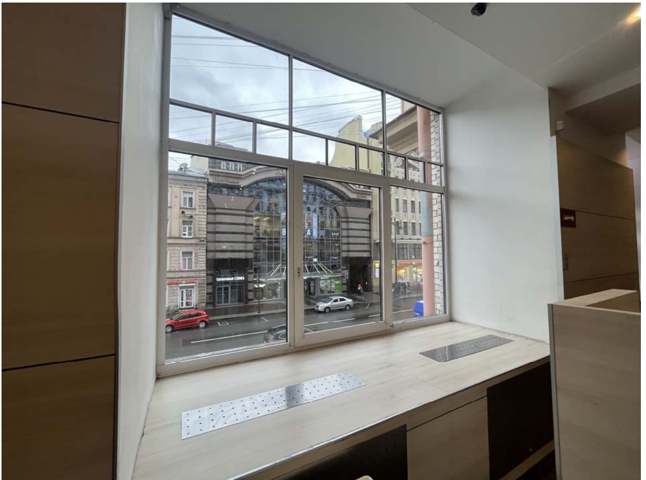
Фото №18. Второй этаж, торговый зал, оконное заполнение.
