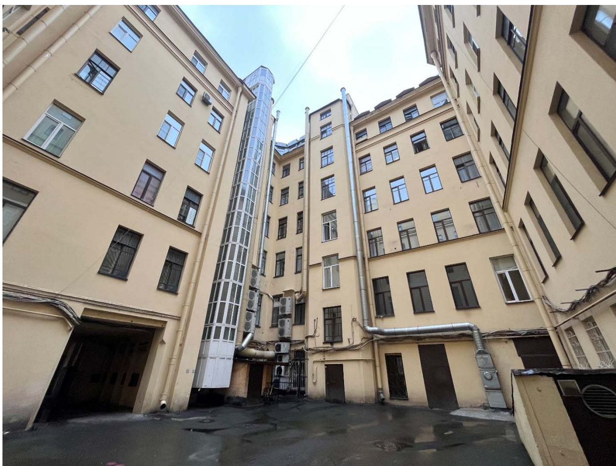
Фото №6. Южный и восточный дворовые фасады.
