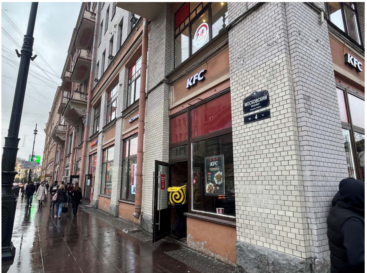
Фото №5. Северный лицевые фасады.
