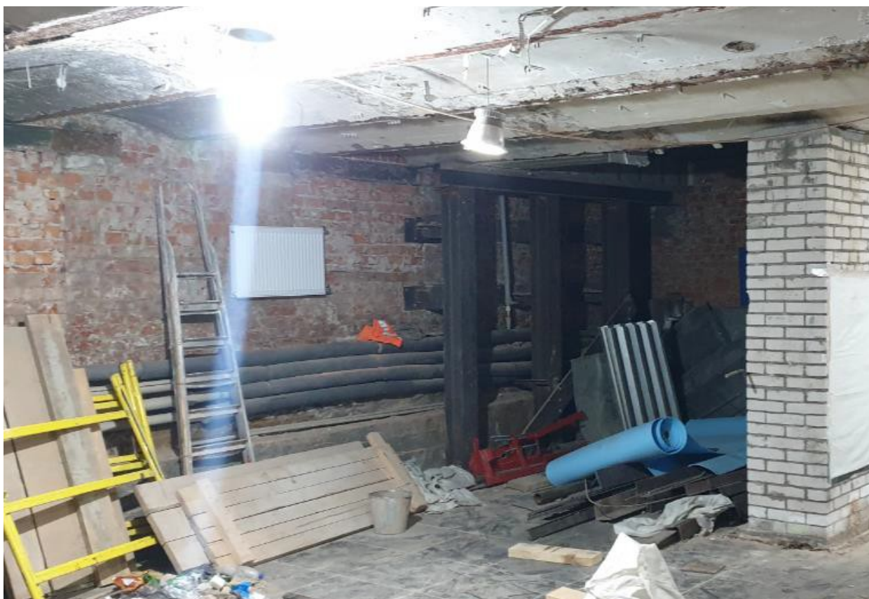
Фото 15 – Помещение подвала в осях А-В/10-11
