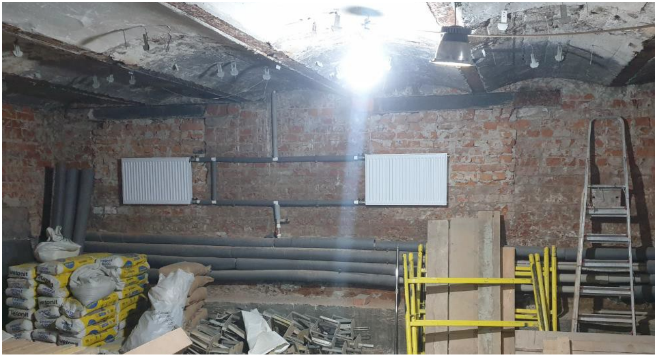
Фото 13 – Помещение подвала в осях Г/10-11
