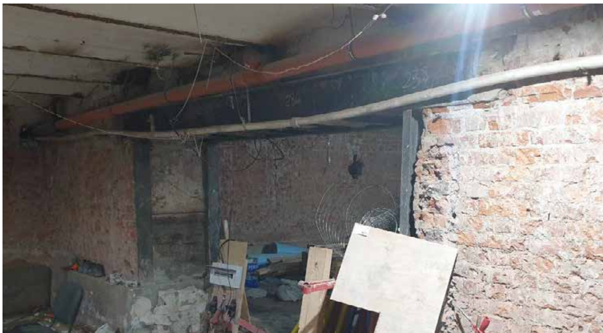
Фото 12 – Помещение подвала в осях В/10-11
