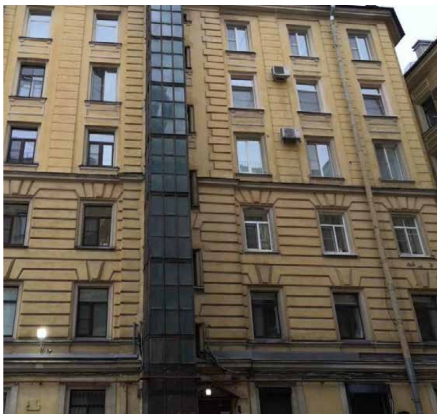
Фото 2 – Фрагмент дворового фасада
