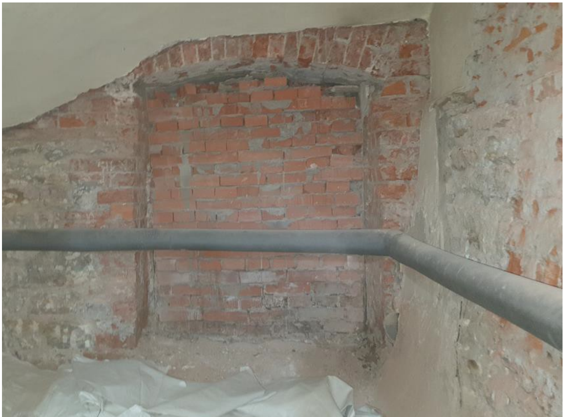
Фото 10 – Помещение подвала в осях Г/10-11
