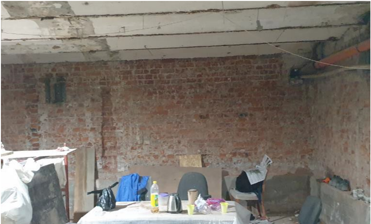
Фото 11 – Помещение подвала в осях В-Г/10
