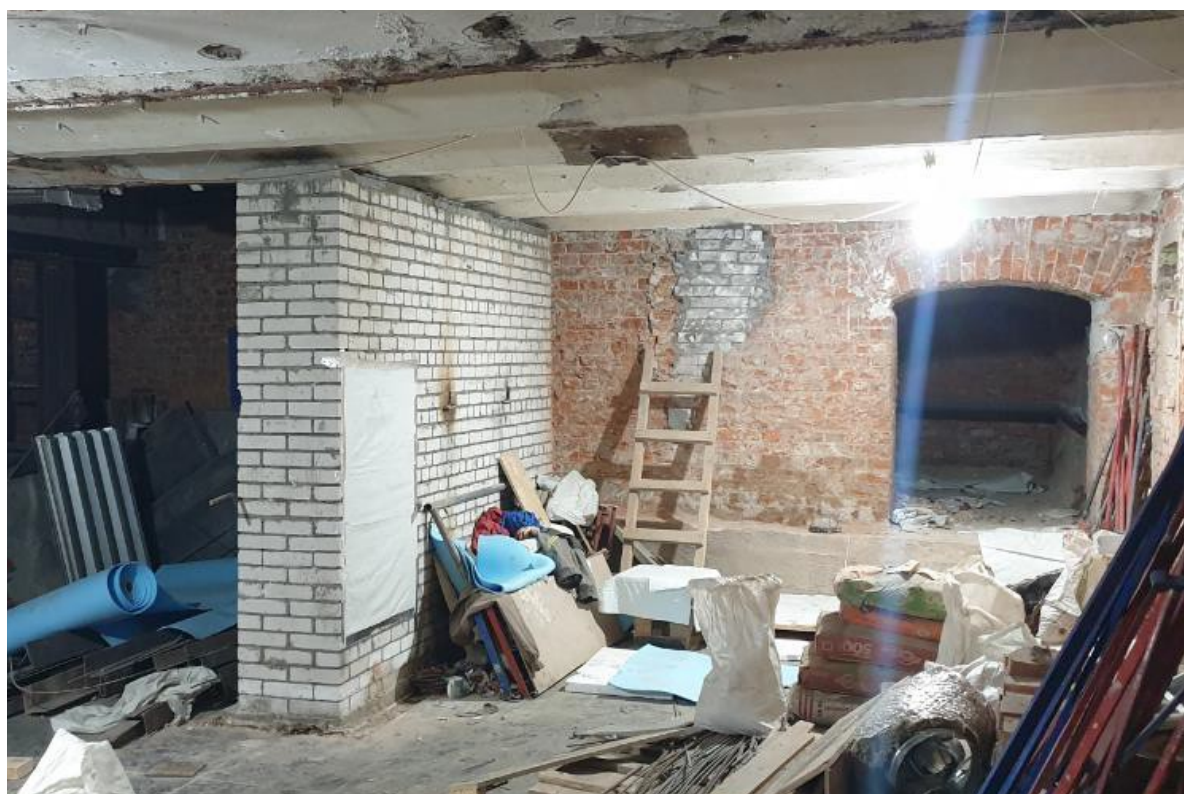
Фото 8 – Помещение подвала в осях А-В/10-11
