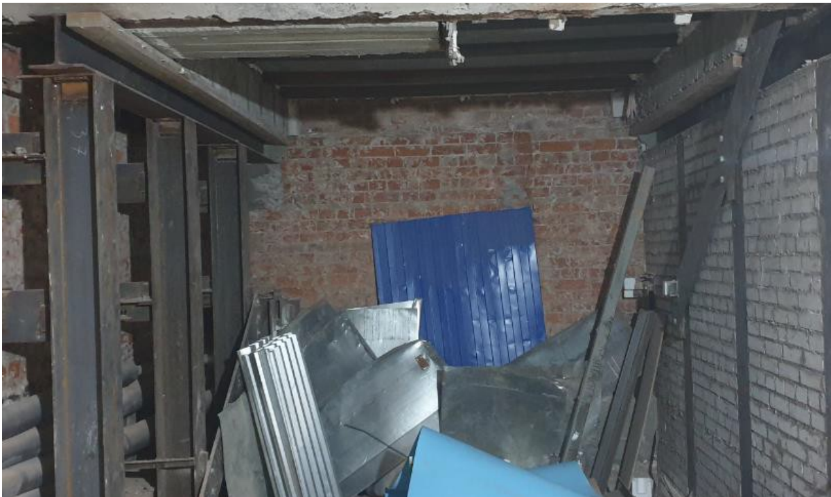
Фото 18 – Помещение подвала в осях А-Б/10-11
