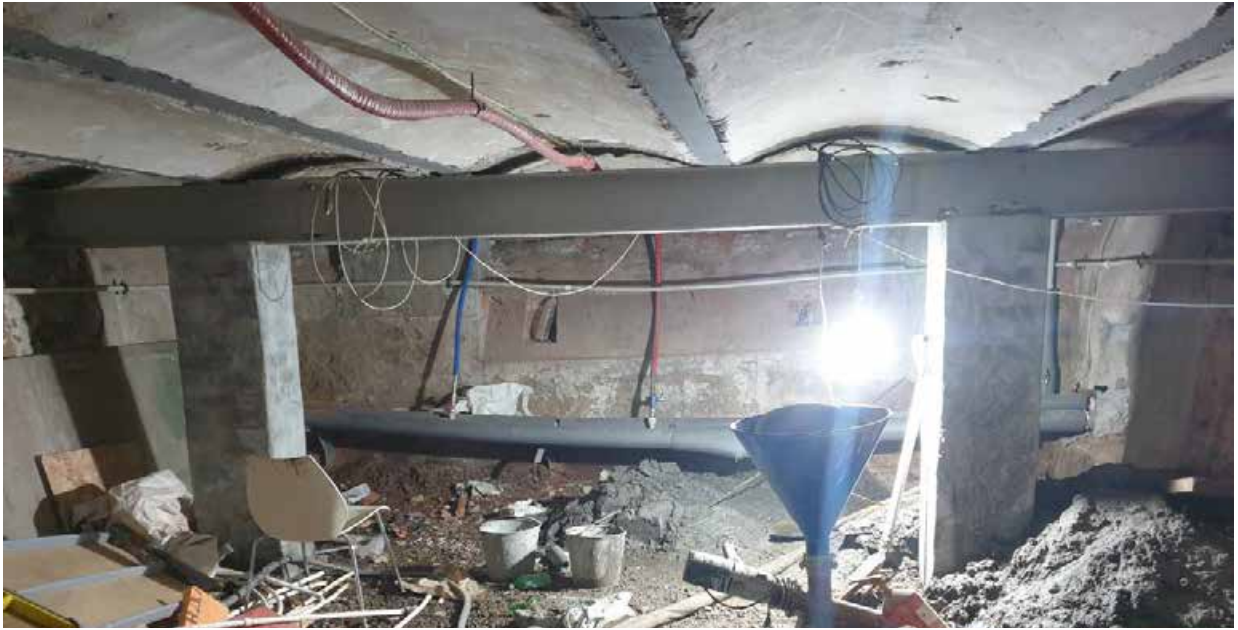
Фото 9 – Помещение подвала в осях А/11-12
