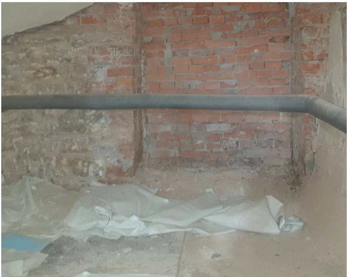
Фото 20 – Помещение подвала в осях Г/10-11
