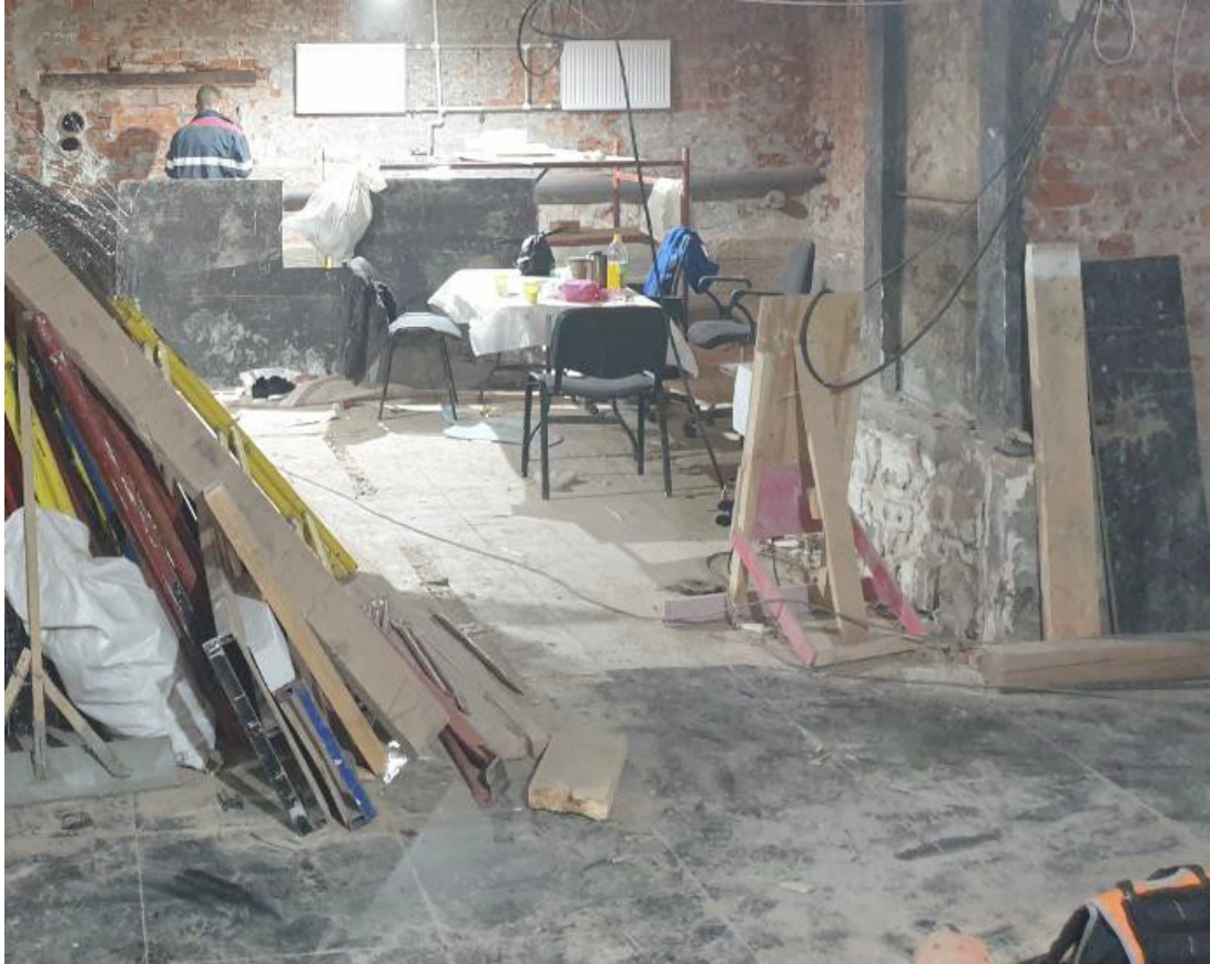
Фото 21 – Помещение подвала в осях А-Г/10-11
