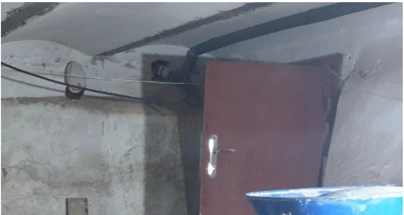
Фото 14 – Помещение подвала в осях А-В/12
