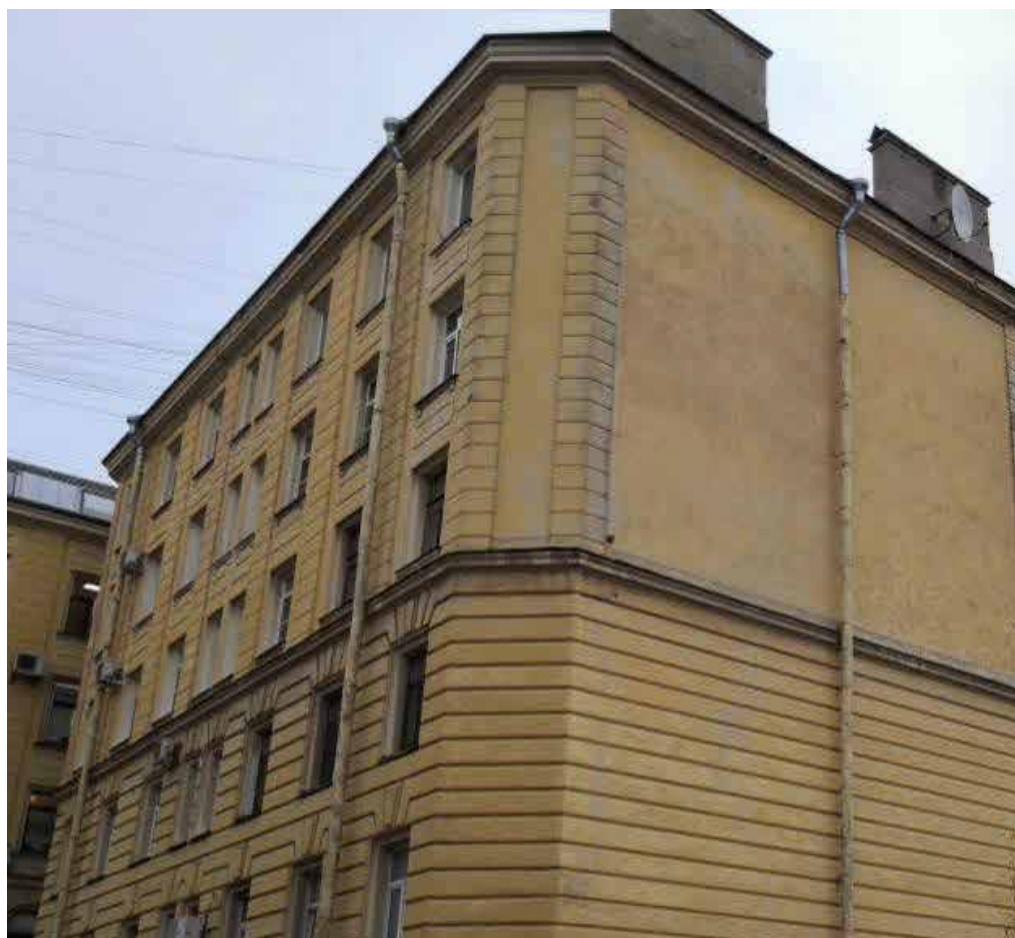
Фото 4 – Фрагмент дворового фасада здания
