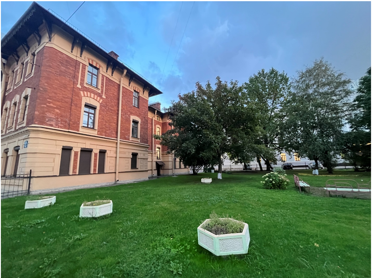
Фото №4. Юго-западный фасад здания и прилегающая территория.
