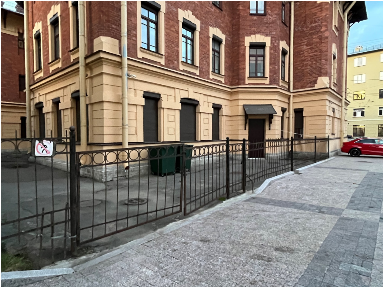
Фото.№9. Юго-восточный фасад здания (фрагмент), ограждение территории, ворота с калиткой.
