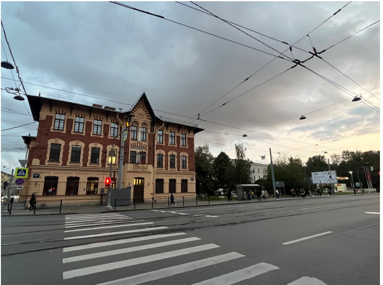
Фото.№2. Северо-западный фасад здания.
