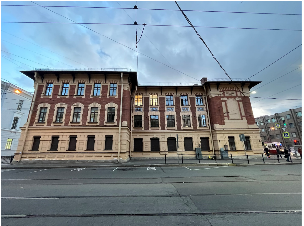
Фото №12. Северо-западный фасад здания.
