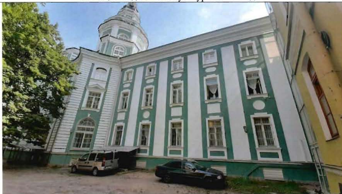
2. Фрагмент дворового фасада корпуса по Университетской набережной
