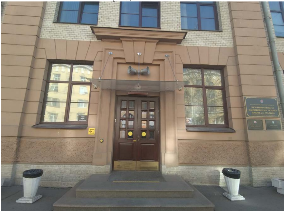
4. Выявленный объект культурного наследия «Здание ремесленного училища Русского технического общества при Петроградском Металлическом заводе». Фрагмент лицевого фасада. 01.09.2023
