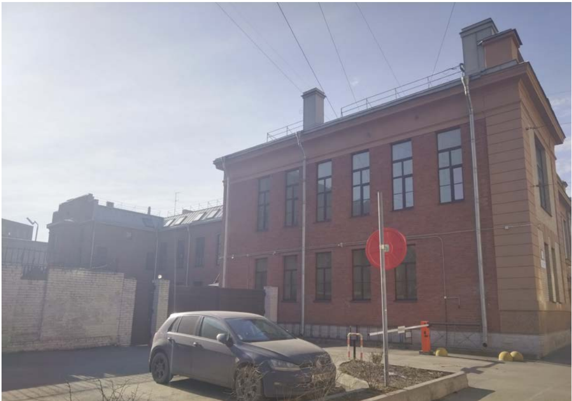
1. Выявленный объект культурного наследия «Здание ремесленного училища Русского технического общества при Петроградском Металлическом заводе». Вид с севера. 01.09.2023
