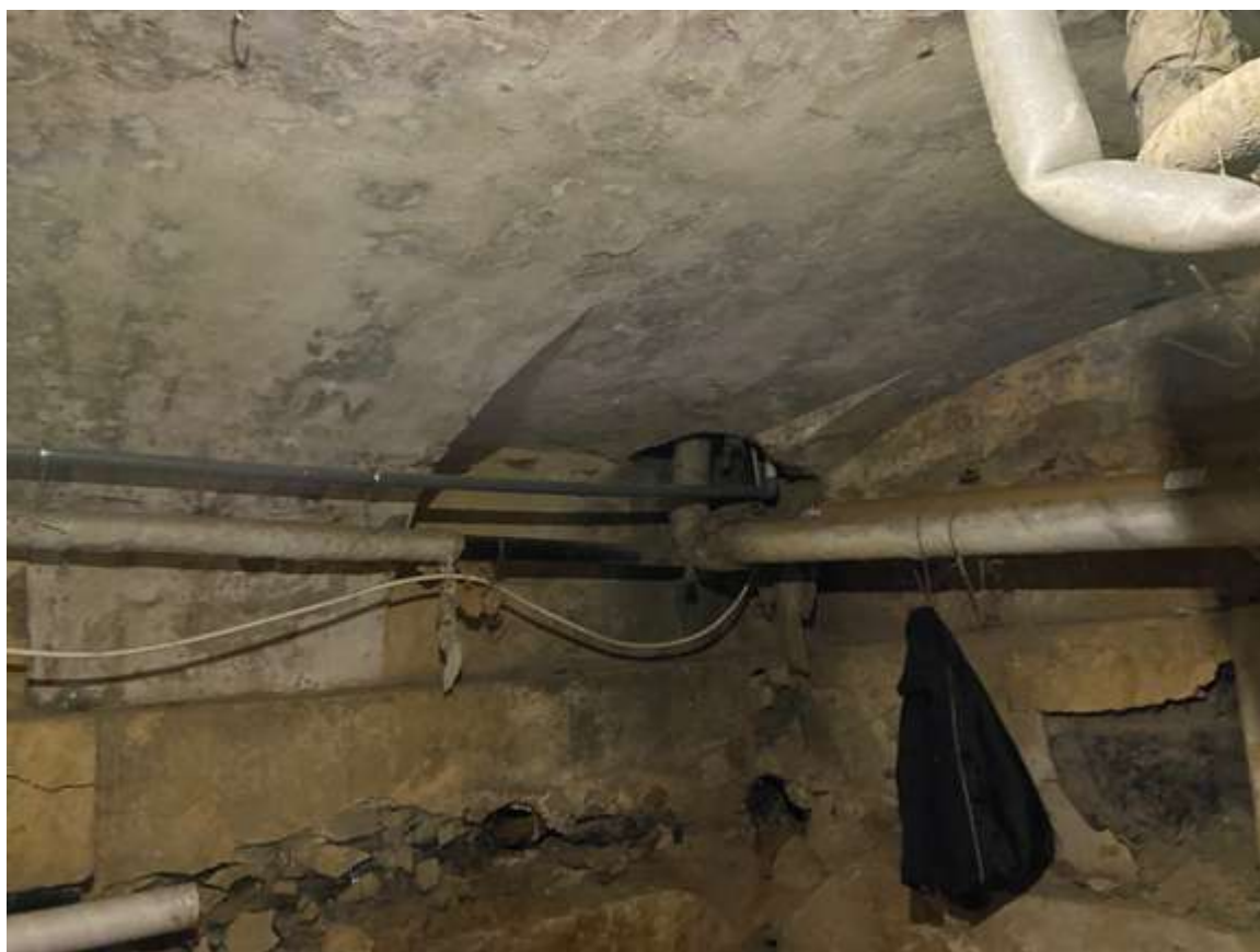
90. Фрагмент интеръера подвала
