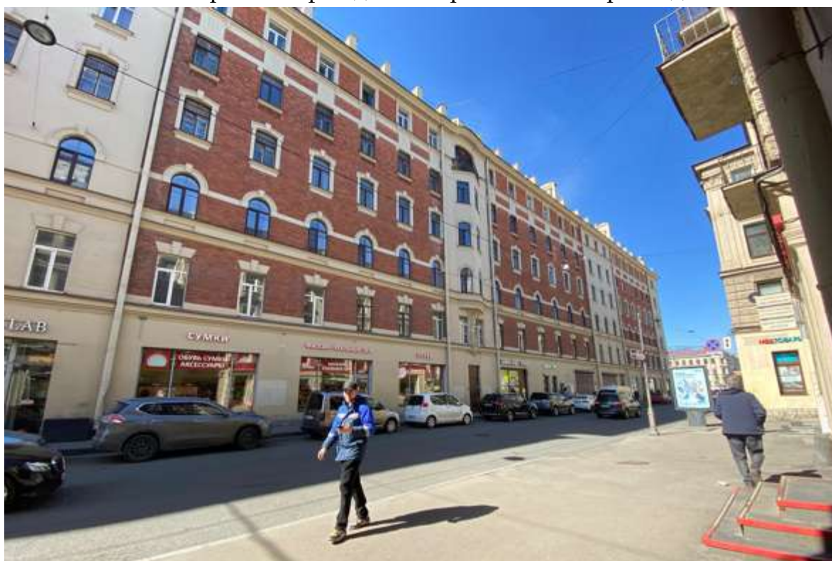
17. Фрагмент фасада со стороны переулка Гривцова
