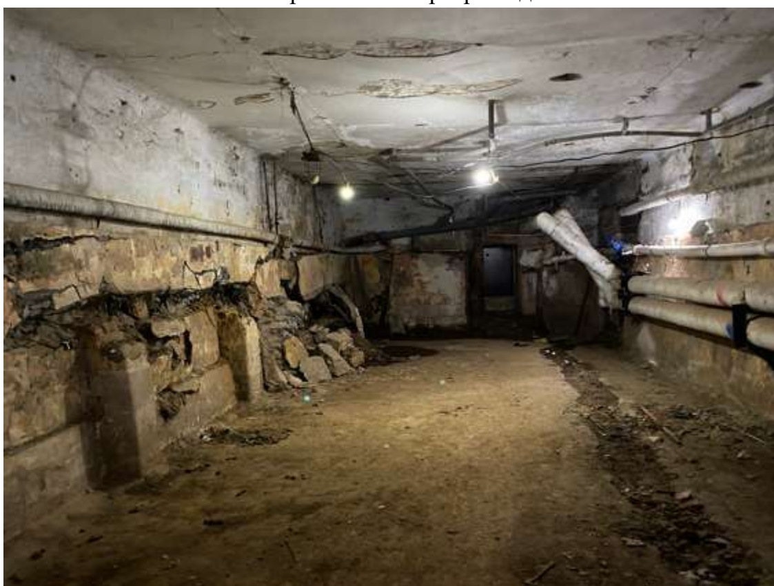
91. Фрагмент интеръера подвала
