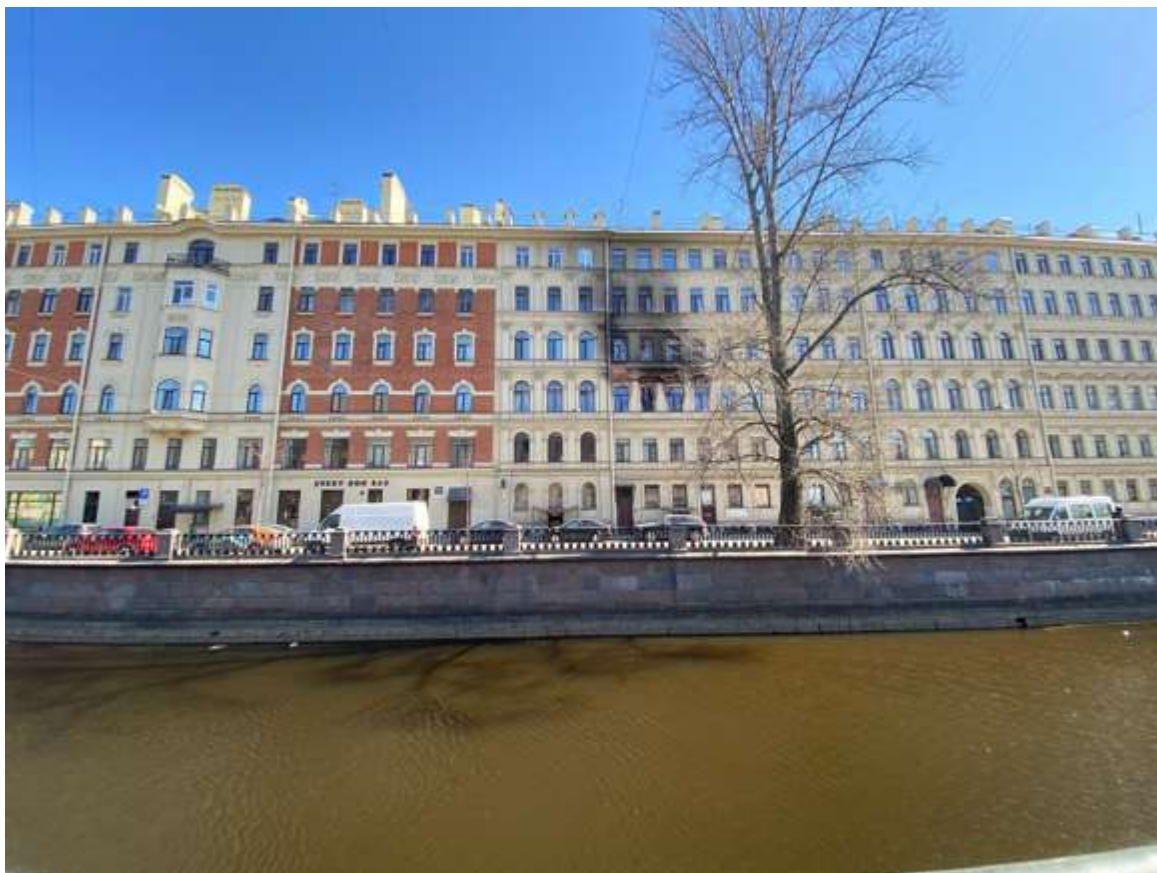
22. Фрагмент фасада со стороны канала Грибоедова
