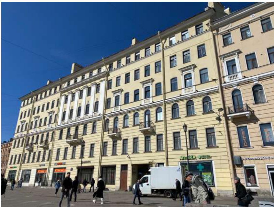
3. Фасад со стороны Сенной площади
