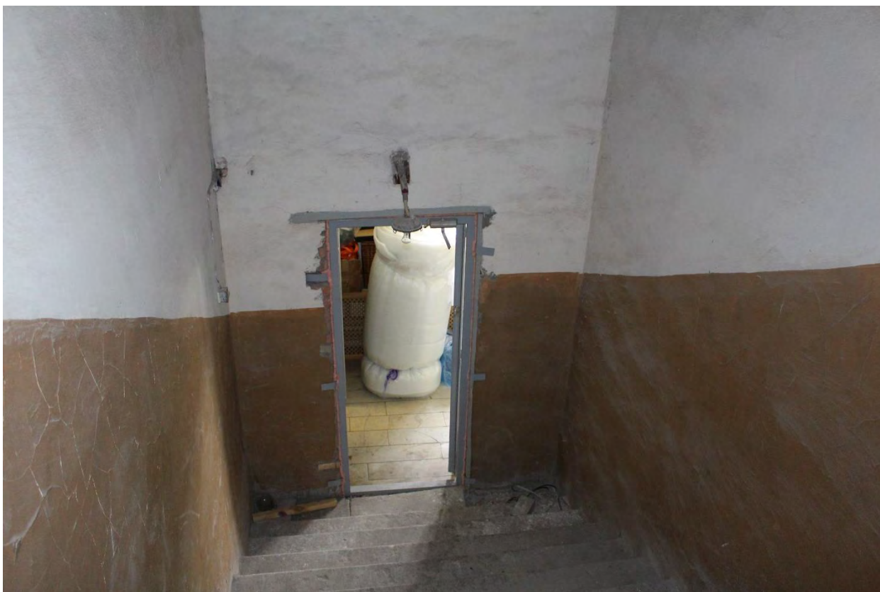
Фото 84. Выход в чердачные помещения лицевого корпуса выявленного объекта культурного наследия «Манеж и конюшни лейб-гвардии Гренадерского полка (здание тира лейб-гвардии Стрелкового батальона)». Фото 22.05.2023 г.
