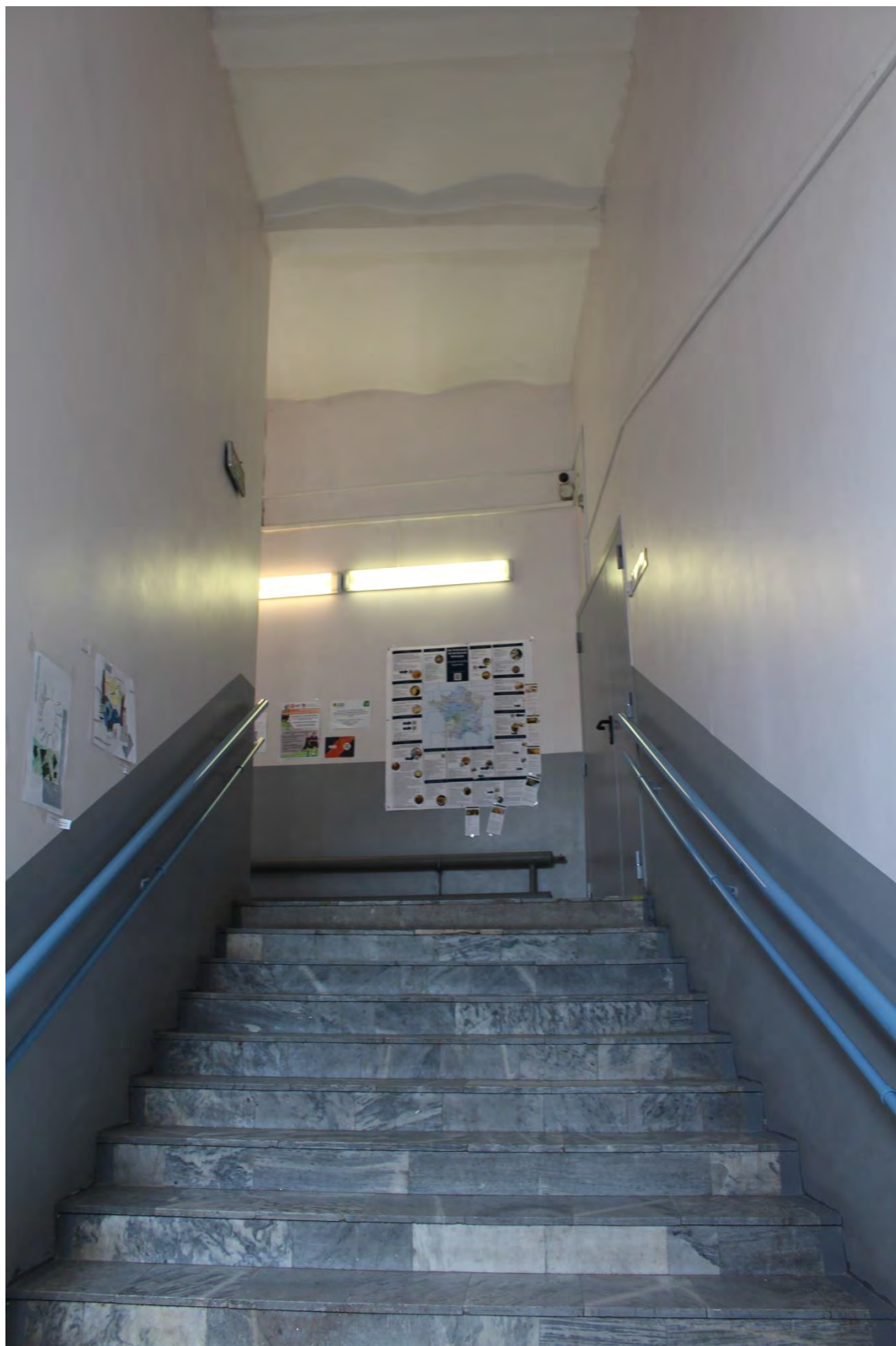
Фото 41. Вид на северо-восточную лестничную клетку лицевого корпуса выявленного объекта культурного наследия «Манеж и конюшни лейб-гвардии Гренадерского полка (здание тира лейб-гвардии Стрелкового батальона)». Фото 22.05.2023 г.
