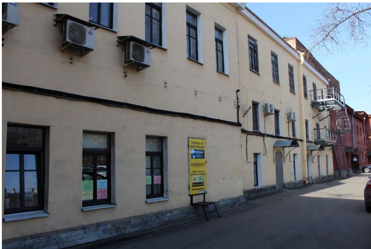
Фото 15. Вид на северо-западный (дворовый) фасад лицевого корпуса выявленного объекта культурного наследия «Манеж и конюшни лейб-гвардии Гренадерского полка (здание тира лейб-гвардии Стрелкового батальона)». Фото 17.04.2023 г.
