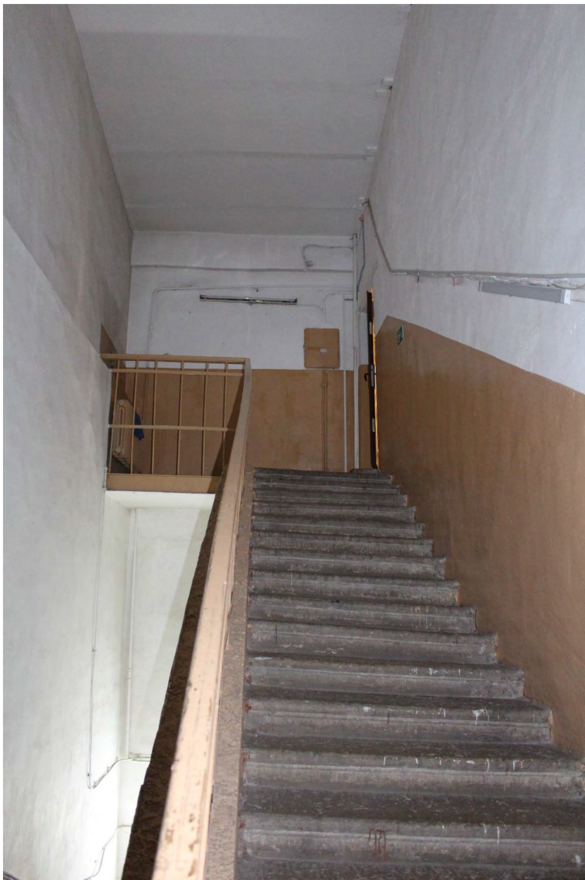
Фото 119. Восточная лестничная клетка дворового корпуса выявленного объекта культурного наследия «Манеж и конюшни лейб-гвардии Гренадерского полка (здание тира лейб-гвардии Стрелкового батальона)». Фото 22.05.2023 г.
