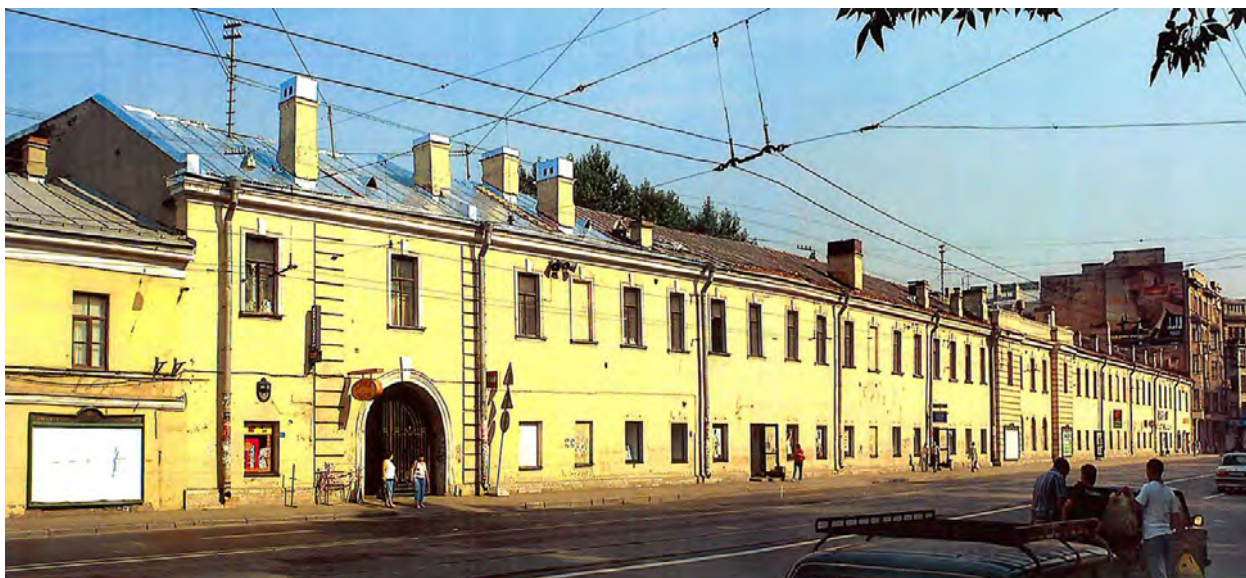
Илл. 44. Вид на юго-восточный (лицевой) фасад дома № 35 по Загородному проспекту. 2008 г. (источник: архив КГИОП).
