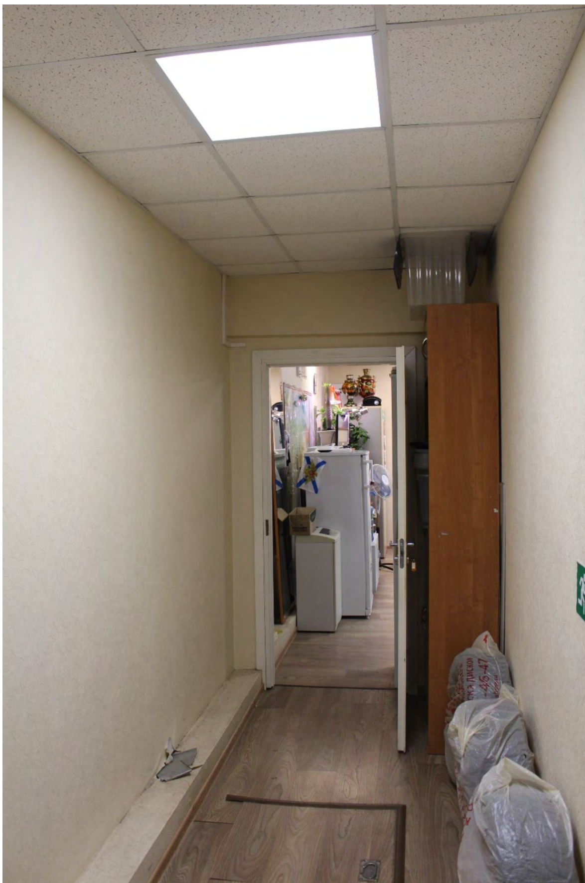
Фото 100. Внутренние помещения 1-го этажа дворового корпуса выявленного объекта культурного наследия «Манеж и конюшни лейб-гвардии Гренадерского полка (здание тира лейб-гвардии Стрелкового батальона)». Фото 22.05.2023 г.
