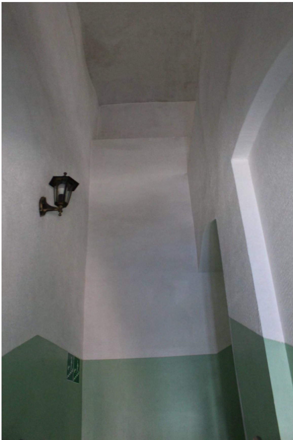
Фото 135. Западная лестничная клетка дворового корпуса выявленного объекта культурного наследия «Манеж и конюшни лейб-гвардии Гренадерского полка (здание тира лейб-гвардии Стрелкового батальона)». Фото 22.05.2023 г.
