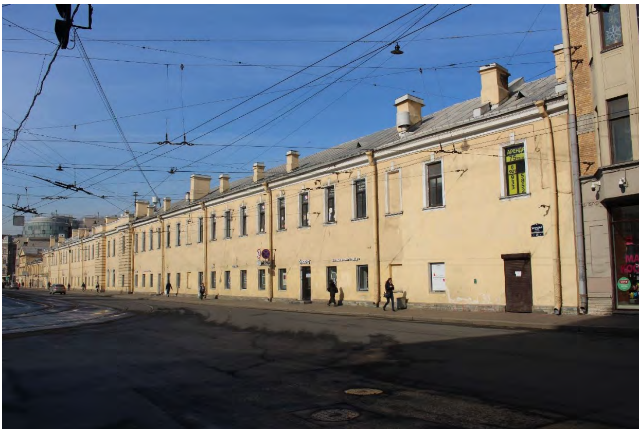
Фото 5. Вид на юго-восточный фасад лицевого корпуса выявленного объекта культурного наследия «Манеж и конюшни лейб-гвардии Гренадерского полка (здание тира лейб-гвардии Стрелкового батальона)». Фото 17.04.2023 г.
