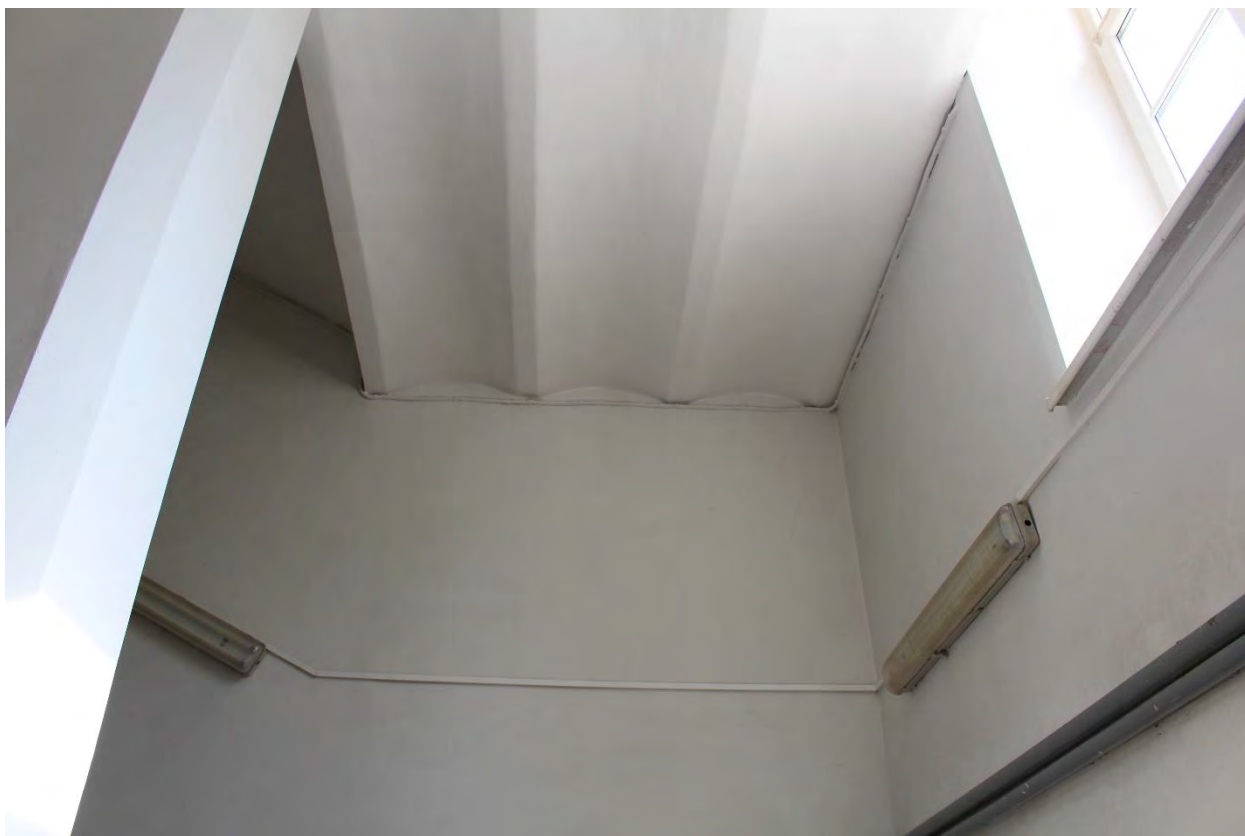
Фото 70. Юго-западная лестничная клетка лицевого корпуса выявленного объекта культурного наследия «Манеж и конюшни лейб-гвардии Гренадерского полка (здание тира лейб-гвардии Стрелкового батальона)». Фото 22.05.2023 г.
