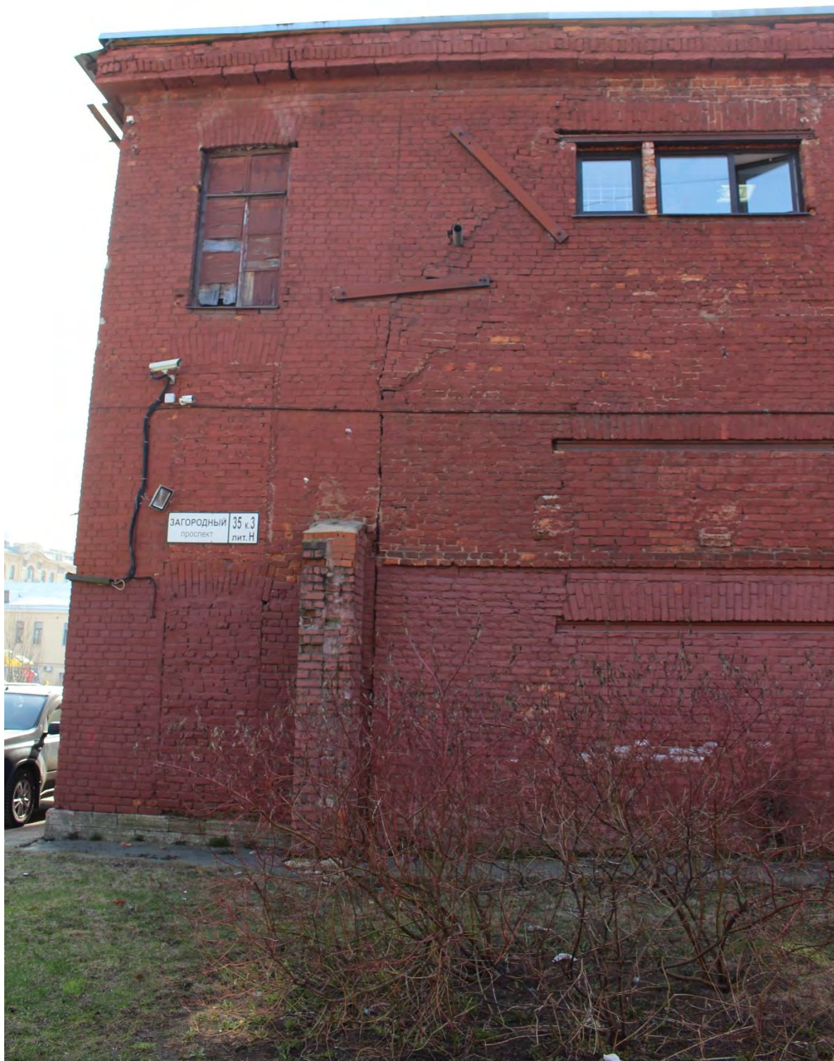
Фото 25. Вид на северную часть северо-западного фасада дворового корпуса выявленного объекта культурного наследия «Манеж и конюшни лейб-гвардии Гренадерского полка (здание тира лейб-гвардии Стрелкового батальона)». Фото 17.04.2023 г.
