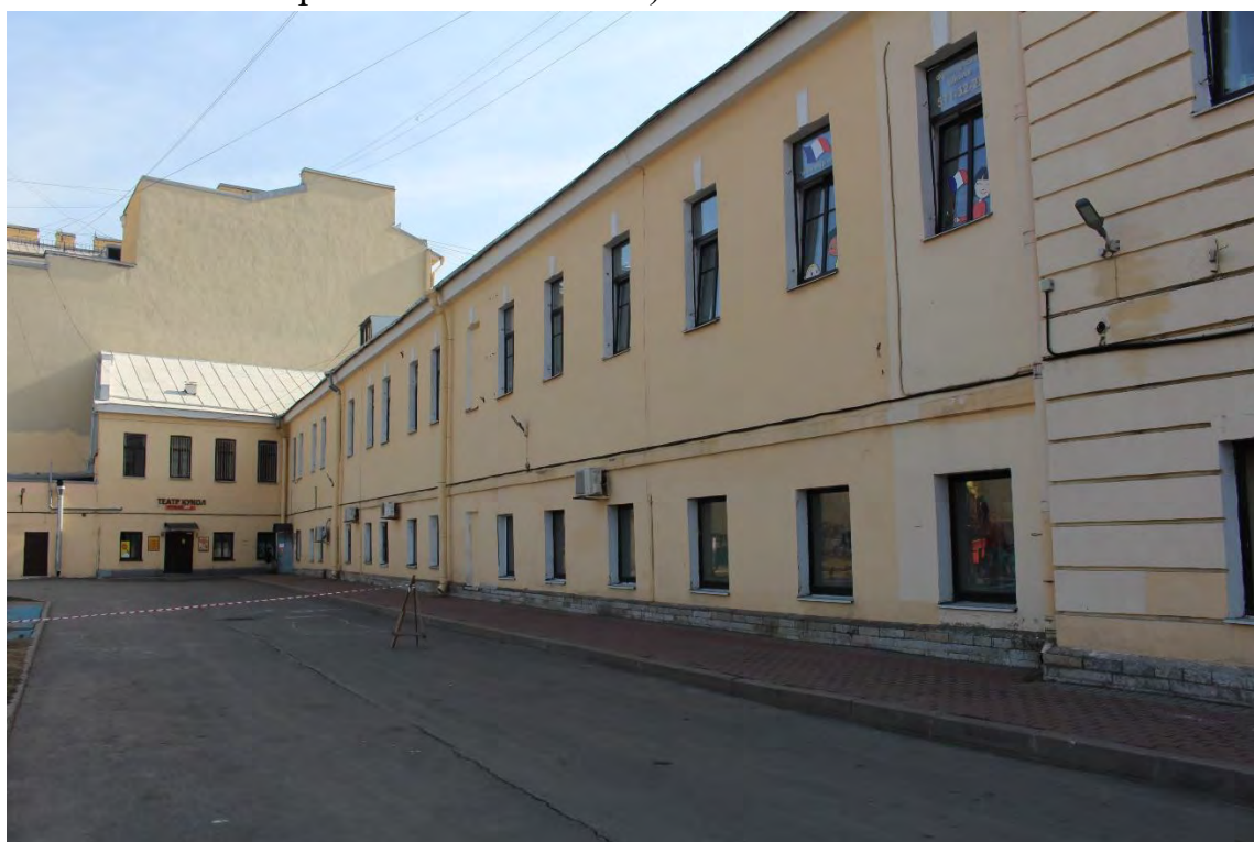
Фото 12. Вид на северо-восточный (дворовый) фасад лицевого корпуса выявленного объекта культурного наследия «Манеж и конюшни лейб-гвардии Гренадерского полка (здание тира лейб-гвардии Стрелкового батальона)». Фото 17.04.2023 г.
