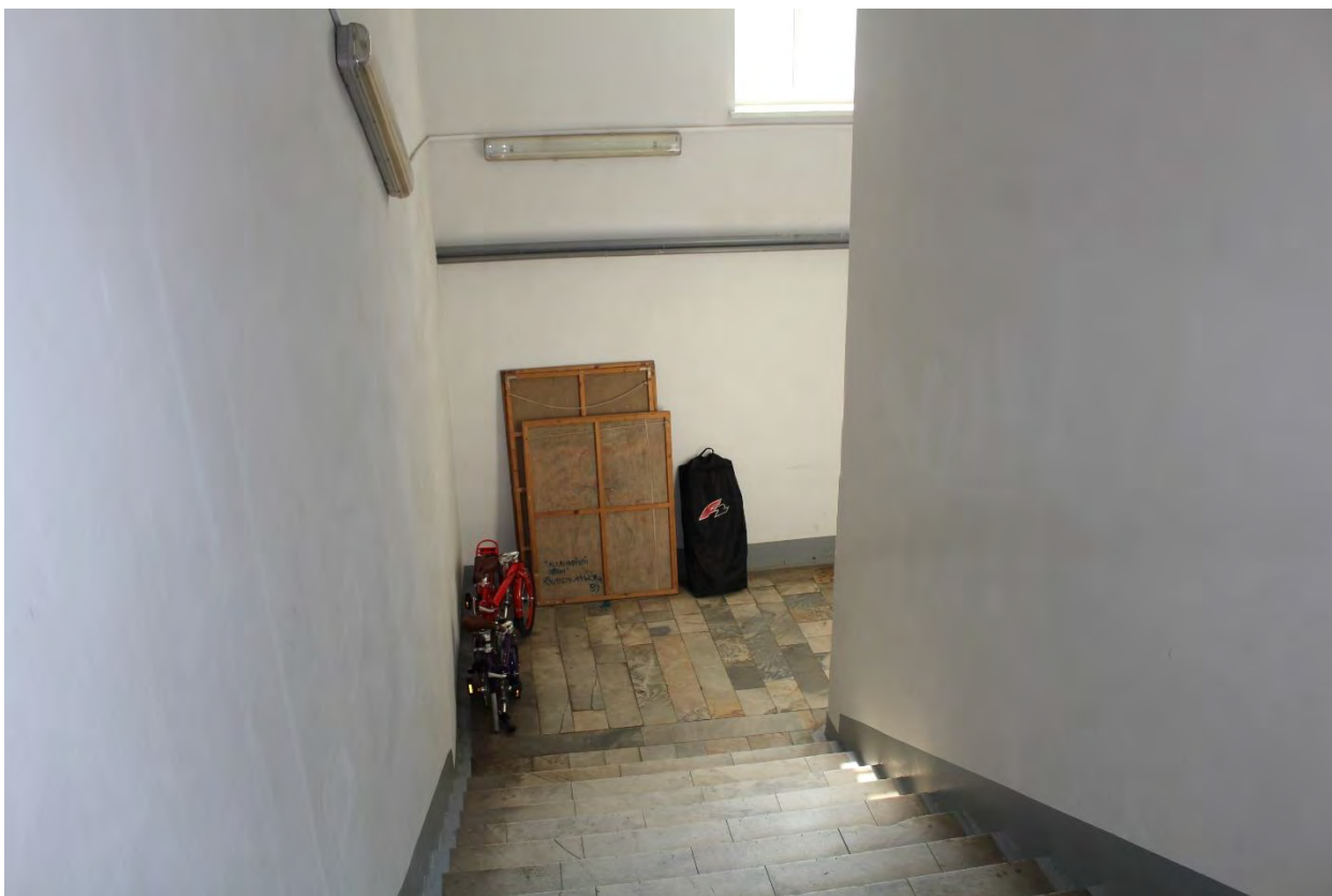
Фото 72. Юго-западная лестничная клетка лицевого корпуса выявленного объекта культурного наследия «Манеж и конюшни лейб-гвардии Гренадерского полка (здание тира лейб-гвардии Стрелкового батальона)». Фото 22.05.2023 г.
