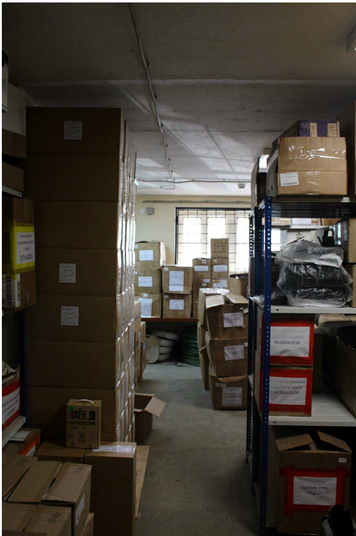
Фото 93. Внутренние помещения 1-го этажа дворового корпуса выявленного объекта культурного наследия «Манеж и конюшни лейб-гвардии Гренадерского полка (здание тира лейб-гвардии Стрелкового батальона)». Фото 22.05.2023 г.
