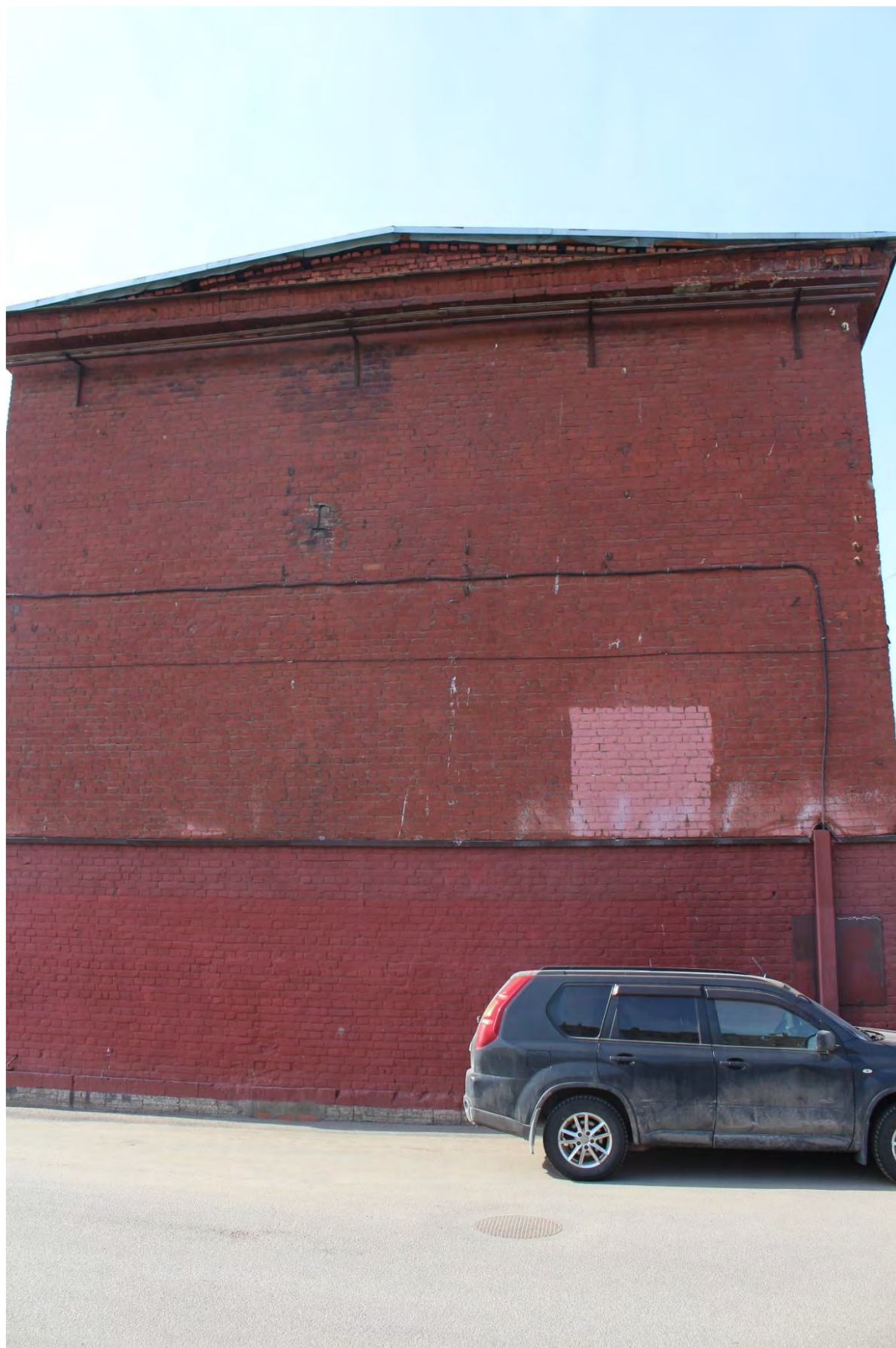
Фото 24. Вид на северо-восточный фасад (торцевой) дворового корпуса выявленного объекта культурного наследия «Манеж и конюшни лейб-гвардии Гренадерского полка (здание тира лейб-гвардии Стрелкового батальона)». Фото 17.04.2023 г.
