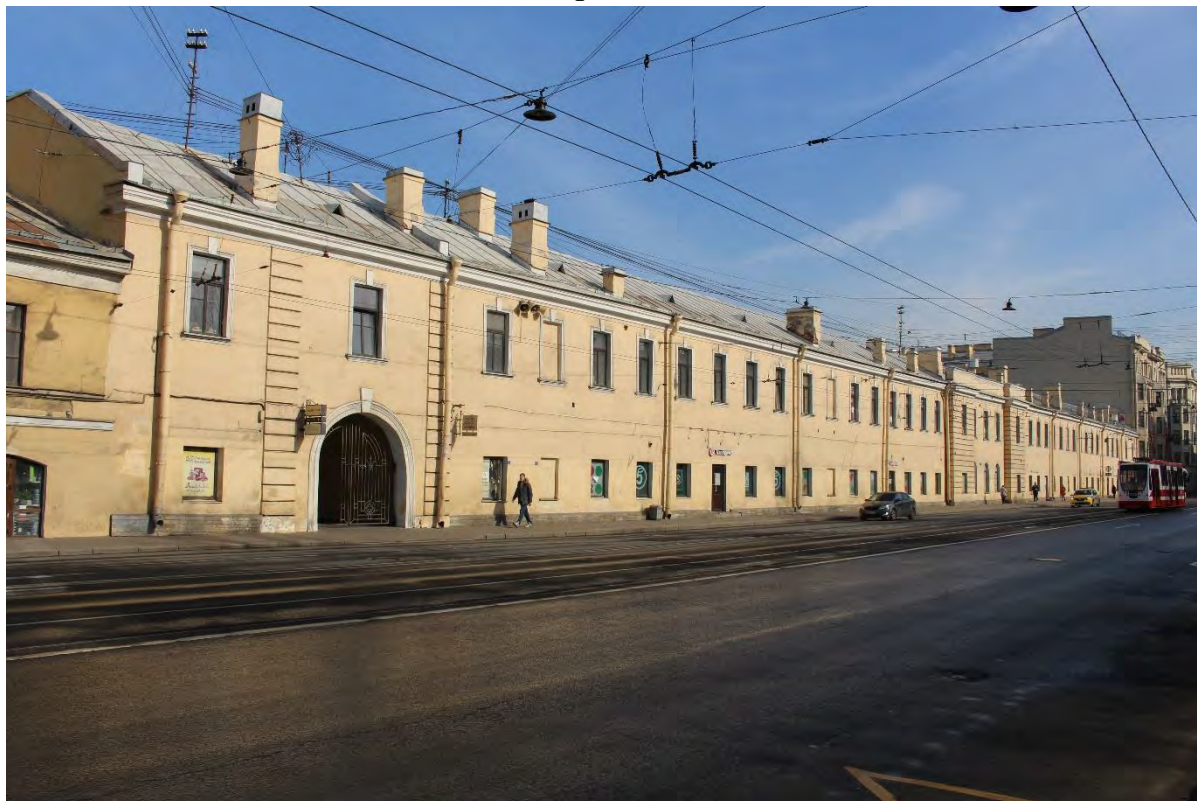
Фото 1. Вид на юго-восточный фасад лицевого корпуса выявленного объекта культурного наследия «Манеж и конюшни лейб-гвардии Гренадерского полка (здание тира лейб-гвардии Стрелкового батальона)». Фото 17.04.2023 г.
