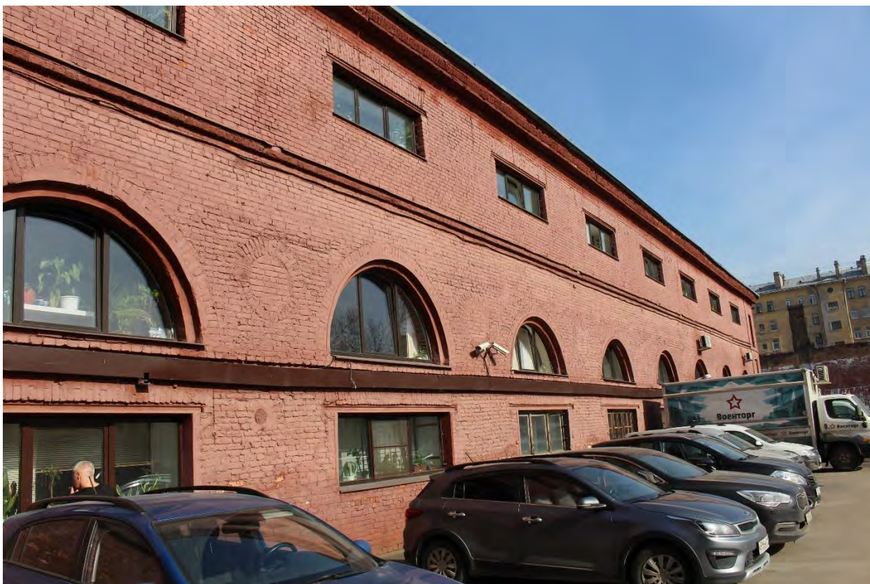
Фото 21. Вид на юго-восточный фасад дворового корпуса выявленного объекта культурного наследия «Манеж и конюшни лейб-гвардии Гренадерского полка (здание тира лейб-гвардии Стрелкового батальона)». Фото 17.04.2023 г.
