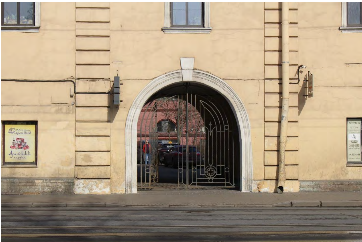
Фото 6. Вид на воротный проезд лицевого корпуса выявленного объекта культурного наследия «Манеж и конюшни лейб-гвардии Гренадерского полка (здание тира лейб-гвардии Стрелкового батальона)». Фото 17.04.2023 г.
