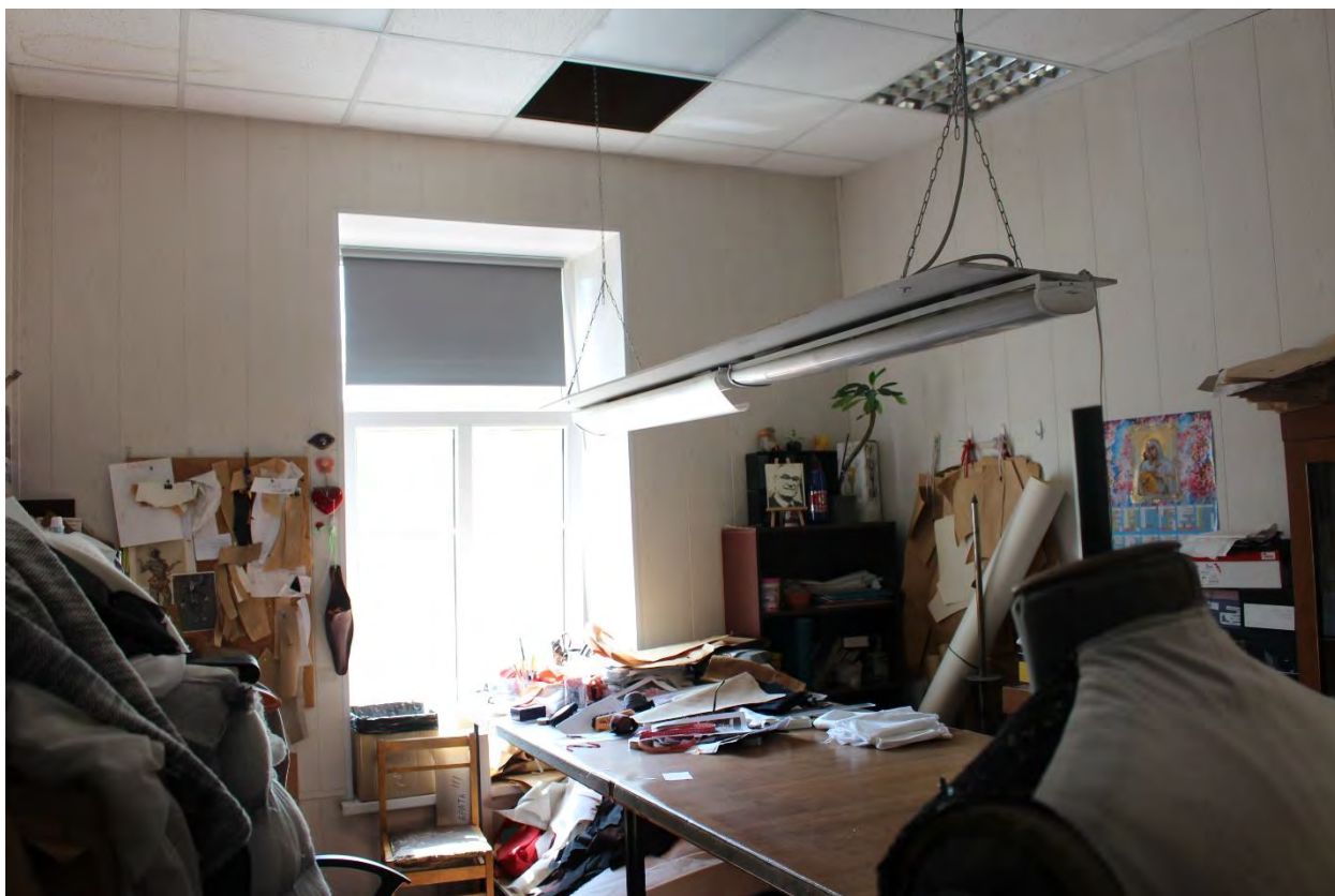
Фото 79. Внутренние помещения 2-го этажа лицевого корпуса выявленного объекта культурного наследия «Манеж и конюшни лейб-гвардии Гренадерского полка (здание тира лейб-гвардии Стрелкового батальона)». Фото 22.05.2023 г.
