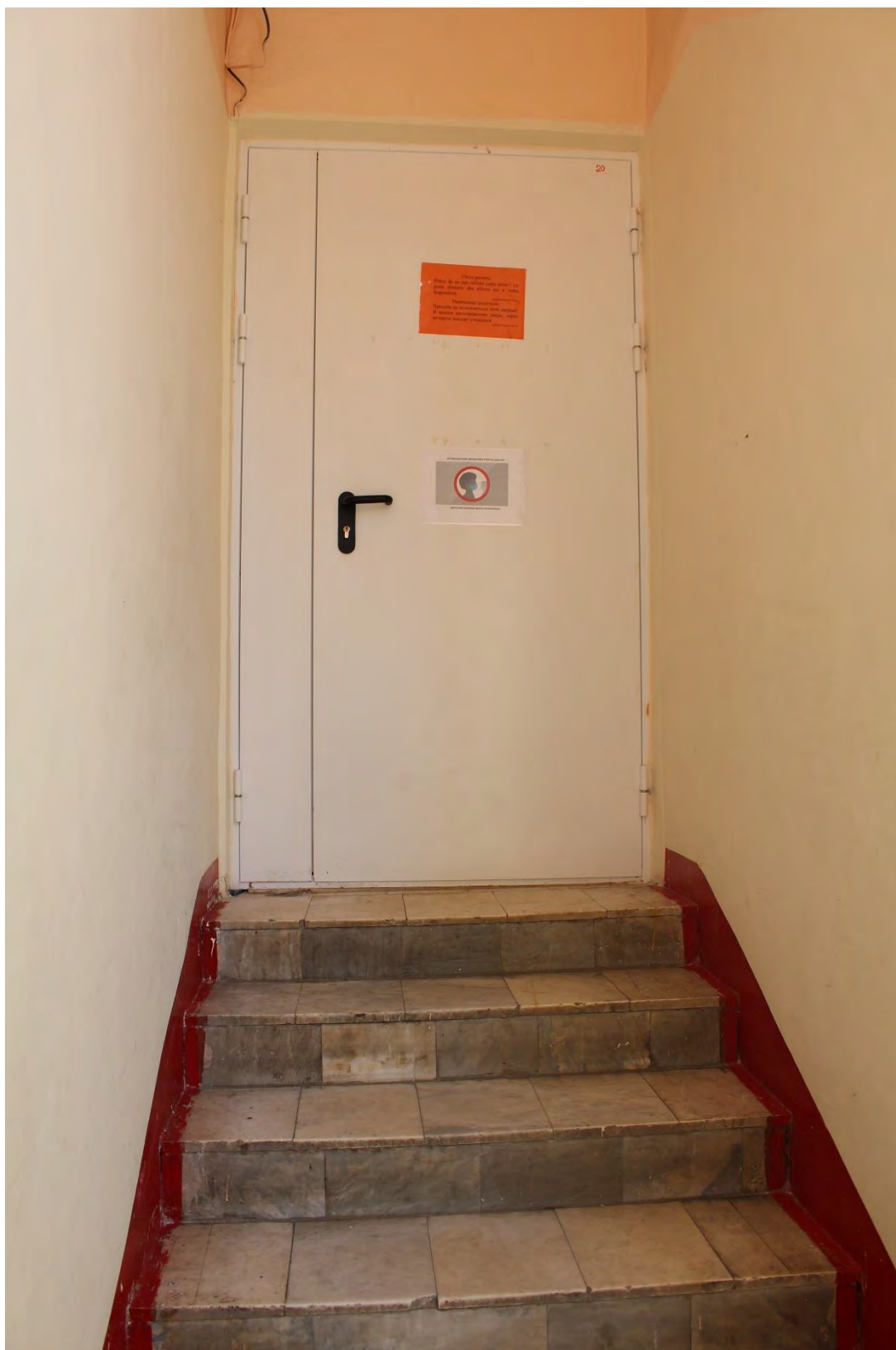
Фото 60. Центральная лестничная клетка в уровне 2-го этажа лицевого корпуса выявленного объекта культурного наследия «Манеж и конюшни лейб-гвардии Гренадерского полка (здание тира лейб-гвардии Стрелкового батальона)». Фото 22.05.2023 г.
