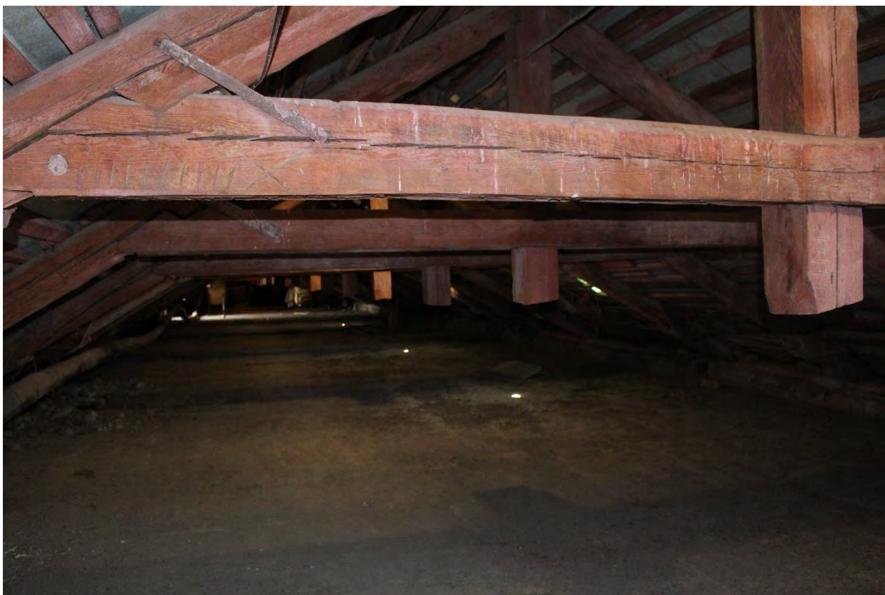
Фото 86. Чердачные помещения лицевого корпуса выявленного объекта культурного наследия «Манеж и конюшни лейб-гвардии Гренадерского полка (здание тира лейб-гвардии Стрелкового батальона)». Фото 22.05.2023 г.
