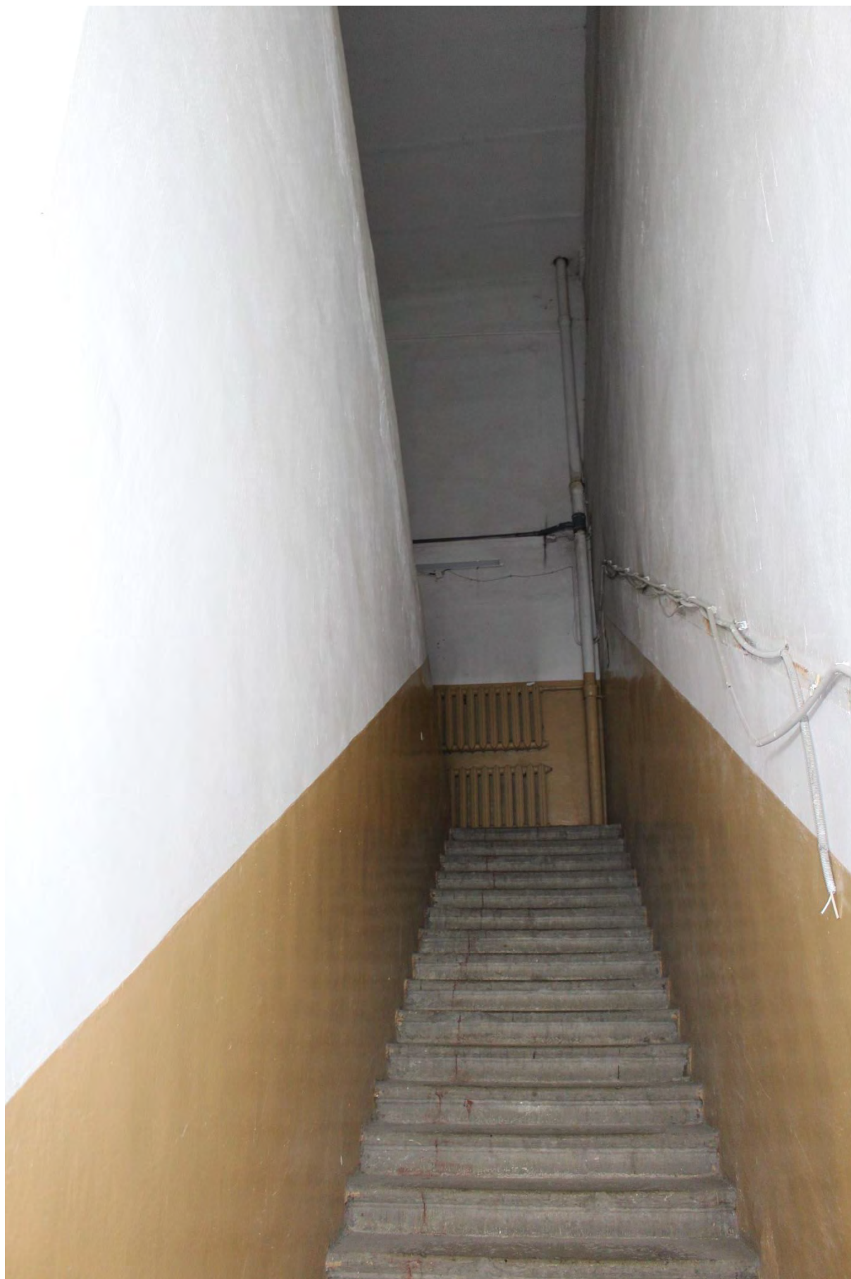
Фото 118. Восточная лестничная клетка дворового корпуса выявленного объекта культурного наследия «Манеж и конюшни лейб-гвардии Гренадерского полка (здание тира лейб-гвардии Стрелкового батальона)». Фото 22.05.2023 г.
