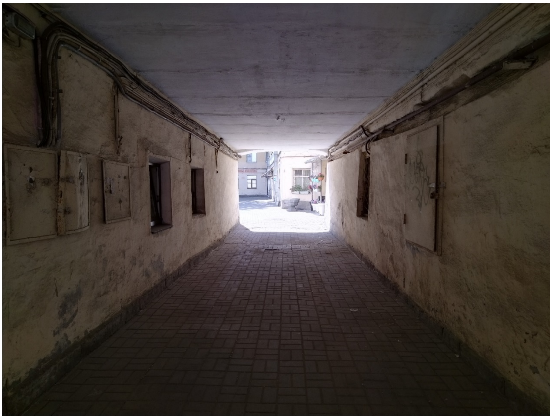
11. Выявленный объект культурного наследия «Дом жилой». Санкт-Петербург, Гончарная ул., д. 25, литера А. Проездная арка. Дата съемки: 12.07.2023.
