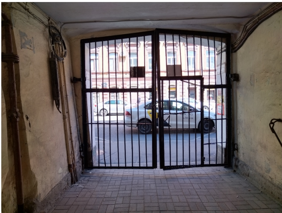
9. Выявленный объект культурного наследия «Дом жилой». Санкт-Петербург, Гончарная ул., д. 25, литера А. Проездная арка. Дата съемки: 12.07.2023.
