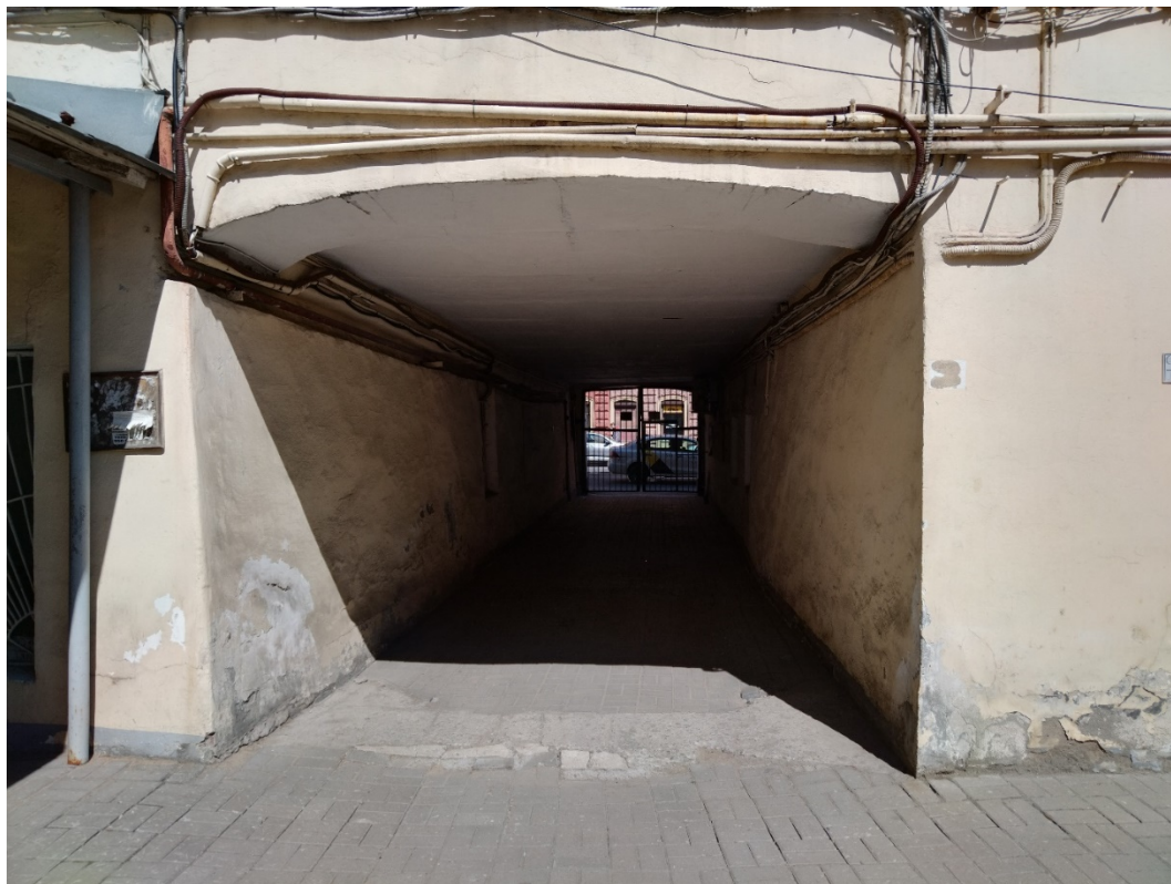
12. Выявленный объект культурного наследия «Дом жилой». Санкт-Петербург, Гончарная ул., д. 25, литера А. Фрагмент дворового фасада. Проездная арка. Дата съемки: 12.07.2023.
