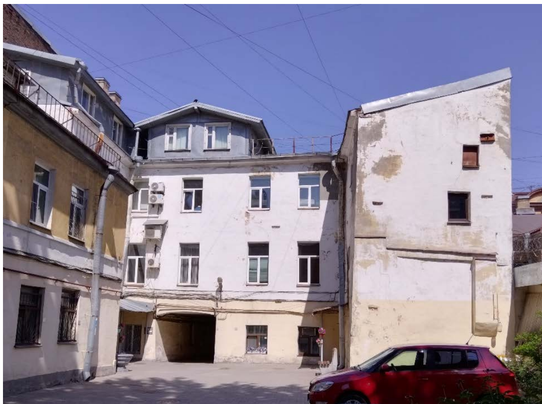
13. Выявленный объект культурного наследия «Дом жилой». Санкт-Петербург, Гончарная ул., д. 25, литера А. Дворовые фасады. Дата съемки: 12.07.2023.
