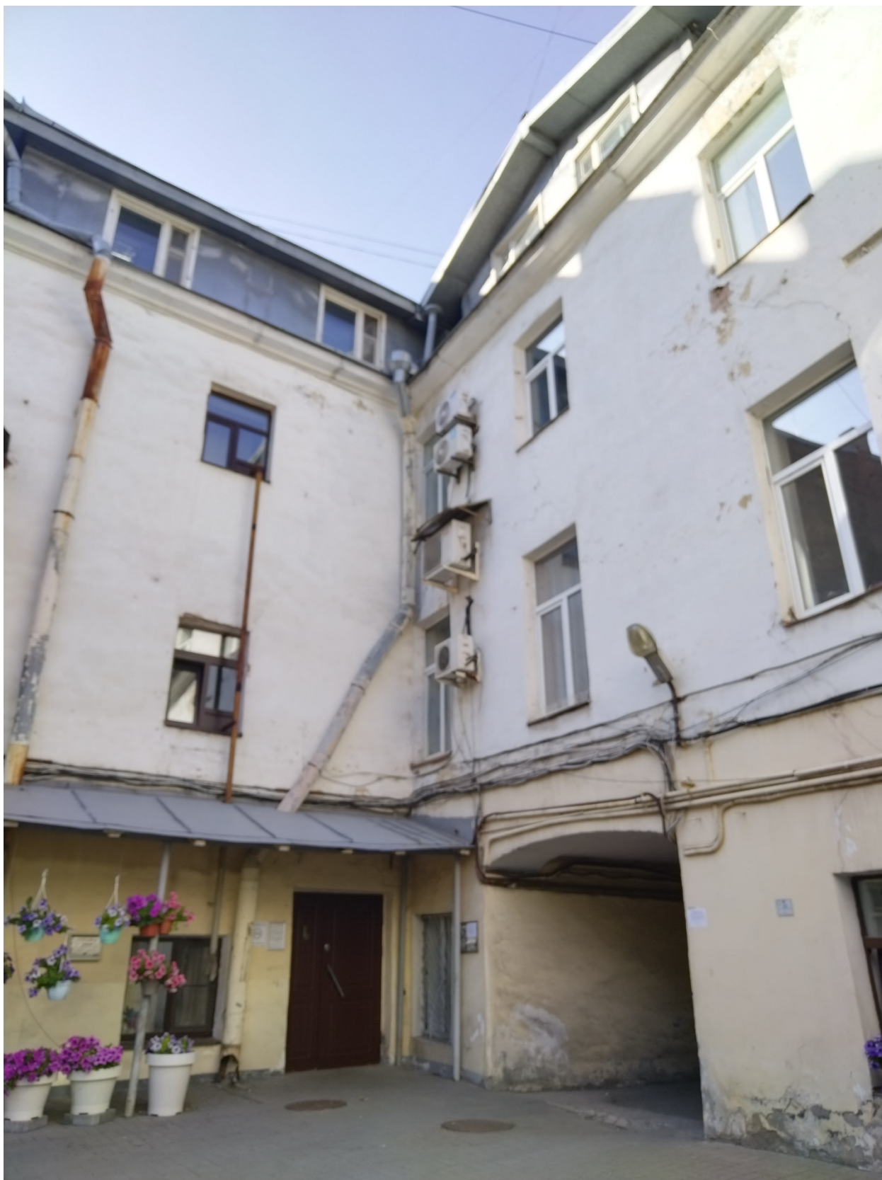
16. Выявленный объект культурного наследия «Дом жилой». Санкт-Петербург, Гончарная ул., д. 25, литера А. Фрагмент восточного и северного дворовых фасадов. Дата съемки: 12.07.2023.
