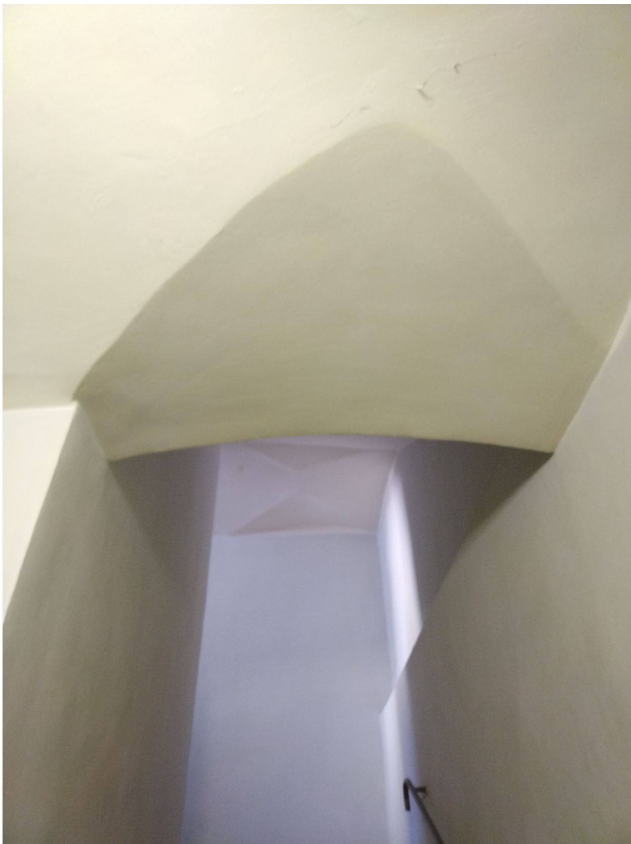
3. Выявленный объект культурного наследия «Дом жилой». Санкт-Петербург, Гончарная ул., д. 25, литера А. Помещение лестницы Л-3. Сводчатые перекрытия. Дата съемки: 12.07.2023.
