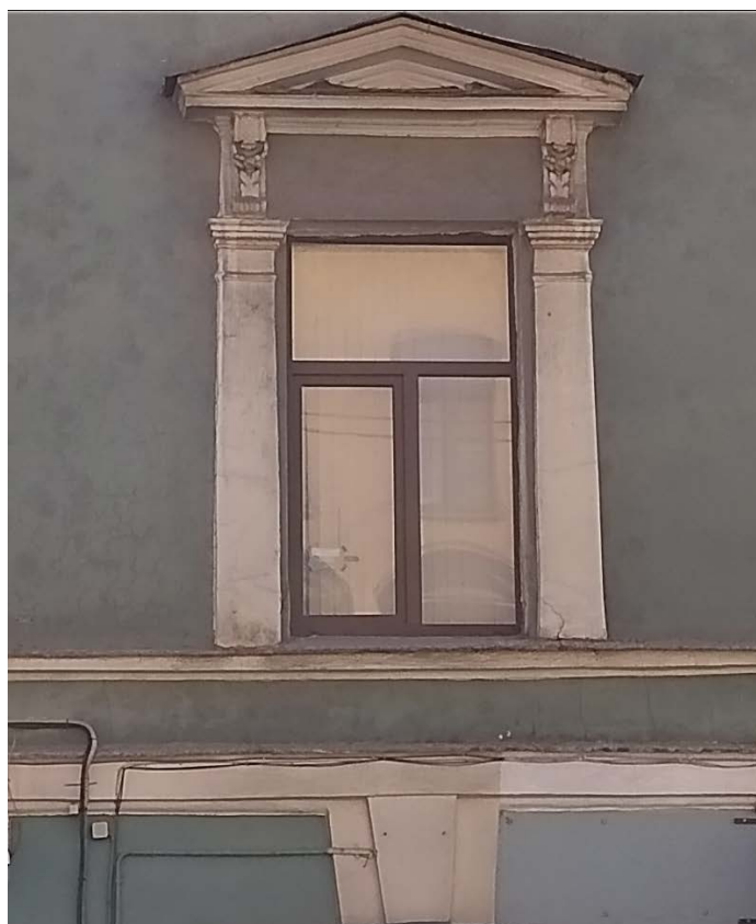
6. Выявленный объект культурного наследия «Дом жилой». Санкт-Петербург, Гончарная ул., д. 25, литера А. Фрагмент лицевого фасада. Оформление оконного проема пилястрами и треугольным сандриком на кронштейнах. Дата съемки: 12.07.2023.
