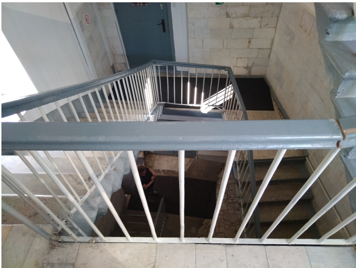
19. Выявленный объект культурного наследия «Дом жилой». Санкт-Петербург, Гончарная ул., д. 25, литера А. Помещение лестницы Л-1. 3 этаж. Дата съемки: 12.07.2023.
