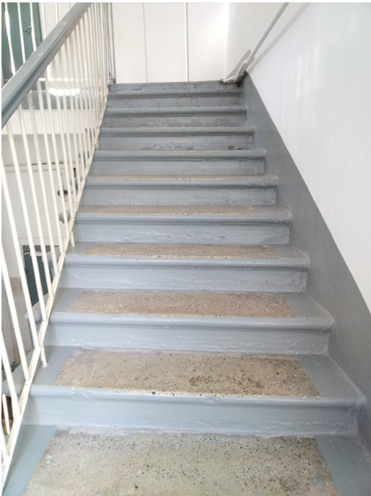
20. Выявленный объект культурного наследия «Дом жилой». Санкт-Петербург, Гончарная ул., д. 25, литера А. Помещение лестницы Л-1. 3 этаж. Дата съемки: 12.07.2023.
