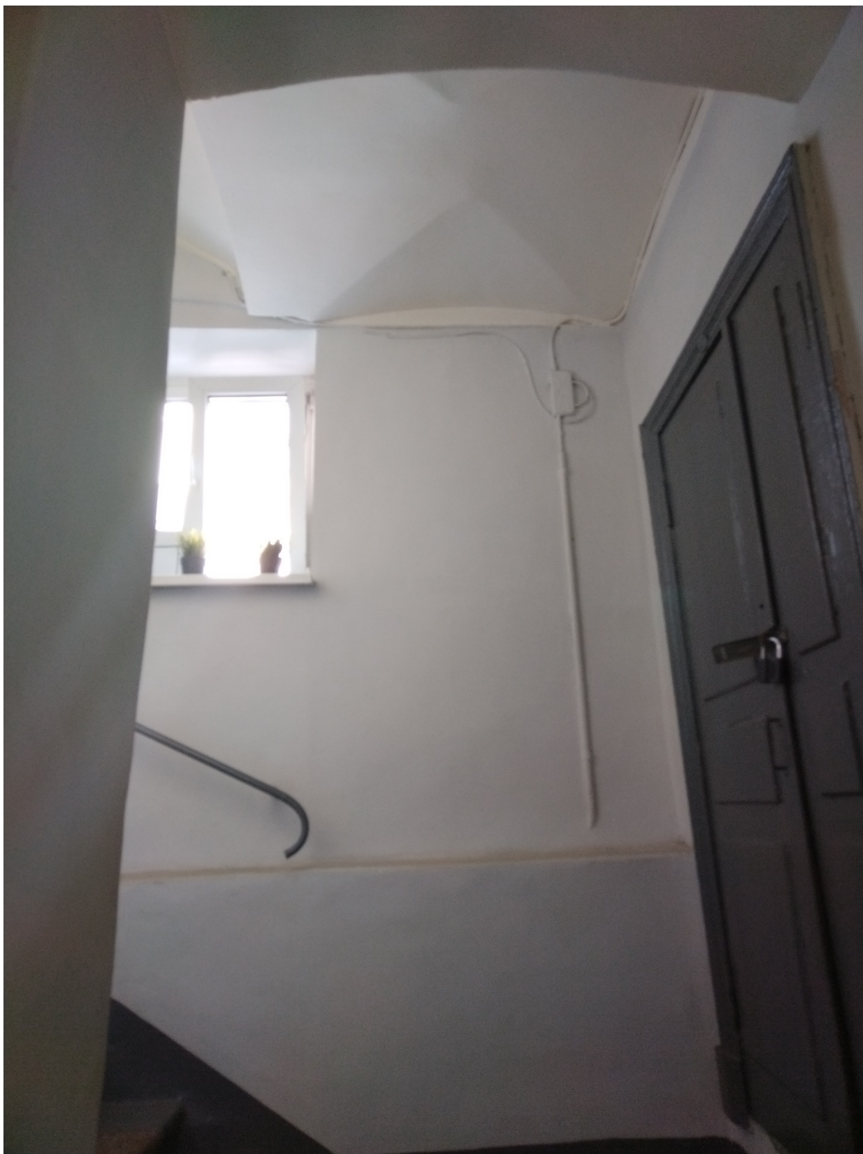
5. Выявленный объект культурного наследия «Дом жилой». Санкт-Петербург, Гончарная ул., д. 25, литера А. Помещение лестницы Л-3. Сводчатые перекрытия. Дата съемки: 12.07.2023.
