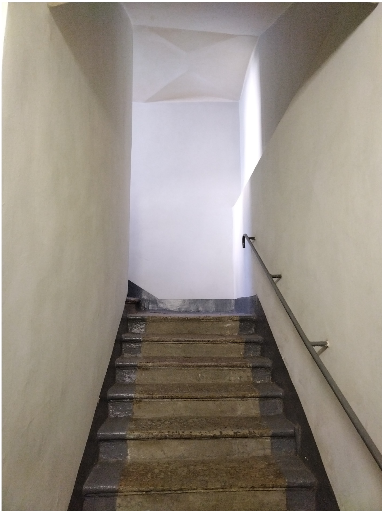
2. Выявленный объект культурного наследия «Дом жилой». Санкт-Петербург, Гончарная ул., д. 25, литера А. Помещение лестницы Л-3. Сводчатые перекрытия. Ступени лещадной плиты. Дата съемки: 12.07.2023.
