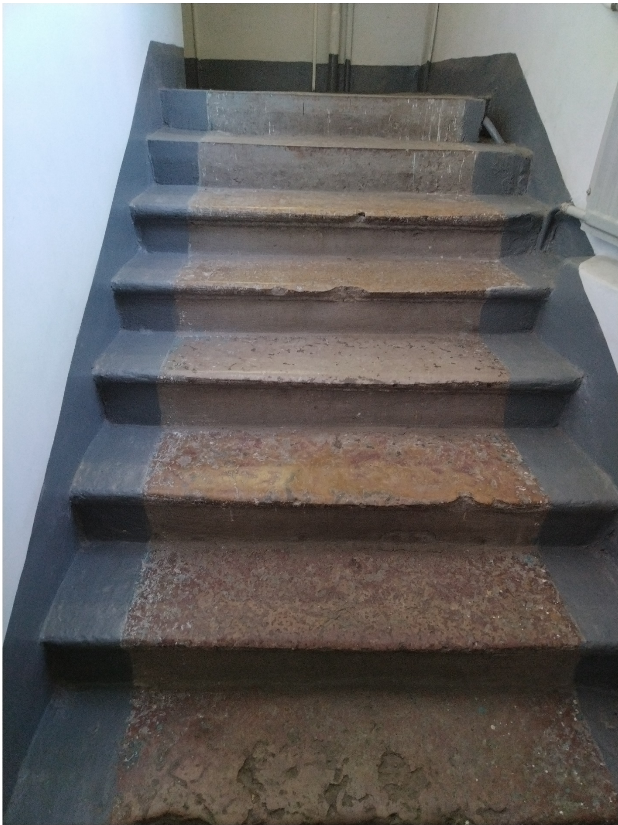
7. Выявленный объект культурного наследия «Дом жилой». Санкт-Петербург, Гончарная ул., д. 25, литера А. Помещение лестницы Л-3. Ступени лещадной плиты. Дата съемки: 12.07.2023.
