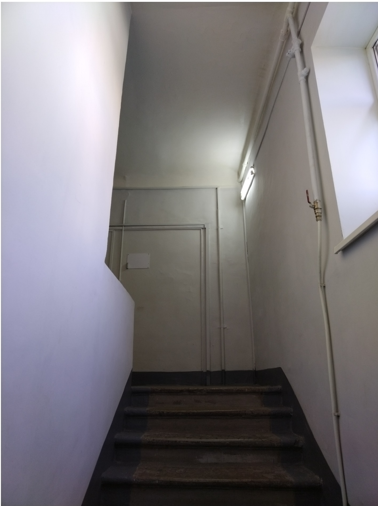
10. Выявленный объект культурного наследия «Дом жилой». Санкт-Петербург, Гончарная ул., д. 25, литера А. Помещение лестницы Л-3. 3 этаж. Дата съемки: 12.07.2023.
