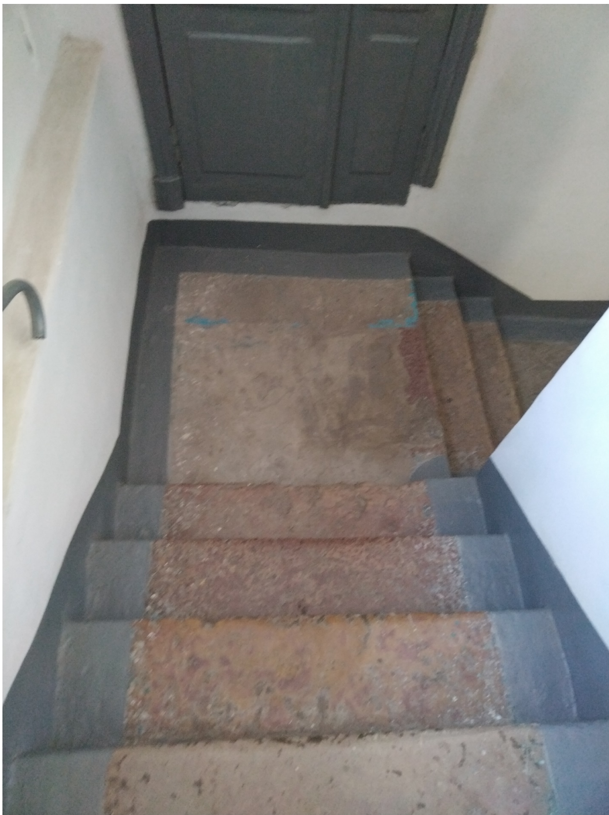
6. Выявленный объект культурного наследия «Дом жилой». Санкт-Петербург, Гончарная ул., д. 25, литера А. Помещение лестницы Л-3. Площадка и ступени лещадной плиты. Дата съемки: 12.07.2023.
