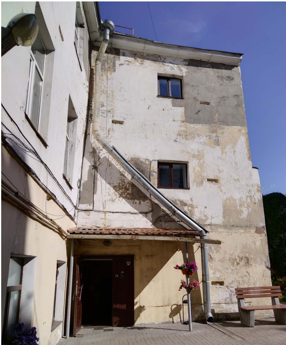
18. Выявленный объект культурного наследия «Дом жилой». Санкт-Петербург, Гончарная ул., д. 25, литера А. Западный дворовый фасада. Дата съемки: 12.07.2023.
