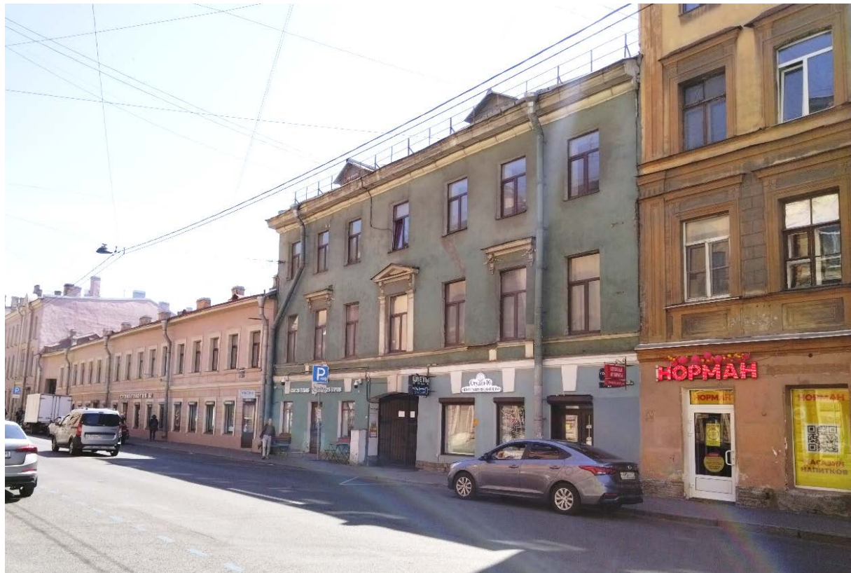
2. Выявленный объект культурного наследия «Дом жилой». Санкт-Петербург, Гончарная ул., д. 25, литера А. Вид на лицевой фасад с северо-запада. Дата съемки: 12.07.2023.
