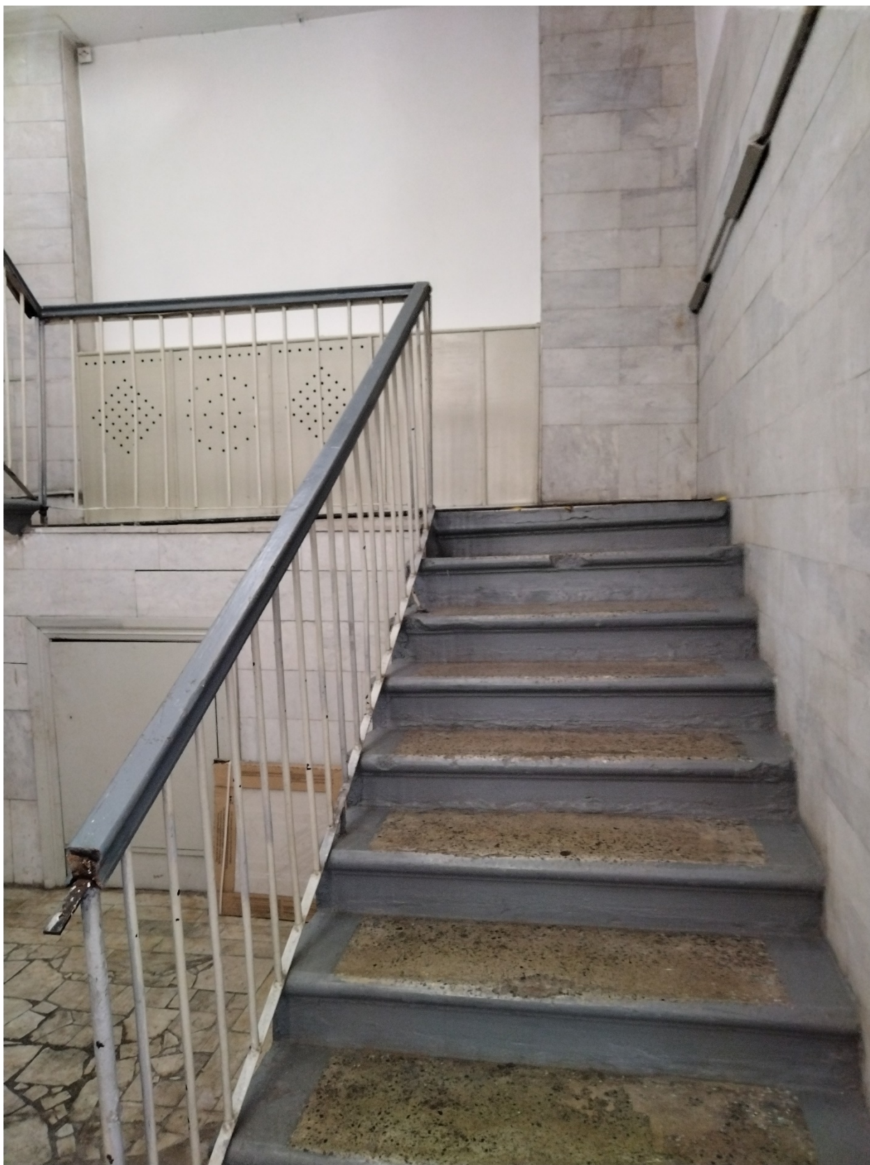
14. Выявленный объект культурного наследия «Дом жилой». Санкт-Петербург, Гончарная ул., д. 25, литера А. Помещение лестницы Л-1. 1 этаж. Дата съемки: 12.07.2023.
