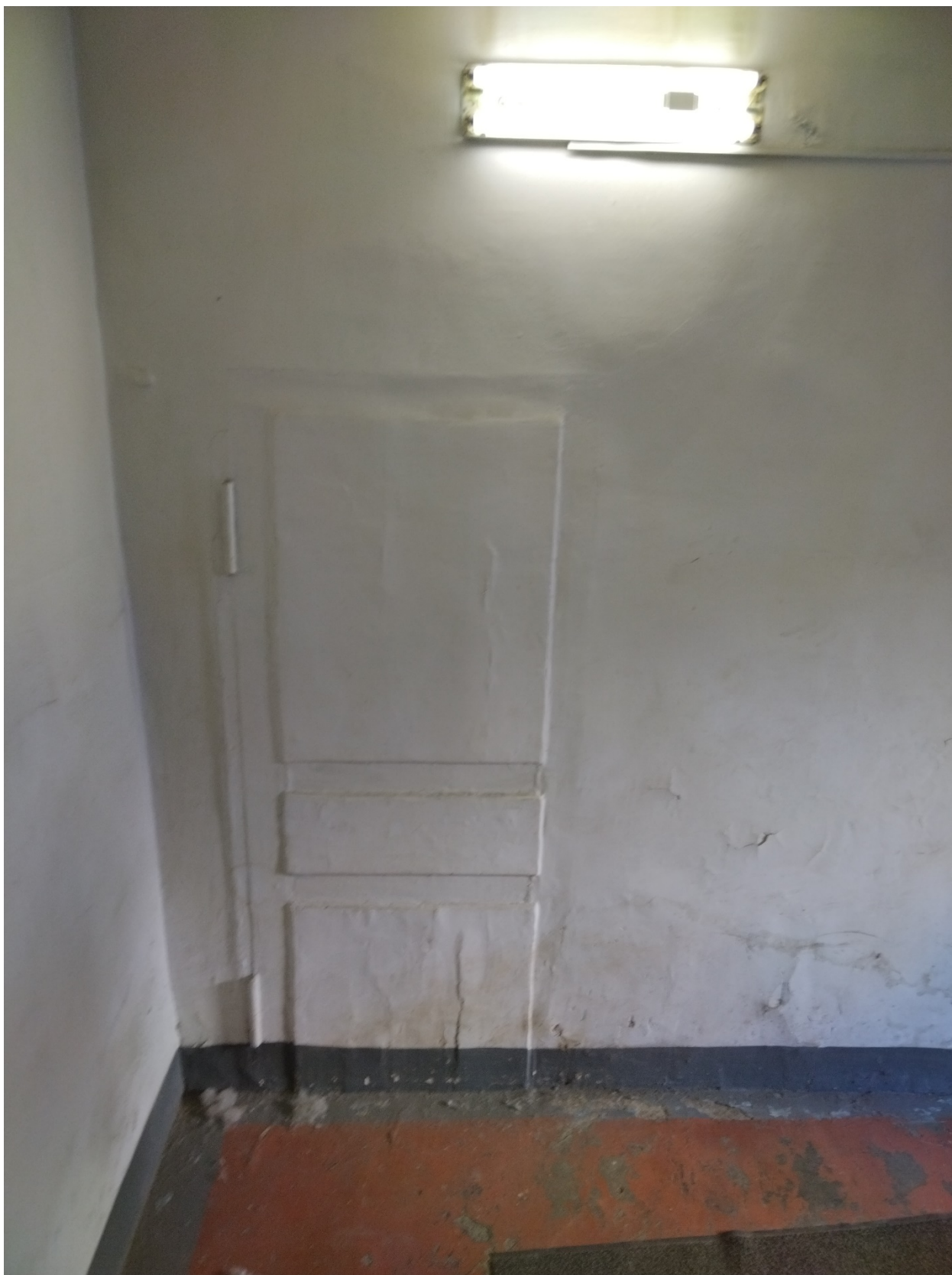
1. Выявленный объект культурного наследия «Дом жилой». Санкт-Петербург, Гончарная ул., д. 25, литера А. Помещение лестницы Л-3. Защищенный дверной проем. Дата съемки: 12.07.2023.
