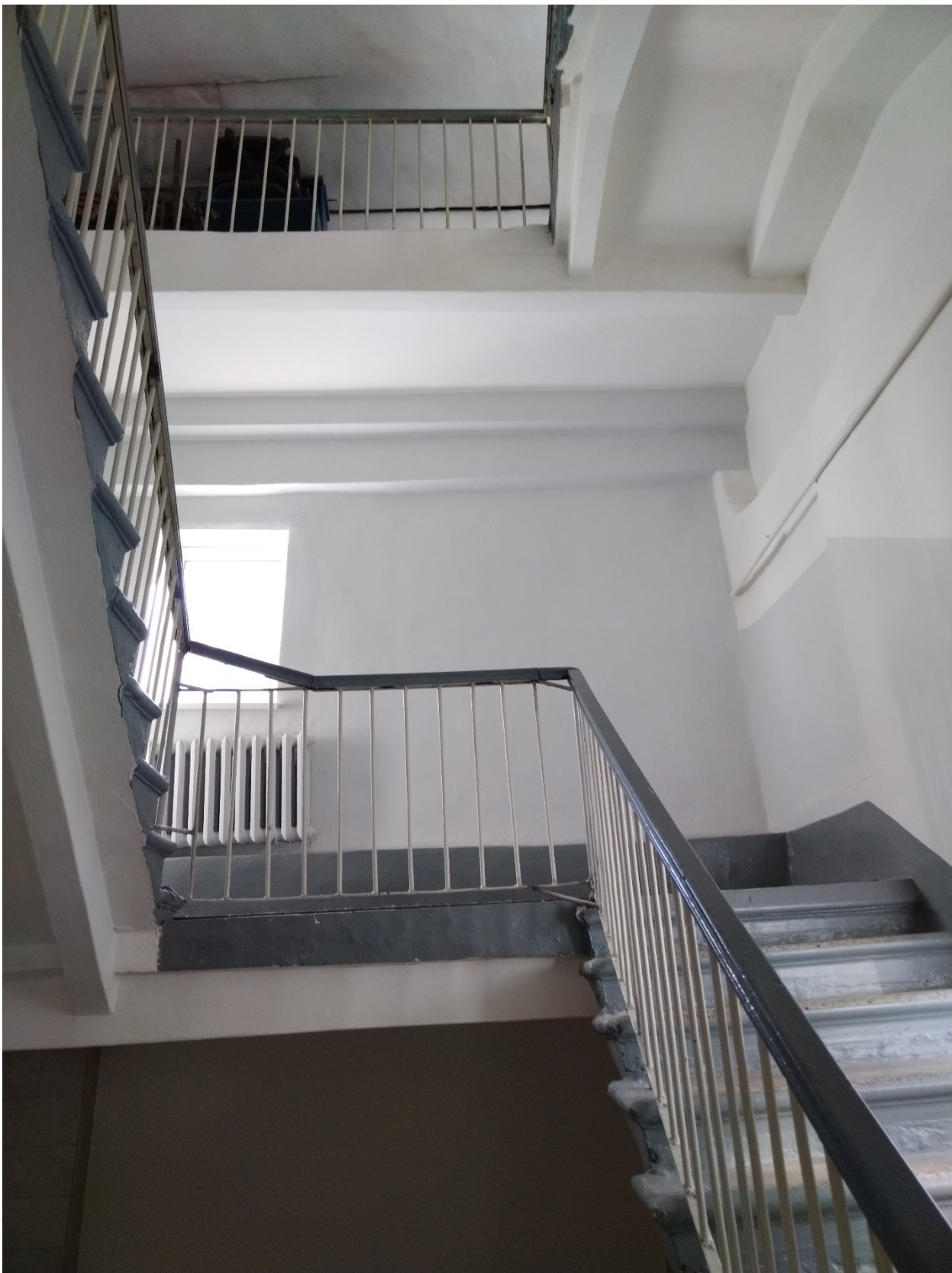
18. Выявленный объект культурного наследия «Дом жилой». Санкт-Петербург, Гончарная ул., д. 25, литера А. Помещение лестницы Л-1. 2 этаж. Дата съемки: 12.07.2023.
