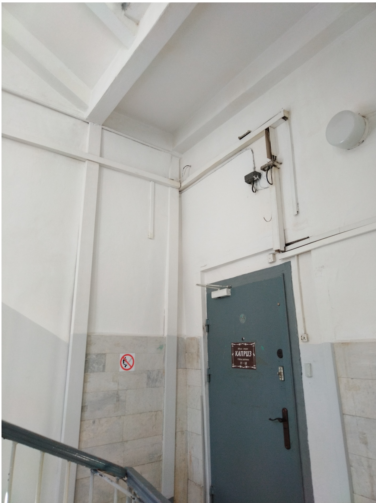
17. Выявленный объект культурного наследия «Дом жилой». Санкт-Петербург, Гончарная ул., д. 25, литера А. Помещение лестницы Л-1. 2 этаж. Дата съемки: 12.07.2023.
