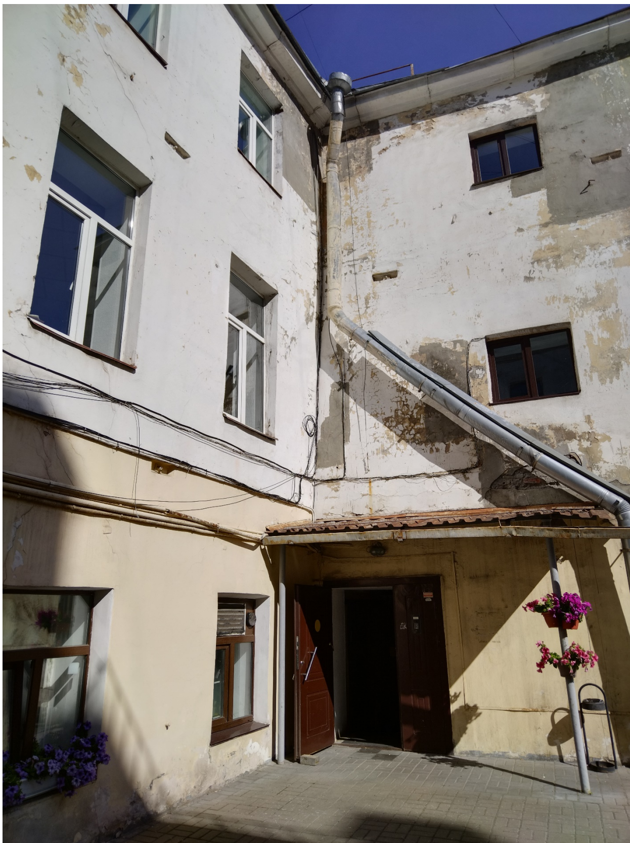
17. Выявленный объект культурного наследия «Дом жилой». Санкт-Петербург, Гончарная ул., д. 25, литера А. Фрагмент южного и западного дворовых фасадов. Дата съемки: 12.07.2023.
