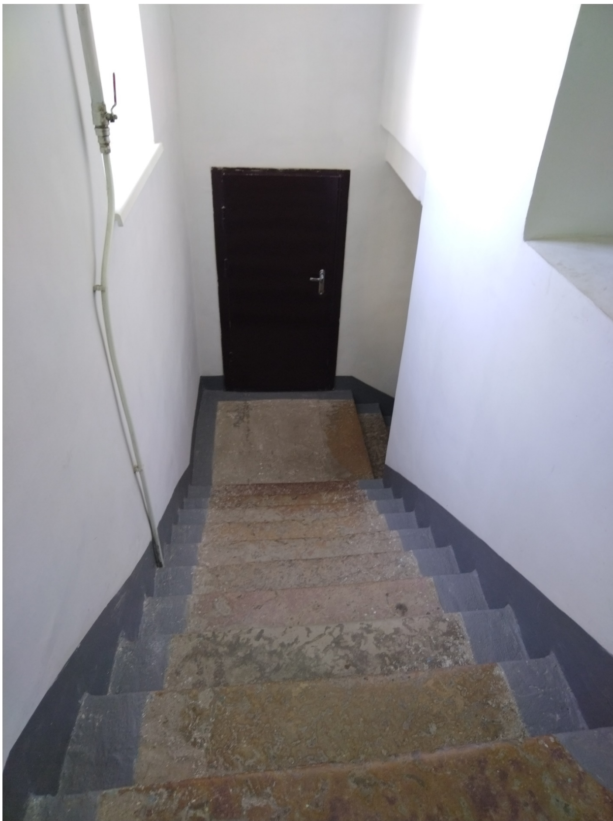
13. Выявленный объект культурного наследия «Дом жилой». Санкт-Петербург, Гончарная ул., д. 25, литера А. Помещение лестницы Л-3. 3 этаж. Дата съемки: 12.07.2023.
