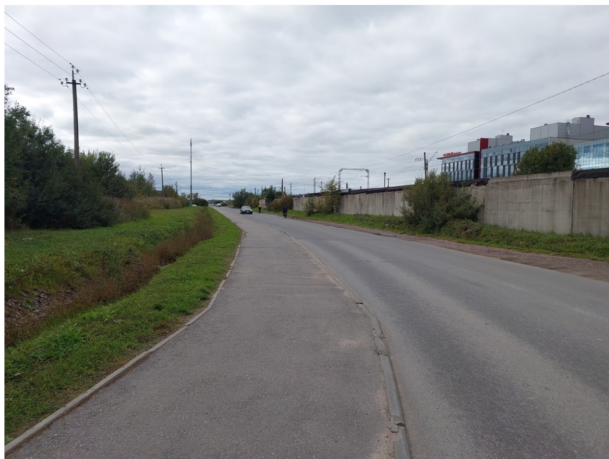
Точка фотофиксации 18. Западная часть участка обследования, трасса ул. Порховской. Вид с В.
