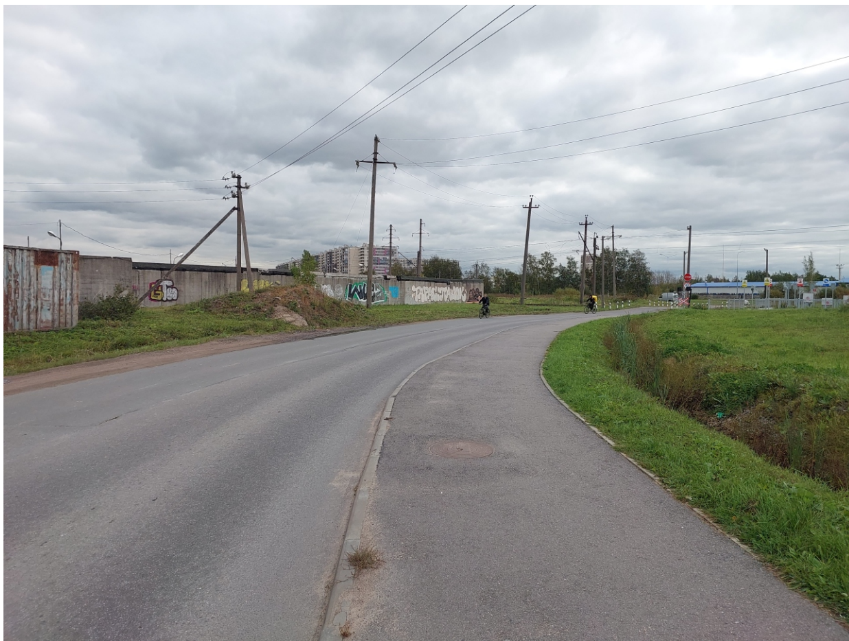
Точка фотофиксации 17. Западная часть участка обследования, трасса ул. Порховской. Вид с З.
