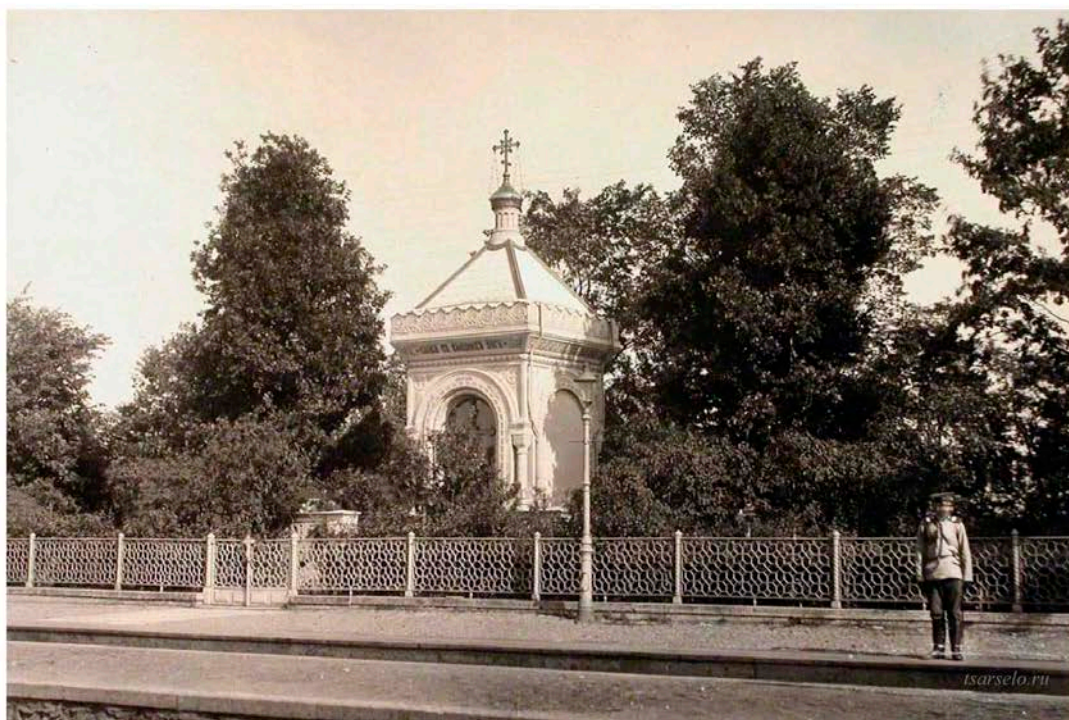
Рис. 5. Александровская, Привокзальная, уч. 4-2023. Дореволюционные виды станционного вокзала и часовни.
