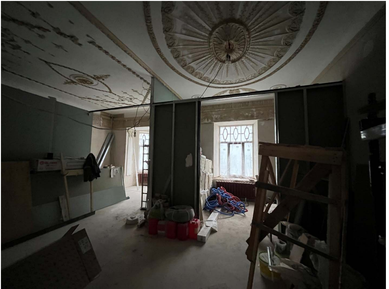
Фото №4. Квартира №45, общий вид.
