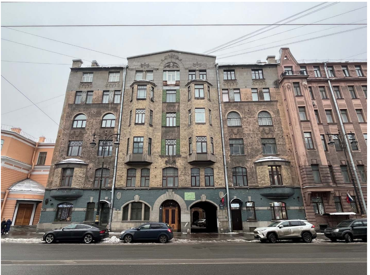
Фото №1. Лицевой фасад.
