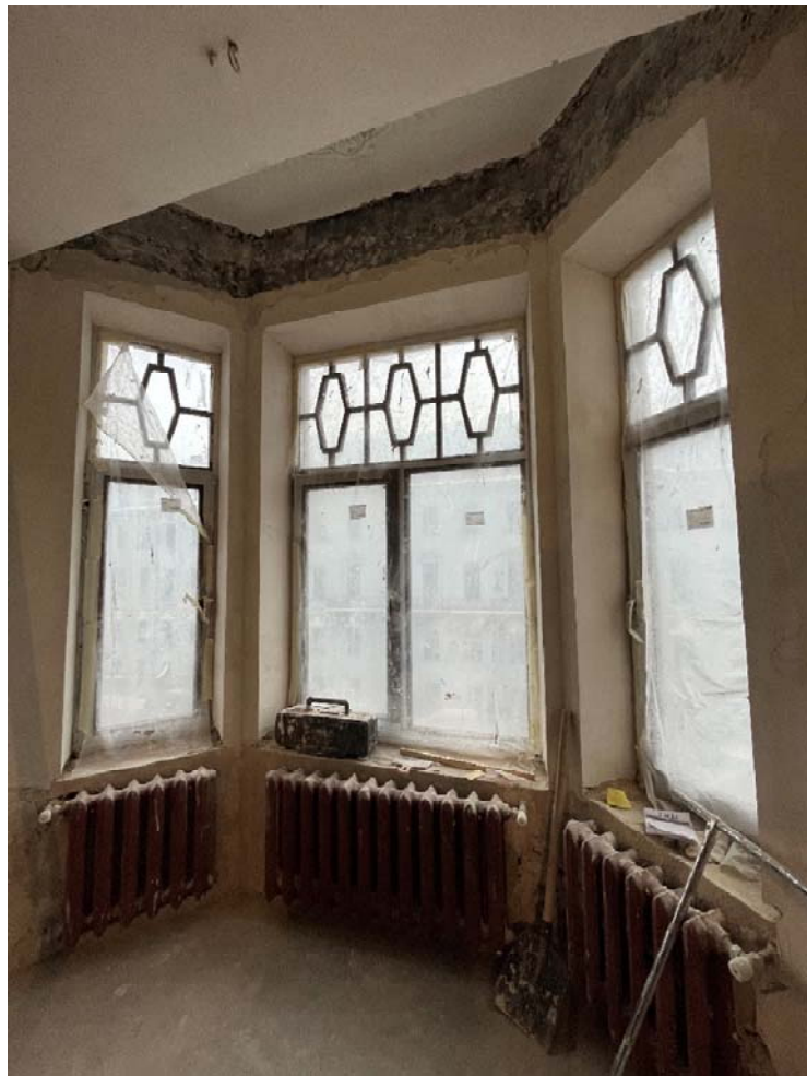
Фото №6. Квартира №45, эркер, оконные заполнения.
