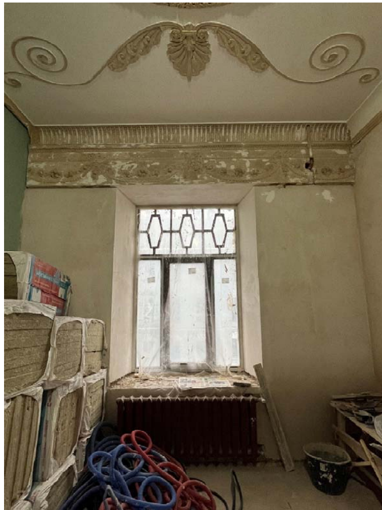
Фото №11. Квартира №45, отделка потолка.
