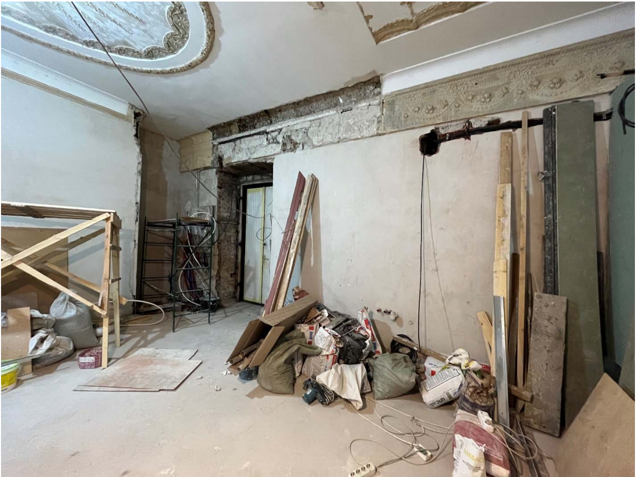
Фото №13. Квартира №45, общий вид.
