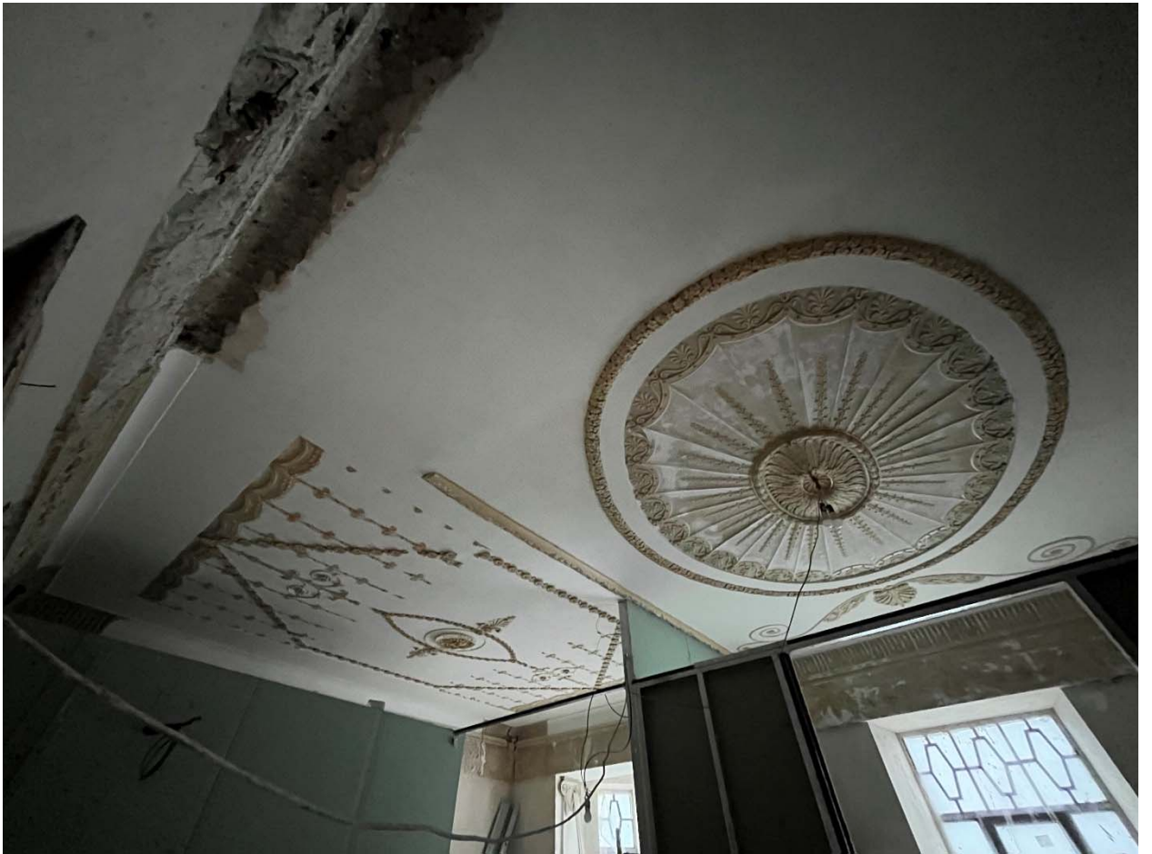
Фото №5. Квартира №45, отделка потолка.
