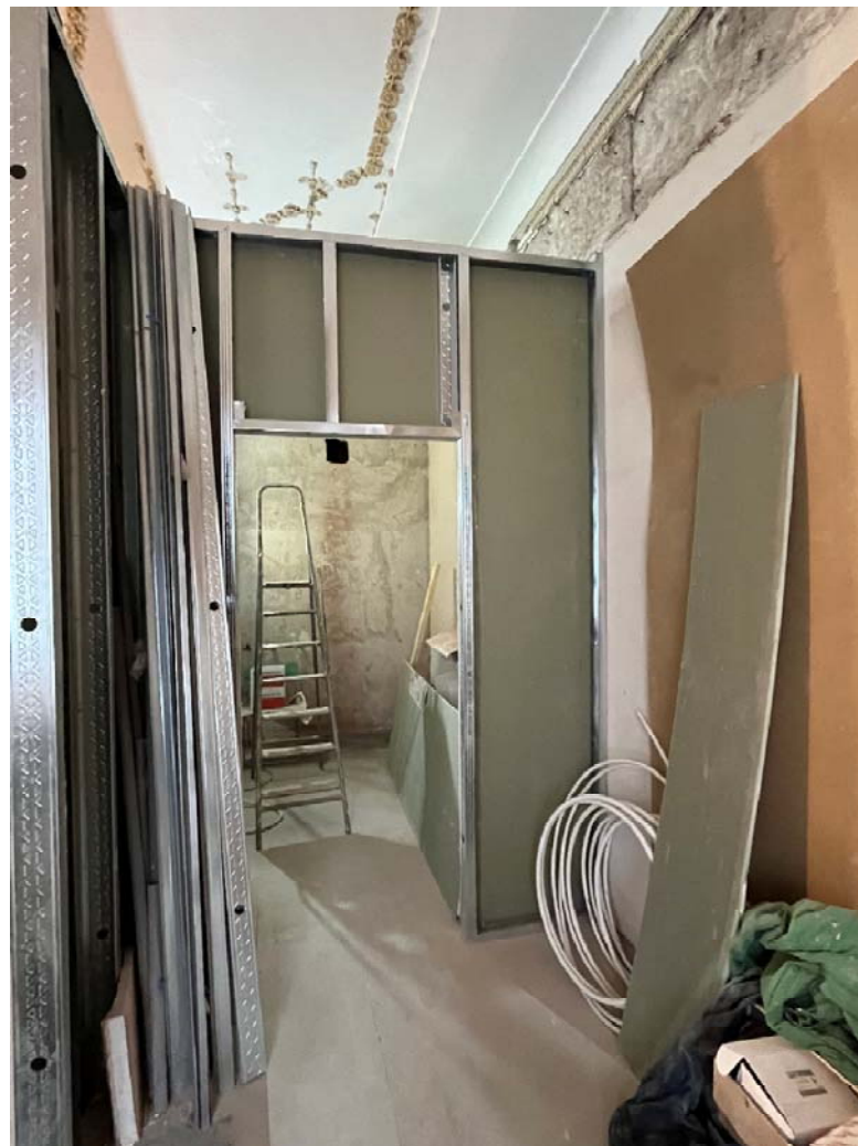
Фото №8. Квартира №45, перегородки из ГКЛ.
