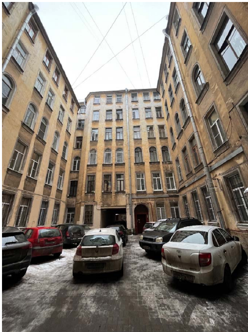
Фото №3. Дворовые фасады.
