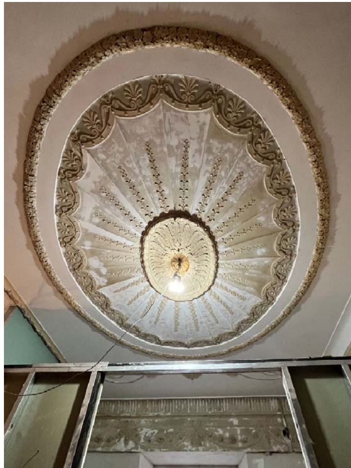
Фото №10. Квартира №45, отделка потолка.
