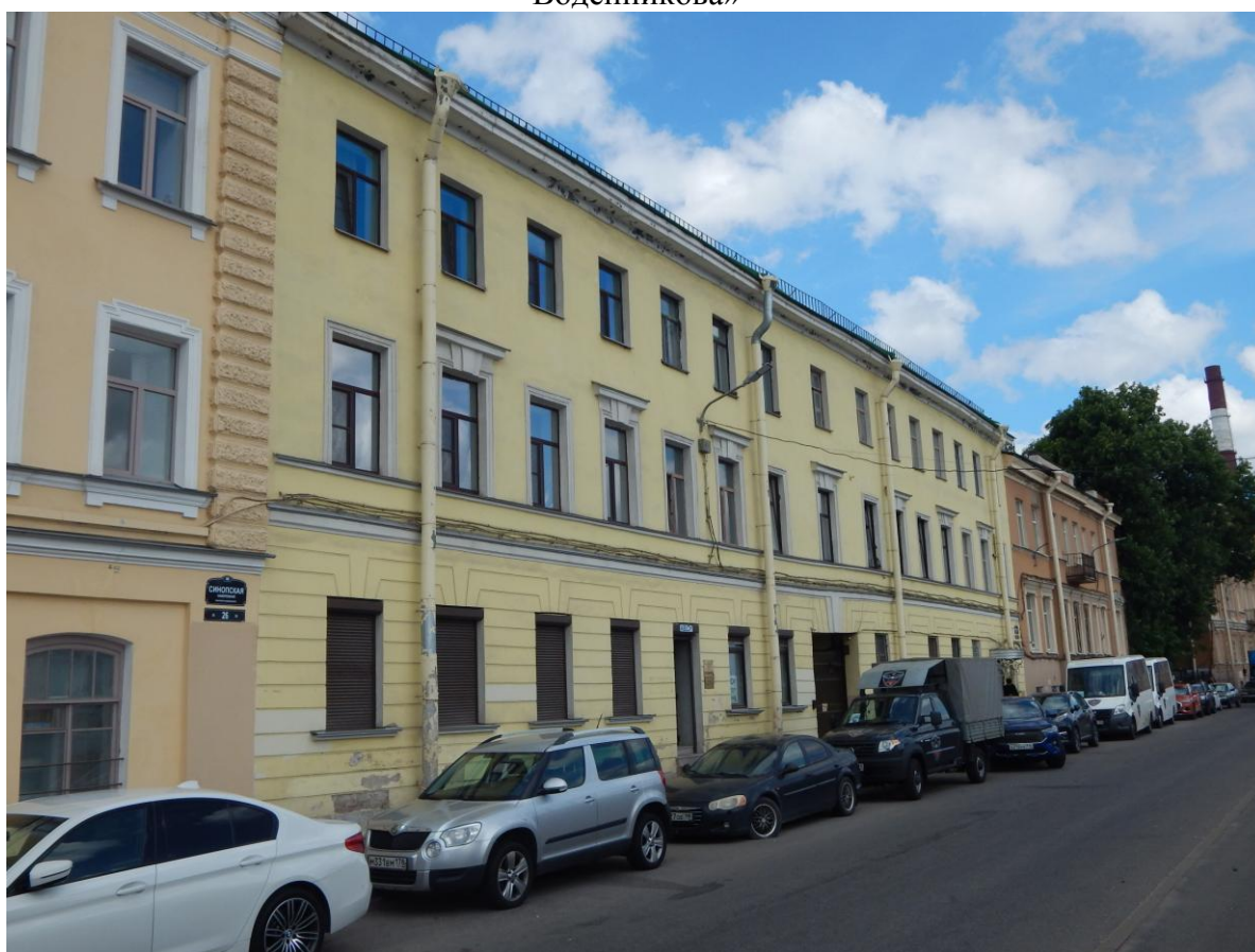
Фото 4. Лицевой фасад выявленного объекта культурного наследия «Дом Трофимовых»
