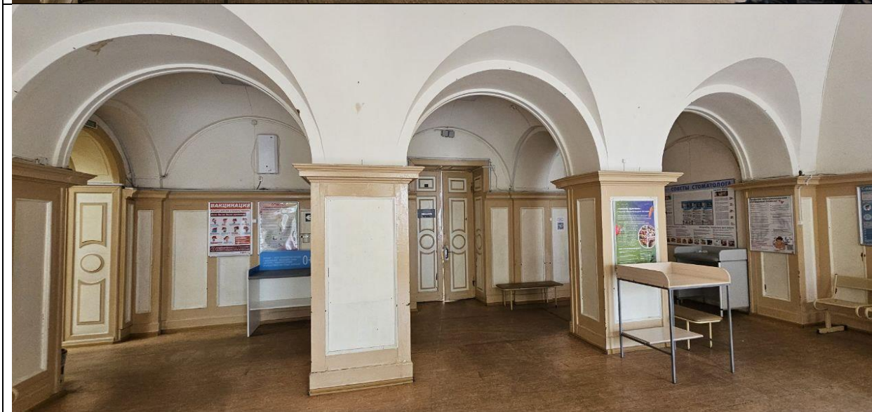
Фото 13,14,15. Общий вид помещений второго этажа.
