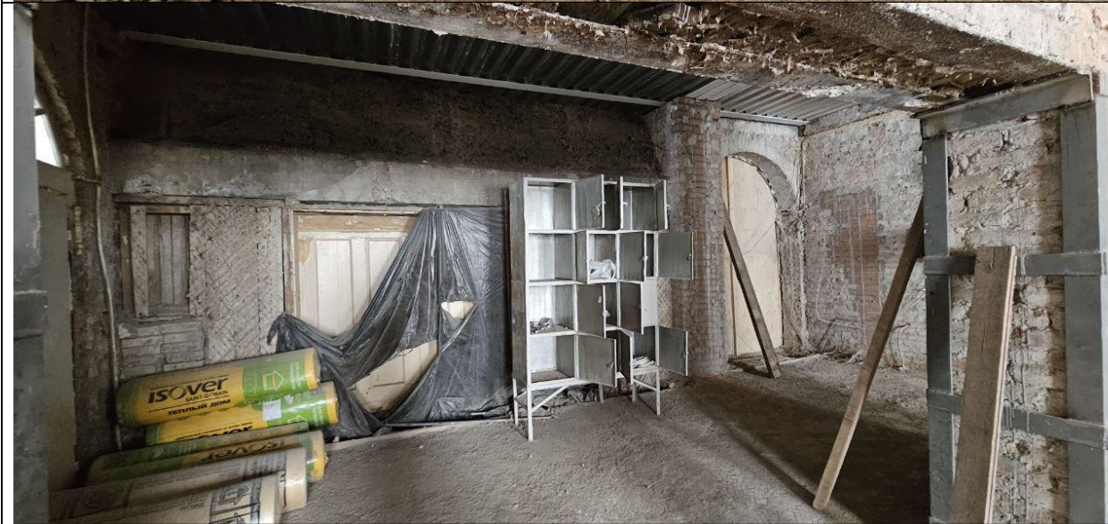
Фото 21,22,23. Общий вид помещений.
