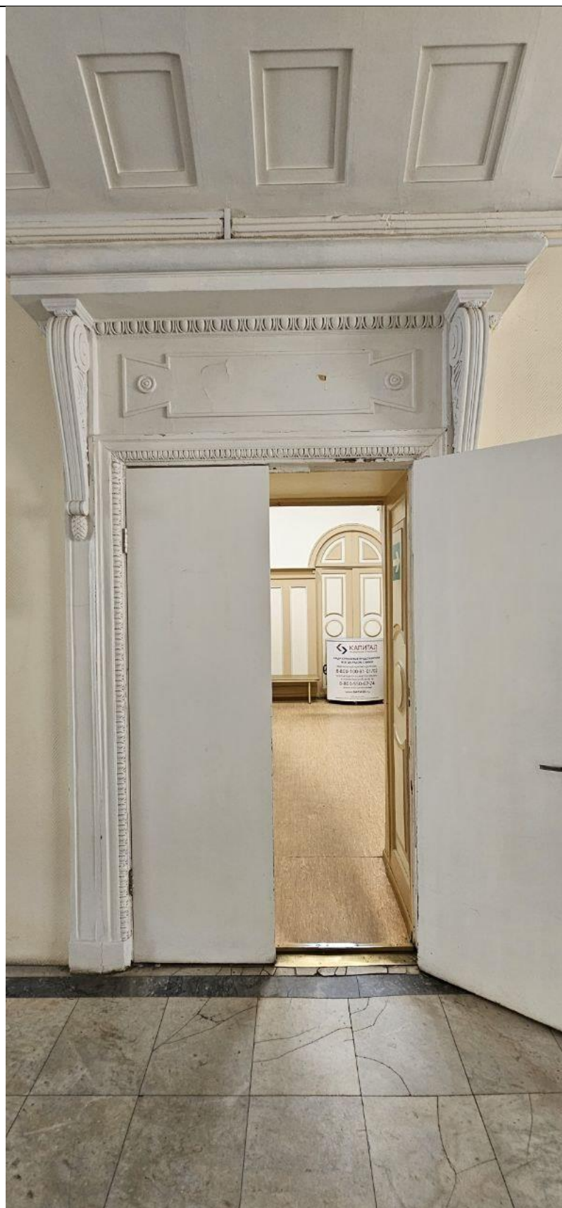
Фото 12. Дверной проем на площадке парадной лестницы.
