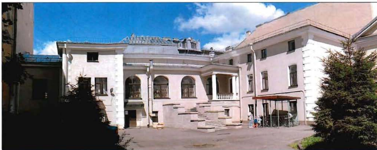
2. Общий вид с юга.
