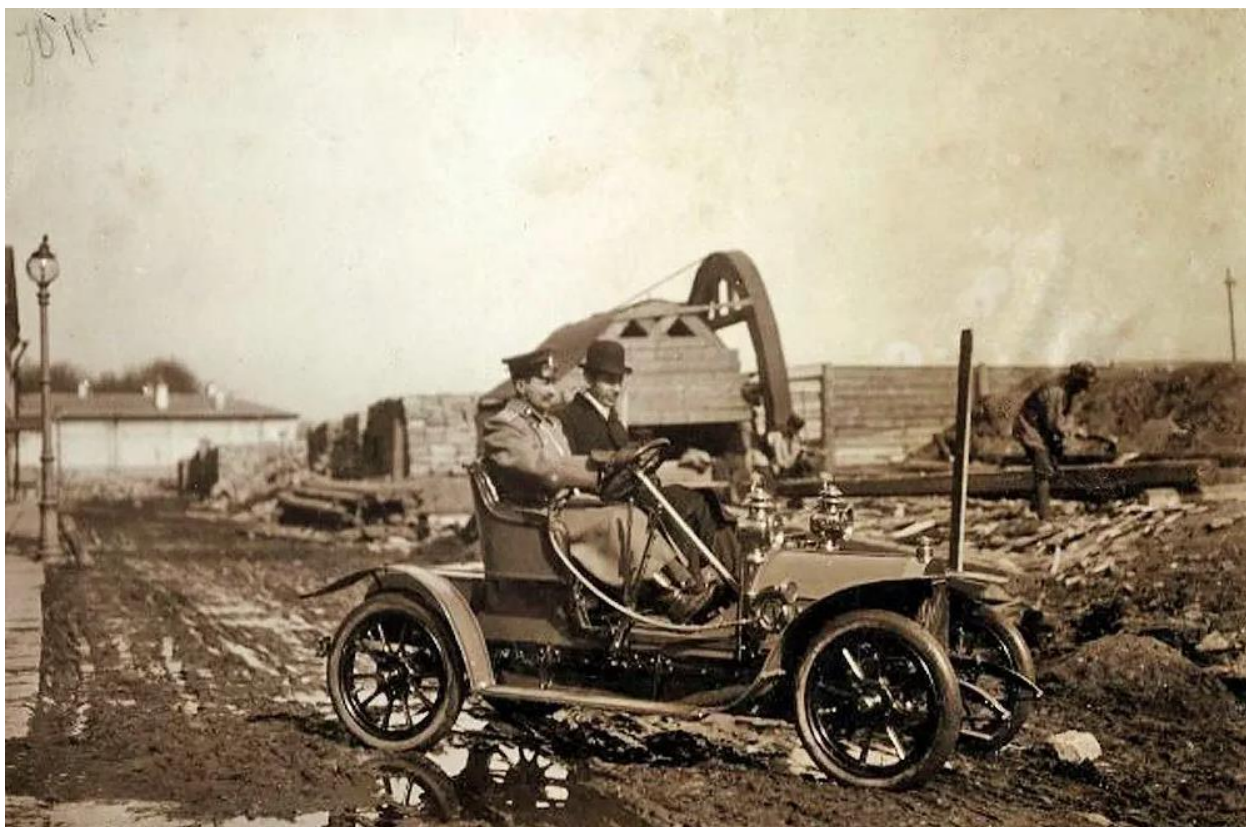
Илл. 7. На строительстве моста Петра Великого. Дата: 1909 – 1911 гг. Источник: pastvu.com.
