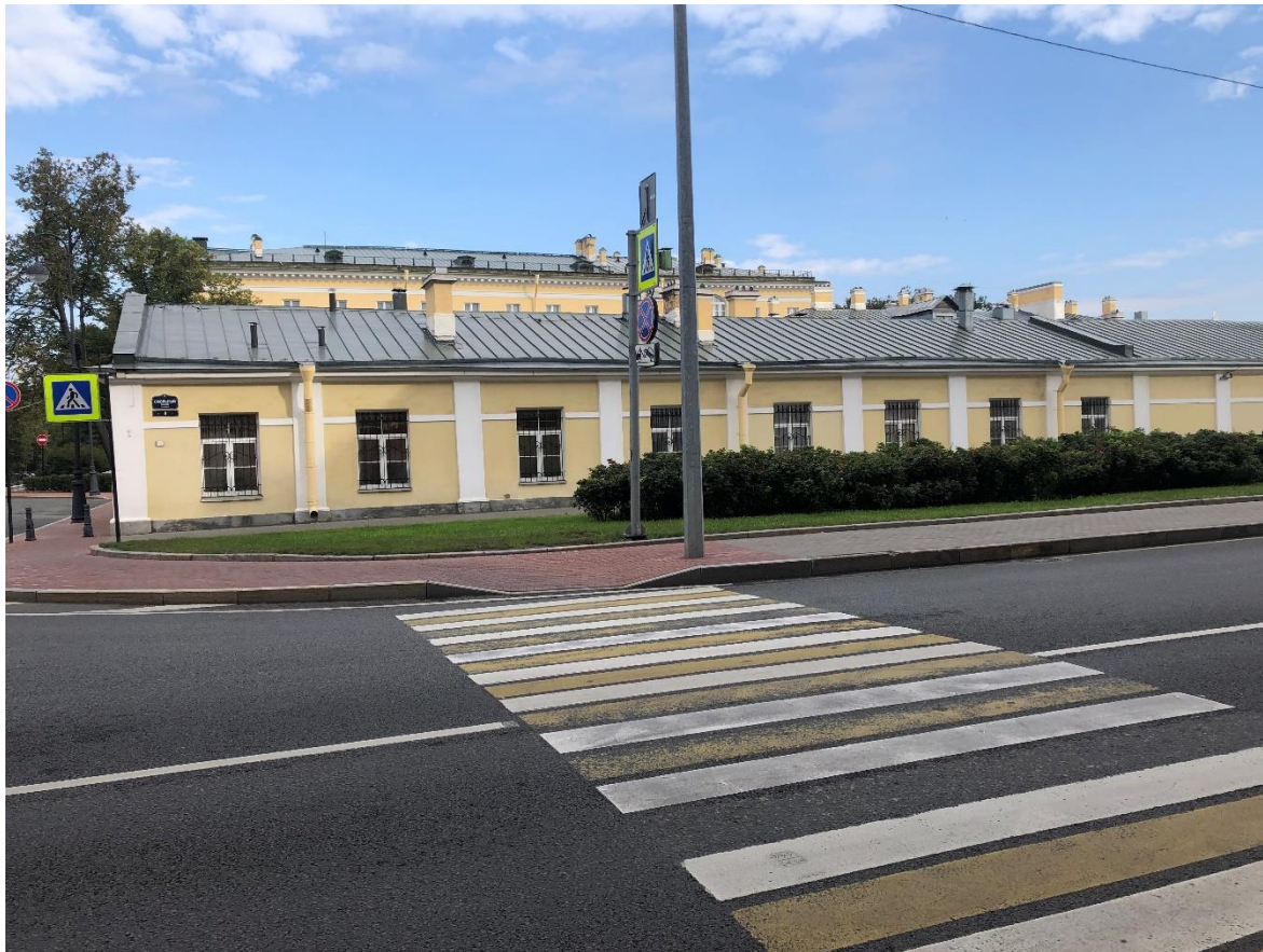
Фото 2. Вид на лицевой фасад по Смольному проспекту.
