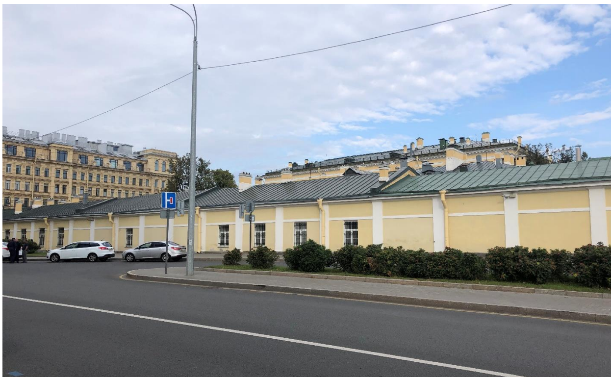
Фото 3. Вид на лицевой фасад по Смольному проспекту.
