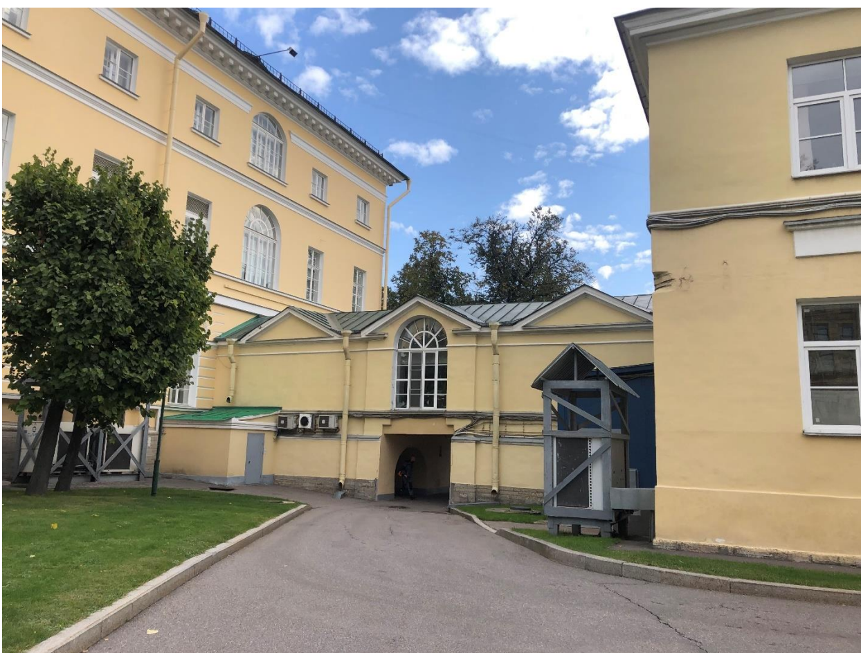
Фото 6. Переход между служебным и главным корпусами.
