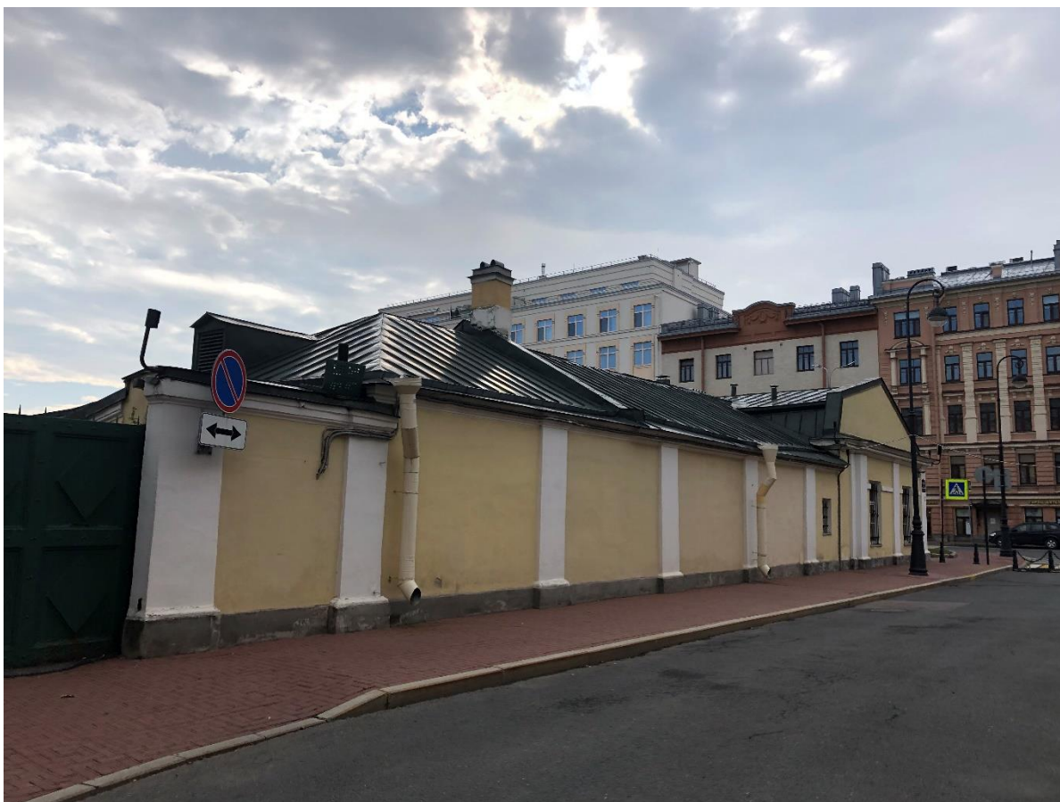
Фото 1. Вид на лицевой фасад по Смольному проезду.
