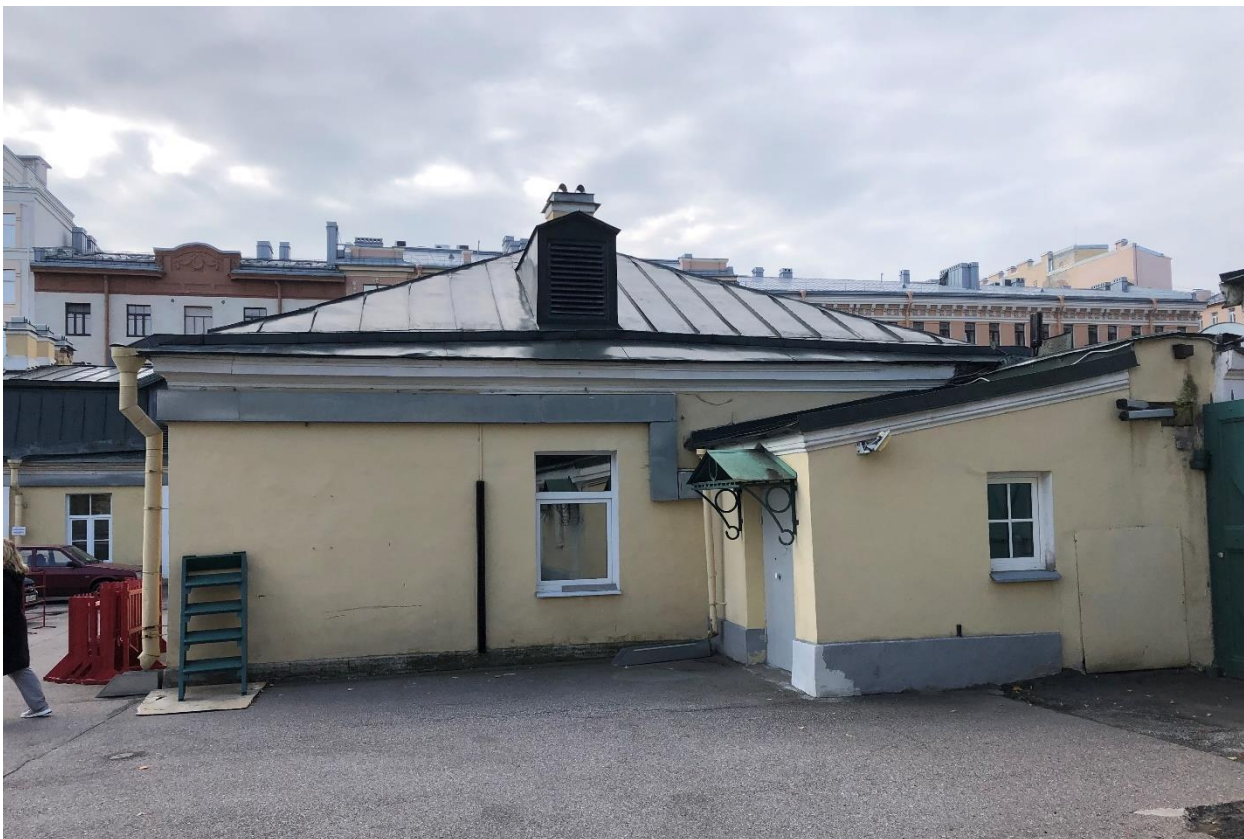
Фото 7. Вид на торцевой фасад.
