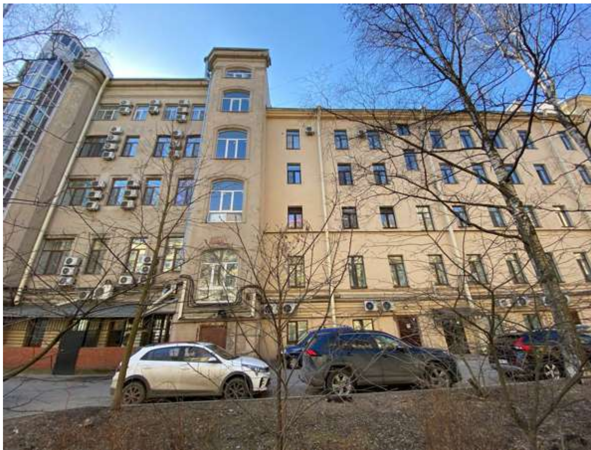
3. Вид на дворовой фасад
