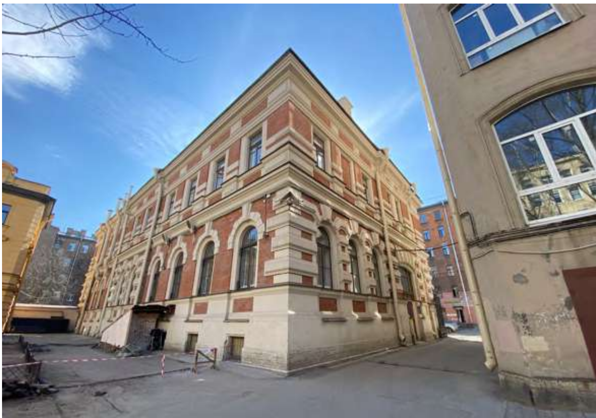
3. Вид на здание столовой со двора
