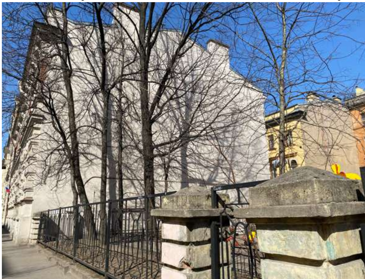
2. Вид на торцевую часть здания столовой
