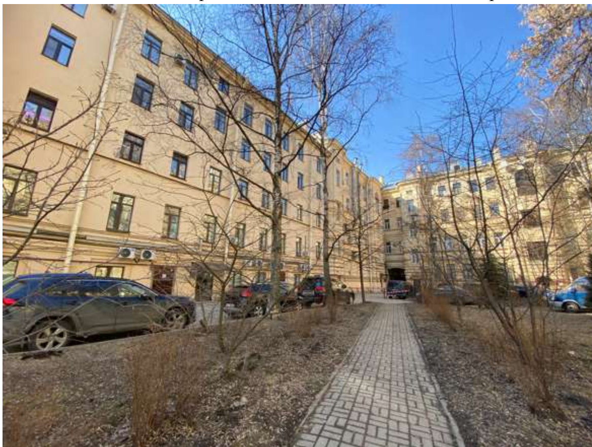
2. Вид на дворовой фасад
