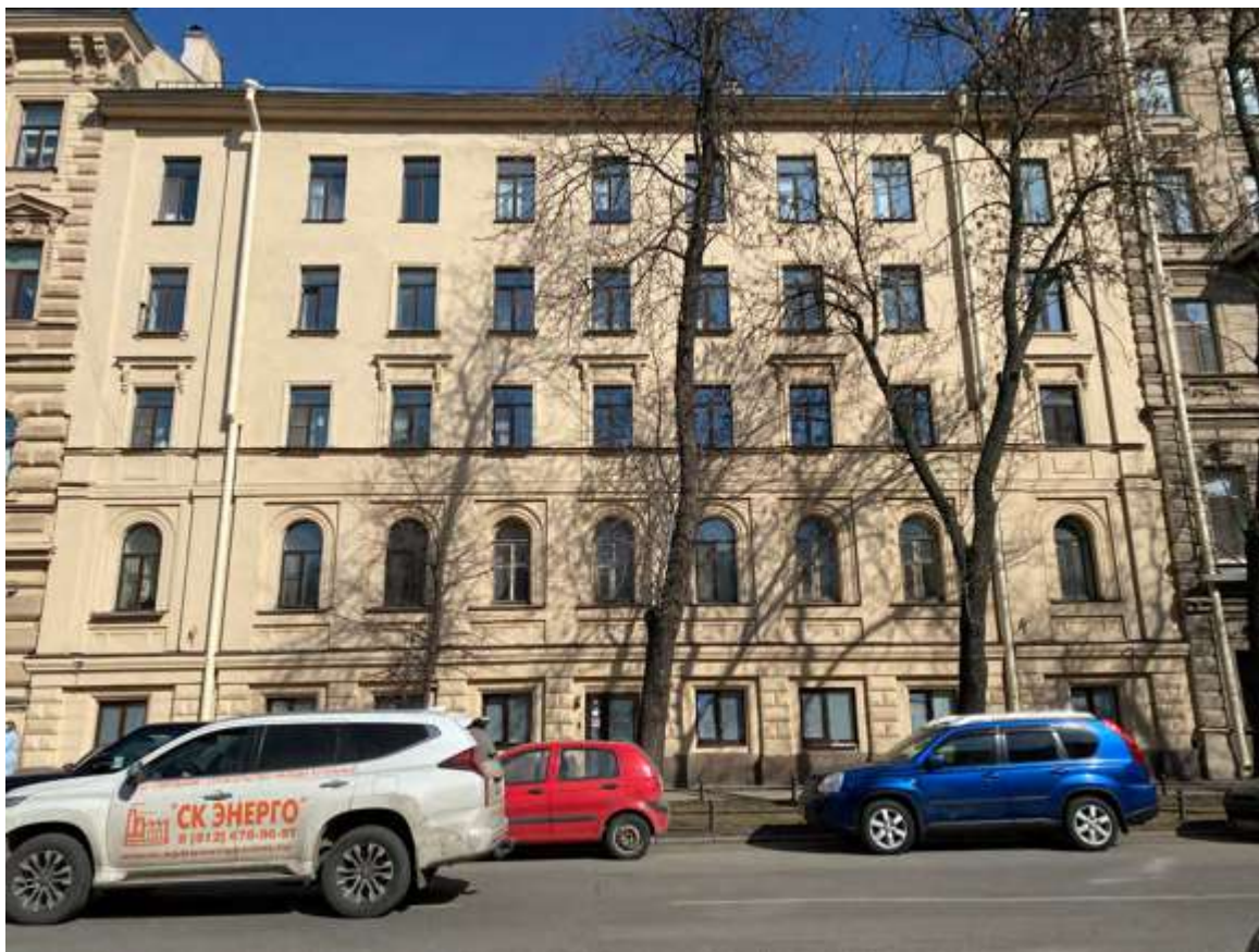
1. Лицевой фасад по 12 линии Васильевского острова
