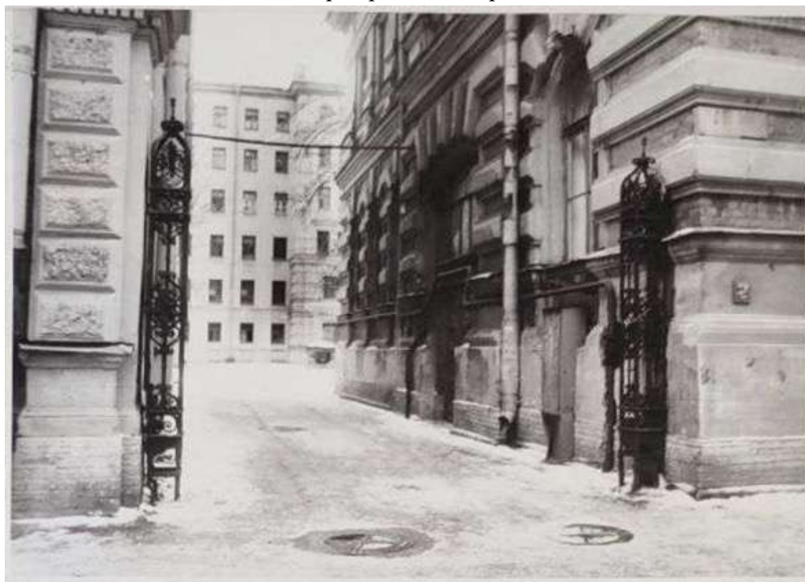
124. Вид ограждения. 1995 г. Архив КГИОП п. 950-VI-14 А-936
