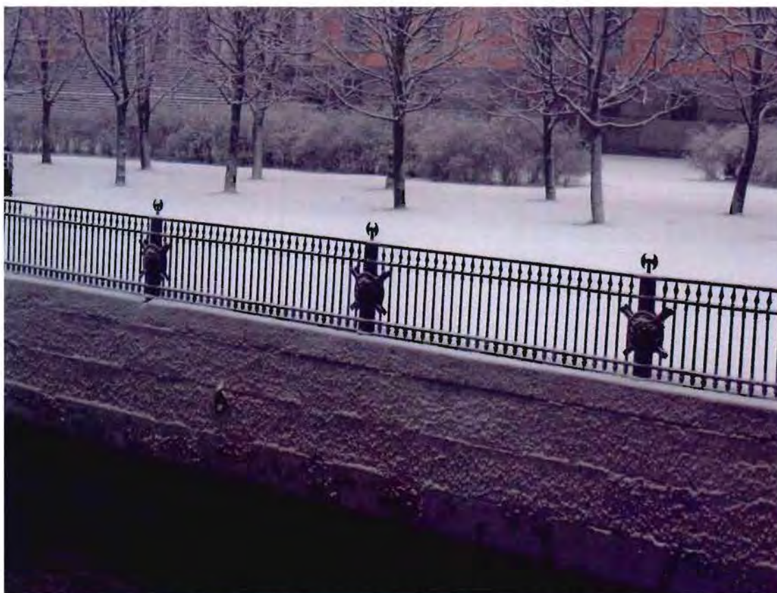
3. Ограждение набережной со стороны Михайловского (Инженерного) замка
