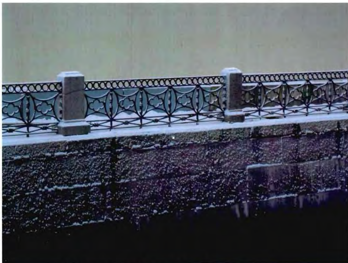
6. Ограждение набережной. Левобережная стенка
