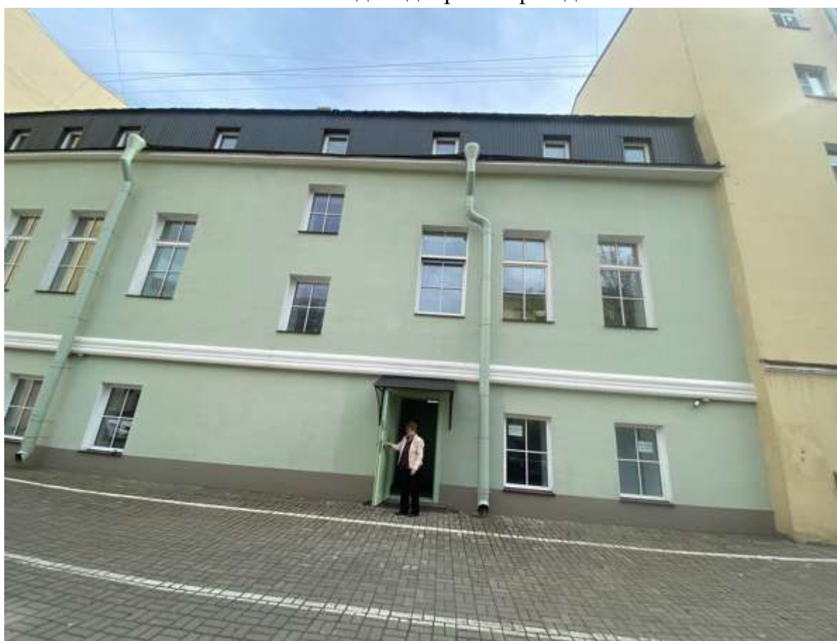
5. Вид на дворовой фасад
