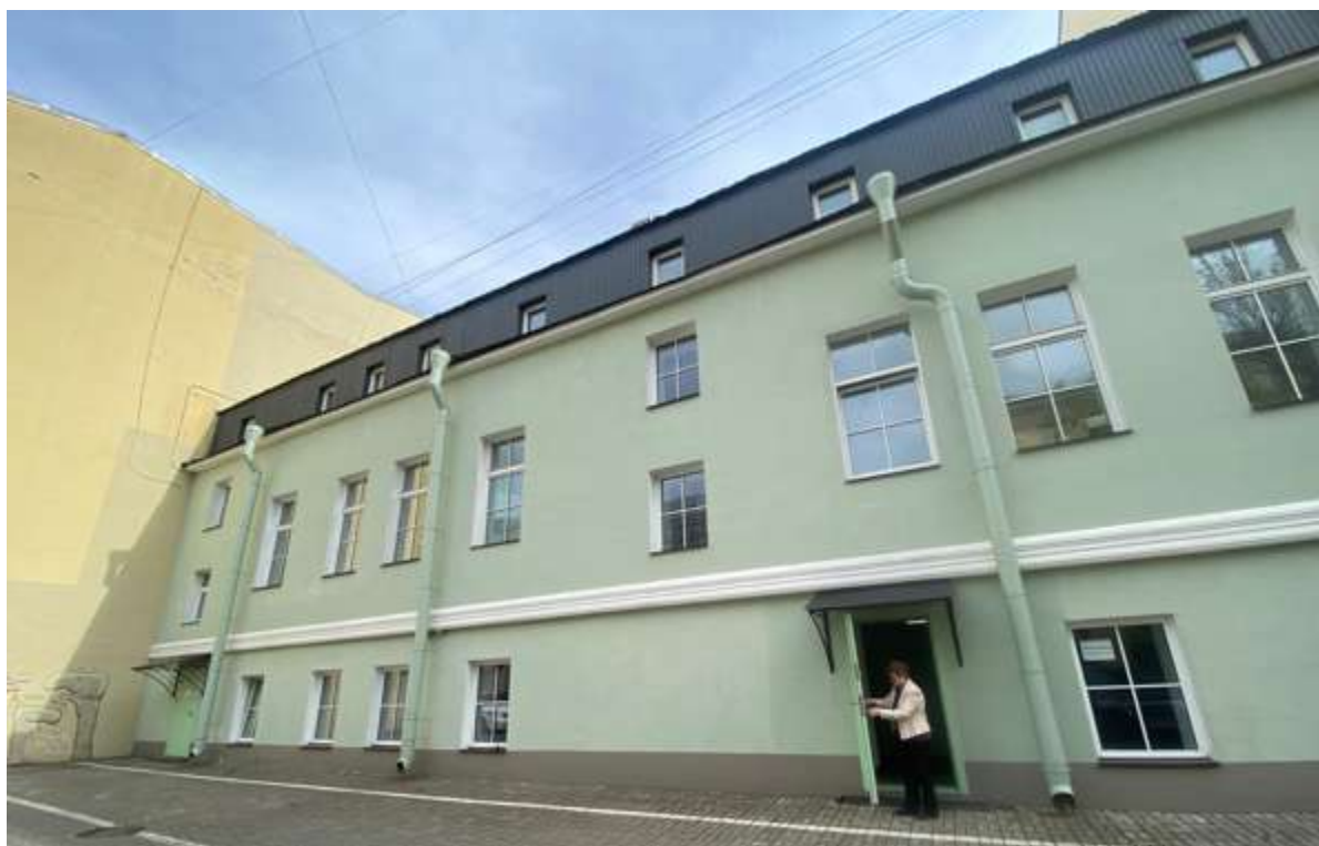
4. Вид на дворовой фасад
