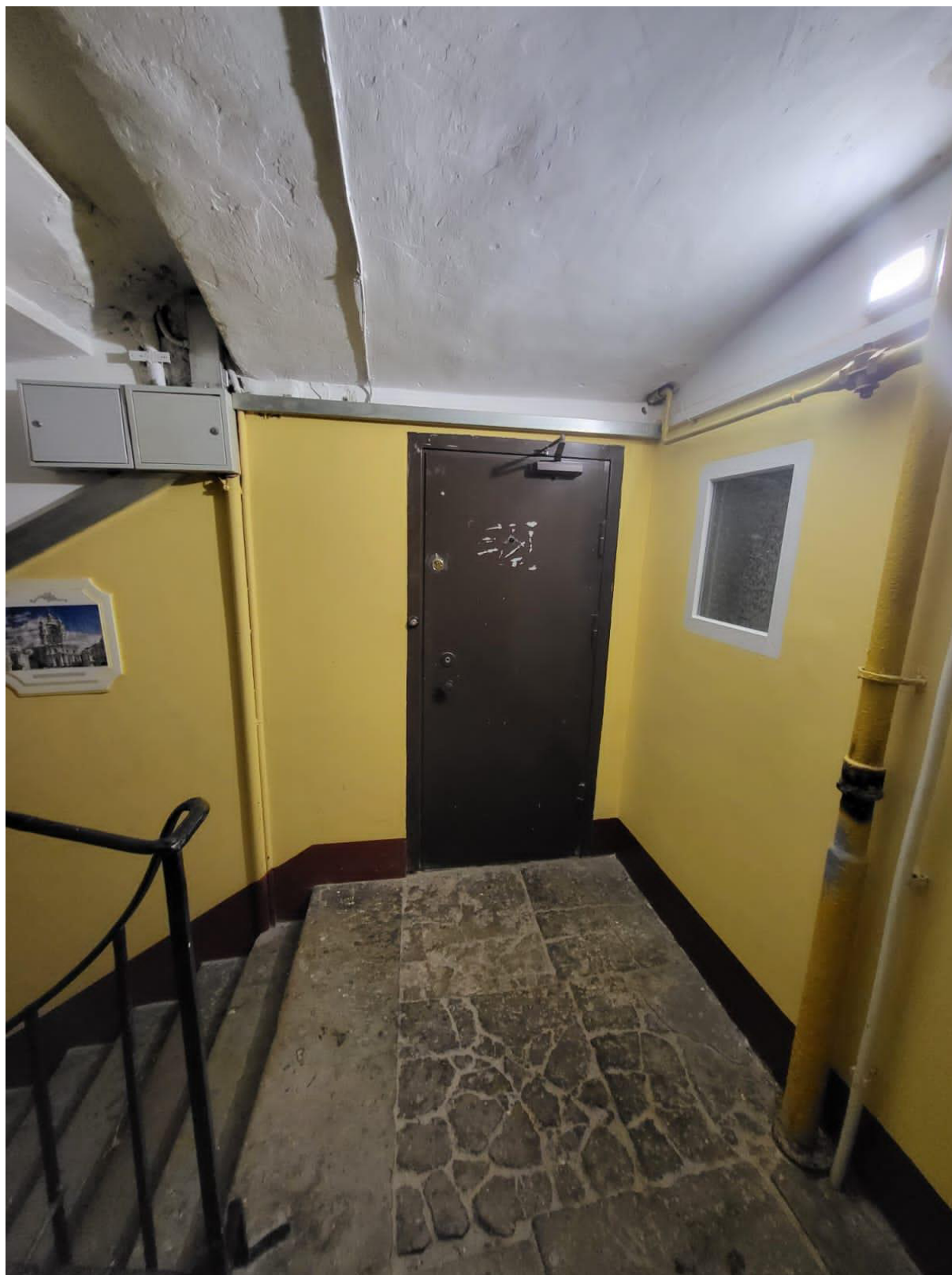
Фото 2. Вход в квартиру №5.
