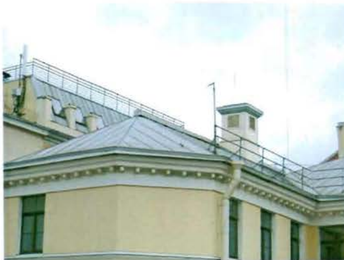
8. Металлическое покрытие кровли
