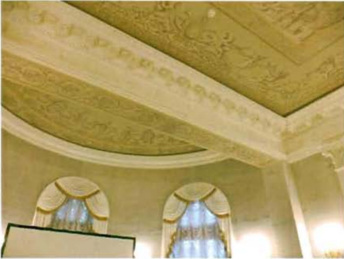
50. Декор на опорных балках в пом. 2Н (164)
