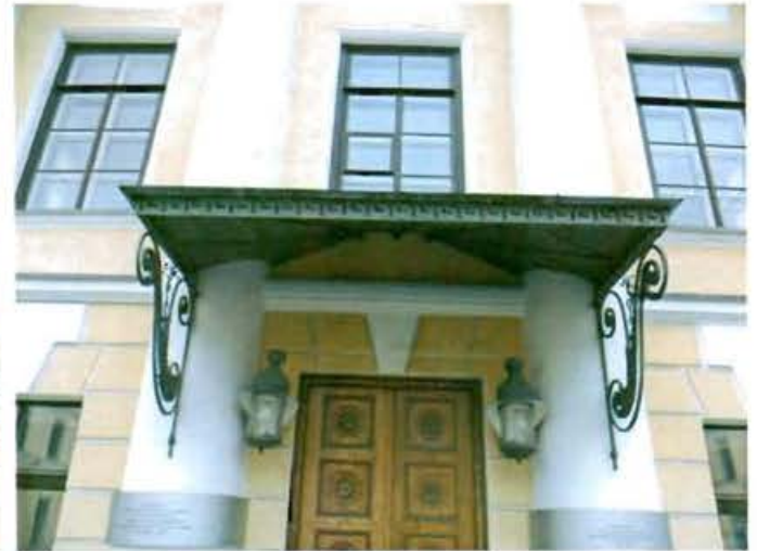
9. Кованый козырек на кронштейнах над входом
