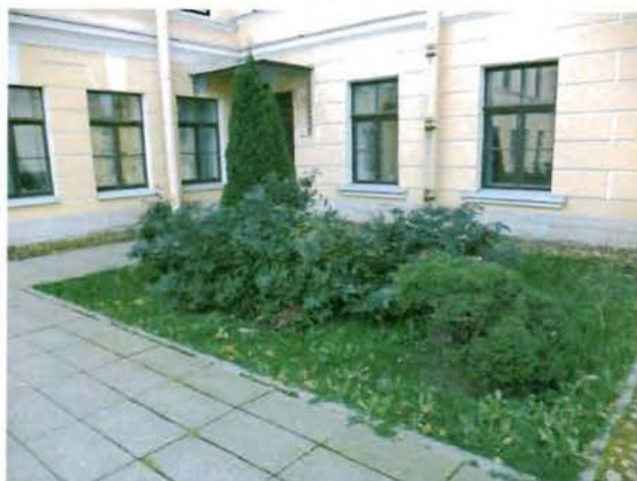
65. Газонный участок с насаждениями с восточной стороны
