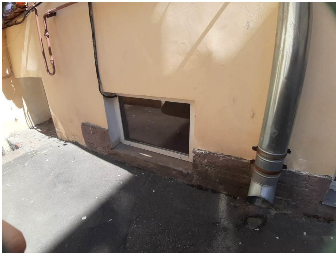
11. Дом Ф. Демидовой (ул. Большая Подьяческая, д. 29, лит. А). Вид на пом. 2-Н со двора. Штиглиц М.С. 05.04.2023.
