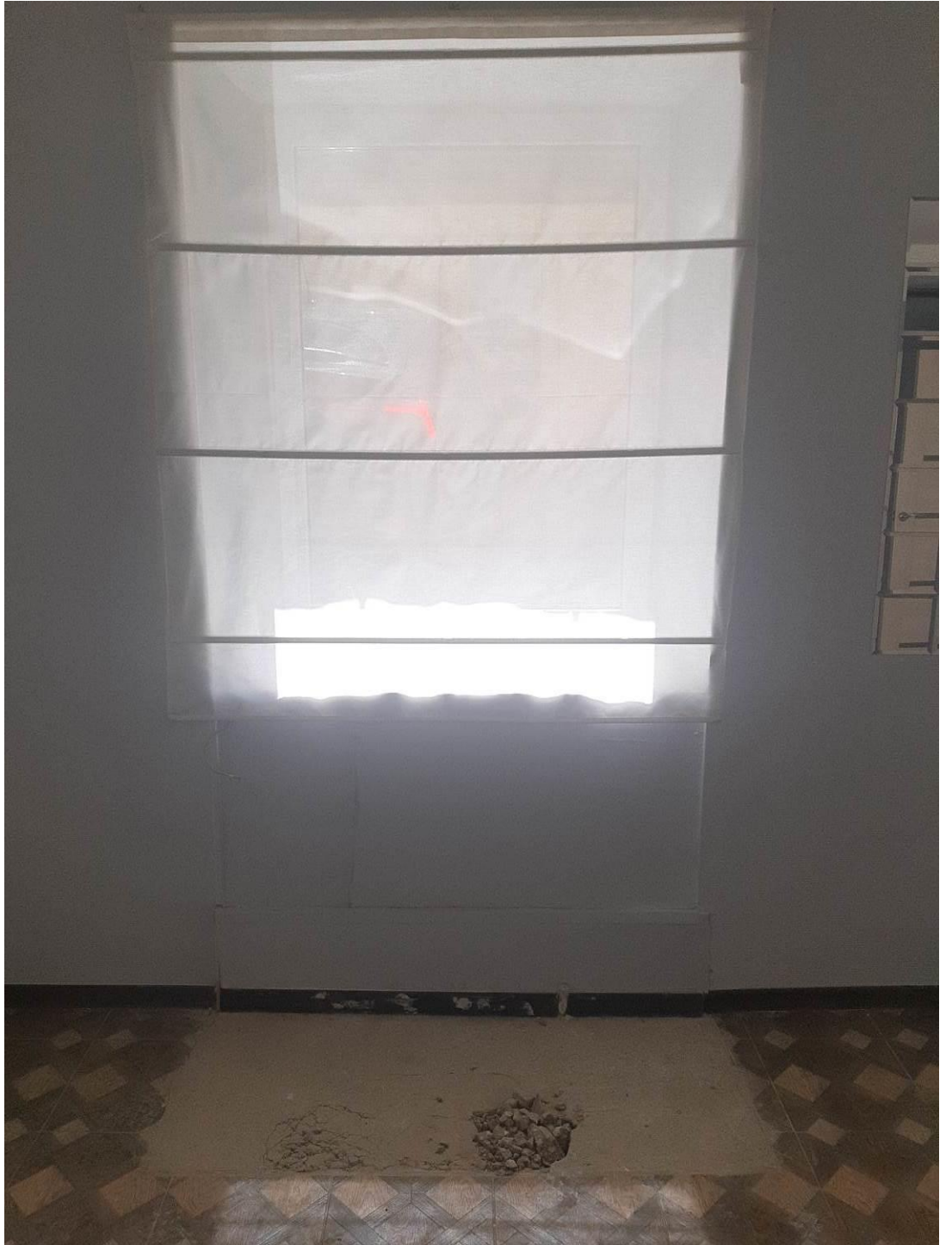
27. Дом Ф. Демидовой (ул. Большая Подьяческая, д. 29, лит. А). Интерьер пом. 1-Н. Заложенный вход. Штиглиц М.С. 05.04.2023.
