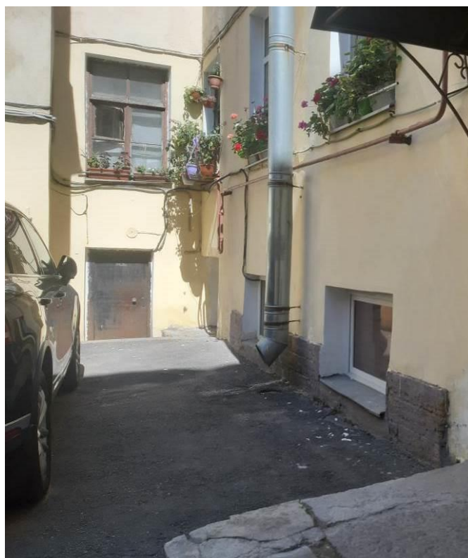
12. Дом Ф. Демидовой (ул. Большая Подьяческая, д. 29, лит. А). Вид на пом. 2-Н со двора. Штиглиц М.С. 05.04.2023.
