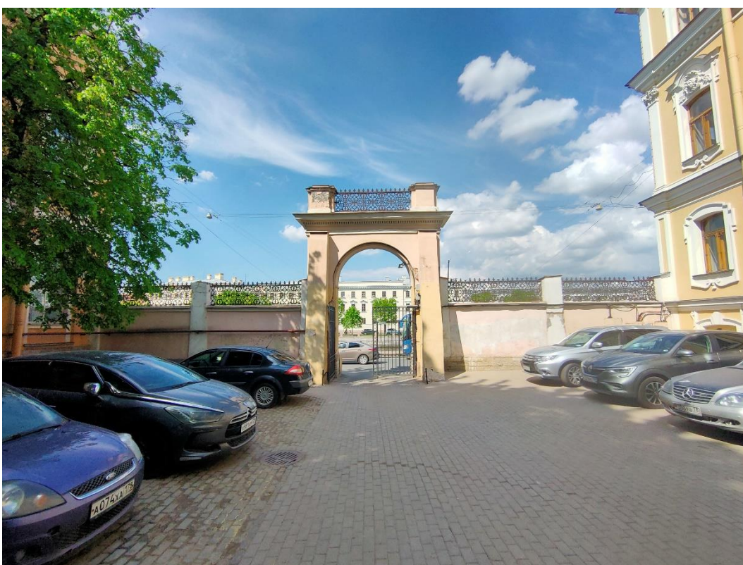
2. «Ограда с воротами», входящие в состав объекта культурного наследия федерального значения «Дом Дубяньских (Зиновьева Н.В., Карловой Н.Ф.), наб. р. Фонтанки, д.46. Общий вид с востока. Фото 15.05.2023г.
