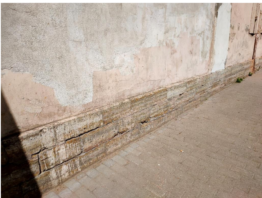
14. «Ограда с воротами», входящие в состав объекта культурного наследия федерального значения «Дом Дубяньских (Зиновьева Н.В., Карловой Н.Ф.)», наб. р. Фонтанки, д.46. Восточная часть ограды. Фрагмент. Фото 15.05.2023г.
