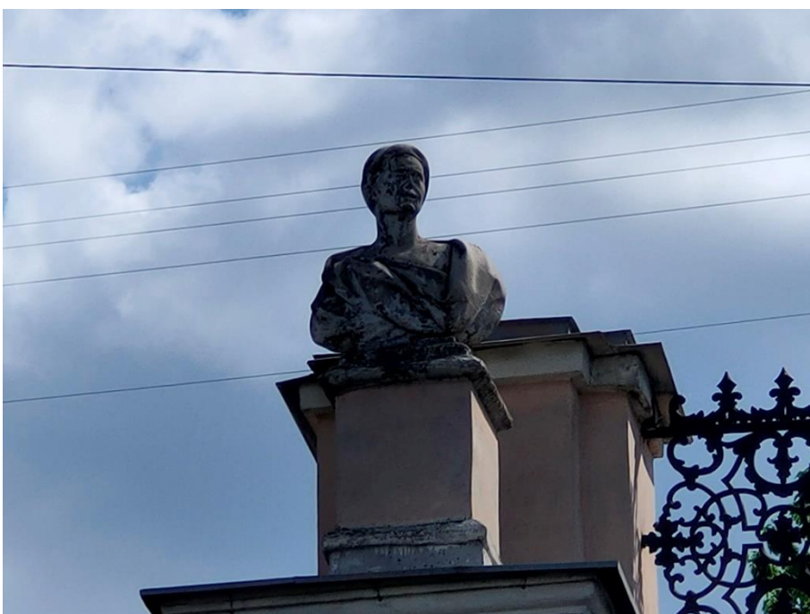
34. «Ограда с воротами», входящие в состав объекта культурного наследия федерального значения «Дом Дубяньских (Зиновьева Н.В., Карловой Н.Ф.)», наб. р. Фонтанки, д.46. Западная часть ограды. Фрагмент. Фото 15.05.2023г.
