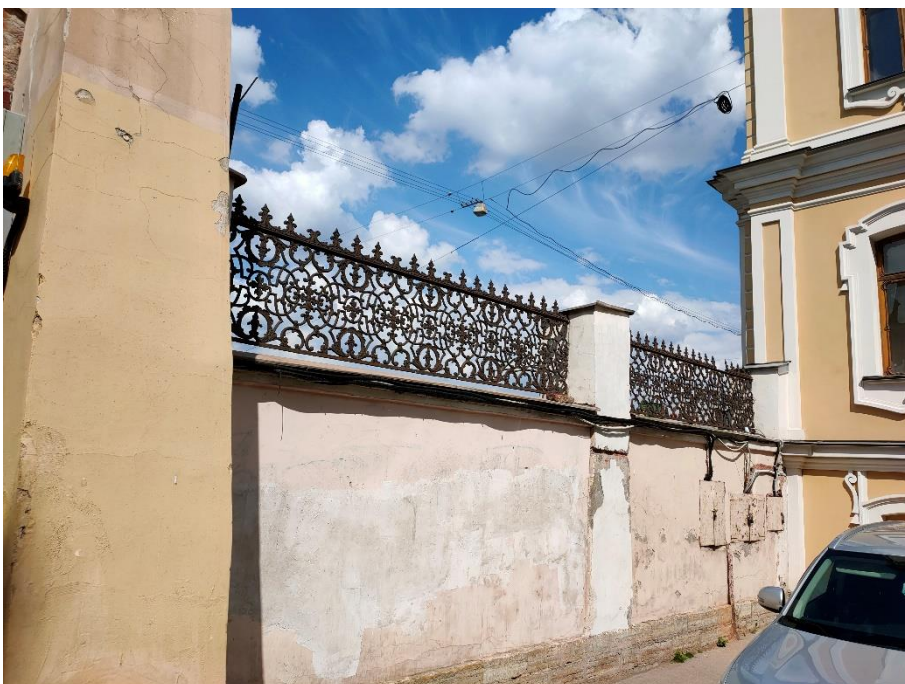
13. «Ограда с воротами», входящие в состав объекта культурного наследия федерального значения «Дом Дубяньских (Зиновьева Н.В., Карловой Н.Ф.)», наб. р. Фонтанки, д.46. Восточная часть ограды. Фрагмент. Фото 15.05.2023г.
