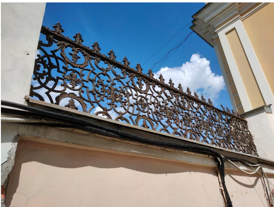
15. «Ограда с воротами», входящие в состав объекта культурного наследия федерального значения «Дом Дубяньских (Зиновьева Н.В., Карловой Н.Ф.), наб. р. Фонтанки, д.46. Восточная часть ограды. Фрагмент. Фото 15.05.2023г.
