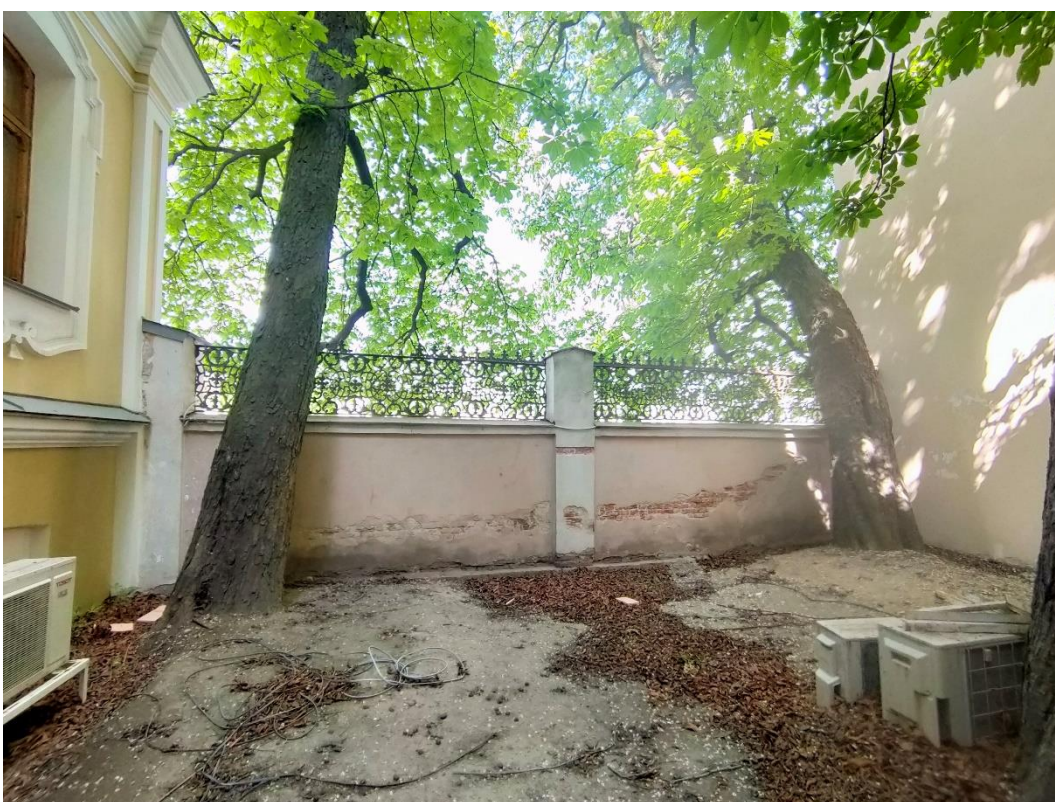
4. «Ограда с воротами», входящие в состав объекта культурного наследия федерального значения «Дом Дубяньских (Зиновьева Н.В., Карловой Н.Ф.), наб. р. Фонтанки, д.46. Общий вид с востока. Фото 15.05.2023г.
