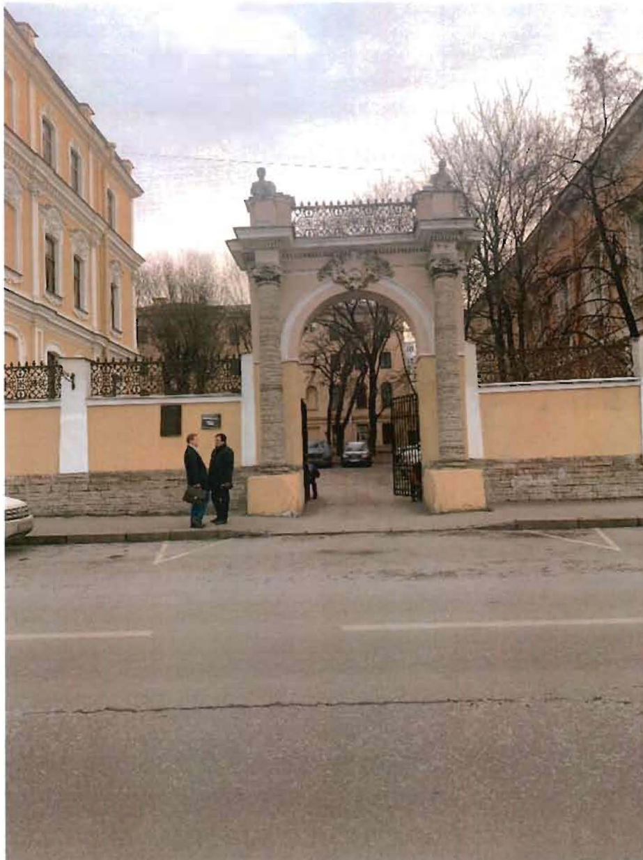
1. Вид на объект культурного наследия с западной стороны.
