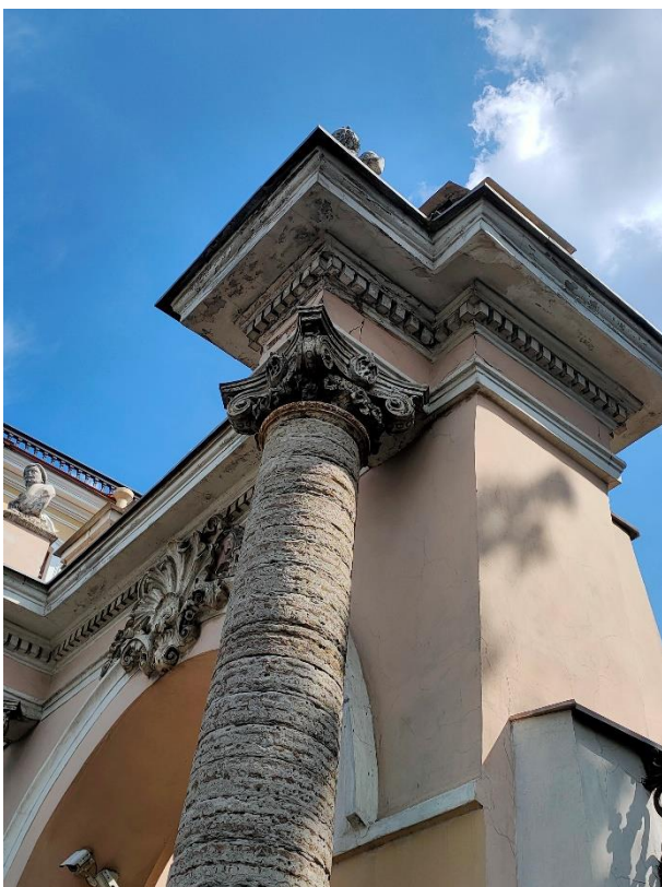
30. «Ограда с воротами», входящие в состав объекта культурного наследия федерального значения «Дом Дубяньских (Зиновьева Н.В., Карловой Н.Ф.), наб. р. Фонтанки, д.46. Западная часть ограды. Фрагмент. Фото 15.05.2023г.
