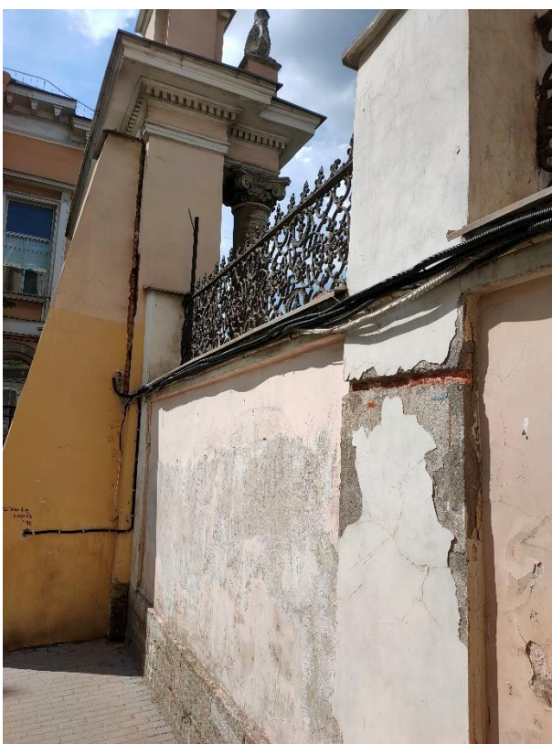
16. «Ограда с воротами», входящие в состав объекта культурного наследия федерального значения «Дом Дубяньских (Зиновьева Н.В., Карловой Н.Ф.), наб. р. Фонтанки, д.46. Восточная часть ограды. Фрагмент. Фото 15.05.2023г.
