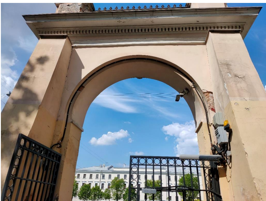
12. «Ограда с воротами», входящие в состав объекта культурного наследия федерального значения «Дом Дубяньских (Зиновьева Н.В., Карловой Н.Ф.), наб. р. Фонтанки, д.46. Восточная часть ограды. Фрагмент. Фото 15.05.2023г.
