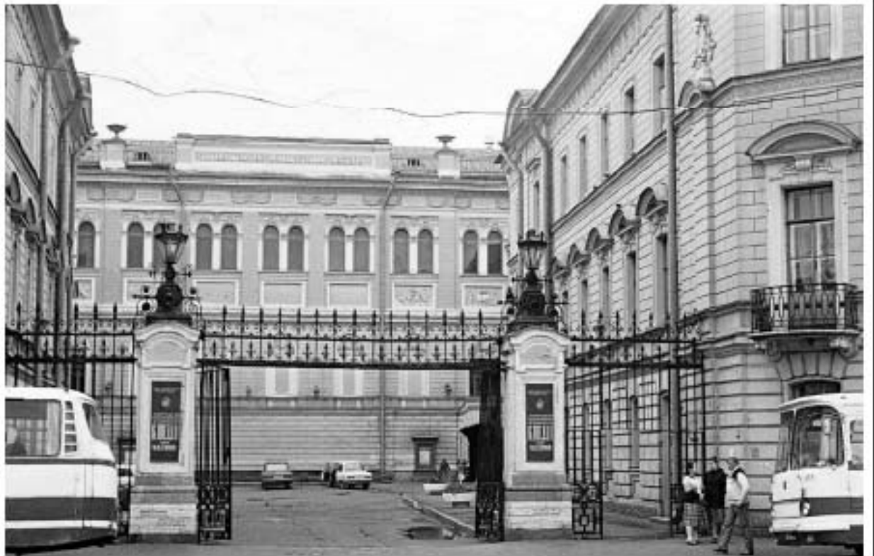
12. Вид на главный фасад капеллы, 1985 г.
