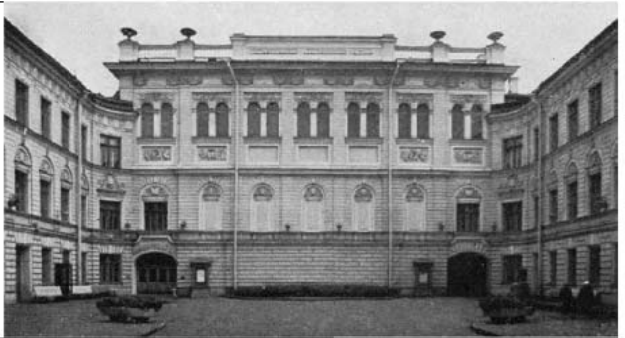
11. Академическая капелла имени М.И. Глинки. 1970 – 1981 гг. Источник: Иогансен М.В., Лисовский В.Г. «Ленинград.-2 издание. Архитектурно-художественные памятники городов СССР»
