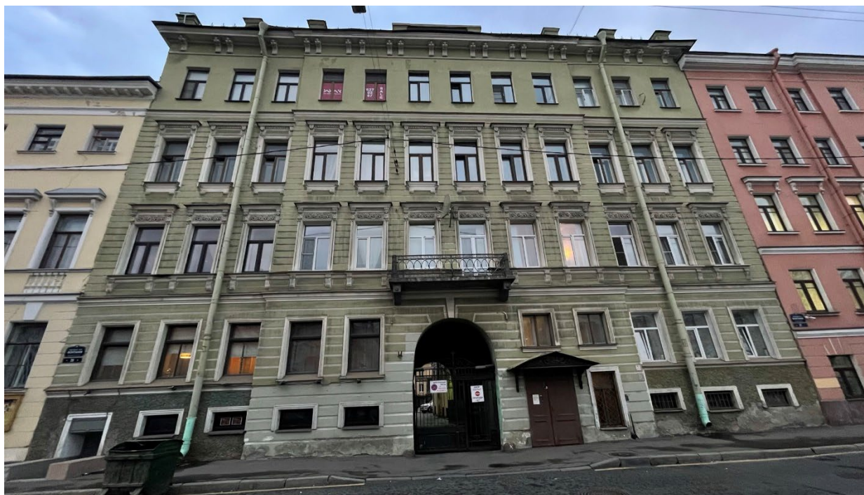
1. Вид на главный фасад здания и окна квартиры по адресу: г.Санкт-Петербург, набережная реки Фонтанки, дом 39, литера А;
