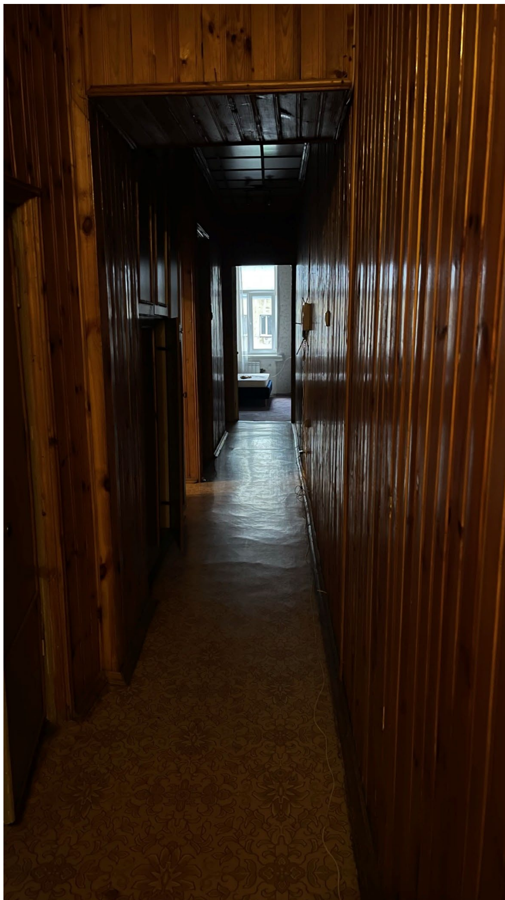
7. Фрагмент интеръера коридора (помещение 5/21.40);
