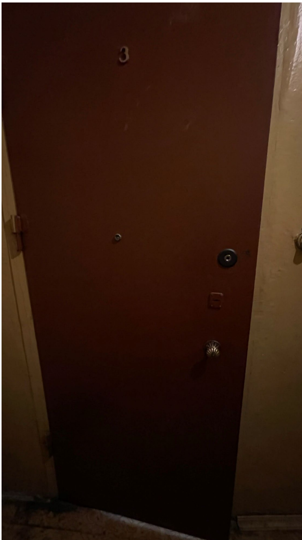
4. Вид на входную дверь в квартиру;
