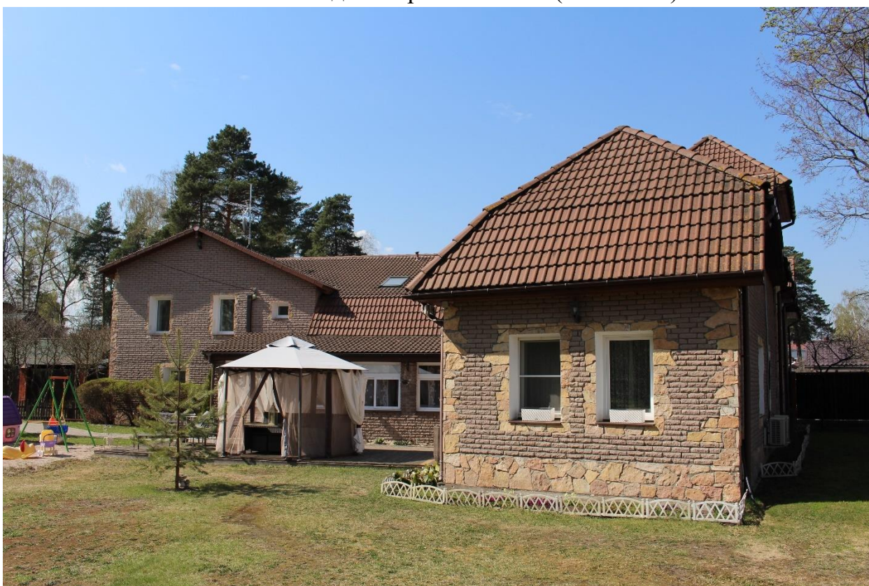
Фото 57. Вид на выявленные объекты культурного наследия «Флигель (каменный 2-этажный)», «Флигель с водонапорной башней (каменный)» с востока.
