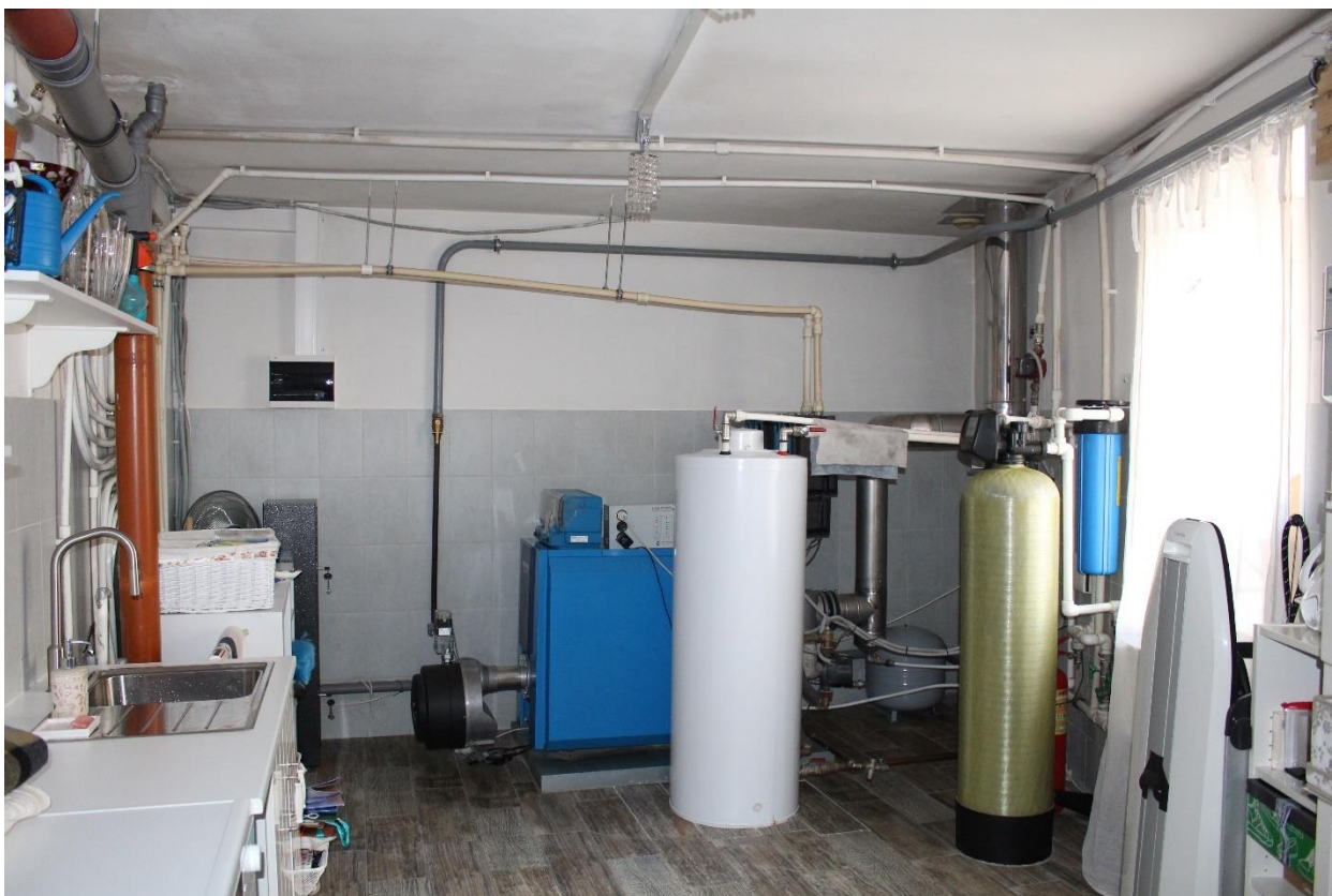
Фото 76. Внутренние помещения выявленных объектов культурного наследия «Флигель (каменный 2-этажный)», «Флигель с водонапорной башней (каменный)». 4-Н. Помещение № 2.
