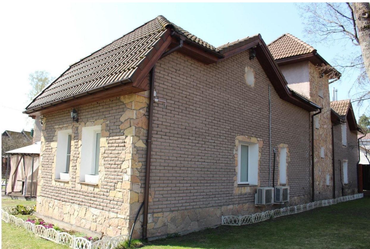
Фото 58. Вид на северный фасад выявленного объекта культурного наследия «Флигель с водонапорной башней (каменный)».
