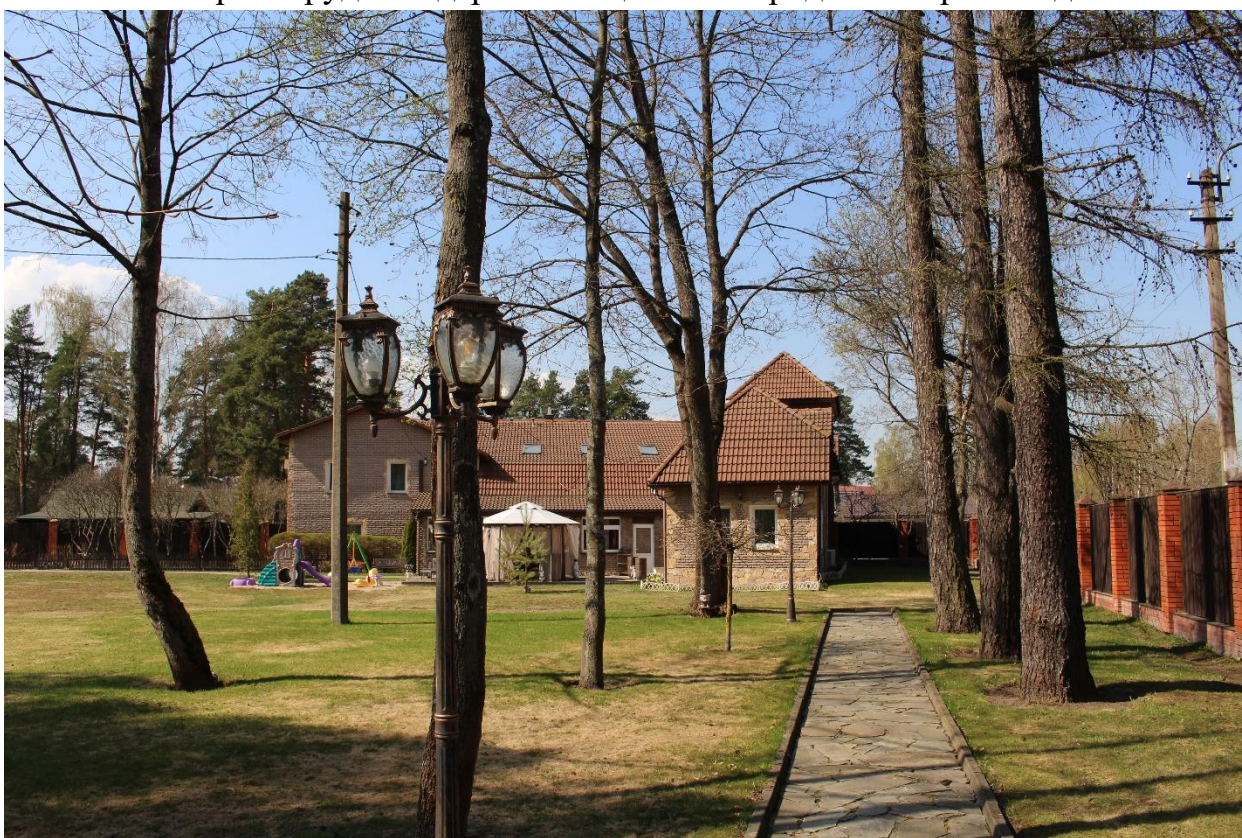
Фото 9. Вид на выявленные объекты культурного наследия «Флигель (каменный 2-этажный)», «Флигель с водонапорной башней (каменный)» с востока.
