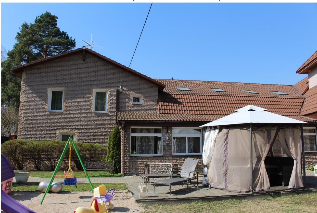
Фото 53. Вид на восточный фасад выявленного объекта культурного наследия «Флигель (каменный 2-этажный)».
