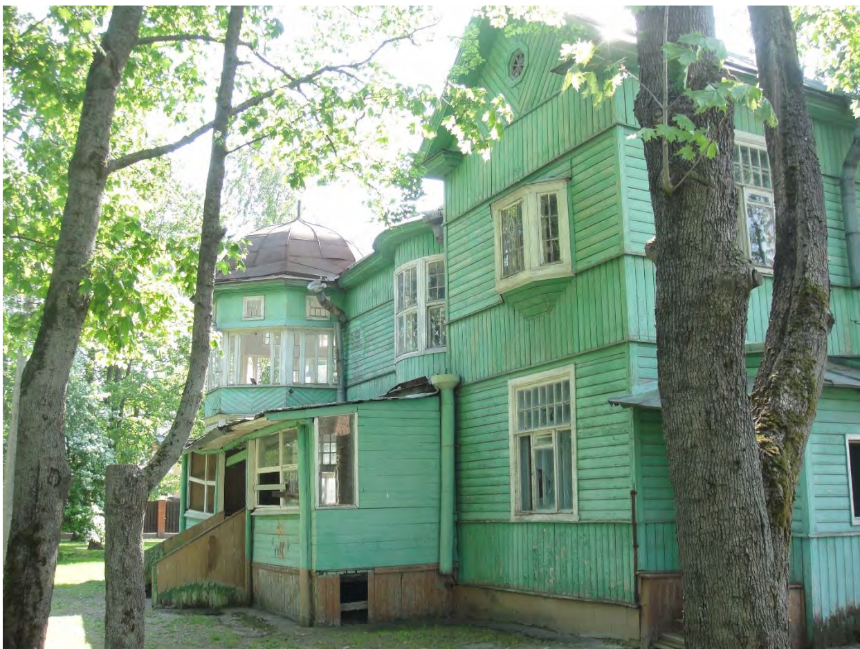
Илл. 52. Вид на дом (деревянный 2-этажный) с северо-востока. 02.06.2011 г. (источник: https://kgior.gov.spb.ru/o-komitete/press-centr/news/13489/?page=88 ).
