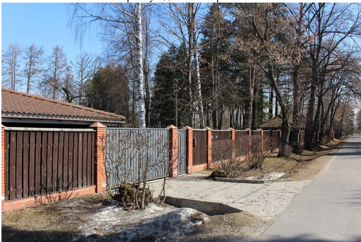
Фото 2. Вид на южную границу выявленного объекта культурного наследия «Комплекс построек усадьбы Полтрока» с юго-запада.
