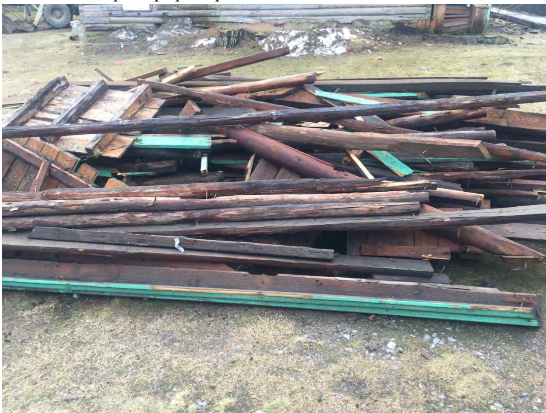
Илл. 68. Разборка деревянного двухэтажного здания в 2017 году (источник: фотография предоставлена собственником).
