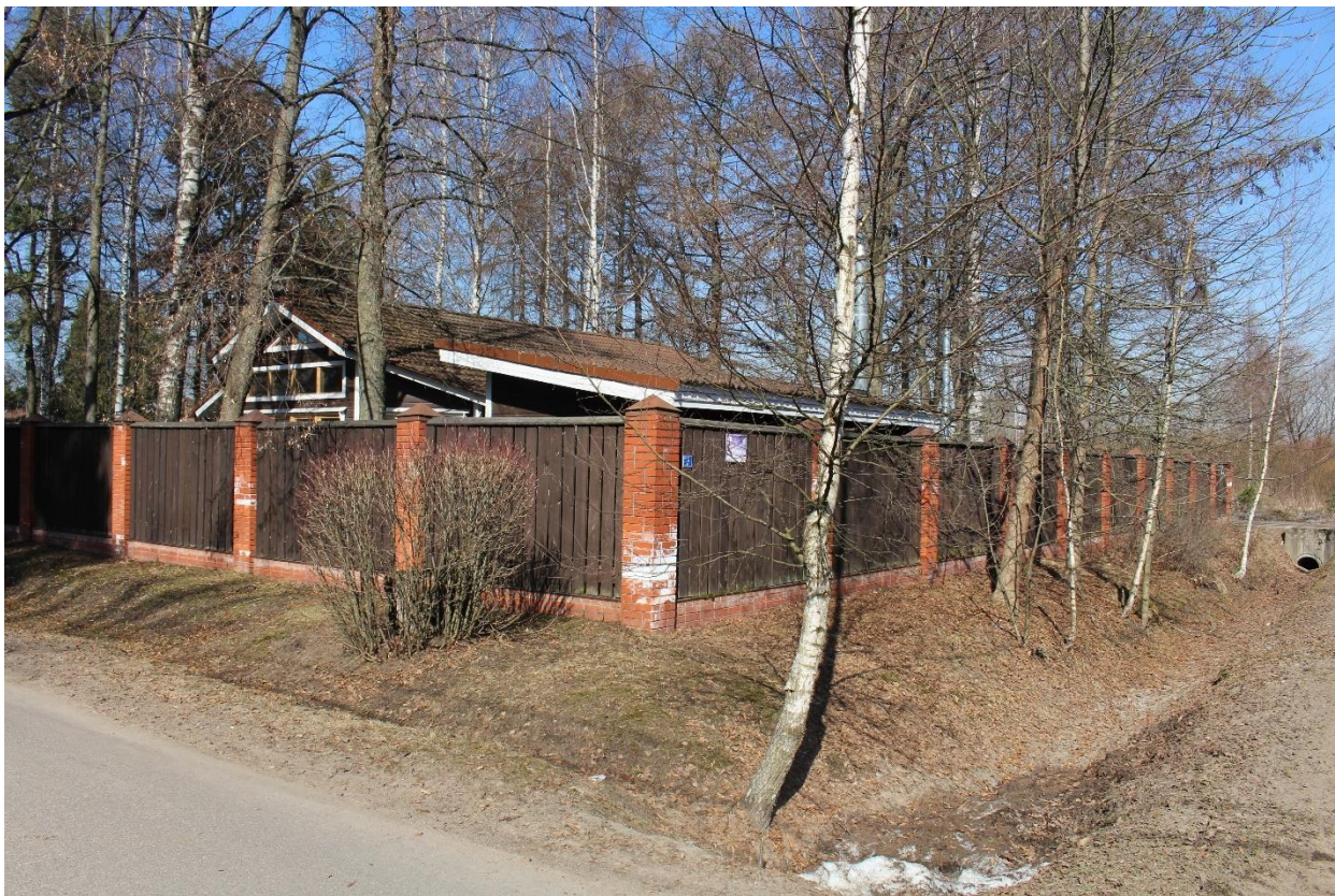
Фото 3. Вид на восточную границу выявленного объекта культурного наследия «Комплекс построек усадьбы Польштрока» с юго-востока.
