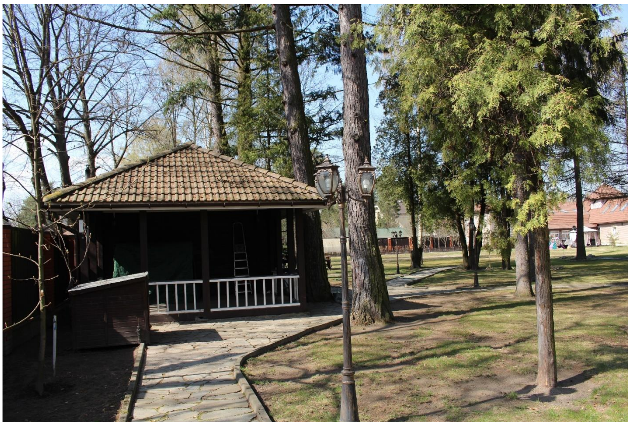
Фото 34. Вид на нежилое деревянное строение в южной части выявленного объекта культурного наследия «Парк с прудом и деревьями ценных пород».
