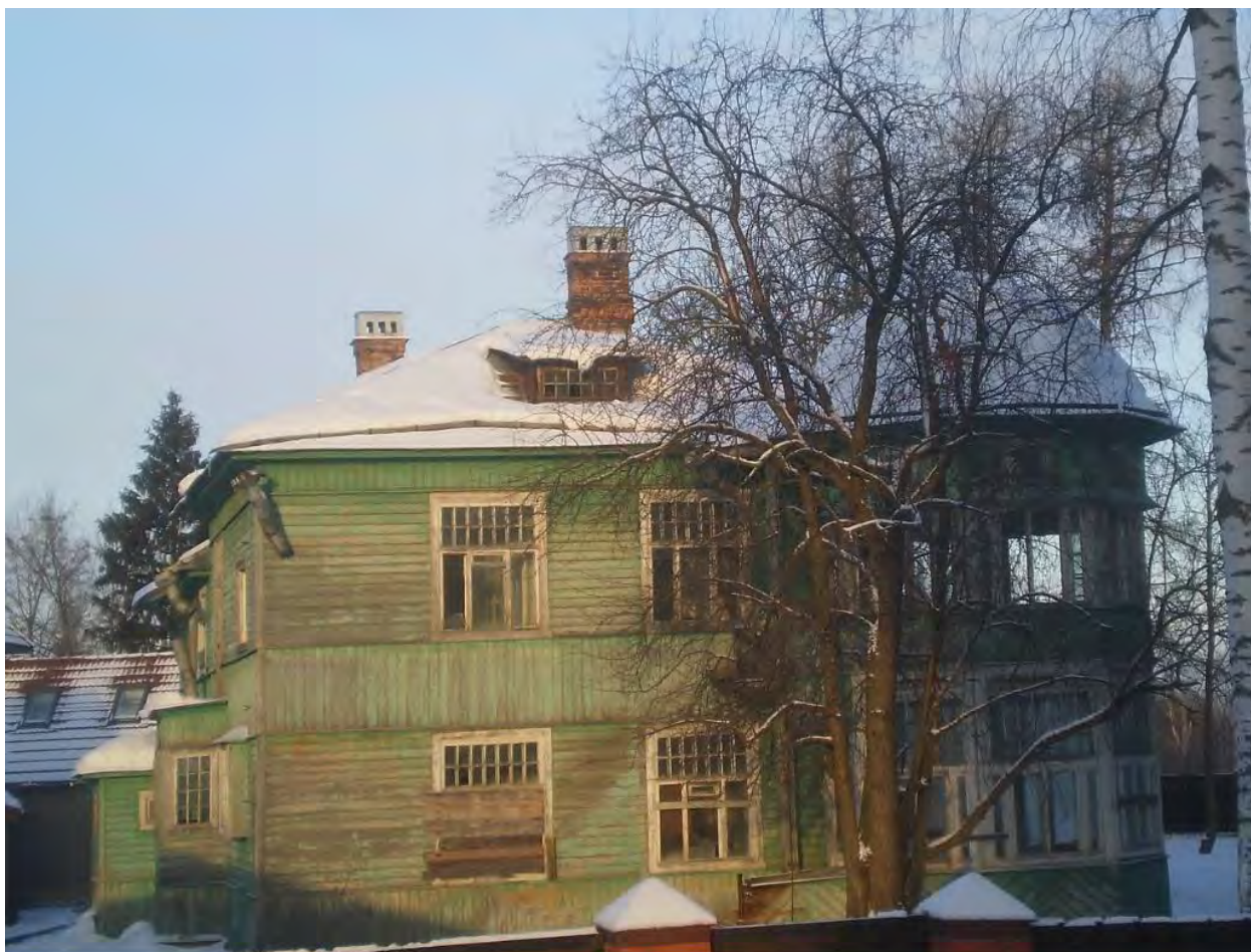
Илл. 54. Вид на дом (деревянный 2-этажный) юго-запада. 2013 г. (источник: https://p2.citywalls.ru/photo_145-148730.jpg?mt=1357669442 ).
