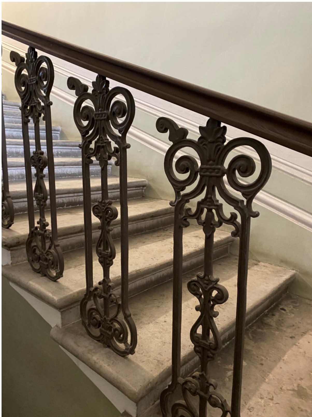
29. Фрагмент ограждений лестницы 2ЛК в уровне 1-го этажа
