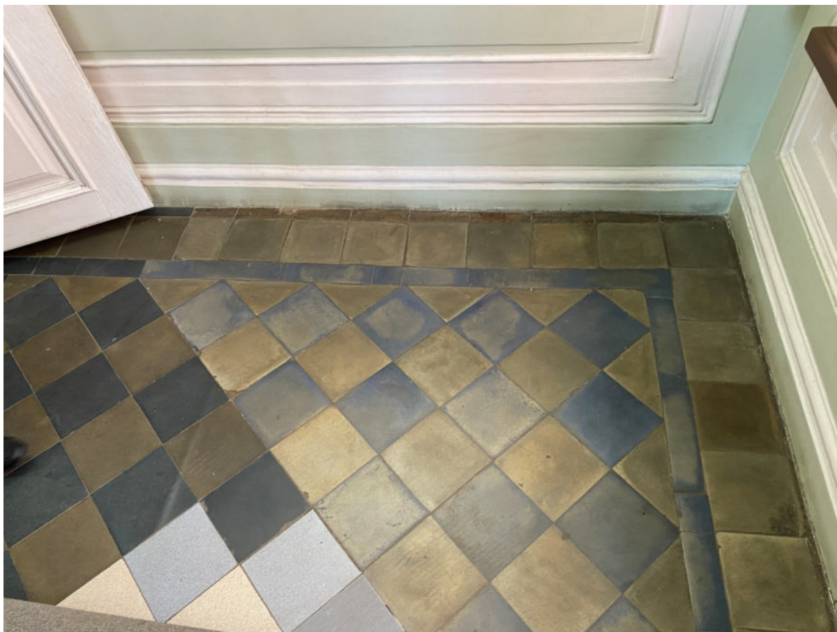
37. Фрагмент лестничной площадки лестницы 2ЛК в уровне 2-го этажа
