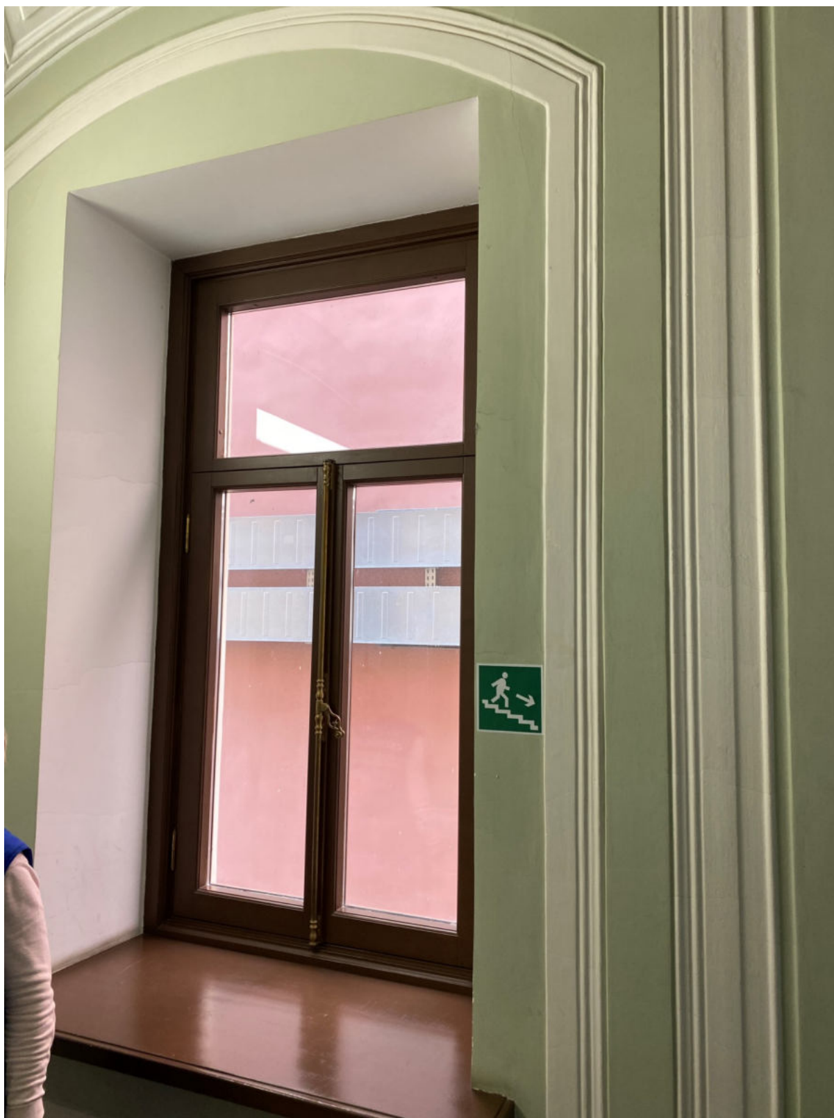
39. Оконное заполнение в части лестницы 2ЛК в уровне 1-го этажа
