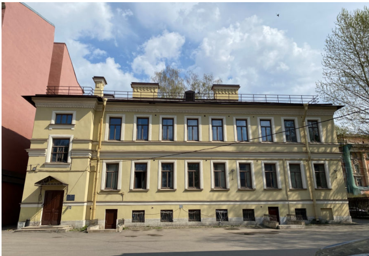
8. Фрагмент западного дворового фасада
