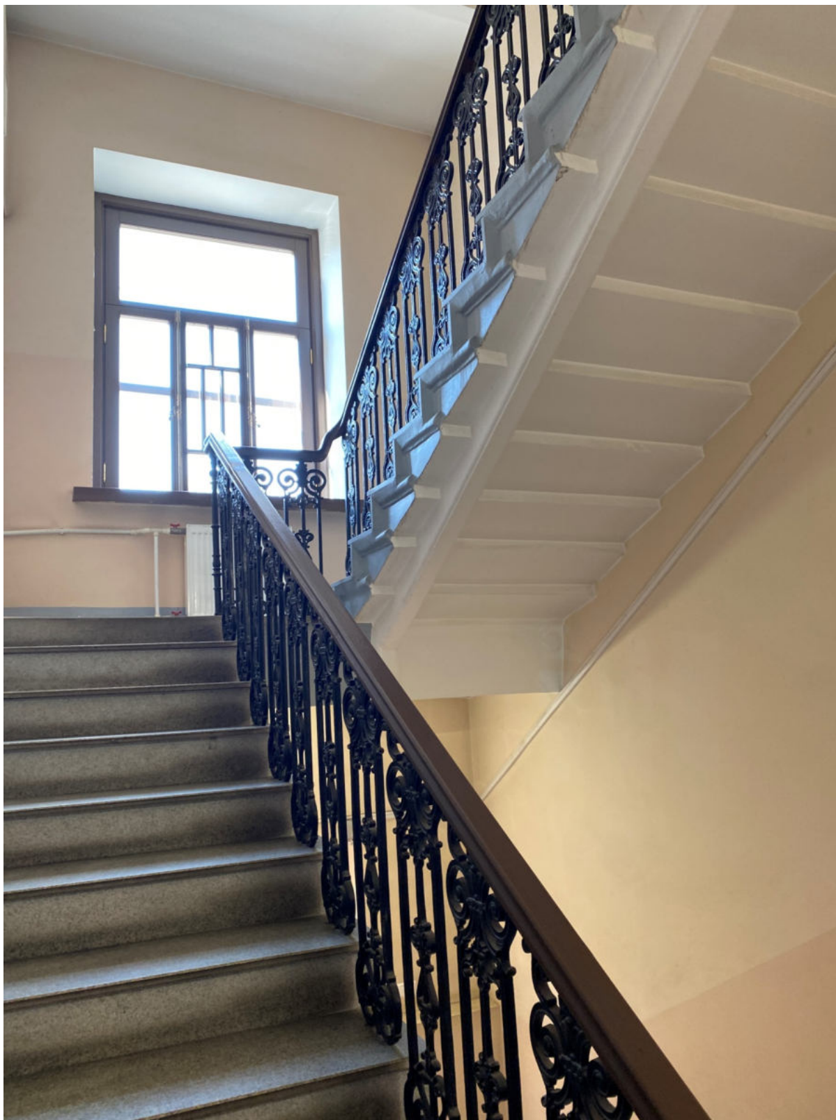
20. Общий вид лестницы 1ЛК в уровне 2-го этажа
