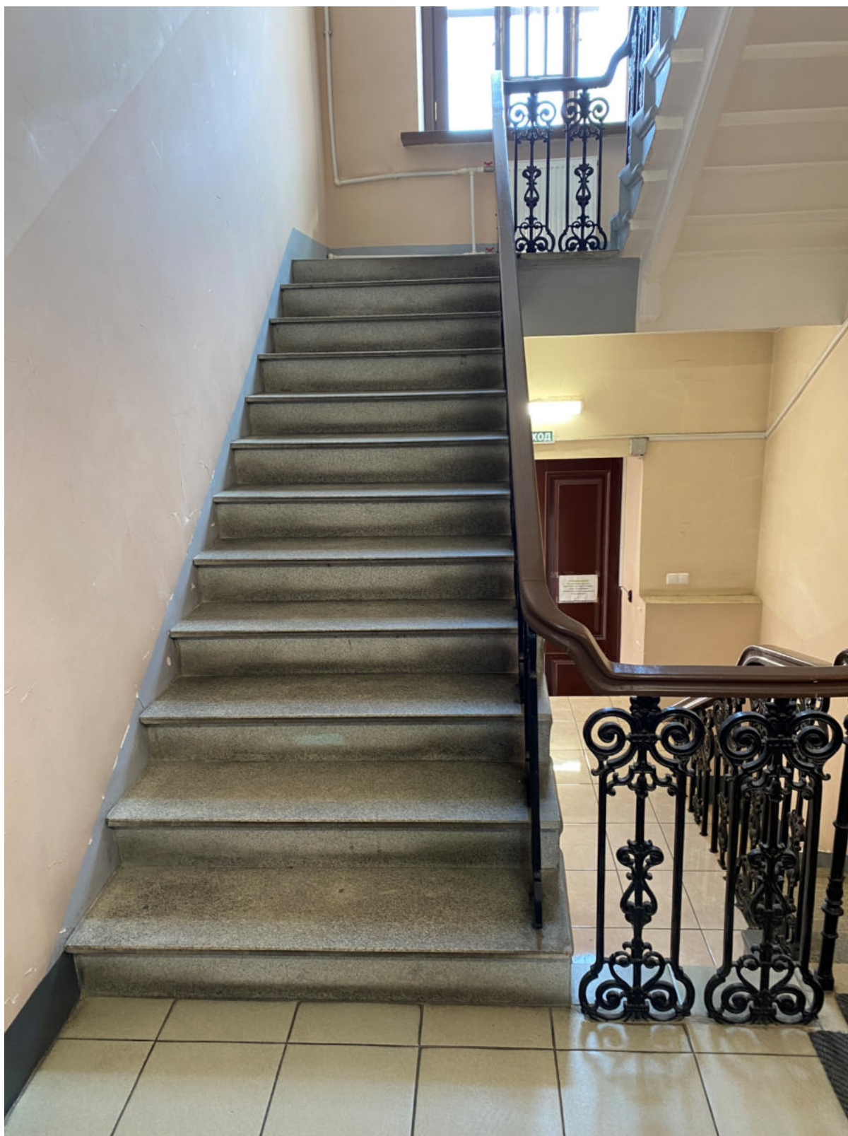
18. Общий вид лестницы 1ЛК в уровне 1-го этажа
