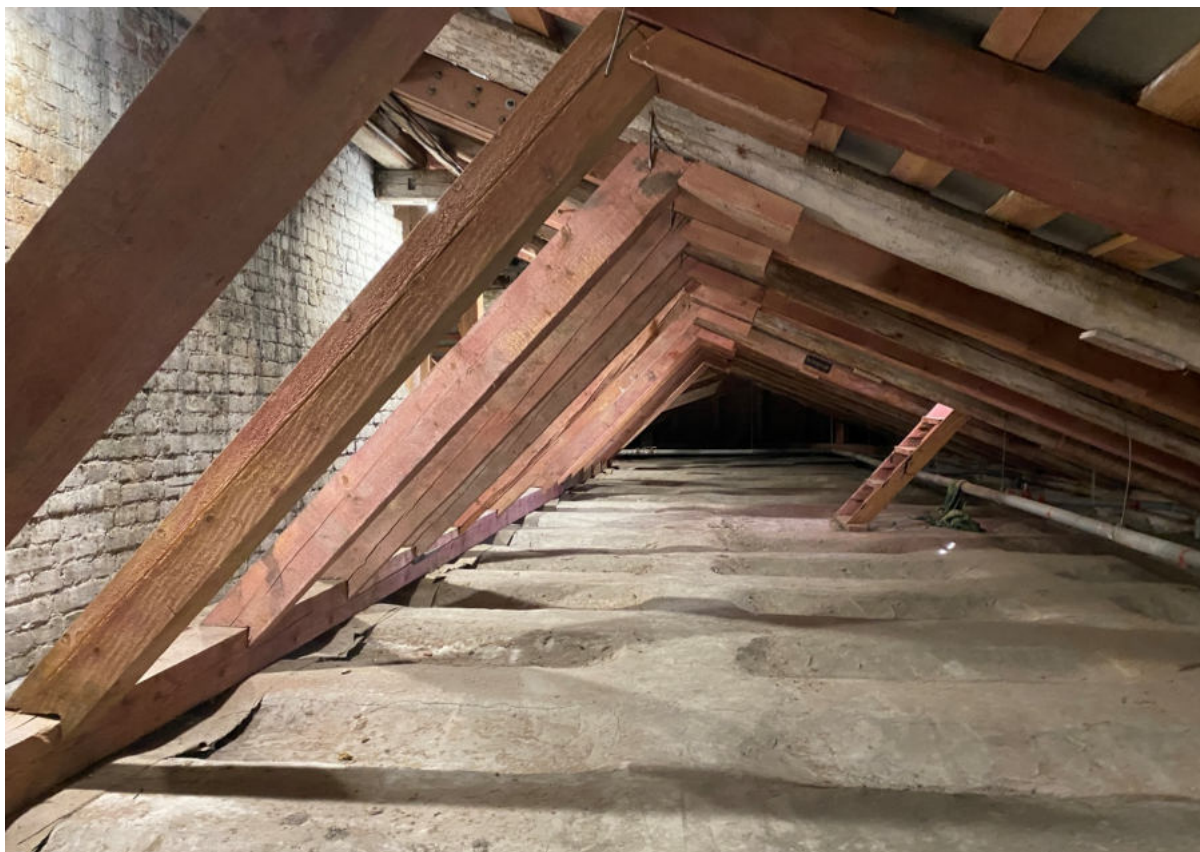
23. Общий вид чердака и стропильной системы
