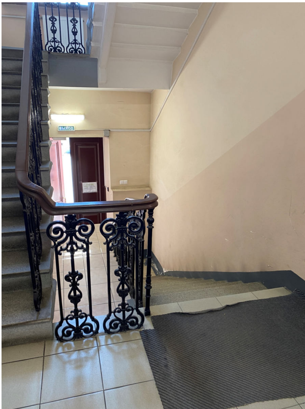
17. Общий вид лестницы 1ЛК в уровне 1-го этажа
