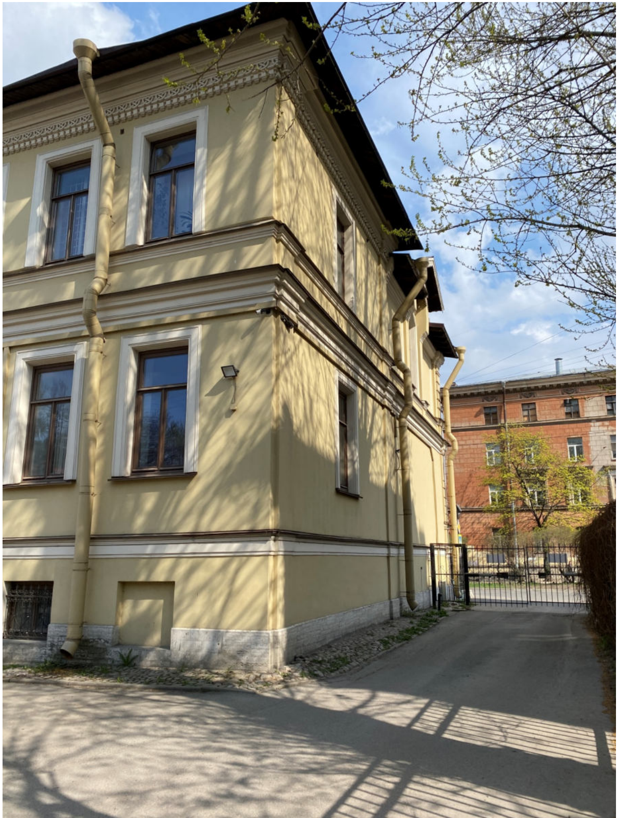
7. Фрагмент южного бокового и западного дворового фасадов
