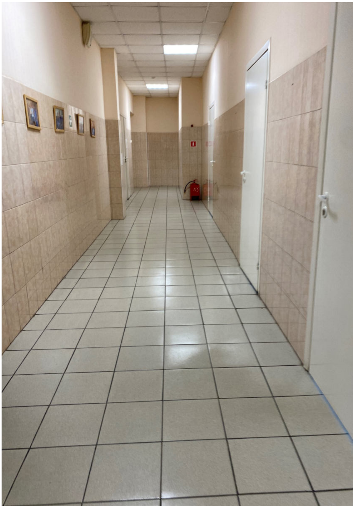
41. Коридор 2-го этажа
