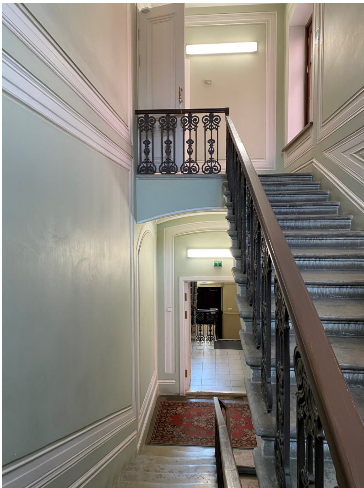
36. Общий вид лестницы 2ЛК в уровне 1-2-го этажей
