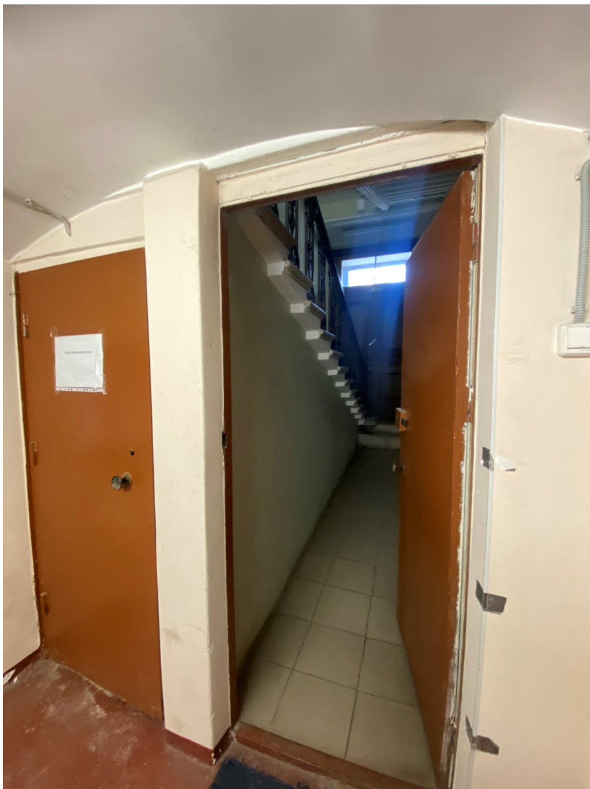
31. Вход в цокольный этаж, расположенный под лестницей 2ЛК
