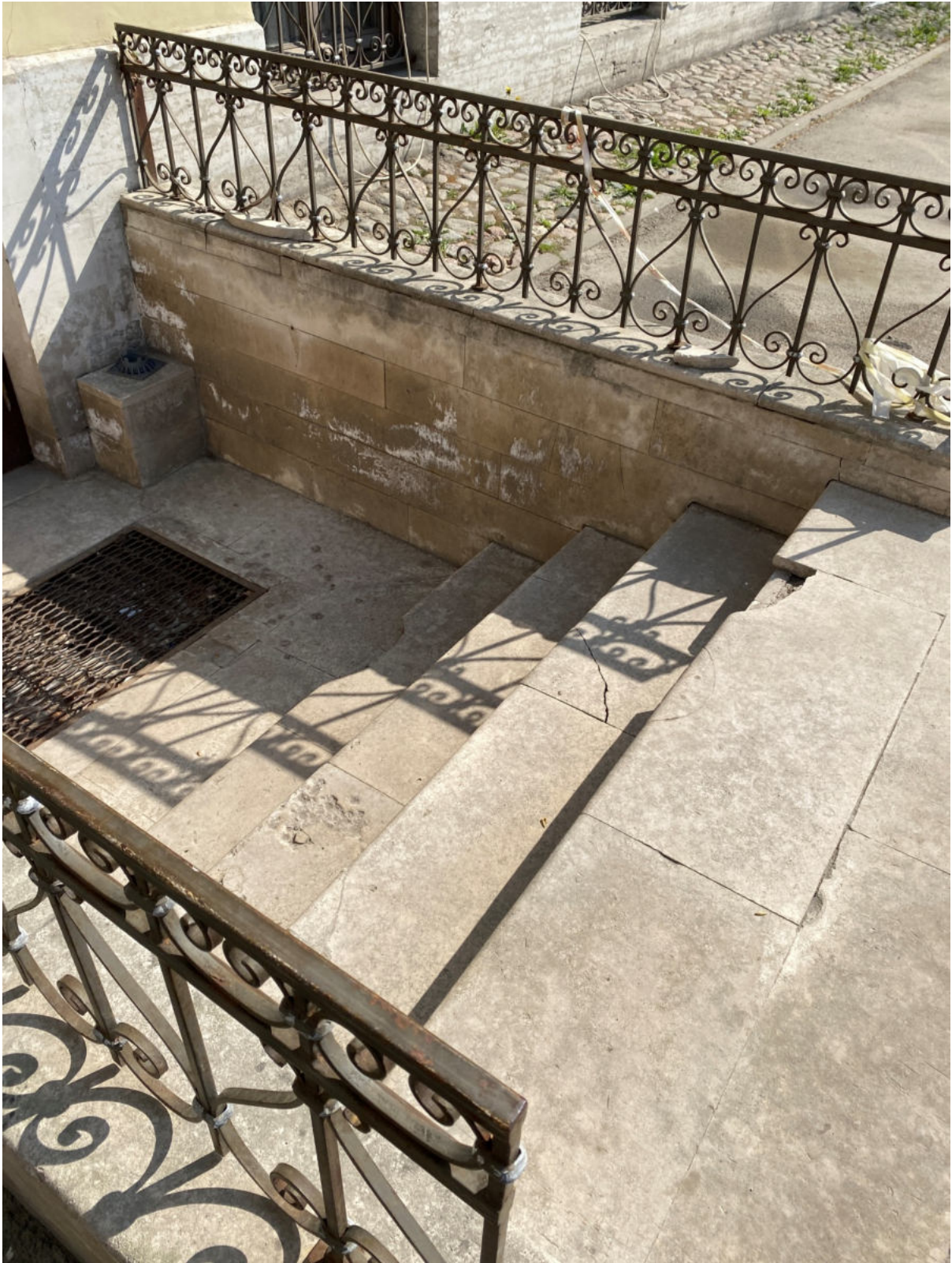
10. Лестница, ведущая в цокольный этаж, расположенная на западном дворовом фасаде
