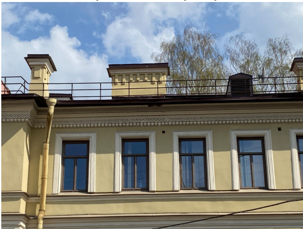
9. Фрагмент западного дворового фасада
