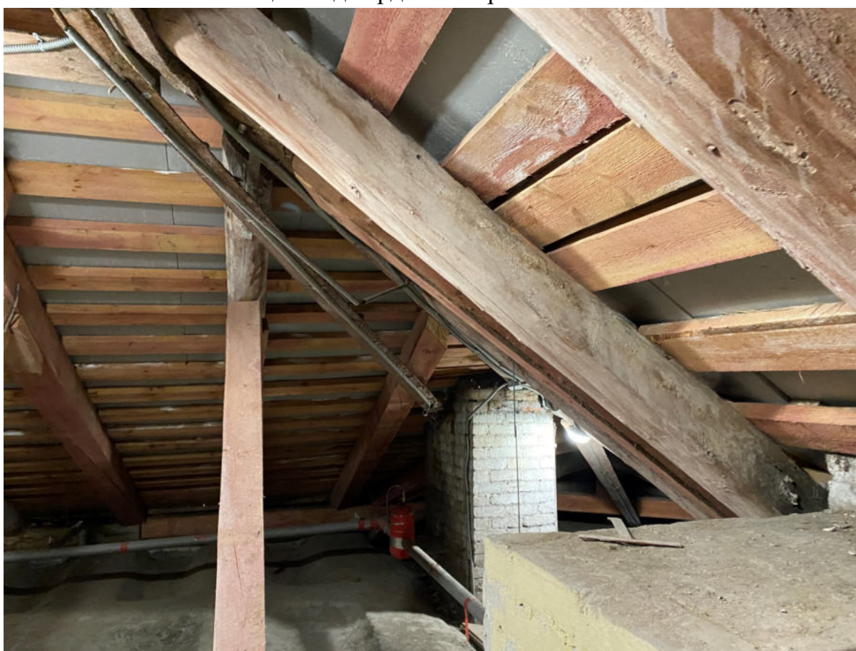
24. Фрагмент чердака и стропильной системы
