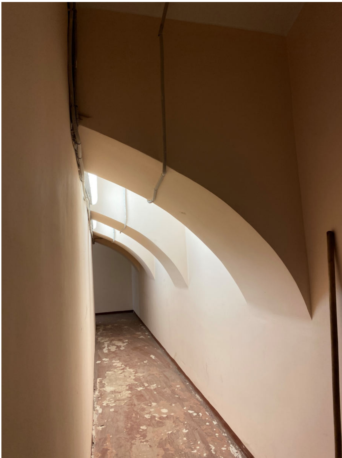
33. Общий вид помещений цокольного этажа
