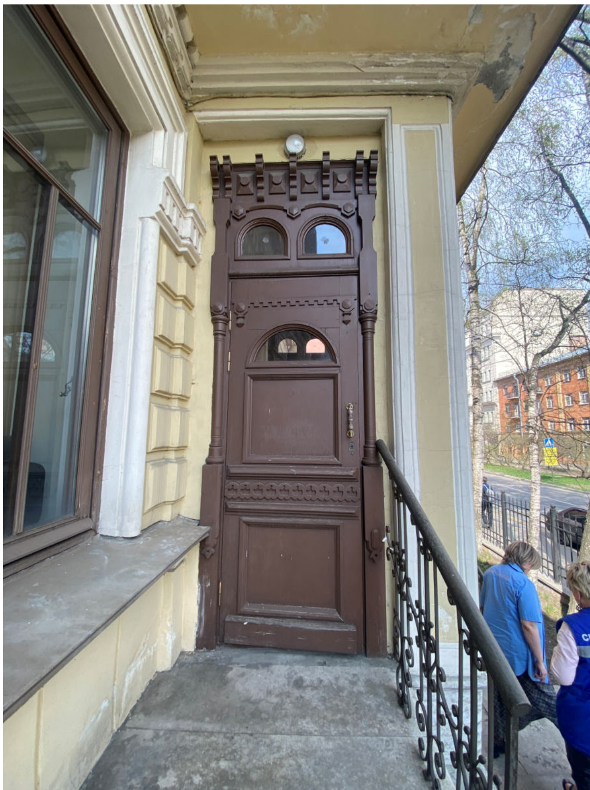
15. Вид на дверное заполнение лицевого фасада
