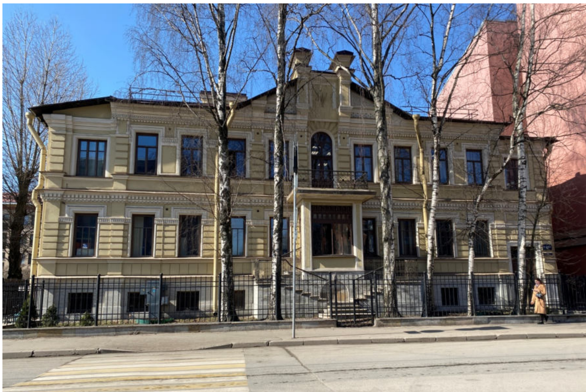
1. Общий вид лицевого фасада по Дровяной улице
