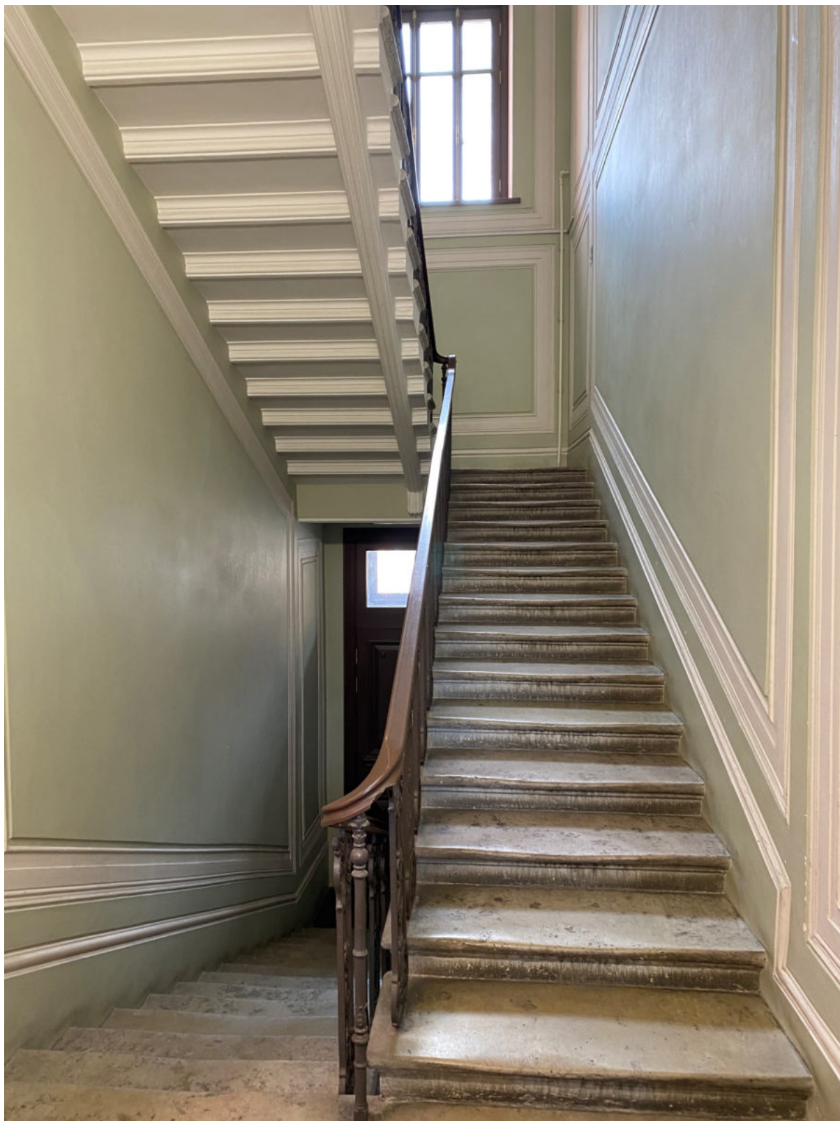
27. Лестница 2ЛК в уровне первого этажа
