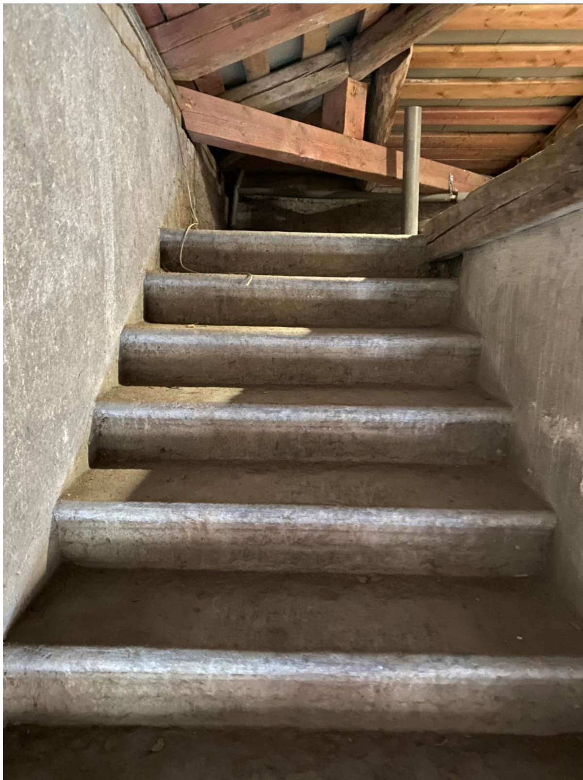
22. Лестница, ведущая на чердак с лестницы 1ЛК
