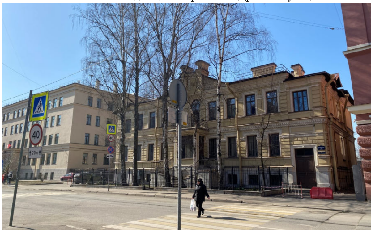
2. Общий вид лицевого фасада по Дровяной улице
