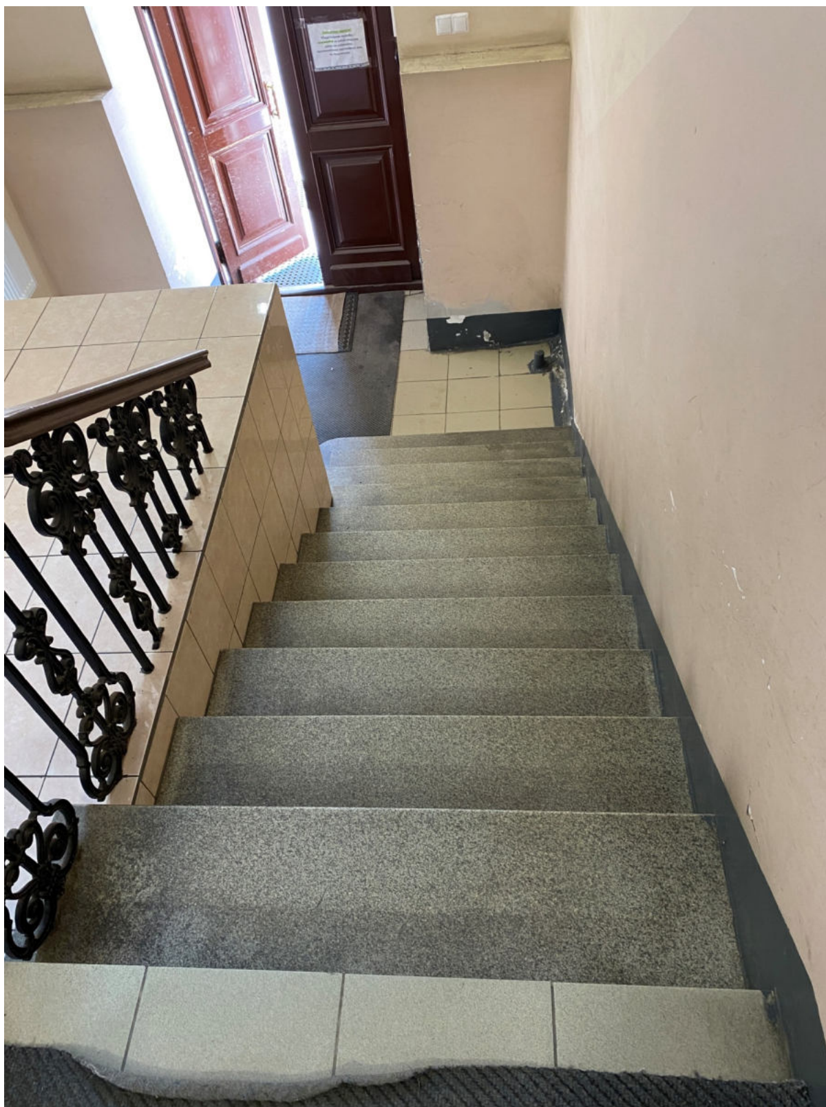
19. Фрагмент лестницы 1ЛК в уровне 1-го этажа
