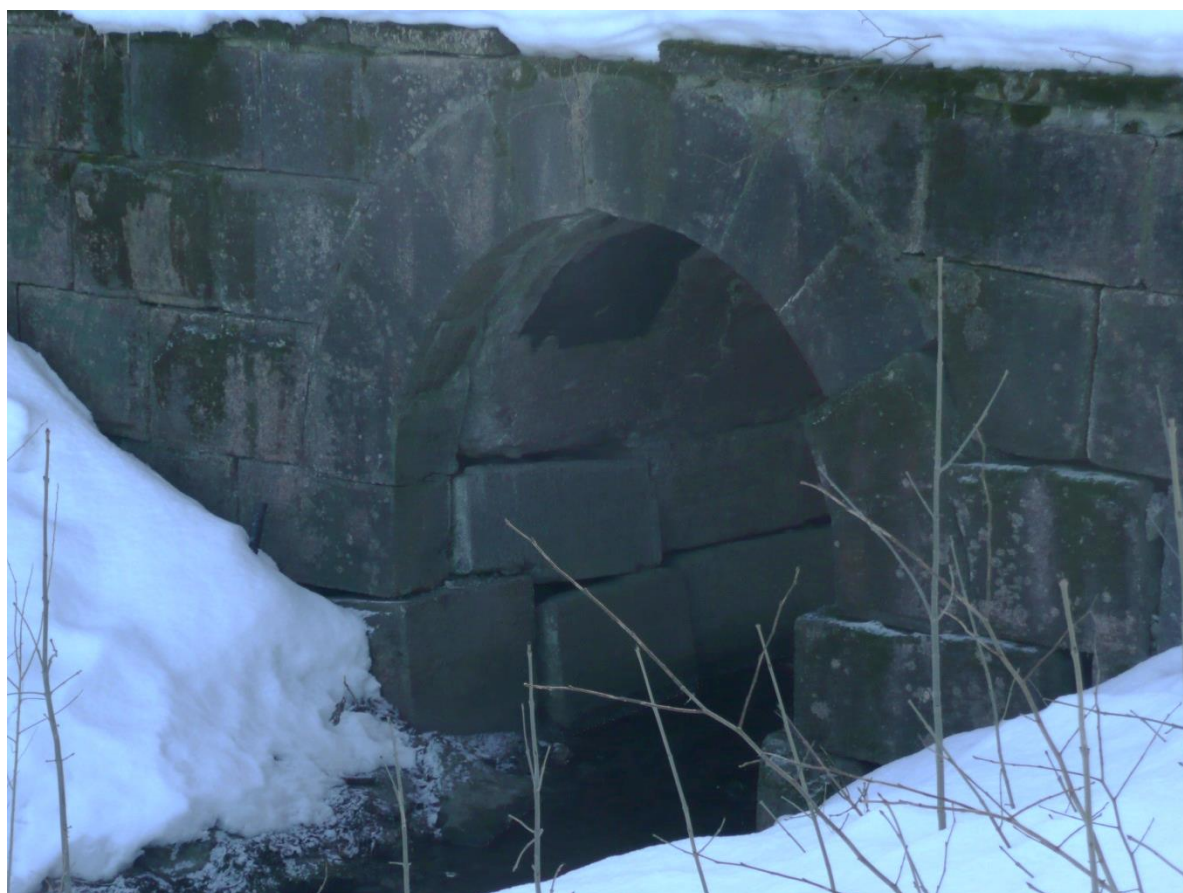
Фото 14. Свод с низовой стороны моста.
