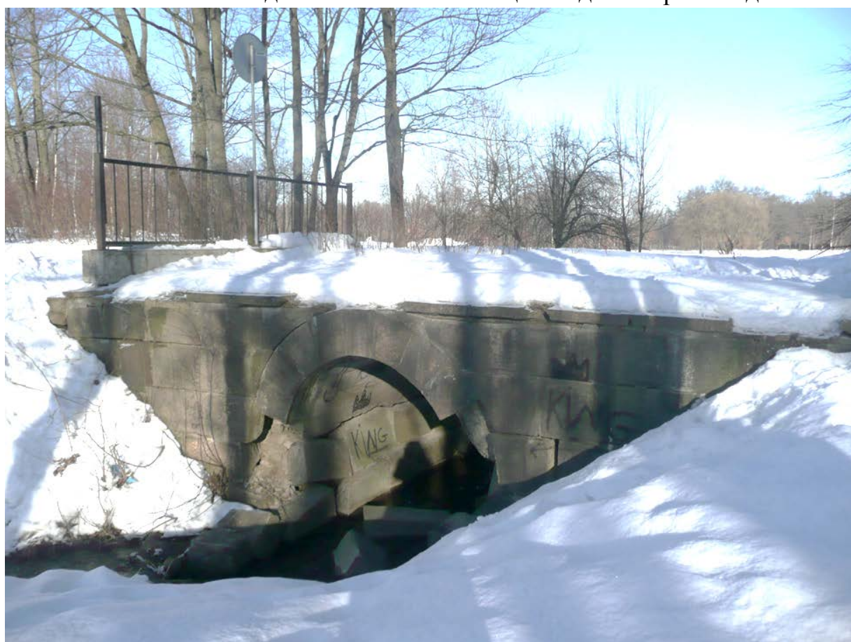
Фото 6. Верховая сторона моста. Общий вид.
