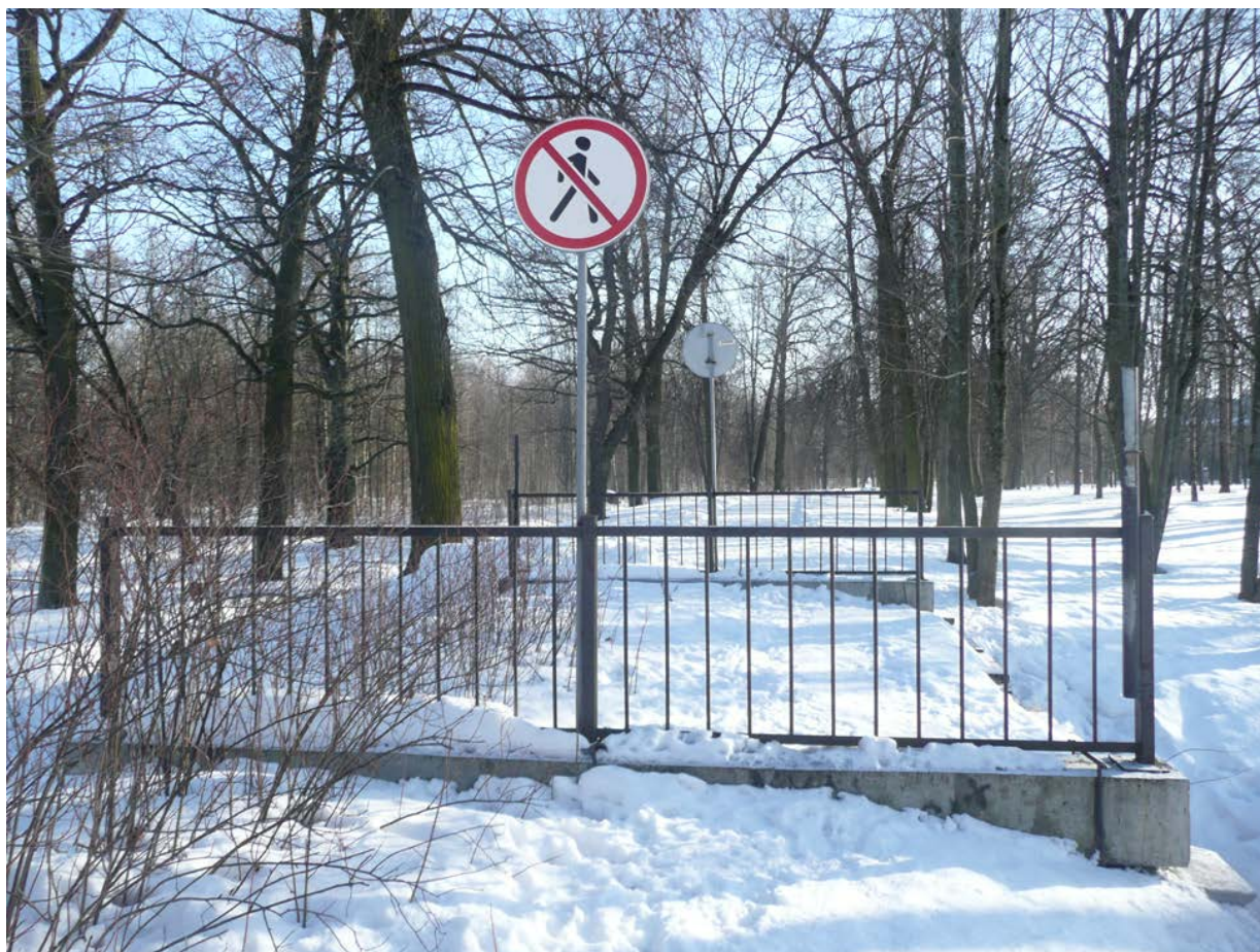
Фото 5. Пешеходная часть моста. Общий вид с северо-запада.
