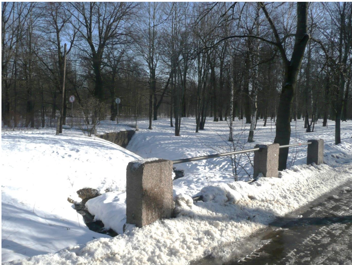
Фото 1. Общий вид моста со стороны тротуара Павловского шоссе.
