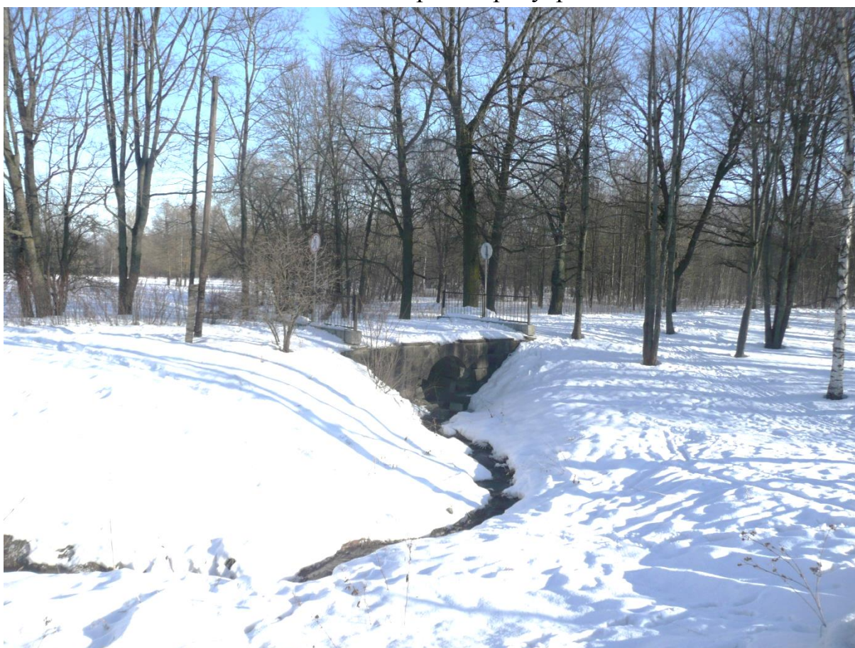
Фото 2. Общий вид моста с запада.
