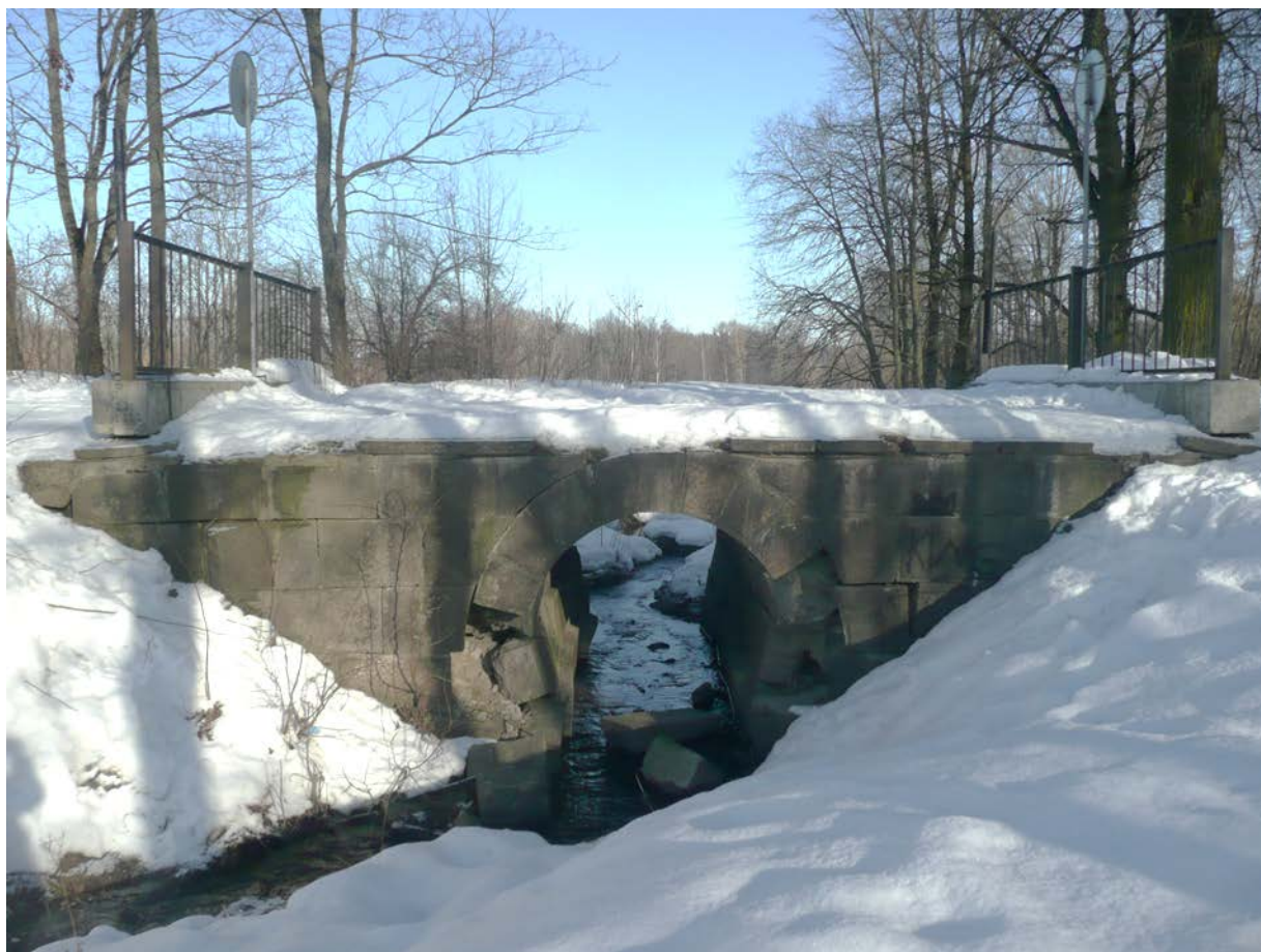
Фото 7. Верхняя сторона моста. Юго-западный фасад.
