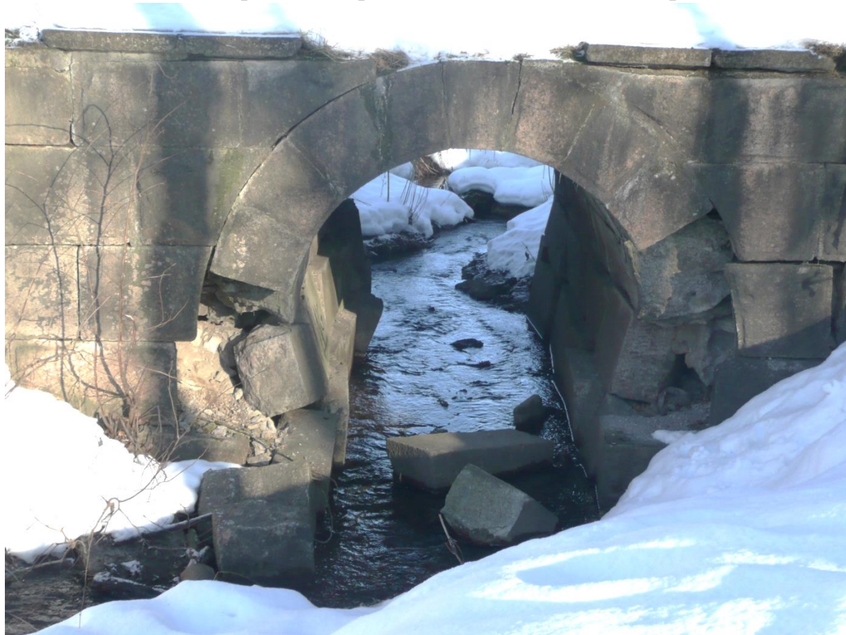
Фото 8. Свод верхней стороны моста. Общий вид.
