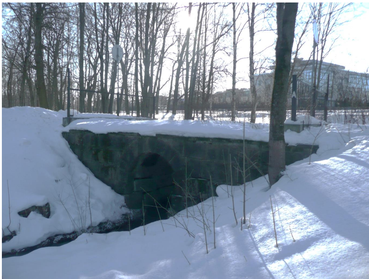
Фото 13. Низовая сторона моста. Общий вид.
