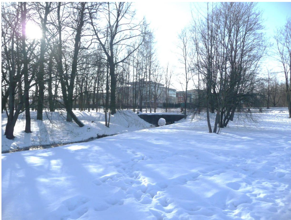
Фото 3. Общий вид моста с северо-востока.
