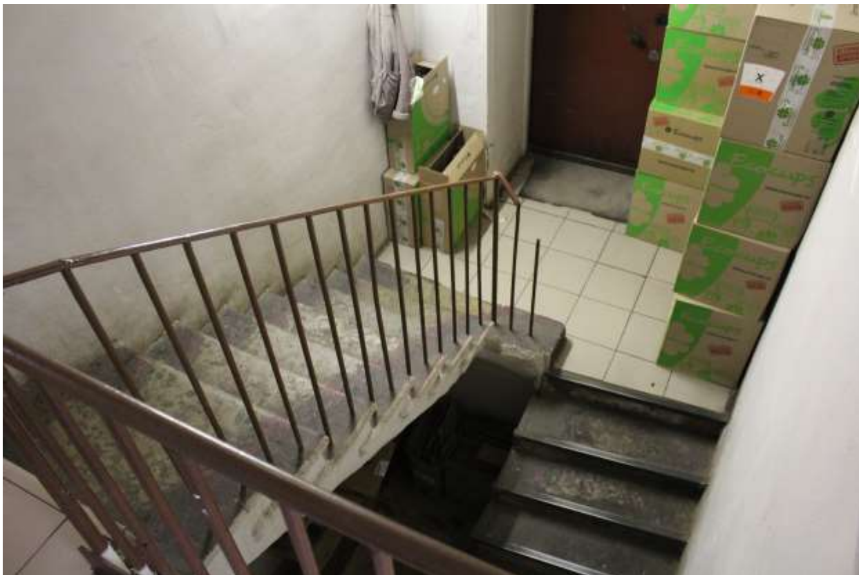
23. Помещение 1-Н. Служебная лестница (пом. № 9).
