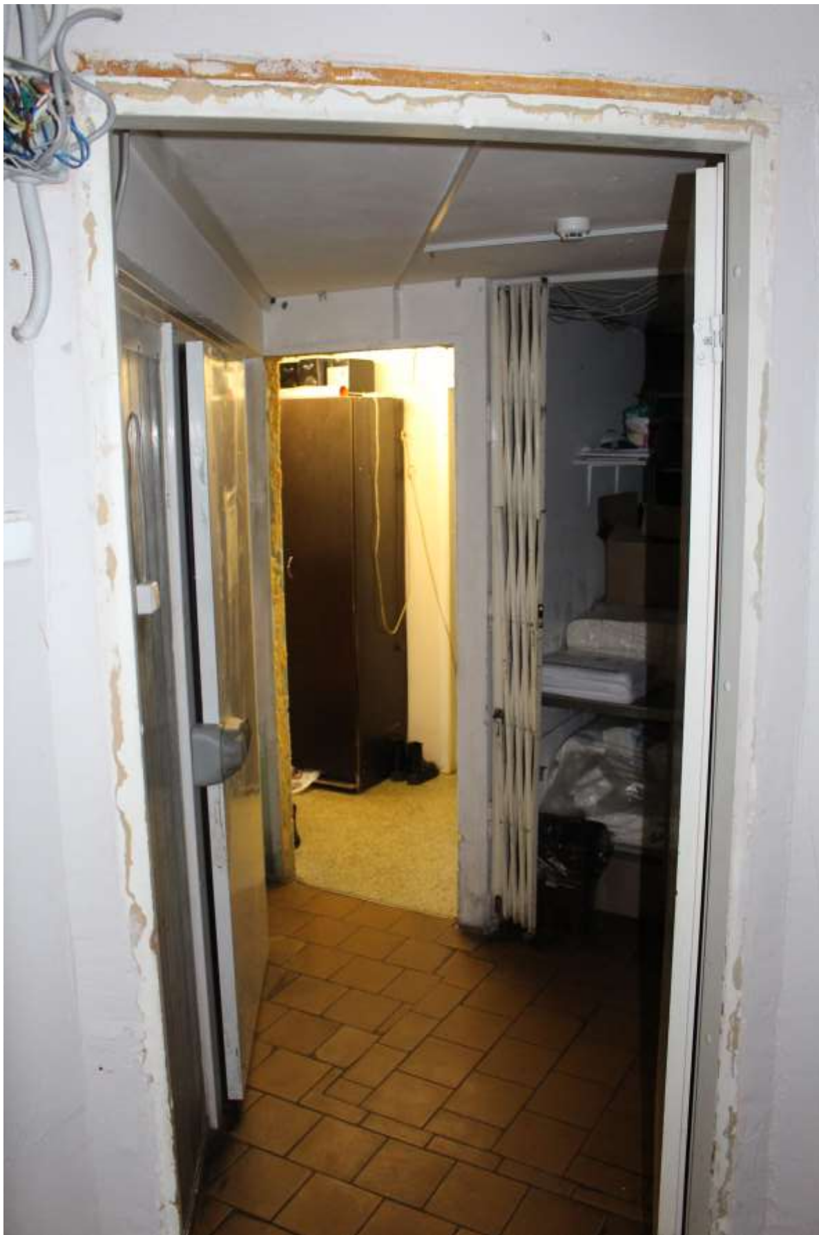
32. Помещение 1-Н. Вид из служебной лестничной клетки на вспомогательное помещение (вид на пом. № 16).
