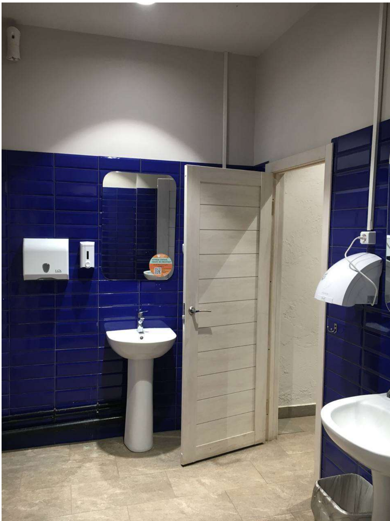
29. Помещение 1-Н. Санузел (пом. № 13, № 11).
