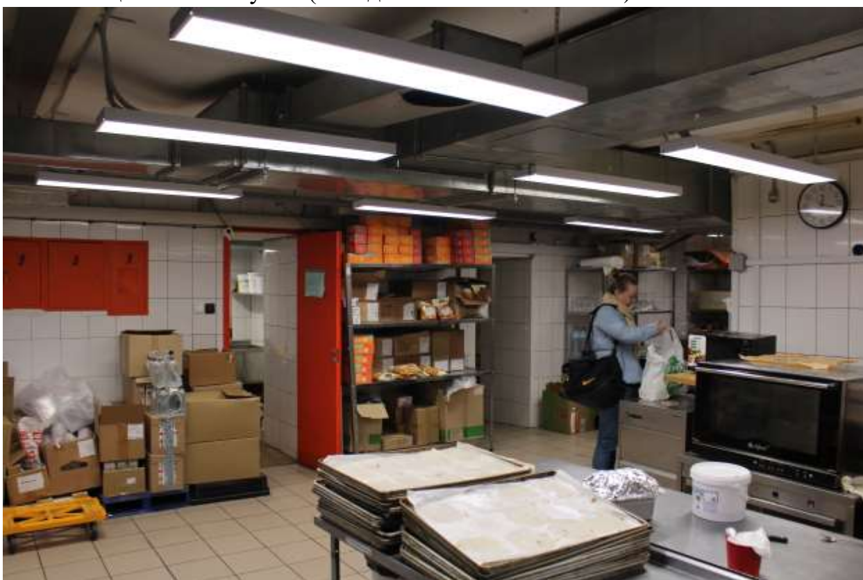
20. Помещение 1-Н. Кухня (объединенные пом. №№5-8).
