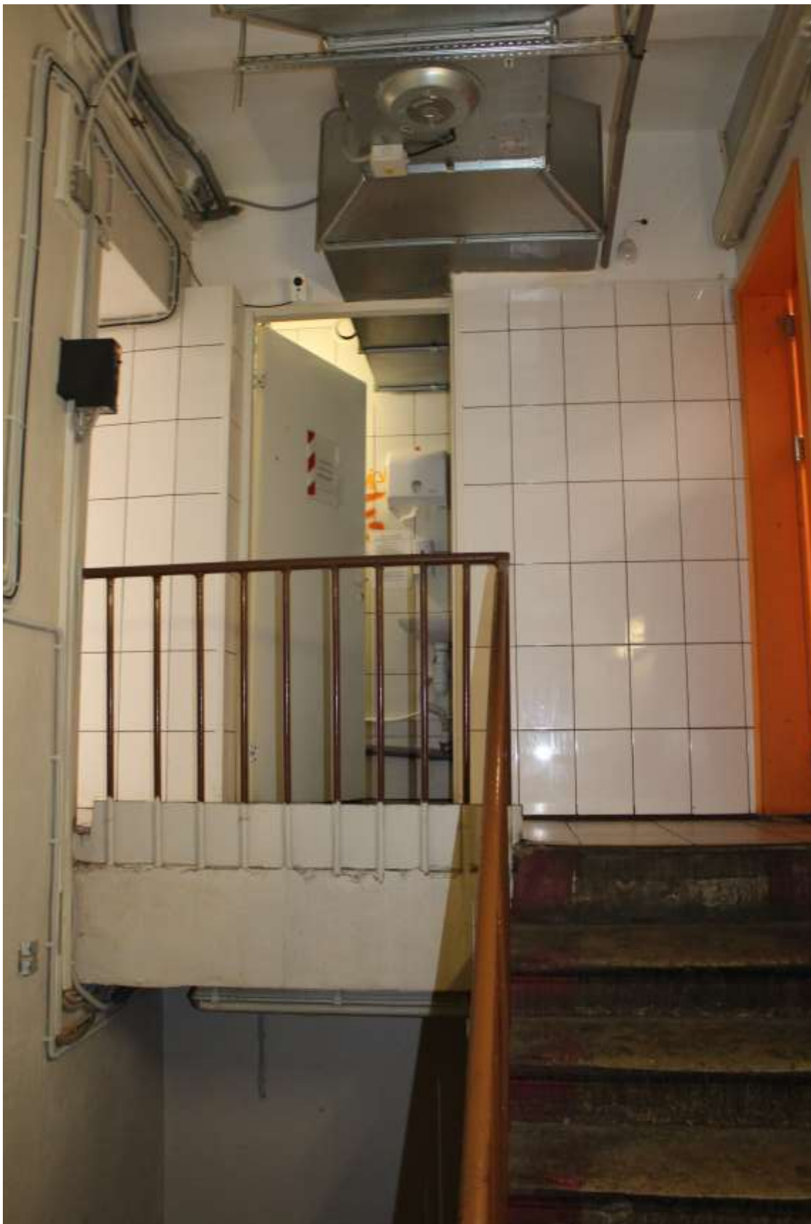
24. Помещение 1-Н. Служебная лестница (пом. № 9).
