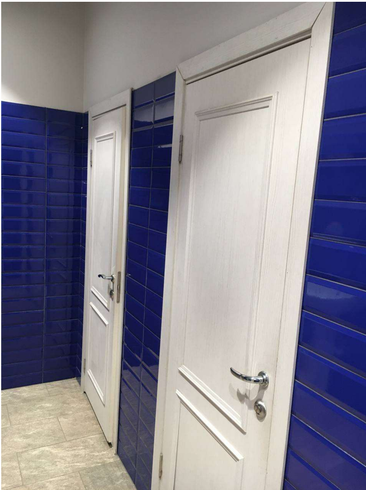
30. Помещение 1-Н. Санузел (пом. № 13, № 11).
