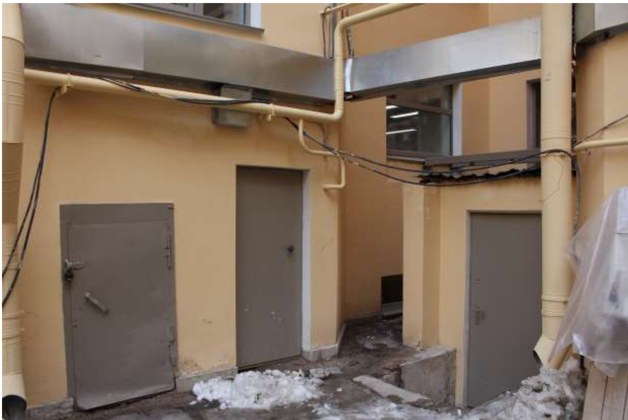
13. Вид на наружные стены помещения 1-Н со стороны двора.
