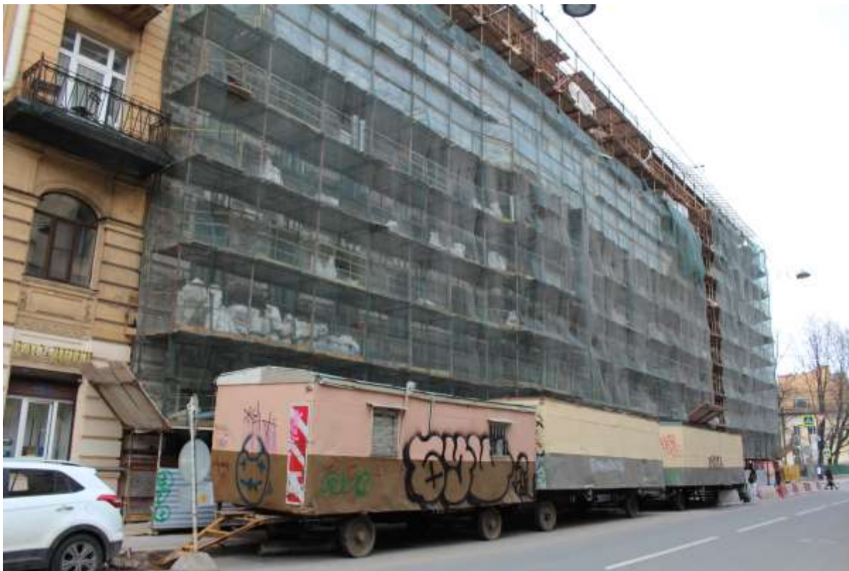
7. Вид на южный фасад западного лицевого корпуса объекта культурного наследия федерального значения «Дом, где в 1904-1905 гг. жил писатель Горький А.М. и в ноябре-декабре 1905 г. состоялись совещания ЦК РСДРП(б) о вооруженном восстании в Москве».
