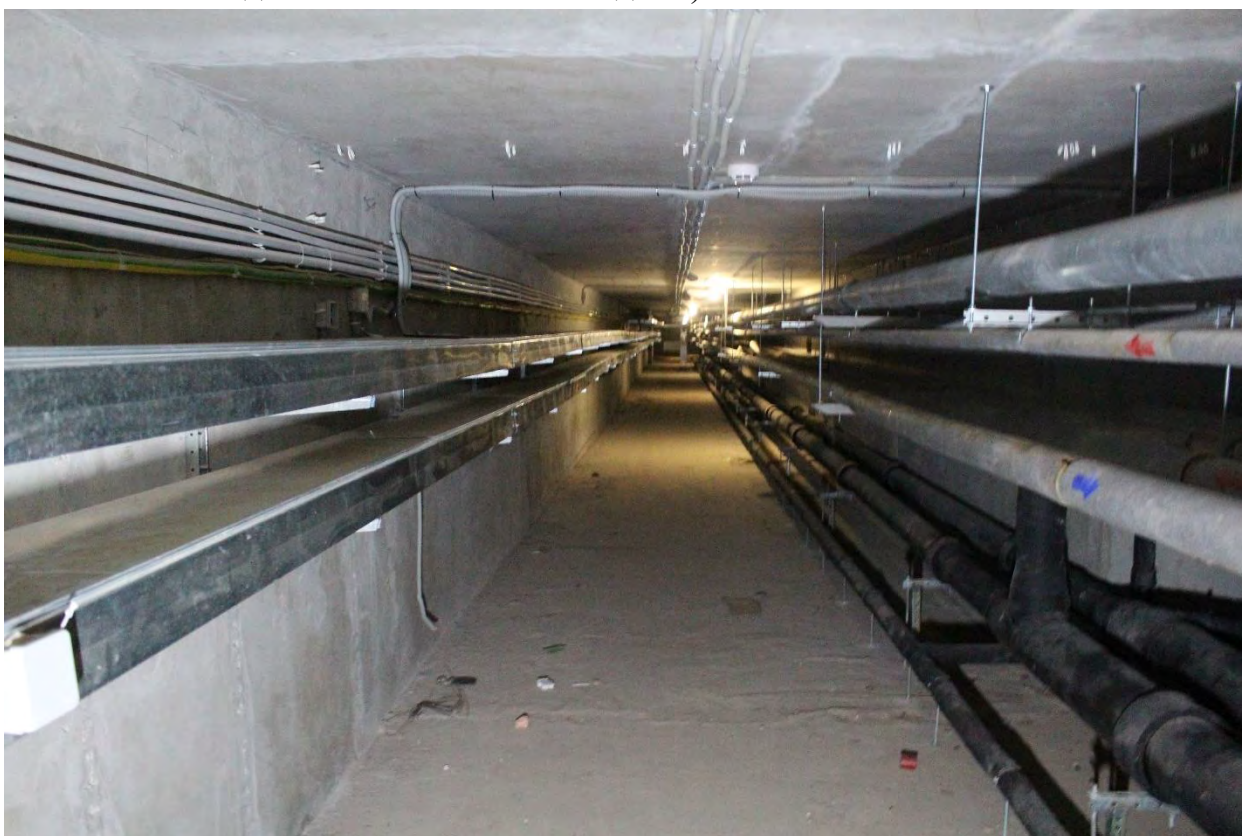
Фото 66. Подвальные помещения главного корпуса выявленного объекта культурного наследия «Главное здание градских богаделен (в 1770-х годах – здание Воспитательного дома)». Фото 19.05.2023 г.
