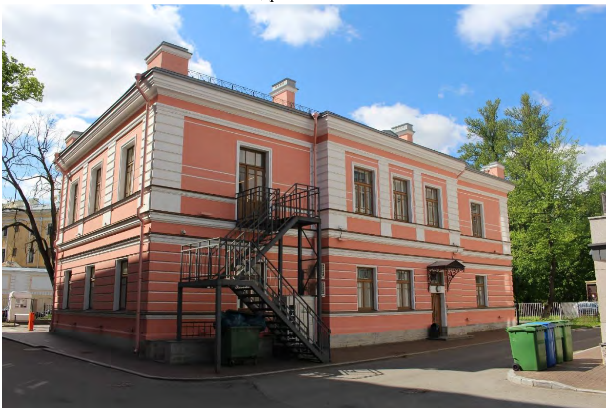
Фото 41. Вид на северный фасад выявленного объекта культурного наследия «Здание богадельни в память бракосочетания вел.кн. Ксении Александровны». Фото 19.05.2023 г.
