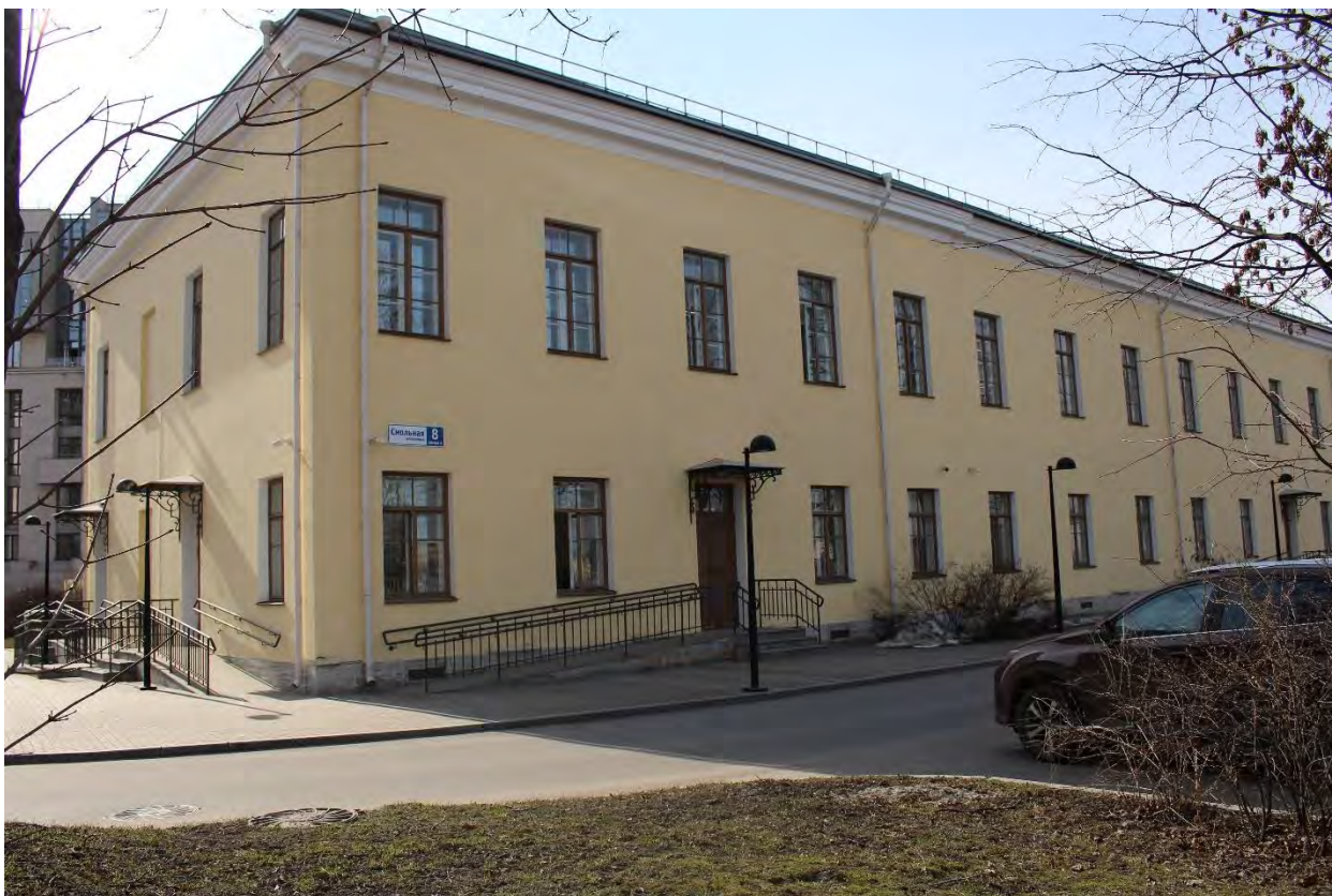
Фото 5. Вид на северо-восточный фасад южного крыла главного корпуса выявленного объекта культурного наследия «Главное здание градских богаделен (в 1770-х годах – здание Воспитательного дома)». Фото 17.04.2023 г.
