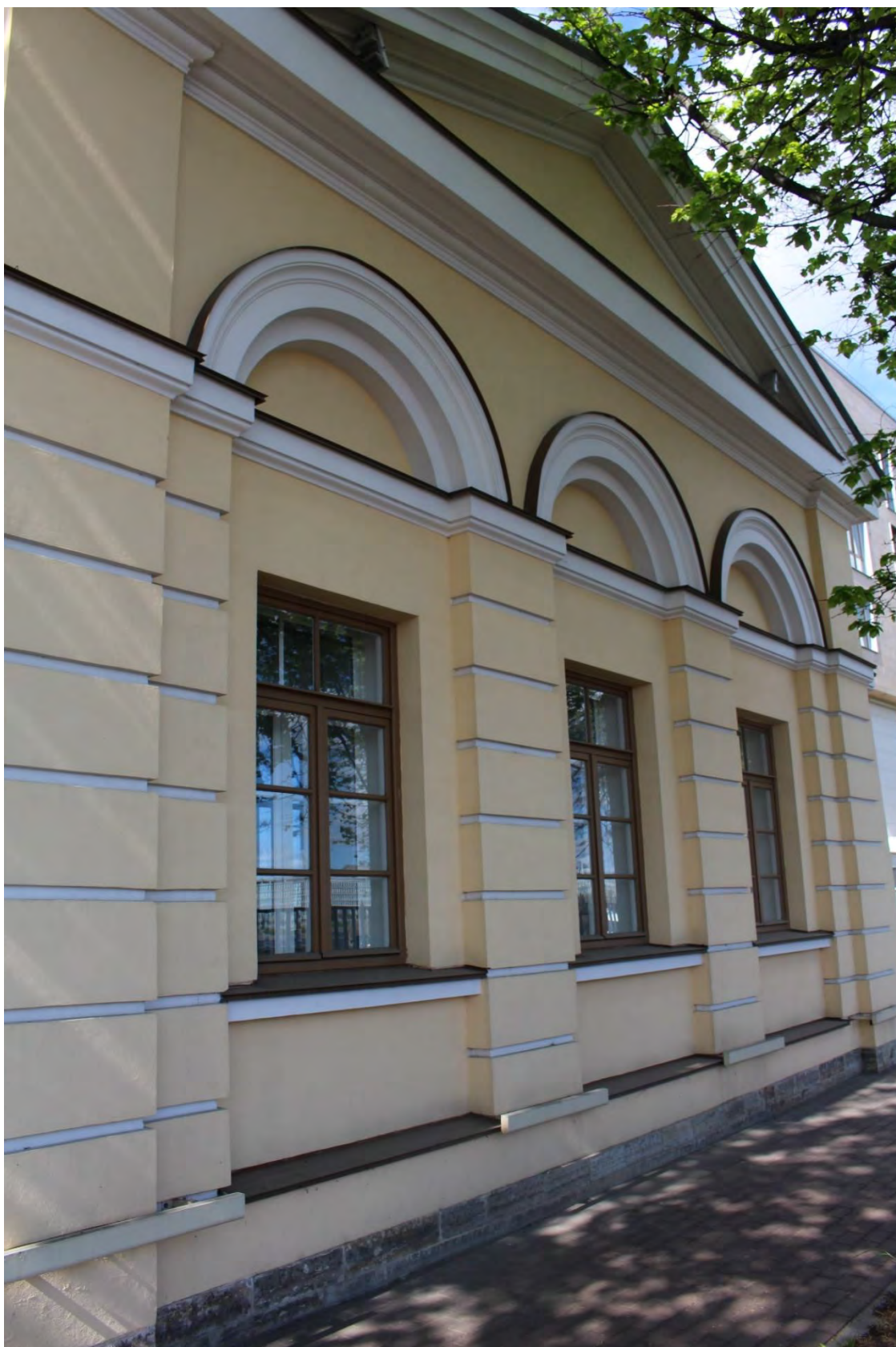
Фото 31. Вид на северо-восточный фасад банного флигеля выявленного объекта культурного наследия «Главное здание градских богаделен (в 1770-х годах – здание Воспитательного дома)». Фото 19.05.2023 г.
