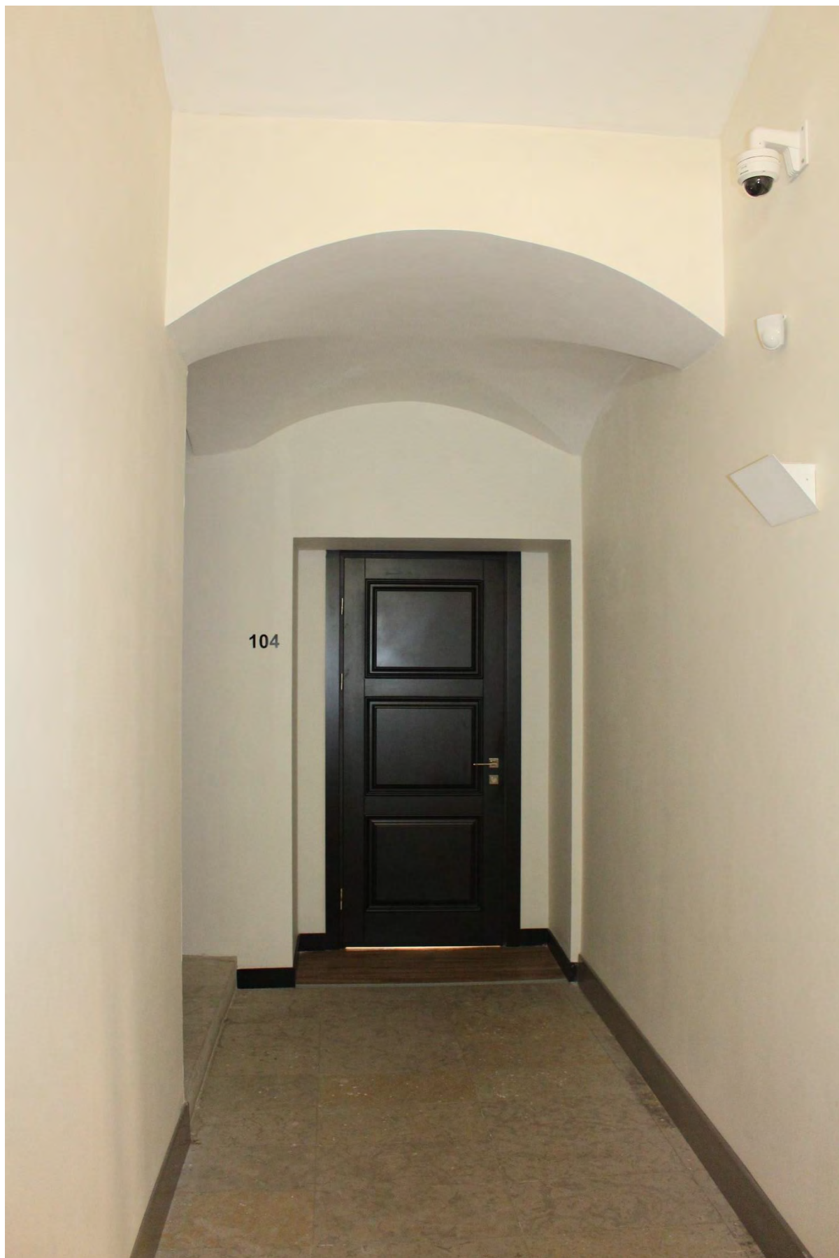
Фото 80. Северо-западная историческая лестница главного корпуса выявленного объекта культурного наследия «Главное здание градских богаделен (в 1770-х годах – здание Воспитательного дома)». Фото 19.05.2023 г.
