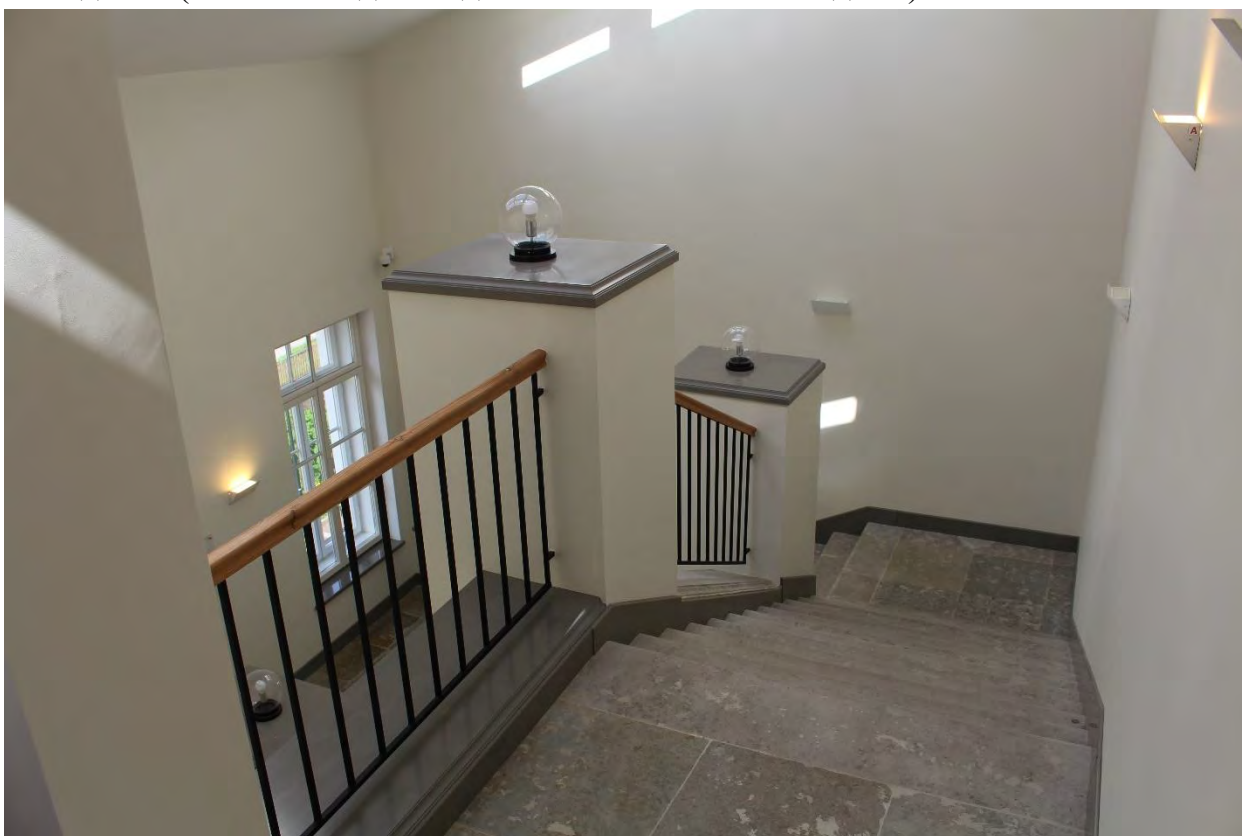
Фото 101. Северо-западная историческая лестница южного крыла главного корпуса выявленного объекта культурного наследия «Главное здание градских богаделен (в 1770-х годах – здание Воспитательного дома)». Фото 19.05.2023 г.
