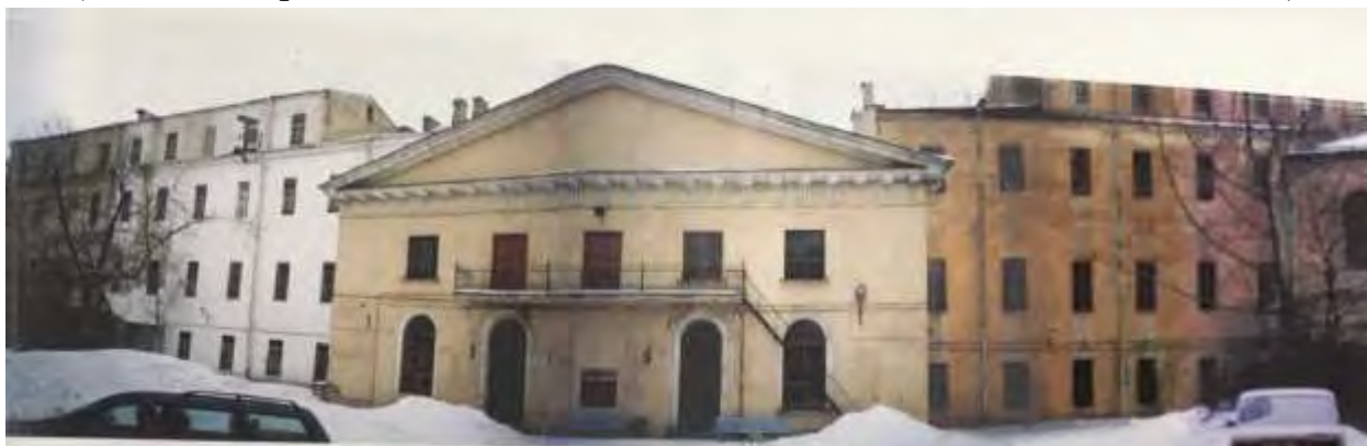
Илл. 57. Главное здание. Внутренний двор. Восточный корпус (центральная часть – бывший «церковный флигель»). 2003 г. (источник: архив КГИОП П. 1144 Н-5667. Вх. № 3-2720 от 28.04.2003 г.).
