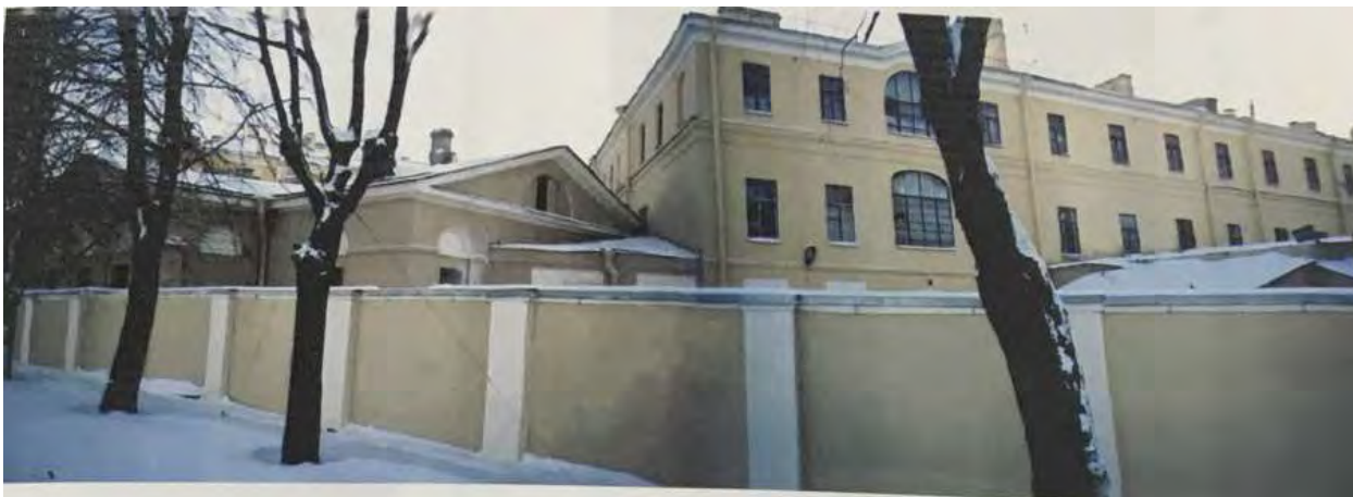
Илл. 54. Вид части главного здания: А8 (слева) и А2-3. 2003 г. (источник: архив КГИОП П. 1144 Н-5667. Вх. № 3-2720 от 28.04.2003 г.).
