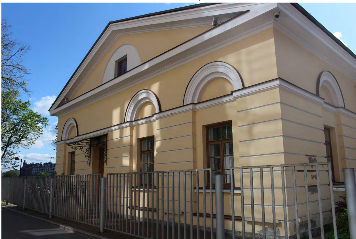
Фото 28. Вид на северо-западный фасад банного флигеля выявленного объекта культурного наследия «Главное здание градских богаделен (в 1770-х годах – здание Воспитательного дома)». Фото 19.05.2023 г.
