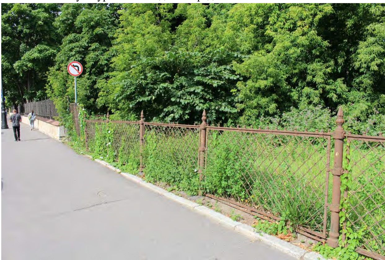
Фото 62. Вид на выявленный объект культурного наследия «Ограда». Фото 19.05.2023 г.
