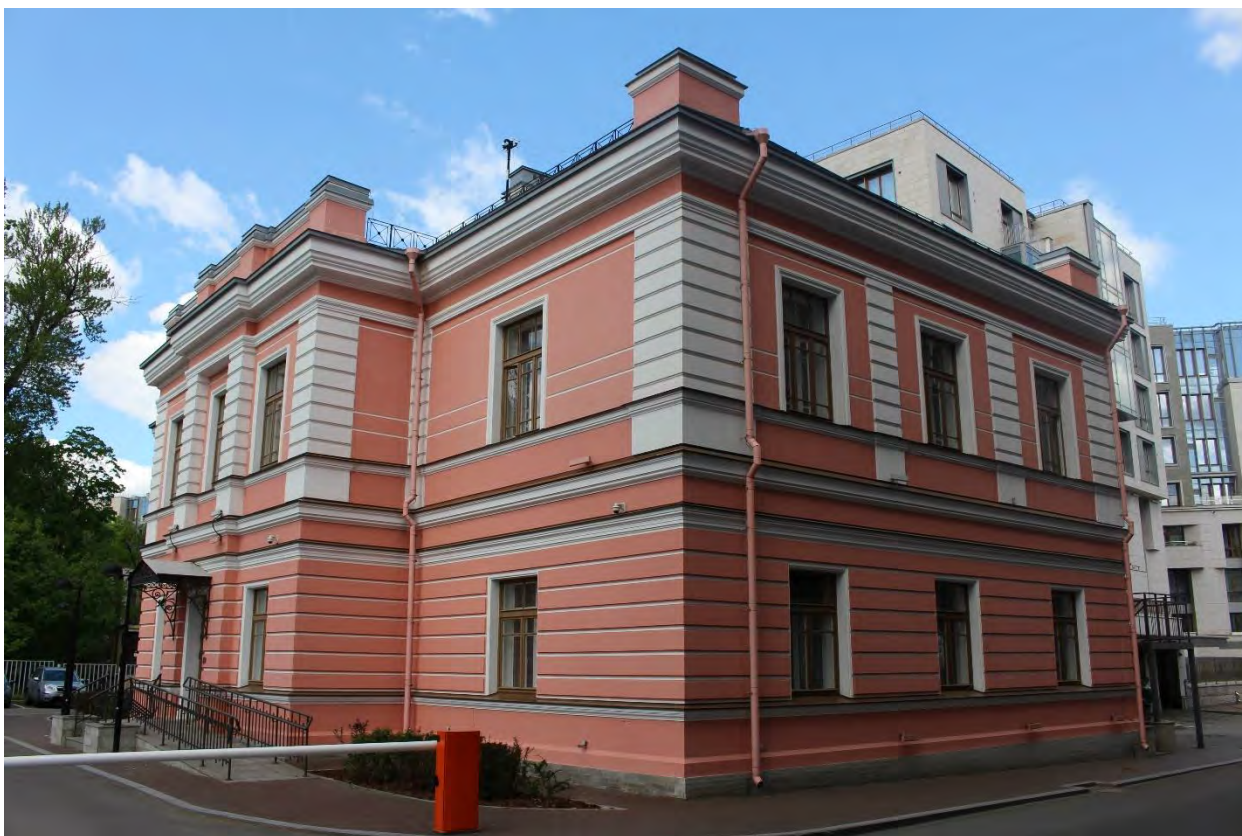
Фото 36. Вид на южный и восточный фасады выявленного объекта культурного наследия «Здание богадельни в память бракосочетания вел.кн. Ксении Александровны». Фото 19.05.2023 г.
