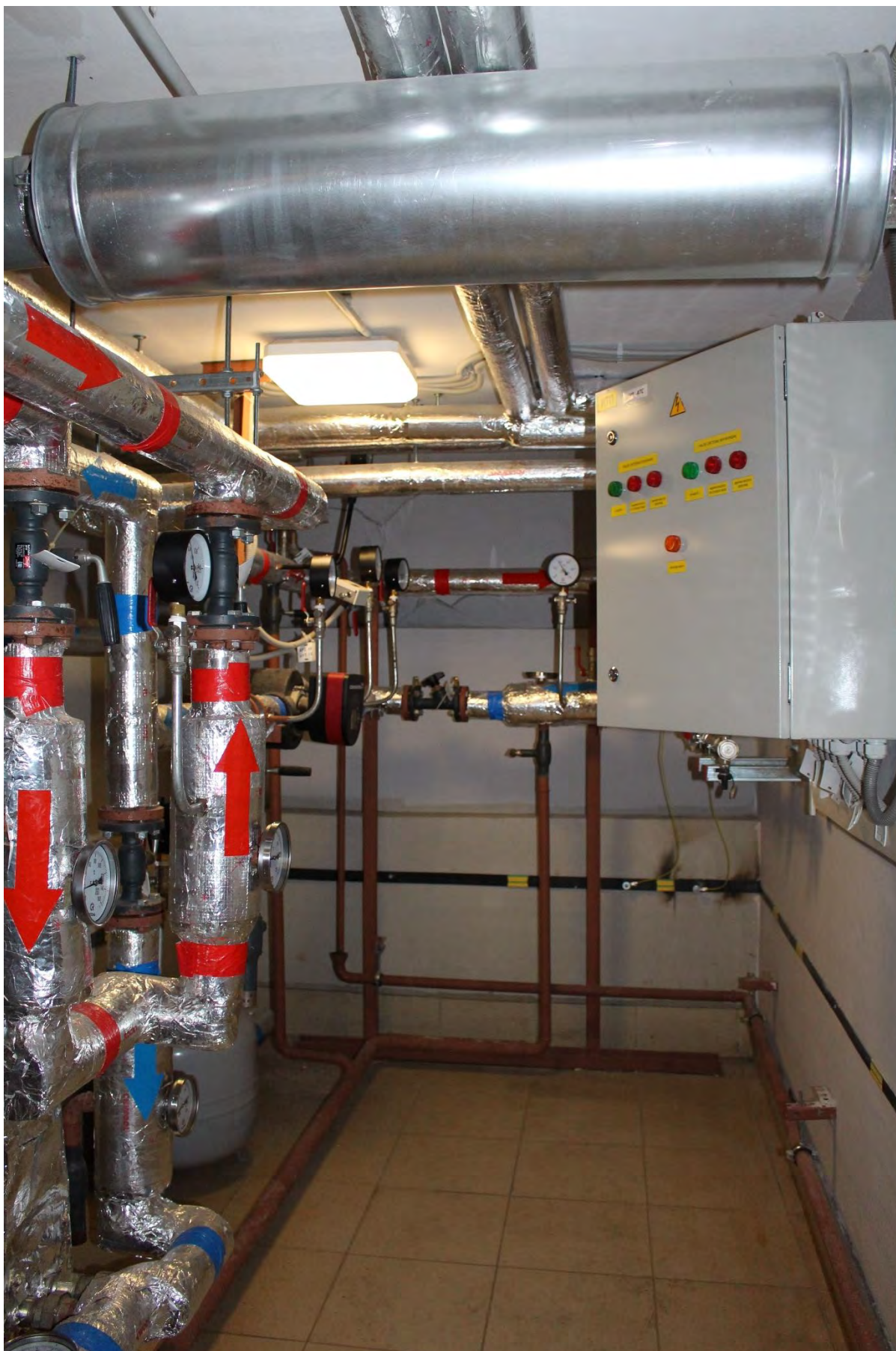
Фото 120. Подвальные помещения банного флигеля выявленного объекта культурного наследия «Главное здание градских богаделен (в 1770-х годах – здание Воспитательного дома)». Фото 19.05.2023 г.
