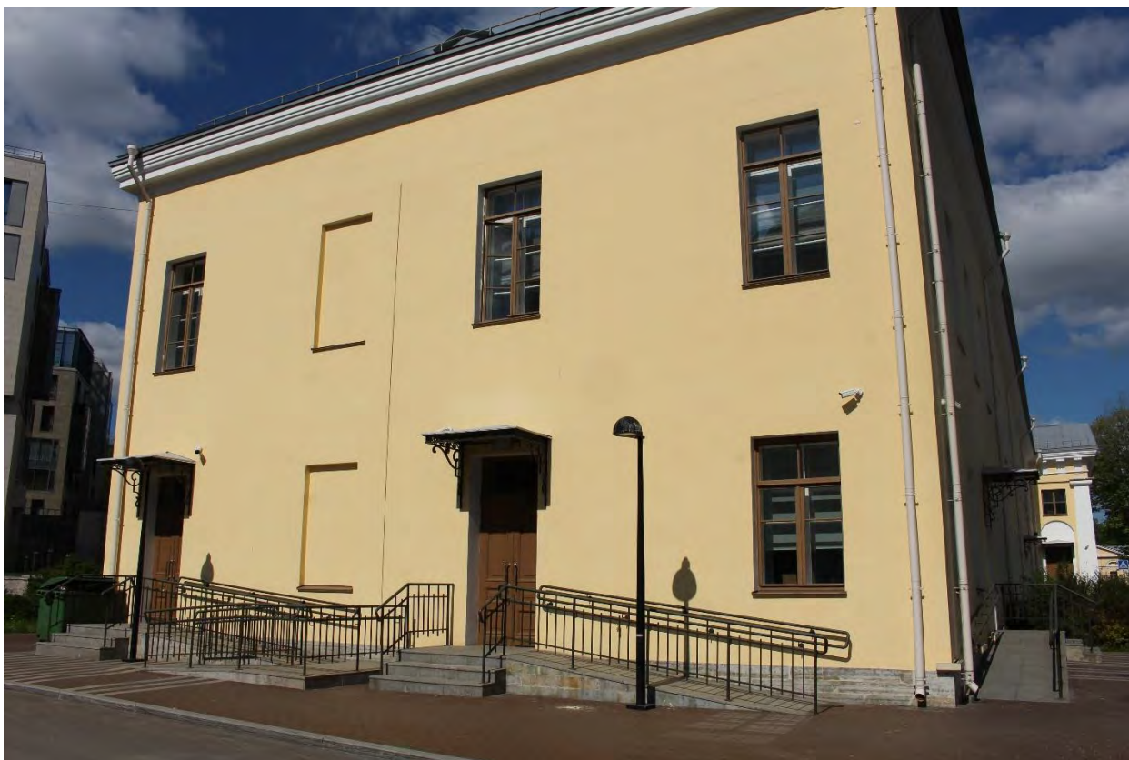
Фото 15. Вид на юго-восточный фасад главного корпуса выявленного объекта культурного наследия «Главное здание градских богаделен (в 1770-х годах – здание Воспитательного дома)». Фото 19.05.2023 г.
