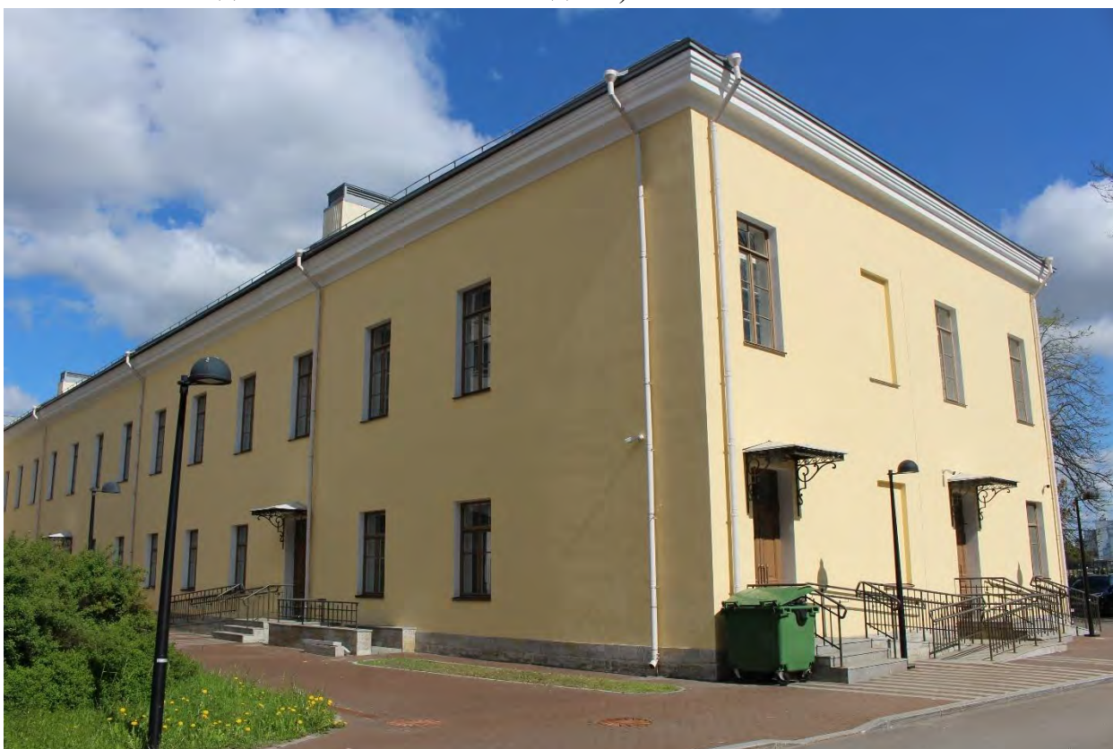
Фото 16. Вид на юго-западный фасад южного крыла главного корпуса выявленного объекта культурного наследия «Главное здание градских богаделен (в 1770-х годах – здание Воспитательного дома)». Фото 19.05.2023 г.
