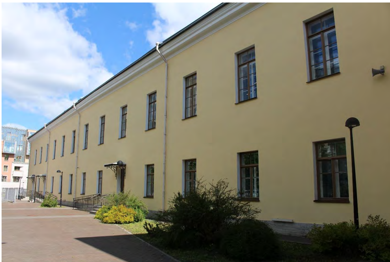
Фото 23. Вид на юго-западный фасад северного крыла главного корпуса выявленного объекта культурного наследия «Главное здание градских богаделен (в 1770-х годах – здание Воспитательного дома)». Фото 19.05.2023 г.
