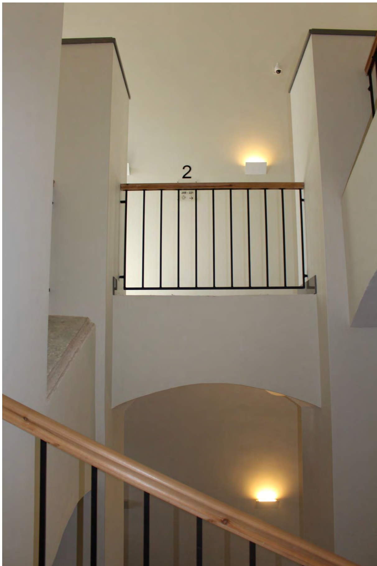
Фото 115. Юго-восточная историческая лестница южного крыла главного корпуса выявленного объекта культурного наследия «Главное здание градских богаделен (в 1770-х годах – здание Воспитательного дома)». Фото 19.05.2023 г.
