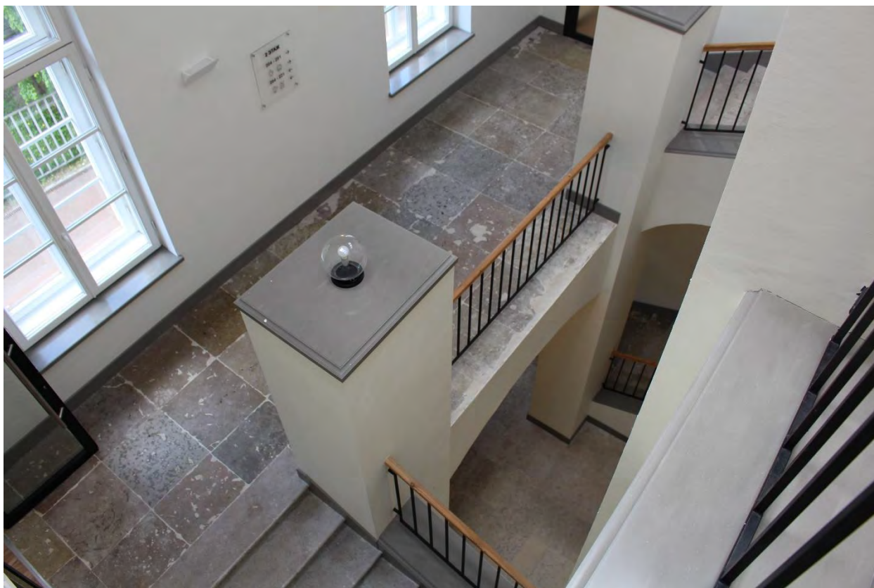
Фото 90. Северо-западная историческая лестница главного корпуса выявленного объекта культурного наследия «Главное здание градских богаделен (в 1770-х годах – здание Воспитательного дома)». Фото 19.05.2023 г.
