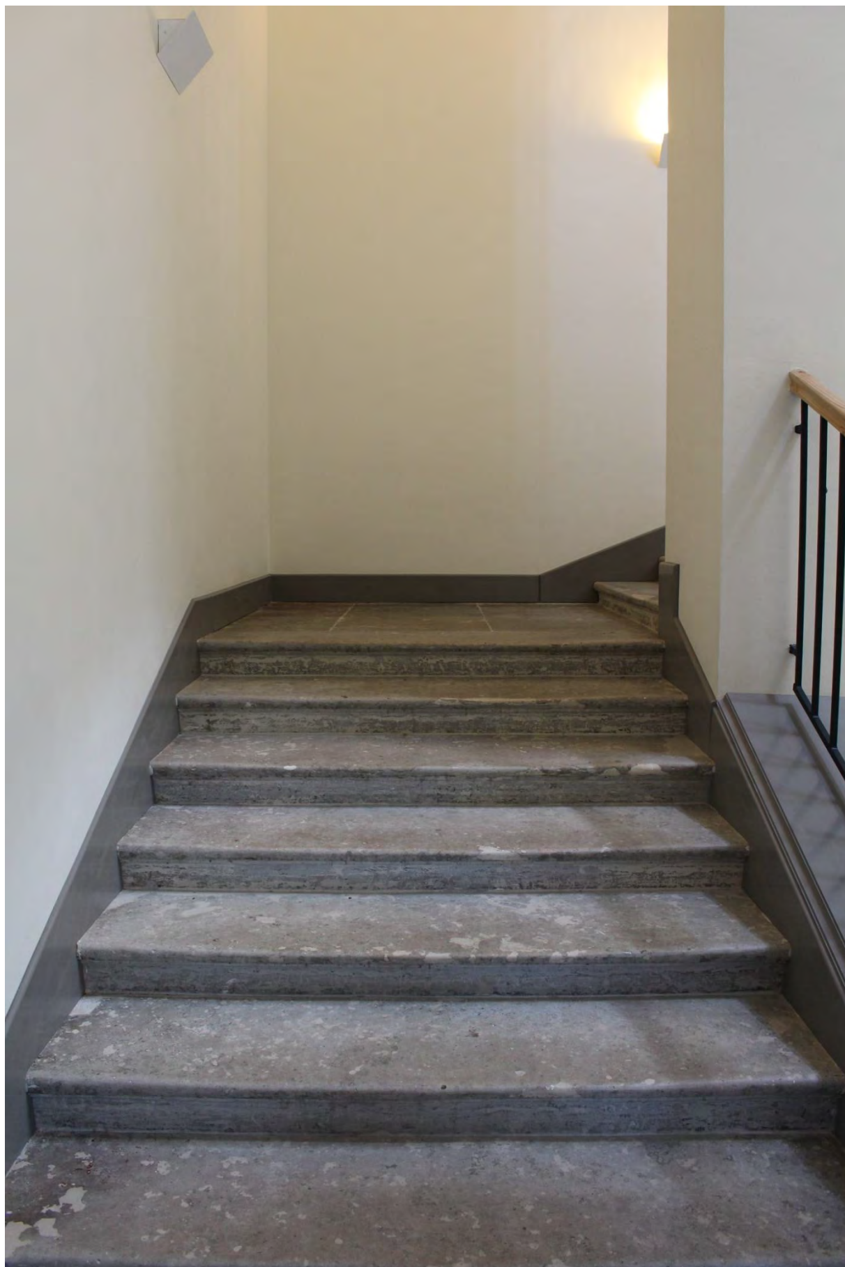
Фото 82. Северо-западная историческая лестница главного корпуса выявленного объекта культурного наследия «Главное здание градских богаделен (в 1770-х годах – здание Воспитательного дома)». Фото 19.05.2023 г.
