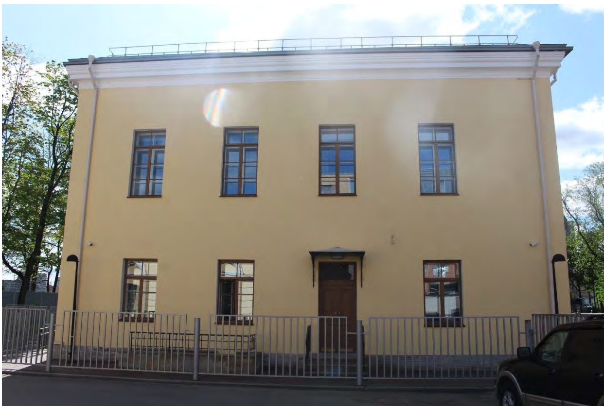
Фото 25. Вид на северо-западный фасад главного корпуса выявленного объекта культурного наследия «Главное здание градских богаделен (в 1770-х годах – здание Воспитательного дома)». Фото 19.05.2023 г.
