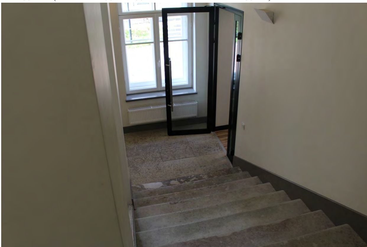
Фото 105. Северо-западная историческая лестница южного крыла главного корпуса выявленного объекта культурного наследия «Главное здание градских богаделен (в 1770-х годах – здание Воспитательного дома)». Фото 19.05.2023 г.
