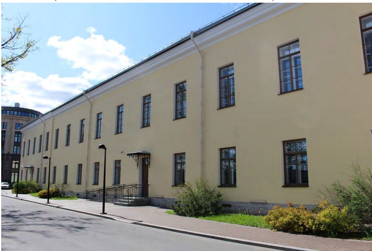
Фото 14. Вид на северо-восточный фасад южного крыла главного корпуса выявленного объекта культурного наследия «Главное здание градских богаделен (в 1770-х годах – здание Воспитательного дома)». Фото 19.05.2023 г.
