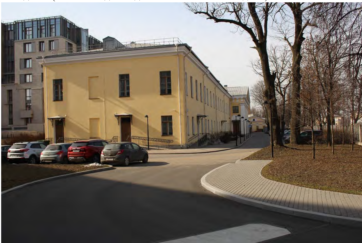
Фото 6. Вид на юго-восточный фасад южного крыла главного корпуса выявленного объекта культурного наследия «Главное здание градских богаделен (в 1770-х годах – здание Воспитательного дома)». Фото 17.04.2023 г.
