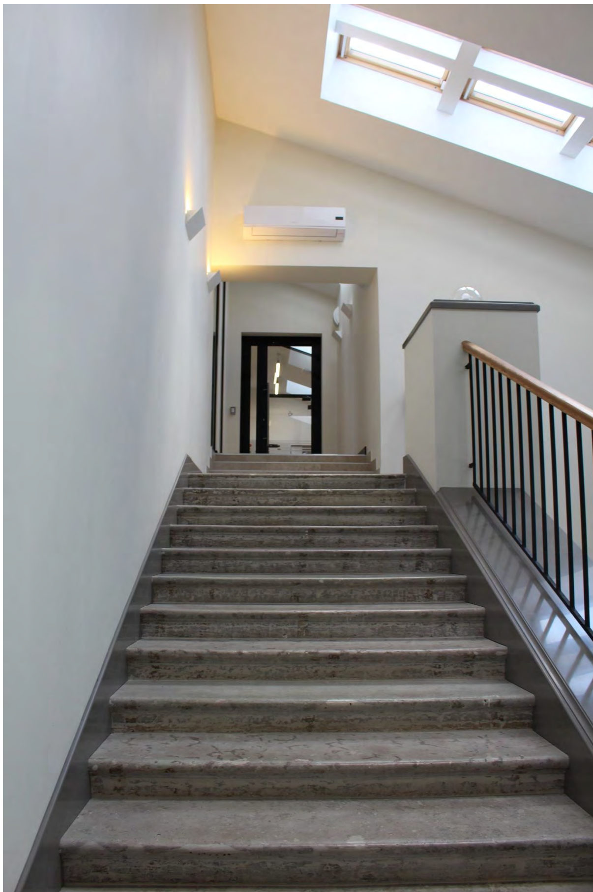
Фото 89. Северо-западная историческая лестница главного корпуса выявленного объекта культурного наследия «Главное здание градских богаделен (в 1770-х годах – здание Воспитательного дома)». Фото 19.05.2023 г.
