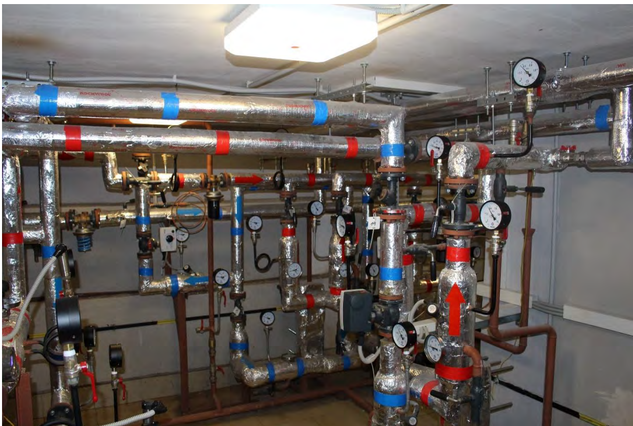
Фото 119. Подвальные помещения банного флигеля выявленного объекта культурного наследия «Главное здание градских богаделен (в 1770-х годах – здание Воспитательного дома)». Фото 19.05.2023 г.
