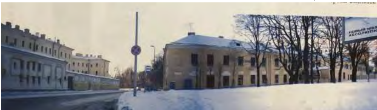
Илл. 53. Ул. Смольного. Вид со стороны Смольной наб. Здания №№ (по ул. Смольного): 3 (слева), 6, 4 (на дальнем плане). 2003 г. (источник: архив КГИОП П. 1144 Н-5667. Вх. № 3-2720 от 28.04.2003 г.).
