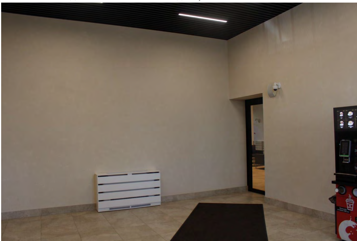
Фото 70. Внутренние помещения 1-го этажа главного корпуса выявленного объекта культурного наследия «Главное здание градских богаделен (в 1770-х годах – здание Воспитательного дома)». Фото 19.05.2023 г.
