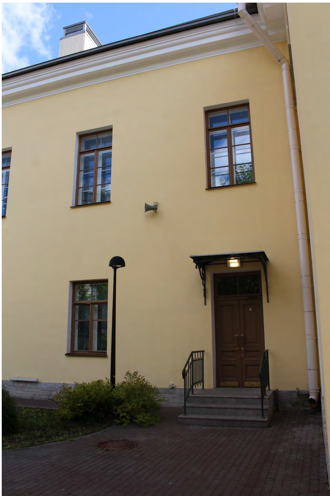
Фото 22. Вид на юго-западный фасад северного крыла главного корпуса выявленного объекта культурного наследия «Главное здание градских богаделен (в 1770-х годах – здание Воспитательного дома)». Фото 19.05.2023 г.
