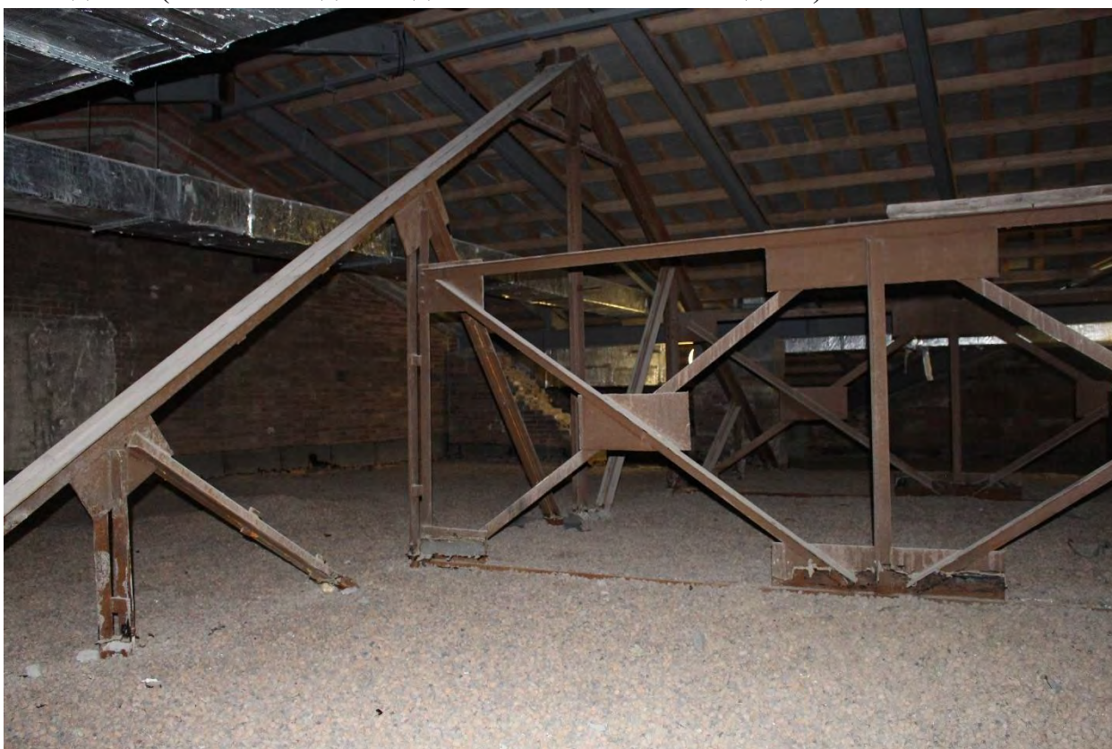
Фото 97. Чердачные помещения центрального объема главного корпуса выявленного объекта культурного наследия «Главное здание градских богаделен (в 1770-х годах – здание Воспитательного дома)». Фото 19.05.2023 г.
