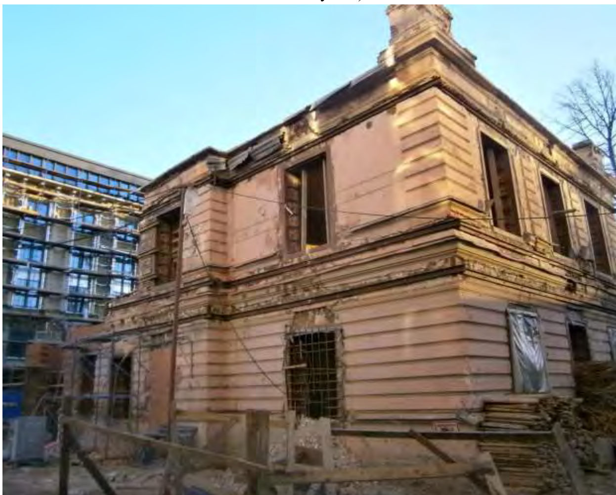
Илл. 70. Здание богадельни в память бракосочетания вел. кн. Ксении Александровны. Вид на северный фасад. 2015 г. (источник: https://p2.citywalls.ru/photo_469-480514.jpg?mt=1605735869 ).
