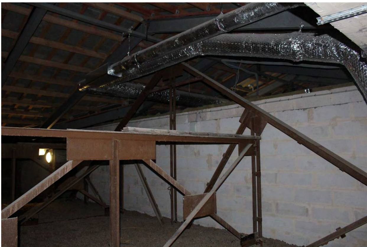
Фото 98. Чердачные помещения центрального объема главного корпуса выявленного объекта культурного наследия «Главное здание градских богаделен (в 1770-х годах – здание Воспитательного дома)». Фото 19.05.2023 г.
