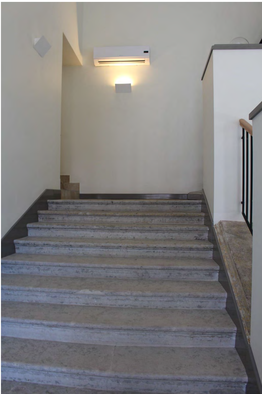
Фото 117. Юго-восточная историческая лестница южного крыла главного корпуса выявленного объекта культурного наследия «Главное здание градских богаделен (в 1770-х годах – здание Воспитательного дома)». Фото 19.05.2023 г.
