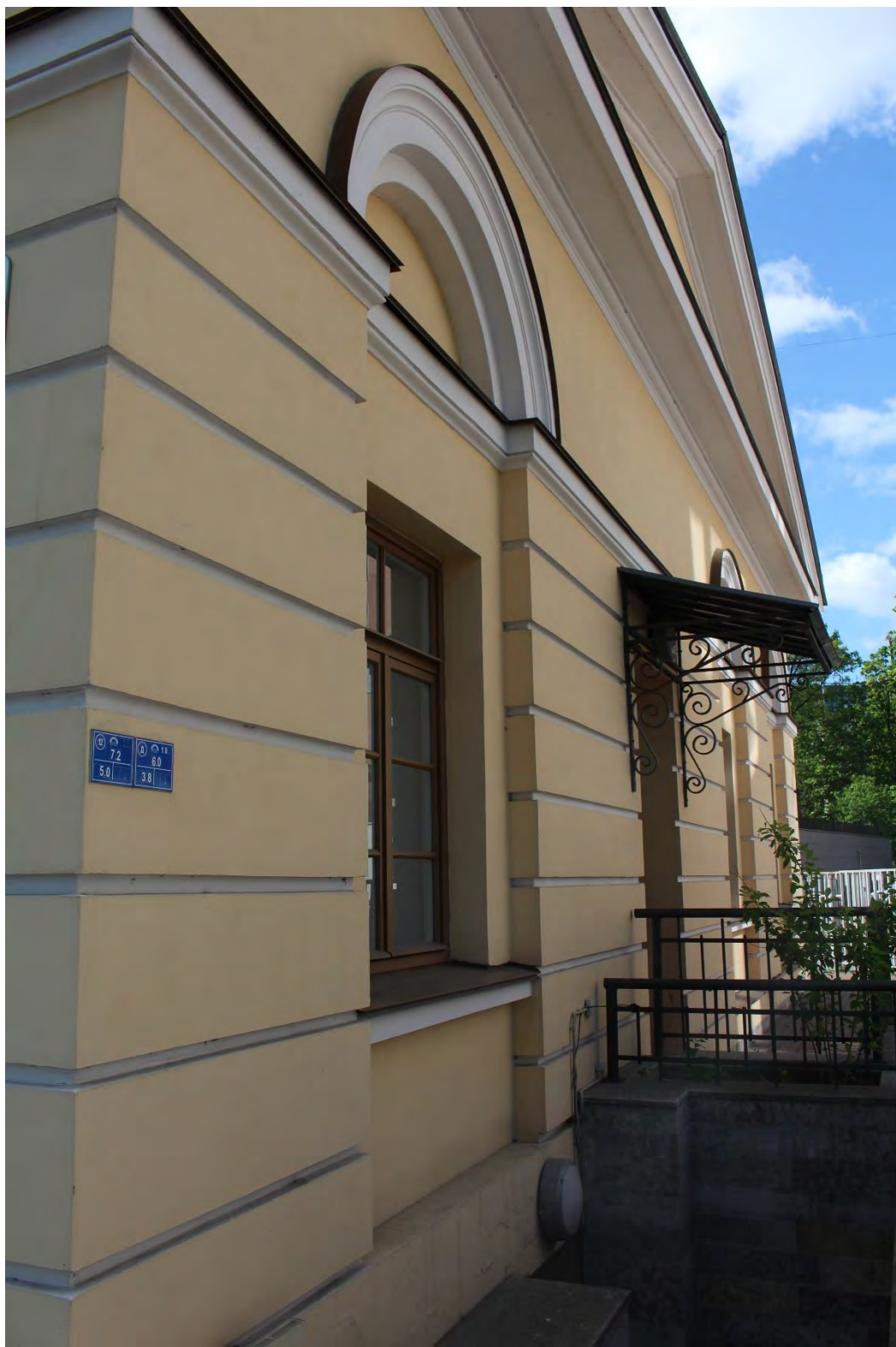
Фото 29. Вид на северо-западный фасад банного флигеля выявленного объекта культурного наследия «Главное здание градских богаделен (в 1770-х годах – здание Воспитательного дома)». Фото 19.05.2023 г.
