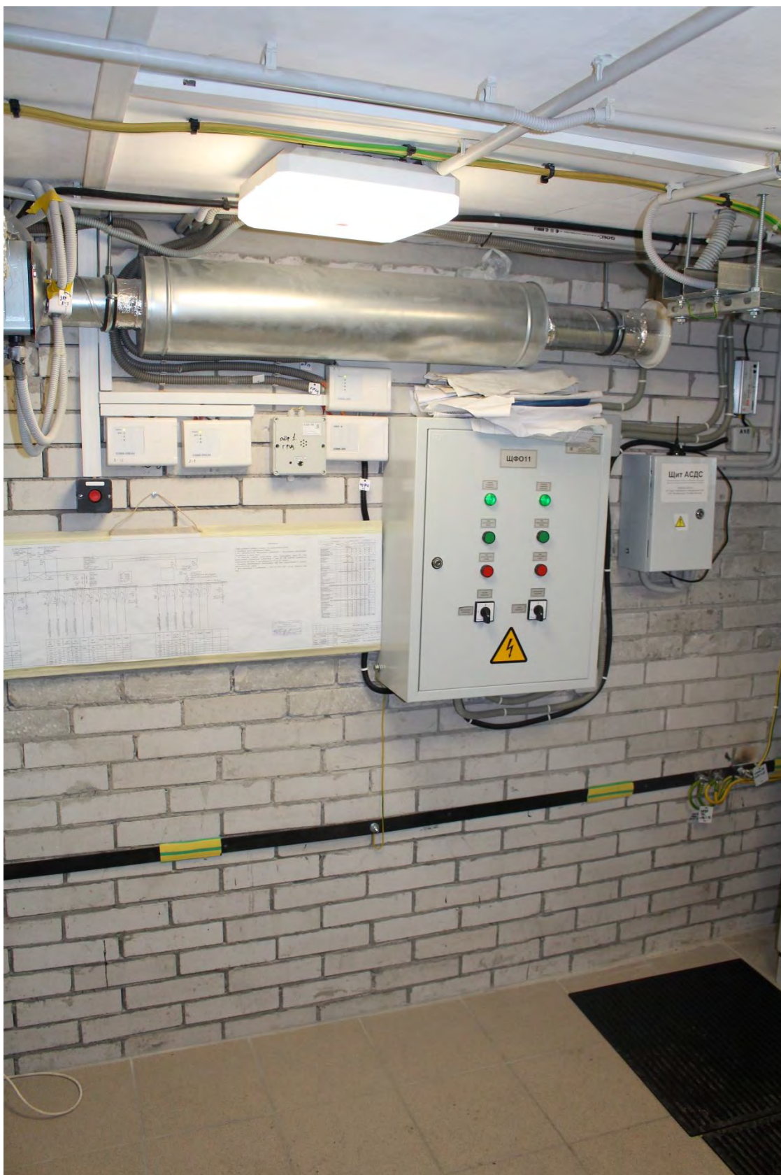
Фото 121. Подвальные помещения банного флигеля выявленного объекта культурного наследия «Главное здание градских богаделен (в 1770-х годах – здание Воспитательного дома)». Фото 19.05.2023 г.
