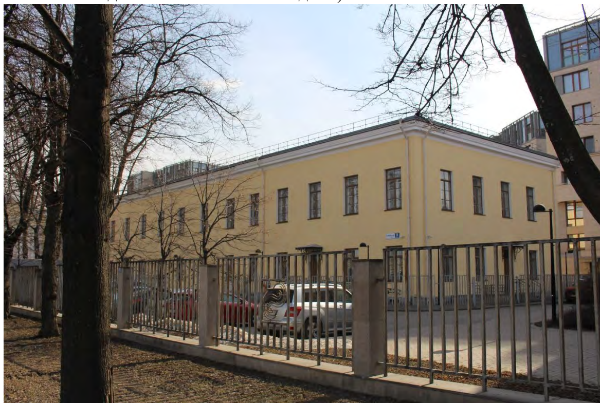
Фото 2. Вид на северо-восточный и северо-западный фасады северного крыла главного корпуса выявленного объекта культурного наследия «Главное здание градских богаделен (в 1770-х годах – здание Воспитательного дома)». Фото 17.04.2023 г.
