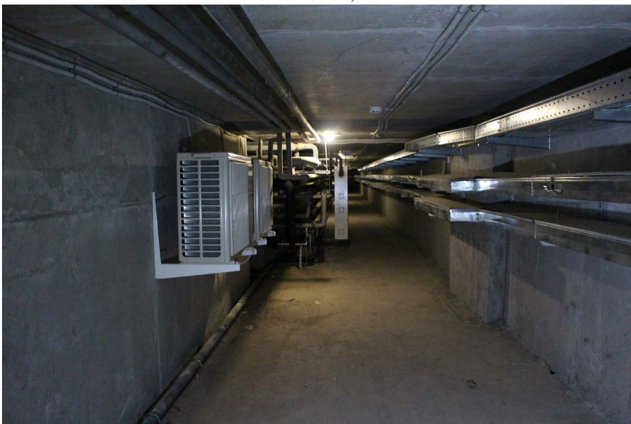
Фото 68. Подвальные помещения главного корпуса выявленного объекта культурного наследия «Главное здание градских богаделен (в 1770-х годах – здание Воспитательного дома)». Фото 19.05.2023 г.
