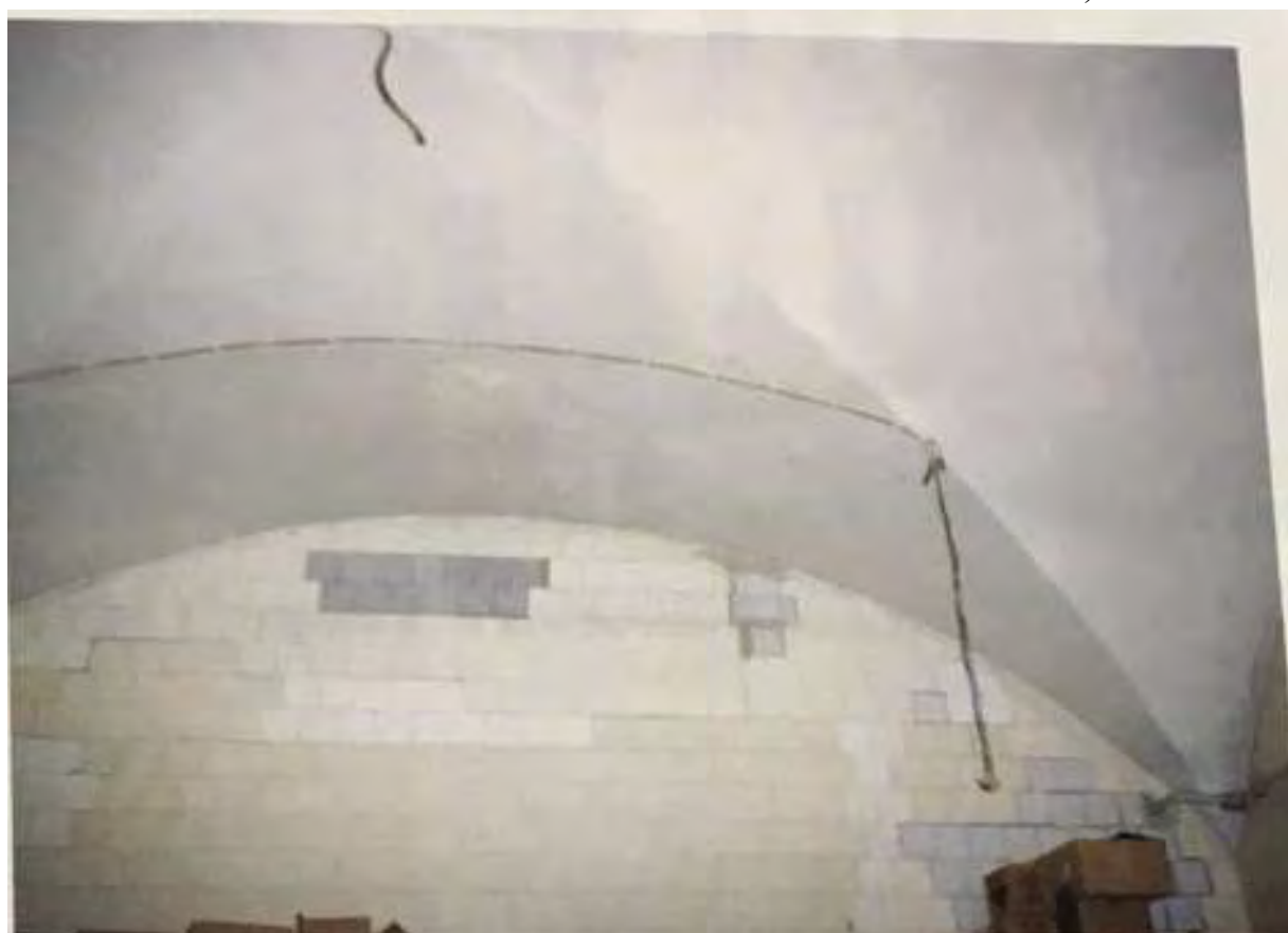
Илл. 62. Корпус А8. Фрагмент интерьера. 2003 г. (источник: архив КГИОП П. 1144 Н-5667. Вх. № 3-2720 от 28.04.2003 г.).
