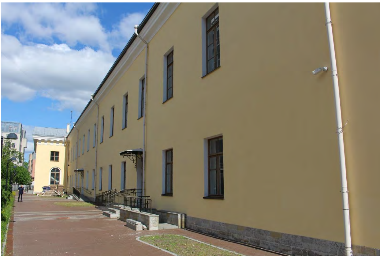
Фото 17. Вид на юго-западный фасад главного корпуса выявленного объекта культурного наследия «Главное здание градских богаделен (в 1770-х годах – здание Воспитательного дома)». Фото 19.05.2023 г.
