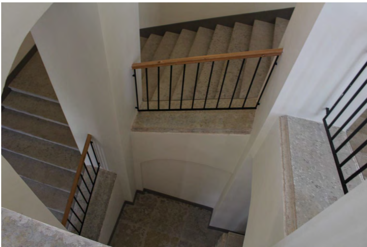
Фото 116. Юго-восточная историческая лестница южного крыла главного корпуса выявленного объекта культурного наследия «Главное здание градских богаделен (в 1770-х годах – здание Воспитательного дома)». Фото 19.05.2023 г.
