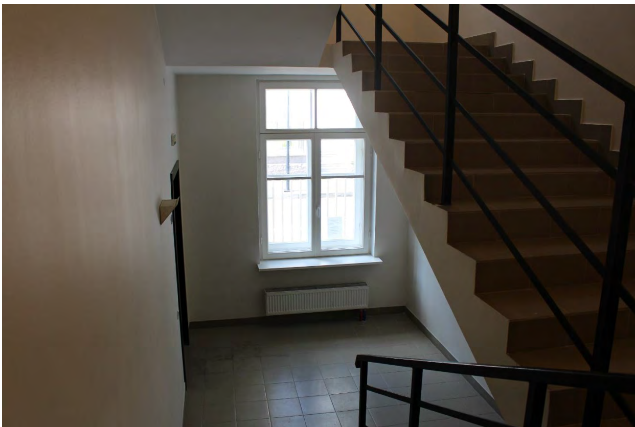
Фото 94. Неисторическая лестничная клетка в северо-западной части главного корпуса выявленного объекта культурного наследия «Главное здание градских богаделен (в 1770-х годах – здание Воспитательного дома)». Фото 19.05.2023 г.
