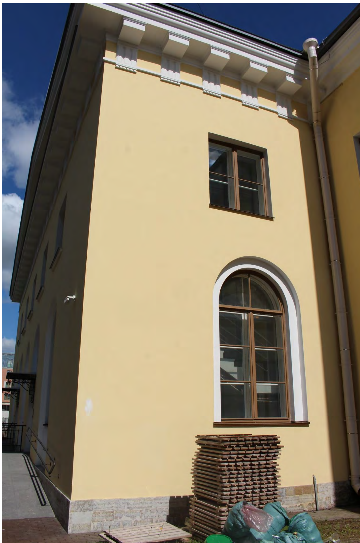
Фото 18. Вид на юго-восточный фасад центрального объема главного корпуса выявленного объекта культурного наследия «Главное здание градских богаделен (в 1770-х годах – здание Воспитательного дома)». Фото 19.05.2023 г.
