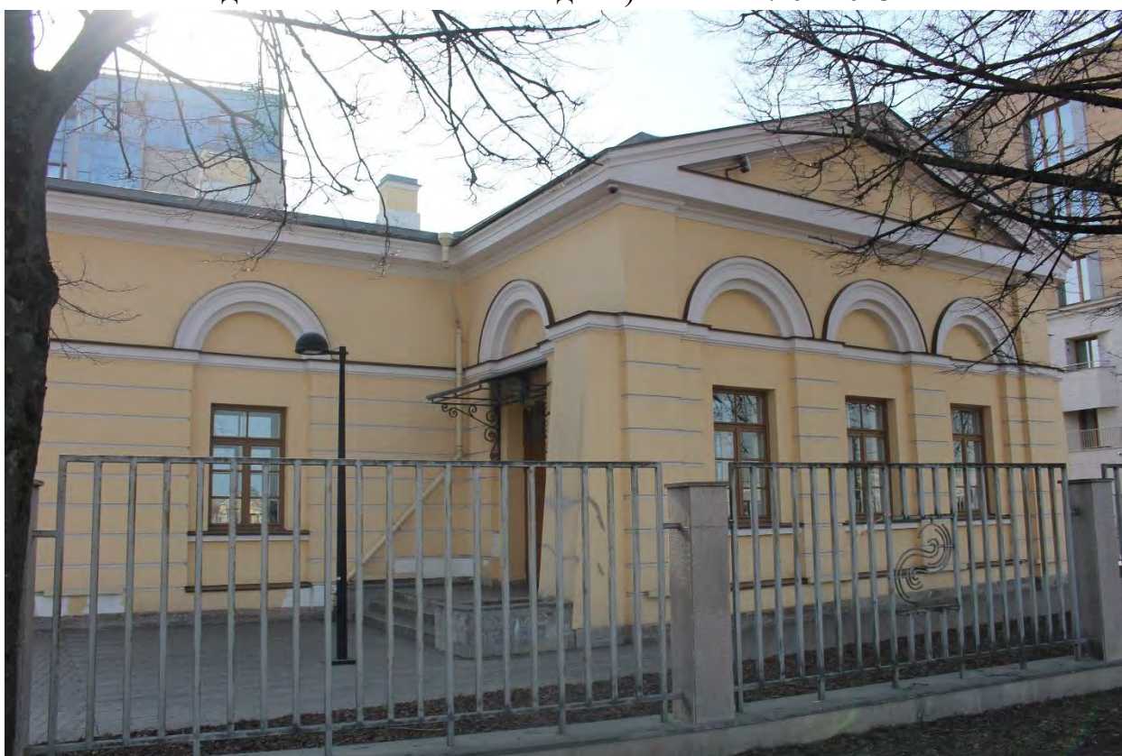
Фото 8. Вид на северо-восточный фасад банного флигеля выявленного объекта культурного наследия «Главное здание градских богаделен (в 1770-х годах – здание Воспитательного дома)». Фото 17.04.2023 г.
