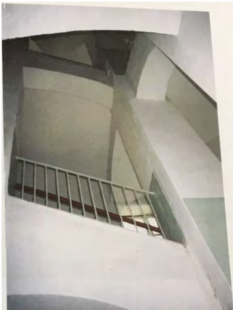
Илл. 58. Корпус А1. Интерьер лестницы. 2003 г. (источник: архив КГИОП П. 1144 Н-5667. Вх. № 3-2720 от 28.04.2003 г.).
