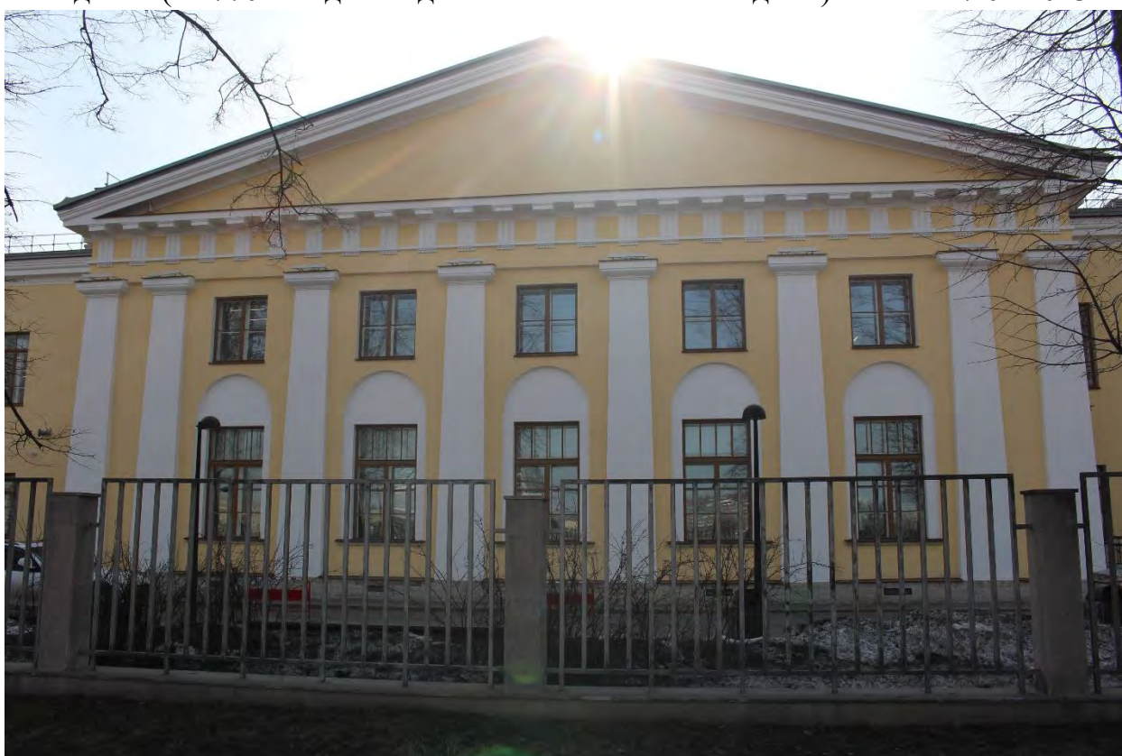
Фото 4. Вид на северо-восточный фасад центрального объема главного корпуса выявленного объекта культурного наследия «Главное здание градских богаделен (в 1770-х годах – здание Воспитательного дома)». Фото 17.04.2023 г.
