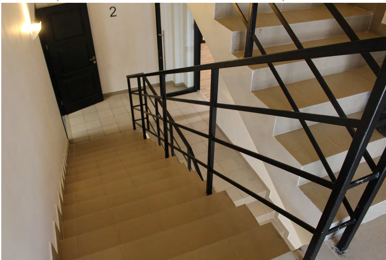
Фото 93. Неисторическая лестничная клетка в северо-западной части главного корпуса выявленного объекта культурного наследия «Главное здание градских богаделен (в 1770-х годах – здание Воспитательного дома)». Фото 19.05.2023 г.
