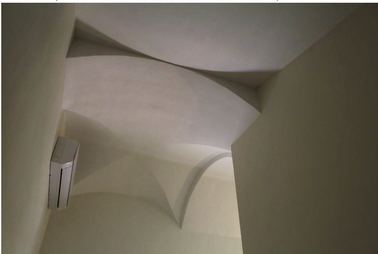
Фото 85. Северо-западная историческая лестница главного корпуса выявленного объекта культурного наследия «Главное здание градских богаделен (в 1770-х годах – здание Воспитательного дома)». Фото 19.05.2023 г.
