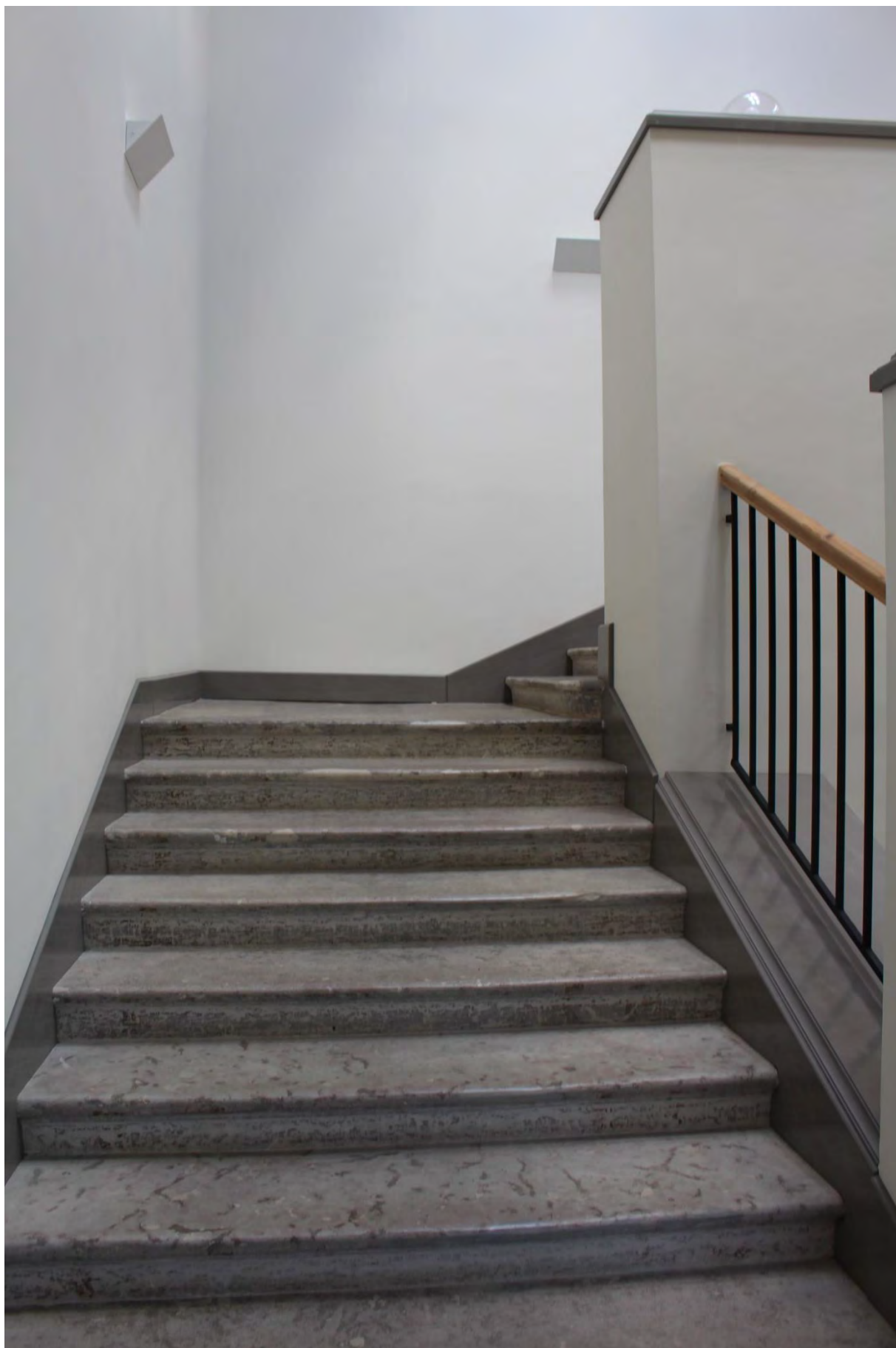
Фото 88. Северо-западная историческая лестница главного корпуса выявленного объекта культурного наследия «Главное здание градских богаделен (в 1770-х годах – здание Воспитательного дома)». Фото 19.05.2023 г.
