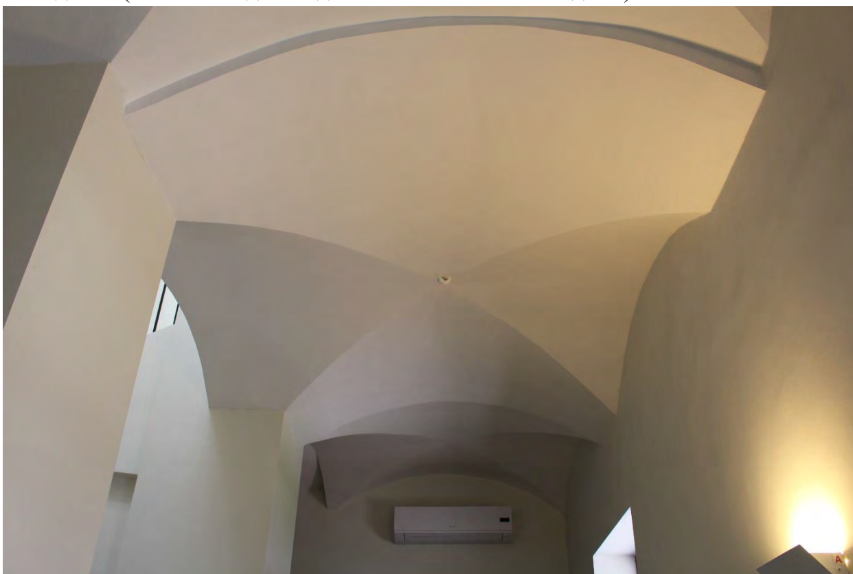
Фото 107. Северо-западная историческая лестница южного крыла главного корпуса выявленного объекта культурного наследия «Главное здание градских богаделен (в 1770-х годах – здание Воспитательного дома)». Фото 19.05.2023 г.
