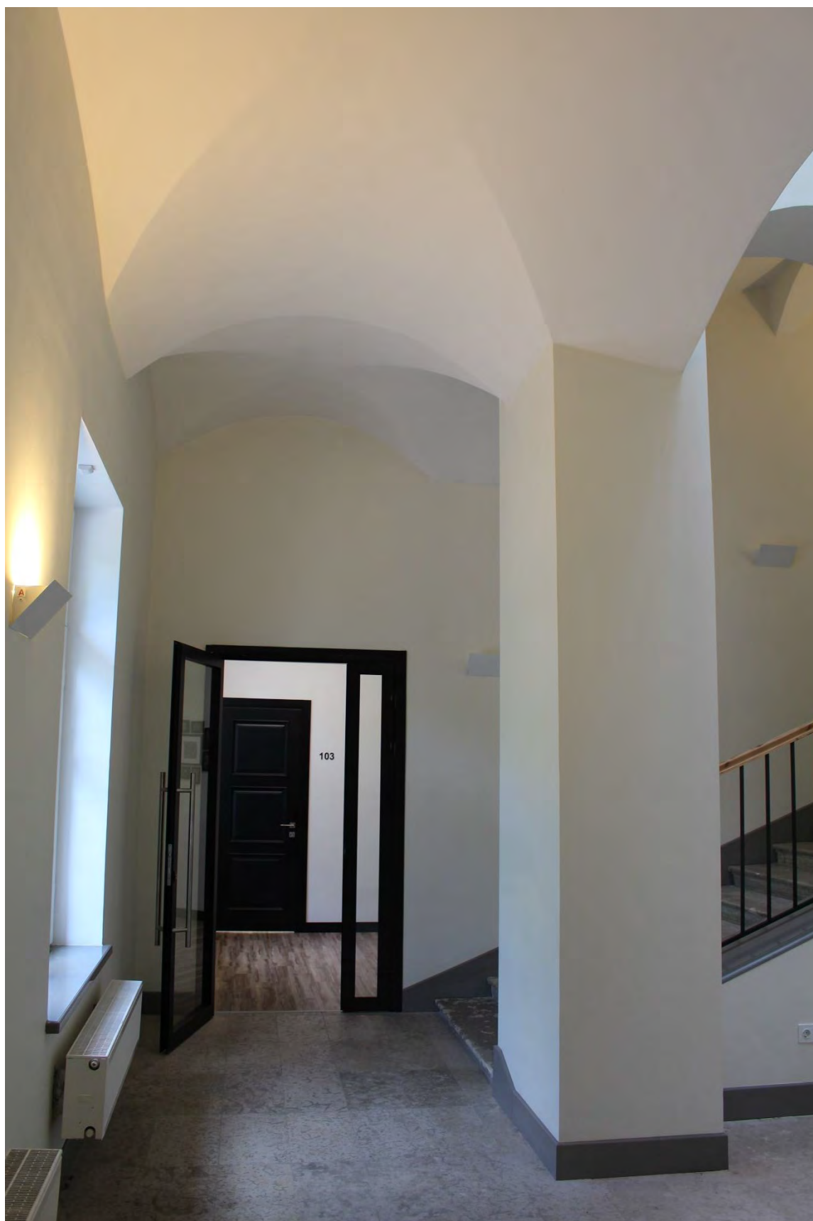
Фото 79. Северо-западная историческая лестница главного корпуса выявленного объекта культурного наследия «Главное здание градских богаделен (в 1770-х годах – здание Воспитательного дома)». Фото 19.05.2023 г.
