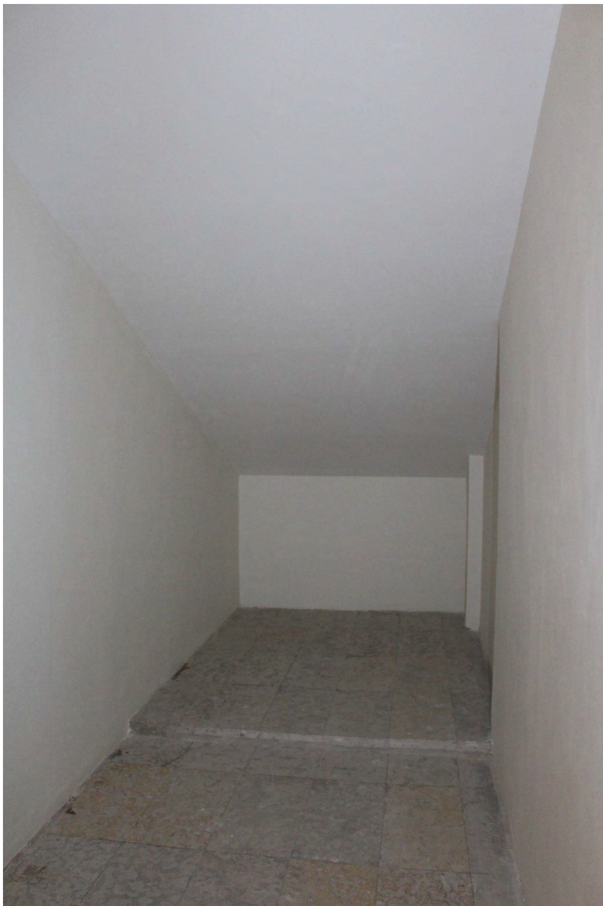
Фото 81. Северо-западная историческая лестница главного корпуса выявленного объекта культурного наследия «Главное здание градских богаделен (в 1770-х годах – здание Воспитательного дома)». Фото 19.05.2023 г.
