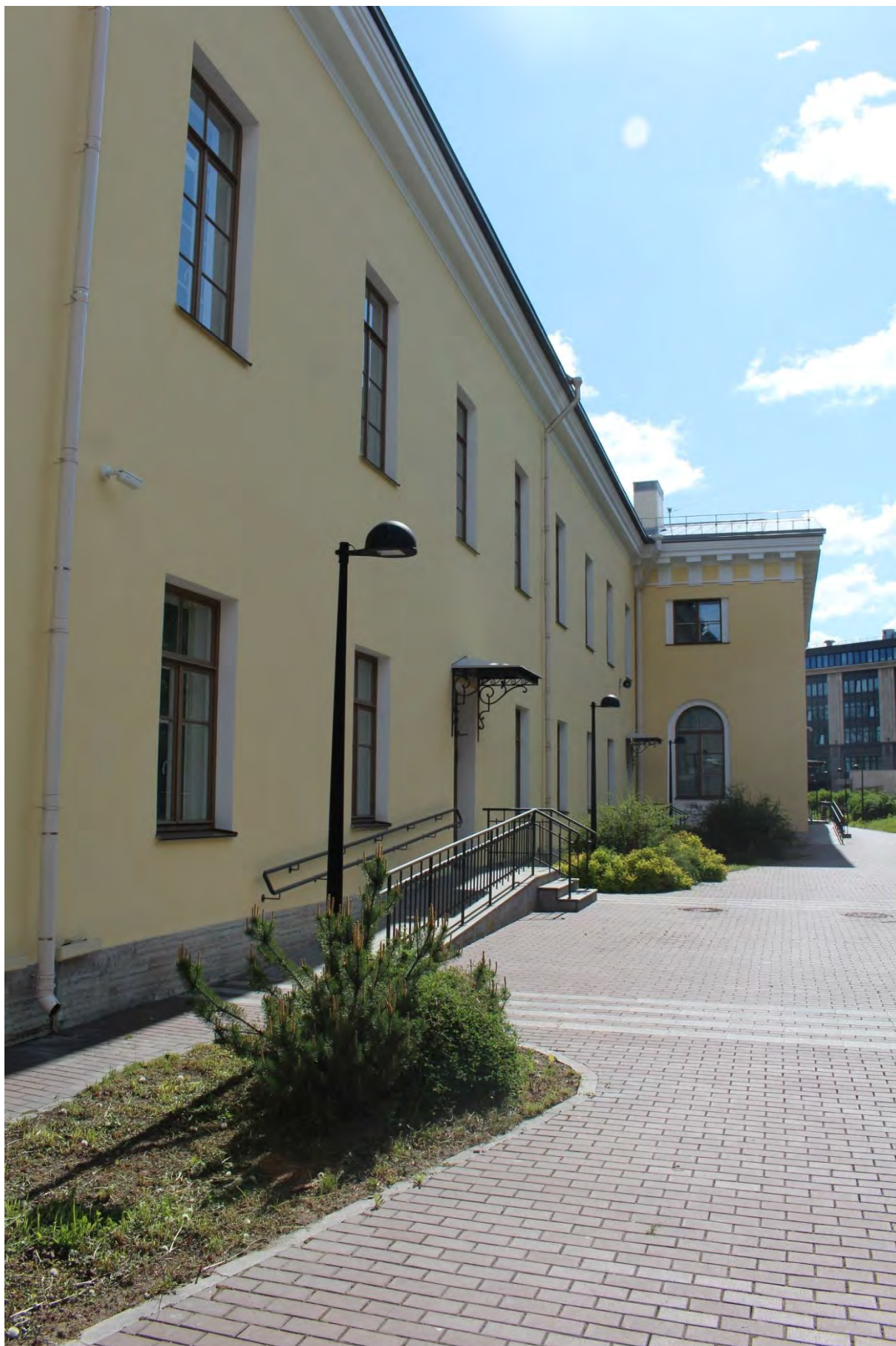
Фото 24. Вид на юго-западный фасад северного крыла главного корпуса выявленного объекта культурного наследия «Главное здание градских богаделен (в 1770-х годах – здание Воспитательного дома)». Фото 19.05.2023 г.
