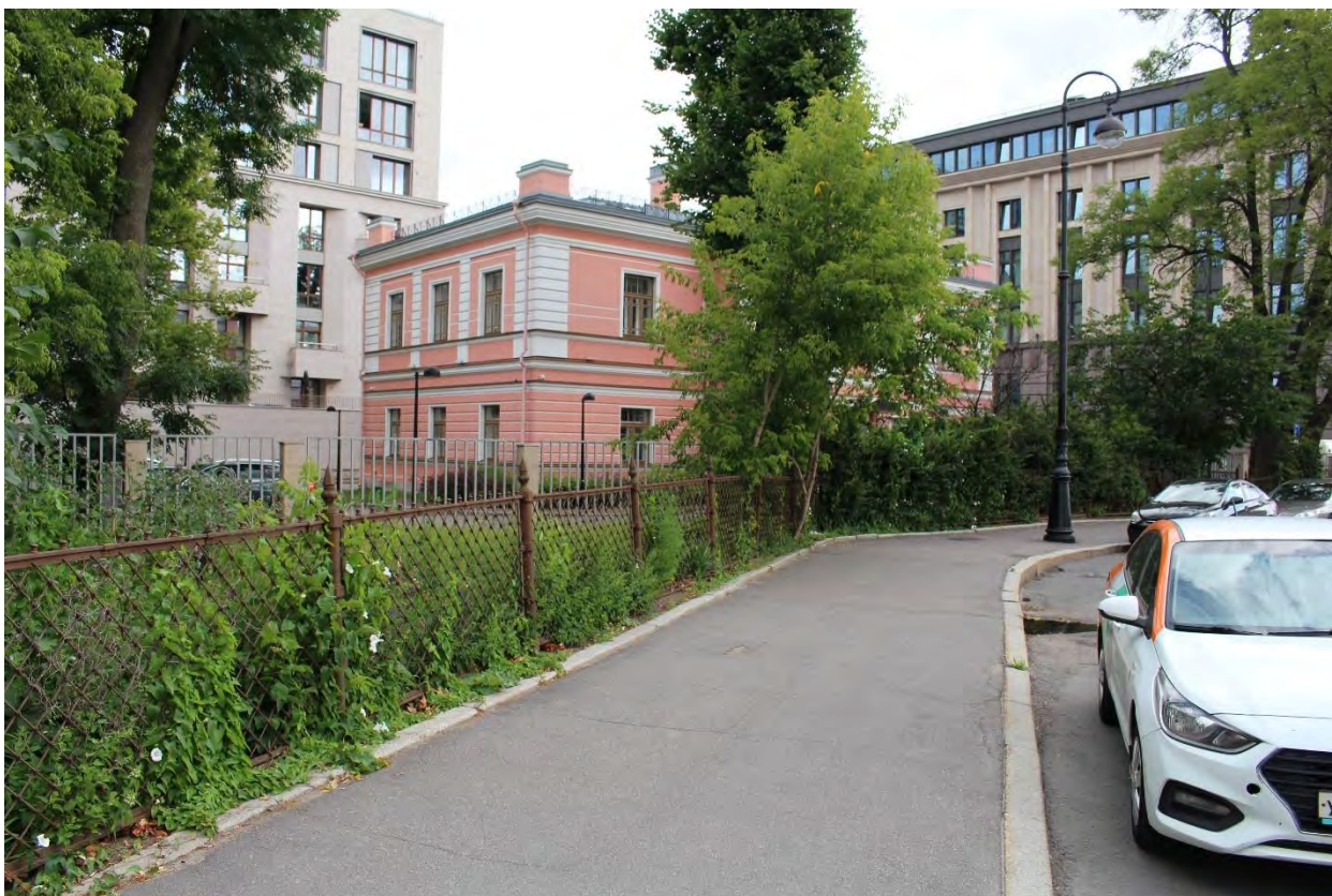
Фото 63. Вид на выявленный объект культурного наследия «Ограда». Фото 19.05.2023 г.
