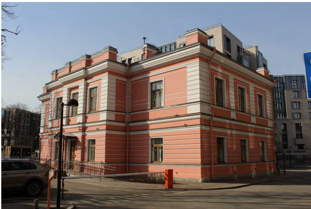
Фото 11. Вид на южный и восточный фасады выявленного объекта культурного наследия «Здание богадельни в память бракосочетания вел.кн. Ксении Александровны». Фото 17.04.2023 г.
