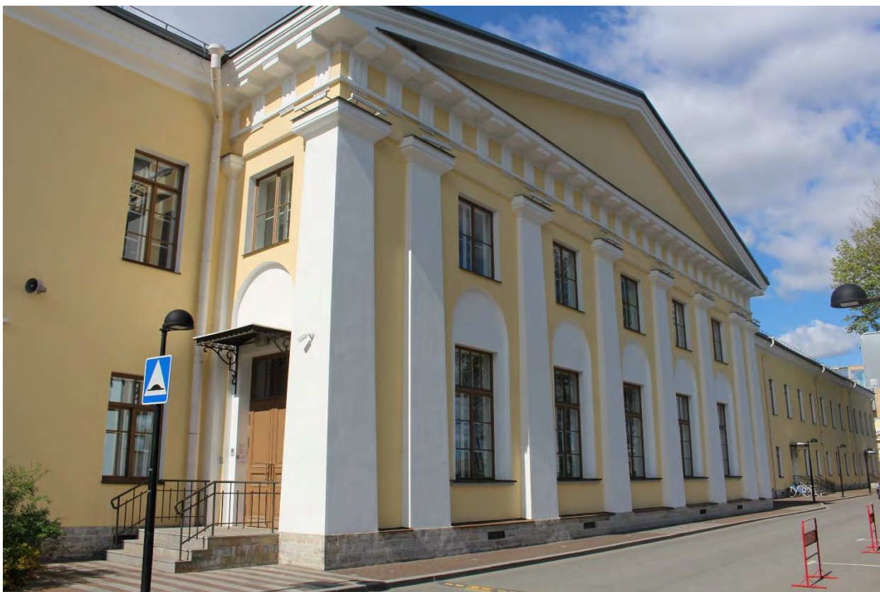
Фото 13. Вид на северо-восточный фасад центрального объема главного корпуса выявленного объекта культурного наследия «Главное здание градских богаделен (в 1770-х годах – здание Воспитательного дома)». Фото 19.05.2023 г.
