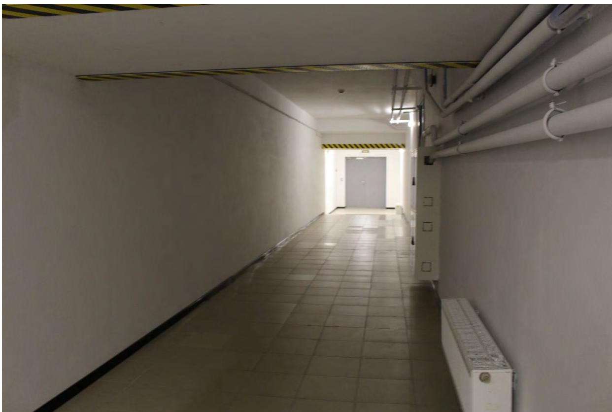
Фото 96. Внутренние помещения мансардного этажа главного корпуса выявленного объекта культурного наследия «Главное здание градских богаделен (в 1770-х годах – здание Воспитательного дома)». Фото 19.05.2023 г.
