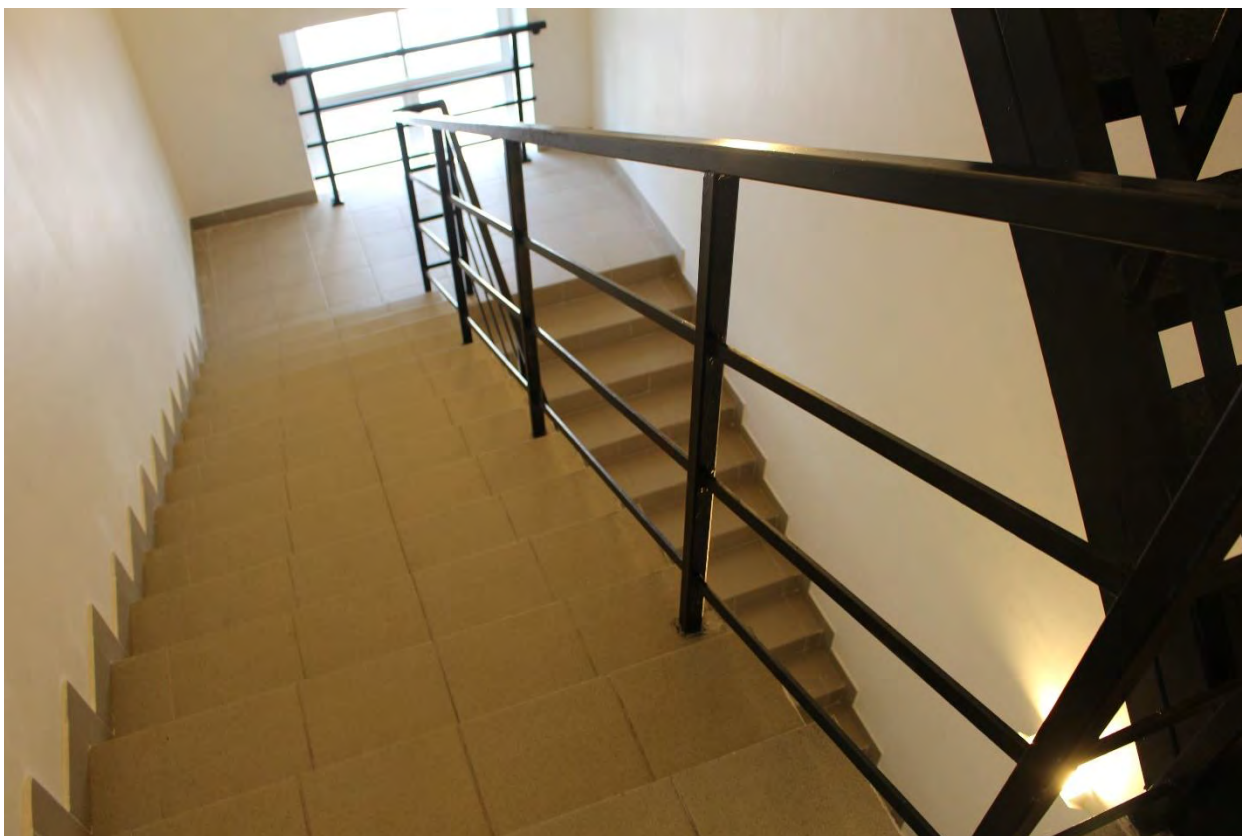
Фото 92. Неисторическая лестничная клетка в северо-западной части главного корпуса выявленного объекта культурного наследия «Главное здание градских богаделен (в 1770-х годах – здание Воспитательного дома)». Фото 19.05.2023 г.
