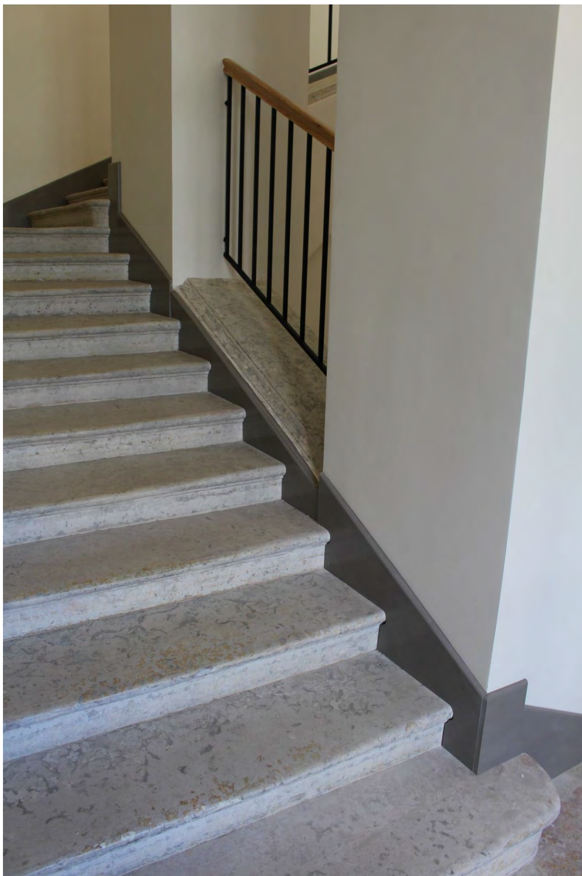
Фото 113. Юго-восточная историческая лестница южного крыла главного корпуса выявленного объекта культурного наследия «Главное здание градских богаделен (в 1770-х годах – здание Воспитательного дома)». Фото 19.05.2023 г.
