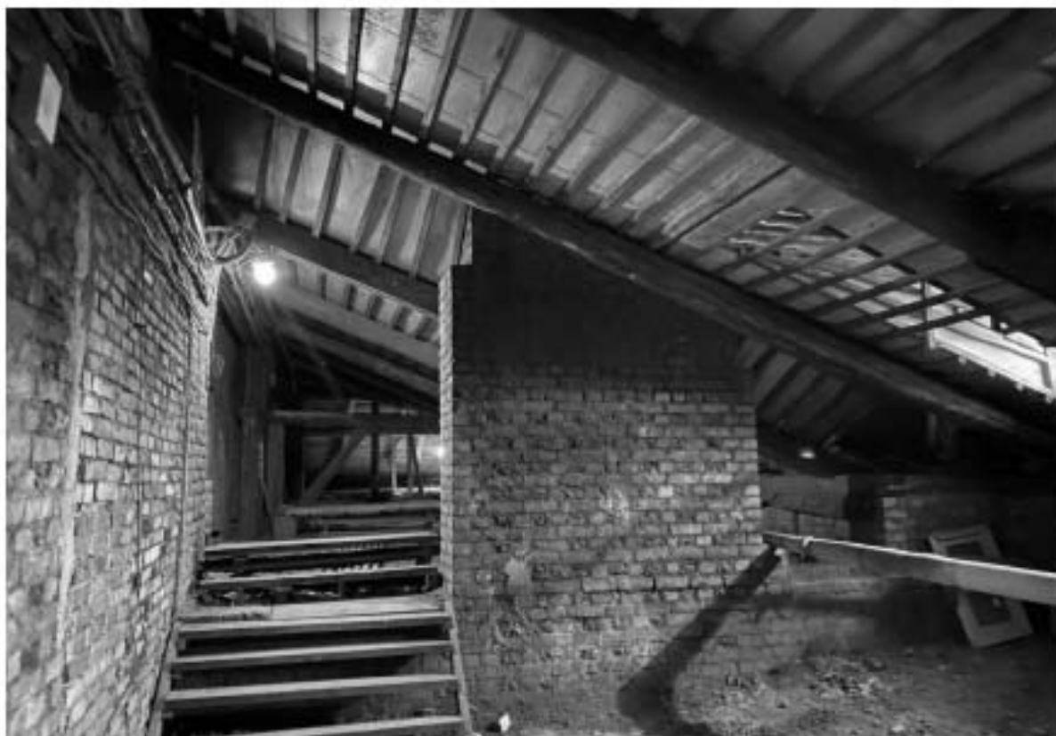
20. Вид на чердачное помещение объекта культурного наследия.
