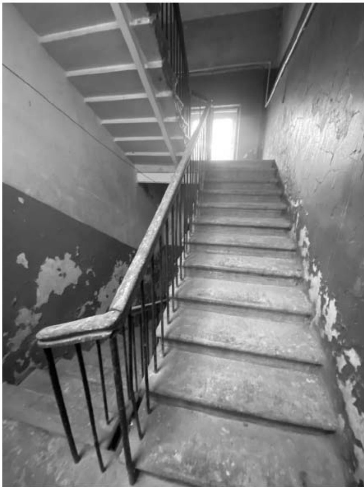
112. Служебная лестница Л5 объекта культурного наследия в уровне 5-го этажа.
