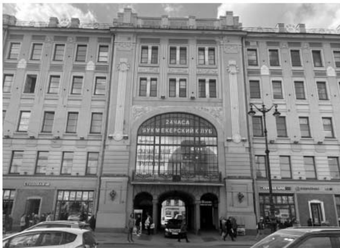
3. Фрагмент лицевого фасада объекта культурного наследия.
