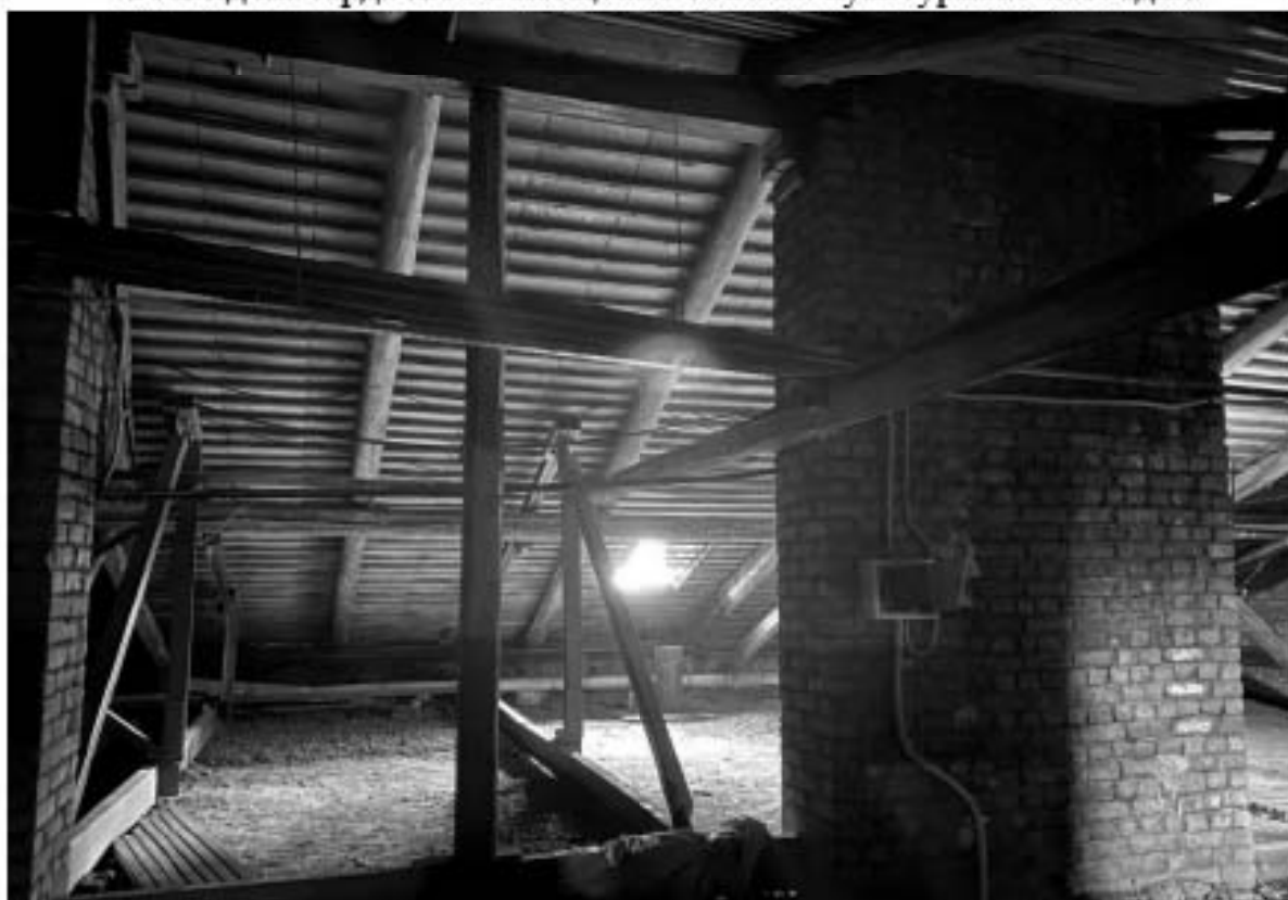
21. Вид на чердачное помещение объекта культурного наследия.
