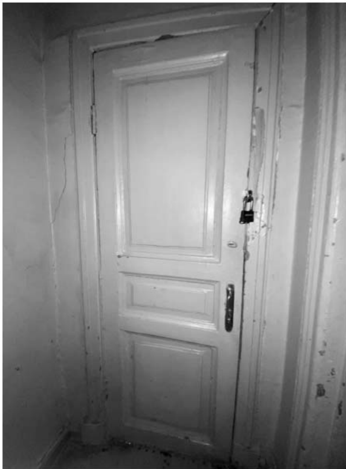
59. Дверное заполнение помещения объекта культурного наследия в уровне 2-го этажа.
