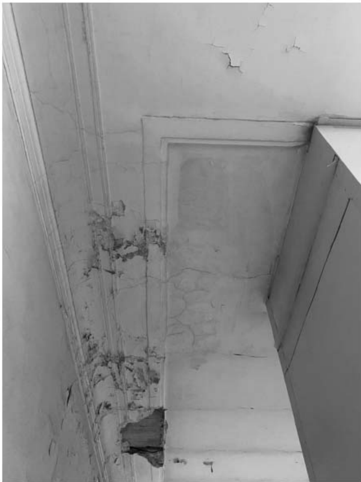
101. Верхнее перекрытие лестницы Л4 объекта культурного наследия в уровне 5-го этажа.
