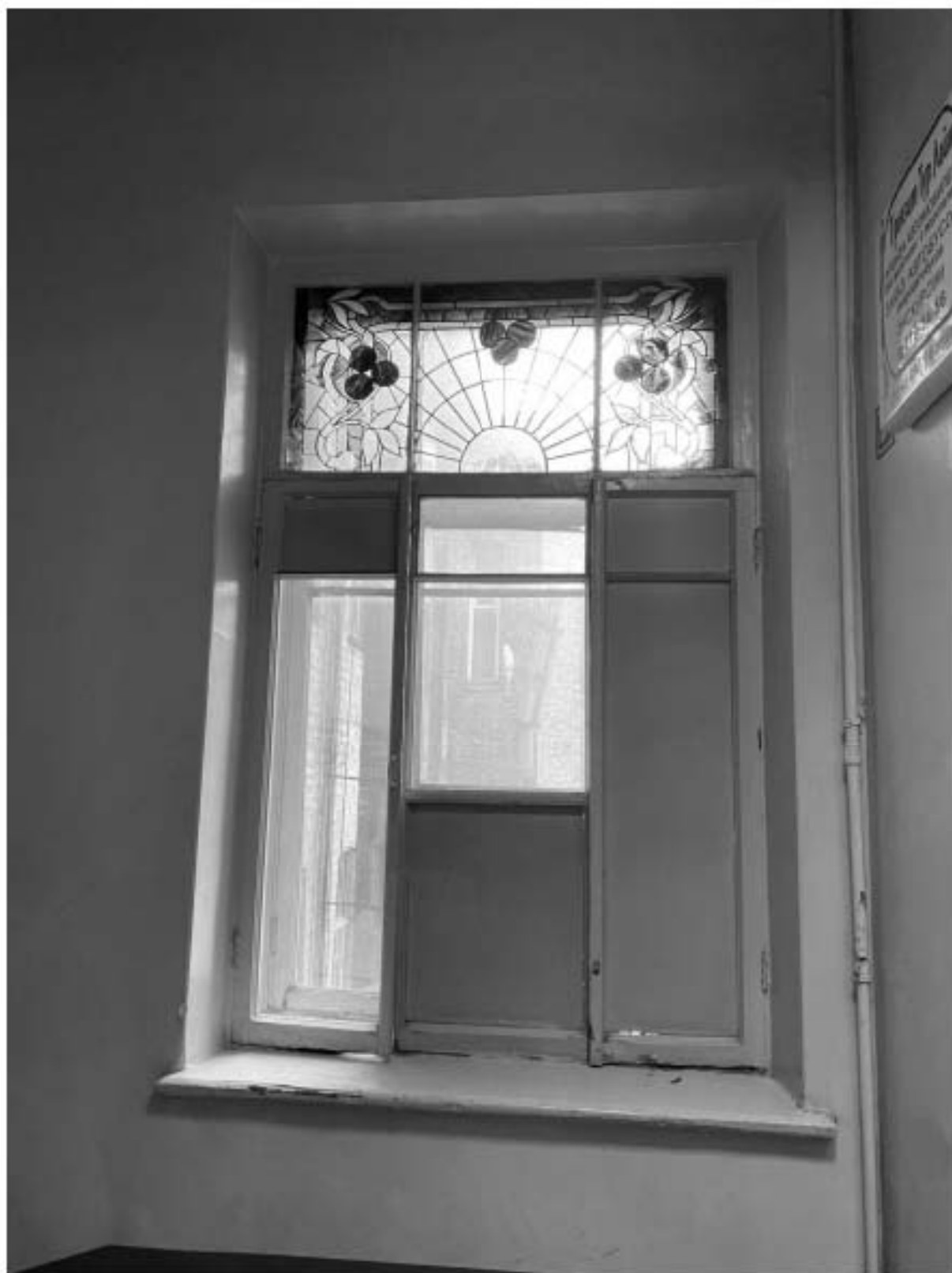
116. Оконное заполнение парадной лестницы Л4 объекта культурного наследия в уровне 5-го этажа.
