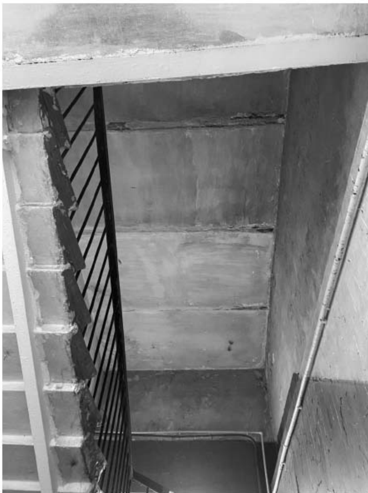
111. Служебная лестница Л5 объекта культурного наследия в уровне 6-го этажа.
