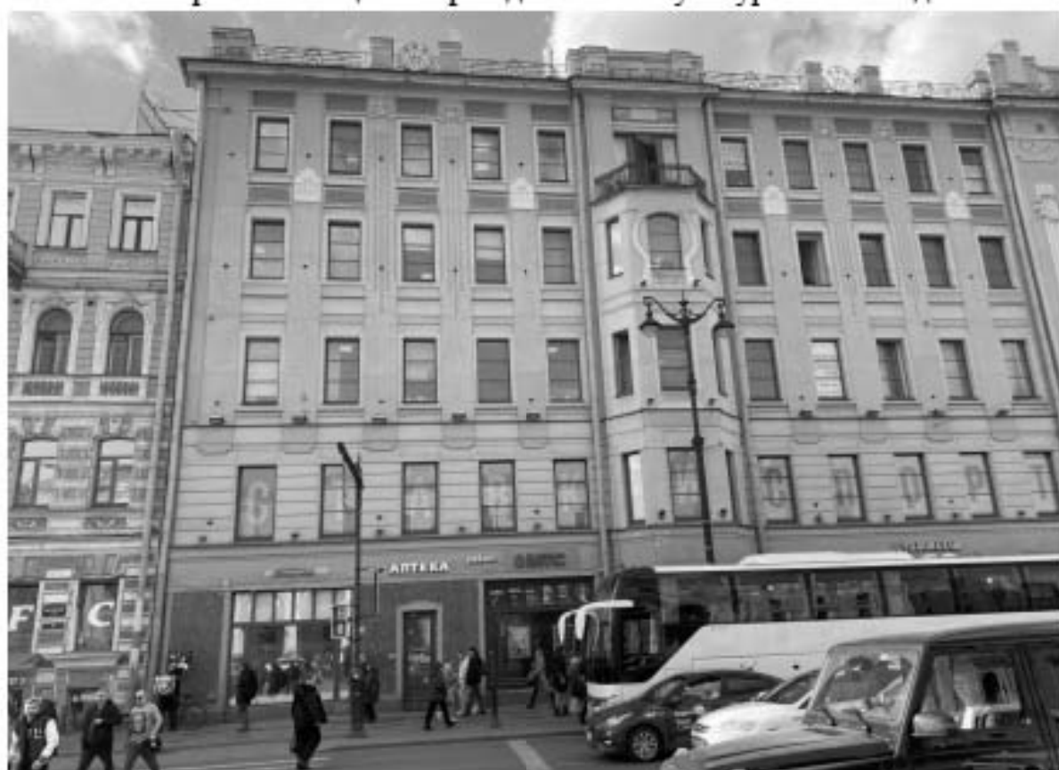
4. Фрагмент лицевого фасада объекта культурного наследия.
