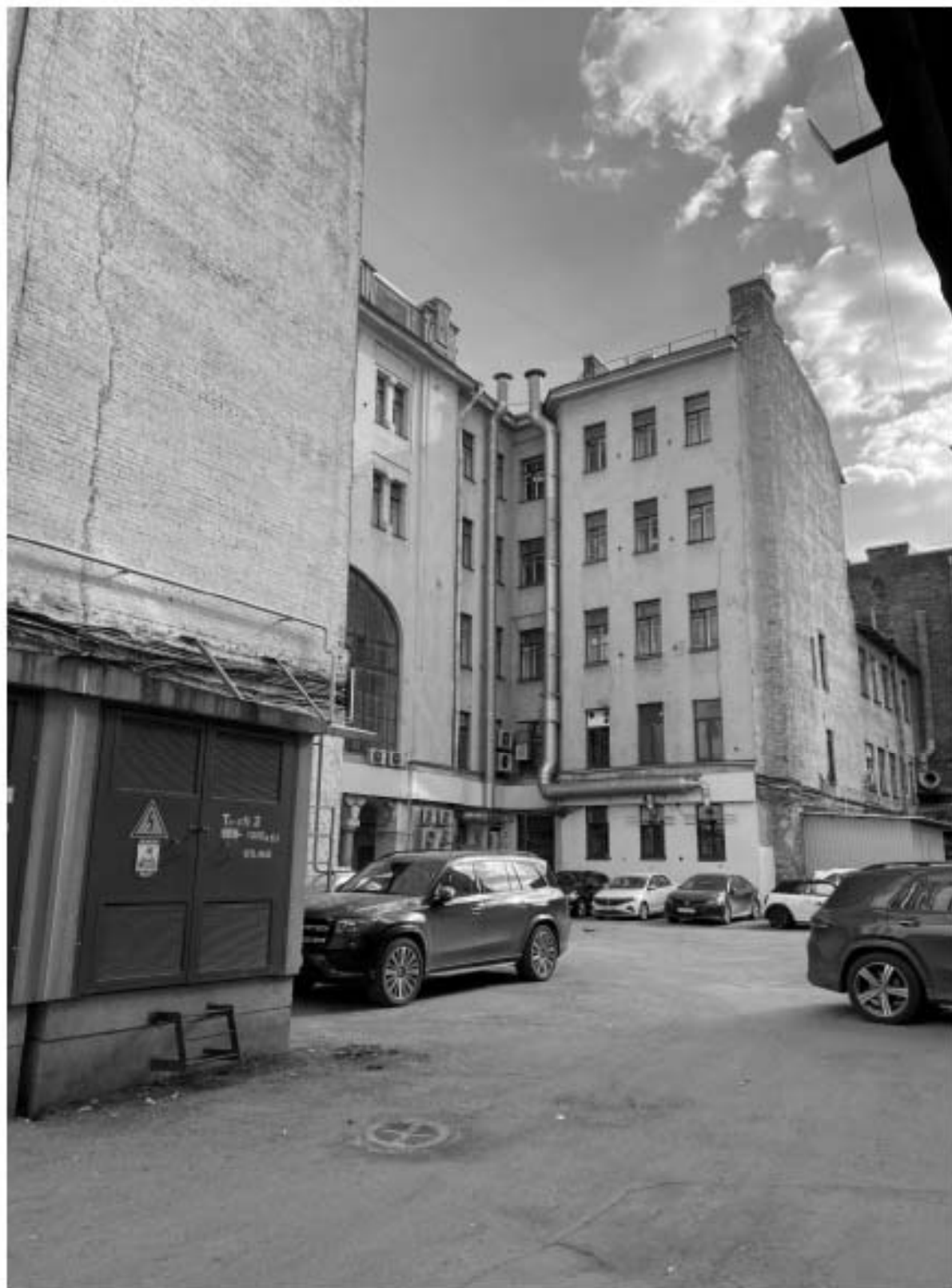
18. Фрагмент дворового фасада с северным и южным ризалитами объекта культурного наследия.
