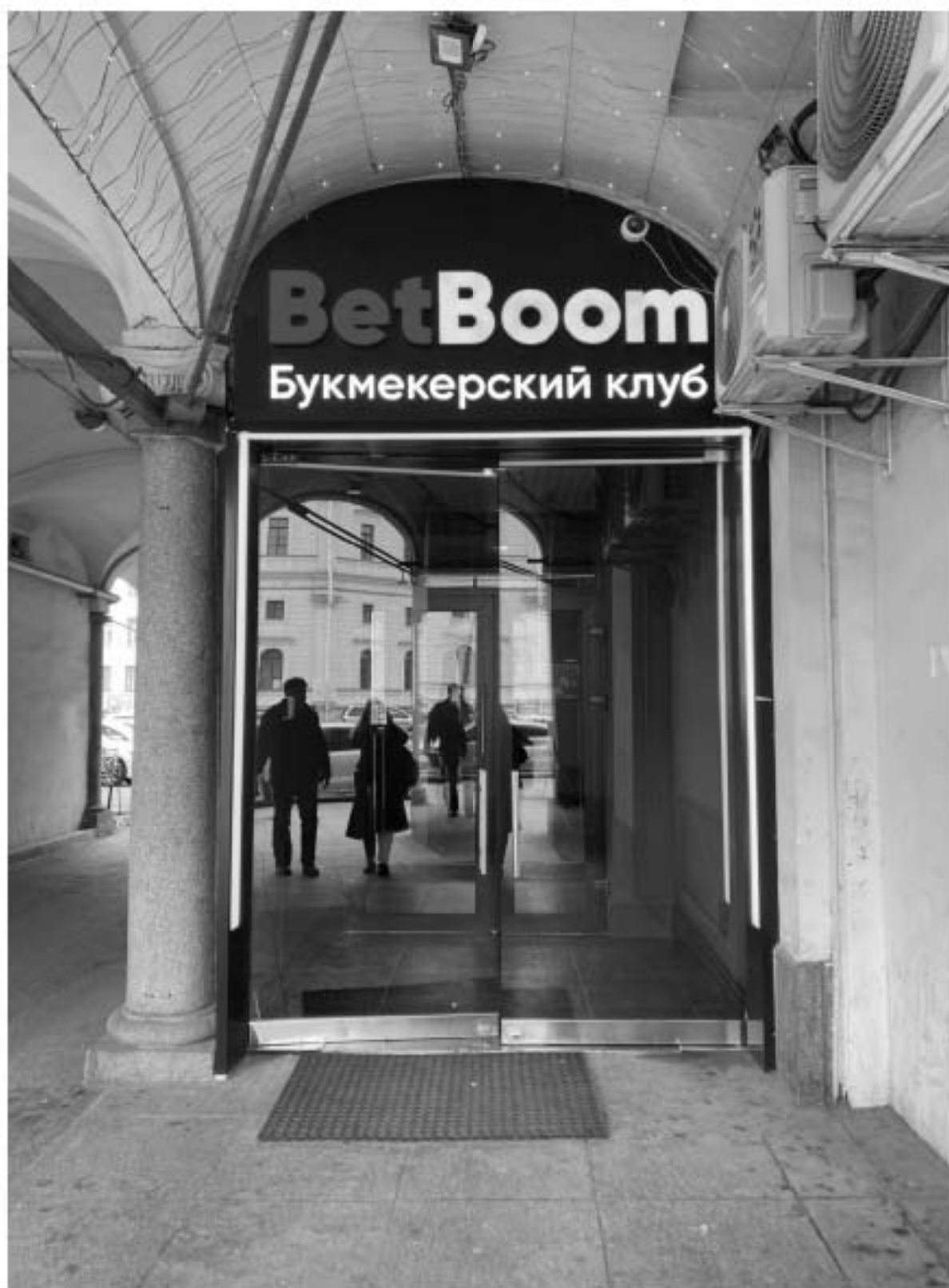
85. Входное дверное заполнение центральной части лицевого фасада по Лиговскому проспекту объекта культурного наследия.
