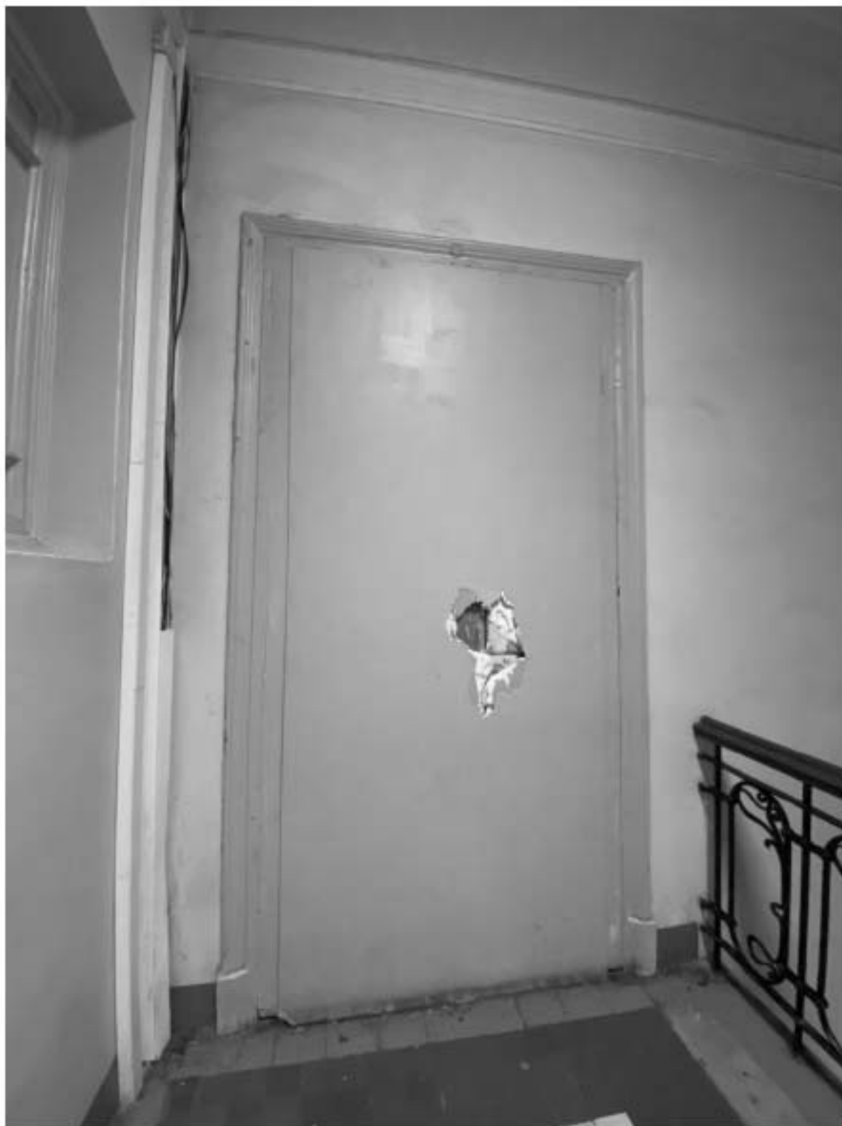
104. Дверное заполнение парадной лестницы Л4 объекта культурного наследия в уровне 5-го этажа.
