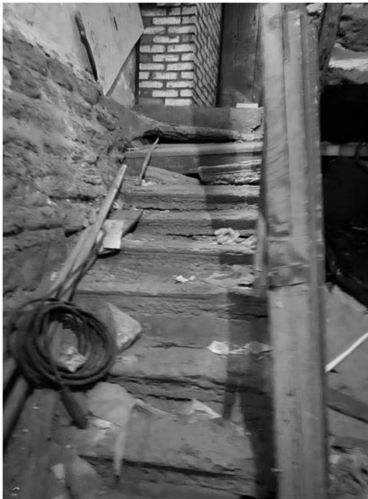
67. Вид на служебную лестницу ЛЗ объекта культурного наследия в уровне подвального этажа.
