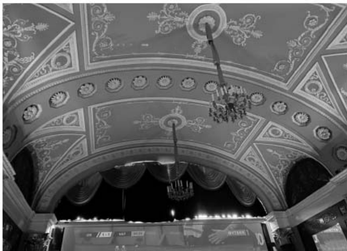
88. Интерьер помещения 6Н(54) объекта культурного наследия в уровне 2-го этажа.
