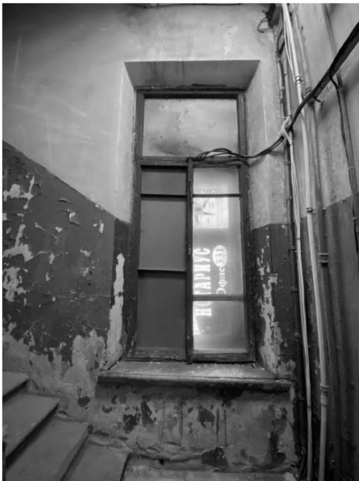
143. Оконное заполнение служебной лестницы Лб объекта культурного наследия в уровне 4-го этажа.
