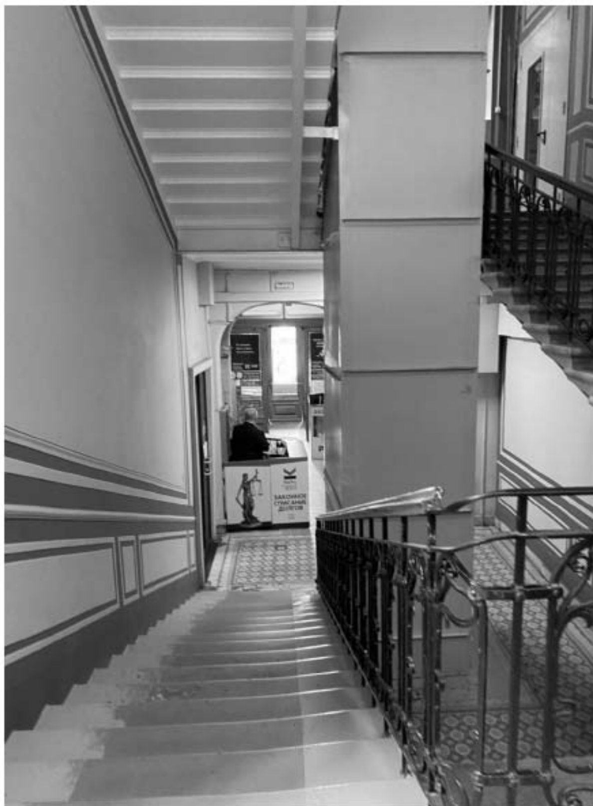
79. Парадная лестница Л1 объекта культурного наследия в уровне 1-го этажа.
