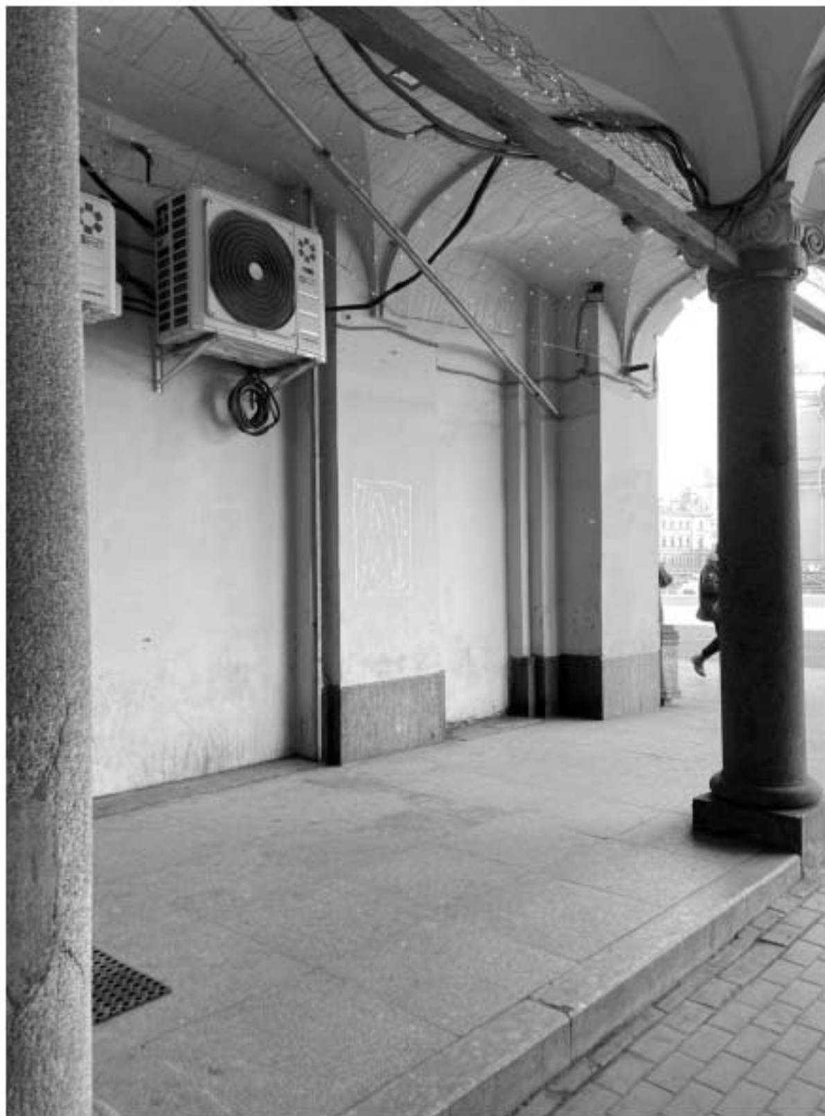
10. Вид на арочный проезд объекта культурного наследия.
