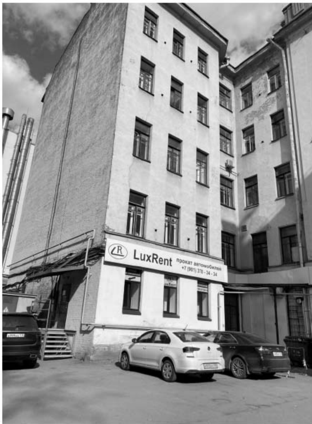
13. Фрагмент дворовых фасадов северного ризалита объекта культурного наследия.
