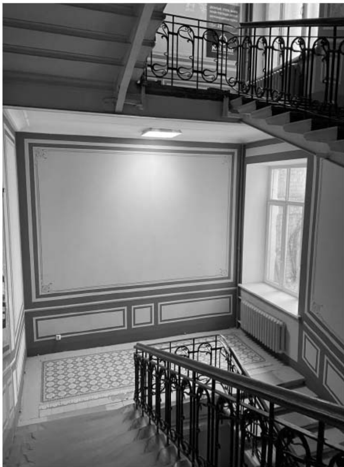
78. Парадная лестница Л1 объекта культурного наследия в уровне 2-го этажа.
