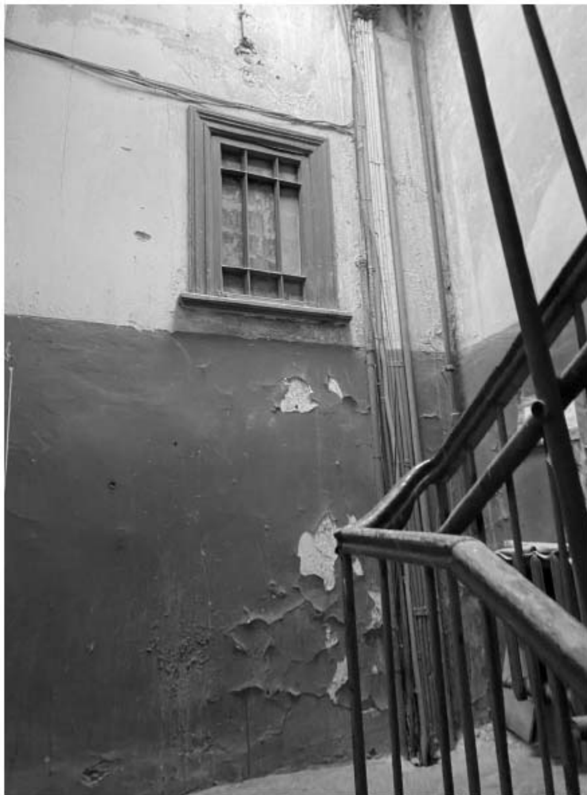
71. Вид на служебную лестницу ЛЗ объекта культурного наследия в уровне 1-го этажа.
