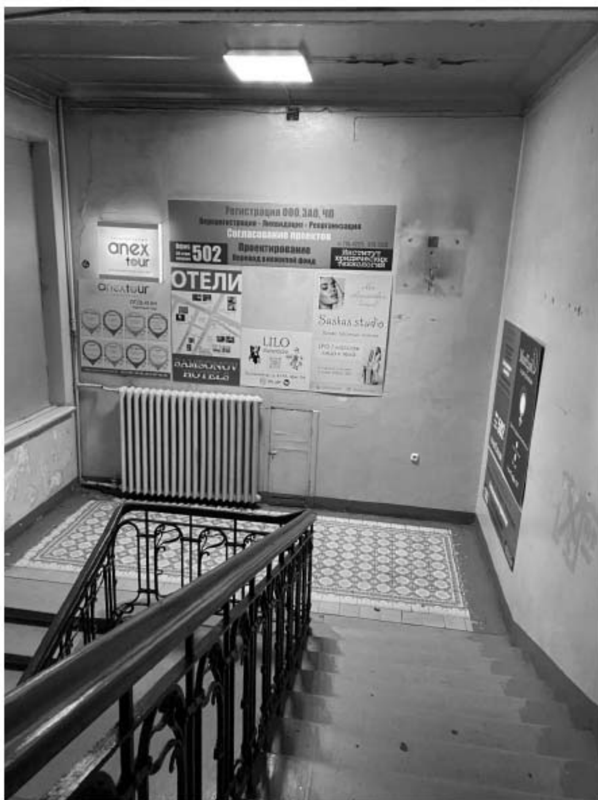
146. Интерьер парадной лестницы Л4 объекта культурного наследия в уровне 2-го этажа.
