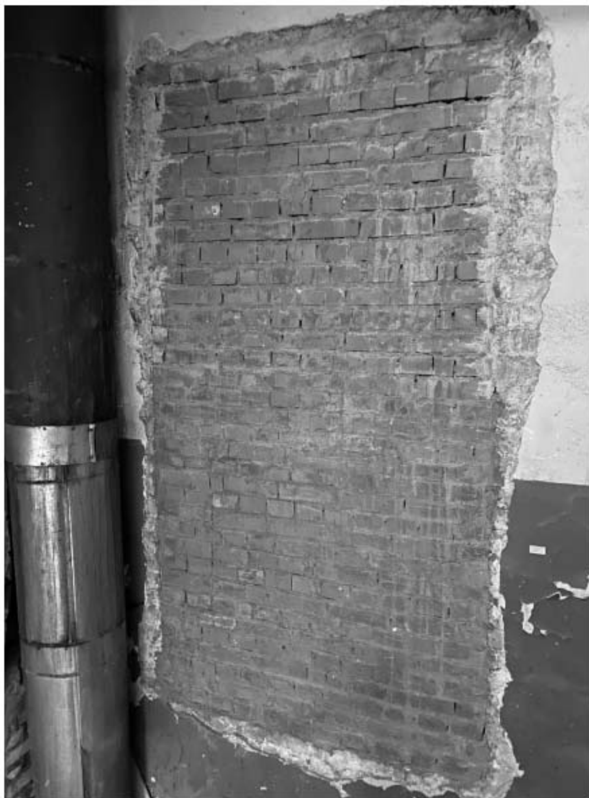
63. Вид на служебную лестницу ЛЗ объекта культурного наследия в уровне 2-го этажа.
