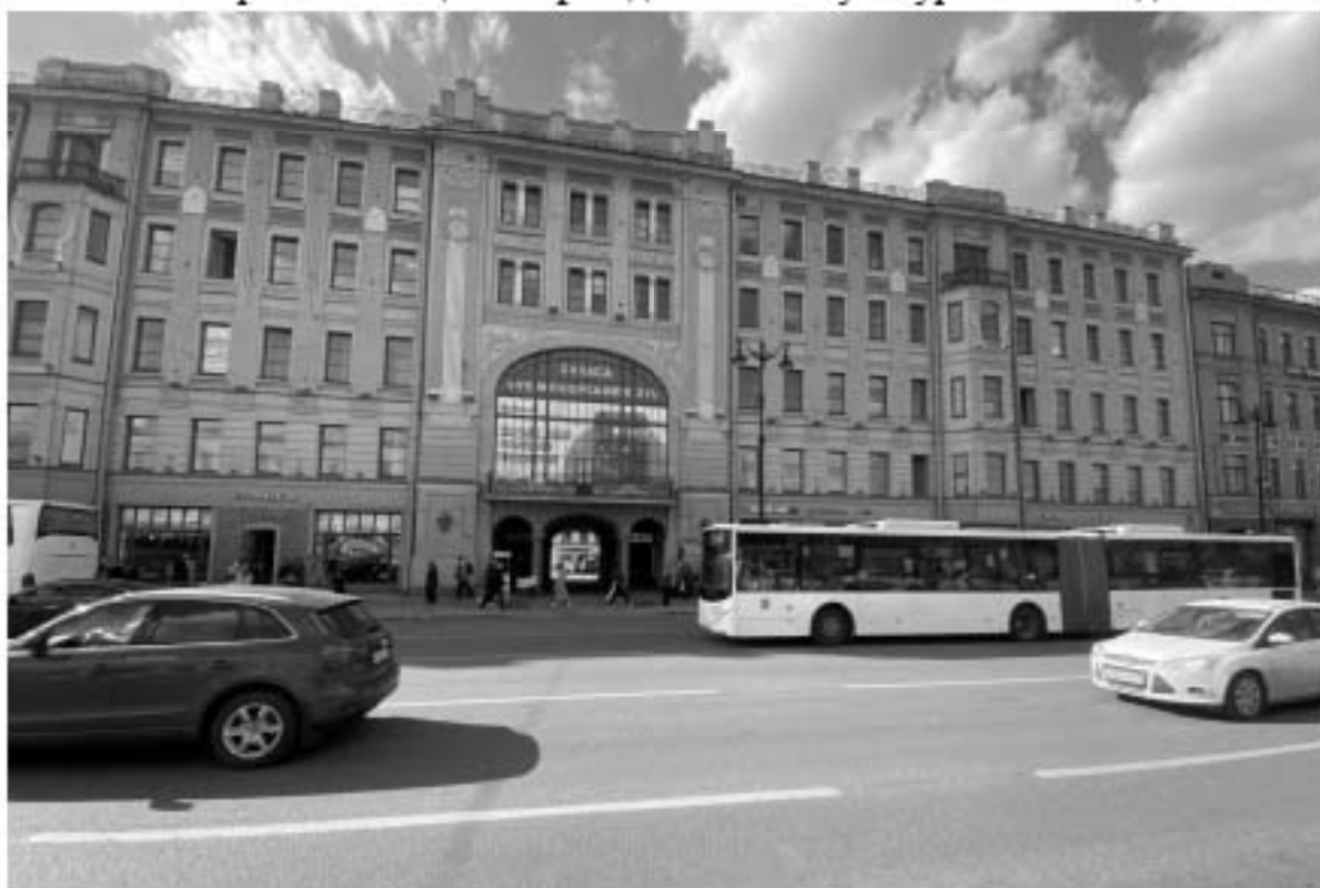
2. Фрагмент лицевого фасада объекта культурного наследия.
