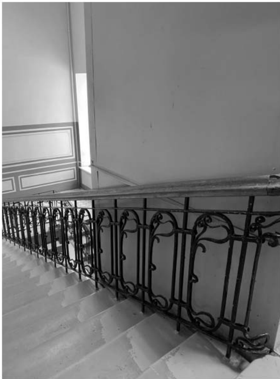
34. Парадная лестница Л1 объекта культурного наследия в уровне 5-го этажа.
