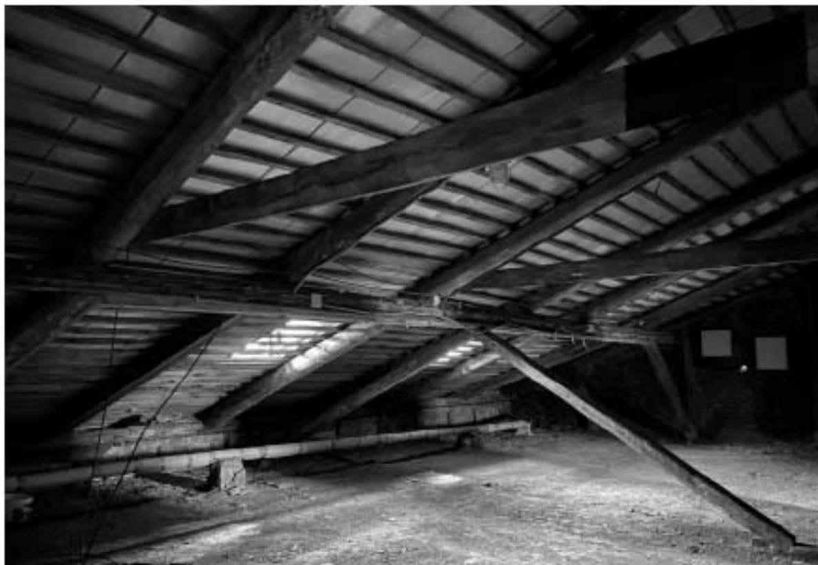
22. Вид на чердачное помещение объекта культурного наследия.
