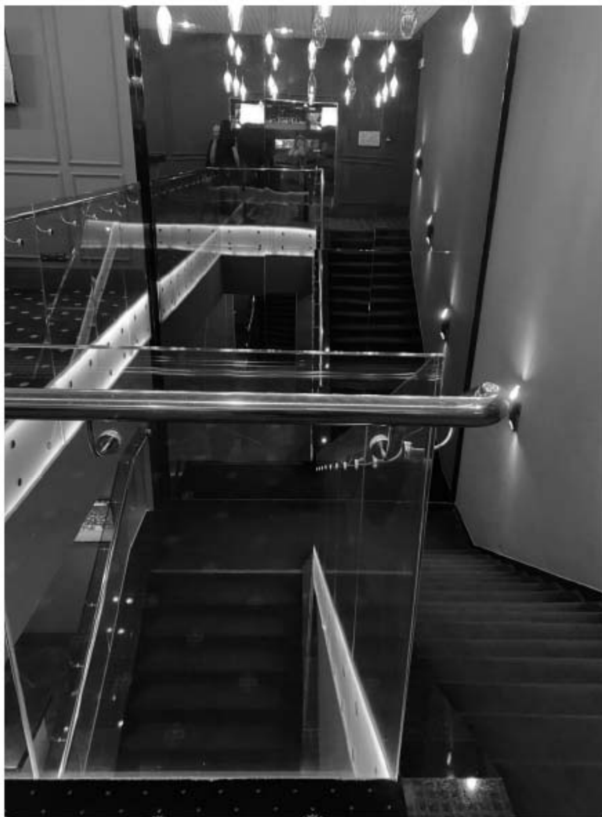
87. Общий вид лестницы Л7, расположенной в центральной части объекта культурного наследия в уровне 2-го этажа.
