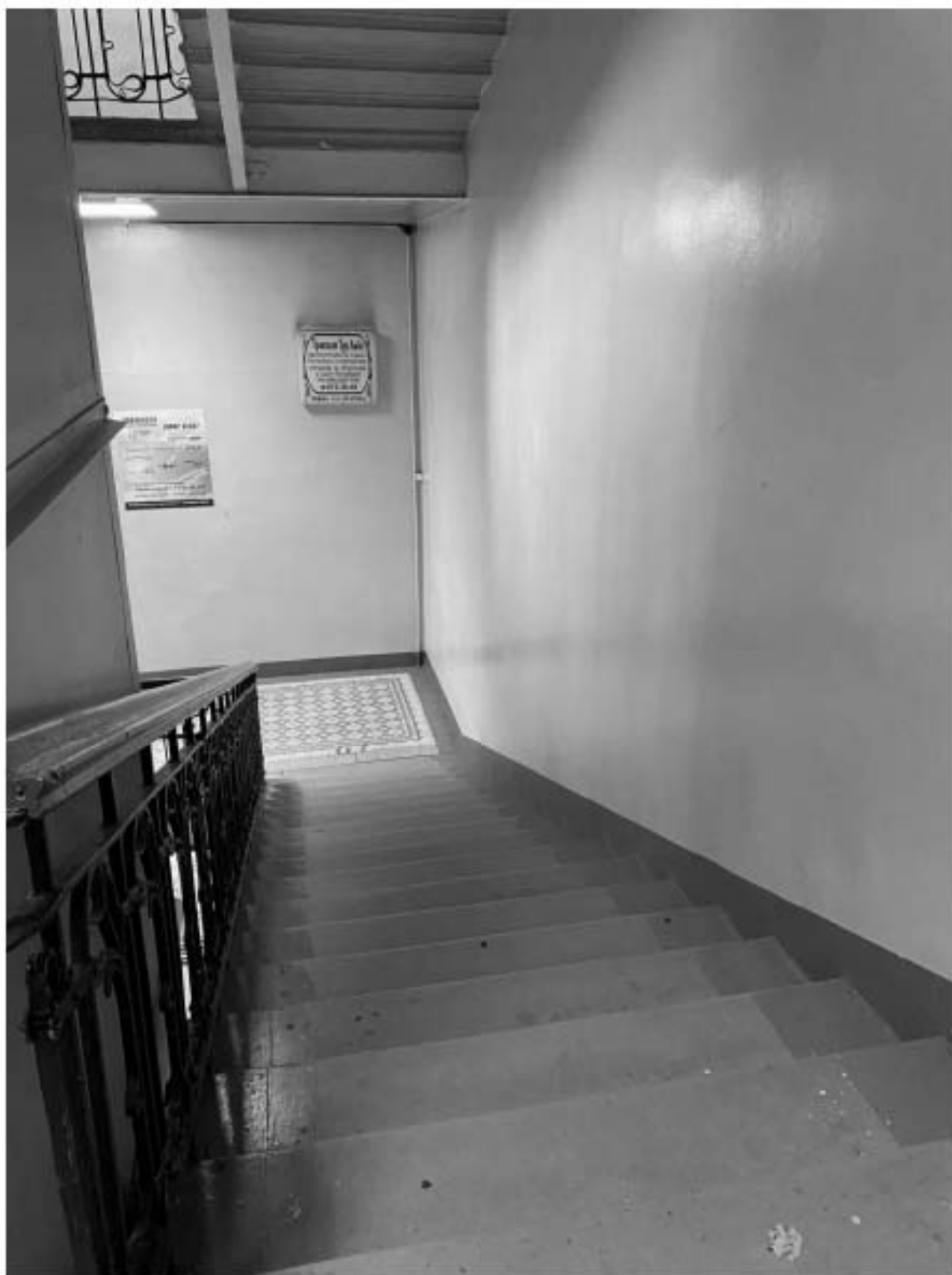
129. Интерьер парадной лестницы Л4 объекта культурного наследия в уровне 4-го этажа.
