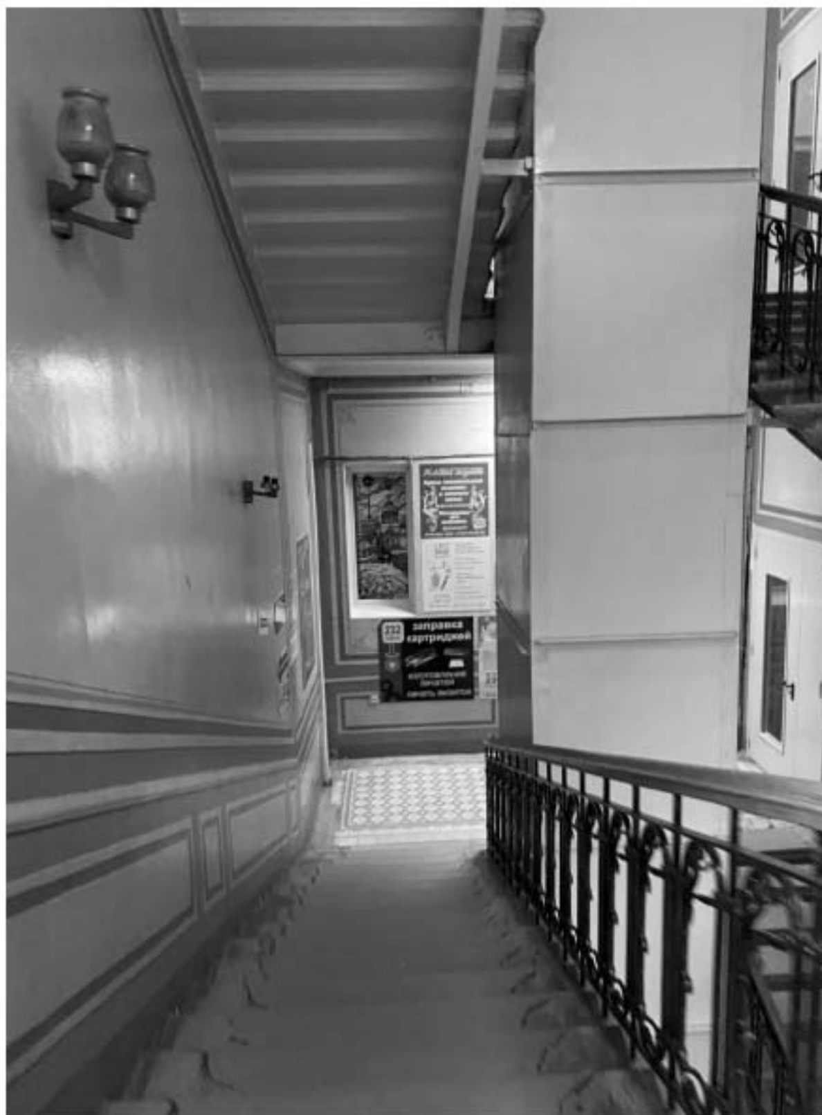
52. Парадная лестница Л1 объекта культурного наследия в уровне 2-го этажа.
