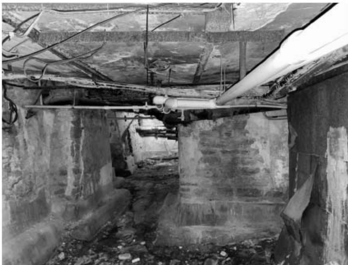
69. Помещения объекта культурного наследия в уровне подвального этажа.
