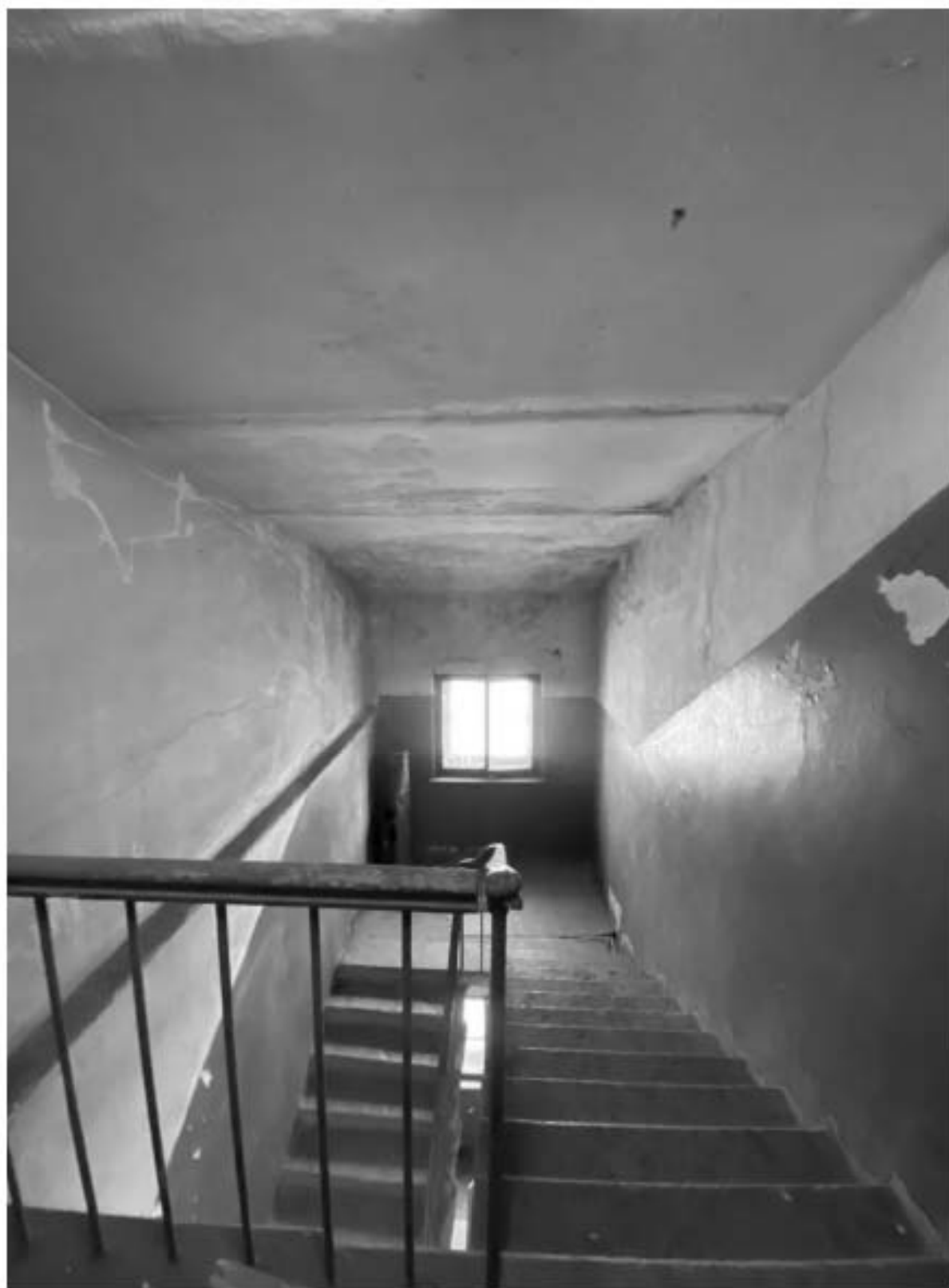
25. Вид на служебную лестницу ЛЗ объекта культурного наследия в уровне 6-го этажа.
