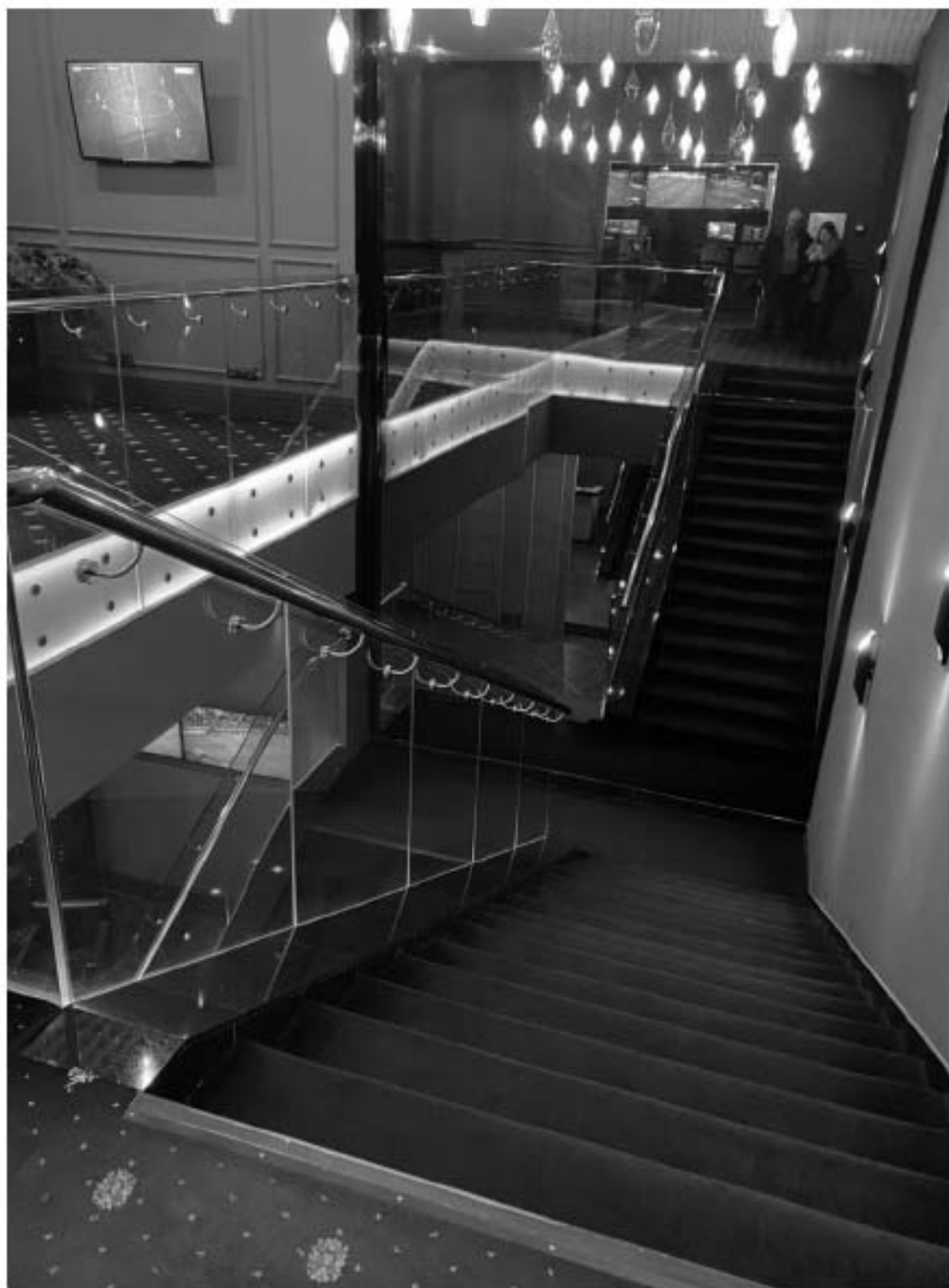
93. Общий вид лестницы Л7, расположенной в центральной части объекта культурного наследия в уровне 2-го этажа.
