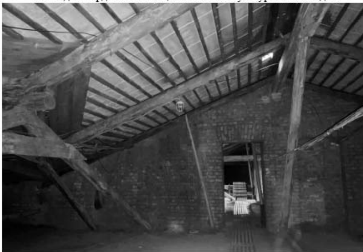
23. Вид на чердачное помещение объекта культурного наследия.
