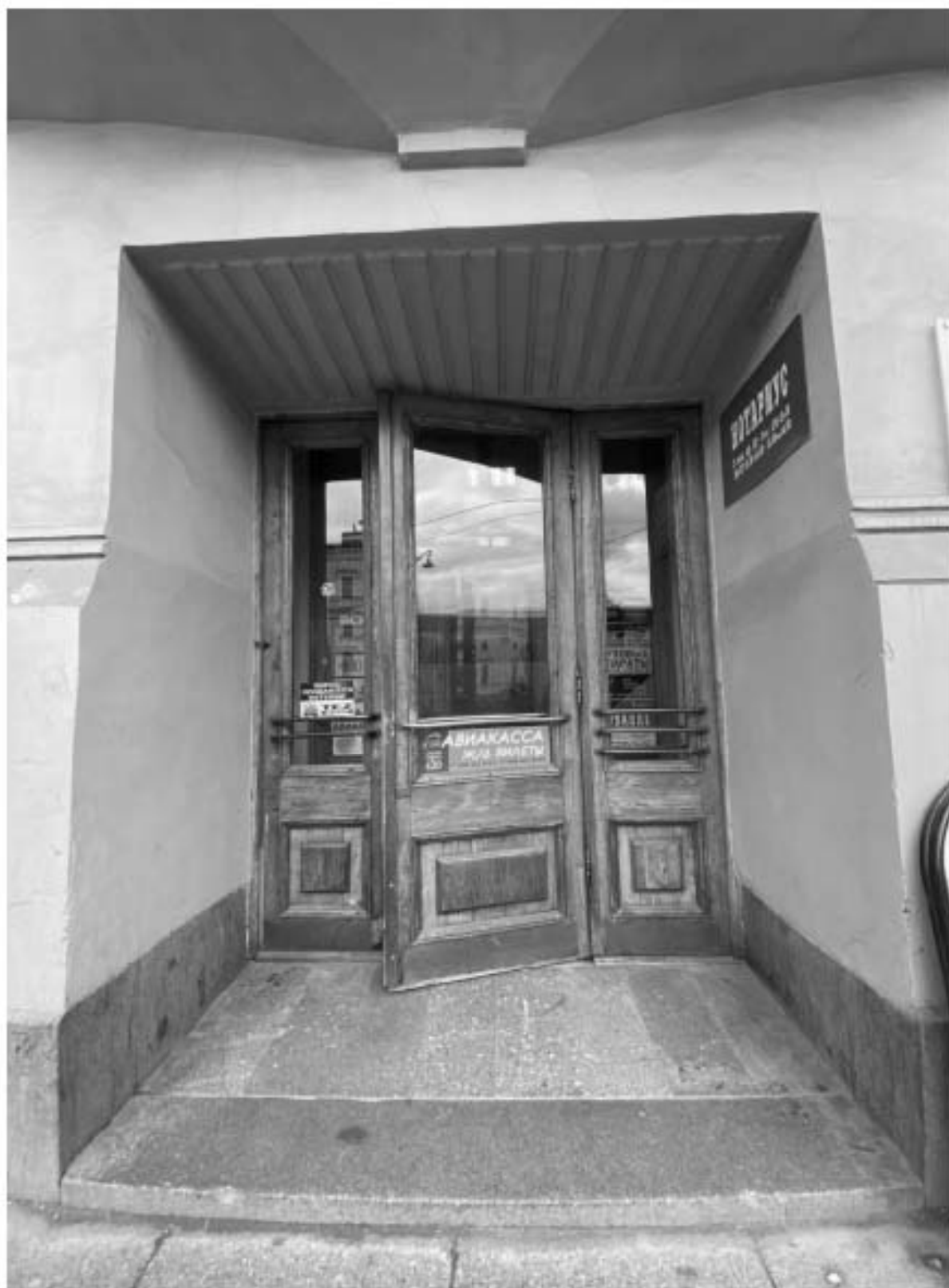
84. Входное дверное заполнение северной части лицевого фасада по Лиговскому проспекту объекта культурного наследия.
