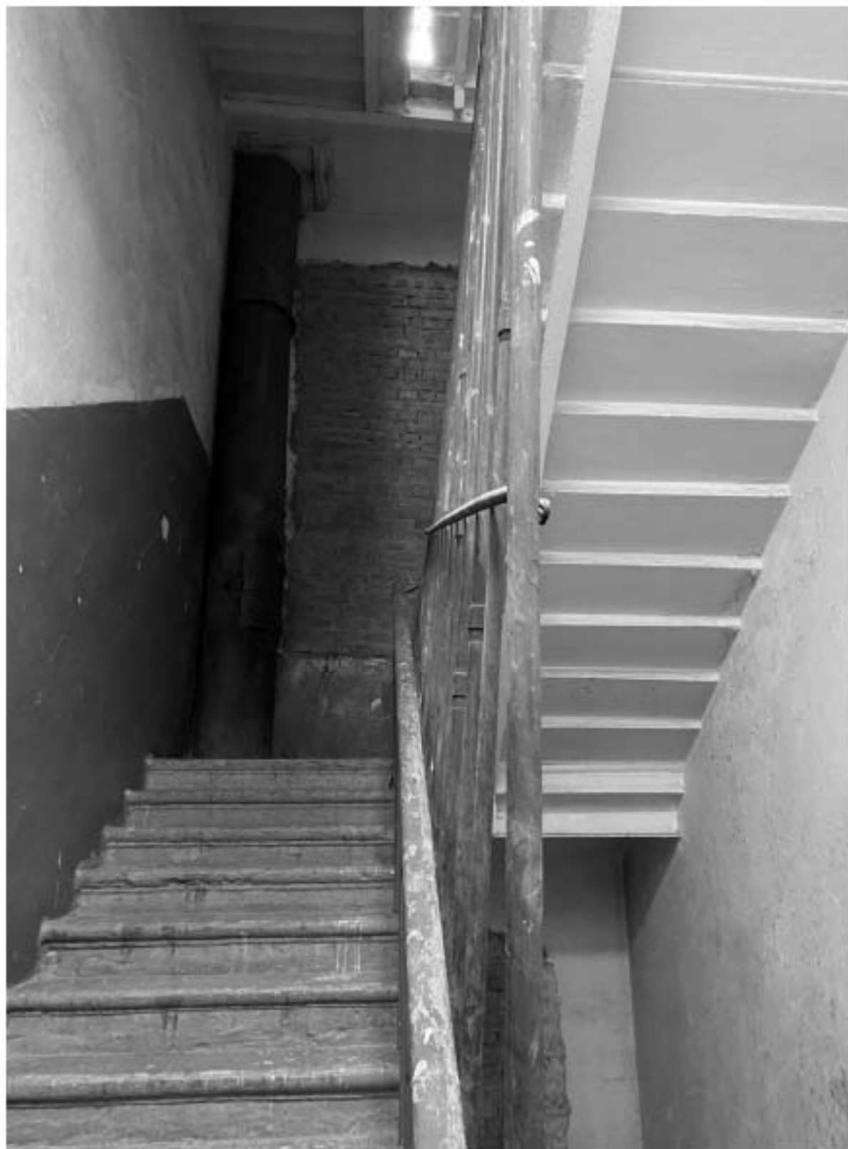
61. Вид на служебную лестницу ЛЗ объекта культурного наследия в уровне 2-го этажа.
