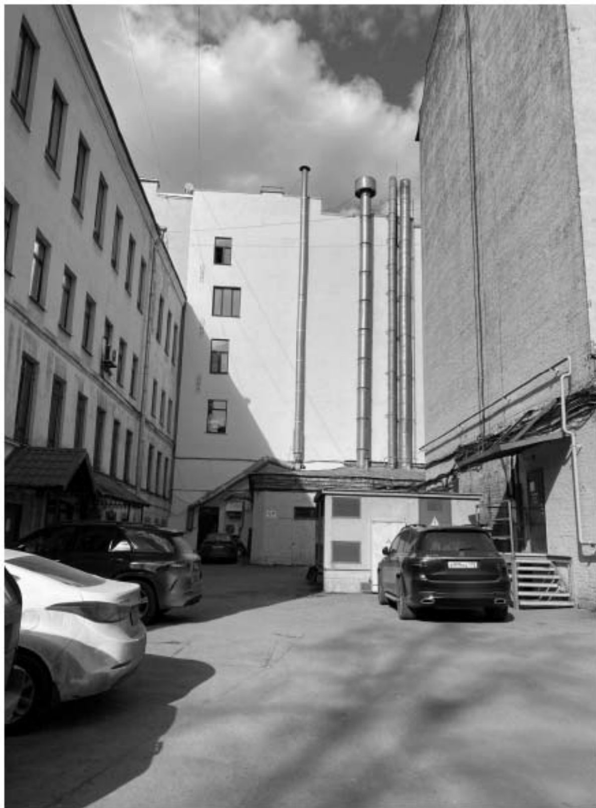
12. Фрагмент дворового фасада северного ризалита объекта культурного наследия.
