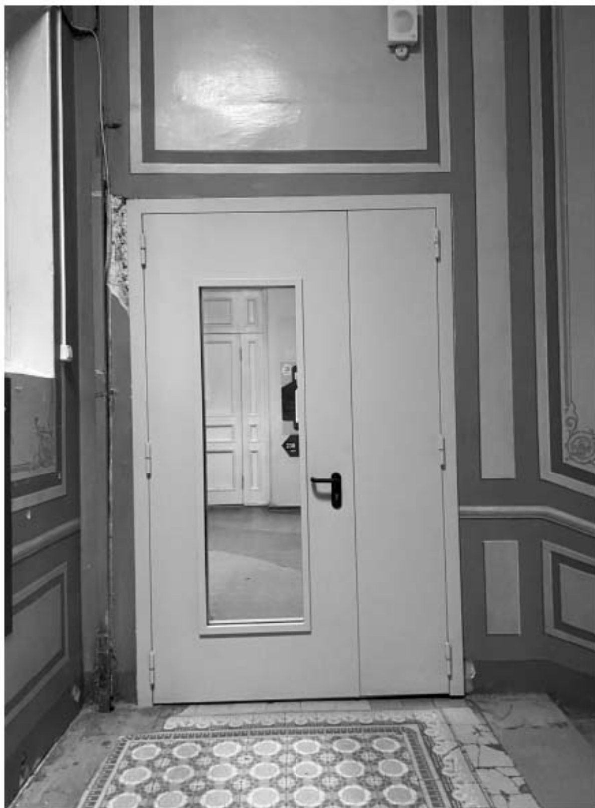
53. Дверное заполнение парадной лестницы Л1 объекта культурного наследия в уровне 2-го этажа.
