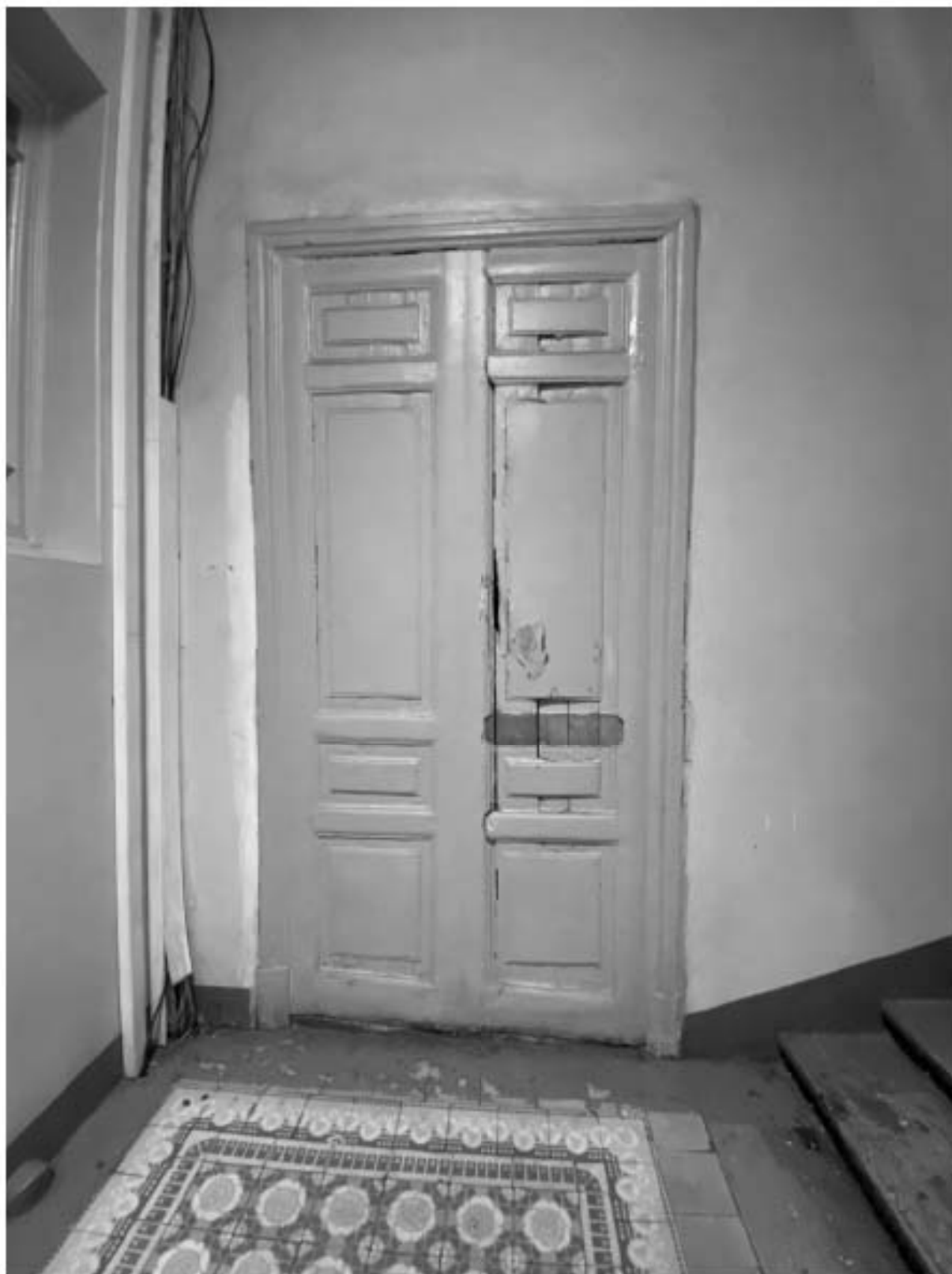
118. Дверное заполнение с парадной лестницы Л4 объекта культурного наследия в уровне 4-го этажа.
