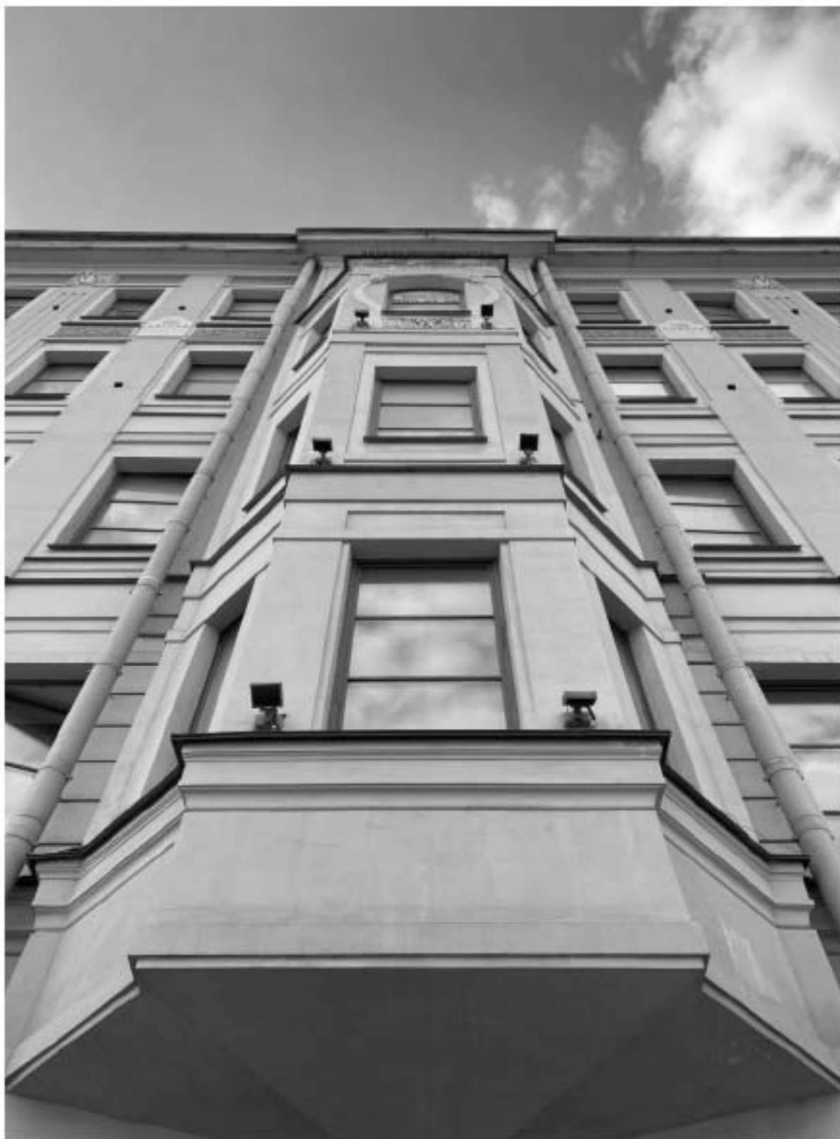
7. Фрагмент лицевого фасада объекта культурного наследия.
