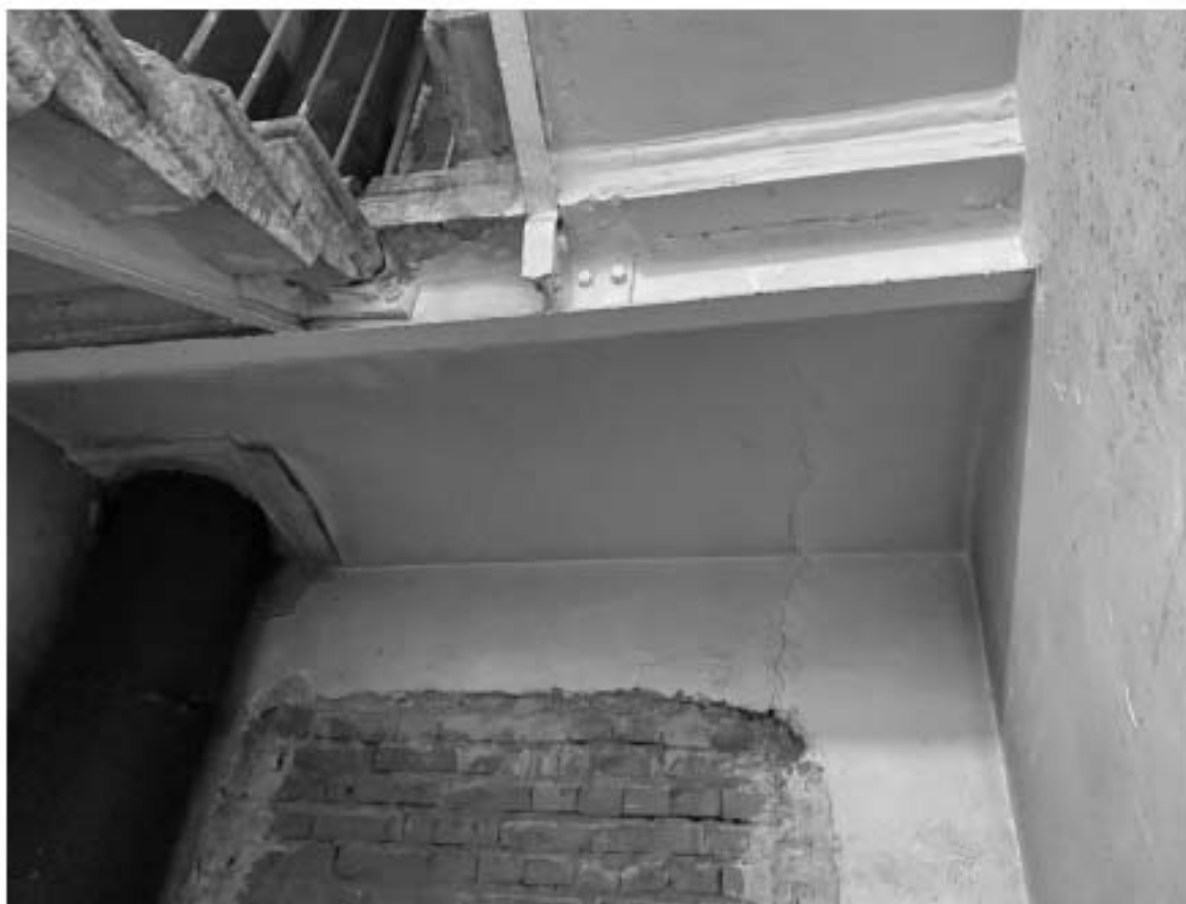
62. Перекрытие служебной лестницы ЛЗ объекта культурного наследия в уровне 2-го этажа.
