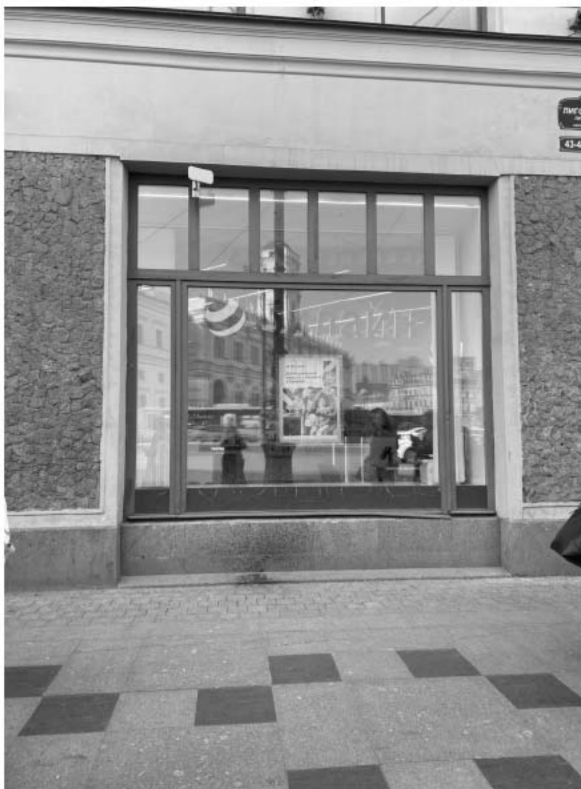
6. Фрагмент оконного заполнения лицевого фасада объекта культурного наследия.
