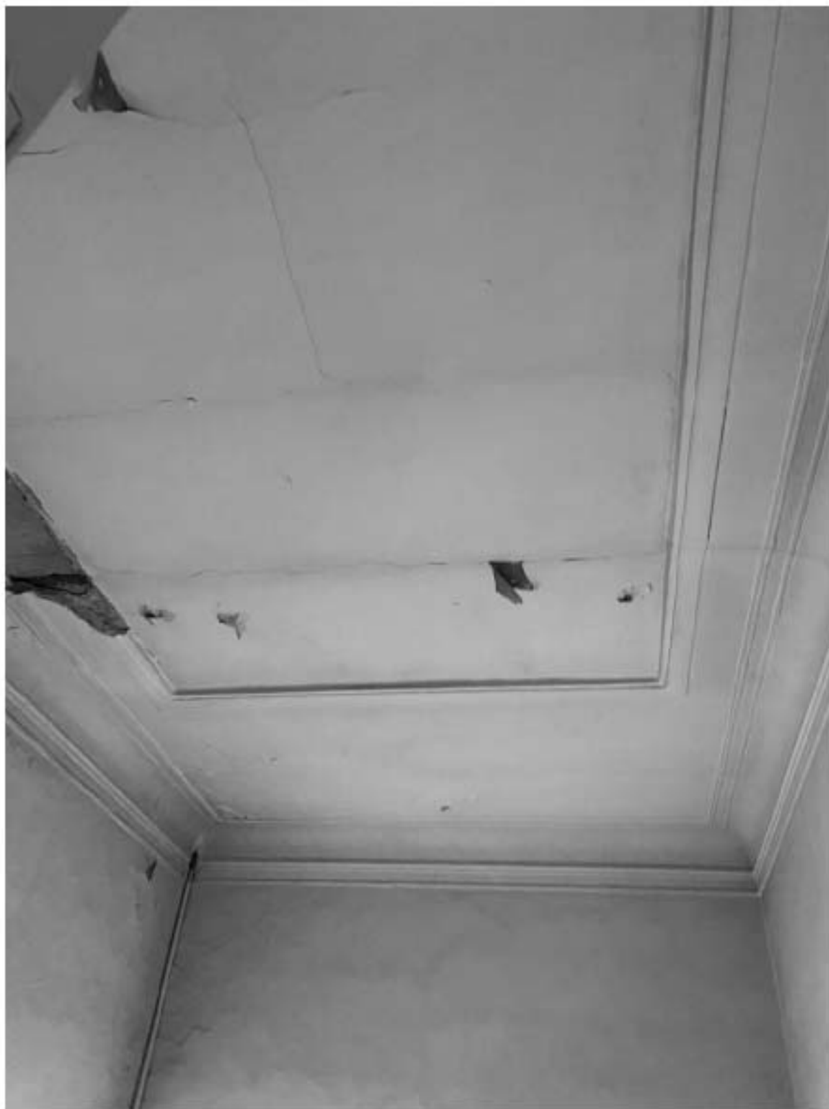
115. Верхнее перекрытие парадной лестницы Л4 объекта культурного наследия в уровне 5-го этажа.
