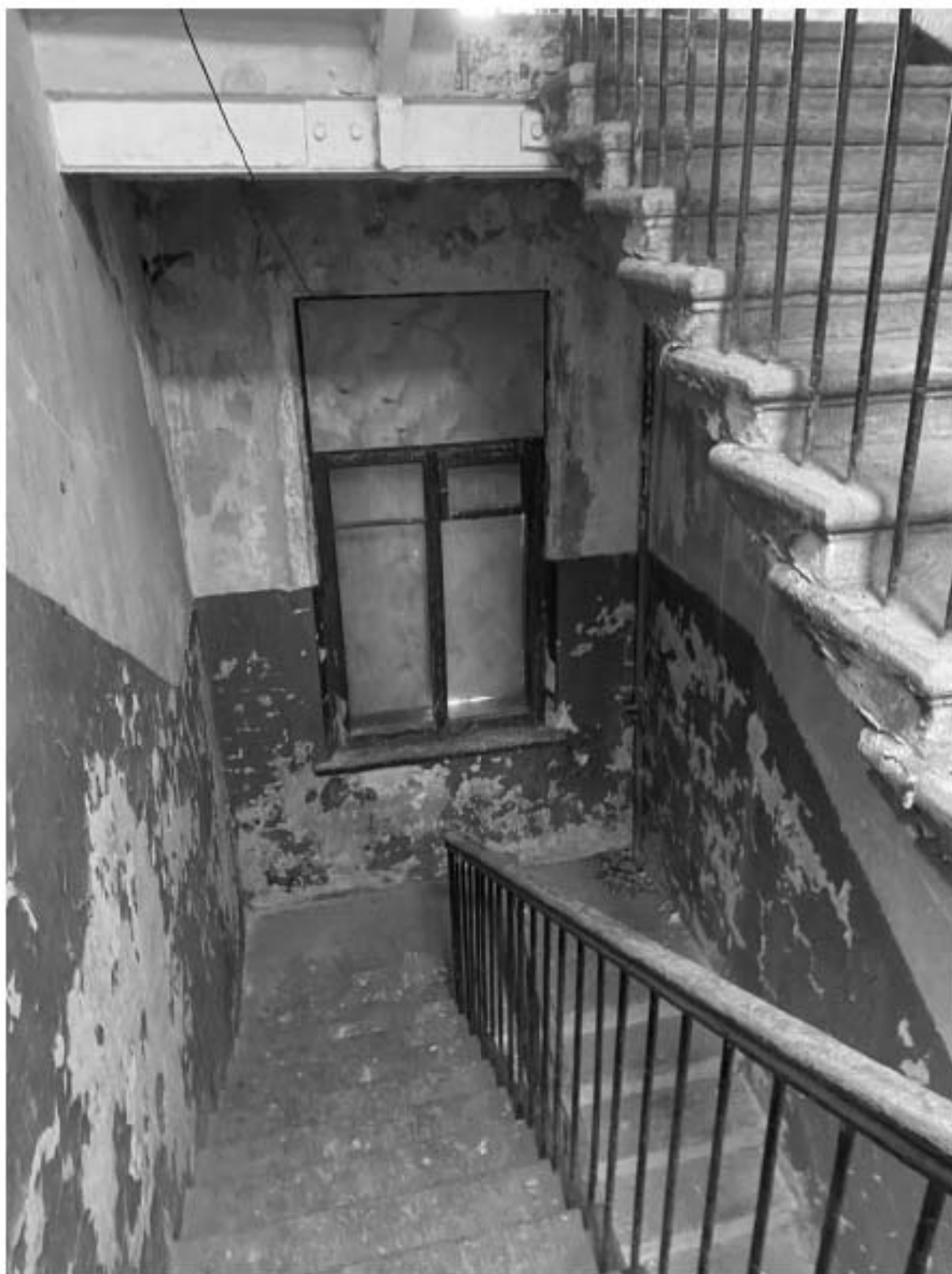
113. Служебная лестница Л5 объекта культурного наследия в уровне 5-го этажа.
