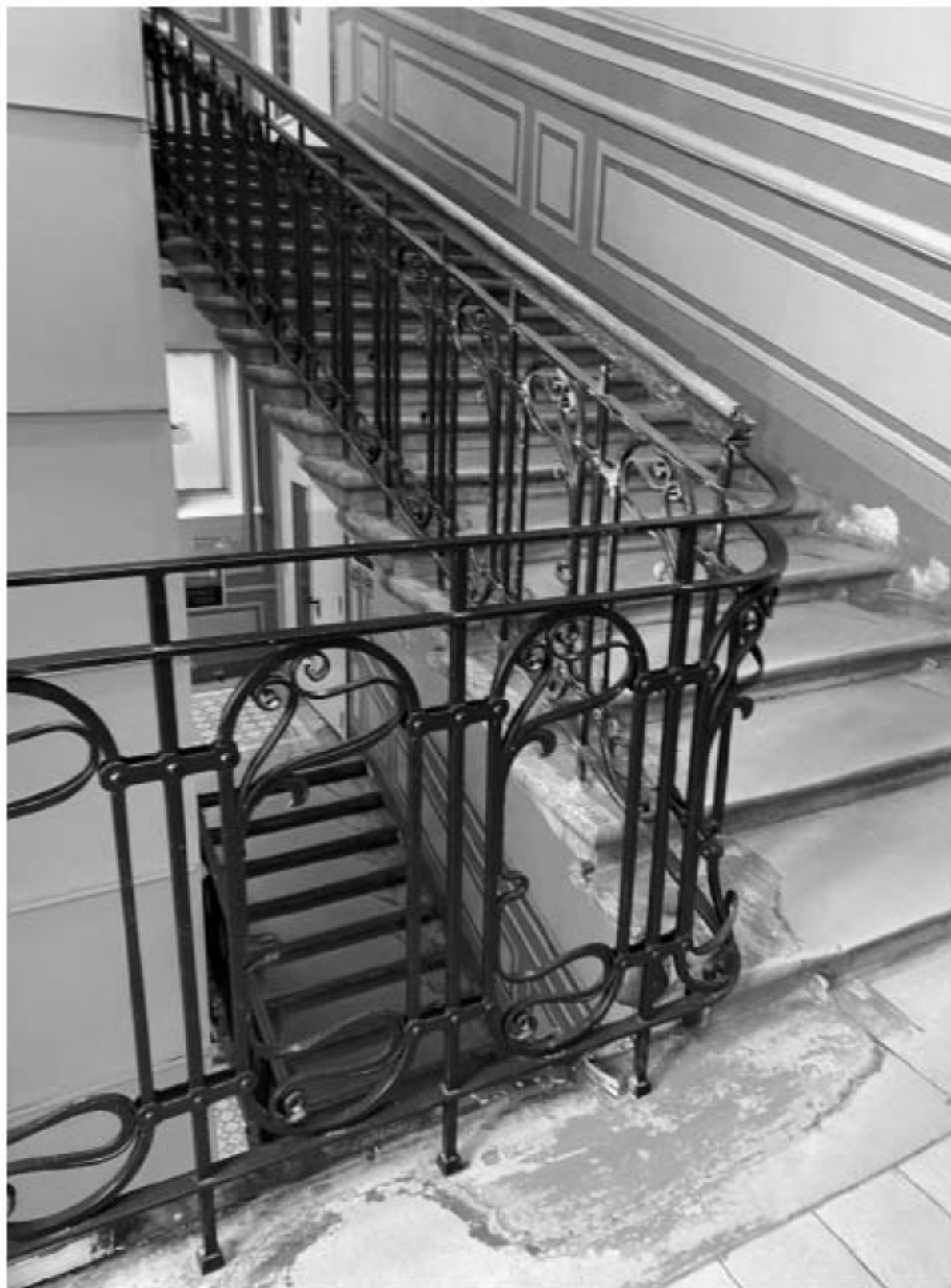
47. Парадная лестница Л1 объекта культурного наследия в уровне 4-го этажа.
