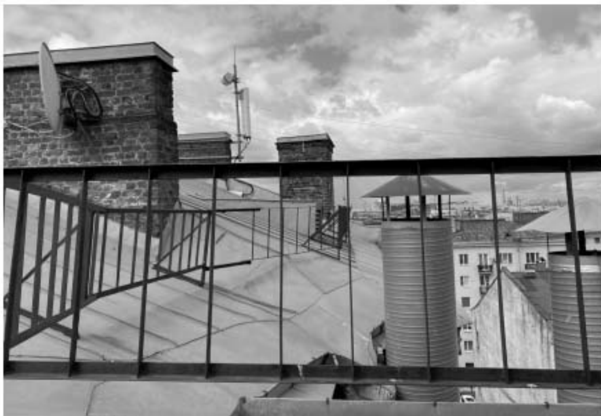
24. Вид на часть крыши объекта культурного наследия.
