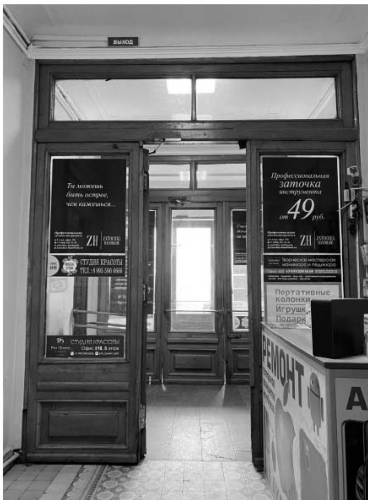
83. Дверное заполнение тамбура объекта культурного наследия в уровне 1-го этажа.
