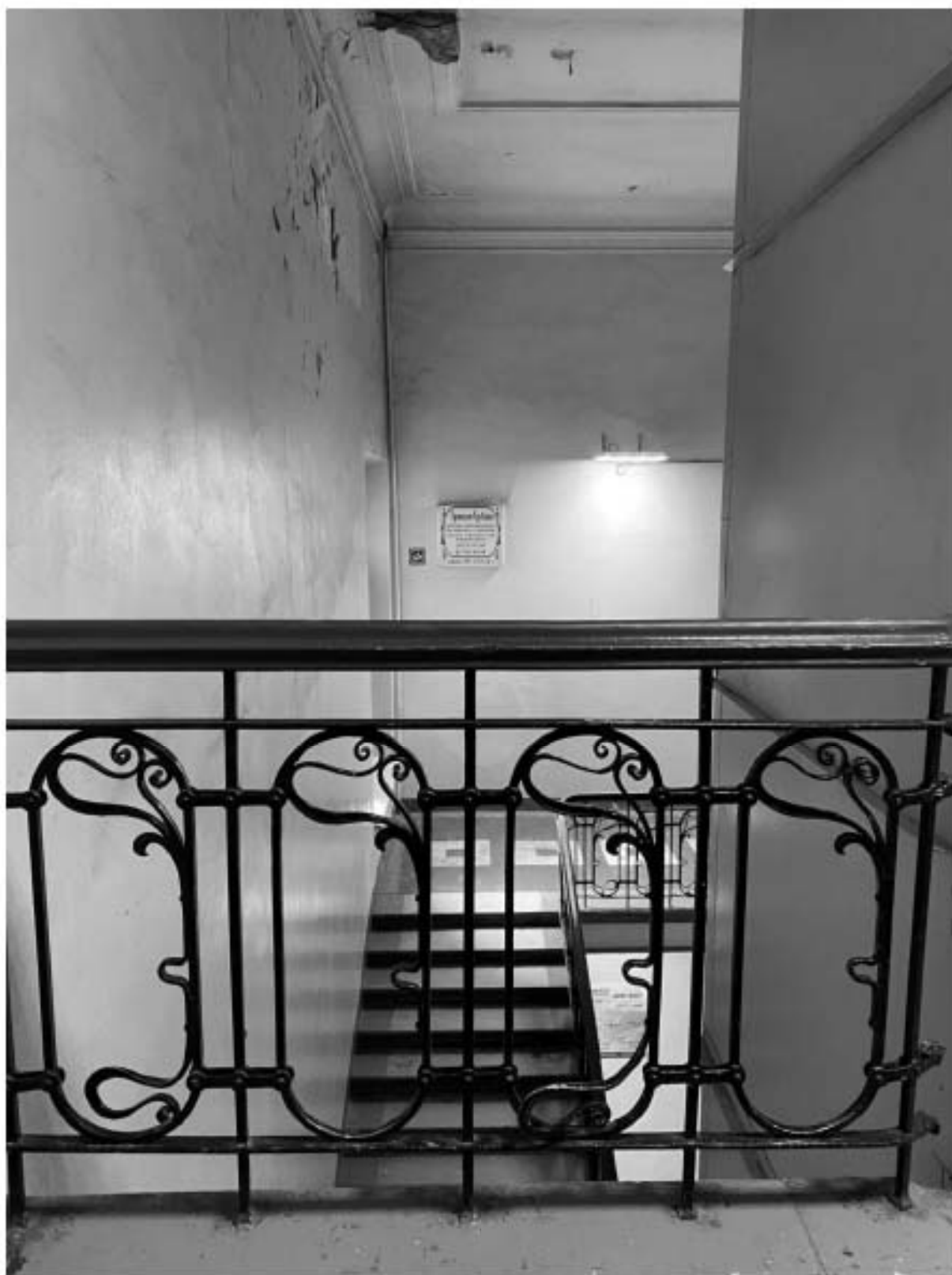
103. Ограждение парадной лестницы Л4 объекта культурного наследия в уровне 5-го этажа.
