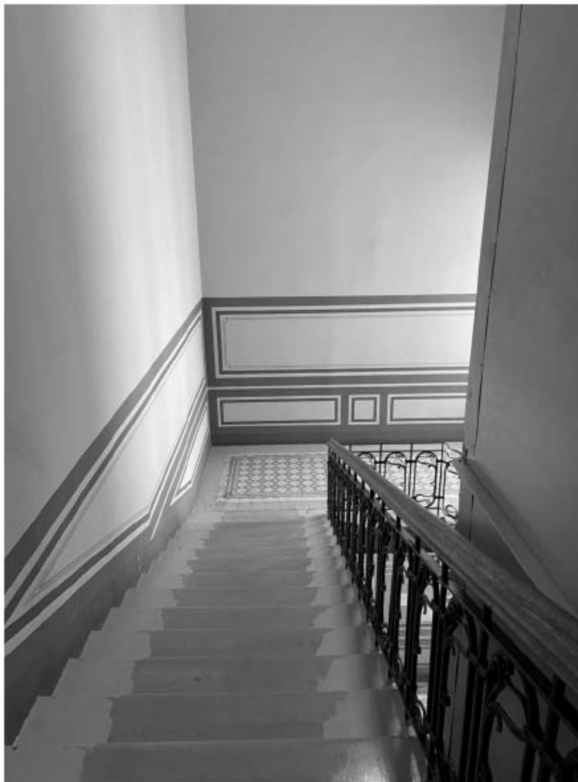
38. Парадная лестница Л1 объекта культурного наследия в уровне 5-го этажа.
