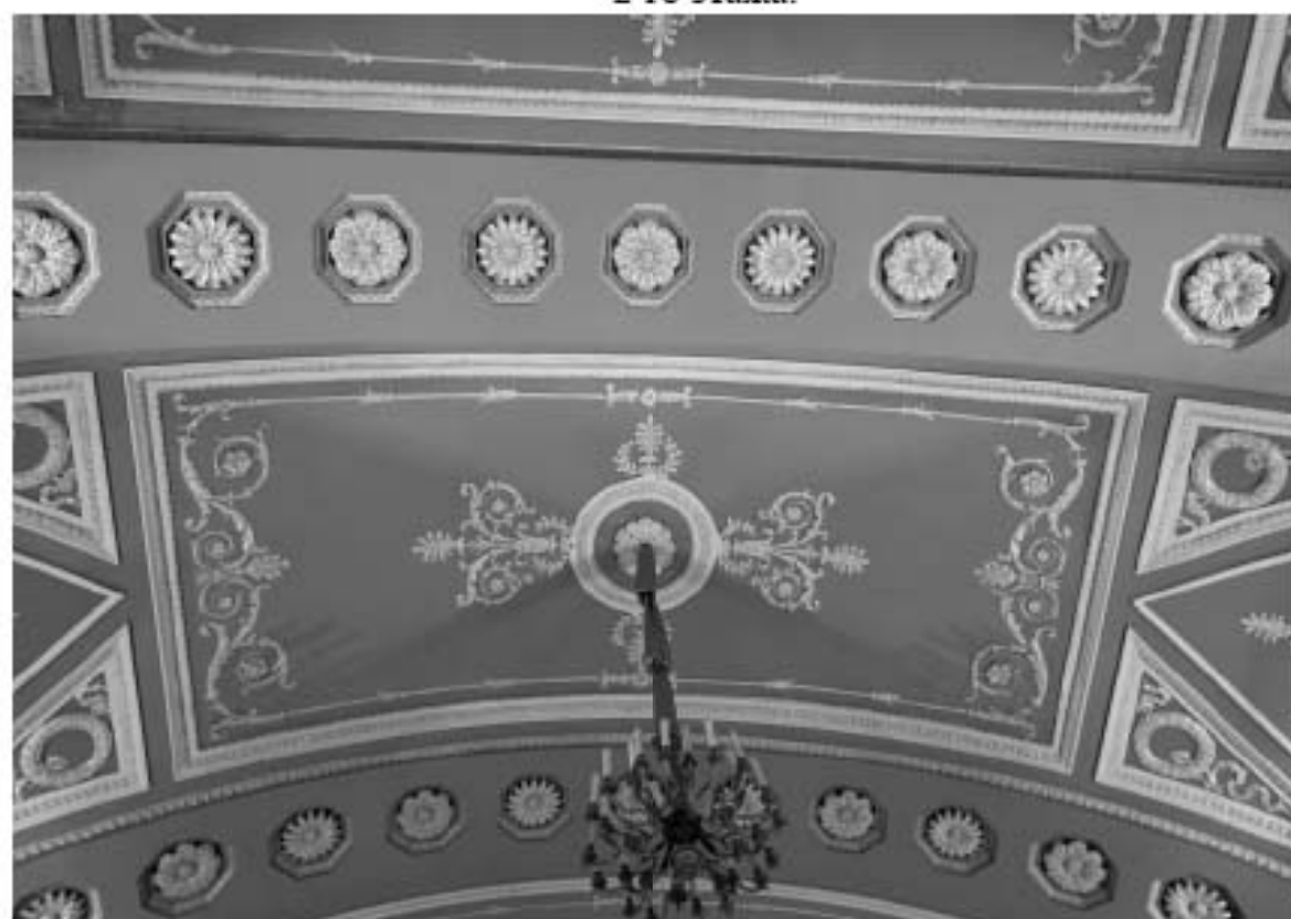
89. Интерьер помещения 6Н(54) объекта культурного наследия в уровне 2-го этажа.
