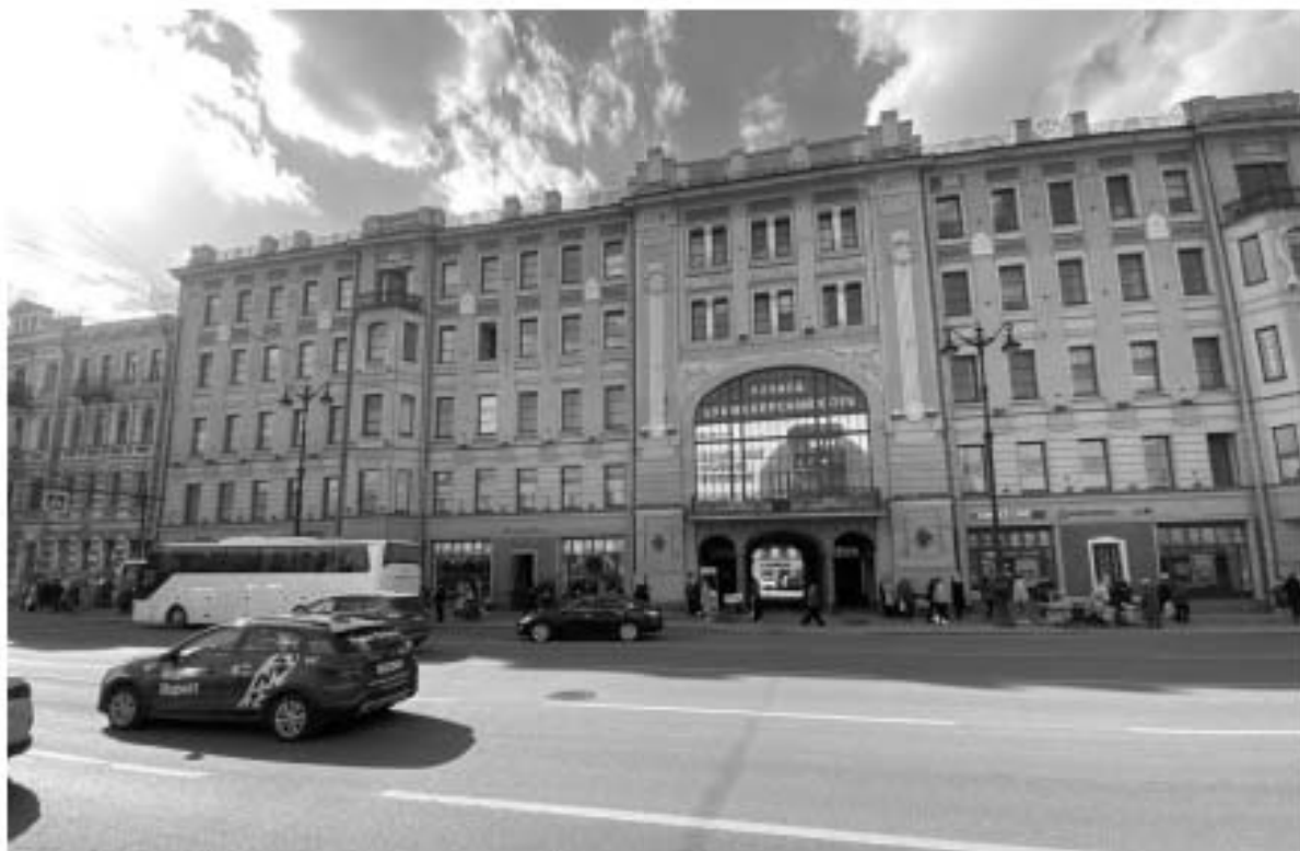
1. Фрагмент лицевого фасада объекта культурного наследия.
