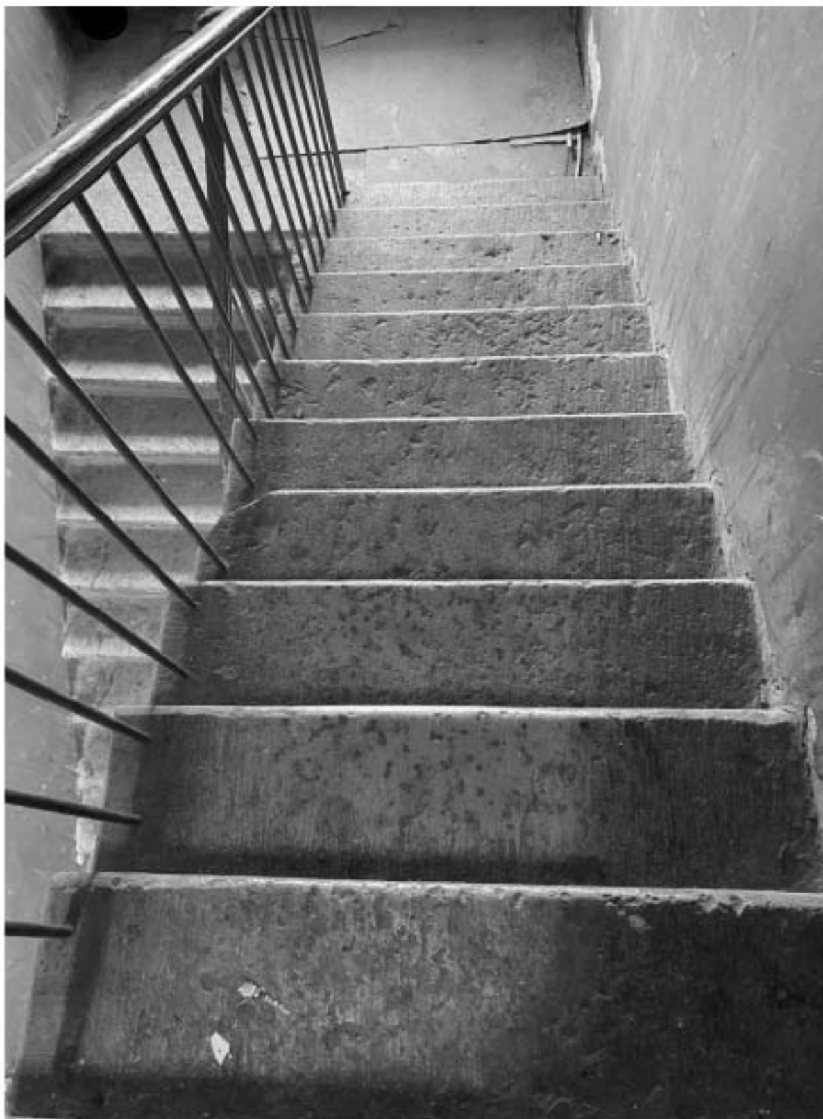
26. Вид на служебную лестницу ЛЗ объекта культурного наследия в уровне 6-го этажа.
