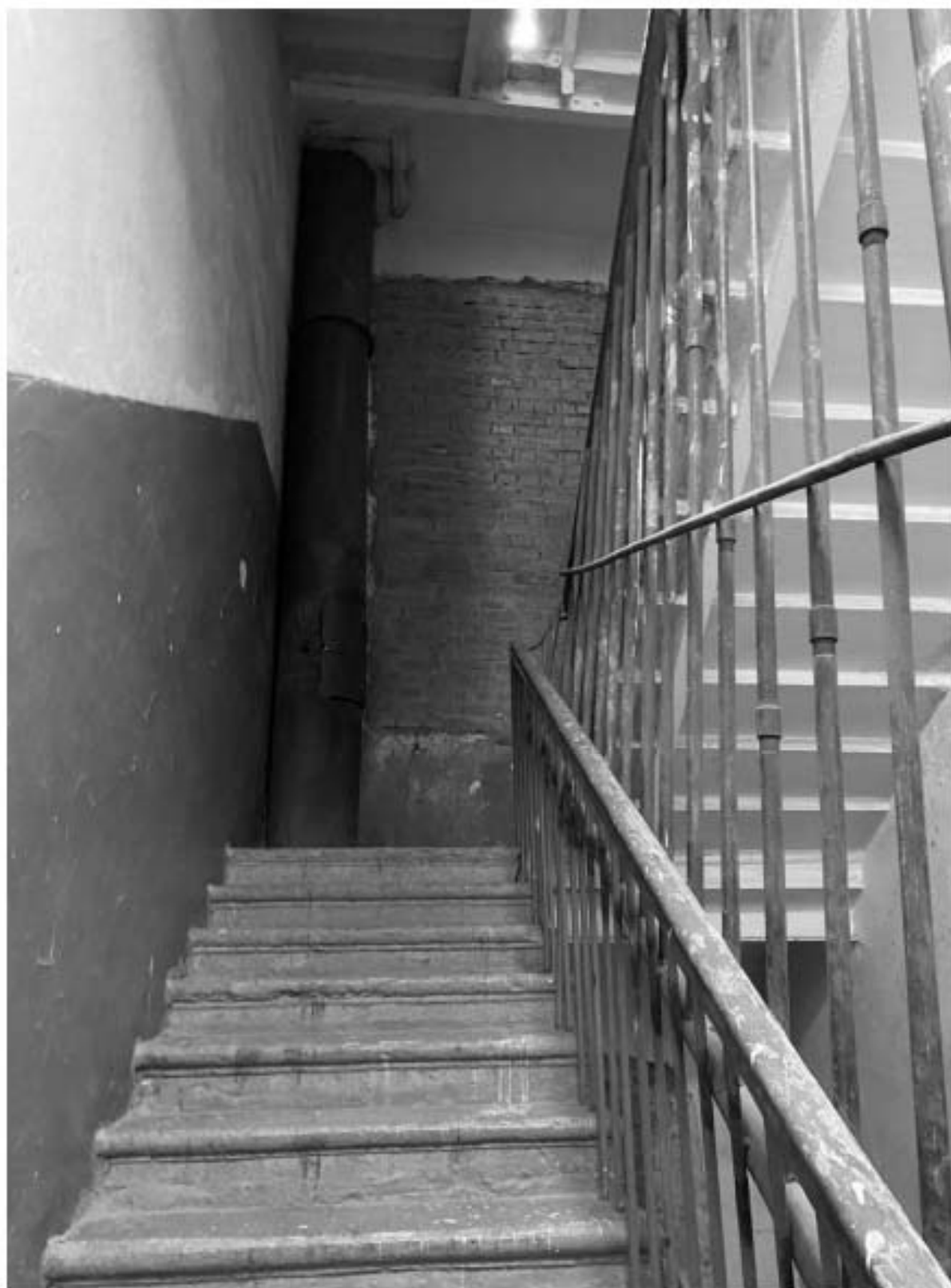
73. Вид на служебную лестницу ЛЗ объекта культурного наследия в уровне 2-го этажа.
