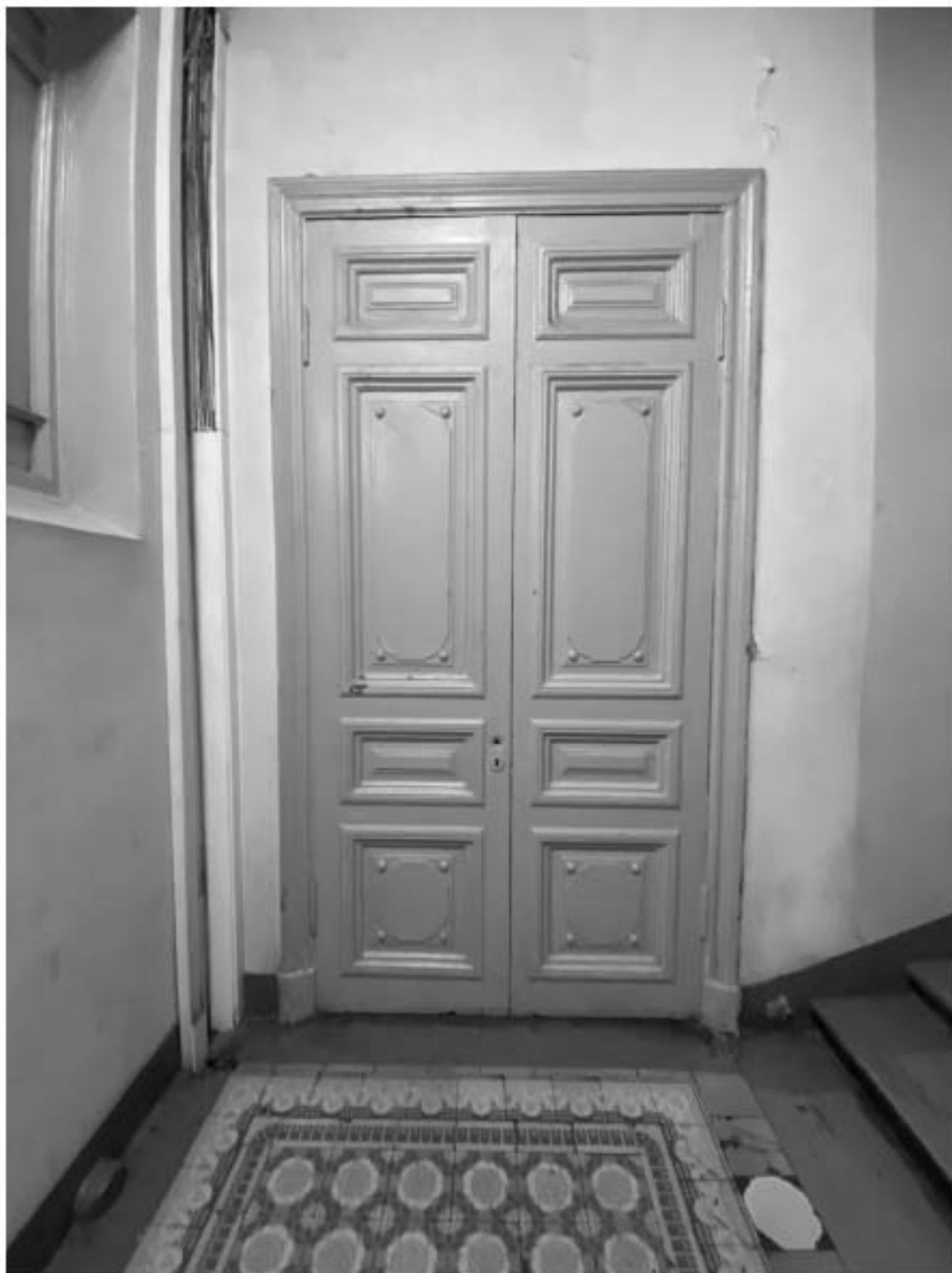
131. Дверное заполнение парадной лестницы Л4 объекта культурного наследия в уровне 3-го этажа
