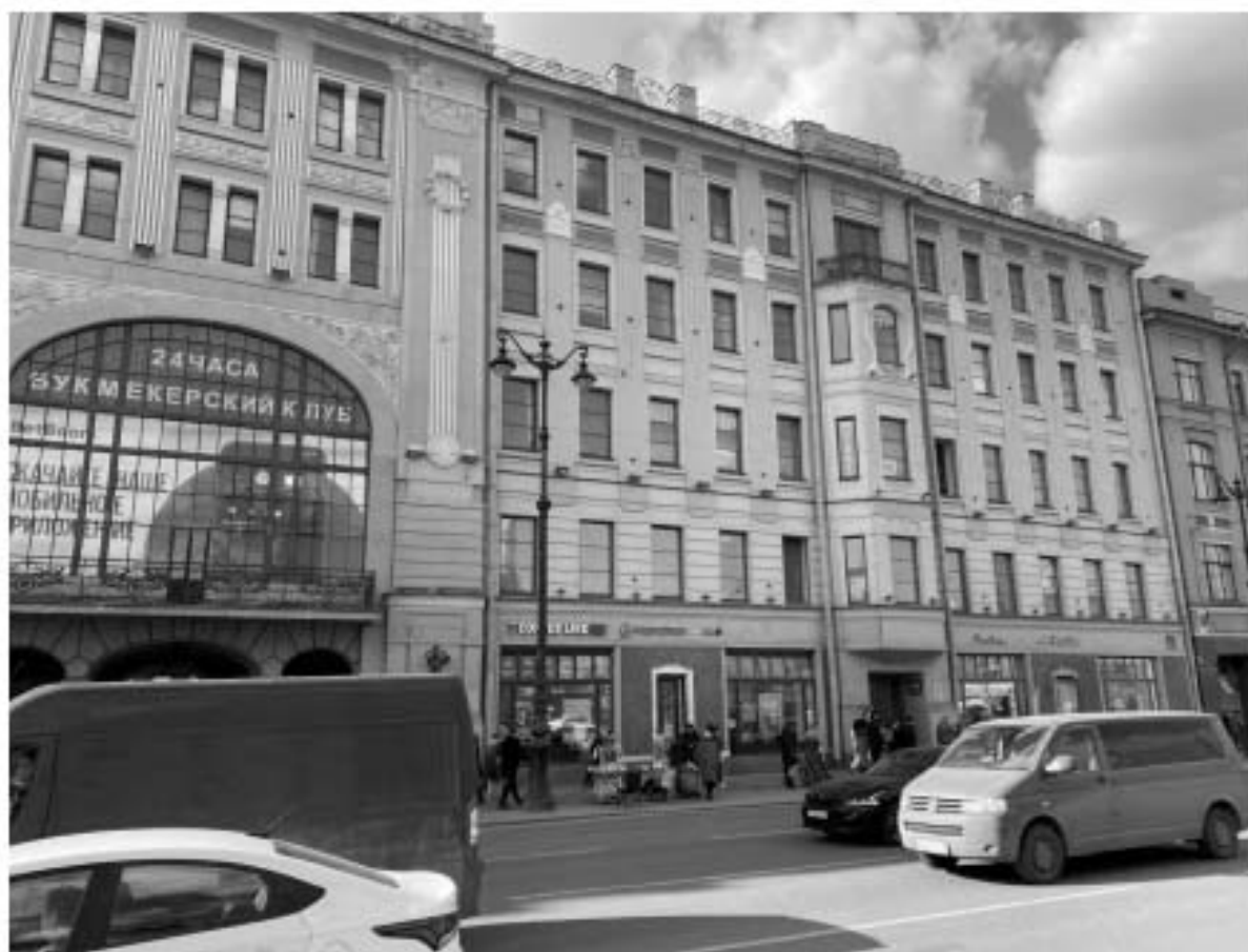
5. Фрагмент лицевого фасада объекта культурного наследия.
