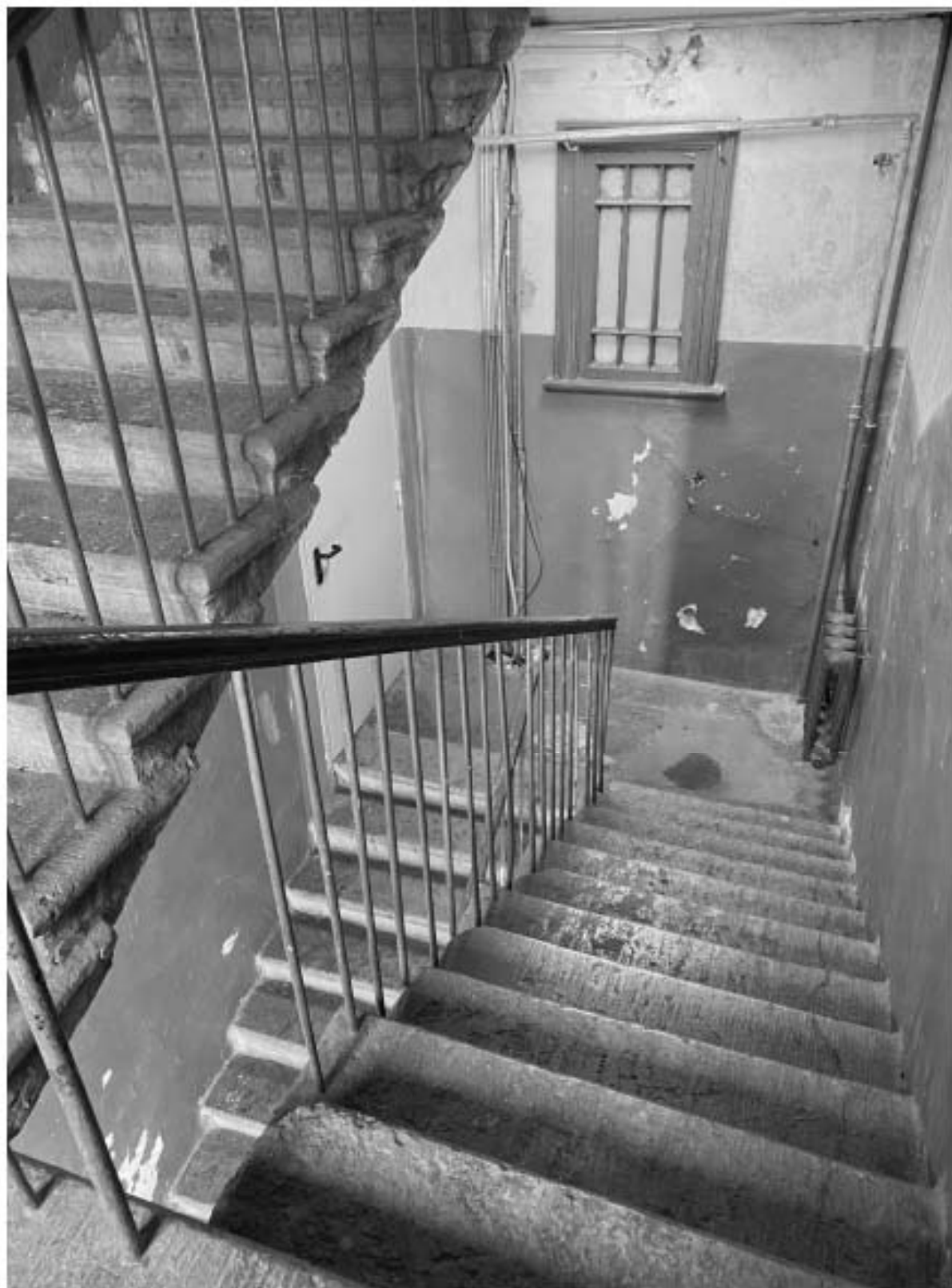
28. Вид на служебную лестницу ЛЗ объекта культурного наследия в уровне 6-го этажа.
