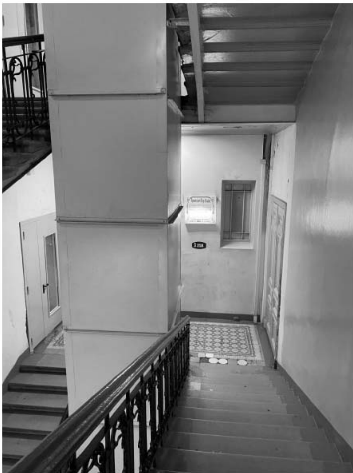
130. Интерьер парадной лестницы Л4 объекта культурного наследия в уровне 3-го этажа.
