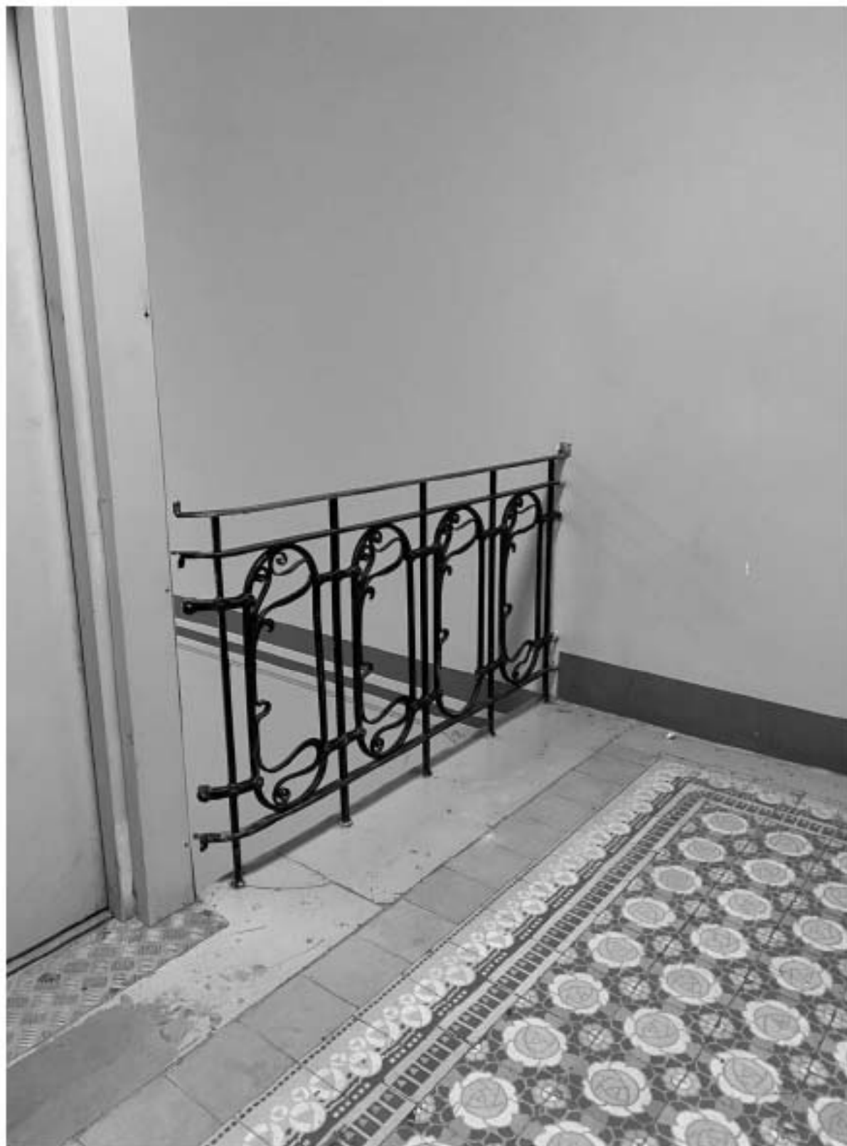
33. Парадная лестница Л1 объекта культурного наследия в уровне 5-го этажа.
