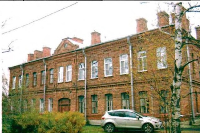
Фото 128. Восточный фасад. Общий вид.
