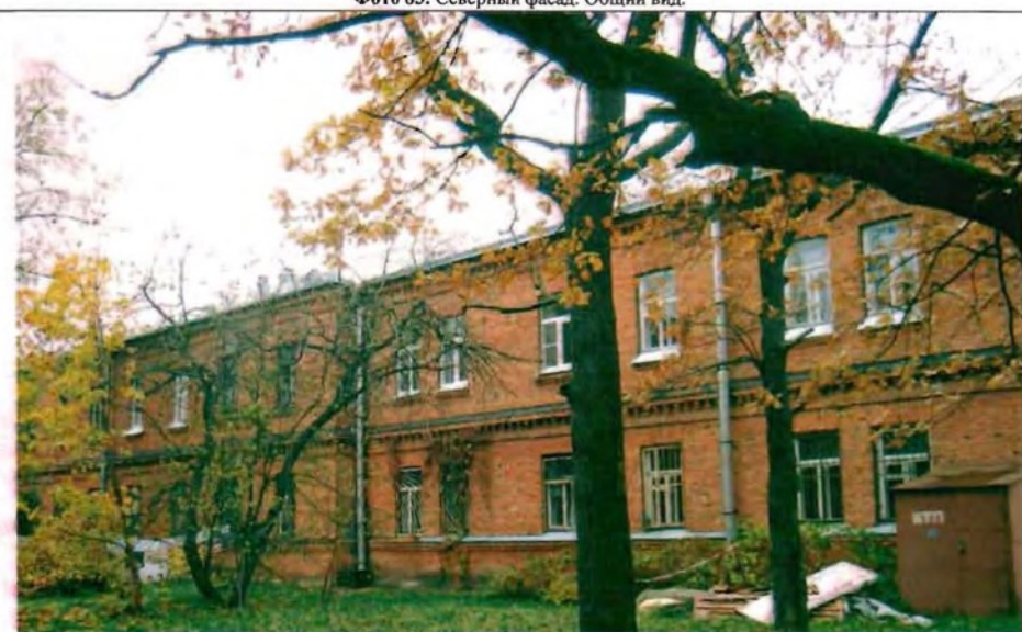
Фото 84. Южный фасад. Общий вид.
