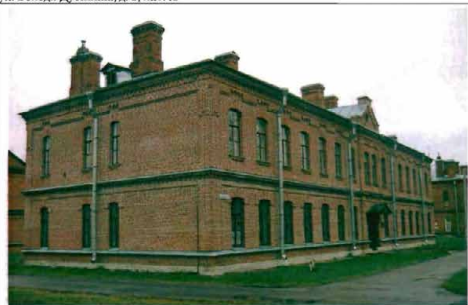
Фото 132. Западный, северный фасады. Общий вид.
