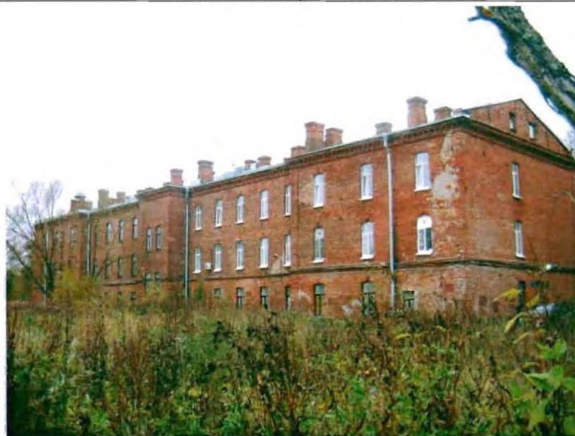
Фото 14. Восточный фасад. Общий вид.
