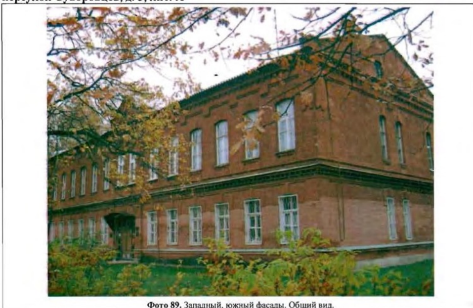
Фото 89. Западный, южный фасады. Общий вид.
