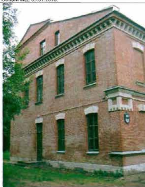
Фото 68. Восточный фасад. Общий вид.
