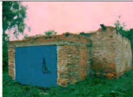
Фото 185. Восточный фасад. Общий вид.
