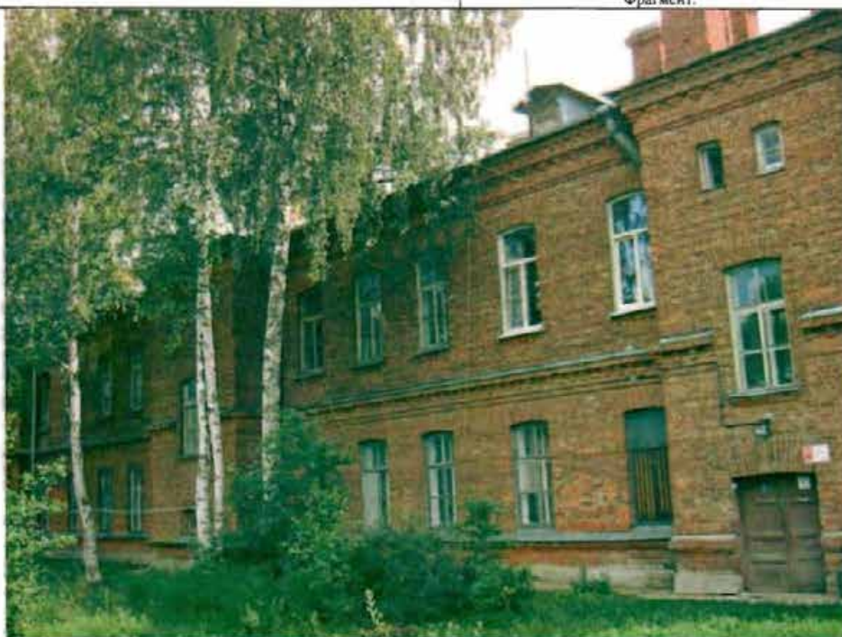
Фото 179. Западный фасад. Общий вид.
