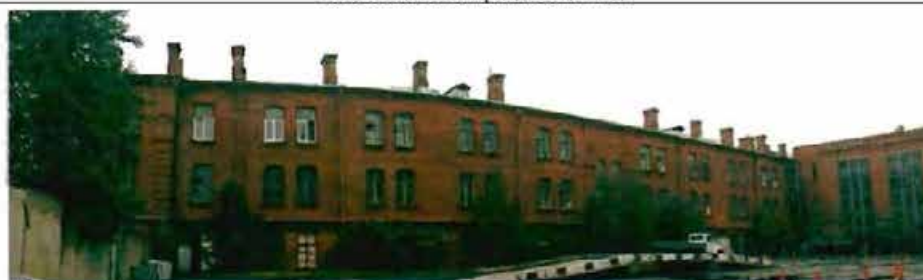
Фото 29. Западный фасад. Общий вид.
