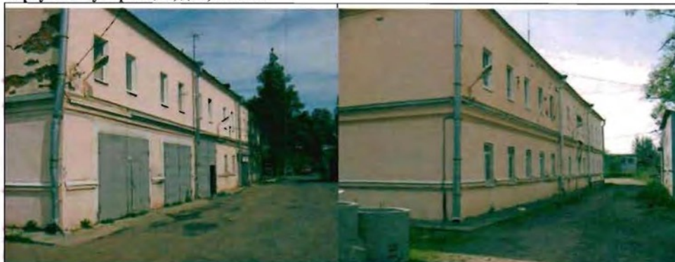
Фото 110. Восточный фасад. Общий вид.
