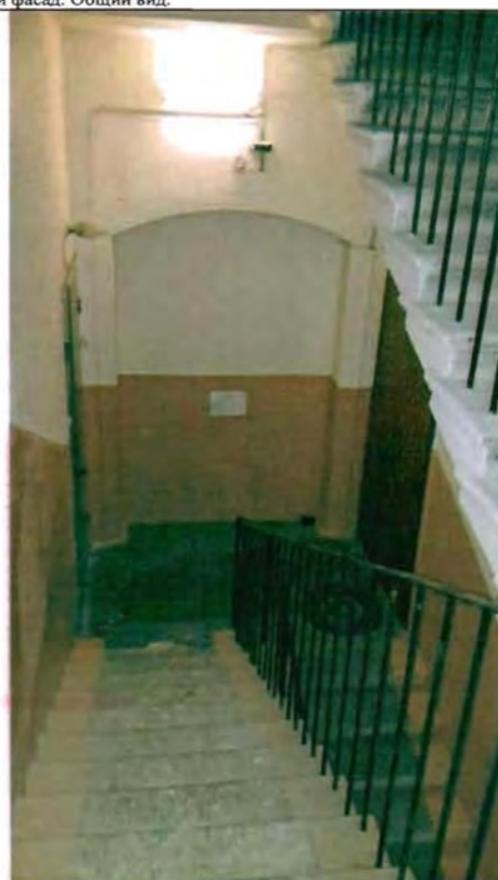
Фото 173. Лестница № 1 в северной части здания. Фрагмент.
