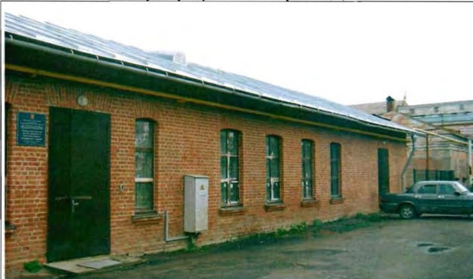
Фото 18. Западный фасад. Общий вид.
