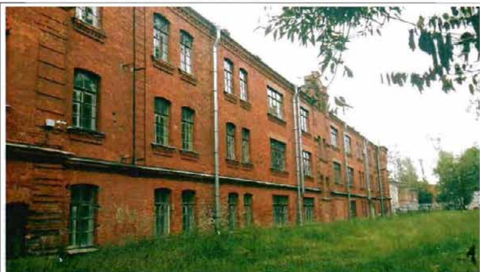
Фото 48. Западный фасад. Общий вид.
