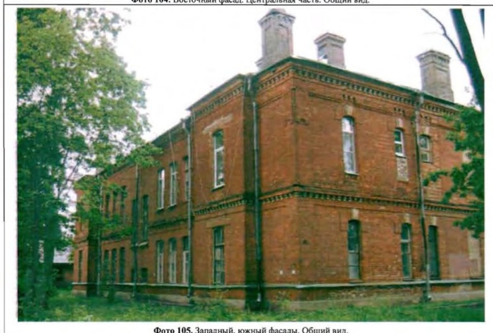
Фото 105. Западный, южный фасады. Общий вид.
