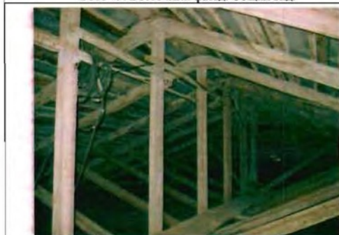
Фото 81. Конструкции крыши. Общий вид.
