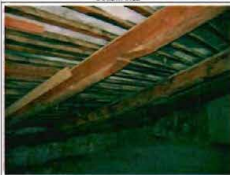
Фото 151. Конструкции крыши. Фрагмент.
