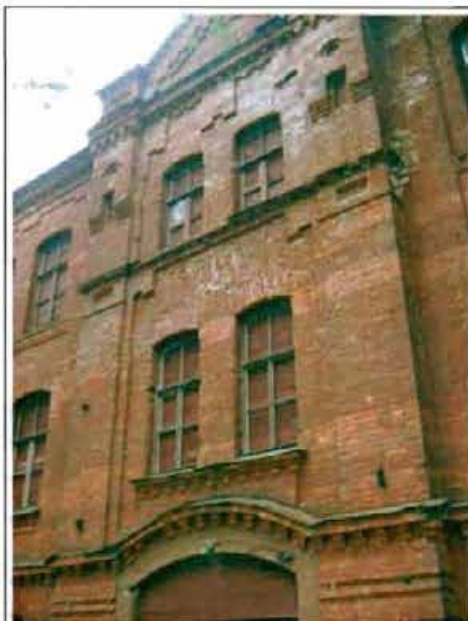
Фото 3. Западный фасад. Фрагмент центральной части фасада.
