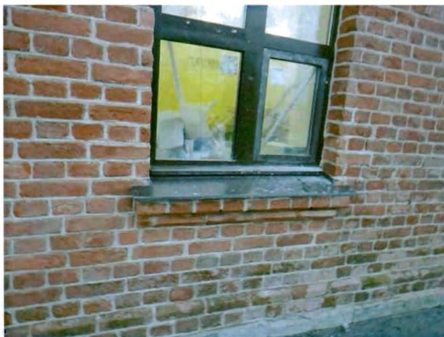
Ступенчатые подоконные доски. Съемка 20.11.2012, Воронина Н.В.
