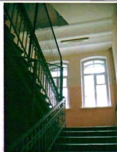
Фото 56. Лестница в центральной части здания. Фрагмент.
