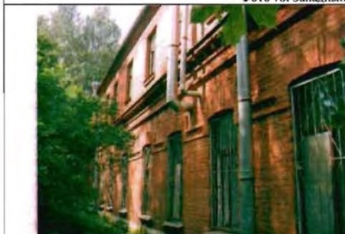
Фото 79. Восточный фасад. Общий вид.
