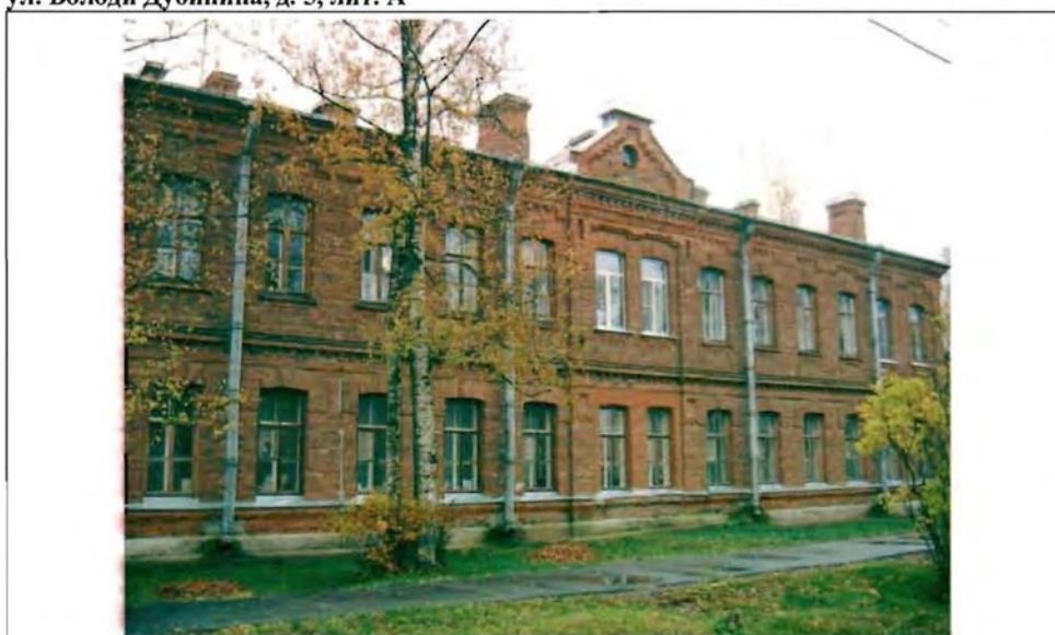
Фото 157. Западный фасад. Общий вид.
