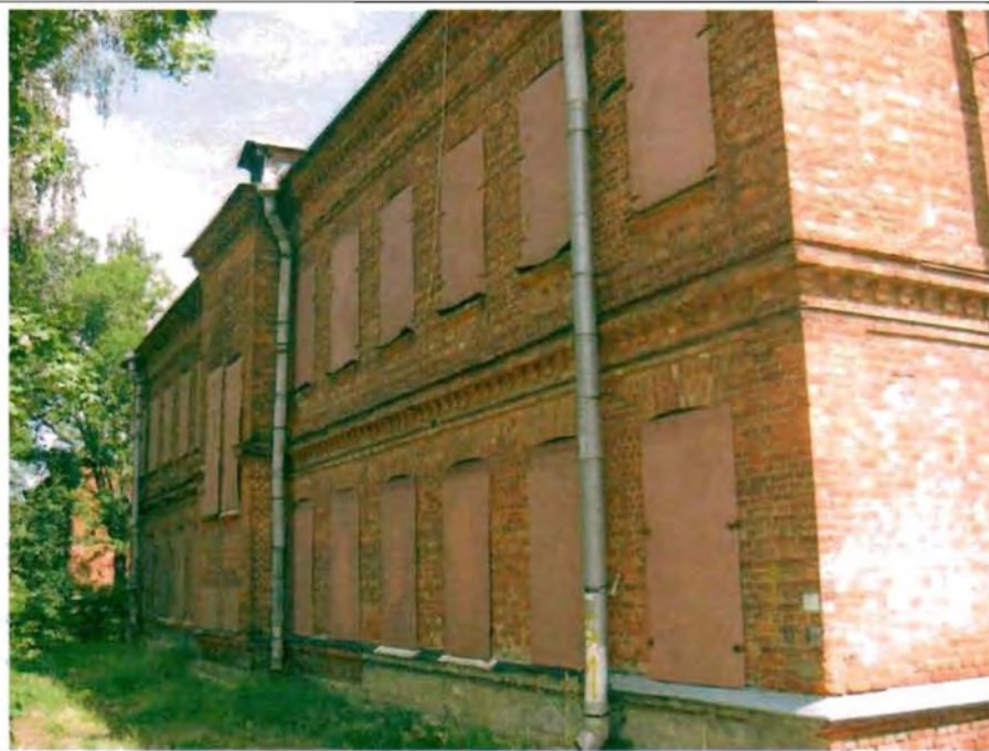
Фото 119. Западный фасад. Общий вид.
