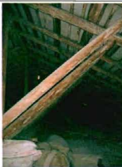
Фото 27. Конструкции крыши. Фрагмент.
