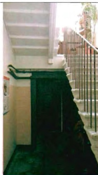
Фото 131. Лестница № 2 в северной части здания. Общий вид.
