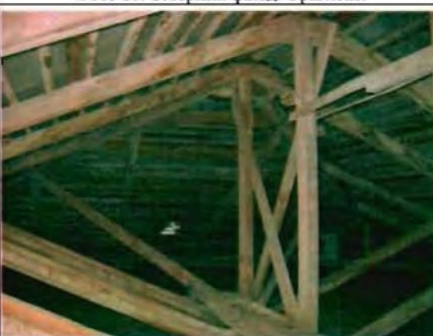
Фото 82. Конструкции крыши. Общий вид.
