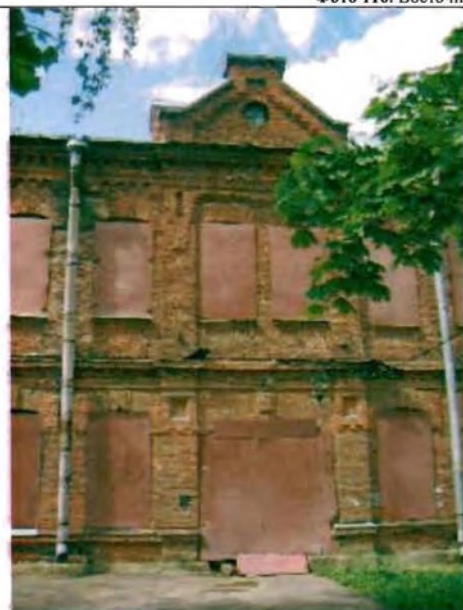
Фото 117. Восточный фасад. Фрагмент центральной части фасада.
