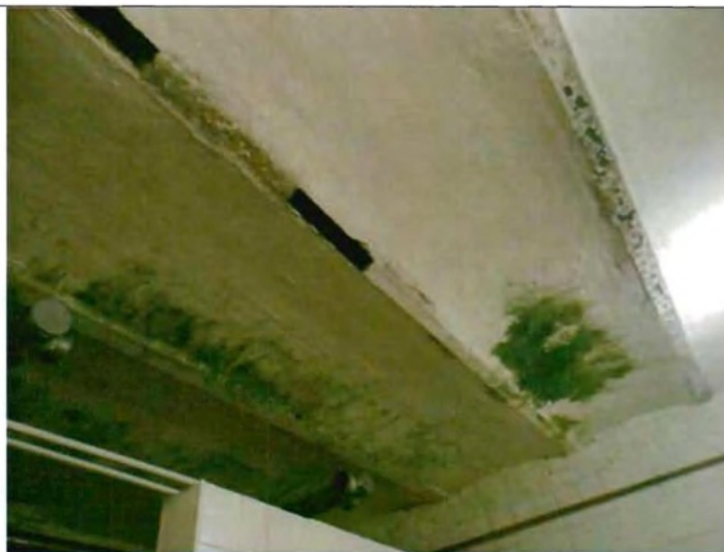
Своды по металлическим балкам. Съёмка 27.11.2012, Воронина Н.В.
