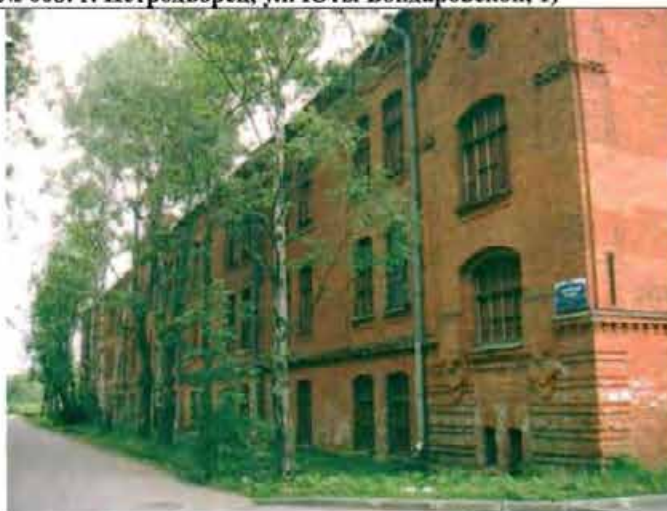
Фото 1. Западный фасад. Общий вид.
