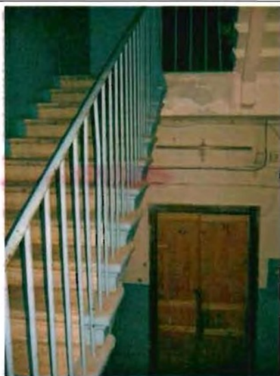
Фото 143. Лестница № 1 в северной части здания. Общий вид.
