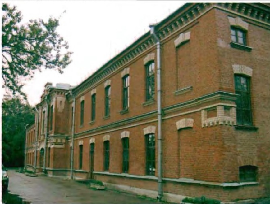
Фото 64. Северный фасад. Общий вид.
