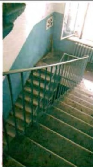
Фото 144. Лестница № 2 в южной части здания. Общий вид.
