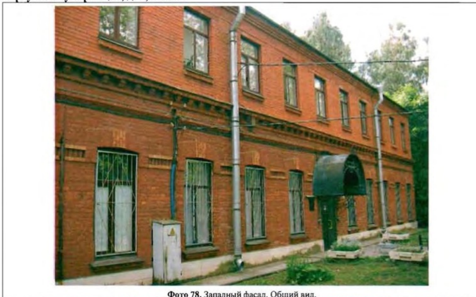
Фото 78. Западный фасад. Общий вид.
