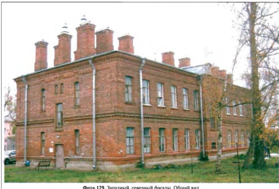
Фото 129. Западный, северный фасады. Общий вид.
