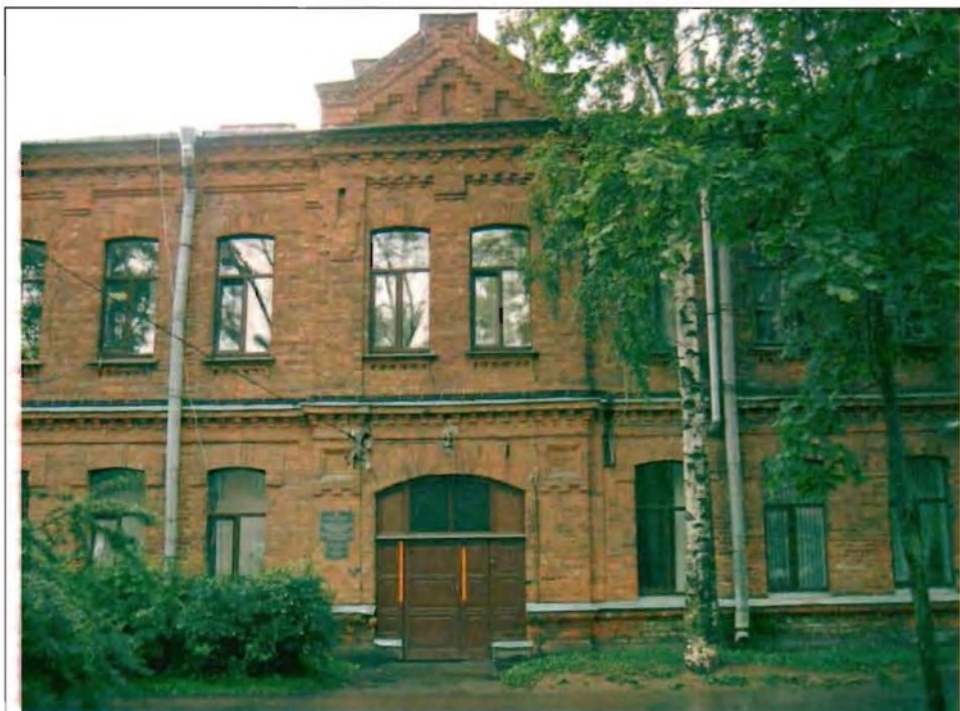
Фото 164. Восточный фасад. Фрагмент центральной части фасада.
