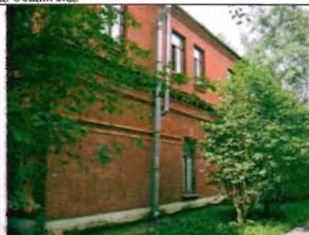
Фото 80. Северный фасад. Фрагмент.
