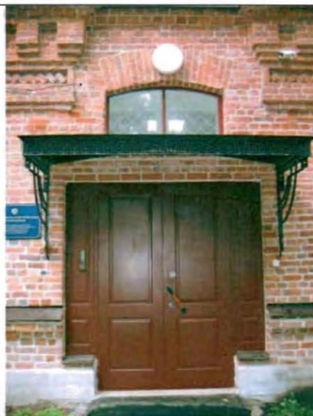
Фото 41. Дверной проем восточного фасада. Общий вид.
