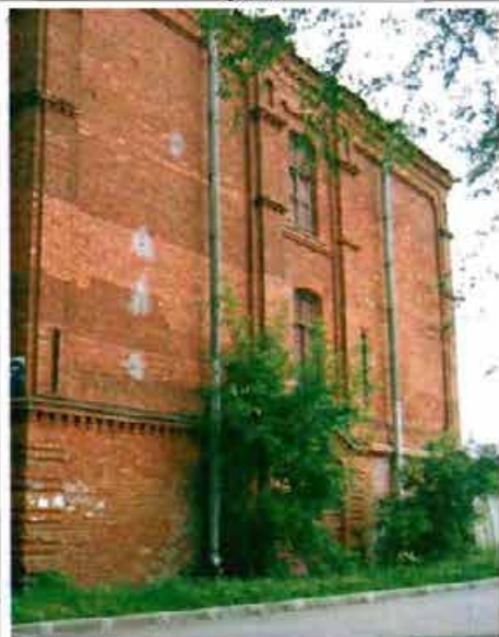
Фото 5. Южный фасад. Общий вид.
