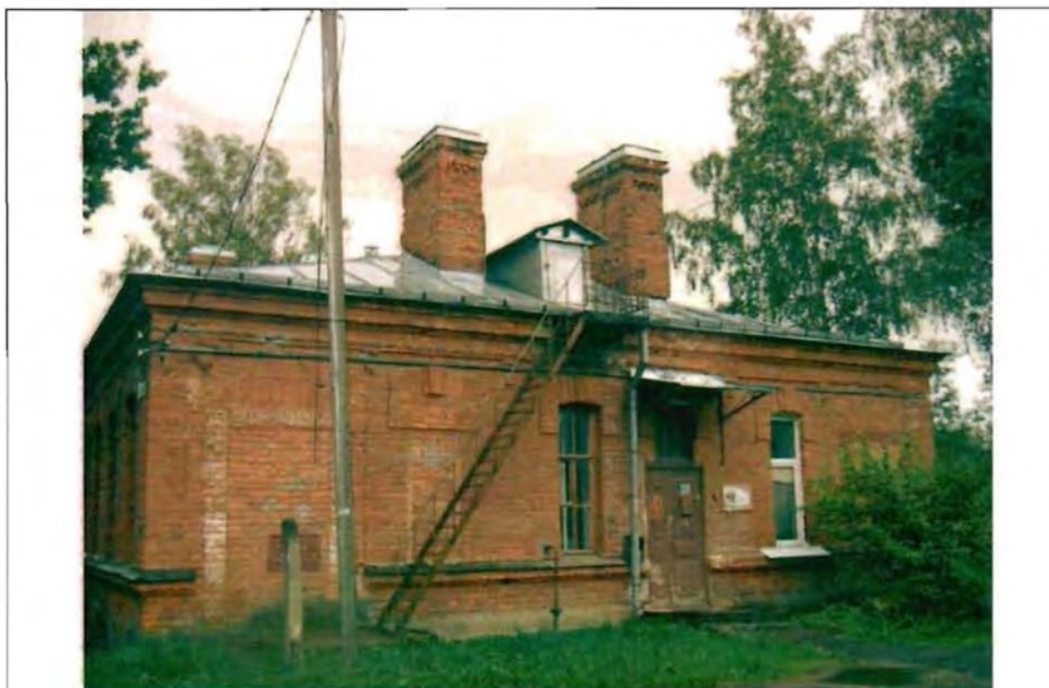
Фото189. Северный фасад. Общий вид.
