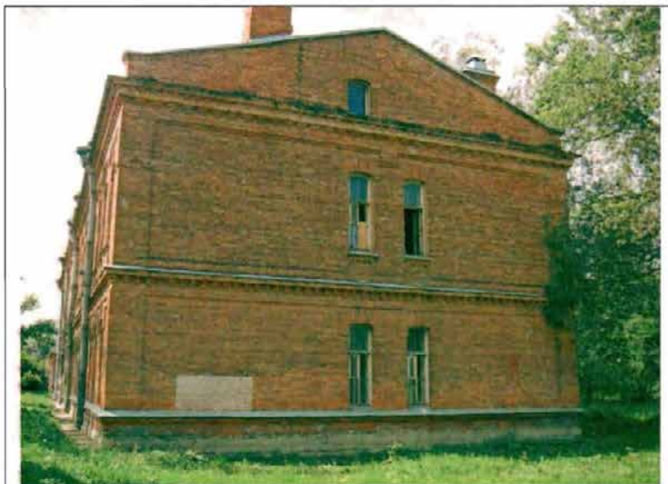
Фото 180. Северный фасад. Общий вид.
