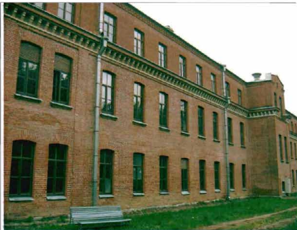
Фото 66. Южный фасад. Общий вид. 05.07.2016.
