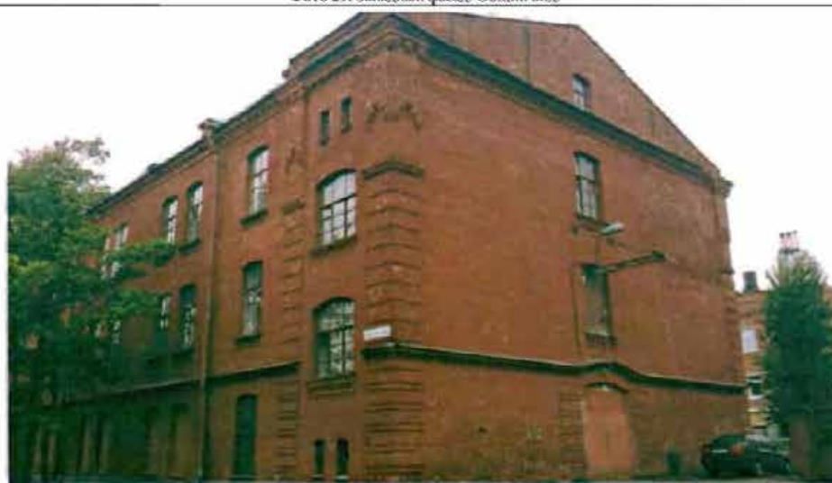
Фото 30. Северный фасад. Общий вид.
