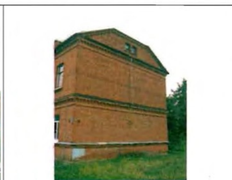
Фото 86. Западный фасад. Общий вид.
