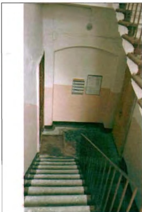
Фото 130. Лестница № 1 в южной части здания. Общий вид.
