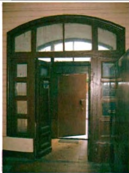
Фото 107. Дверной проем тамбура. Общий вид.
