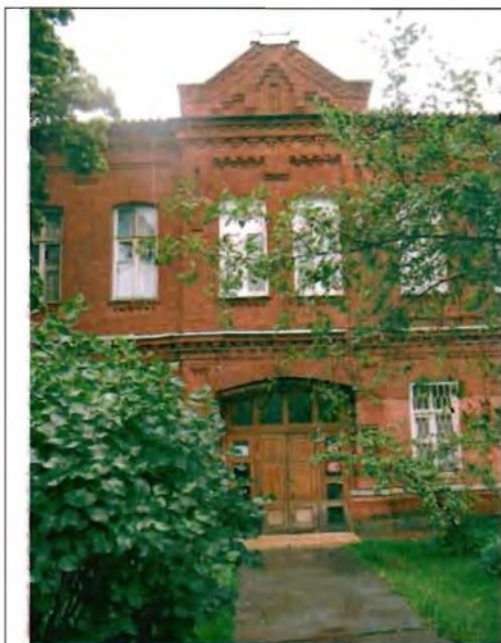
Фото 90. Восточный фасад. Центральная часть. Общий вид.
