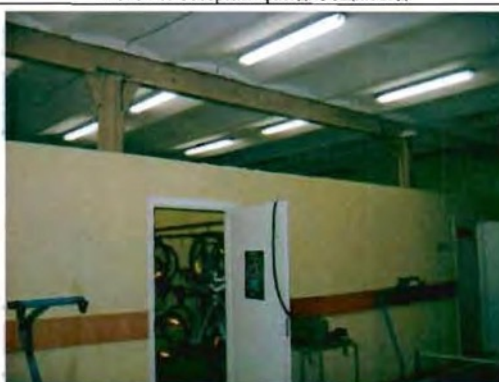
Фото 22. Интерьер. Помещение в уровне 1-го этажа. Общий вид.
