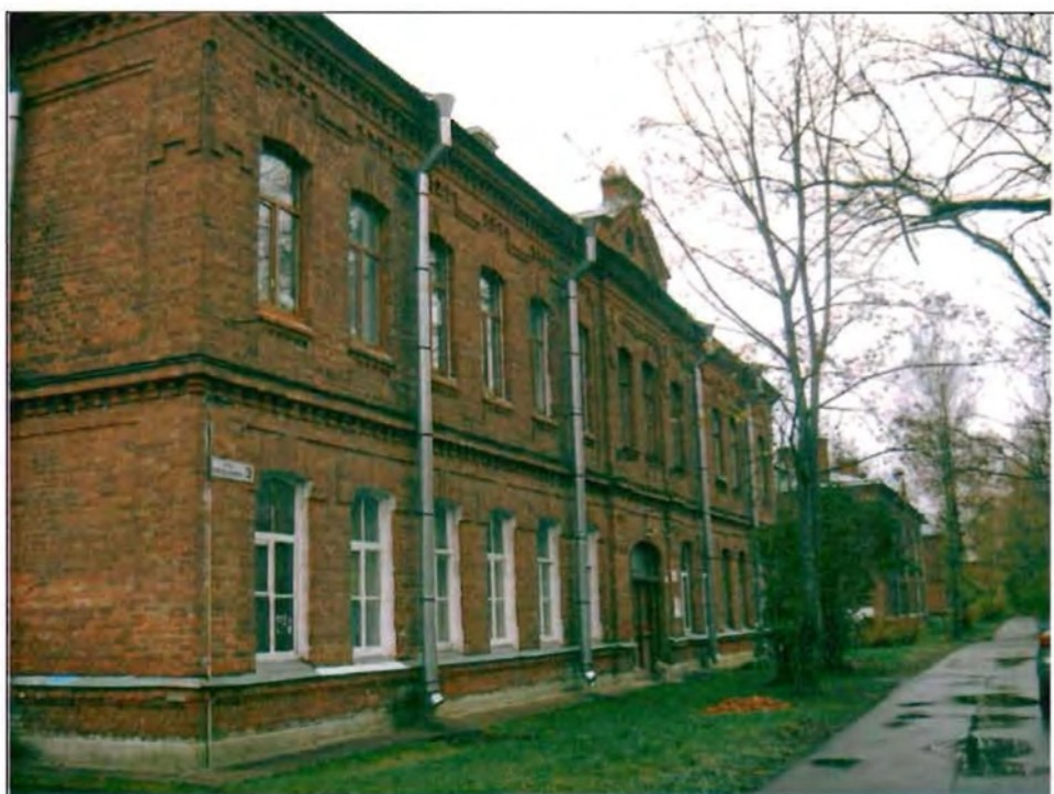
Фото 146. Западный фасад. Общий вид.
