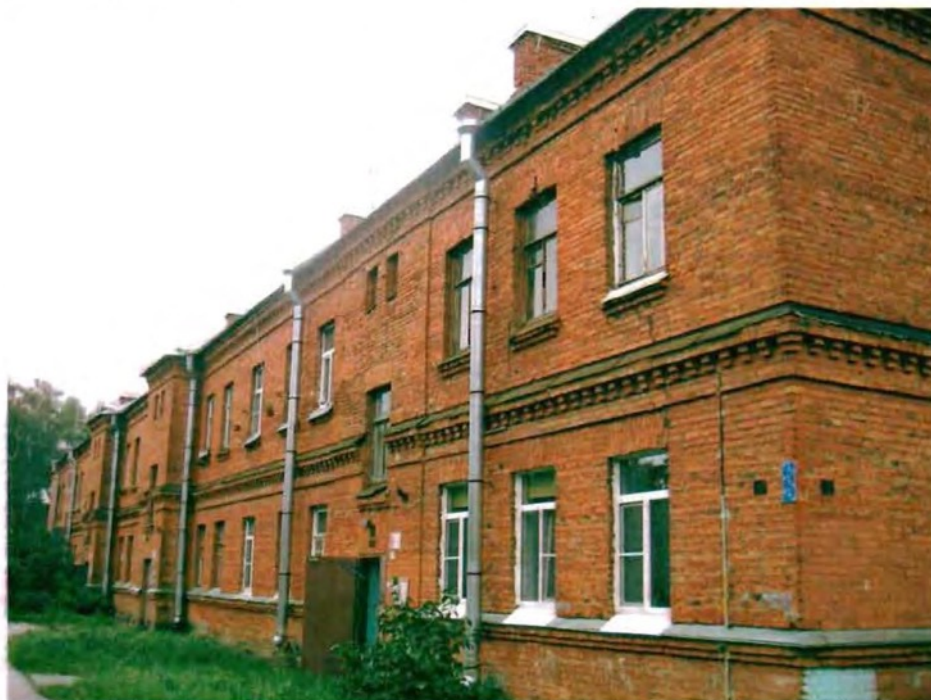
Фото 83. Северный фасад. Общий вид.
