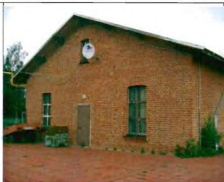
Фото 21. Южный фасад. Общий вид.
