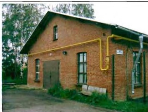
Фото 20. Северный фасад. Общий вид.
