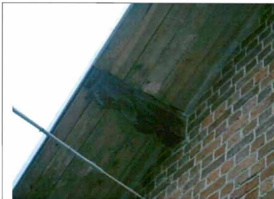
Деревянные кобылки. Съемка 20.11.2012, Воронина Н.В.
