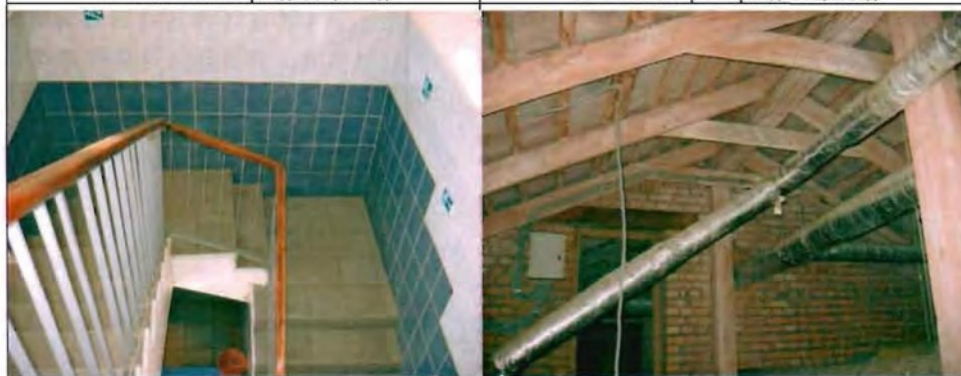
Фото 114. Лестница. Общий вид.
