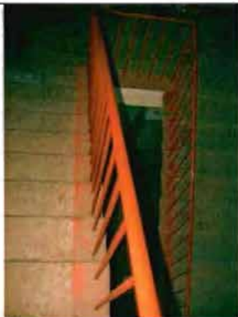
Фото 149. Лестница № 1 в северной части здания. Общий вид.
