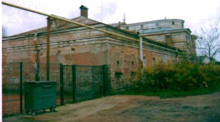
Фото 24. Западный, северный фасады. Общий вид.
