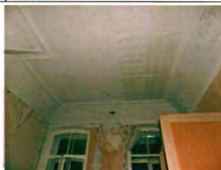
Фото 121. Помещение 1-го этажа.
