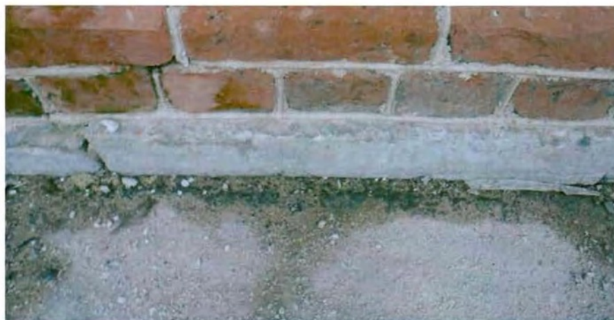
Цоколь, облицованный известняковой скобой. Съемка 20.11.2012, Воронина Н.В.
