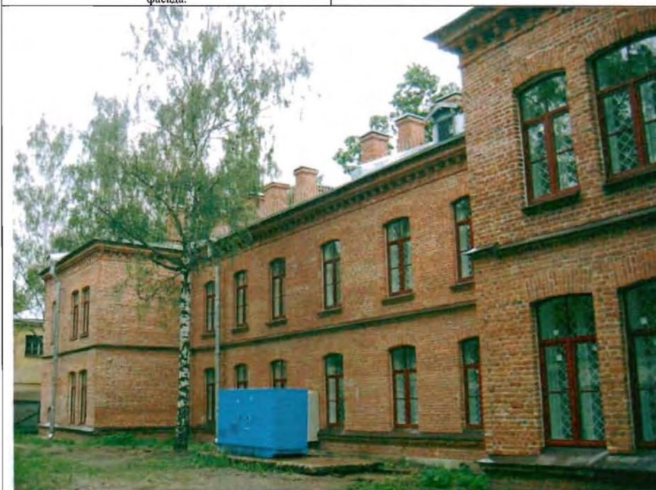
Фото 42. Западный фасад. Общий вид.
