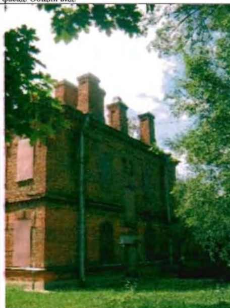
Фото 118. Северный фасад. Общий вид.
