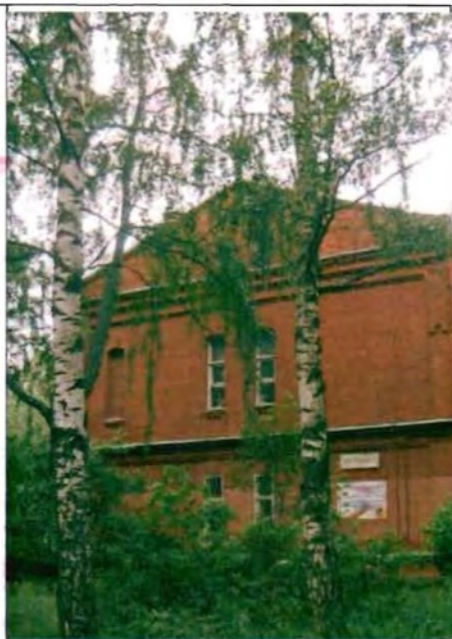
Фото 91. Северный фасад. Общий вид.
