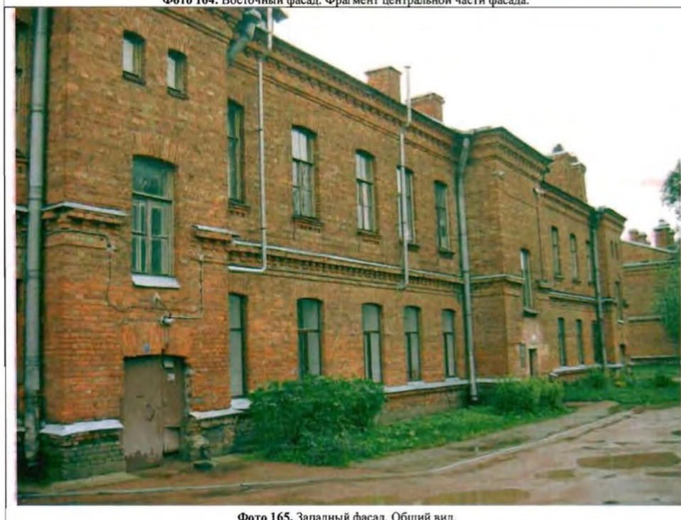
Фото 165. Западный фасад. Общий вид.
