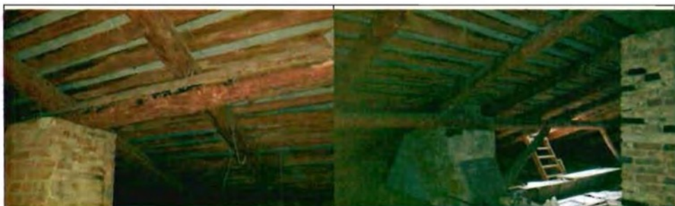
Фото 62. Конструкции крыши. Общий вид.
