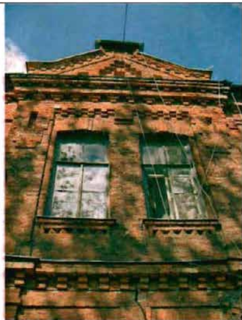
Фото 177. Восточный фасад. Центральная часть. Фрагмент.
