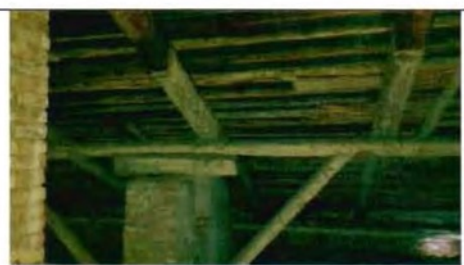
Фото 38. Конструкции крыши. Фрагмент.
