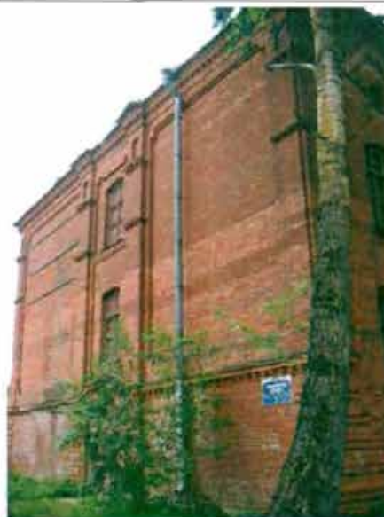
Фото 6. Северный фасад. Общий вид.
