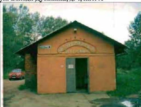
Фото 153. Восточный фасад. Общий вид.
