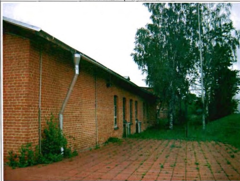
Фото 19. Восточный фасад. Общий вид.
