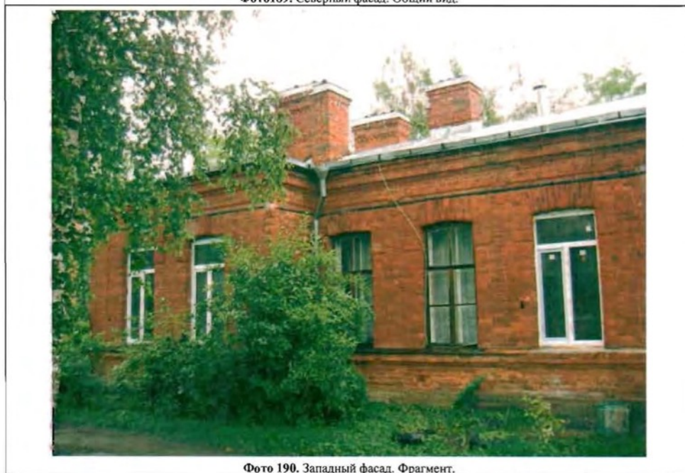
Фото 190. Западный фасад. Фрагмент.
