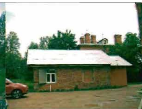
Фото 154. Южный фасад. Общий вид.
