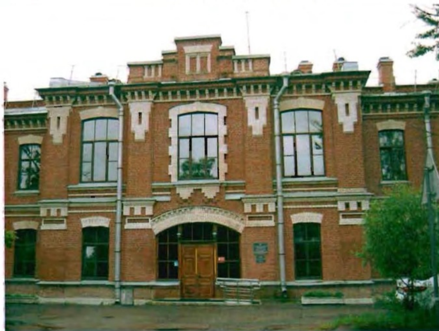
Фото 65. Северный фасад. Фрагмент центральной части фасада.
