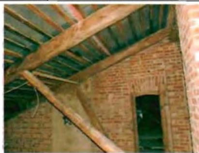
Фото 127. Конструкции крыши. Общий вид.
