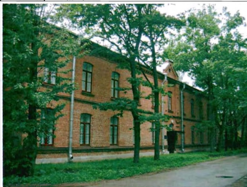
Фото 39. Восточный фасад. Общий вид.
