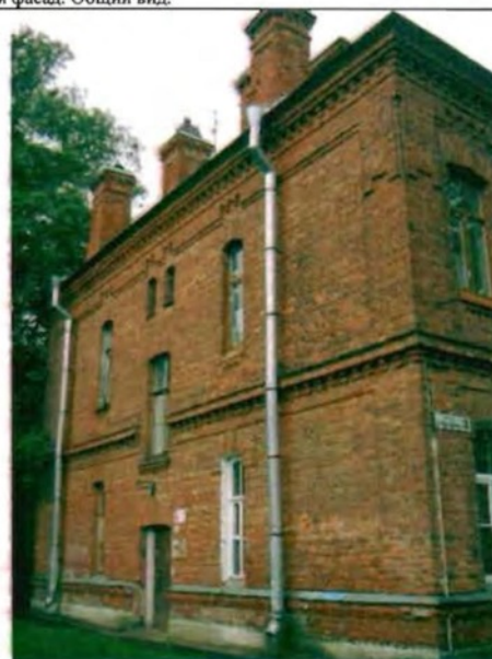
Фото 148. Северный фасад. Общий вид.
