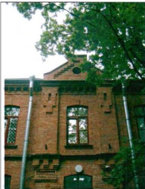
Фото 40. Восточный фасад. Фрагмент центральной части фасада.
