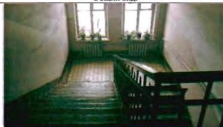
Фото 34. Интерьер. Лестница. Общий вид.
