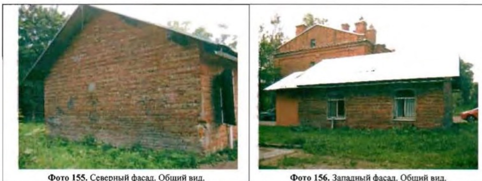
Фото 155. Северный фасад. Общий вид.
