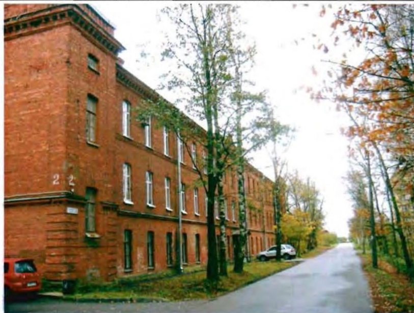
Фото 13. Западный фасад. Общий вид.
