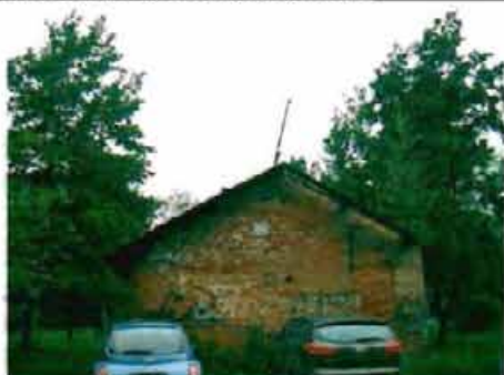
Фото 94. Восточный фасад. Общий вид.
