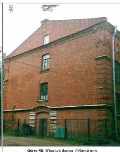
Фото 50. Южный фасад. Общий вид.
