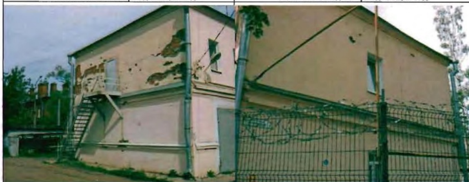
Фото 112. Южный фасад. Общий вид.
