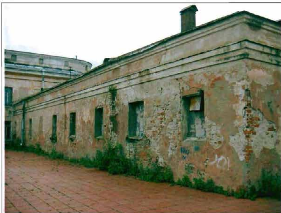
Фото 25. Восточный фасад. Общий вид.
