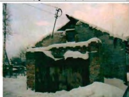
Фото 184. Восточный фасад. Общий вид. 14.01.2015.
