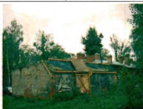
Фото 186. Западный, северный фасады. Общий вид.
