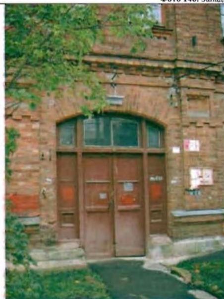
Фото 147. Дверной проем западного фасада. Общий вид.
