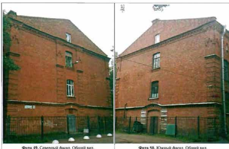
Фото 49. Северный фасад. Общий вид.
