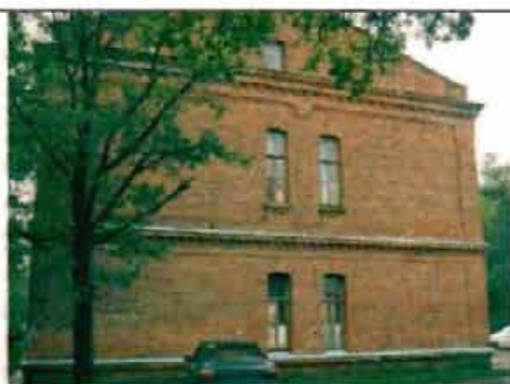
Фото 167. Северный фасад. Общий вид.
