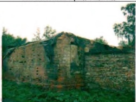
Фото 187. Северный фасад. Общий вид.
