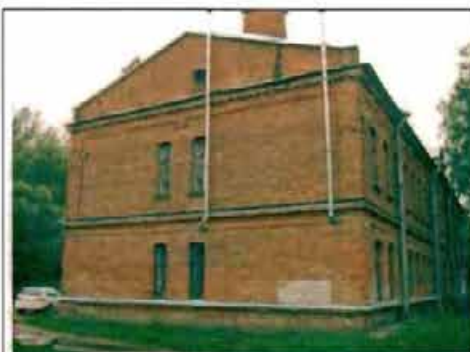
Фото 166. Южный фасад. Общий вид.
