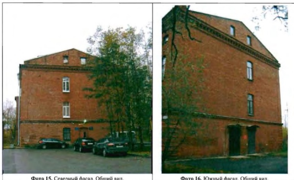
Фото 15. Северный фасад. Общий вид.
