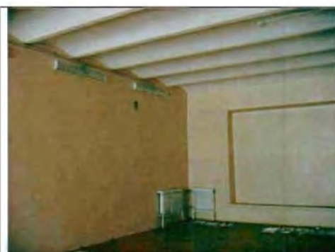
Фото 51. Интерьер. Помещение в уровне 1-го этажа. Общий вид.
