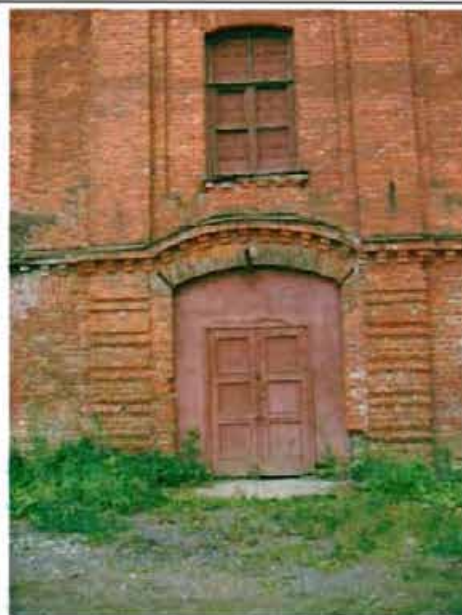
Фото 4. Западный фасад. Фрагмент центральной части фасада.
