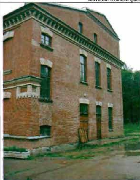
Фото 67. Западный фасад. Общий вид.
