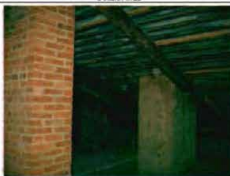
Фото 152. Конструкции крыши. Фрагмент.
