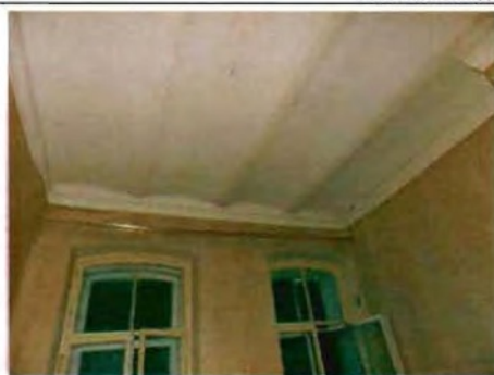
Фото 120. Помещение 1-го этажа. Общий вид.
