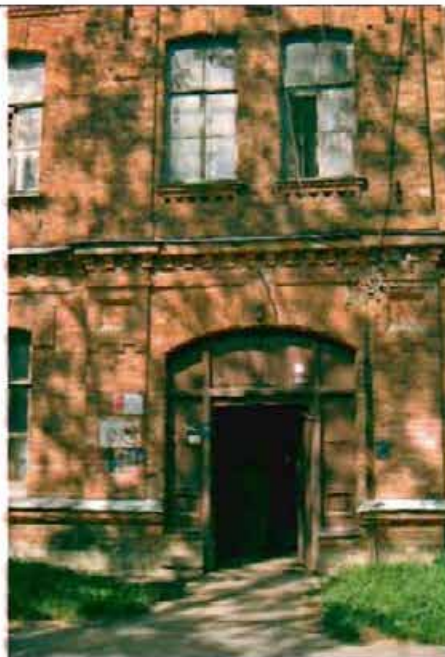
Фото 178. Восточный фасад. Центральная часть. Фрагмент.
