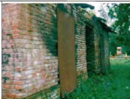
Фото 95. Северный фасад. Общий вид.
