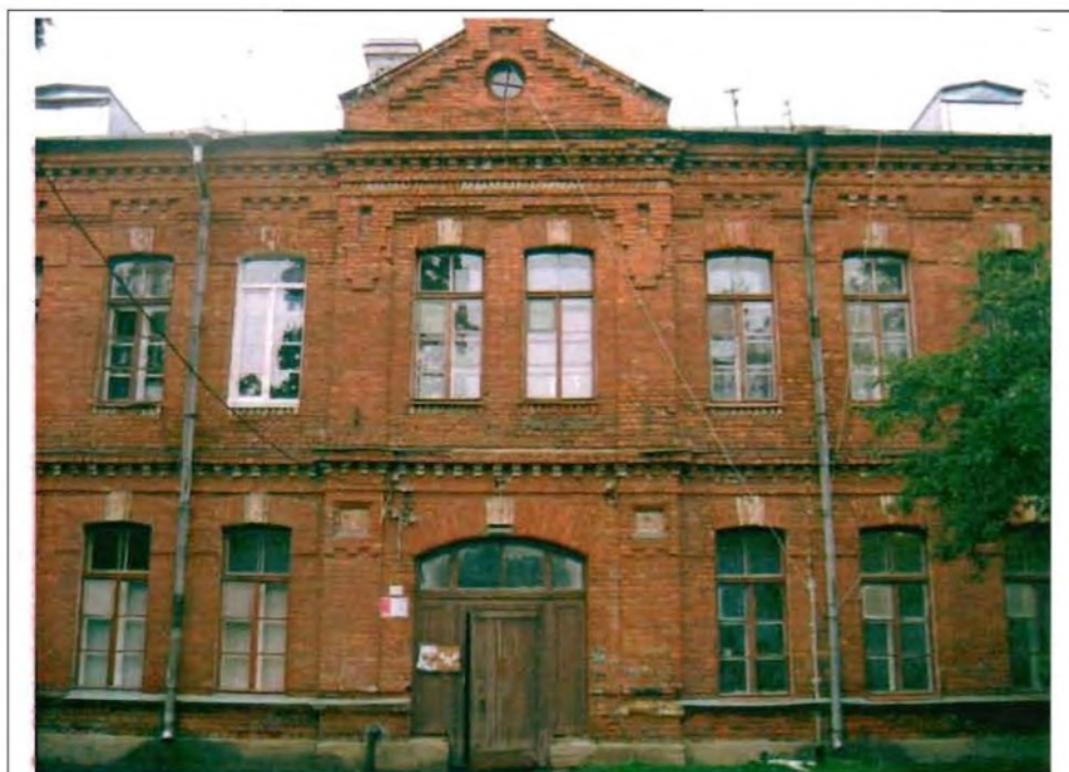
Фото 104. Восточный фасад. Центральная часть. Общий вид.
