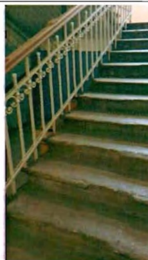
Фото 57. Лестница в центральной части здания. Фрагмент.
