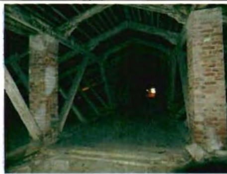
Фото 12. Конструкции крыши. Общий вид. 29.12.2015.
