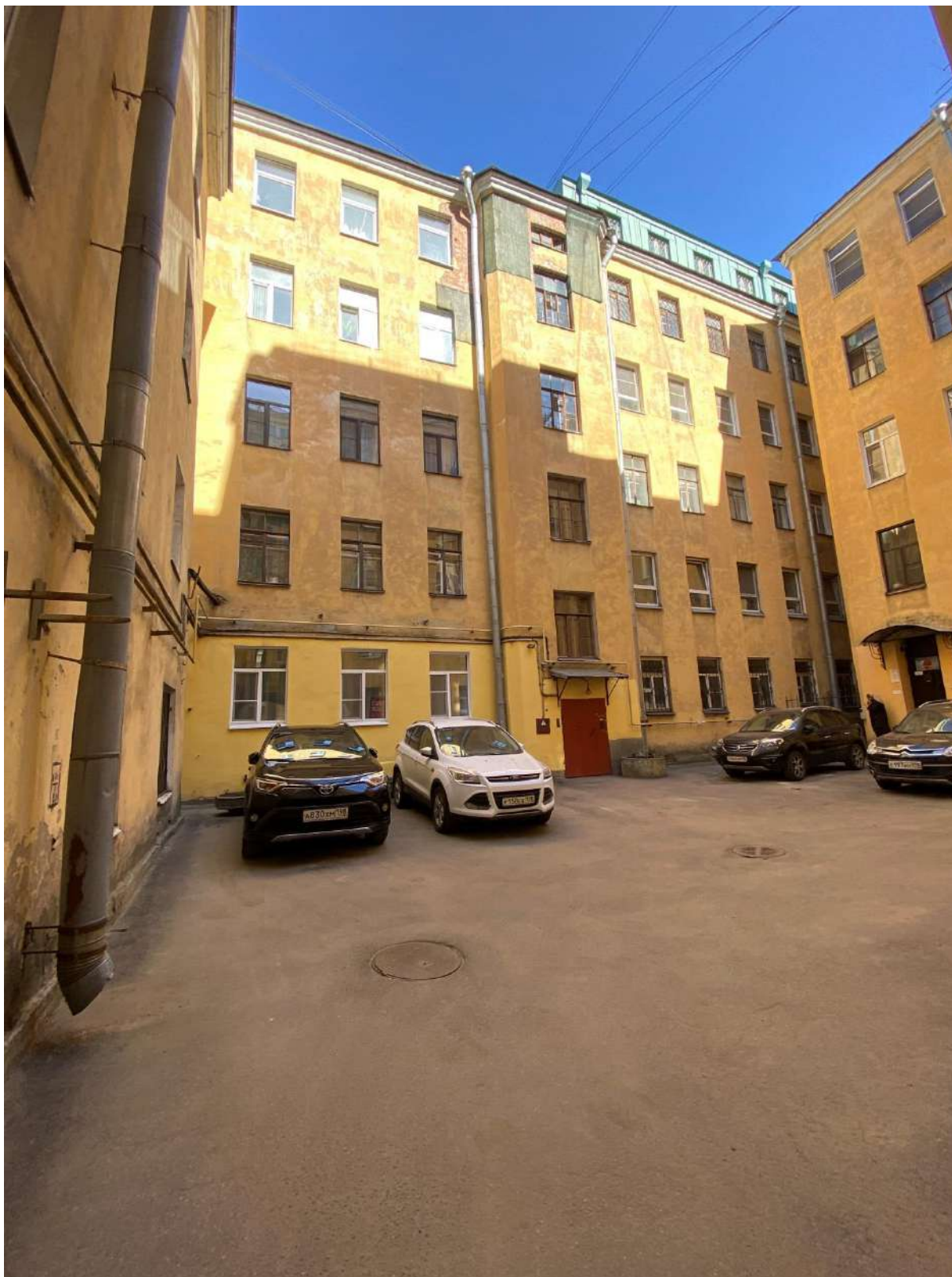
14. Фрагмент дворовых фасадов объекта культурного наследия
