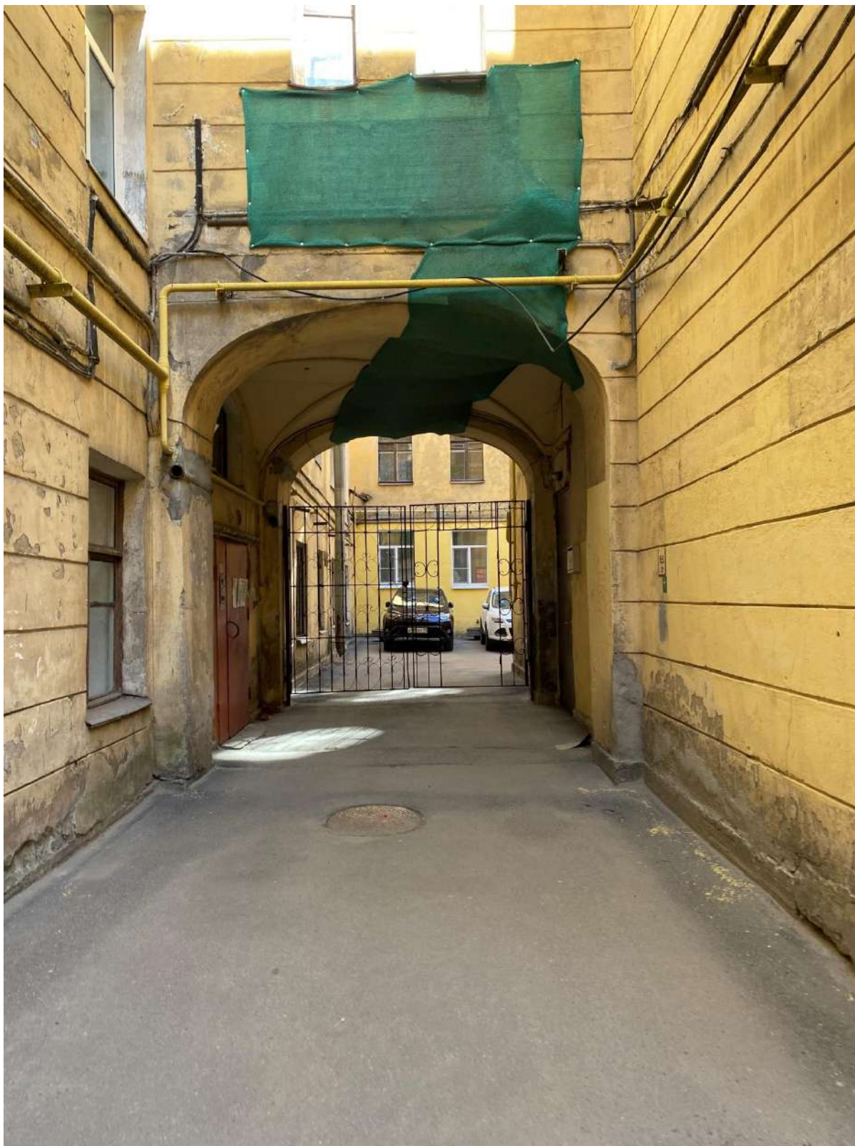
13. Фрагмент дворовых фасадов объекта культурного наследия
