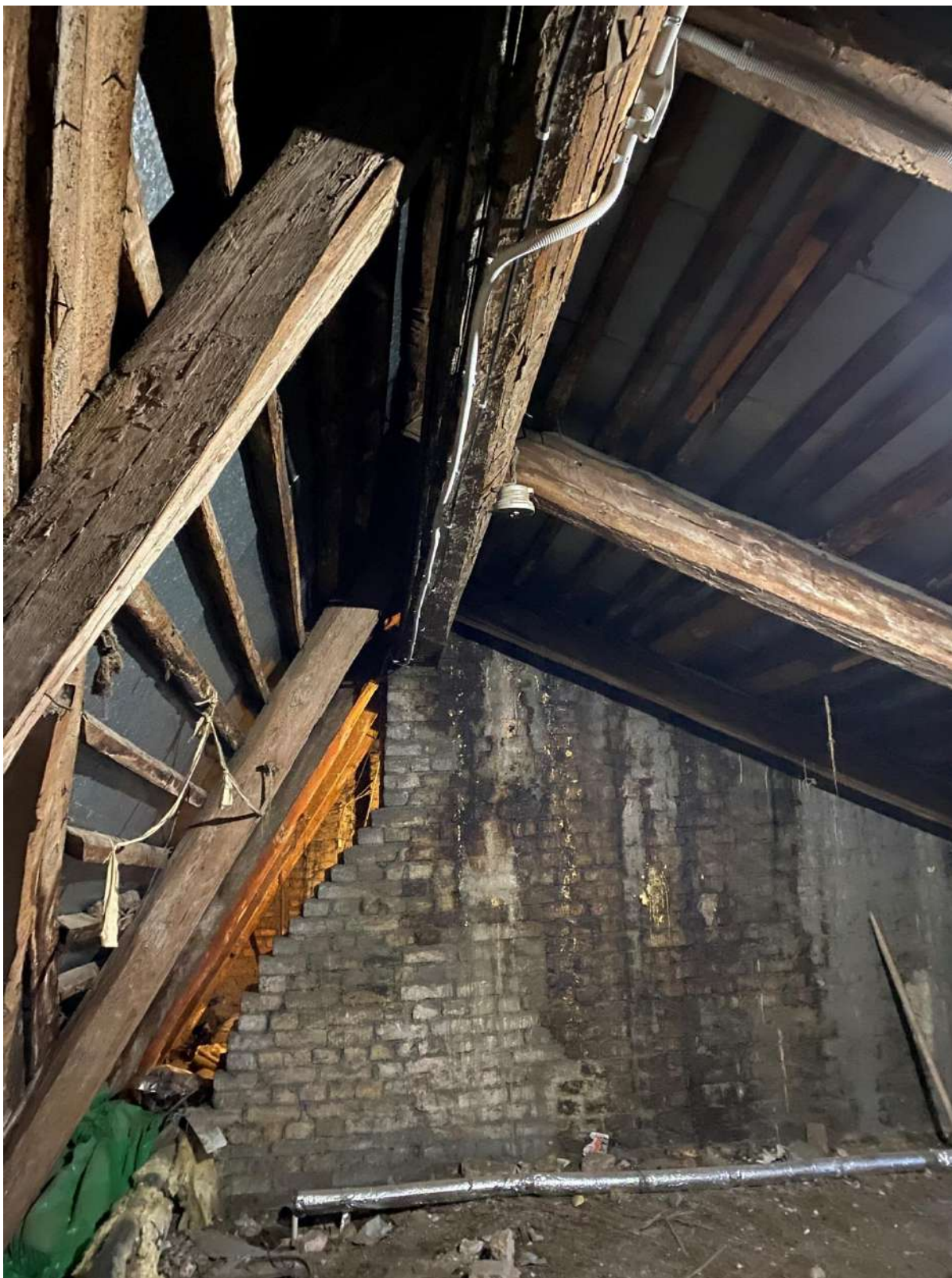
50. Общий вид чердачного помещения
