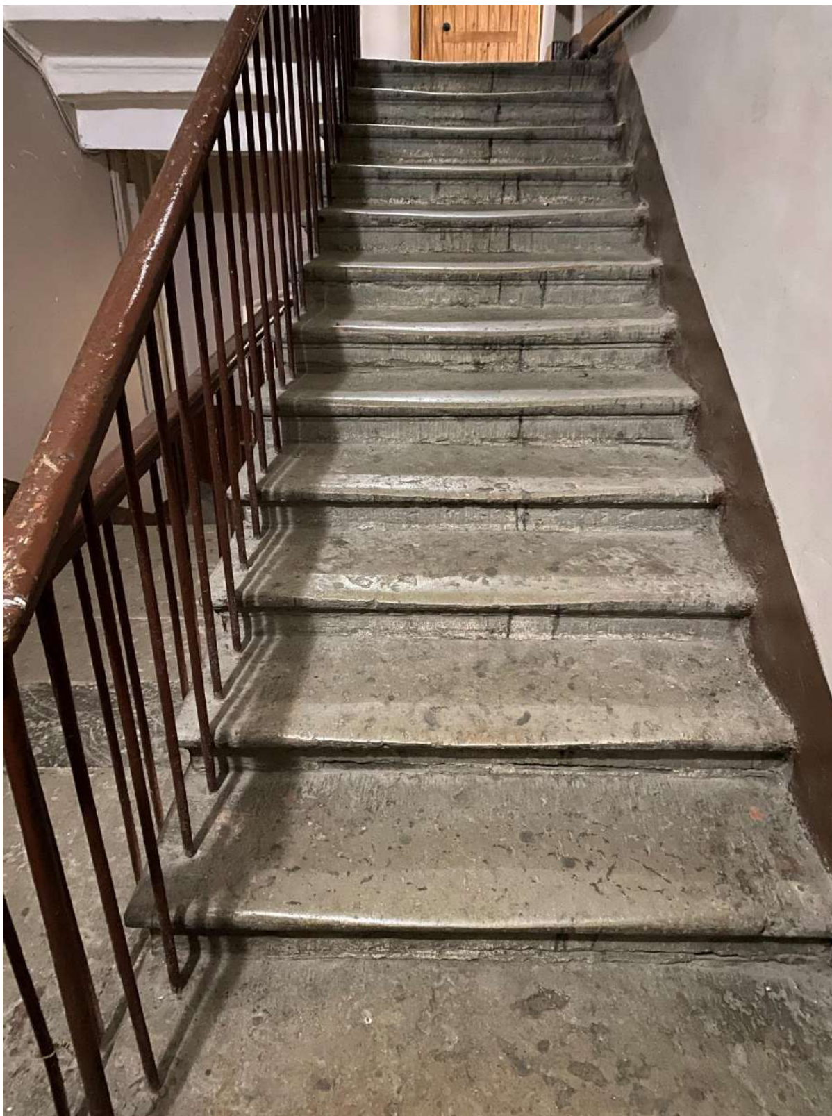
71.Общий вид лестницы 5ЛК в уровне 1-го этажа
