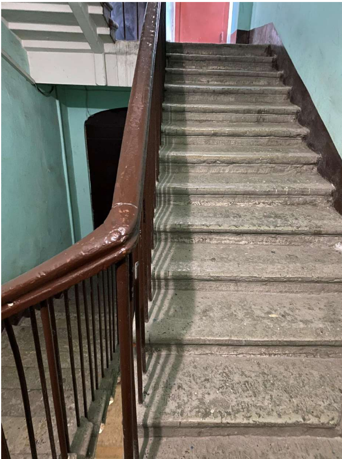
80. Общий вид лестницы 5ЛК в уровне 5-го этажа
