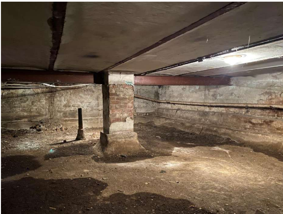
34. Общий вид подвального помещения
