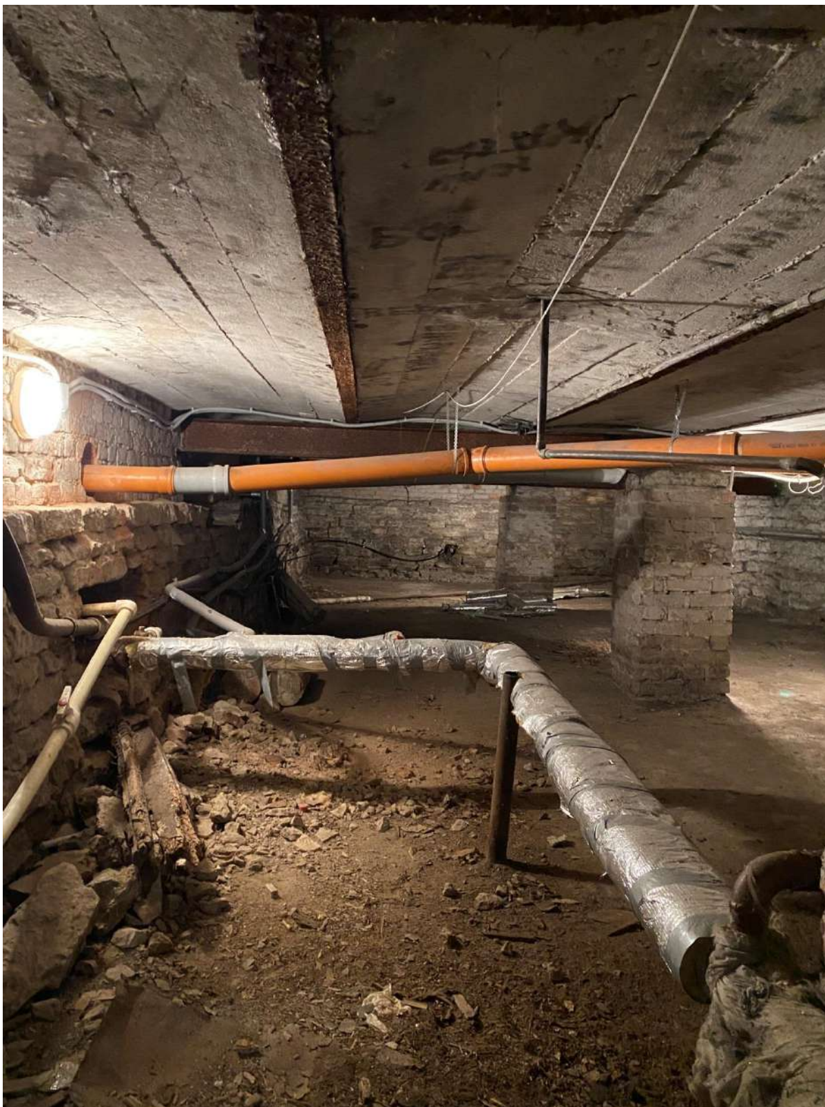
68. Общий вид подвального помещения
