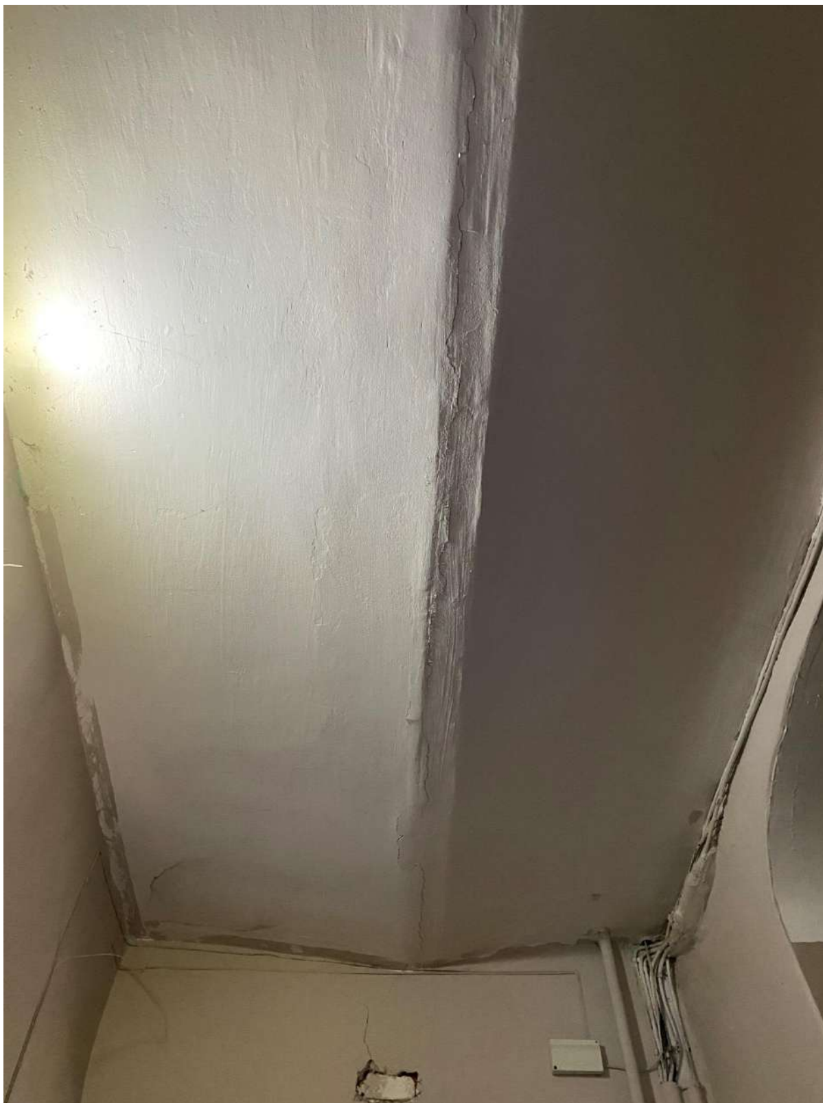
73. Перекрытие лестницы 5ЛК в уровне 2-го этажа
