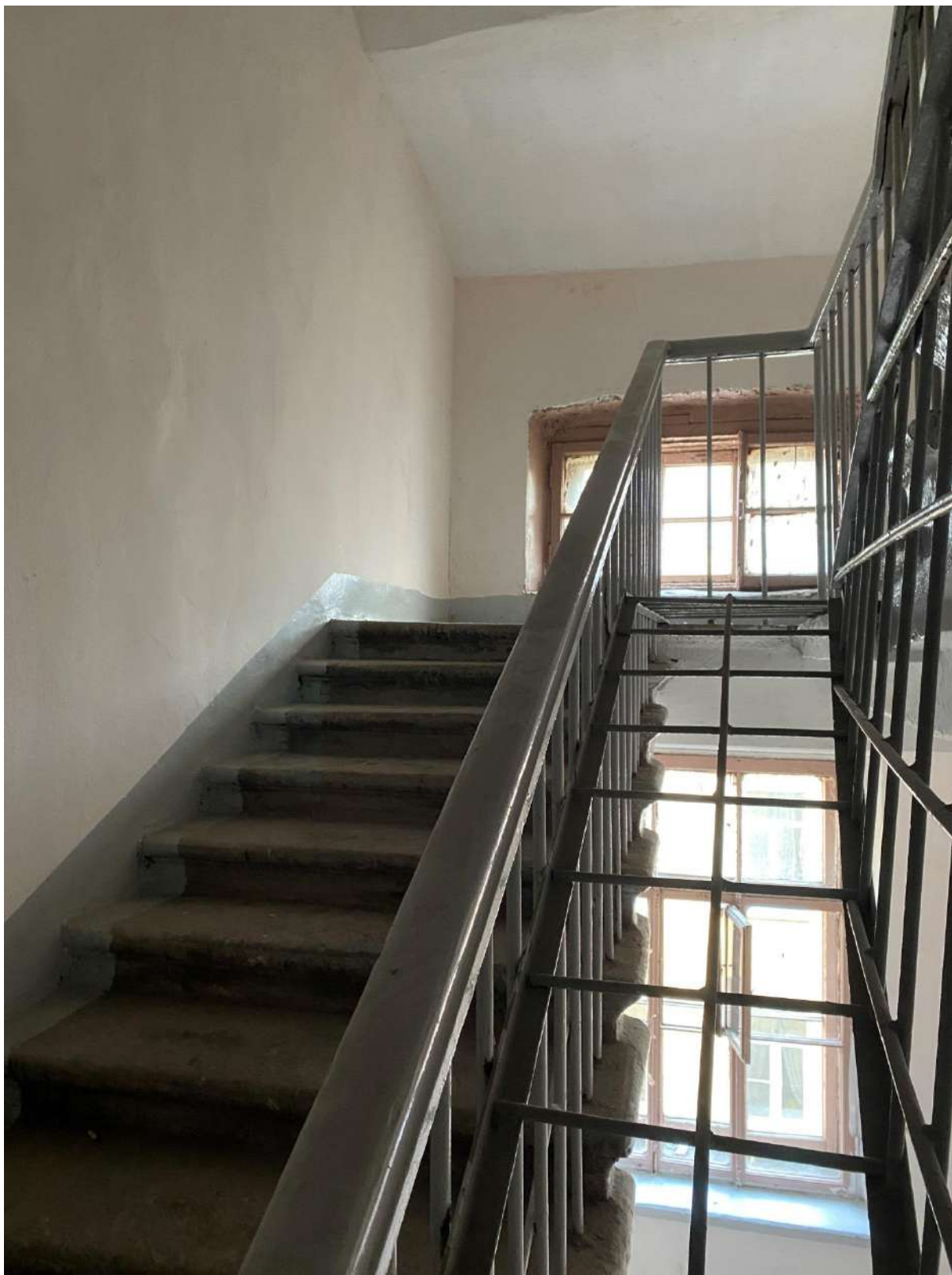
95. Общий вид лестницы БЛК в уровне 5-го этажа
