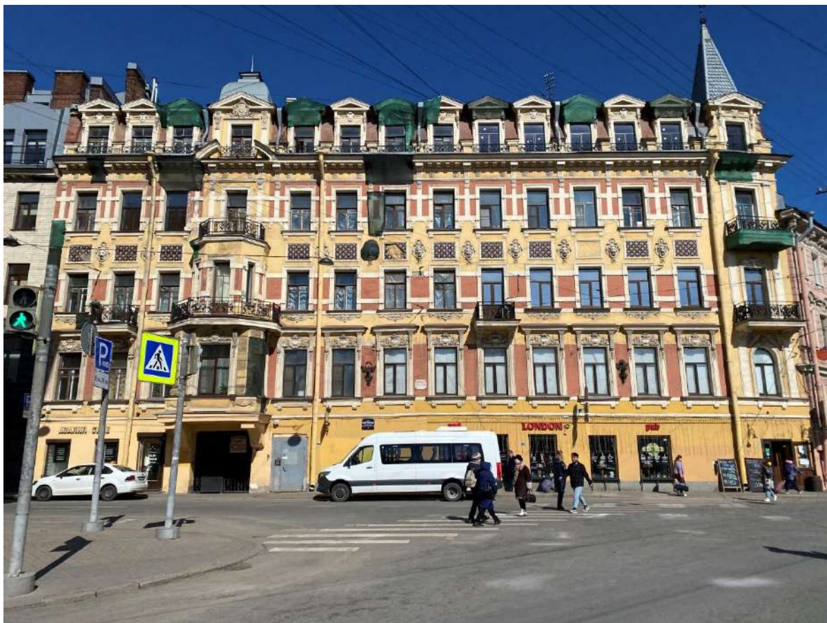
1. Общий вид лицевого фасада по проспекту Римского-Корсакова
