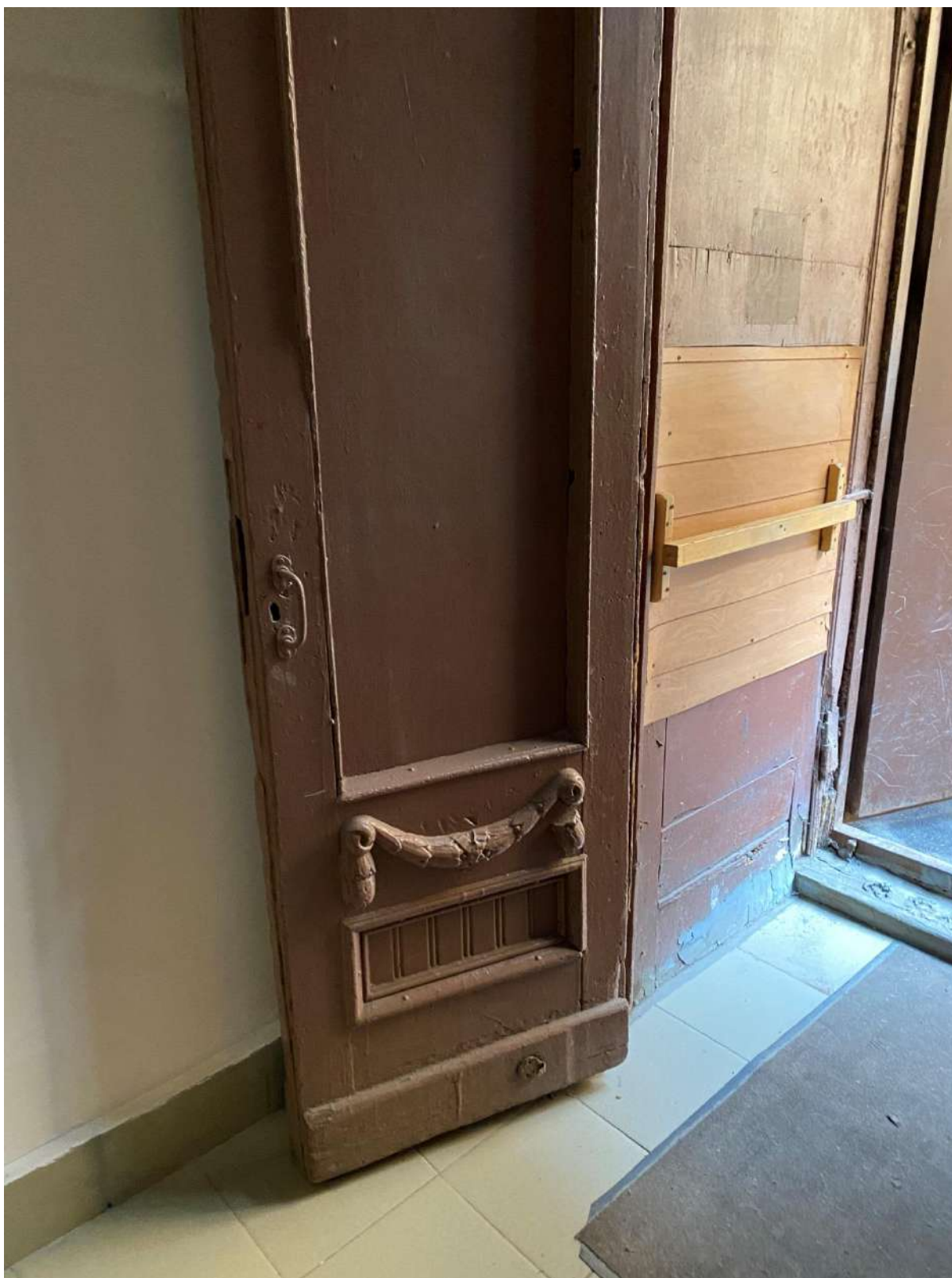
51. Фрагмент дверного заполнения тамбура лестницы 4ЛК
