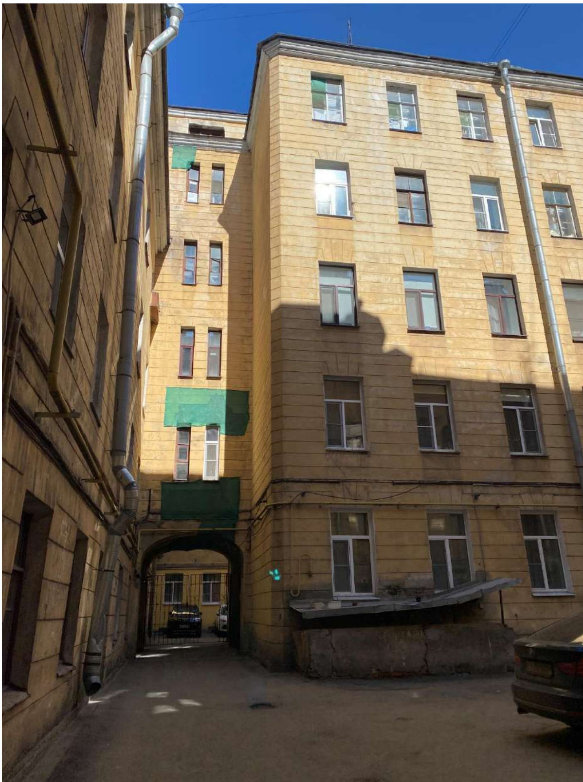
8. Фрагмент дворовых фасадов объекта культурного наследия
