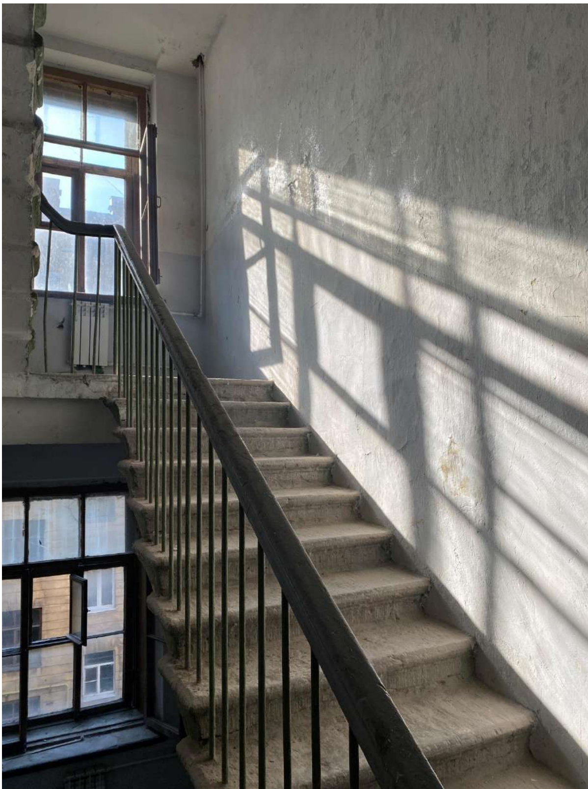
43. Общий вид лестницы ЗЛК в уровне 5-го этажа
