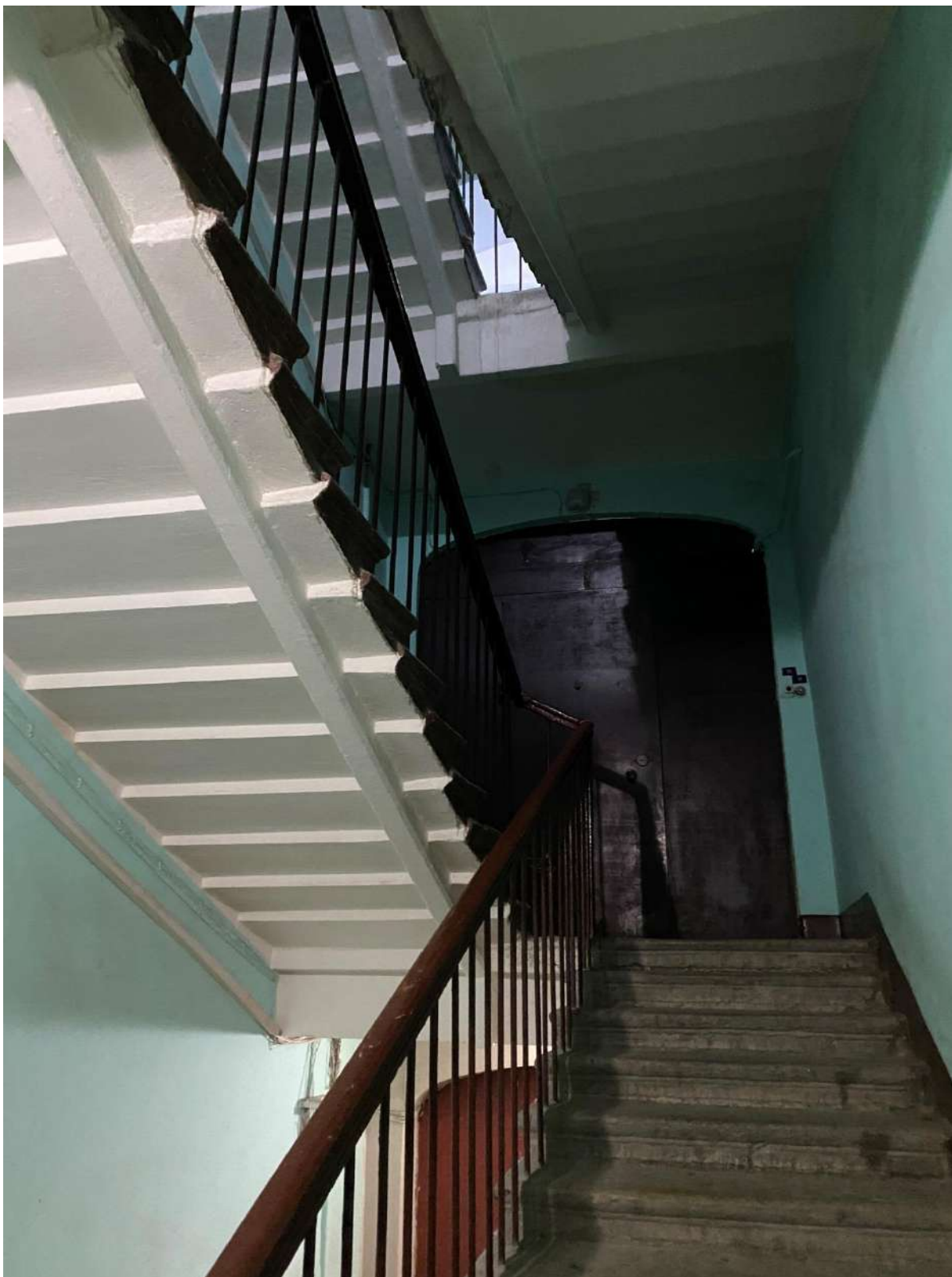
78. Общий вид лестницы 5ЛК в уровне 3-го этажа
