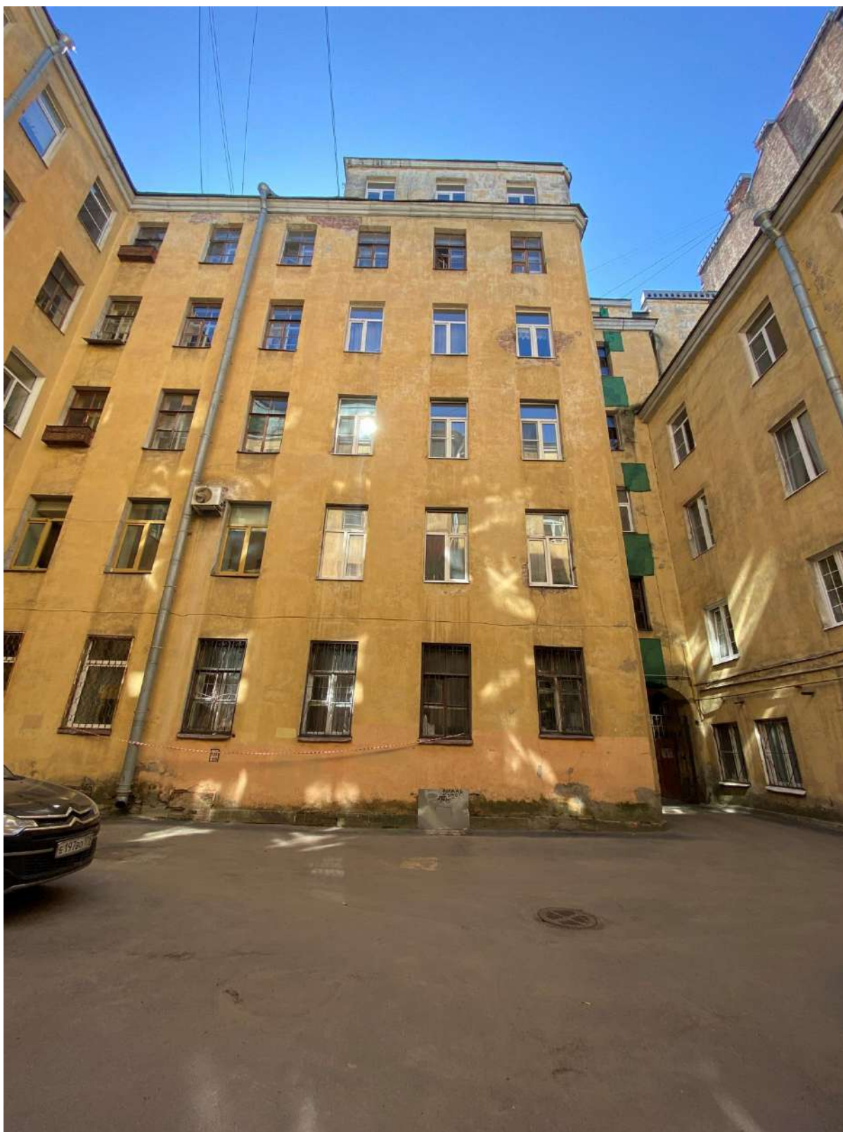
16. Фрагмент дворовых фасадов объекта культурного наследия
