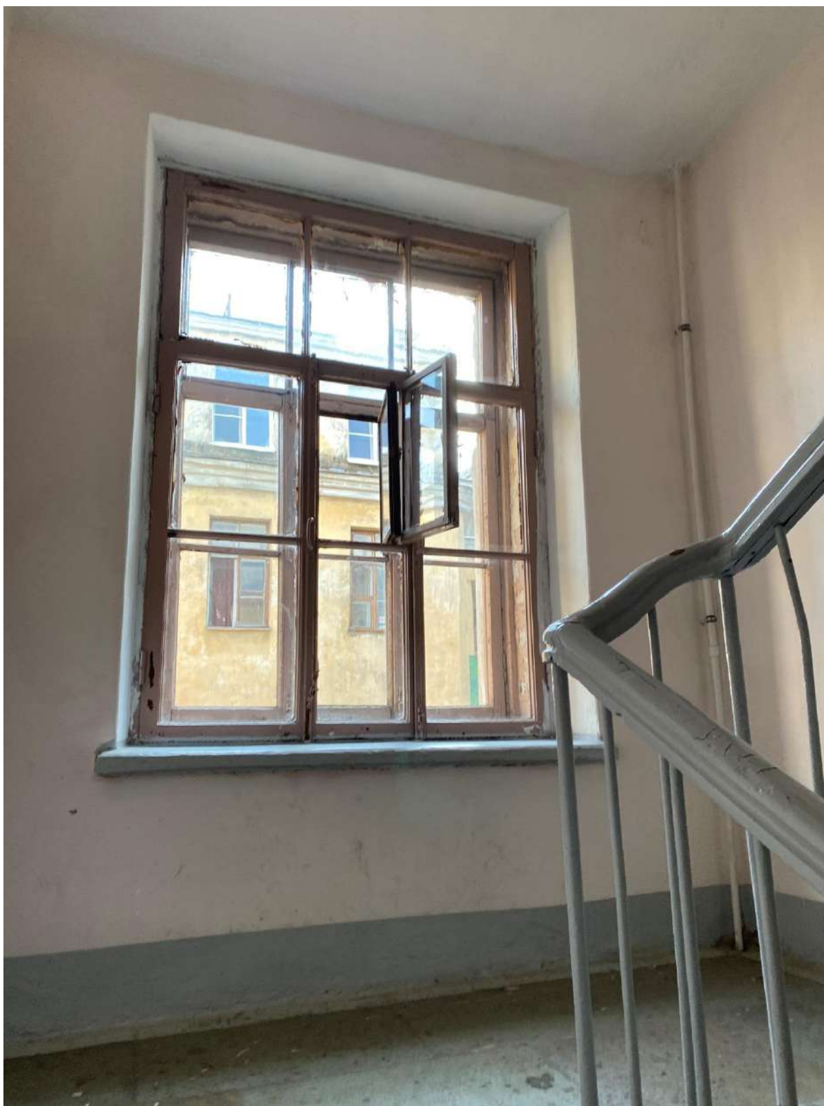
93. Оконное заполнение в части лестницы 6ЛК в уровне 4-го этажа
