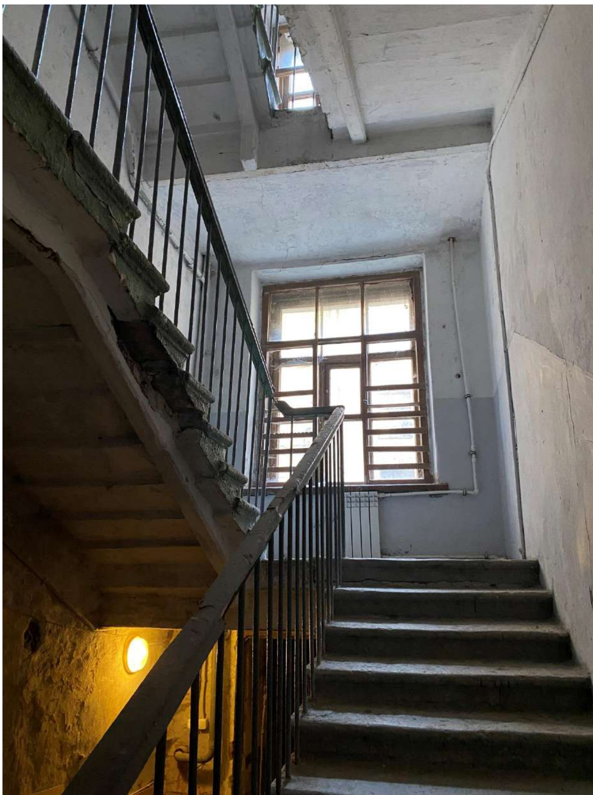
35. Общий вид лестницы ЗЛК в уровне 1-го этажа
