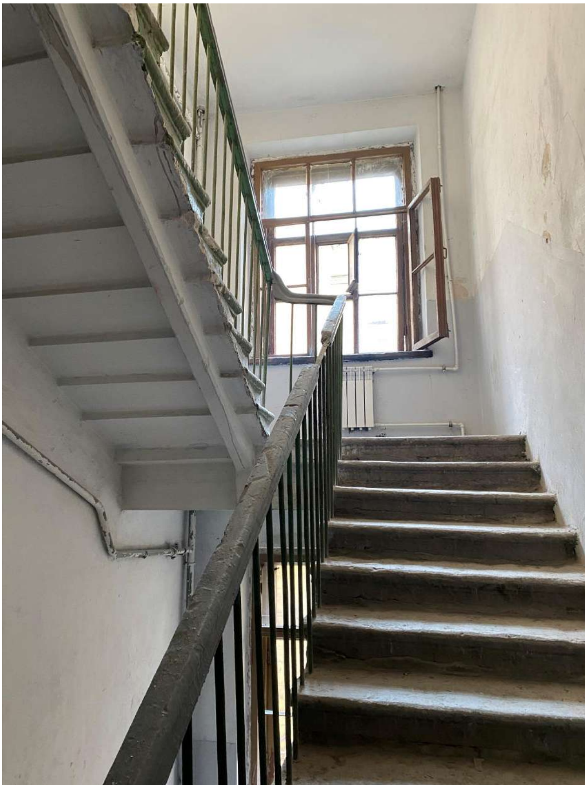
40. Общий вид лестницы ЗЛК в уровне 3-го этажа
