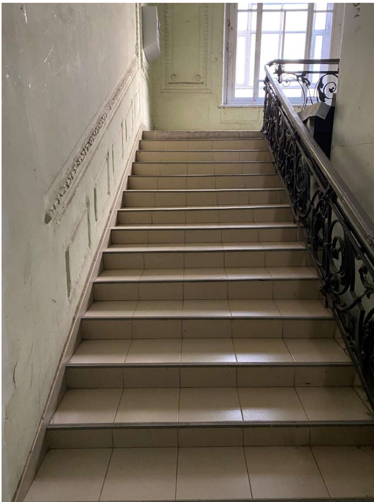
19. Фрагмент лестницы 1ЛК в уровне 1-го этажа
