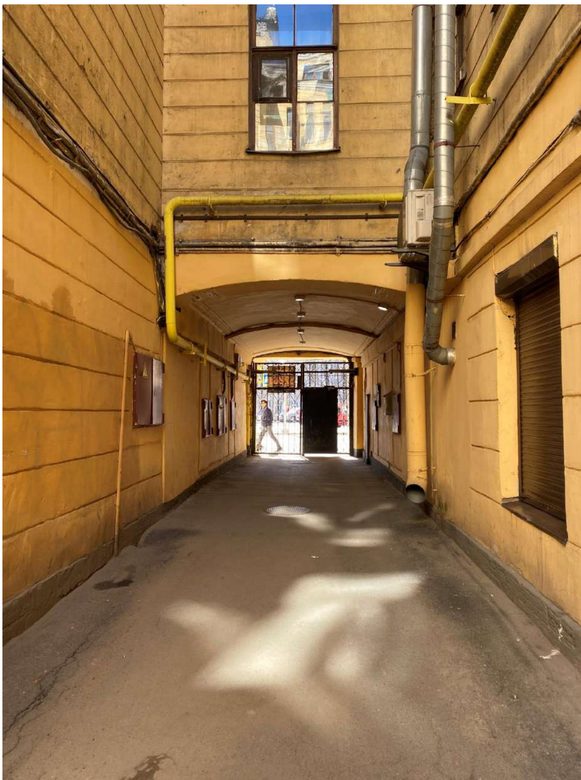
7. Фрагмент дворовых фасадов объекта культурного наследия
