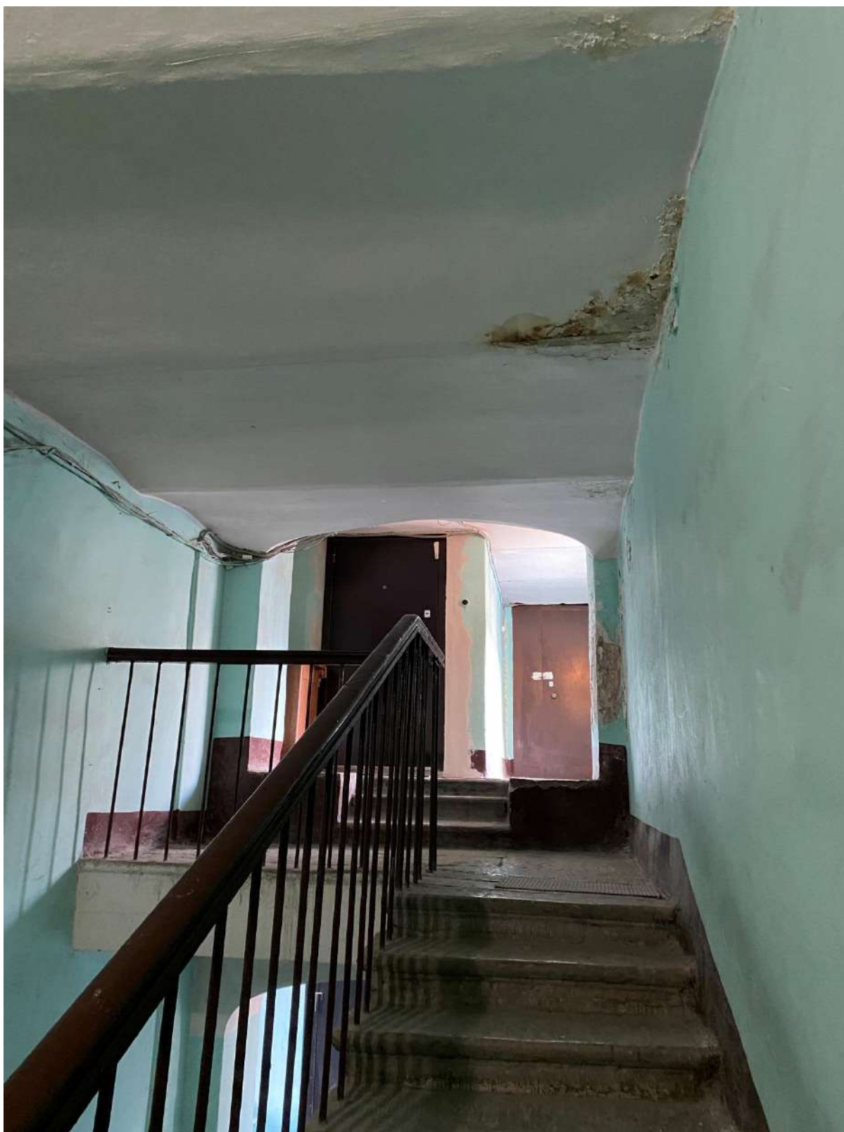
84.Перекрытие лестницы 5ЛК в уровне 5-го этажа
