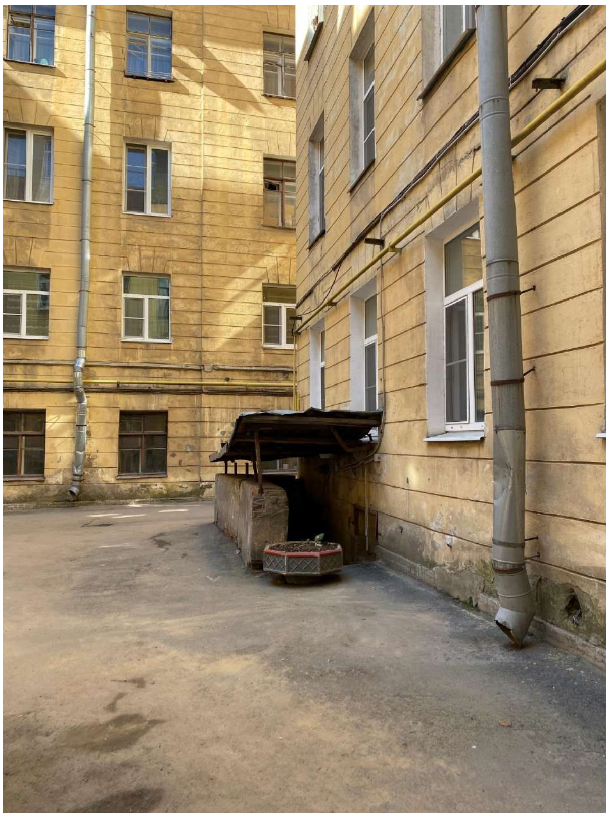
12. Фрагмент дворовых фасадов объекта культурного наследия
