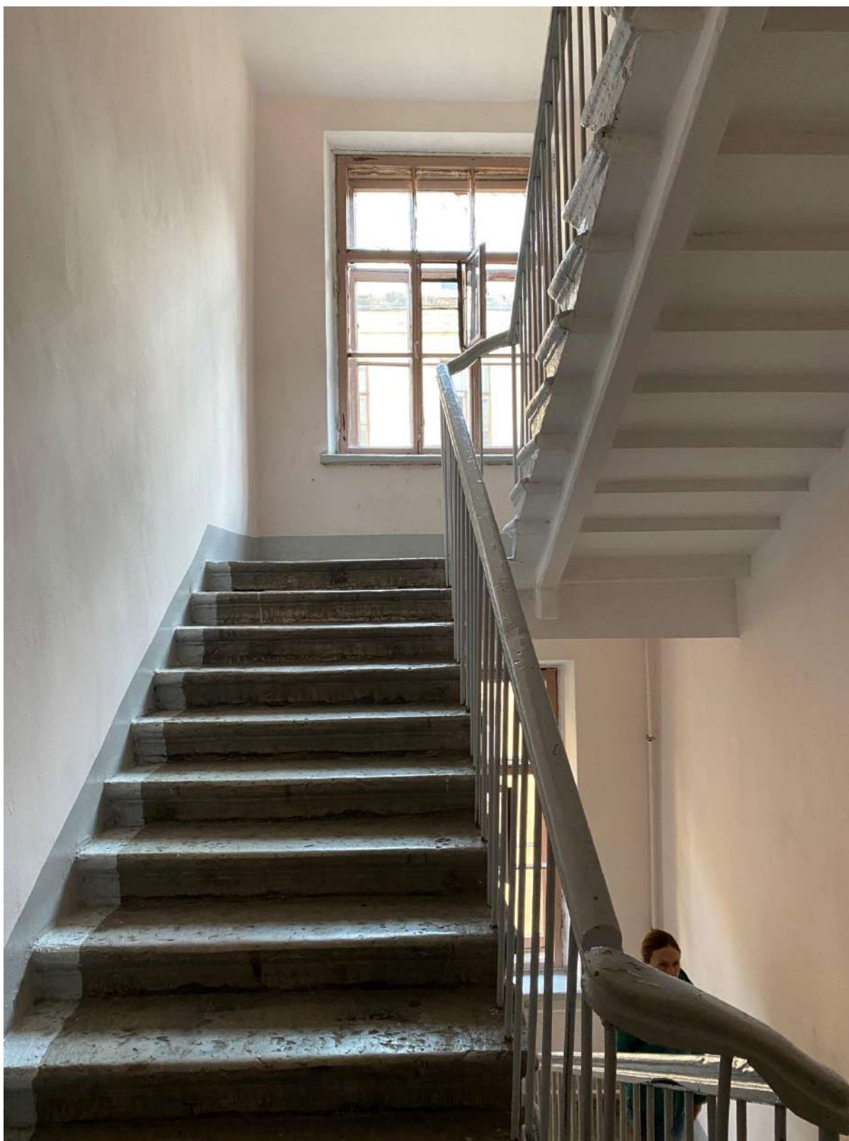
92. Общий вид лестницы БЛК в уровне 4-го этажа
