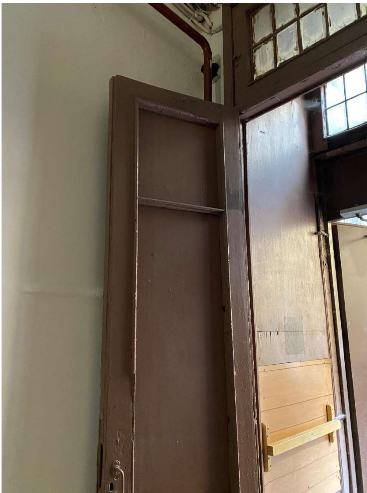
52. Фрагмент дверного заполнения тамбура лестницы 4ЛК
