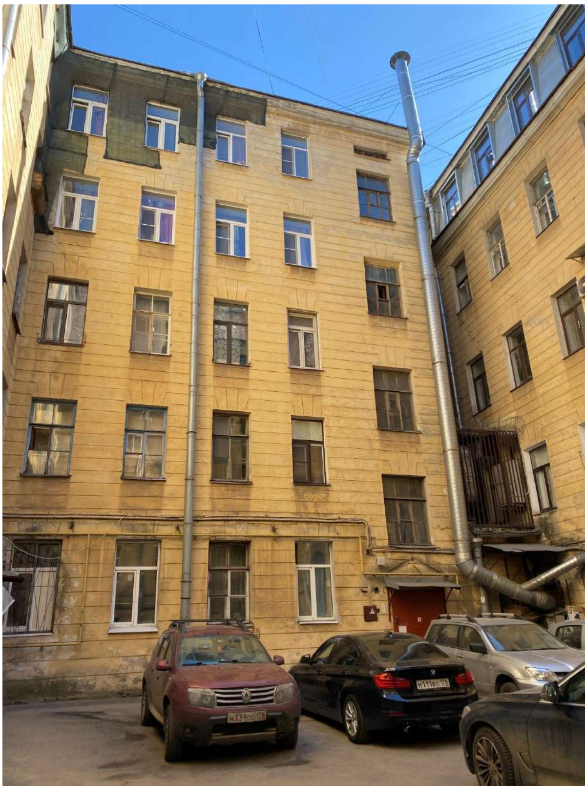
10. Фрагмент дворовых фасадов объекта культурного наследия
