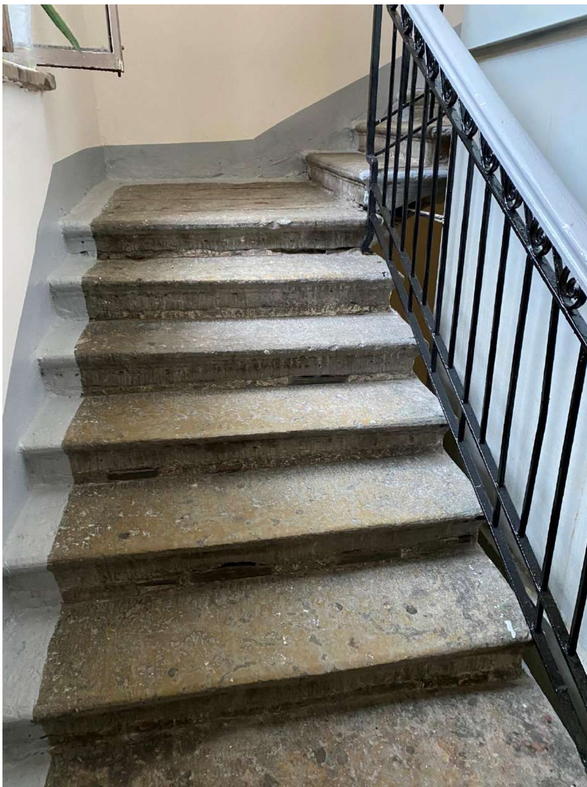
63. Общий вид лестницы 4ЛК в уровне 4-го этажа
