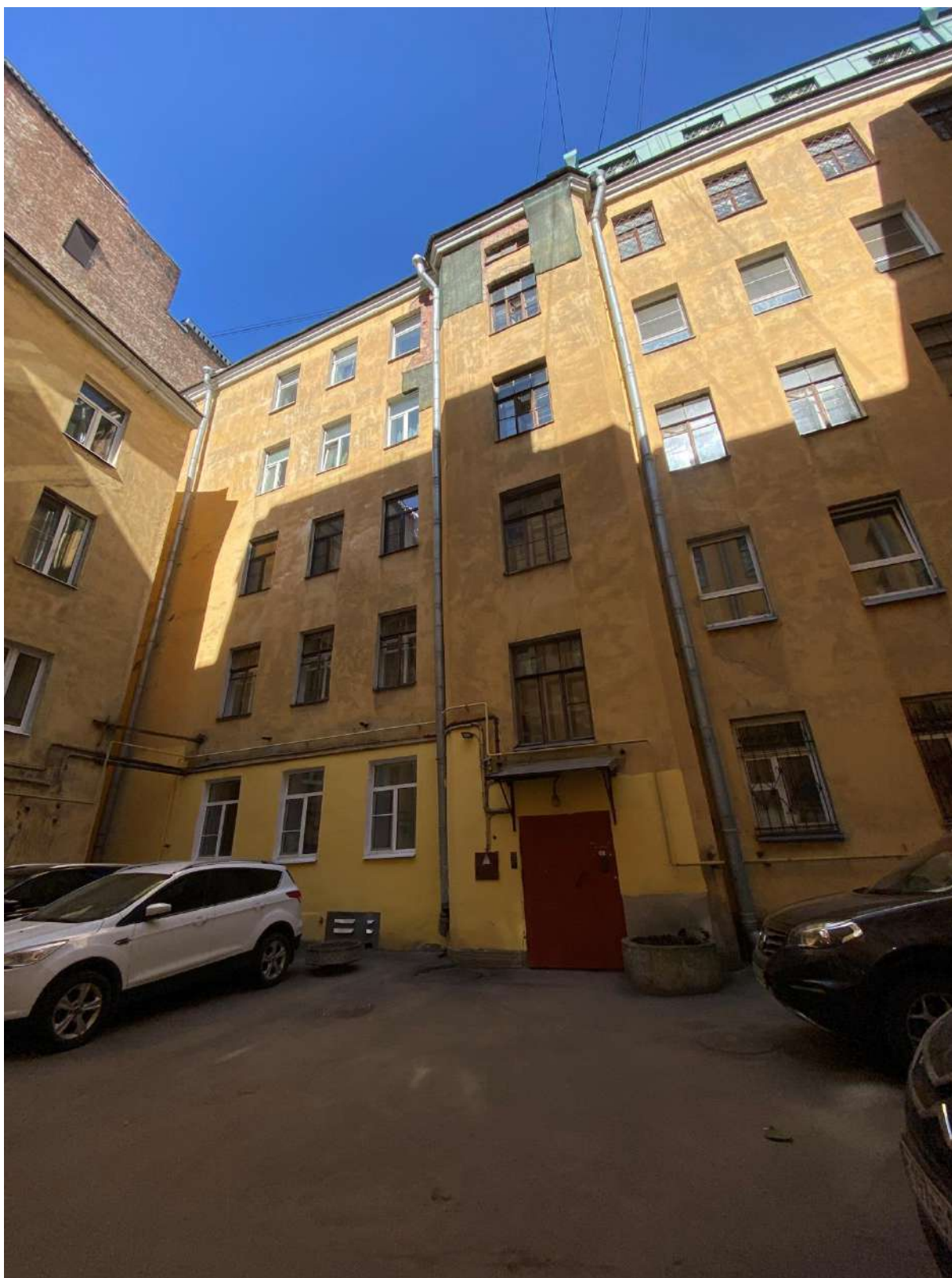
15. Фрагмент дворовых фасадов объекта культурного наследия
