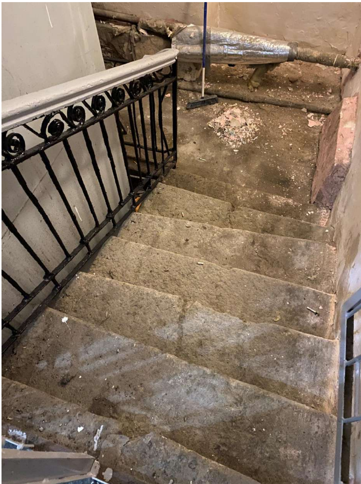
67. Площадка лестницы 4ЛК в уровне подвала
