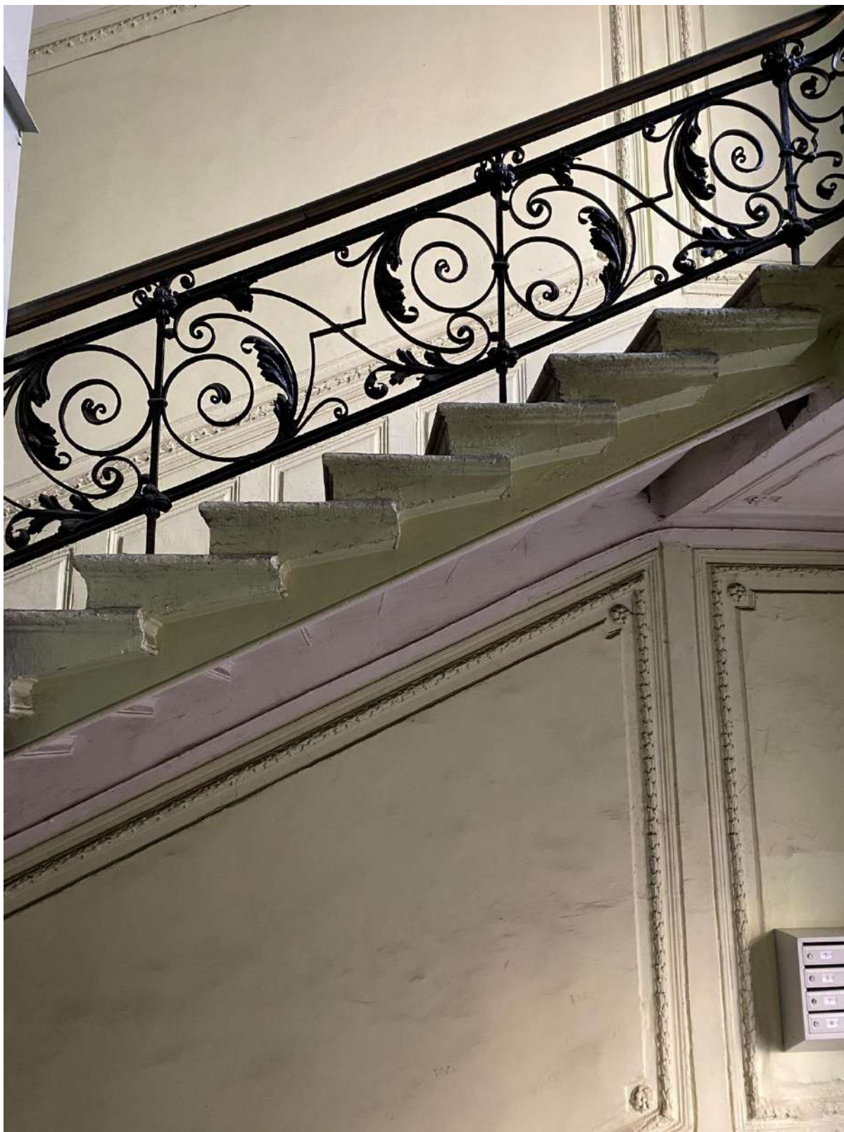
25. Ограждение лестницы 1ЛК в уровне 2-го этажа
