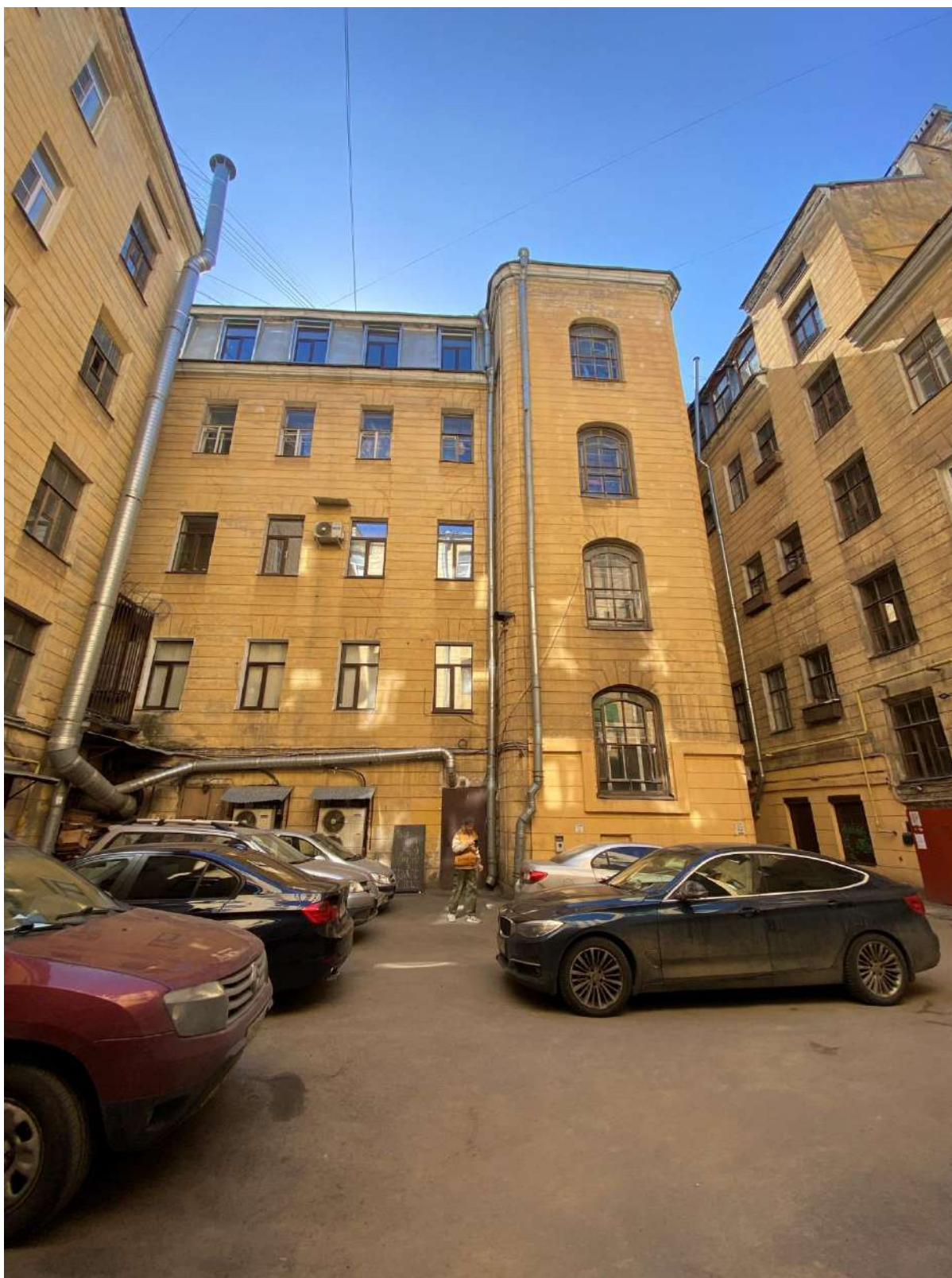
11. Фрагмент дворовых фасадов объекта культурного наследия
