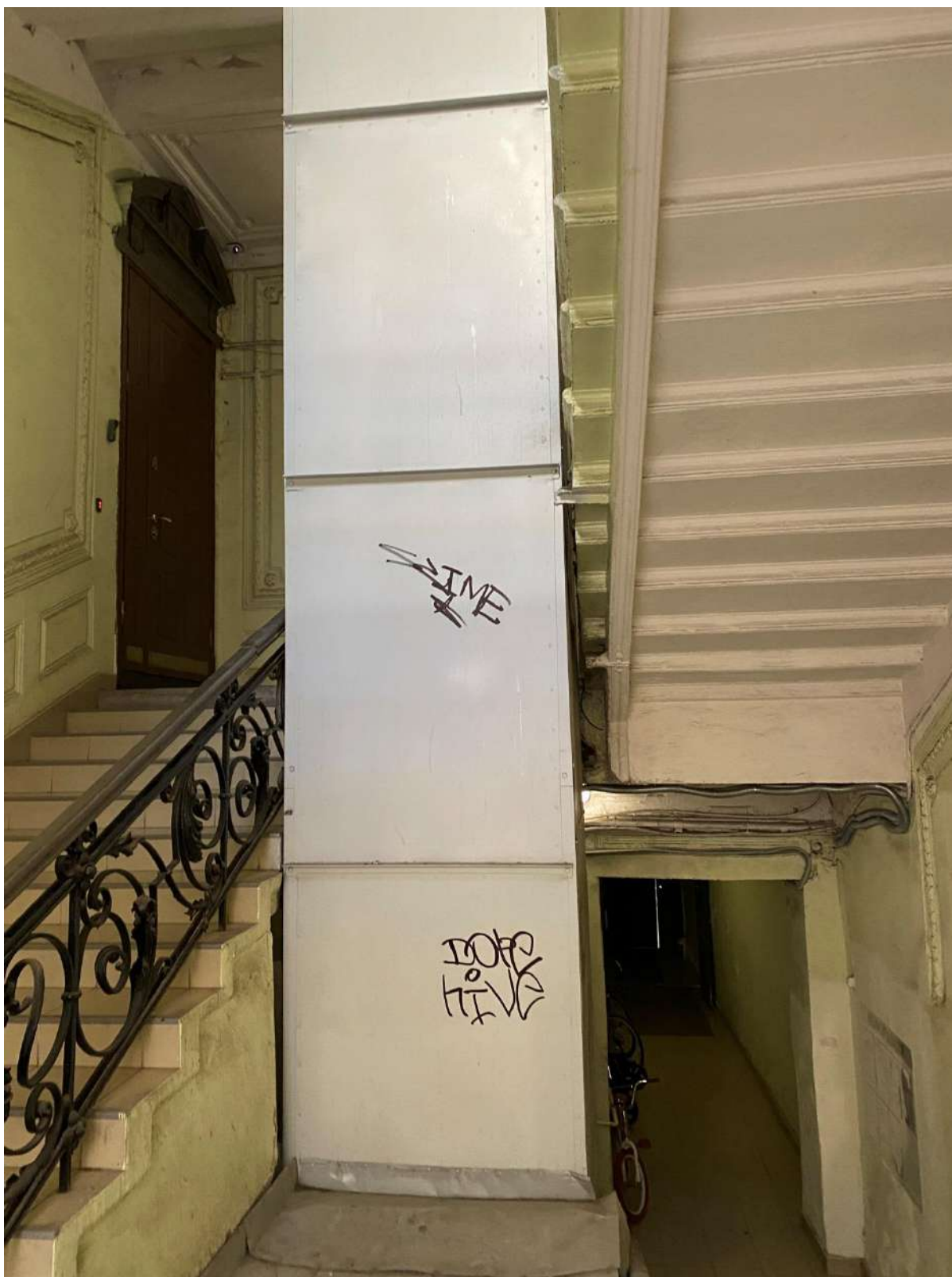
24. Общий вид лестницы 1ЛК в уровне 1-го этажа
