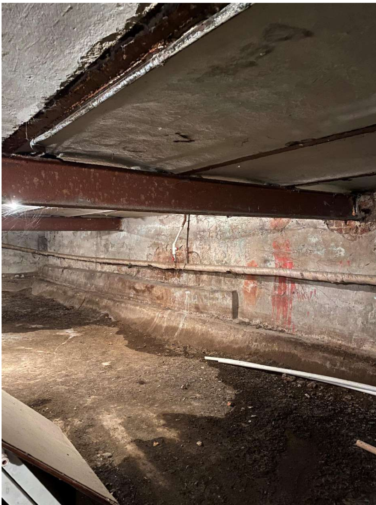
33.Общий вид подвального помещения
