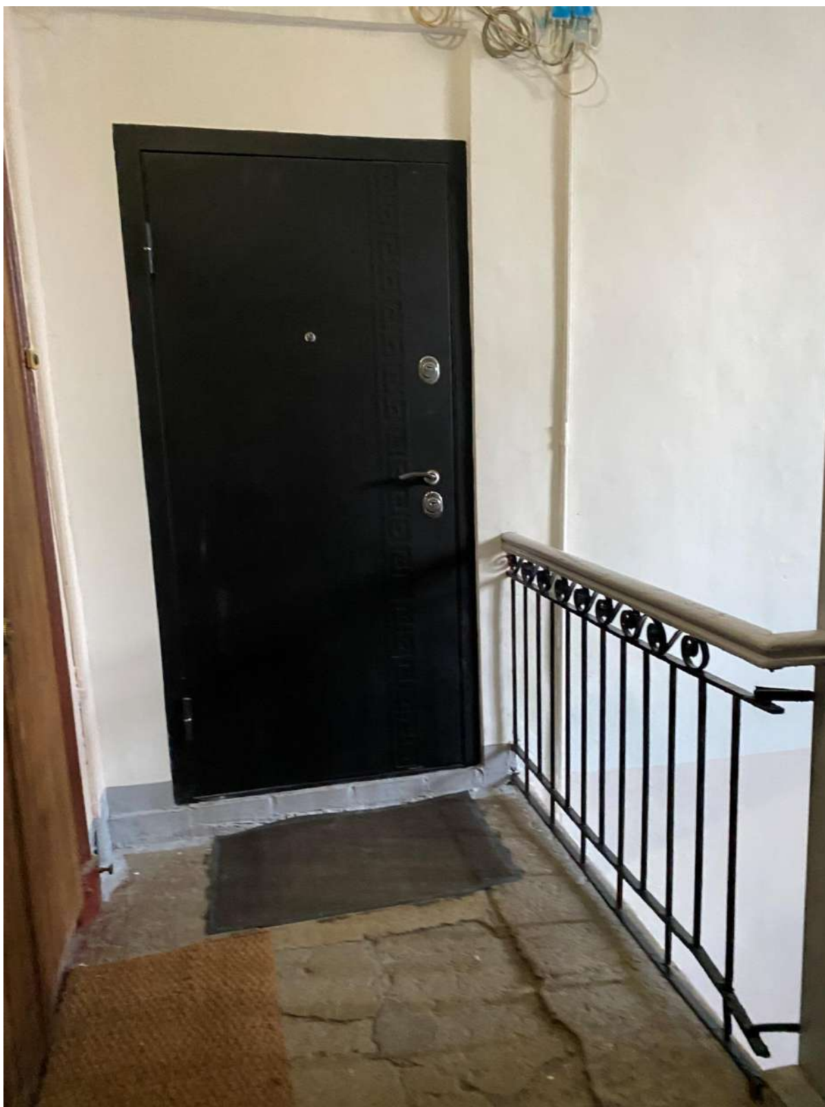
66. Площадка лестницы 4ЛК в уровне 5-го этажа
