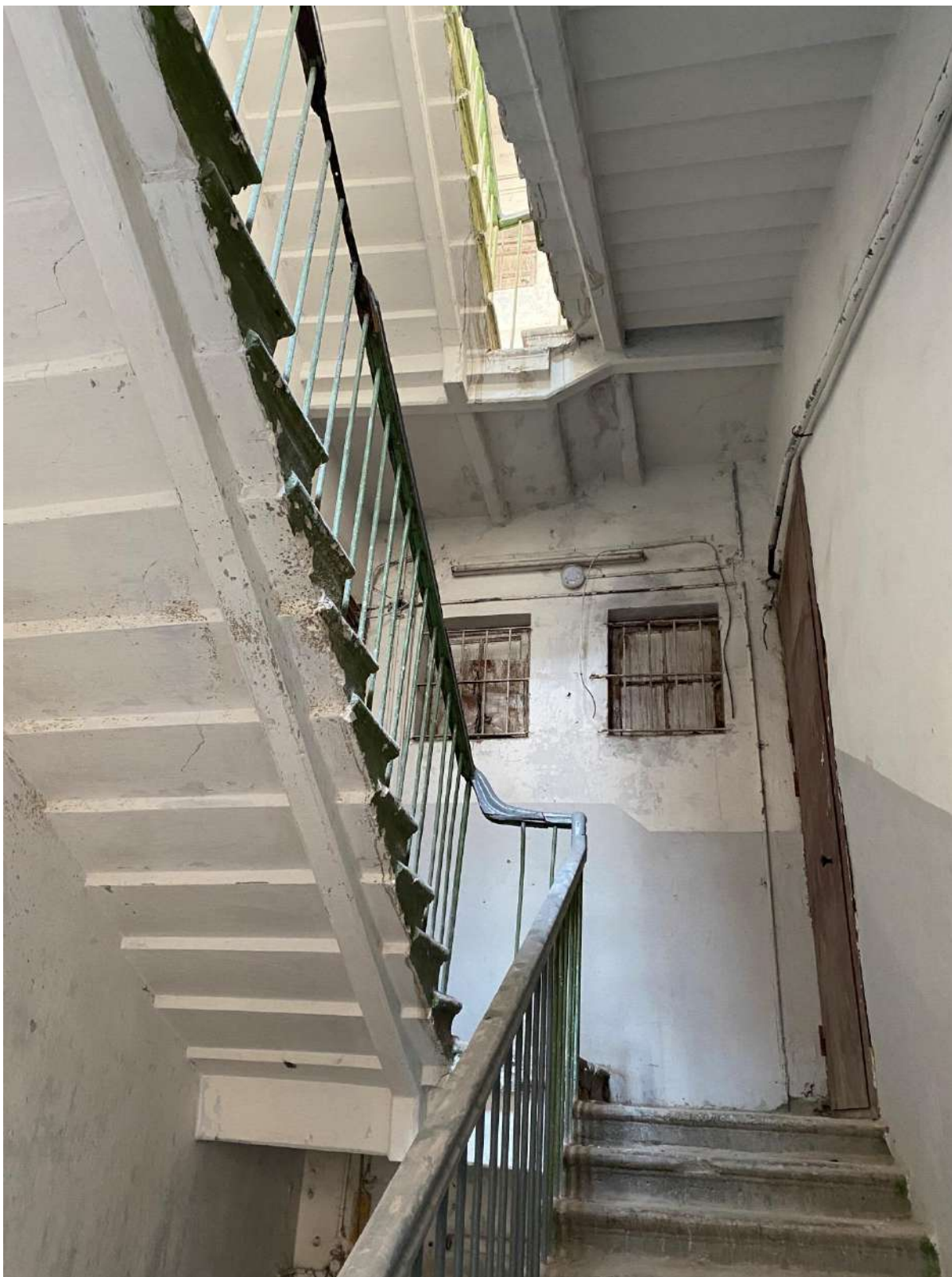
39.Общий вид лестницы ЗЛК в уровне 3-го этажа
