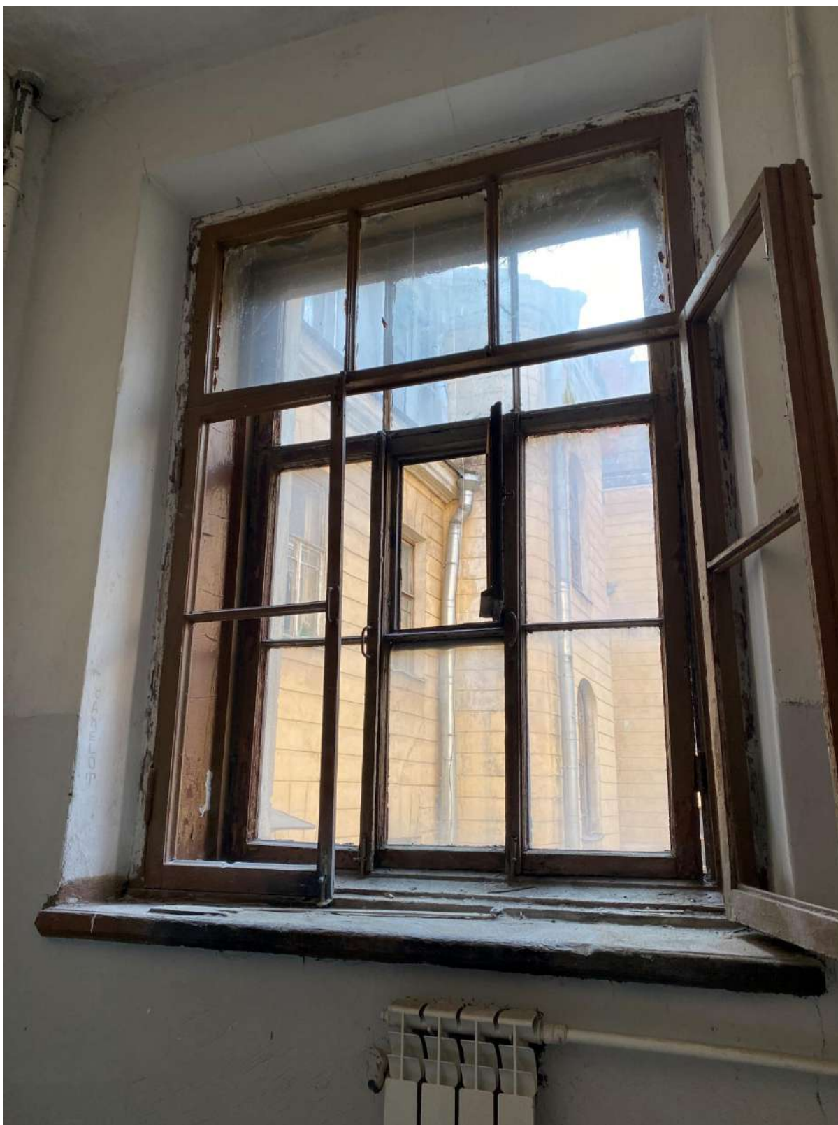
41. Оконное заполнение в части лестницы ЗЛК в уровне 4-го этажа
