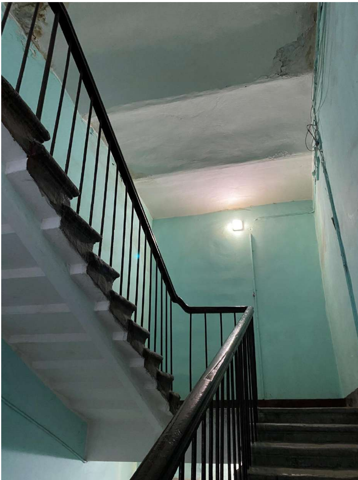
83. Перекрытие лестницы 5ЛК в уровне 5-го этажа
