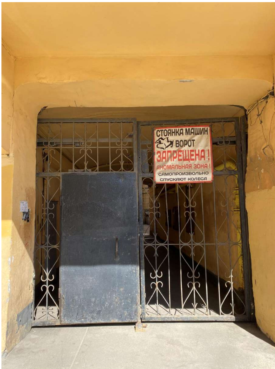
4. Воротное заполнение лицевого фасада по проспекту Римского-Корсакова
