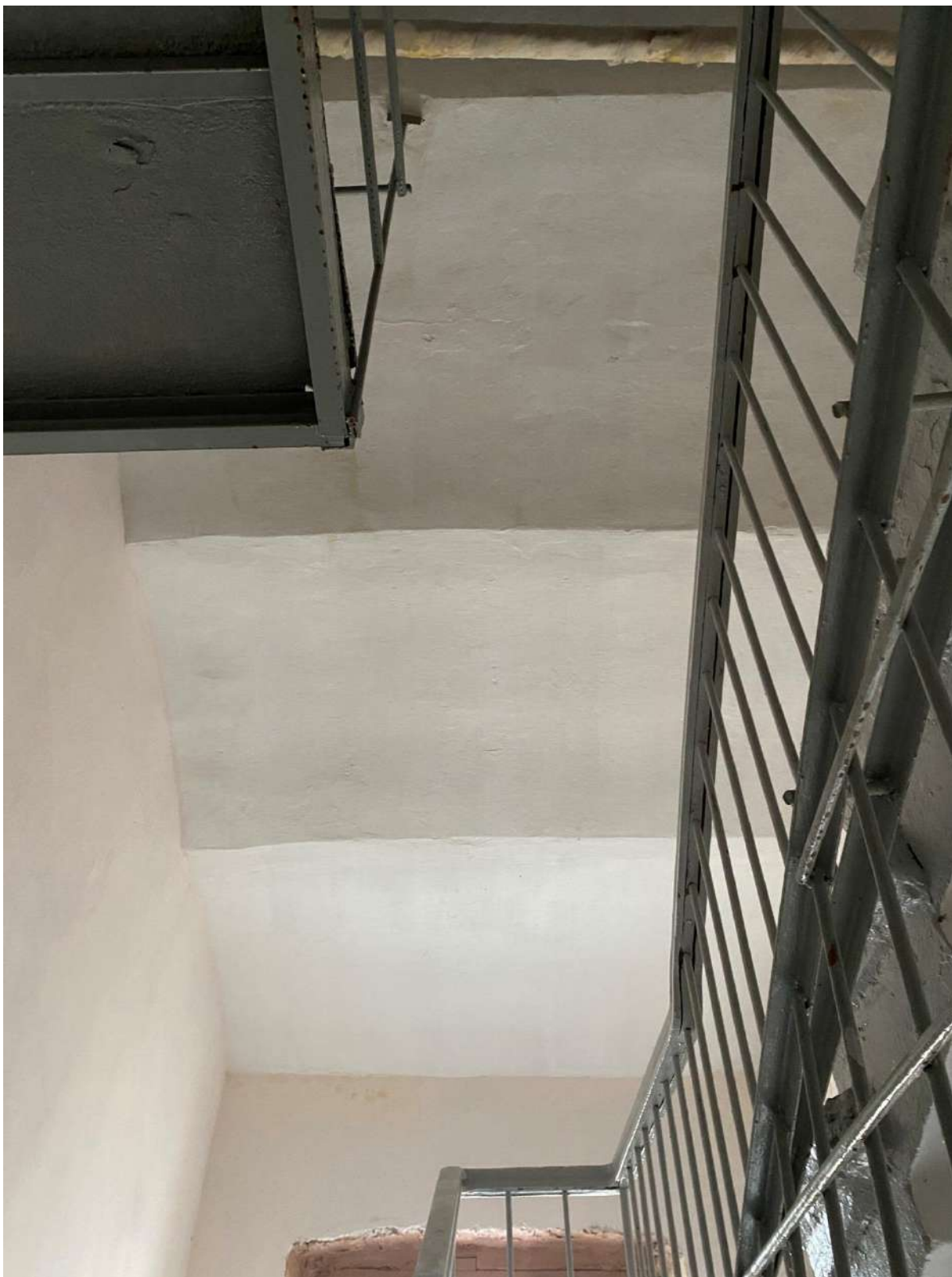
96. Перекрытие лестницы БЛК в уровне 5-го этажа
