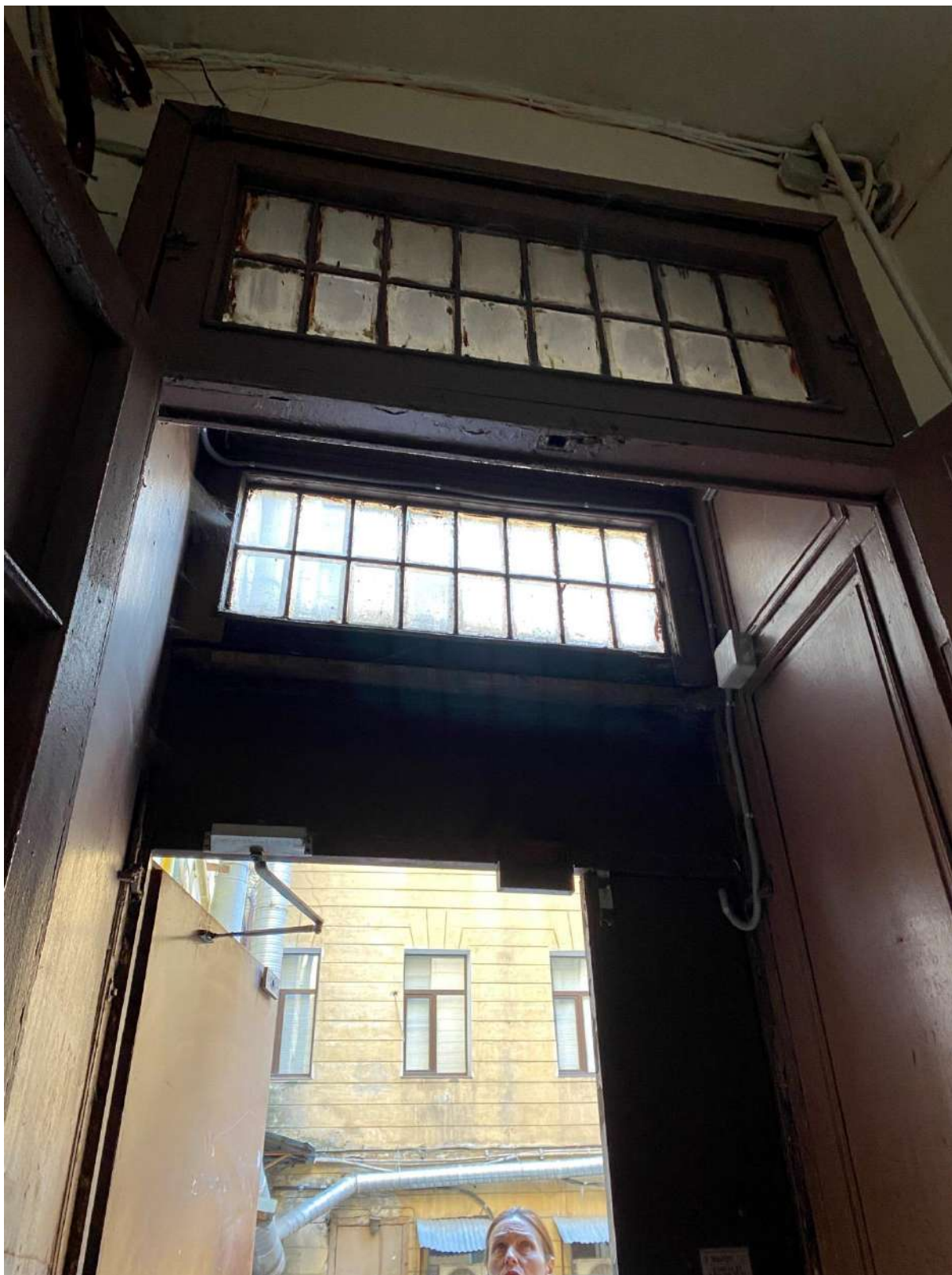
53. Фрагмент дверного заполнения тамбура лестницы 4ЛК
