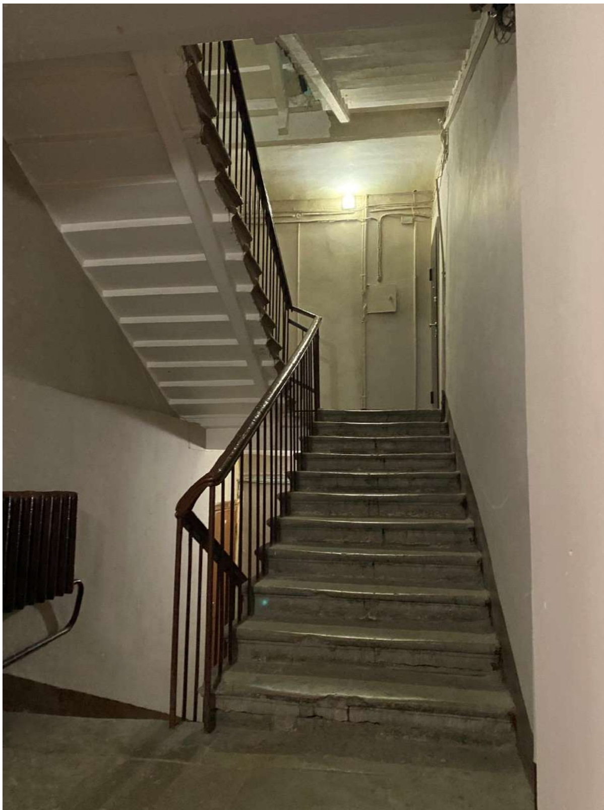
74. Общий вид лестницы 5ЛК в уровне 2-го этажа
