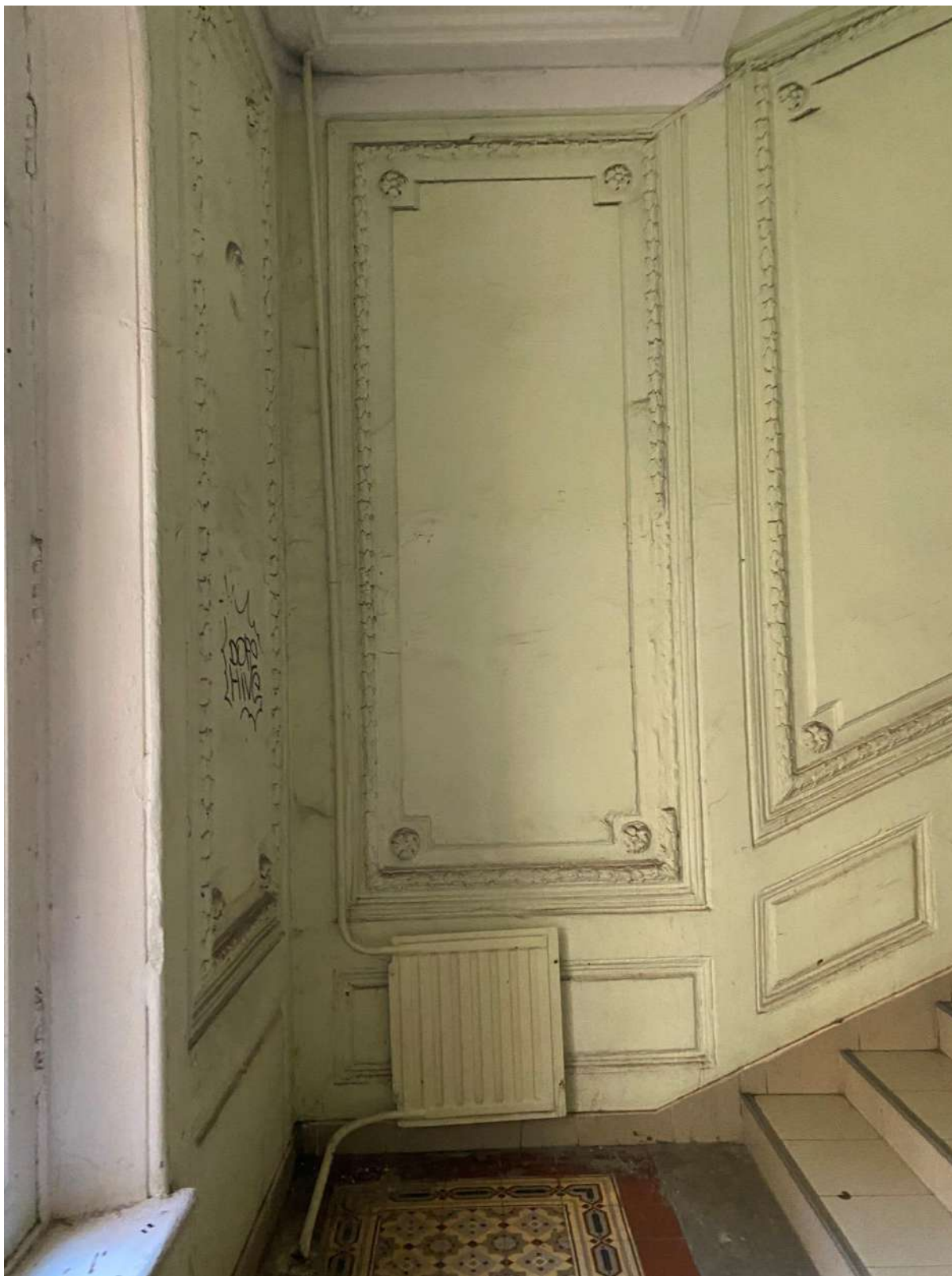
22.Общий вид лестницы 1ЛК в уровне 1-го этажа
