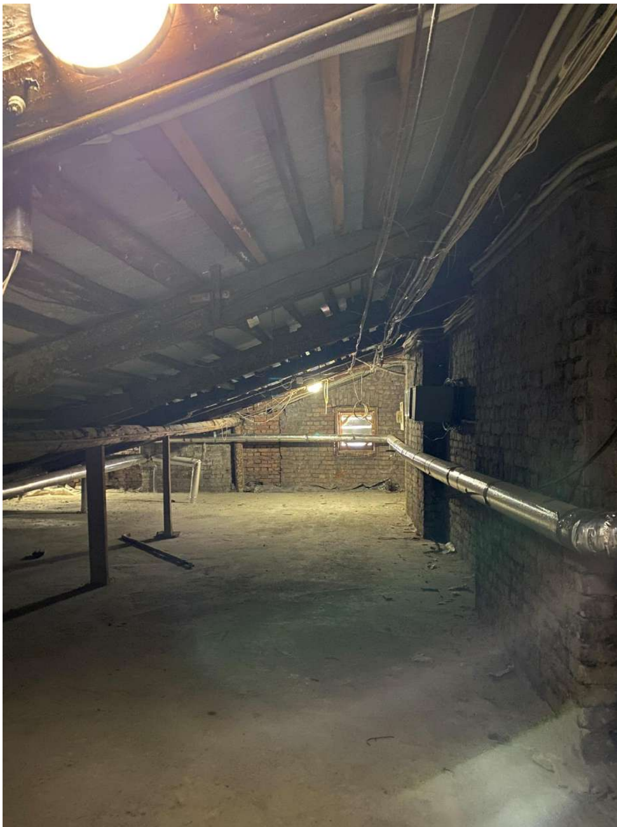
47. Общий вид чердачного помещения
