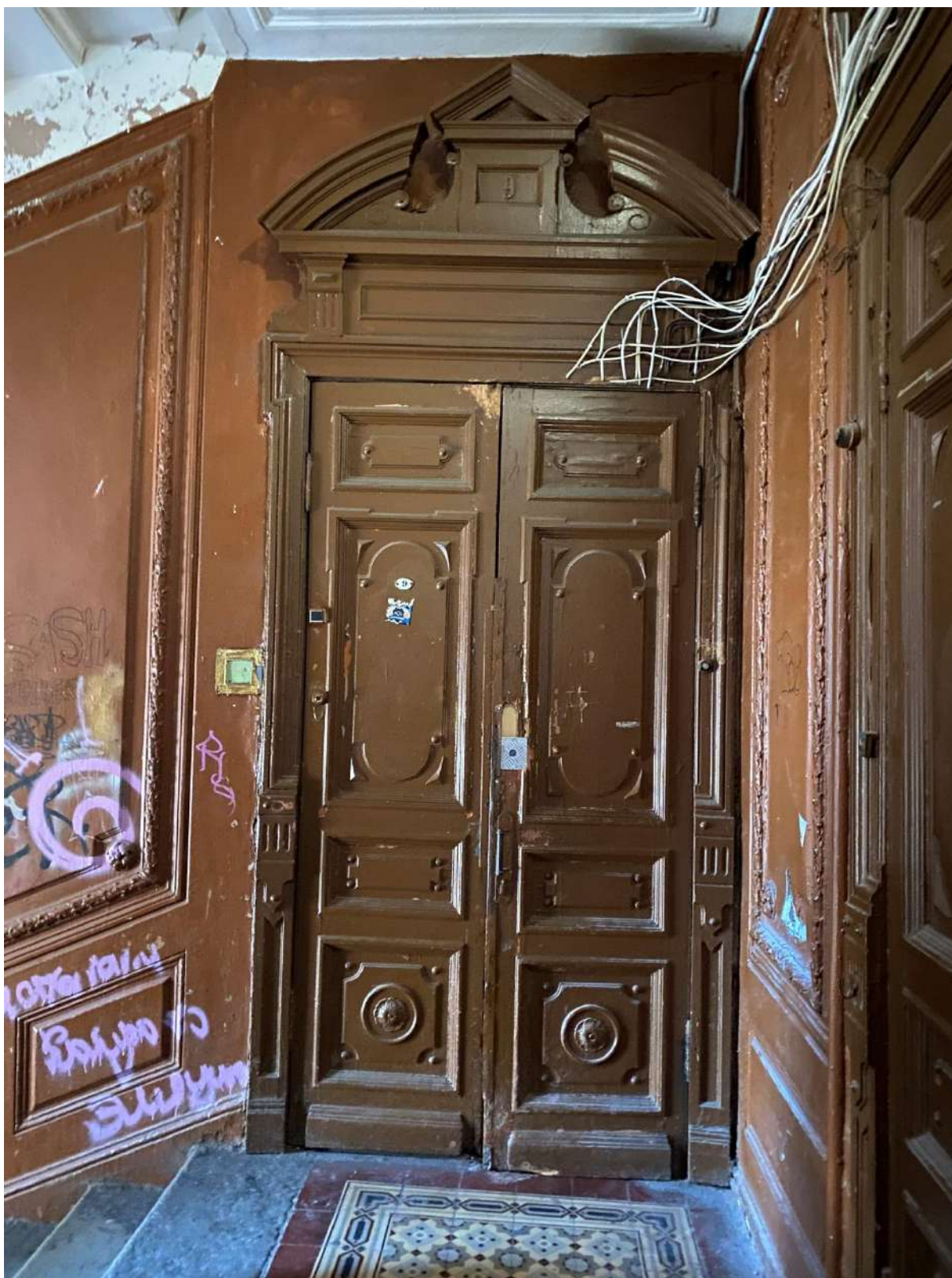
30. Общий вид дверного заполнения в части лестницы 1ЛК в уровне 3-го этажа
