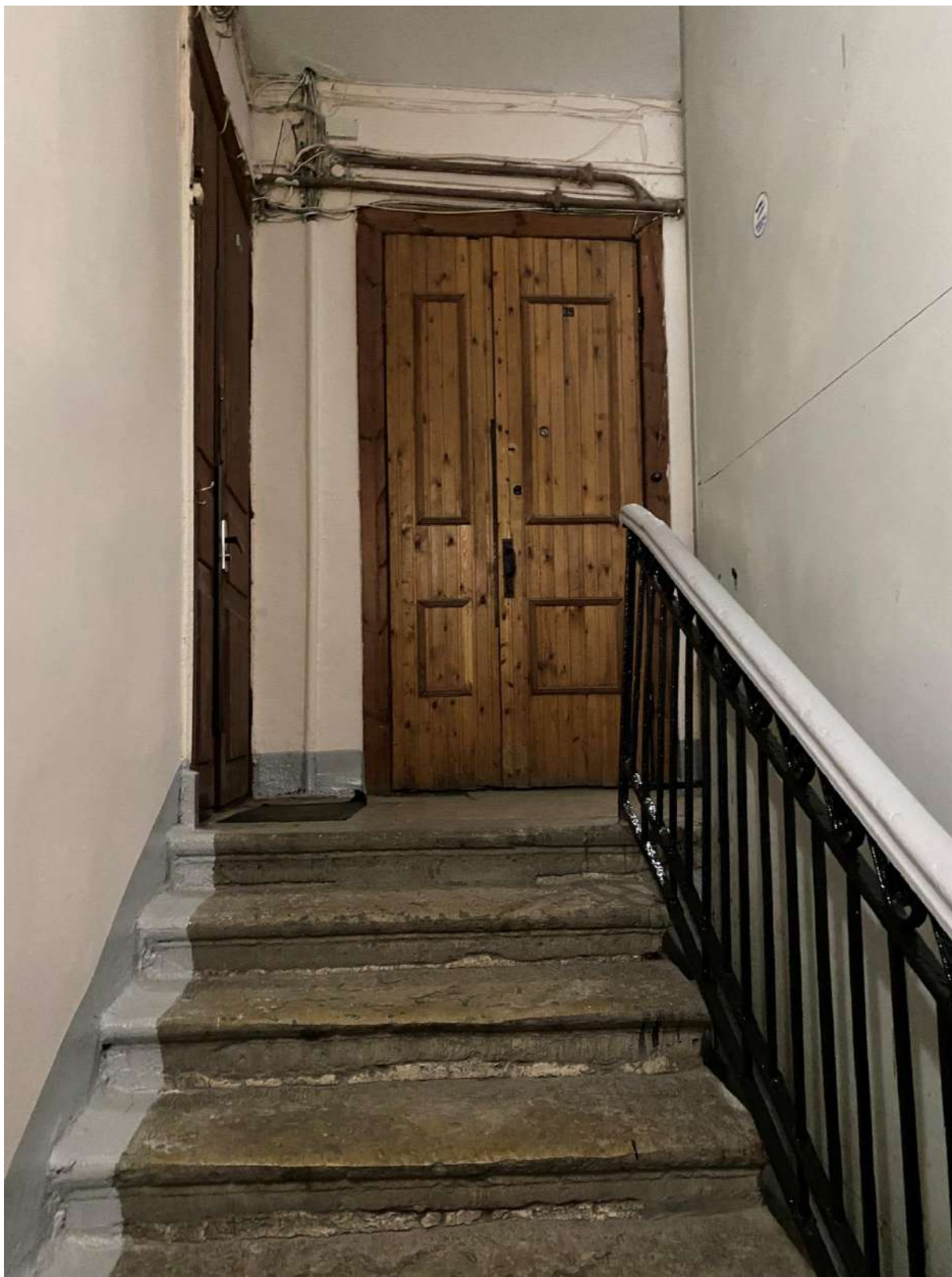
57. Общий вид лестницы 4ЛК в уровне 2-го этажа
