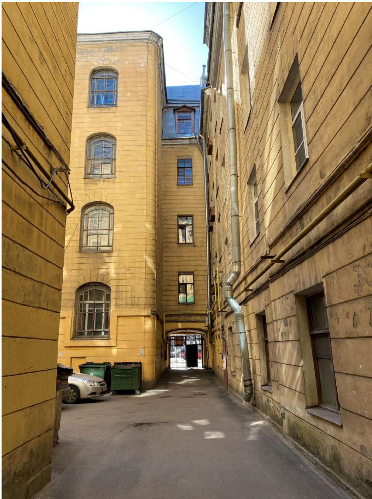
17. Фрагмент дворовых фасадов объекта культурного наследия
