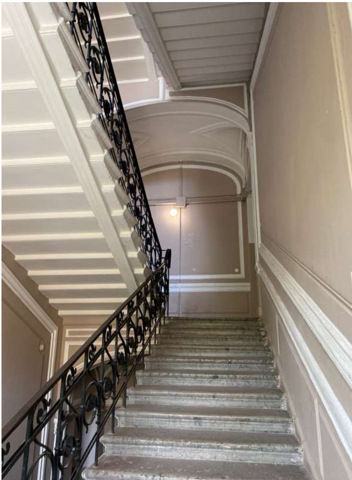
27. Лестница 2ЛК в уровне второго этажа
