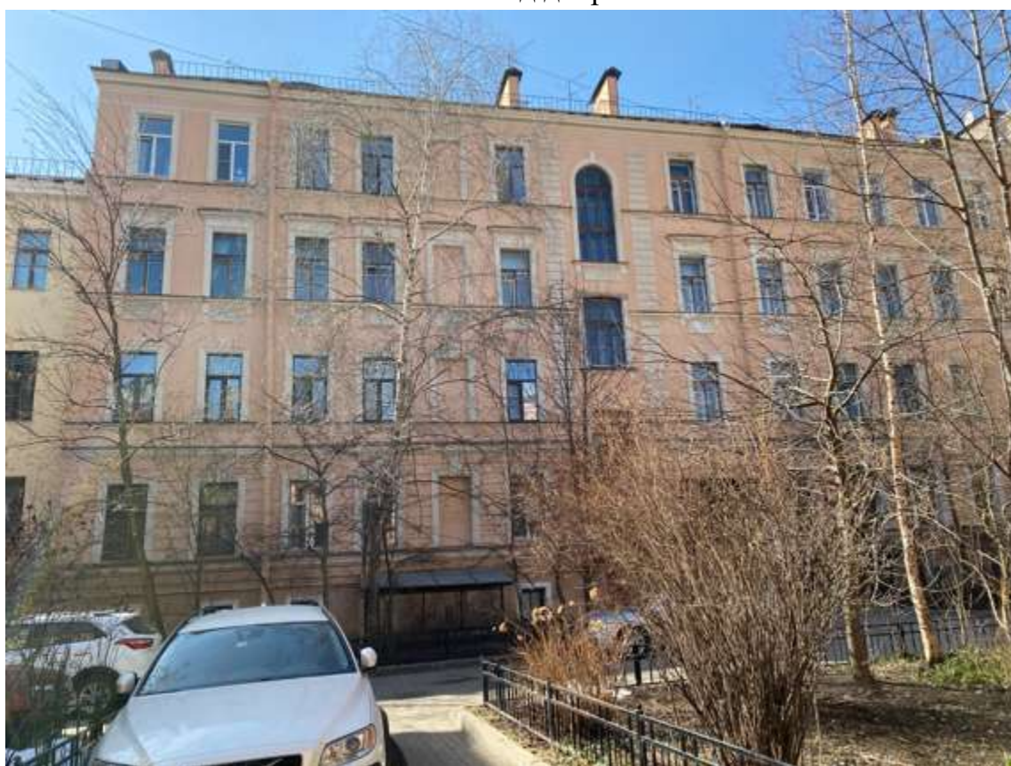
11. Фрагмент дворового фасада
