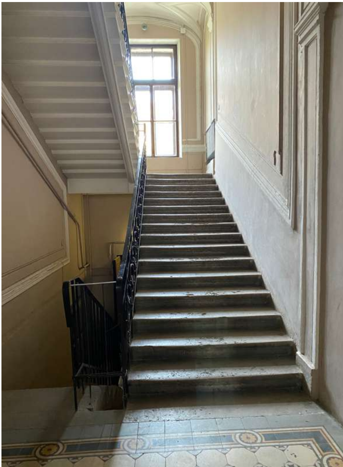
23. Лестница 2ЛК в уровне первого этажа
