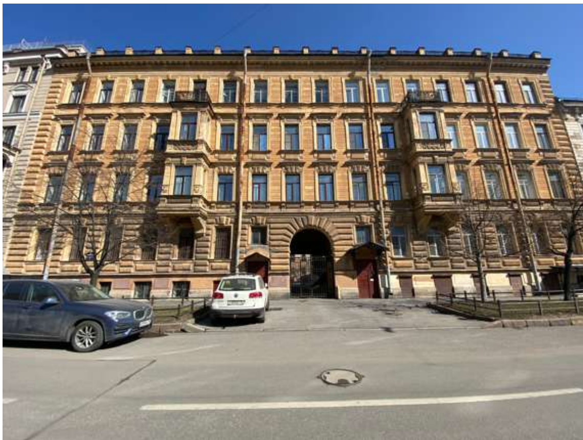
1. Лицевой фасад по 2-ой линии Васильевского острова
