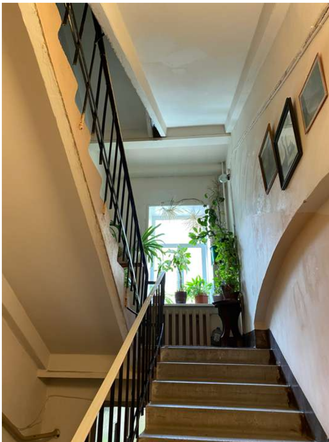
12. Лестница 2ЛК в уровне первого этажа
