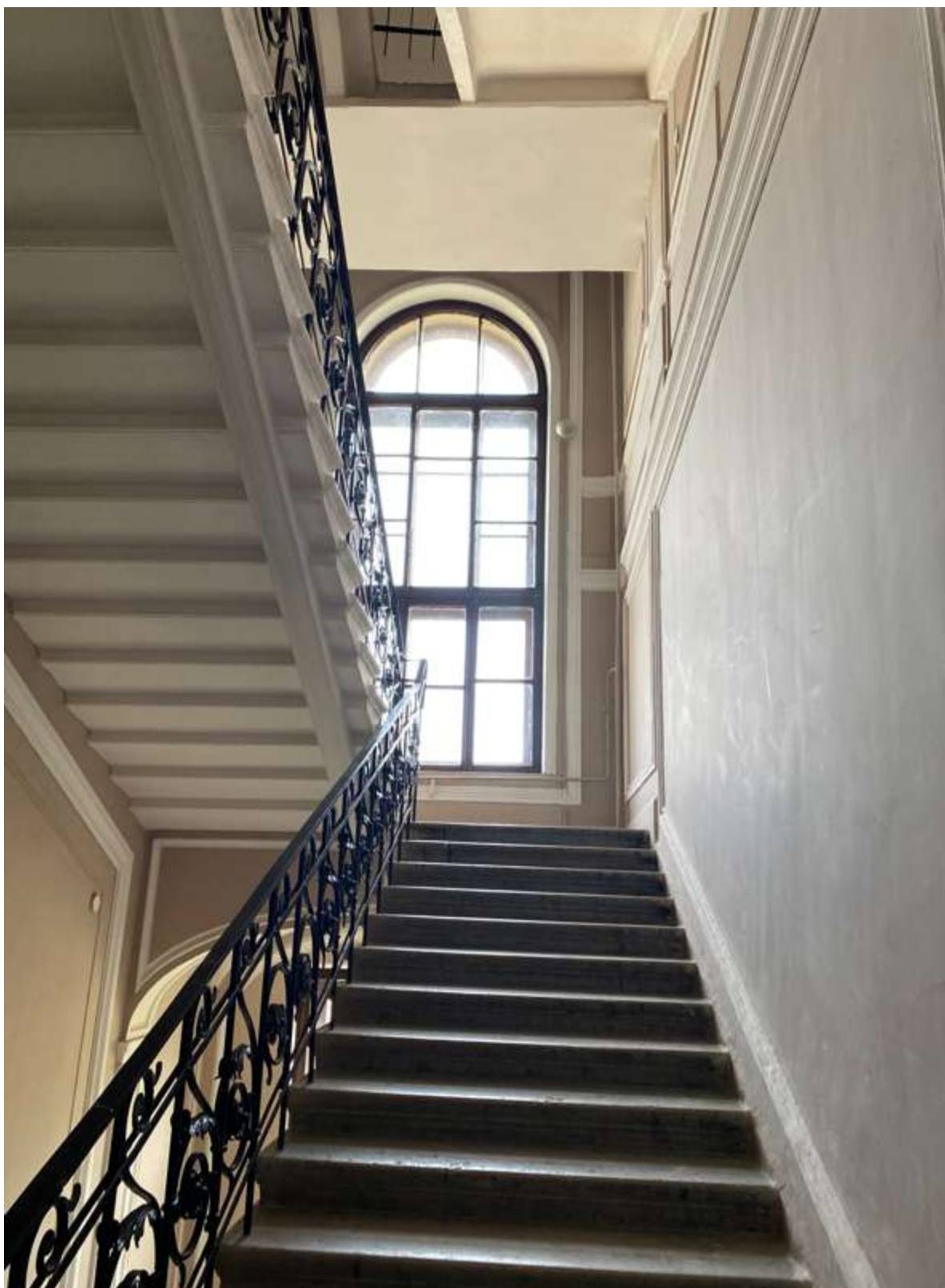
32. Лестница 2ЛК в уровне третьего этажа
