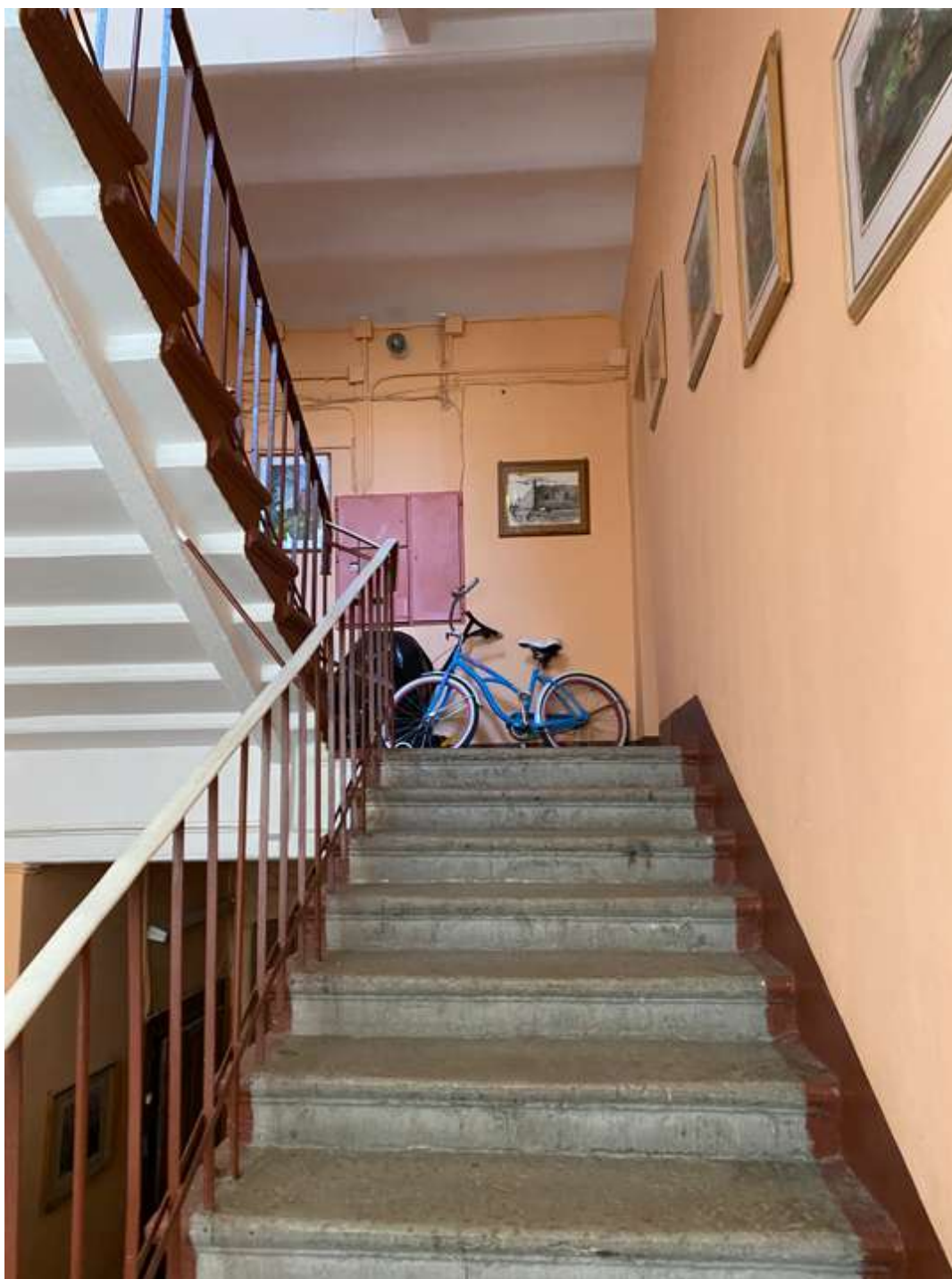
13. Лестница 1ЛК в уровне второго этажа
