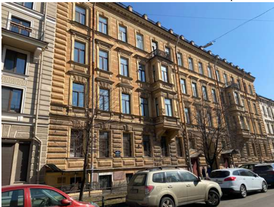
2. Лицевой фасад по 2-ой линии Васильевского острова
