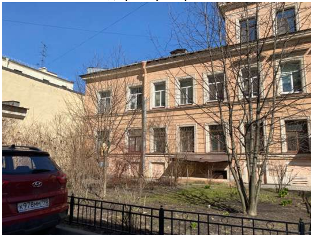
5. Фрагмент дворового фасада флигеля
