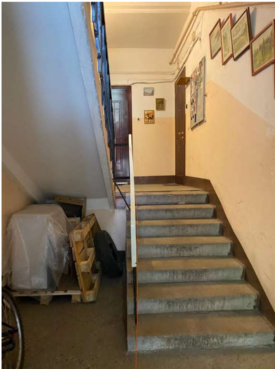
11. Лестница 2ЛК в уровне первого этажа
