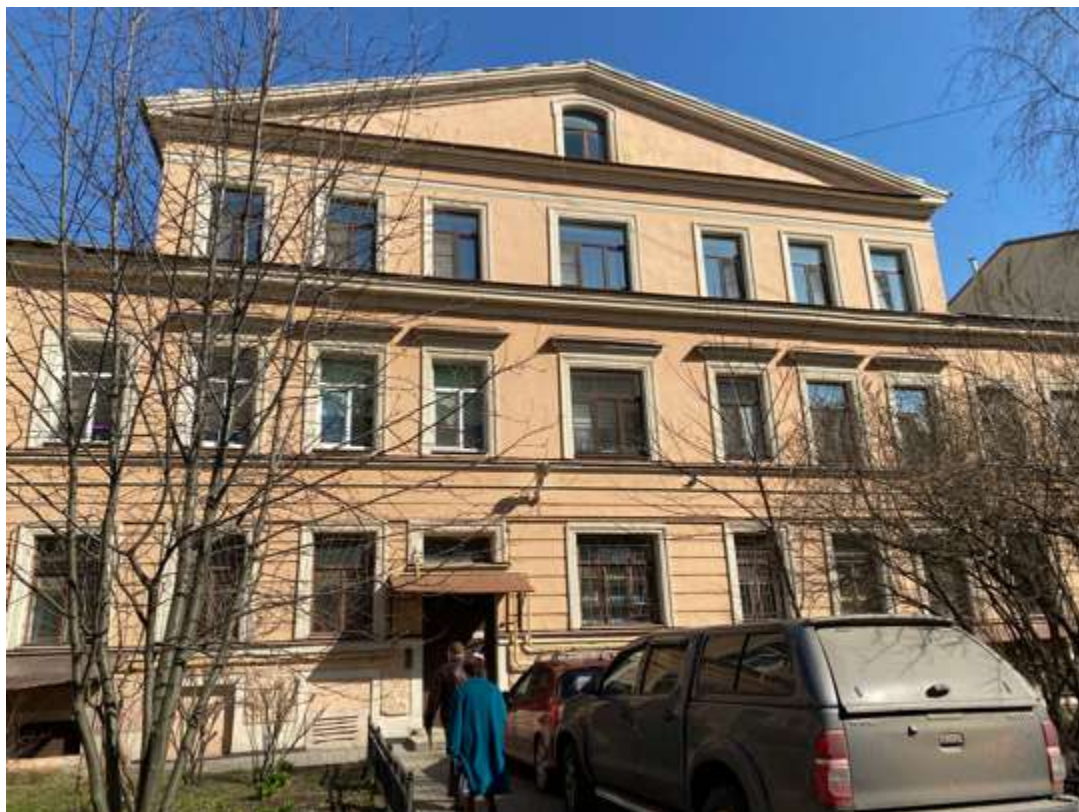
6. Фрагмент дворового фасада флигеля
