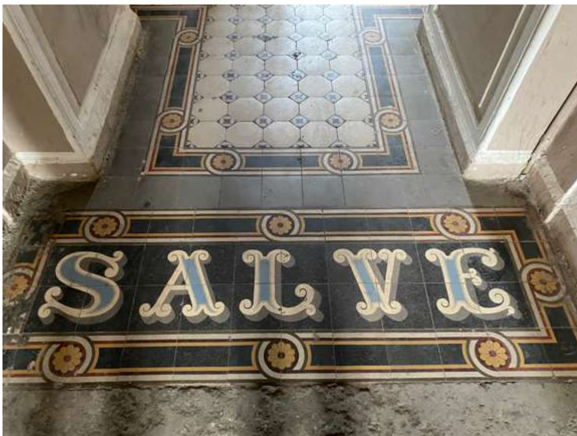
21. Напольное покрытие на площадке лестницы в уровне первого этажа
