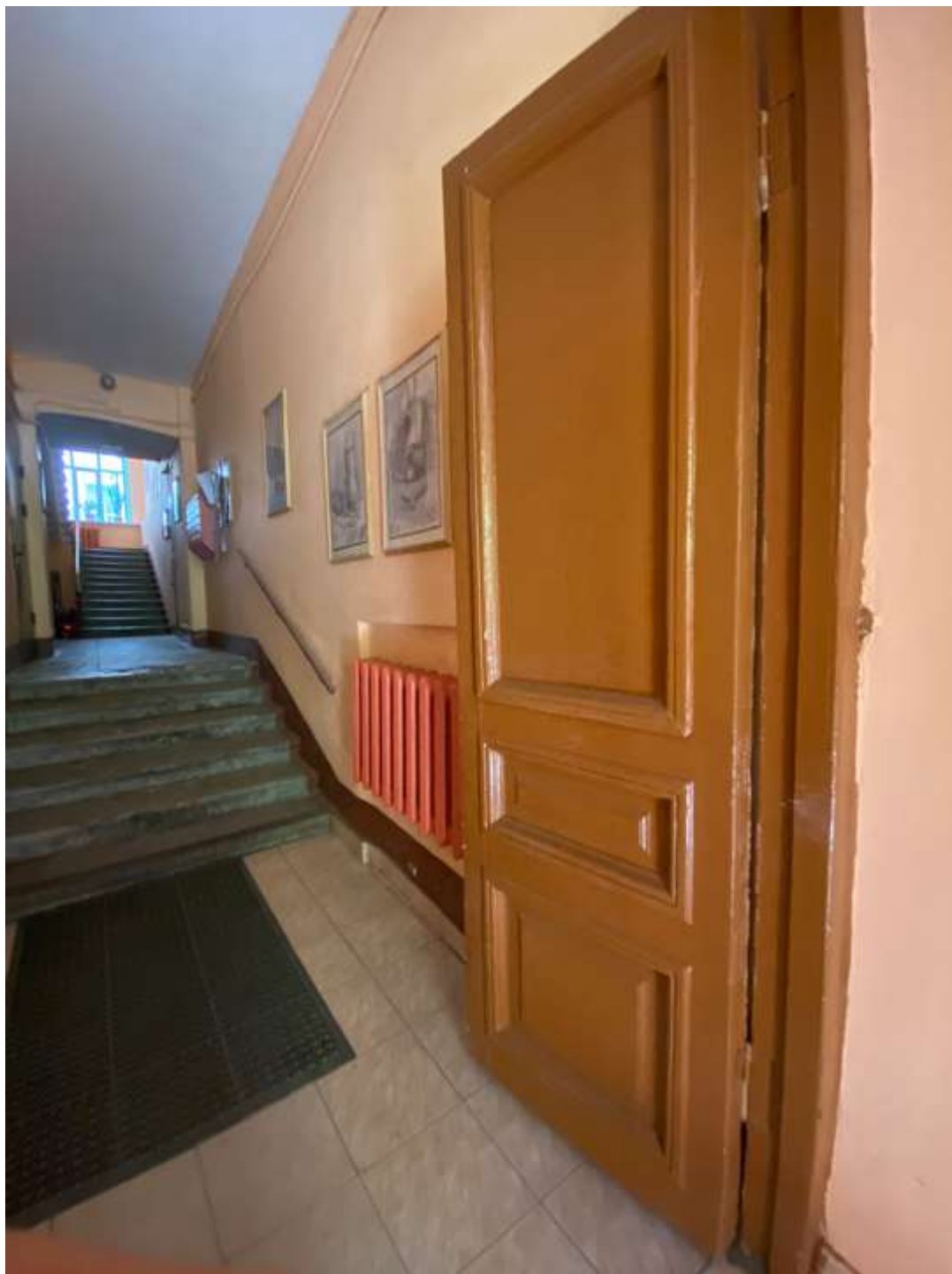
9. Дверное заполнение входа на лестницу 1ЛК
