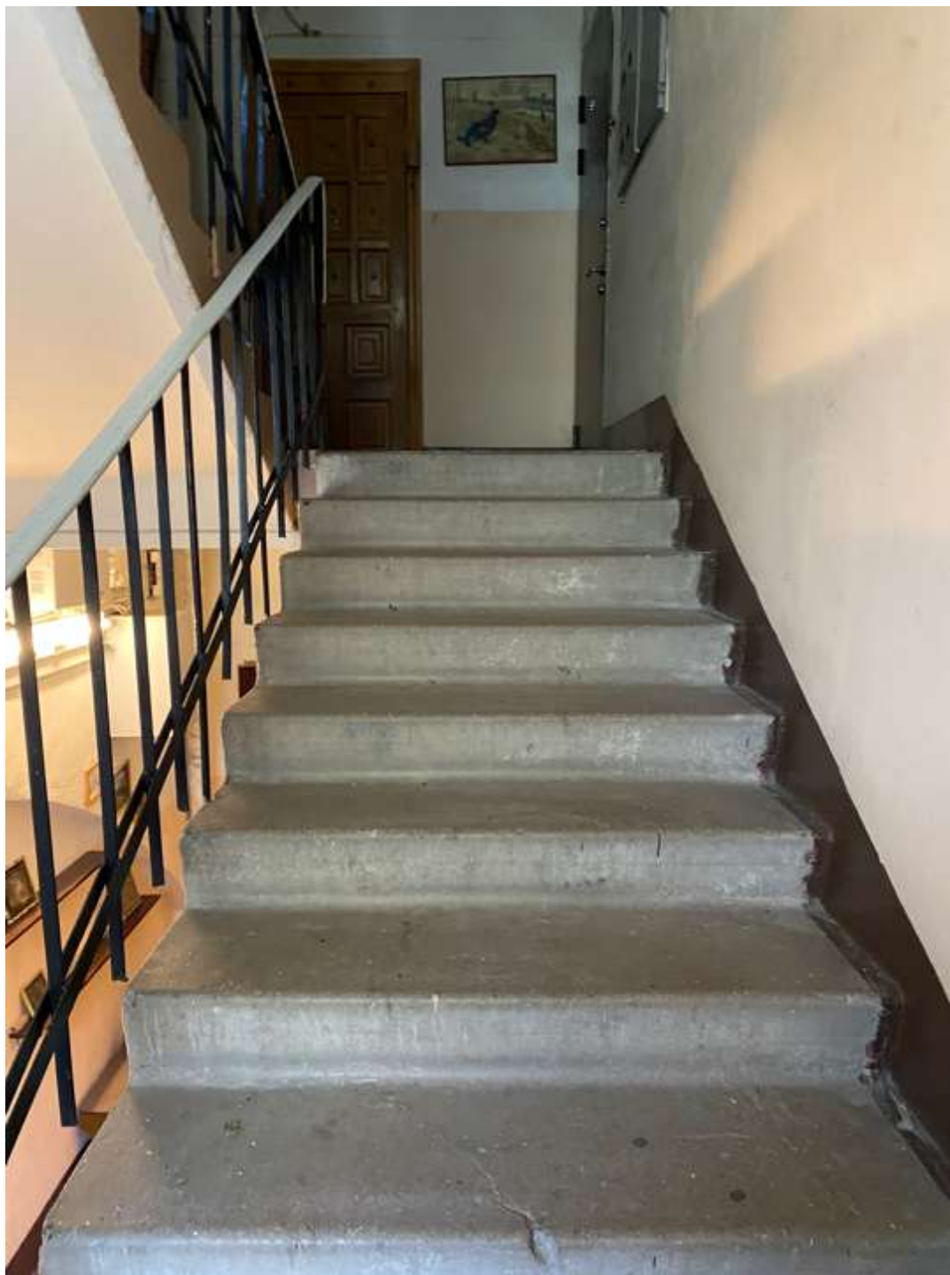
15. Лестница 2ЛК в уровне второго этажа
