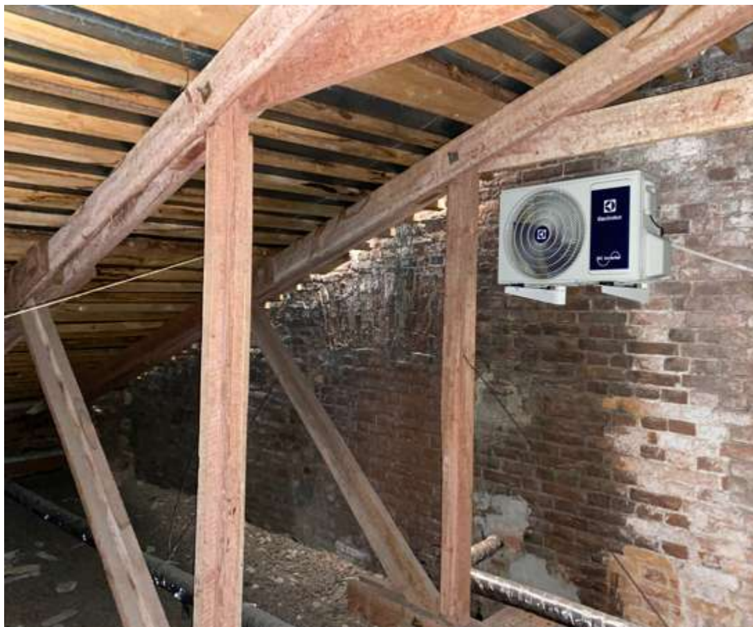
19. Фрагмент интеръера чердака
