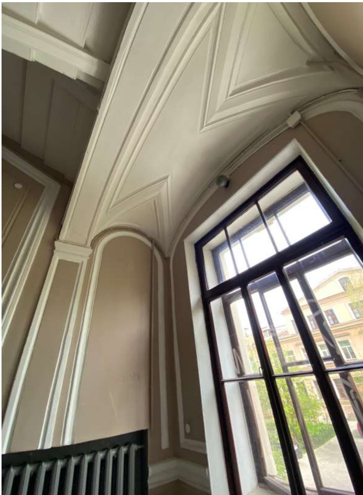
26. Лестница 2ЛК между первым и вторым этажами
