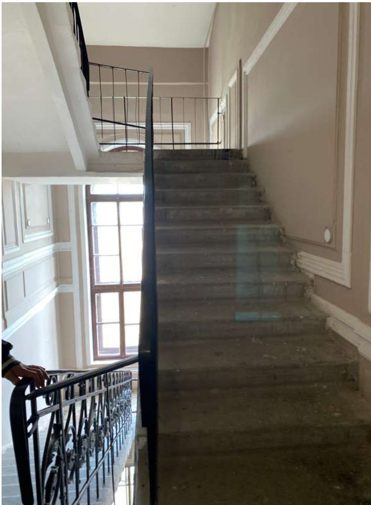
36. Лестница 2ЛК в уровне четвертого этажа
