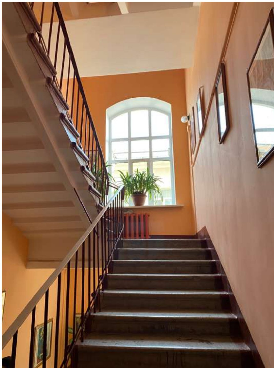
14. Лестница 1ЛК в уровне второго этажа
