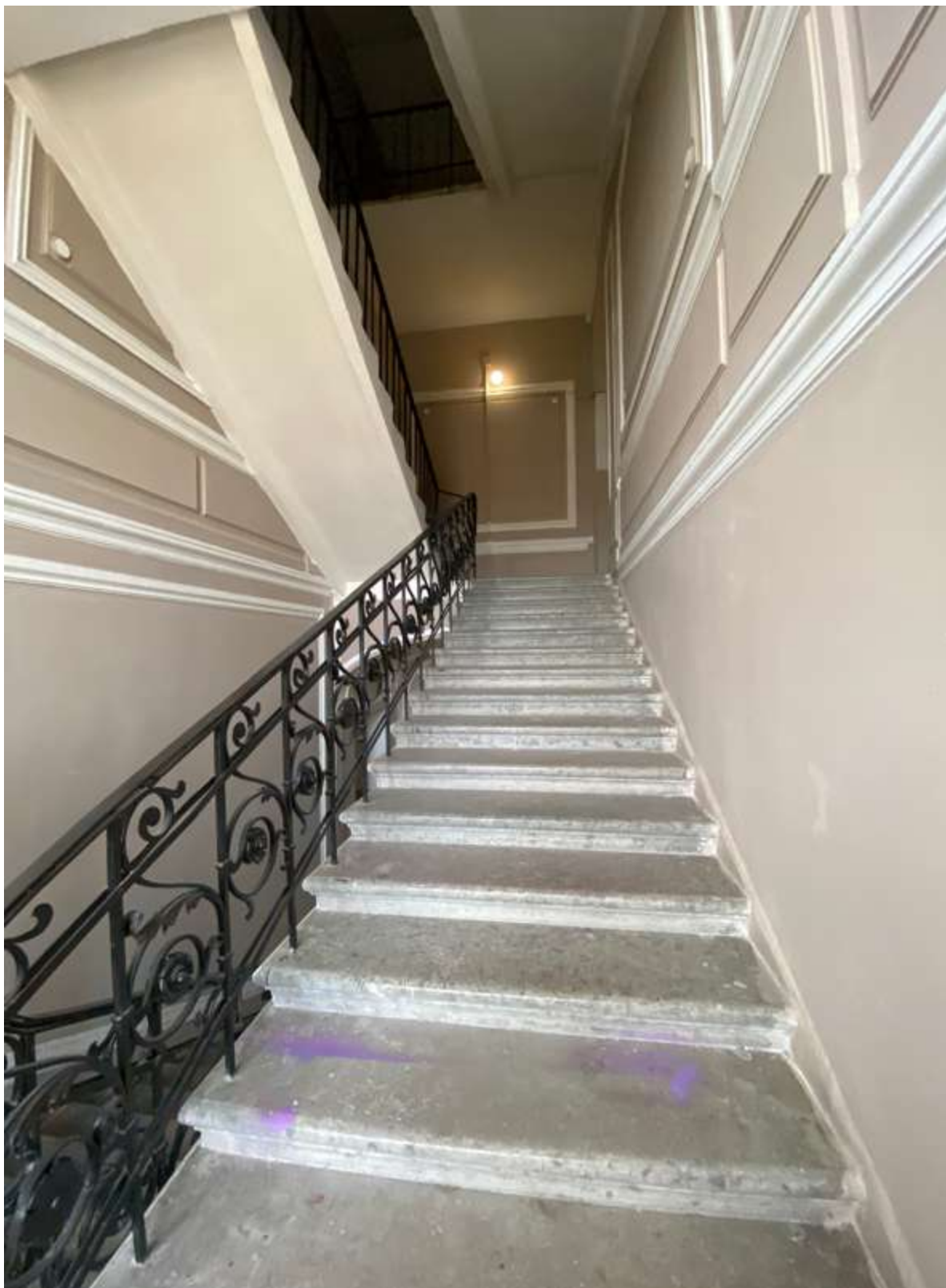
33. Лестница 2ЛК в уровне четвертого этажа
