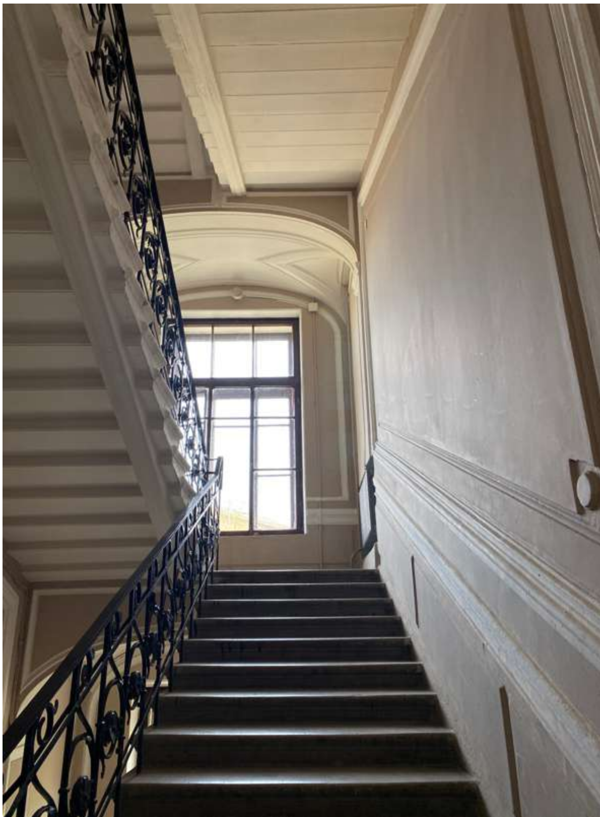
30. Лестница 2ЛК в уровне второго этажа
