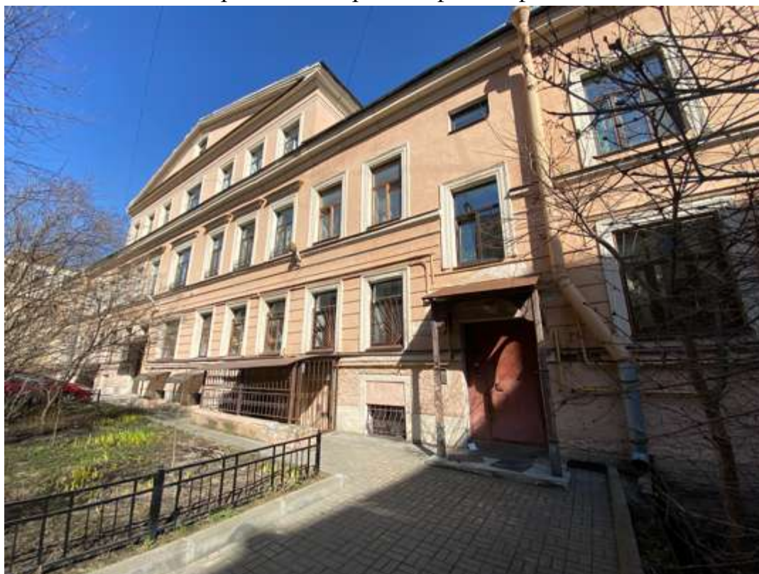
7. Фрагмент дворового фасада флигеля
