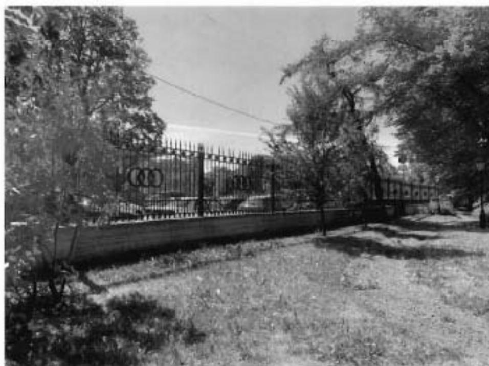
3. Фрагмент северного фасада объекта культурного наследия.
