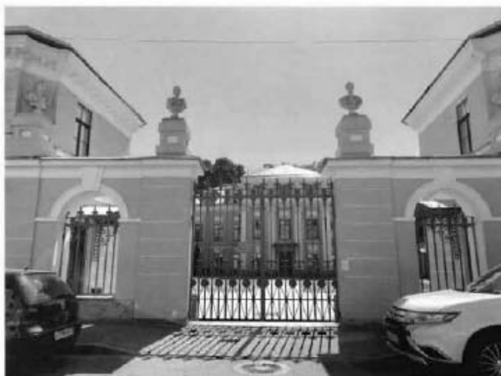
1. Северный фасад объекта культурного наследия.
