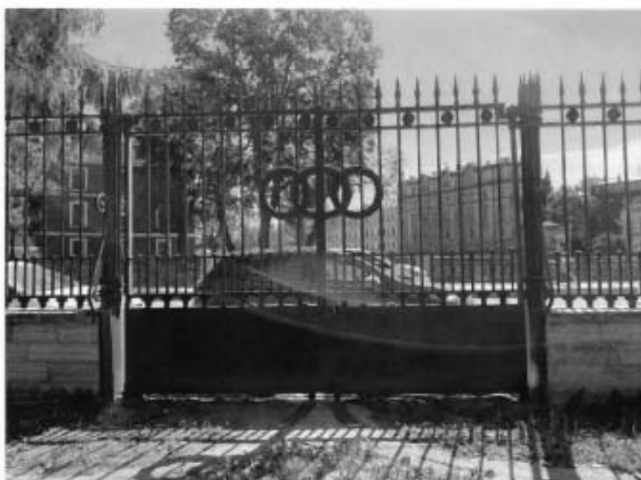
5. Общій вид ворот на северном фасаде объекта культурного наследия.
