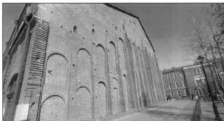
7. Южный фасад объекта культурного наследия.
