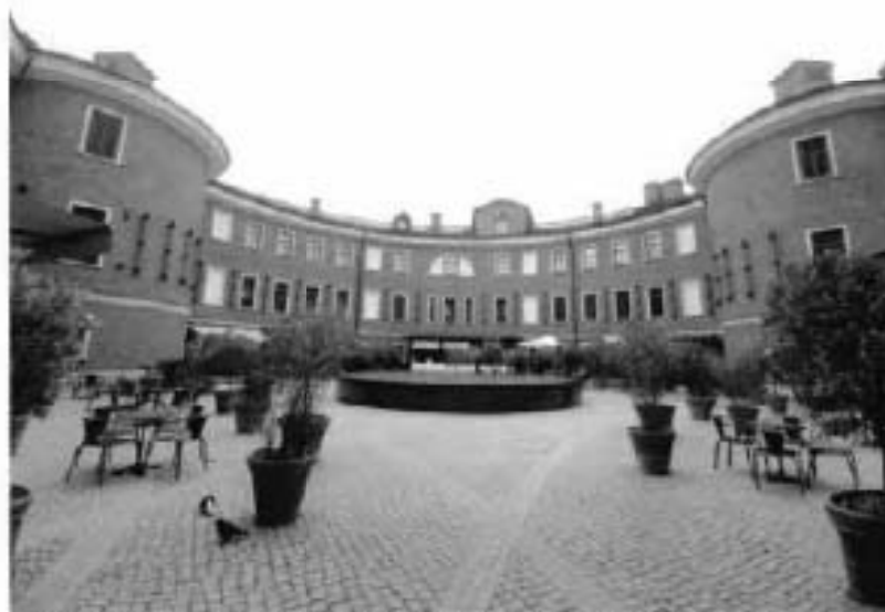
3. Вид на фрагмент дворового фасада и территорию внутреннего двора объекта культурного наследия (фотография от 28.06.2022)
