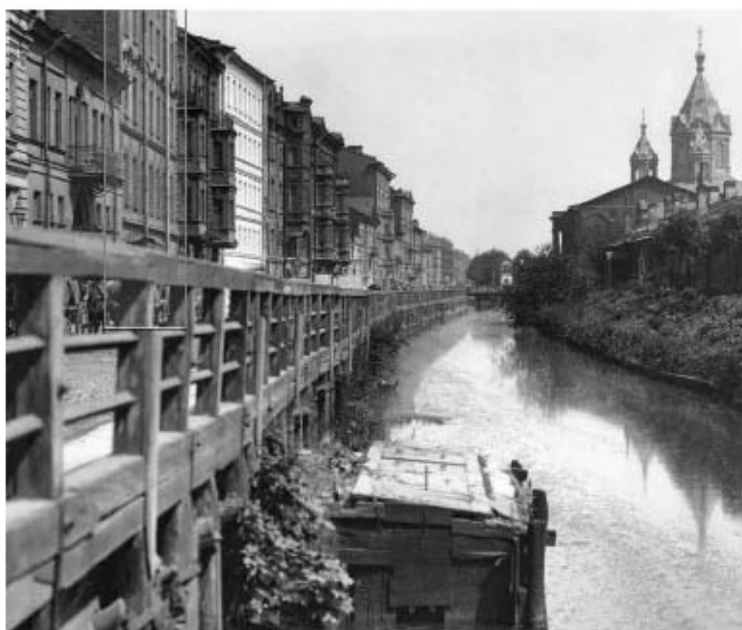
Илл. 10. Вид на Адмиралтейский канал и церковь Благовещения Пресвятой Богородицы. Фото 1902-1914 гг.
