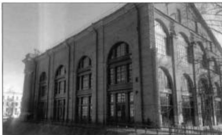
2. Северный фасад объекта культурного наследия.
