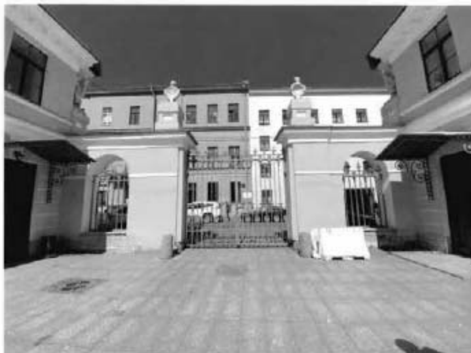
2. Южный фасад объекта культурного наследия.
