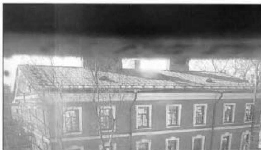
5. Кровля объекта культурного наследия.
