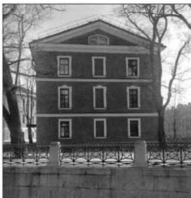
4. Западный фасад объекта культурного наследия.
