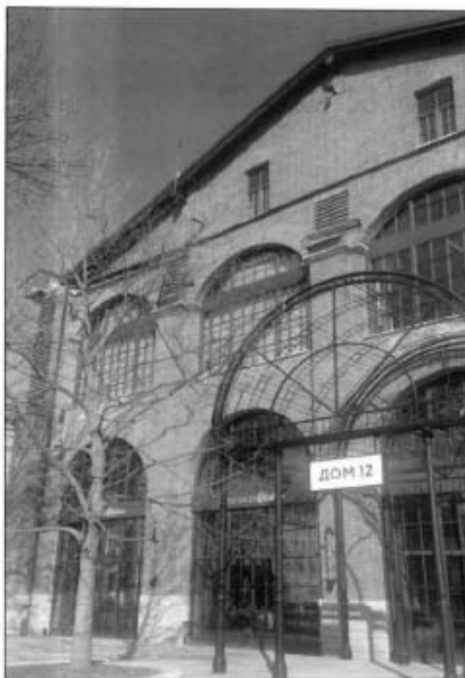
6. Фрагмент западного фасада объекта культурного наследия.
