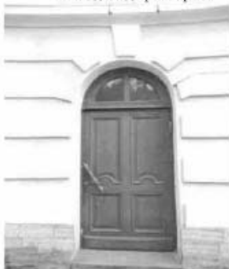
5. Входной дверной проем
