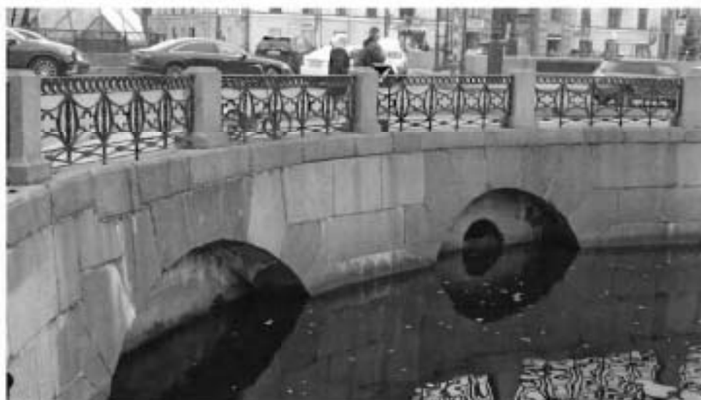
3. Вид на объект культурного наследия с юго-западной стороны в сторону пл. Труда.
