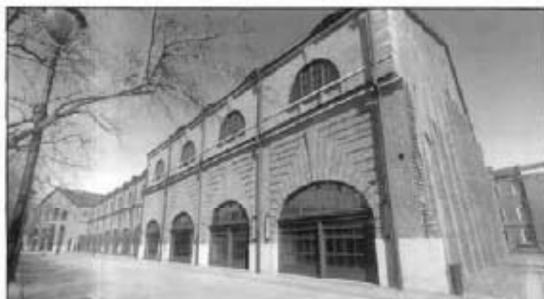
4. Западный фасад объекта культурного наследия.
