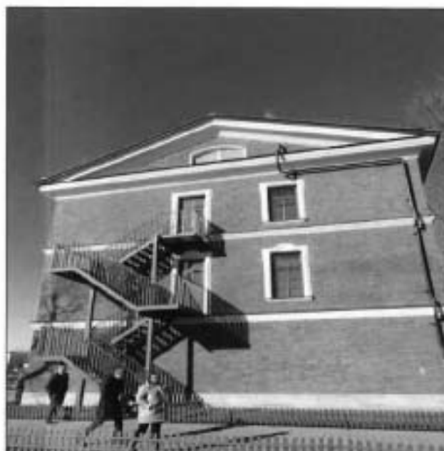
3. Восточный фасад объекта культурного наследия
