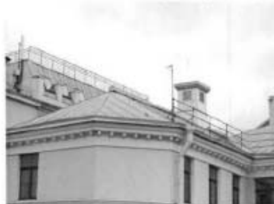
8. Металлическое покрытие кровли
