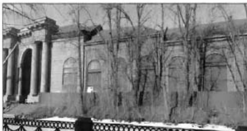
14. Фрагмент южного лицевого фасада объекта культурного наследия.
