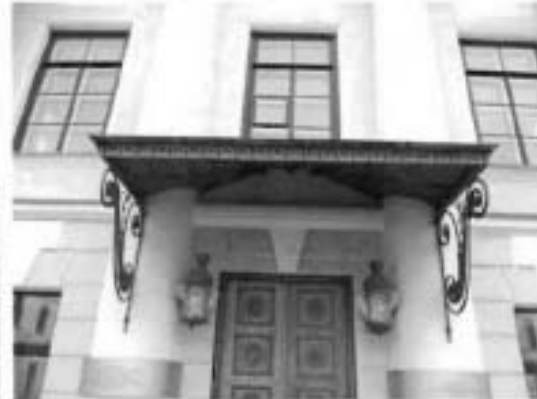
9. Кованый козырек на кронштейнах над входом
