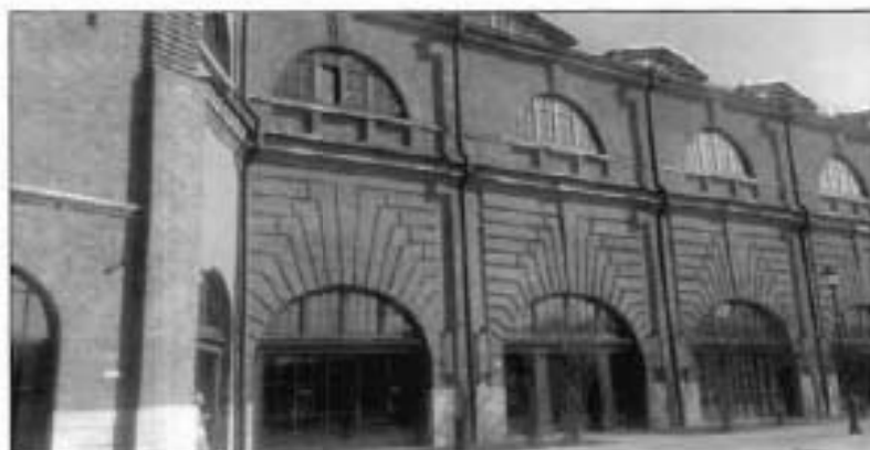
5. Фрагмент западного фасада объекта культурного наследия.
