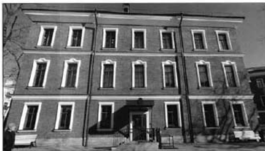
2. Южный фасад объекта культурного наследия.
