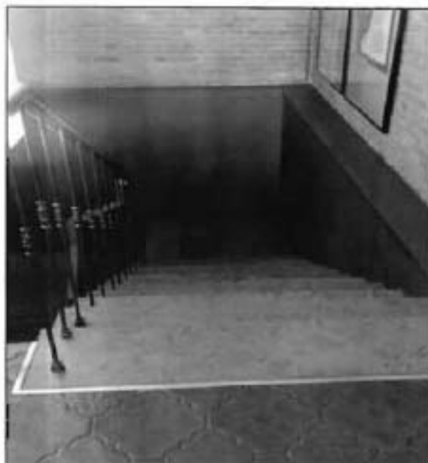
5. Лестница (пом. 1-Н (11, 25, 40)).
