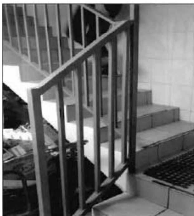
6. Лестница (пом. 1-Н (24, 30)).
