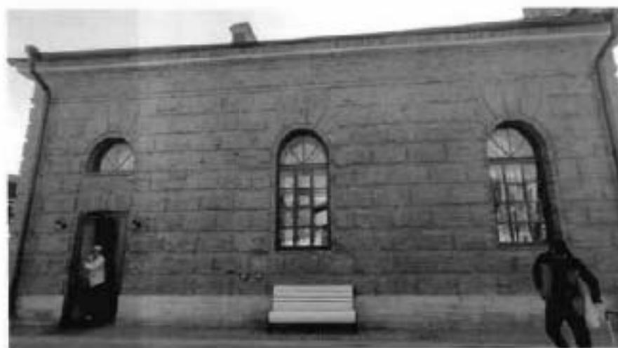
2. Северный фасад объекта культурного наследия.
