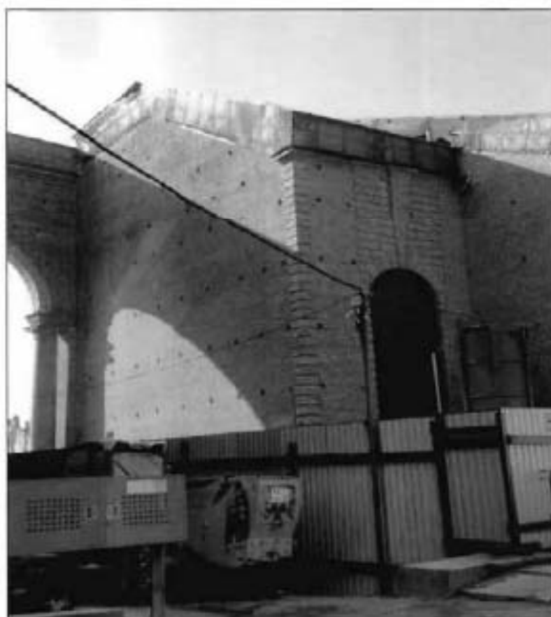
25. Вид на фланкирующую арку западного объема объекта культурного наследия.
