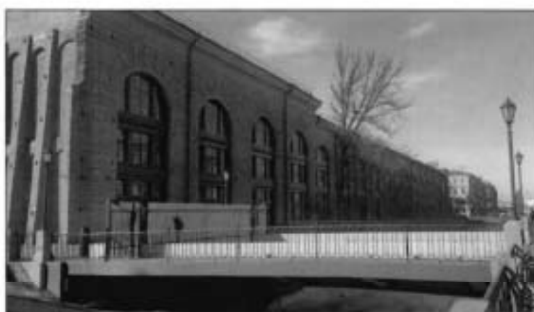
1. Лицевой фасад объекта культурного наследия.
