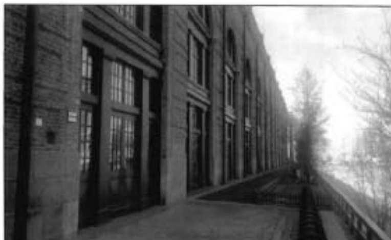
8. Восточный фасад объекта культурного наследия.
