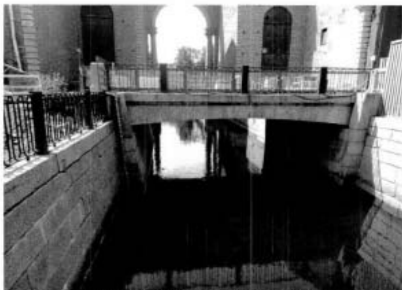
2. Канал, расположенный с южной стороны.
