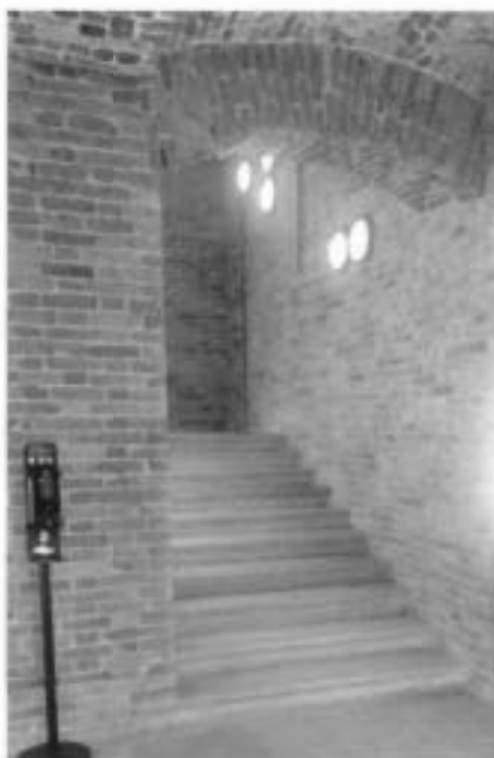
4. Вид на лестницу пом. 1-Н (59) объекта культурного наследия (фотография от 18.03.2022)
