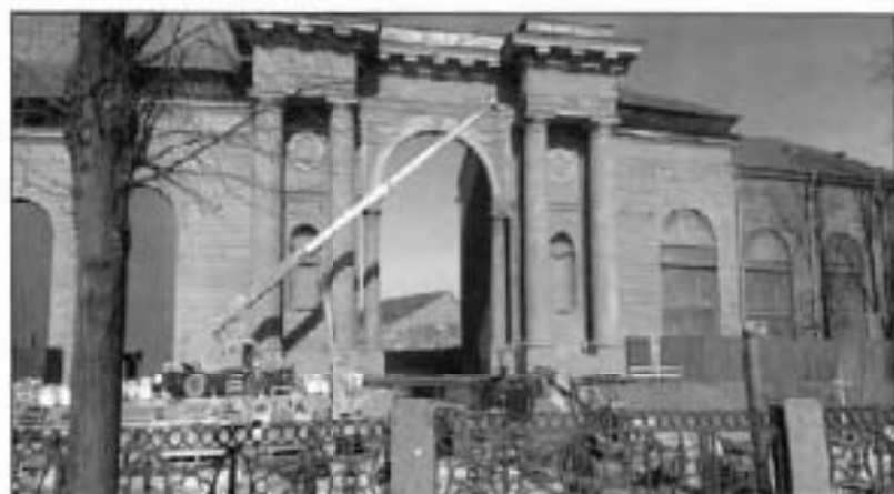
16. Вид на арку объекта культурного наследия между корпусами литеры О и литеры Н.
