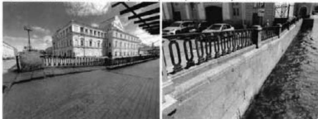
33. Общий вид набережной от моста Декабристов до Матвеева моста
