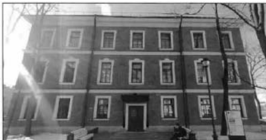
1. Северный фасад объекта культурного наследия.
