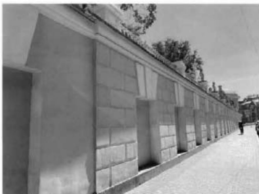
3. Фрагмент западного фасада объекта культурного наследия.
