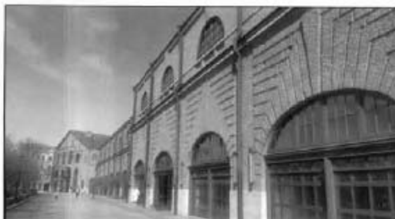
3. Западный фасад объекта культурного наследия.
