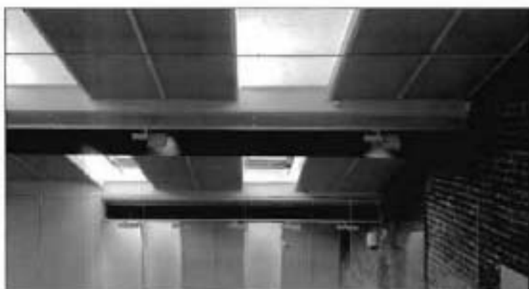
12. Помещение артресолит 4-го этажа.
